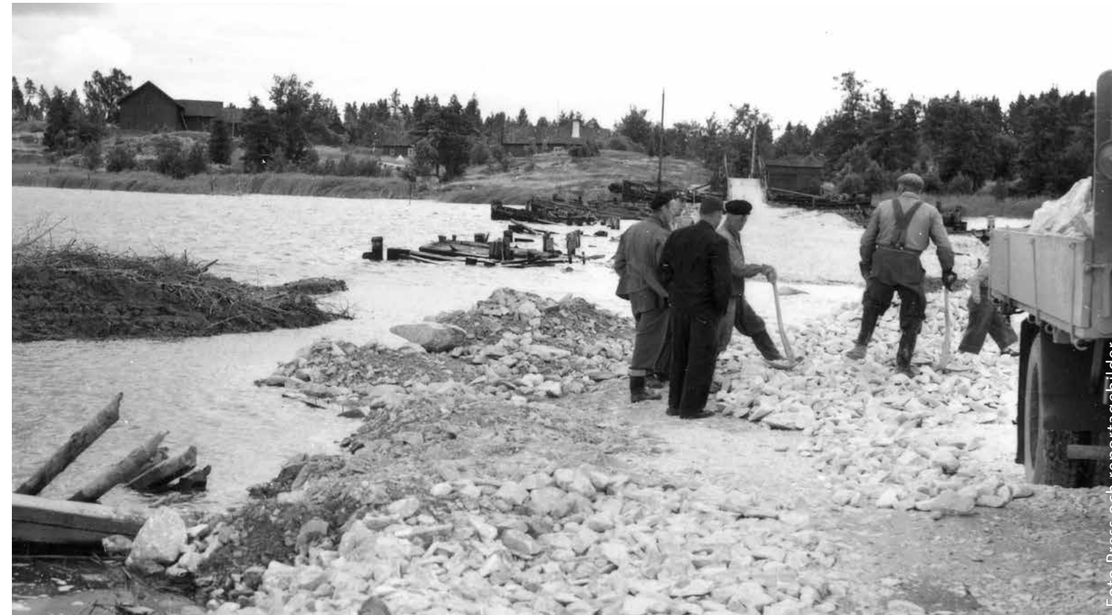
Vägbanken är byggd på prämar, rester av dem sticker upp här på bilden som togs 1952.
