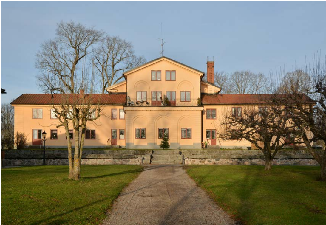
Orangeriets södra sida. Byggnaden inrymmer idag lägenheter. I de välvda partierna i byggnadens centrala del fanns tidigare stora glasade partier.. (SLM D2020-0359)
