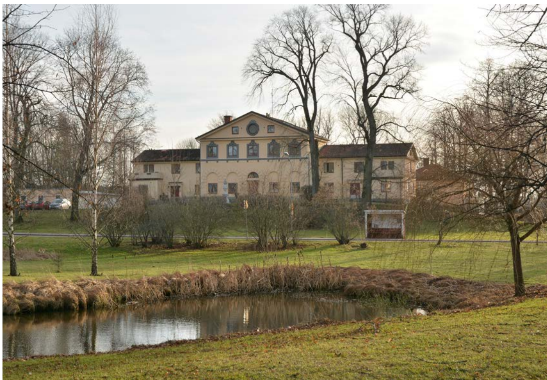
Orangeriet sett från slottsparken i norr med den södra slottedammen i förgrunden. Nya byggnader på gräsytan framför orangeriet riskerar att påverka orangeriets koppling till slottet och parken negativt, och de också skulle förta en del av orangeriets monumentalitet. (SLM D2020-0360)
