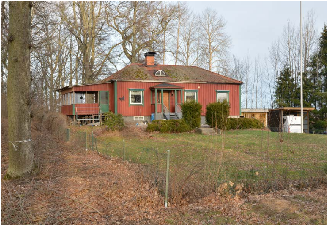
Bostadshuset vid Bondegatan (Sävstaholm 13:7) i östra hörnet av slottsparken. (SLM D2020-0333)
