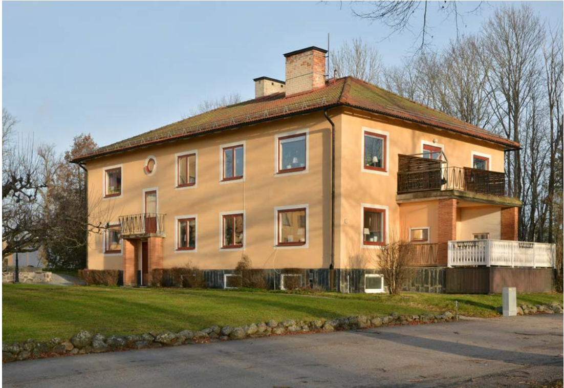
Fastigheten Orangeriet 1 söder om orangeribyggnaden. Huset uppfördes tillsammans med det snarlika huset på Orangeriet 2 i slutet av 1940-talet och har en mycket välbevarad och tidstypisk utformning. (SLM D2020-0362)
