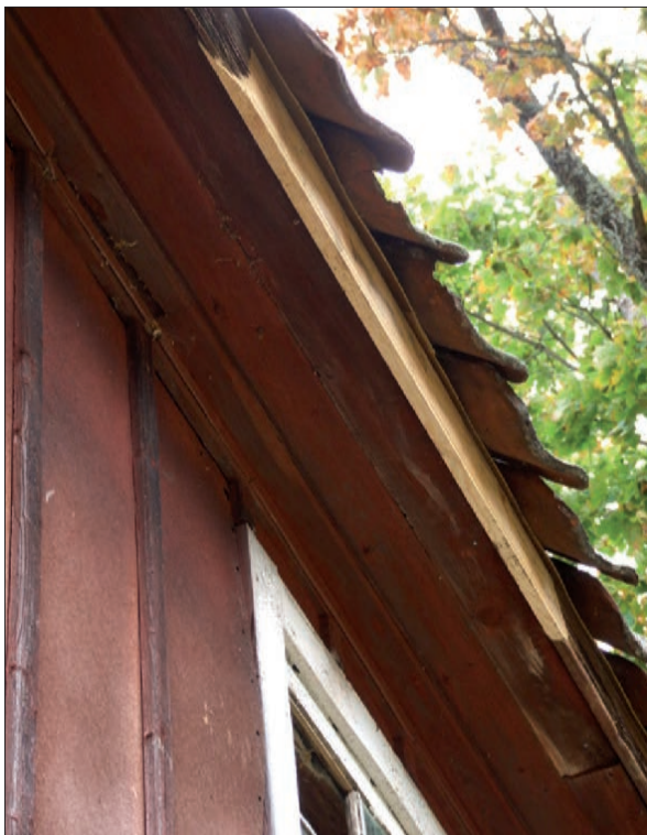
7 Rötskadade delar av takfotsbrädan lagades i med friskt virke (Slm D12-0803).
