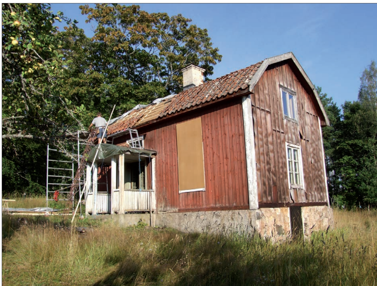
11 Lillstugan sedd från nordväst under takrenoveringen. Masonitskivor lades nu under teglet. I bild hantverkare Emanuel Jakobsson (Slm D12-0807).
