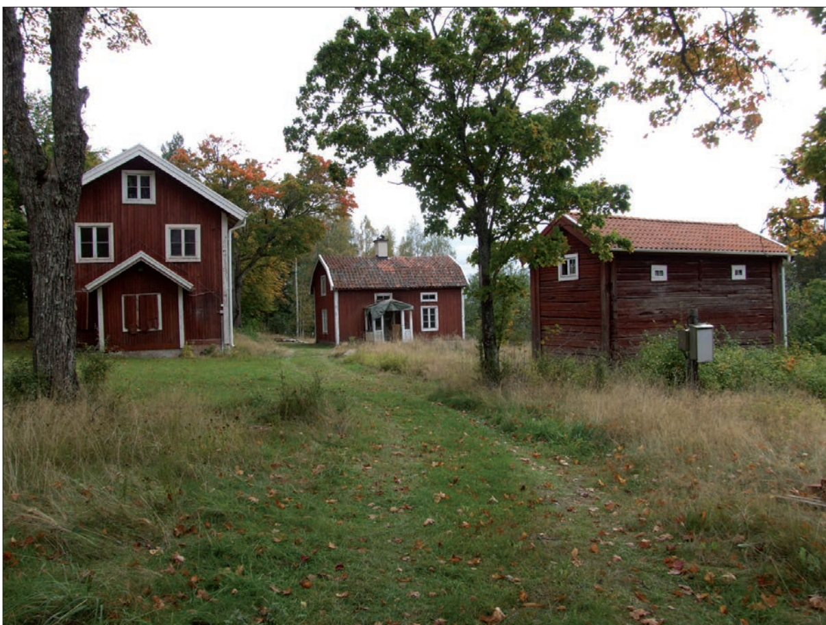
2 Sandängs gård från norr: Till vänster syns det nyare bostadshuset, i bildens mitt syns lillstugan och till höger boden. Före renoveringen i augusti 2012 (Slm D12-0800).
