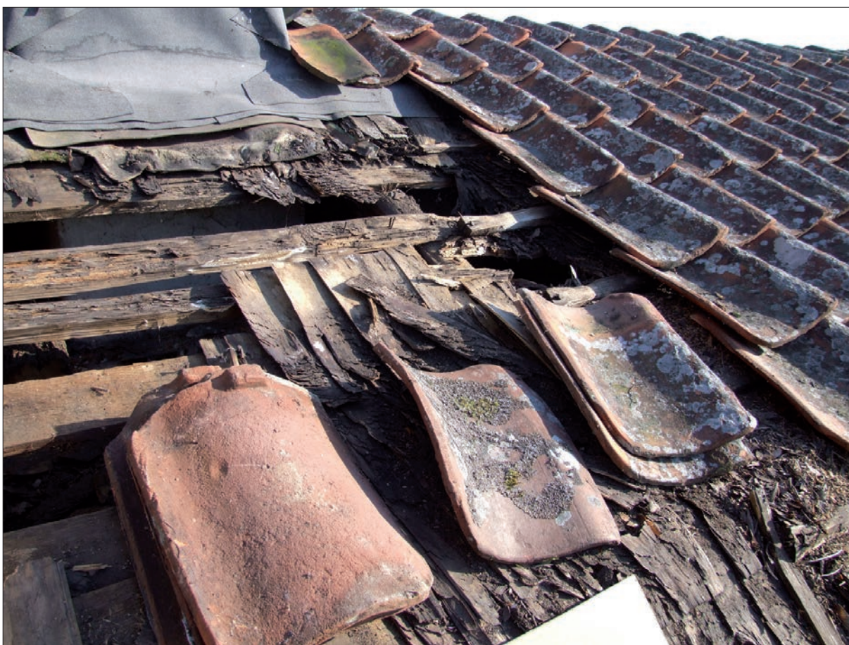
6 Del av norra takfallet under reparationen. Den undre stickspånstäckningen behölls, men vattenskadade och rötade partier togs bort. Ovanpå lades oljehärdade masonitskivor (Slm D12-0802).
