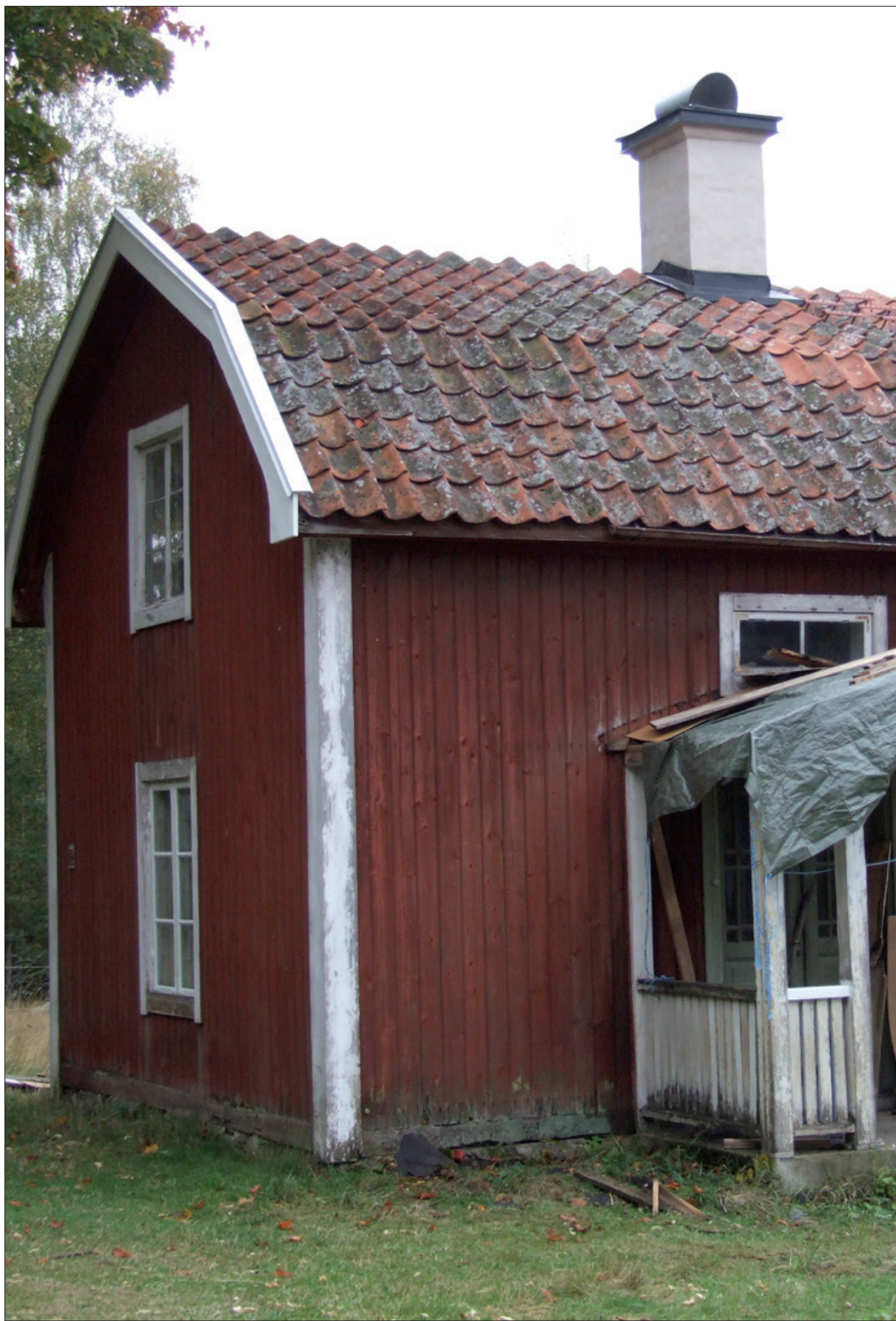
12 Lillstugan sedd från norr efter takrenoveringen vid slutbesiktningen den 25 september (Slm D12-0808).
