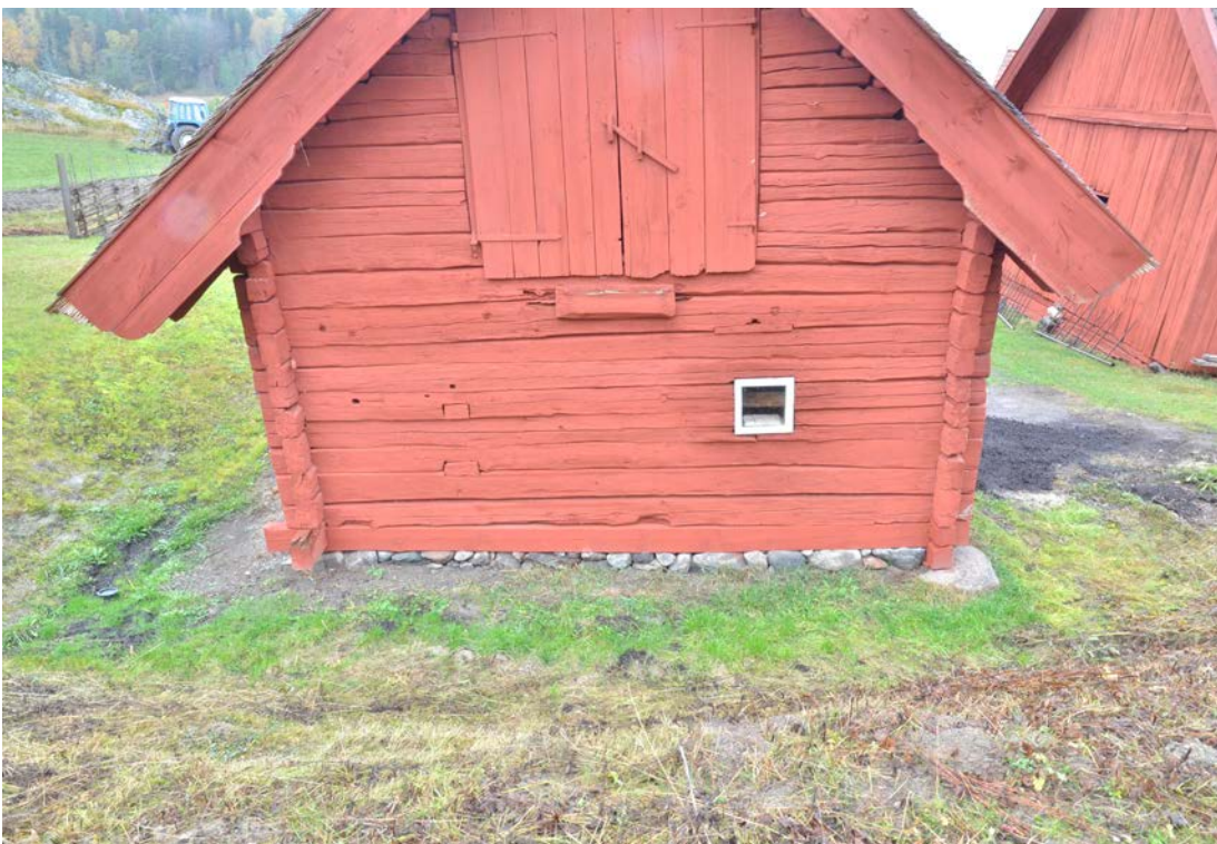
Bild 25. Oxstallet efter avslutade åtgärder. Foto 2022-10-25. SLM D2023-0023.
