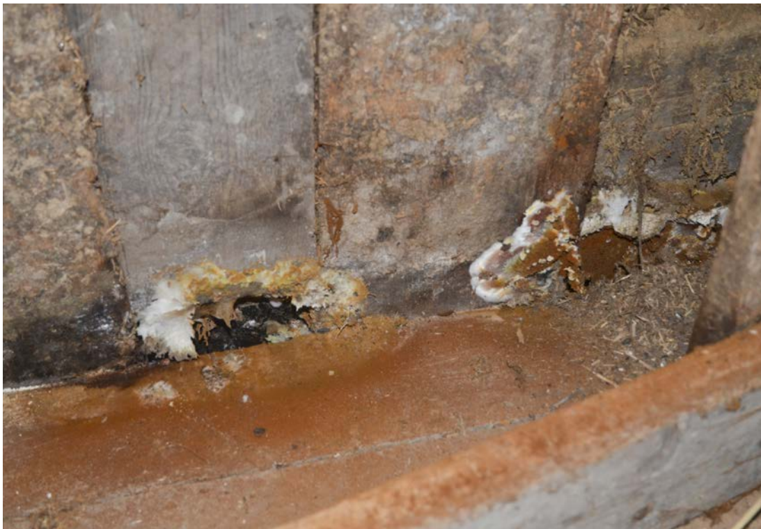
Bild 11. Svampkroppar bakom den borttagna golvlisten i oxstallets nordöstra hörn. Foto 2021-10-07, SLM D2023-0009.
