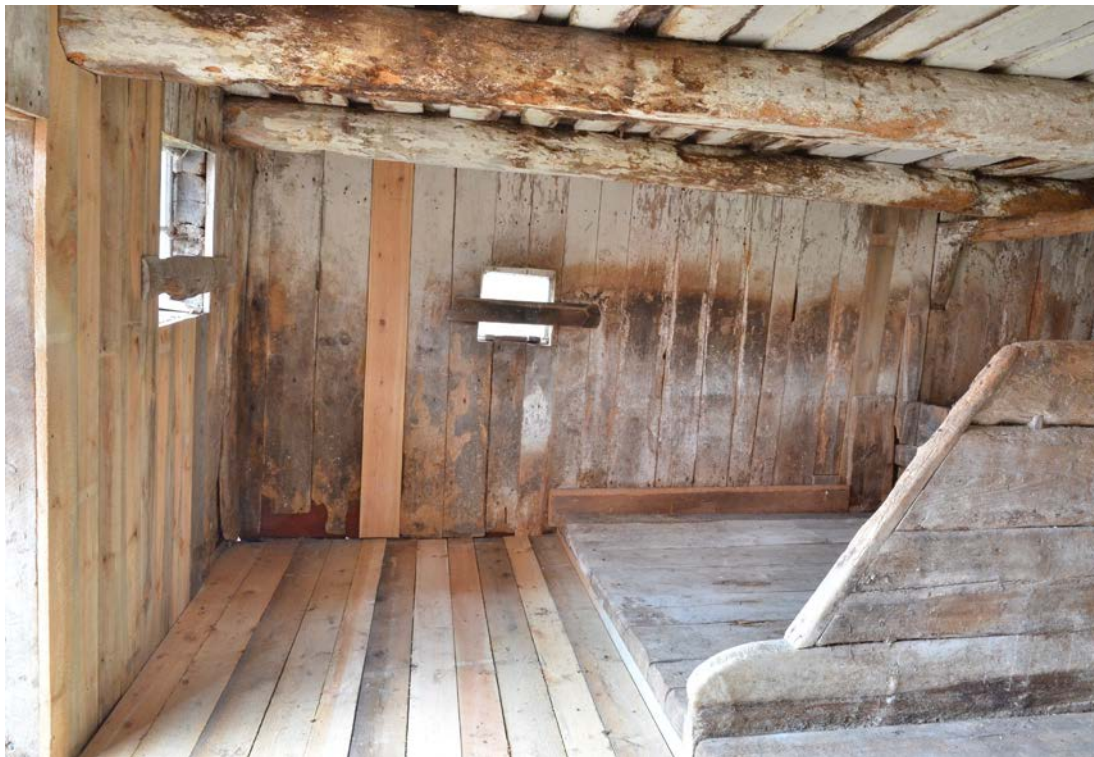
Bild 28. Oxstallet efter avslutade åtgärder. Foto 2022-10-25. SLM D2023-0026.
