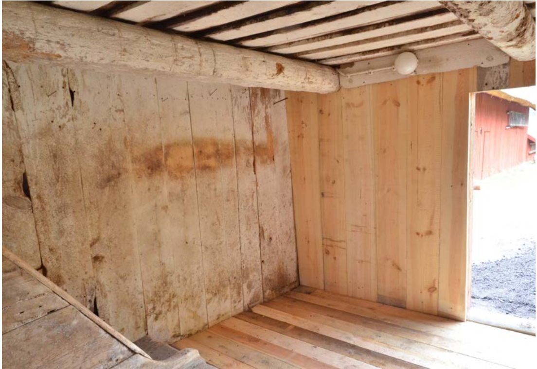
Bild 30. Oxstallet efter avslutade åtgärder. Foto 2022-10-25. SLM D2023-0028.
