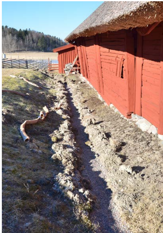
Bild 18. Pågående grävning för ny dräneringsledning. Foto 2022-03-04. SLM D2023-0016.
