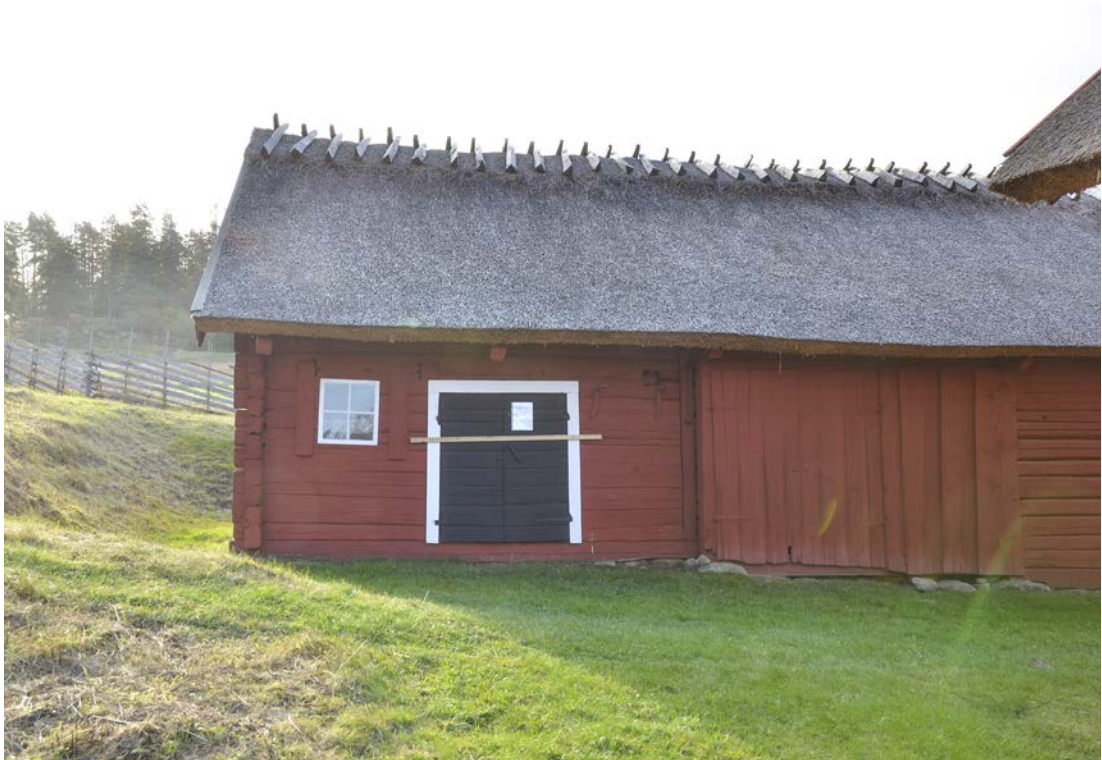
Bild 3. Ladugården med oxstall innan åtgärder. Foto 2021-10-25. SLM D2023-0001.
