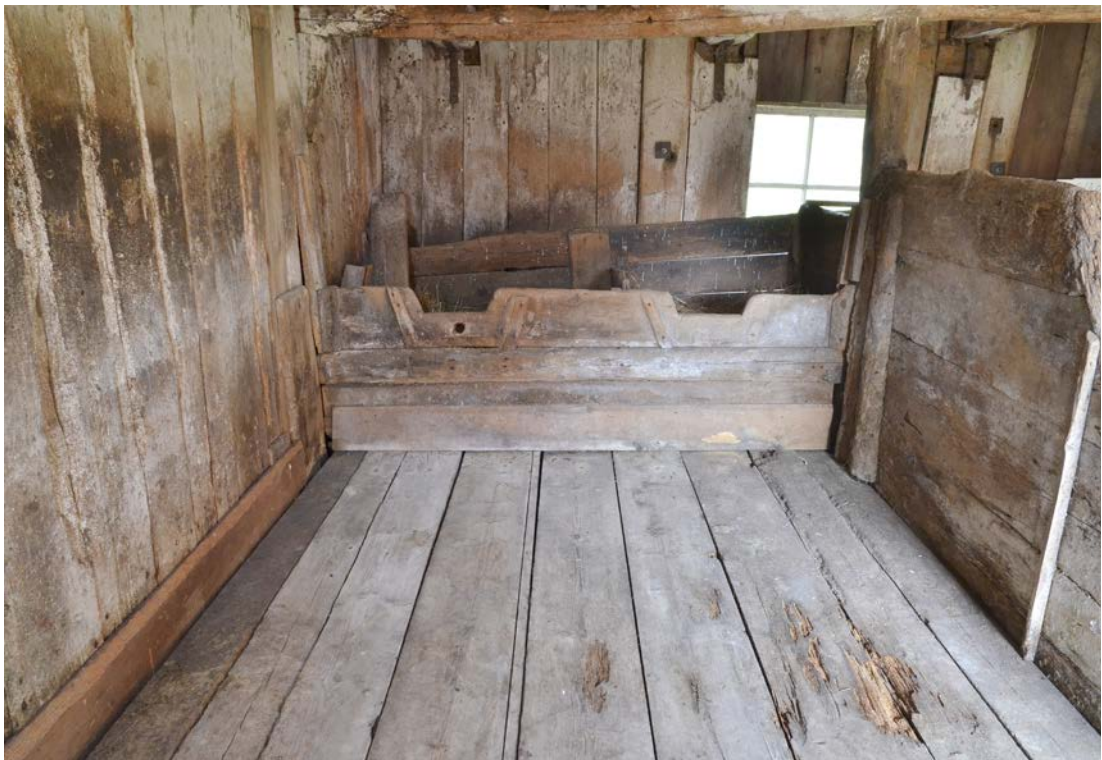
Bild 27. Oxstallet efter avslutade åtgärder. Foto 2022-10-25. SLM D2023-0025.
