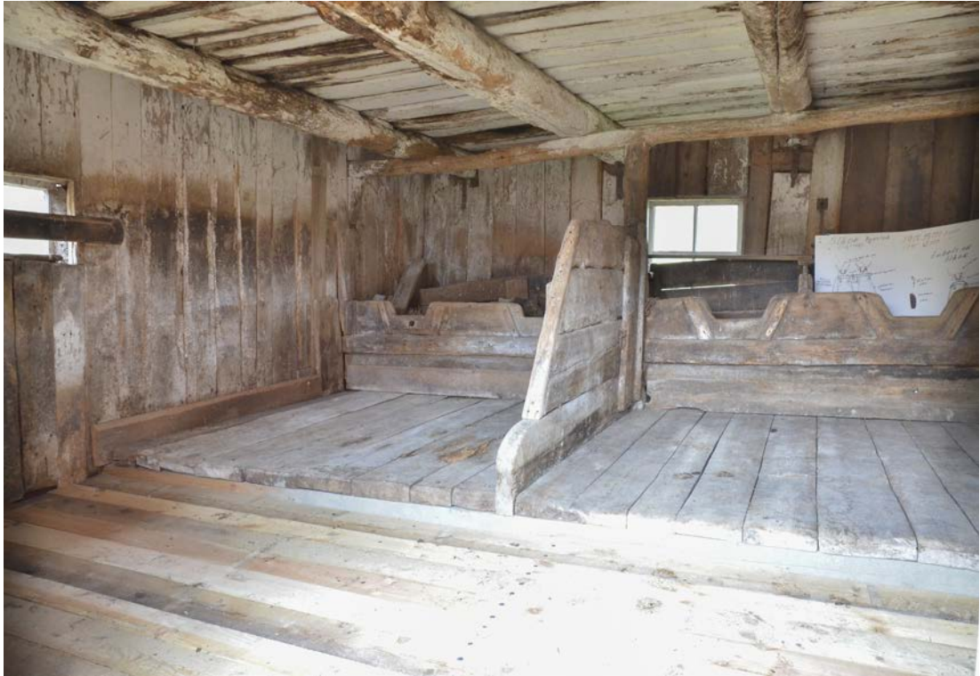
Bild 26. Oxstallet efter avslutade åtgärder. Foto 2022-10-25. SLM D2023-0024.
