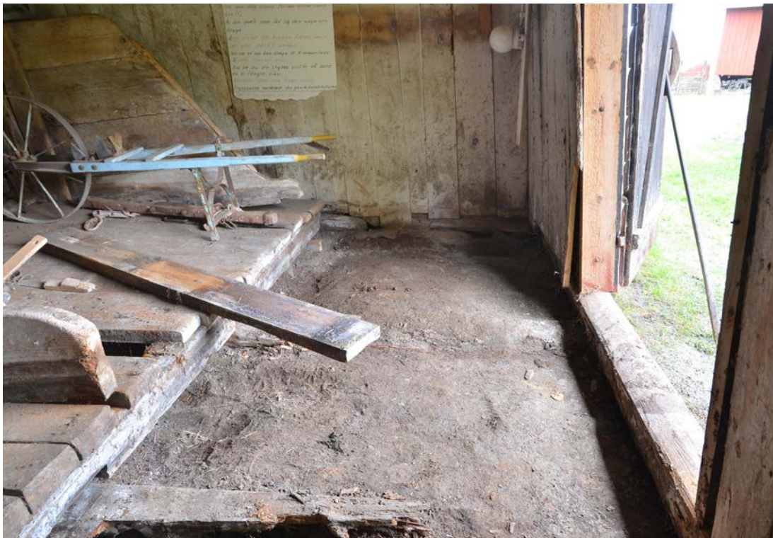
Bild 14. Främre golvdelen efter att brädor och fyllning avlägsnats. Foto 2021-11-09. SLM D2023-0012.
