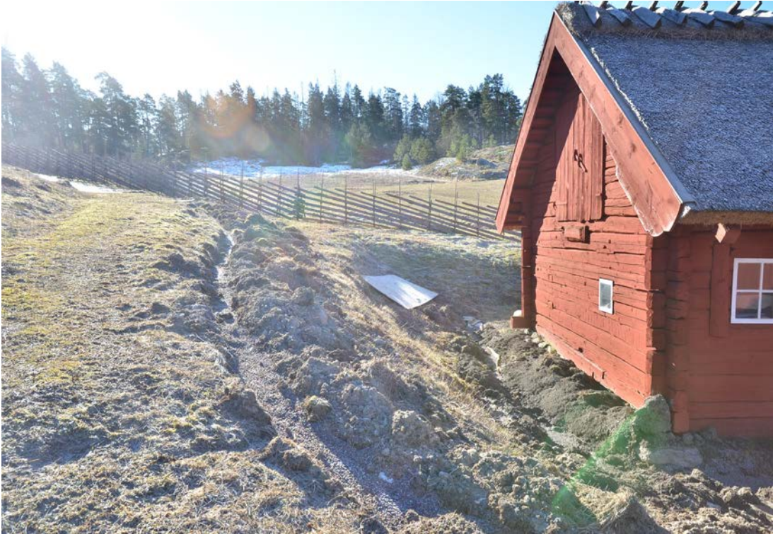
Bild 16. Pågående grävning av diken för dränering. Foto 2022-03-04. SLM D2023-0014.
