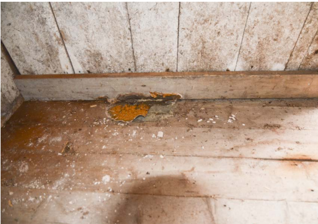
Bild 10. Svampkropp i oxstallets nordvästra hörn. Foto 2021-10-07. SLM D2023-0008.
