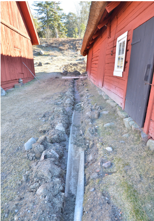
Bild 17. Pågående grävning för ny dräneringsledning. Foto 2022-03-04. SLM D2023-0015.
