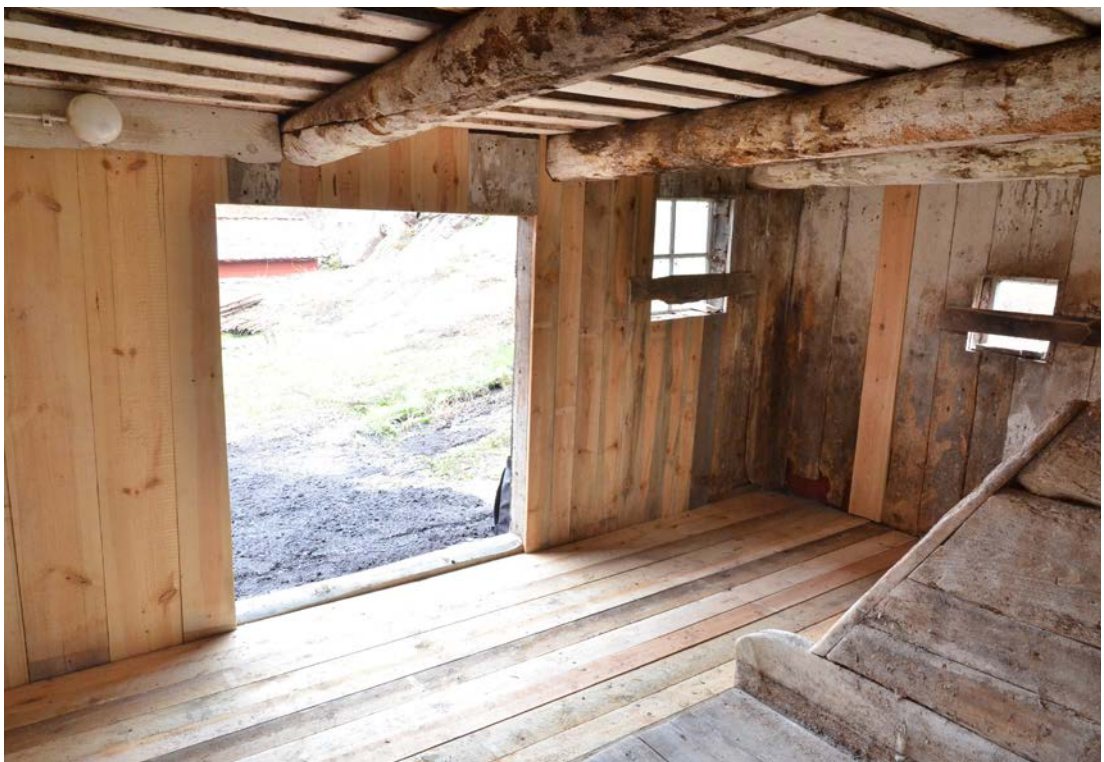
Bild 31. Oxstallet efter avslutade åtgärder. Foto 2022-10-25. SLM D2023-0029.
