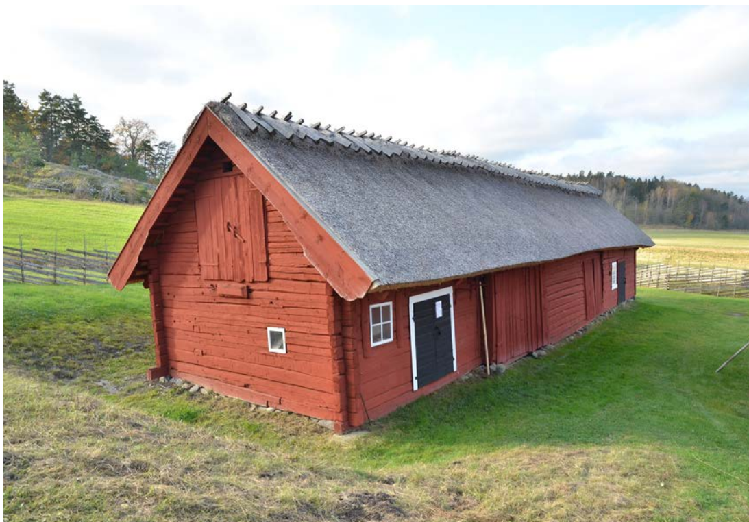
Bild 2. Ladugården med oxstallet i östra gaveln innan åtgärder. Vy mot sydväst. Foto 2021-10-25. SLM D2021-0588.
