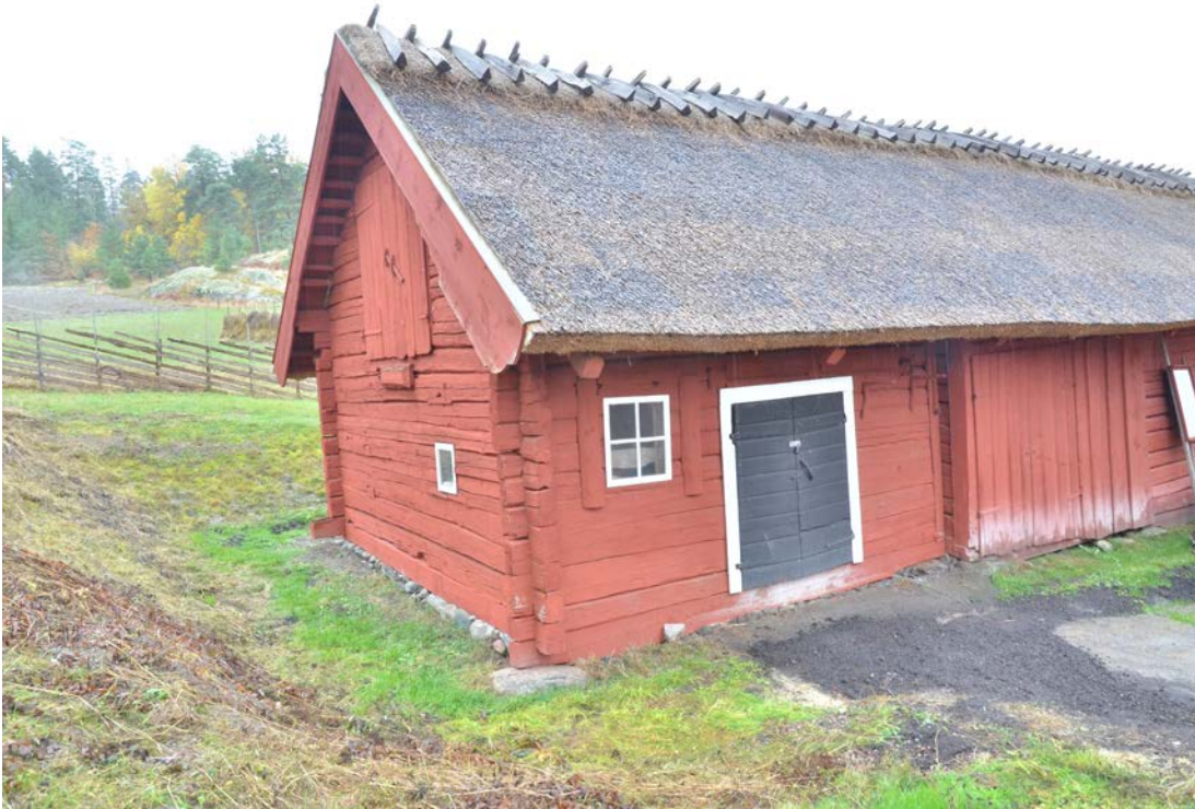
Bild 24. Oxstallet efter avslutade åtgärder. Foto 2022-10-25. SLM D2023-0022.
