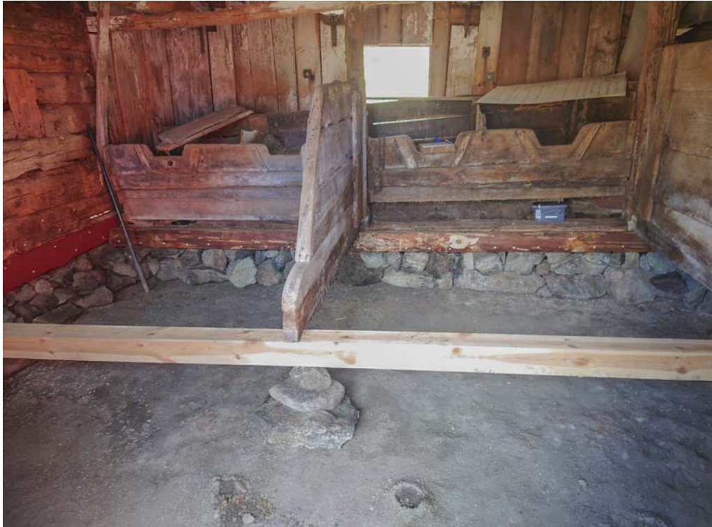
Bild 20. Ny grundläggning under fodertrågen och östra gavelns syll. Foto av Jon Åhlund, augusti 2022. SLM D2023-0018.
