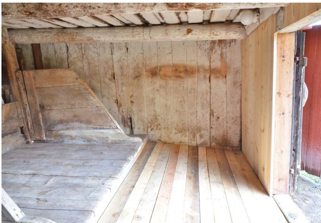
Bild 29. Oxstallet efter avslutade åtgärder. Foto 2022-10-25. SLM D2023-0027.
