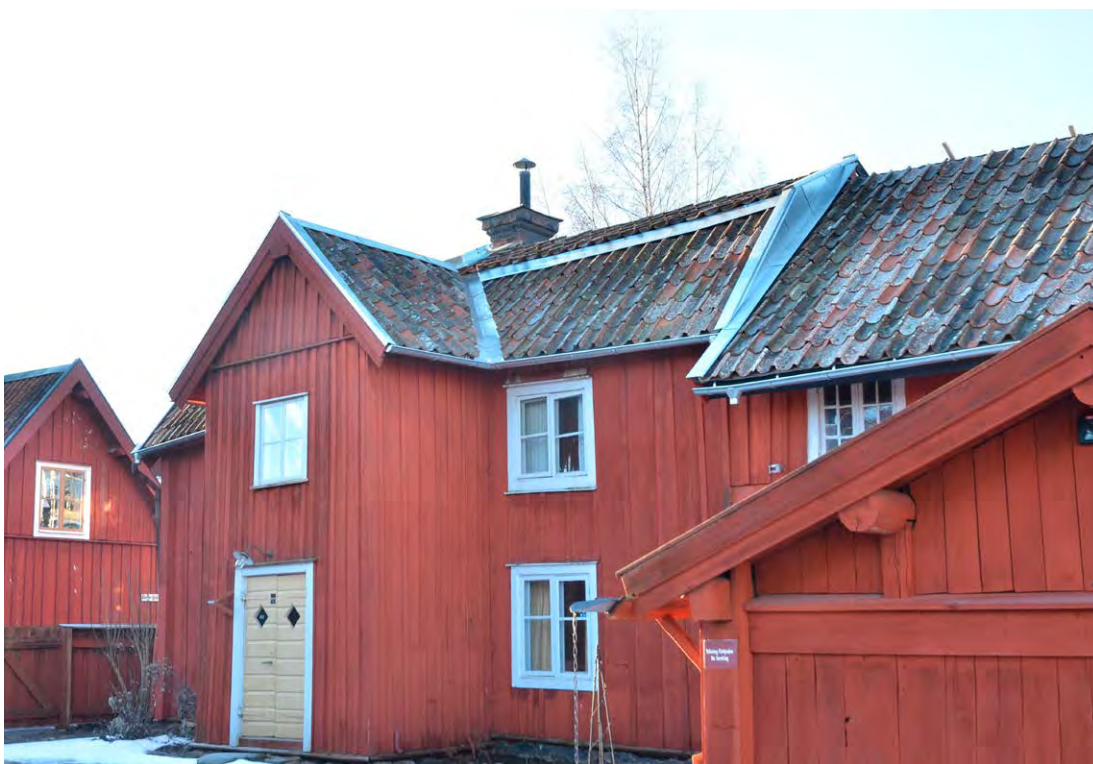
Bild 15. Garvarebostadens tak efter avslutad renovering. Målningen av de nya plåtdelarna återstår dock. Foto 2022-01-25. SLM D2022-0170.
