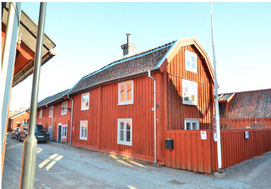
Bild 20. Garvarebostadens västra takfall efter avslutad renovering. Foto 2022-03-04. SLM D2022-0175.
