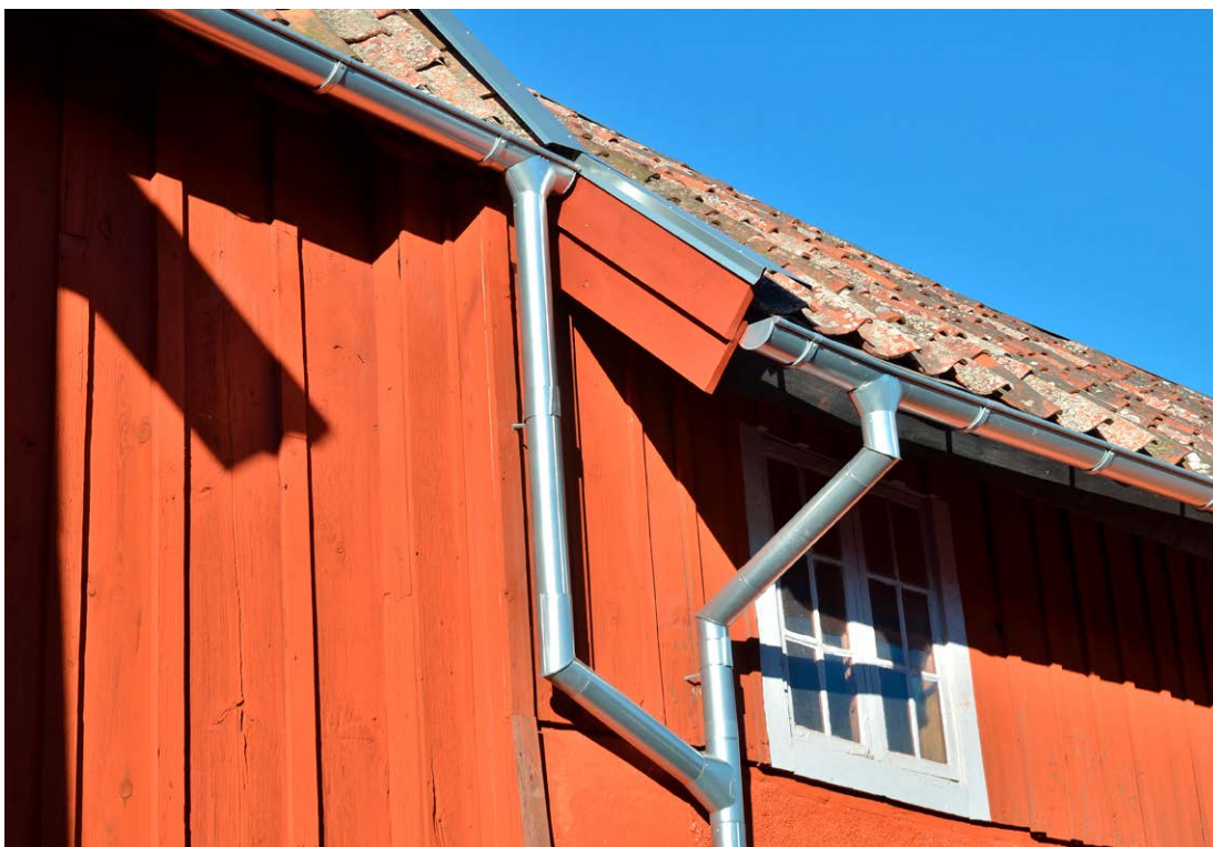
Bild 14. Handtillverkade stuprör på östra fasaderna. Foto 2022-03-04. SLM D2022-0169.
