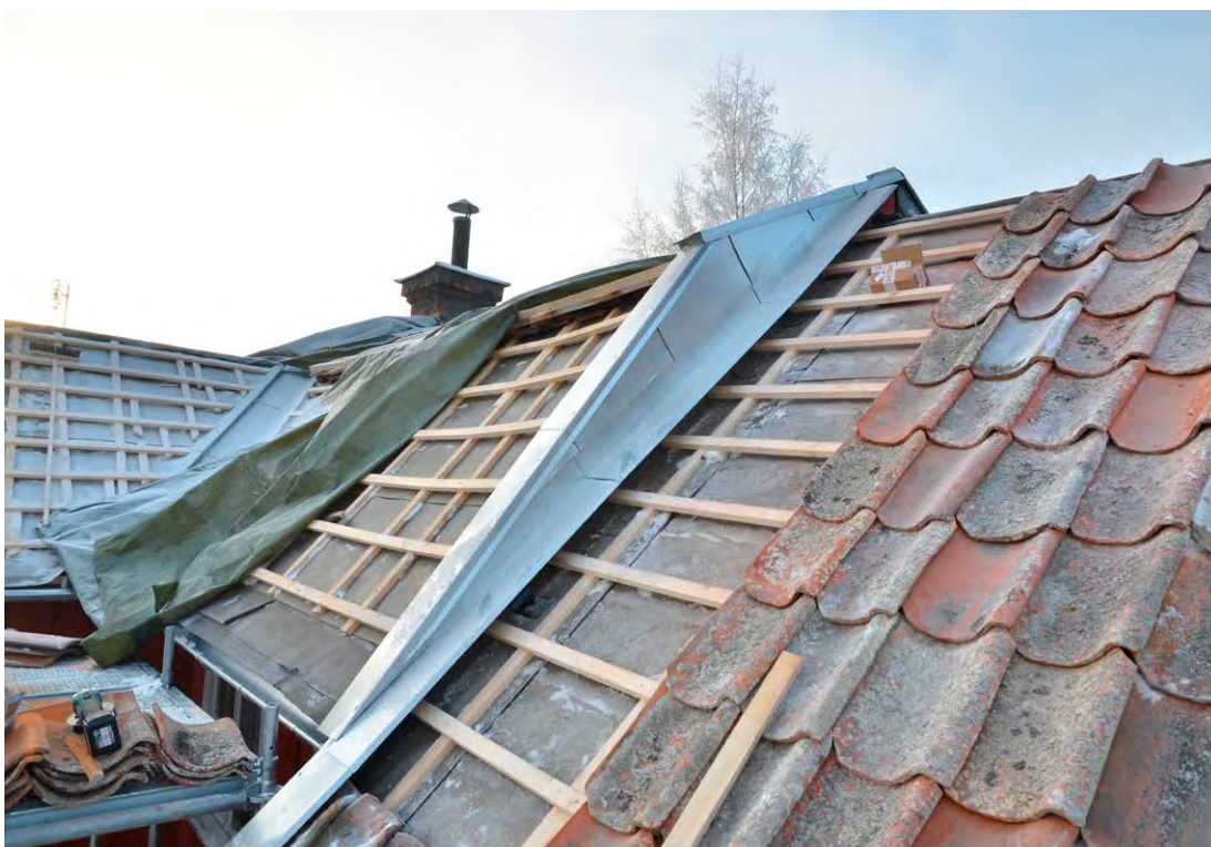
Bild 13. Samma gavelröste, klätt med falsad plåt. Torkladans tak (till höger i bild) har renoverats, återläggning av tegel pågår. Foto 2021-12-07. SLM D2022-0168.
