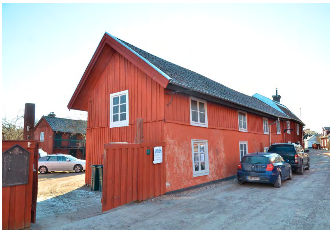
Bild 21. Torkladans västra takfall efter avslutad renovering. Foto 2022-03-04. SLM D2022-0176.
