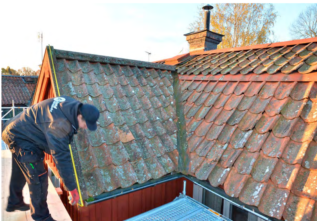
Bild 4. Garvaregårdens nordöstra takfall innan renovering. Foto 2021-10-25. SLM D2022-0159.
