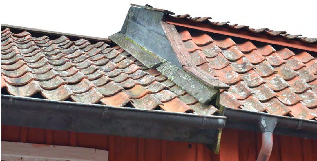
Bild 9. Panelklätt gavelröste mellan garvarebostaden och torkladan, innan renovering (västra takfallet). Foto 2021-10-29. SLM D2022-0164.
