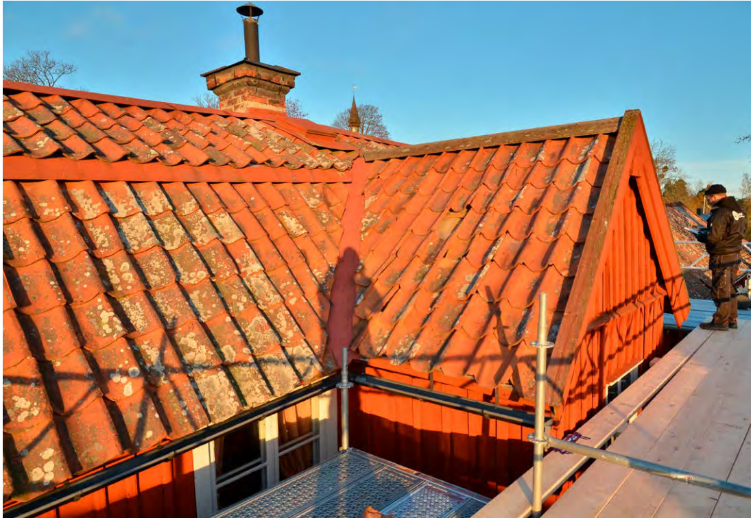
Bild 5. Garvarebostadens sydöstra takfall innan renovering. Foto 2021-10-25. SLM D2022-0160.
