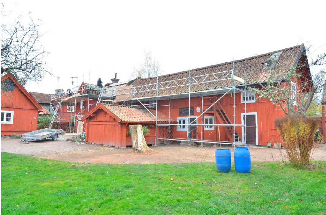
Bild 10. Östra takfallen under pågående renovering, med start vid garvarebostaden. Foto 2021-10-29. SLM D2022-0165.
