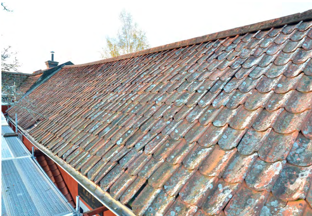
Bild 3. Torkladans östra takfall innan renovering. Foto 2021-10-25. SLM D2022-0158.
