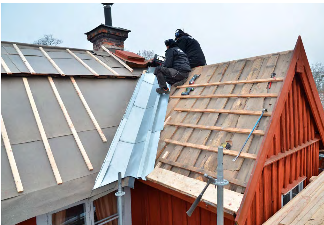
Bild 11. Garvarebostadens nordöstra takfall under pågående renovering och tillverkning av rännal. Foto 2021-10-29. SLM D2022-0166.
