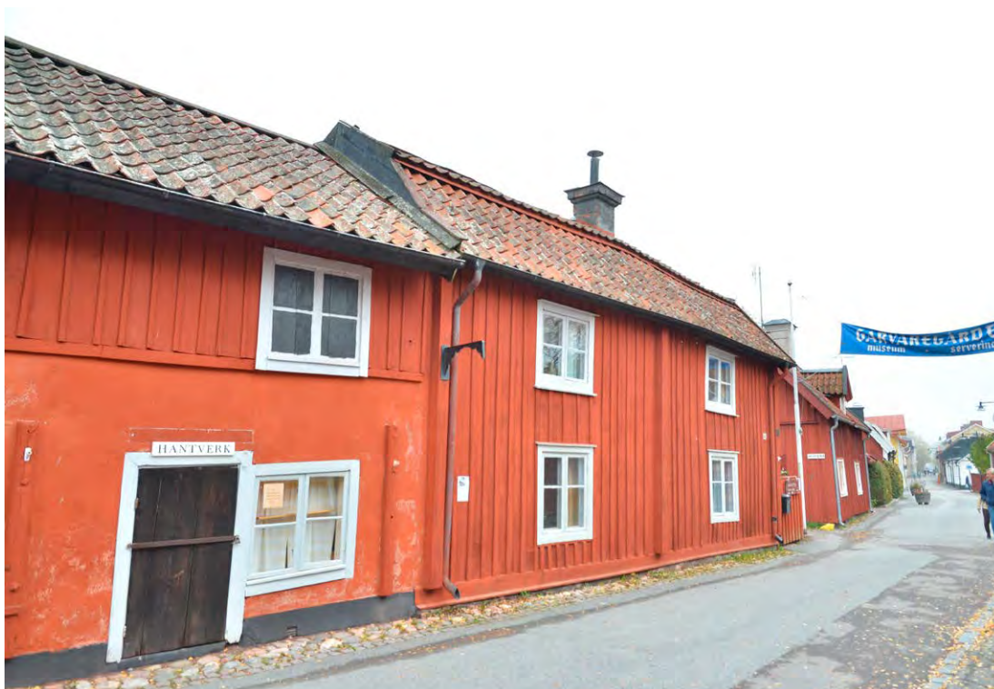
Bild 1. Torkladans och garvarebostadens västra takfall innan renovering. Foto 2021-10-29. SLM D2022-0156.
