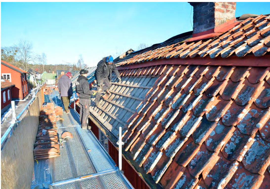
Bild 16. Nedplockning av tegelpannor på garvarebostadens västra takfall. Foto 2022-01-25. SLM D2022-0171.
