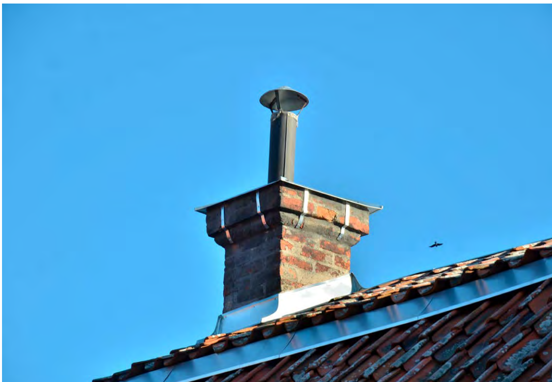
Bild 19. Skorstenen, efter avslutad renovering. Målning med röd linoljefärg återstår dock. Foto 2022-03-04. SLM D2022-0174.
