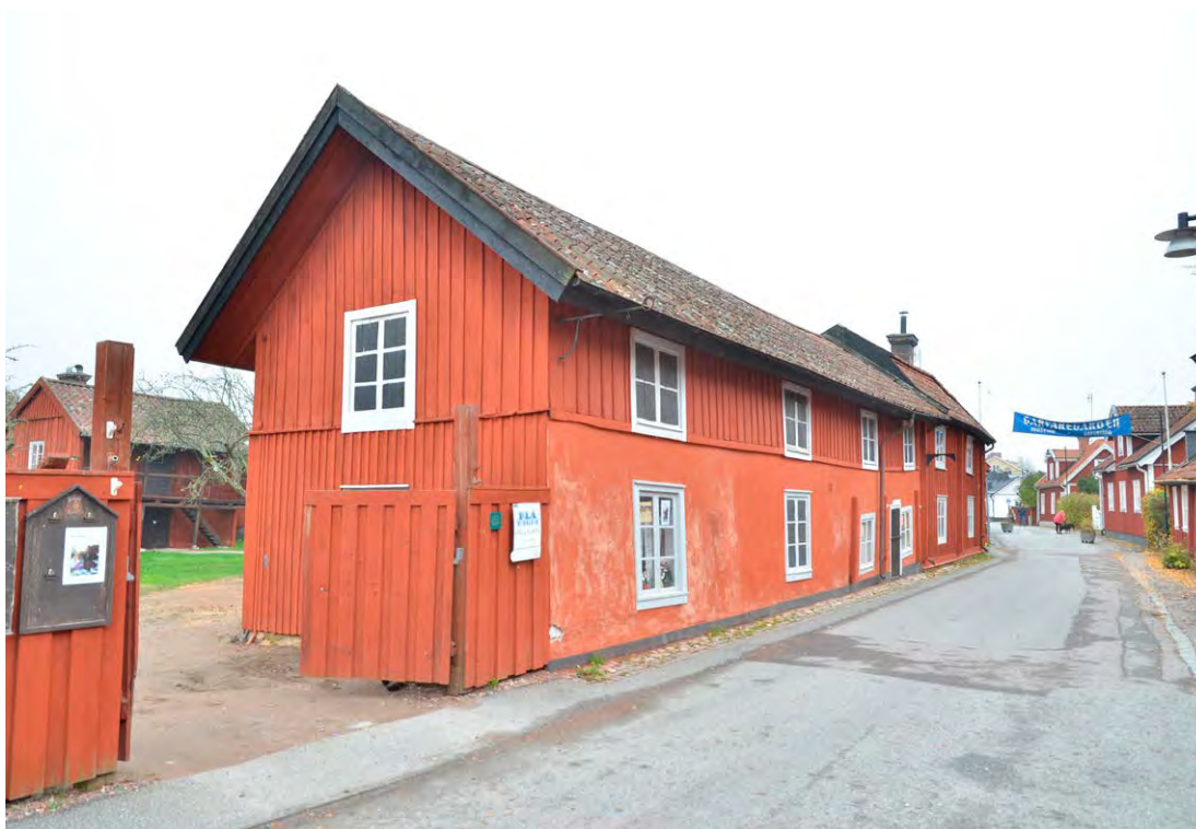
Bild 2. Torkladan innan renovering. Foto 20211029. SLM D2022-0157.
