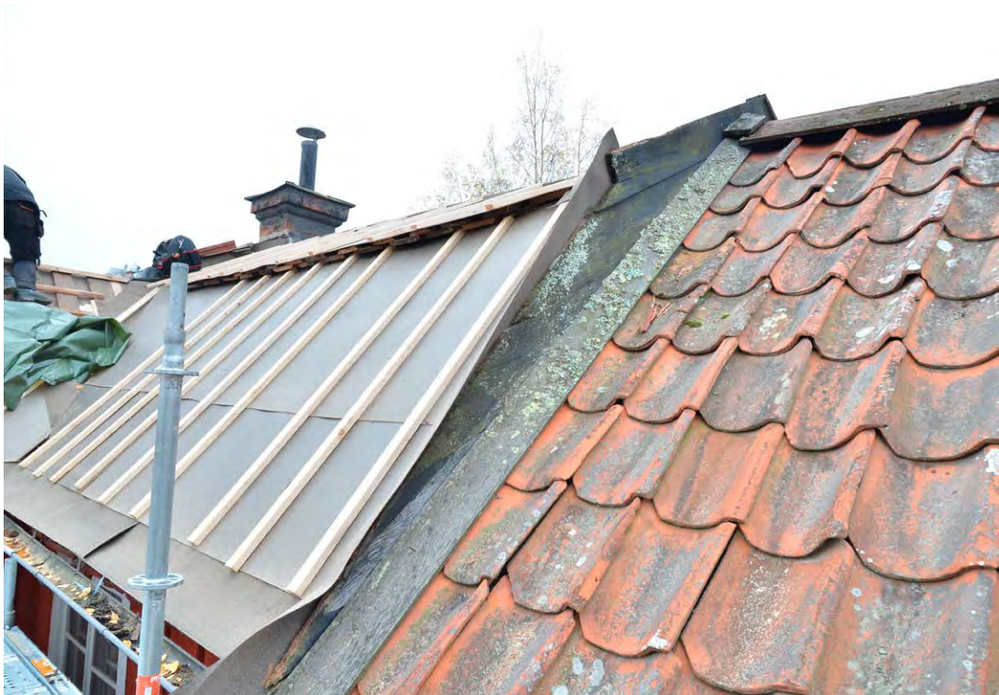
Bild 12. Panelkläda gavelröset vid östra takfallen. Foto 2021-10-29. SLM D2022-0167.
