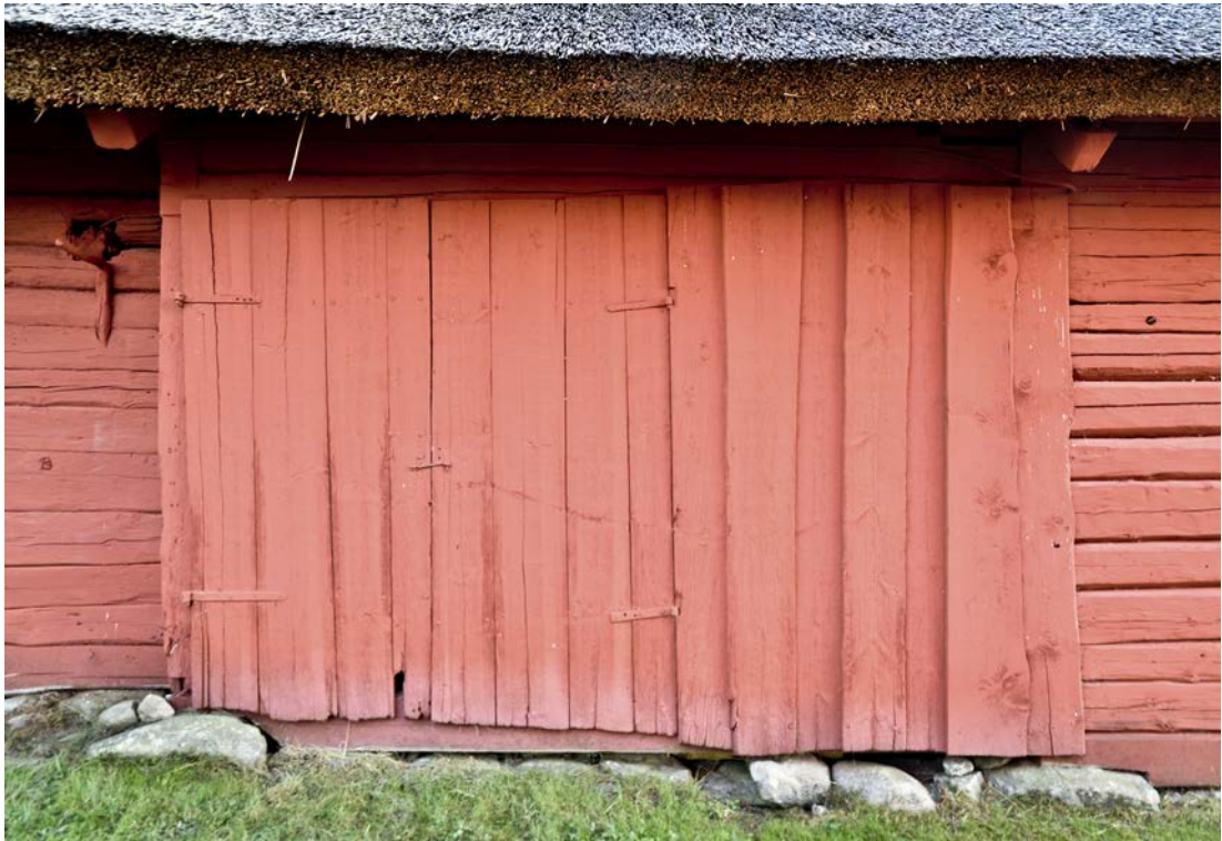
Bild 12. Porten till förrådet. SLM D2021-0590.
