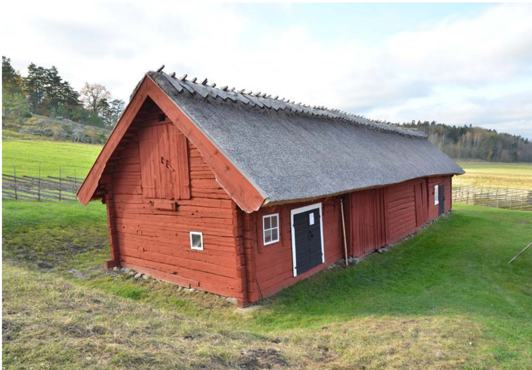
Bild 8. Ladugårdens nordöstra fasader. Oxstallet ligger i gaveln i bildens förgrund. SLM D2021-0588.
