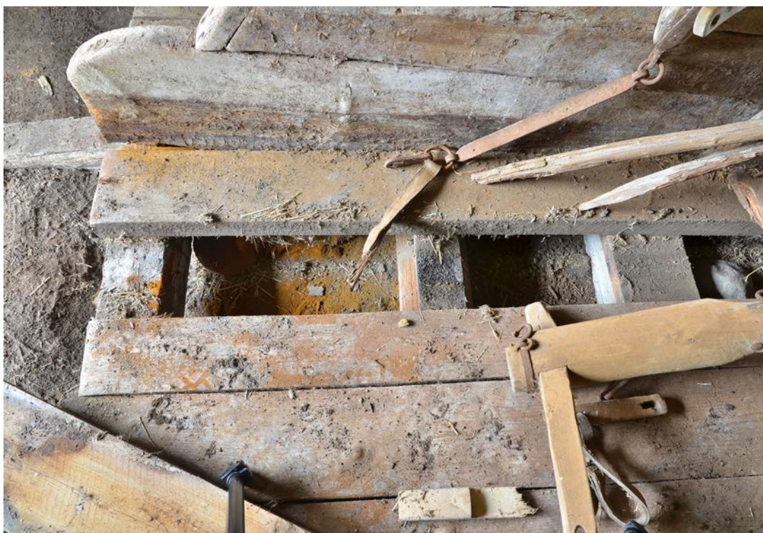
Bild 32. Svampsporer och bjälkar under båsens golvbrädor. SLM D2021-0627.
