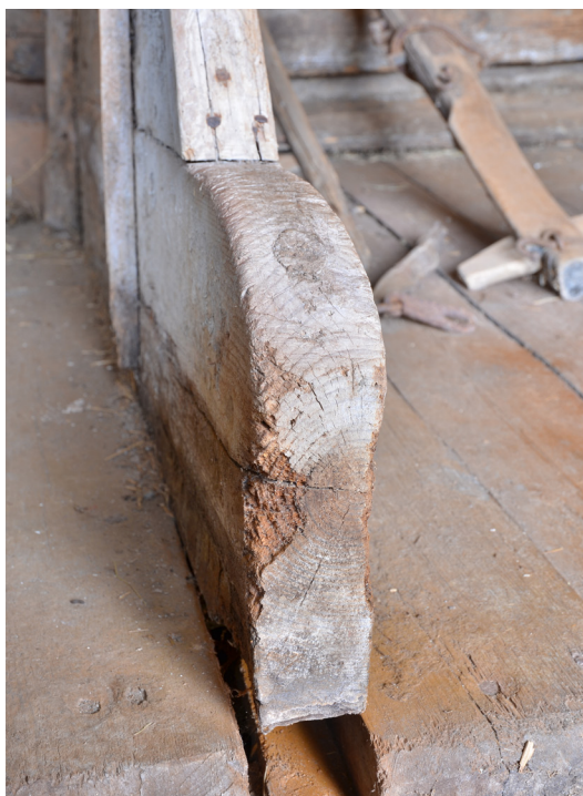
Bild 41. Vänstra båsavskiljarens rundade nedre bräda. SLM D2021-0636.
