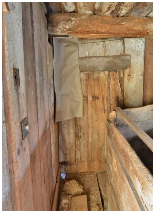
Bild 46. Utrymmet bakom fodertrågen och dörren till förrådet. Vy mot väster. SLM D2021-0641.
