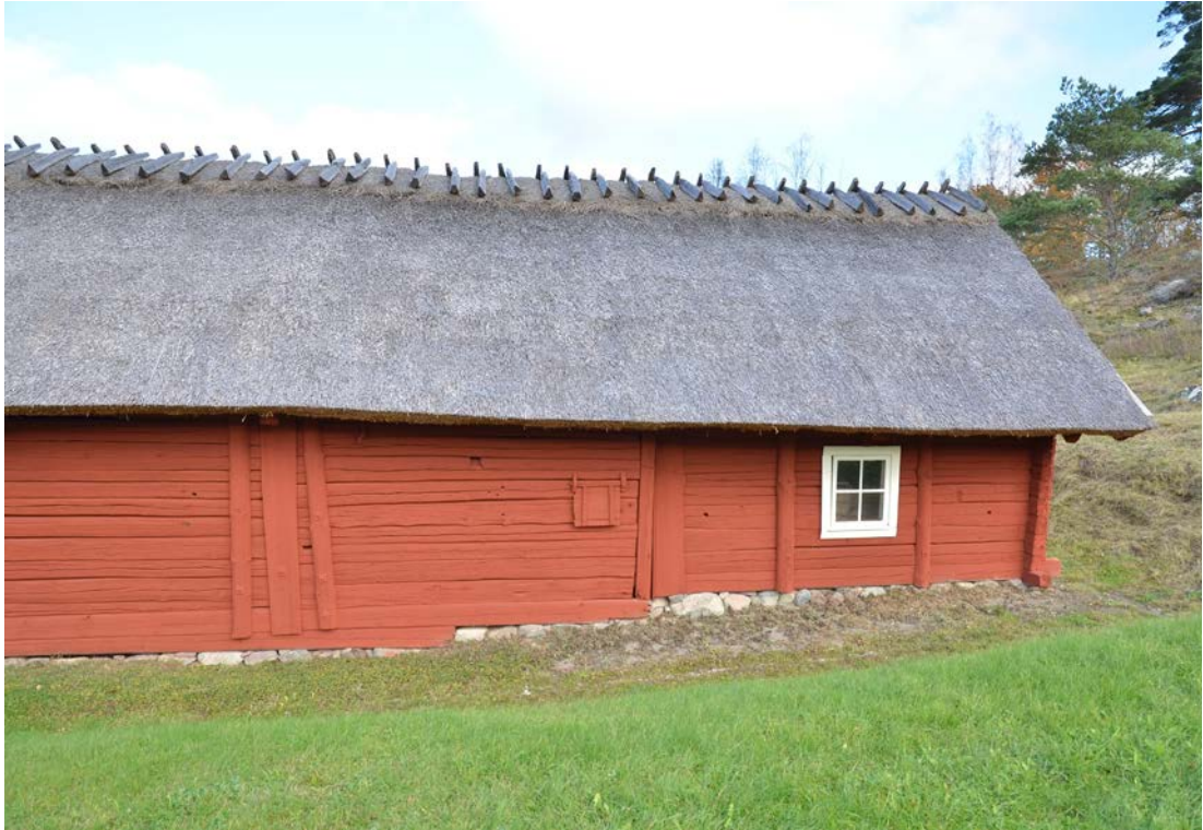
Bild 17. Södra fasadens östra del. SLM D2021-0606.
