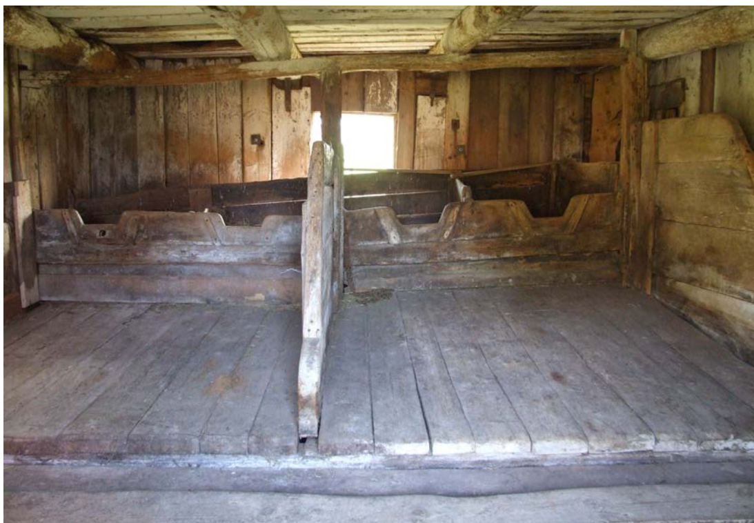
Bild 26. Vid gränsen mellan det främre brädgolvet och båsens golv fanns fram till 2018 en nedsänkning som utgjorde en gödselränna. Eva Wockatz, 2011-07-13. SLM D2021-0613.
