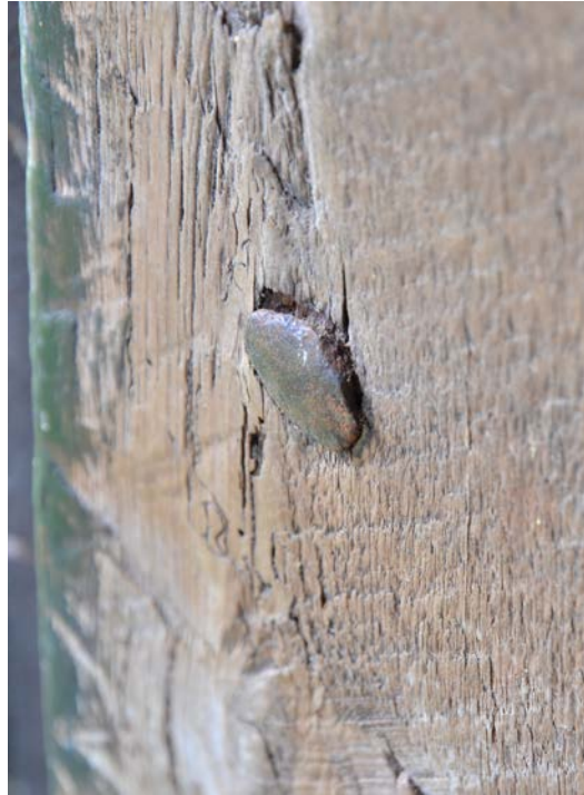
Bild 15. Handsmidd spik i dörrkarmen. SLM D2021-0599.
