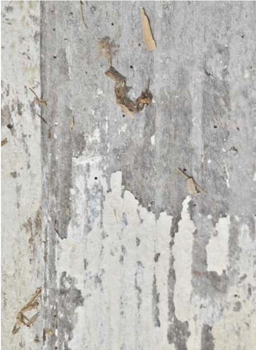
Bild 23. Kalkfärgsstruken väggpanel. SLM D2021-0620.
