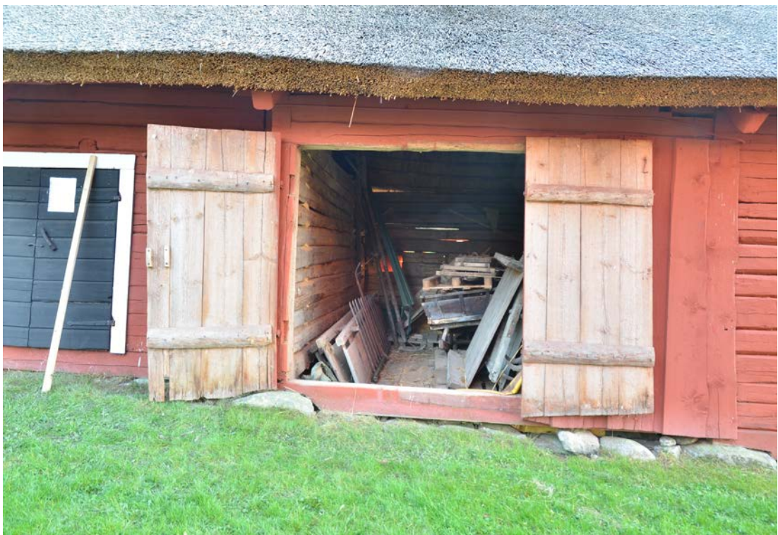
Bild 13. Utsidan av portarna till förrådet. SLM D2021-0591.
