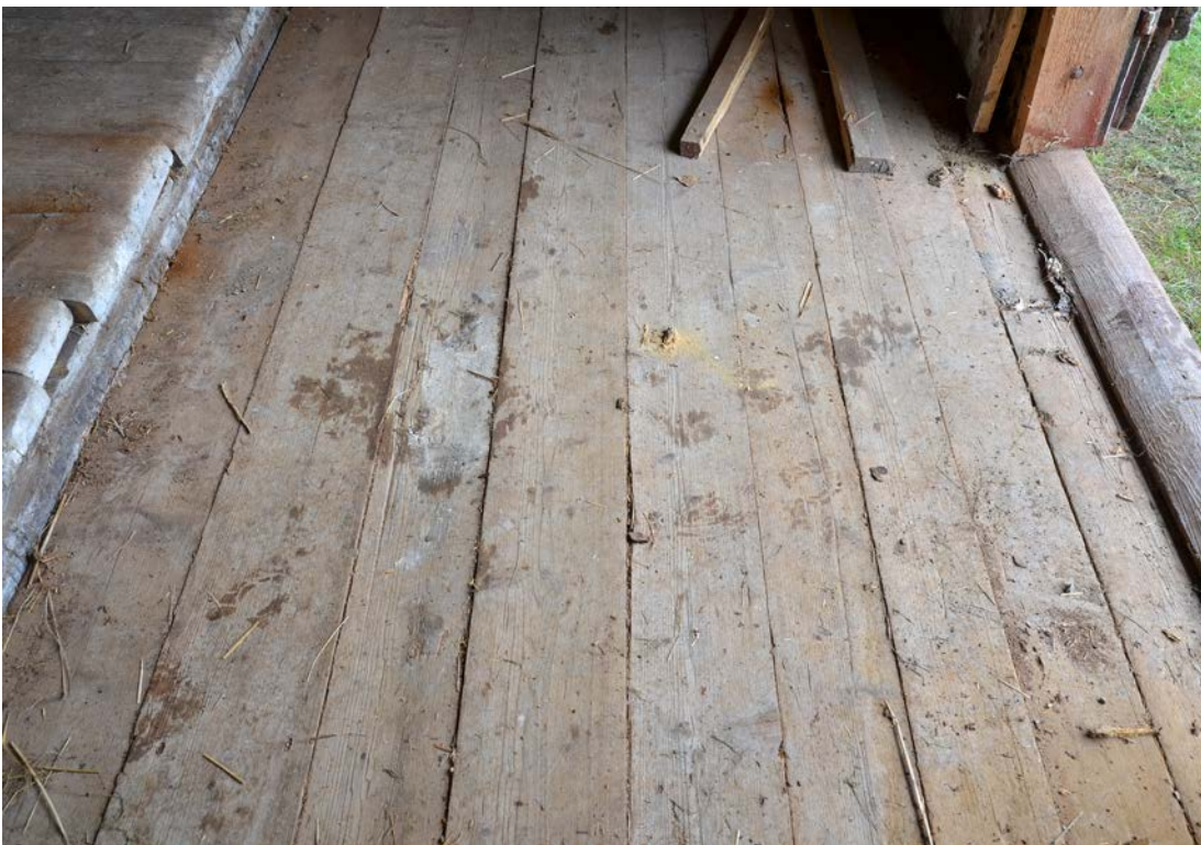
Bild 25. Mitten av det "främre" brädgolv. Jämfört med tidigare (se bild 27) ligger golvbrädorna sedan 2018 relativt tätt, vilket kan ha medfört en sämre luftväxling och därmed bidragit till hussvampens tillväxt. SLM D2021-0622.
