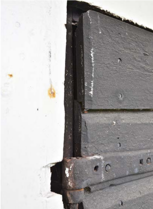
Bild 14. Gångjärn på portarna till oxstallet. SLM D2021-0598.
