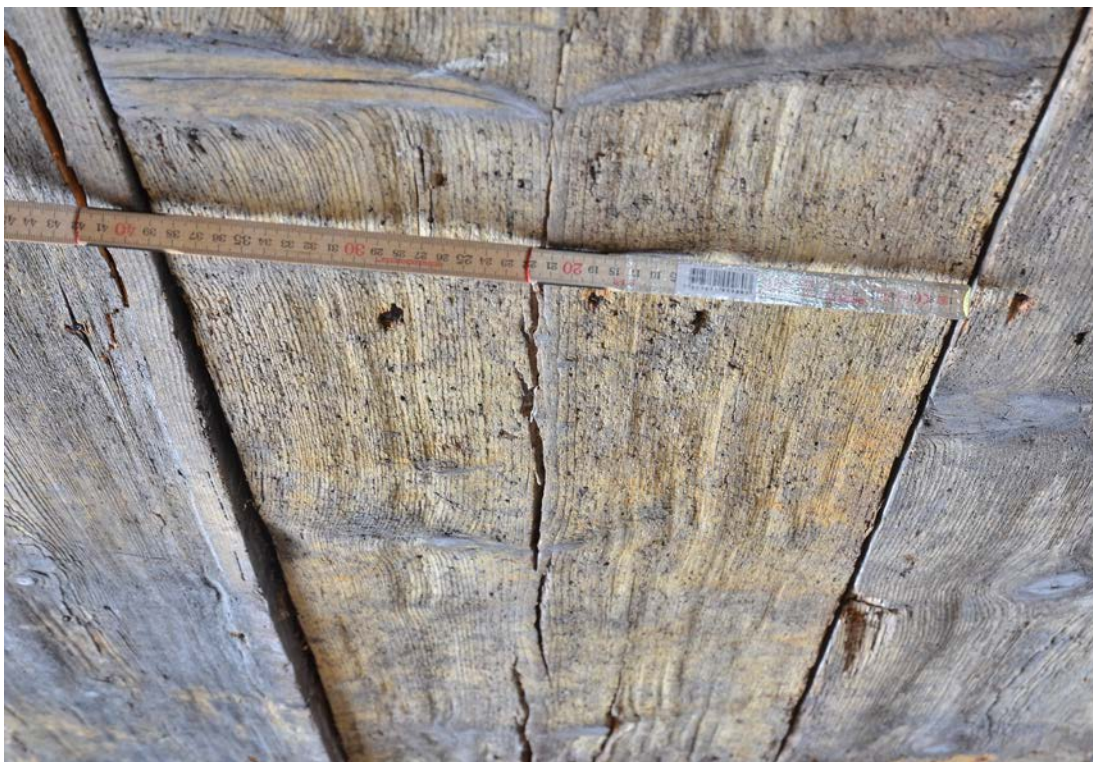
Bild 15. En av de bredaste brädorna i taket, som också har tydliga "bubblor" i ytskiktet (jämför med bild 20). SLM D2021-0278.
