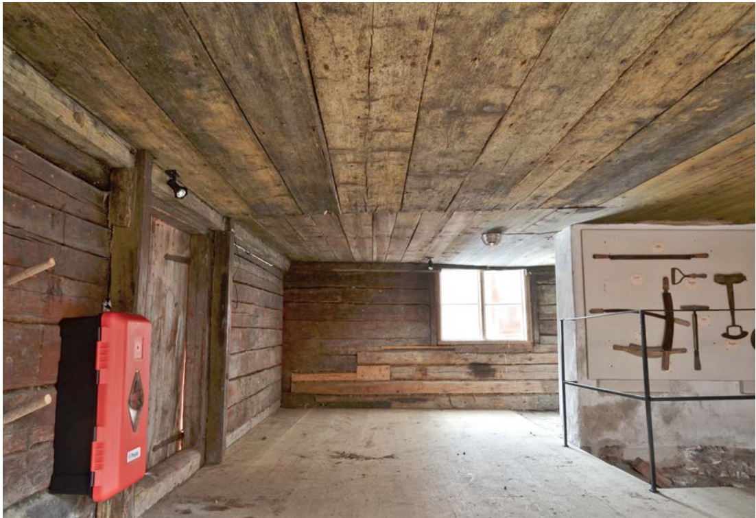
Bild 3. Garveriets bottenvåning, vy mot norr. SLM D2021-0268.
