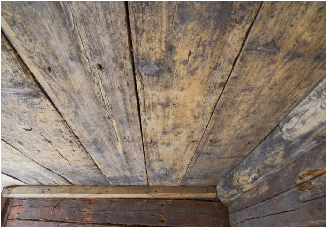
Bild 14. Bräddtak i bottenvåningens sydvästra hörn, vy mot söder. SLM D2021-0277.
