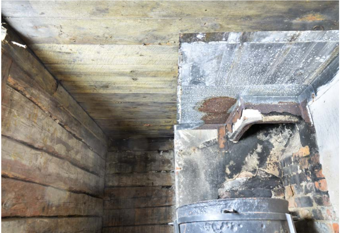
Bild 8. Bottenvåningens nordvästra hörn vars tak utgörs av klingsågade brädor. SLM D2021-0271.
