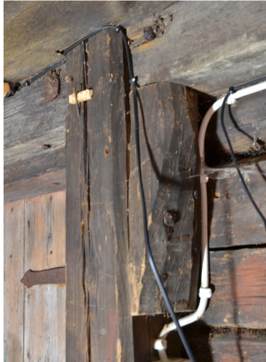
Bild 11. Stolpe vid entréns norra sida, som försetts med bärande konsol som dymlats fast. Motsatta (södra) stolpen ser ut på samma sätt. SLM D2021-0274.
