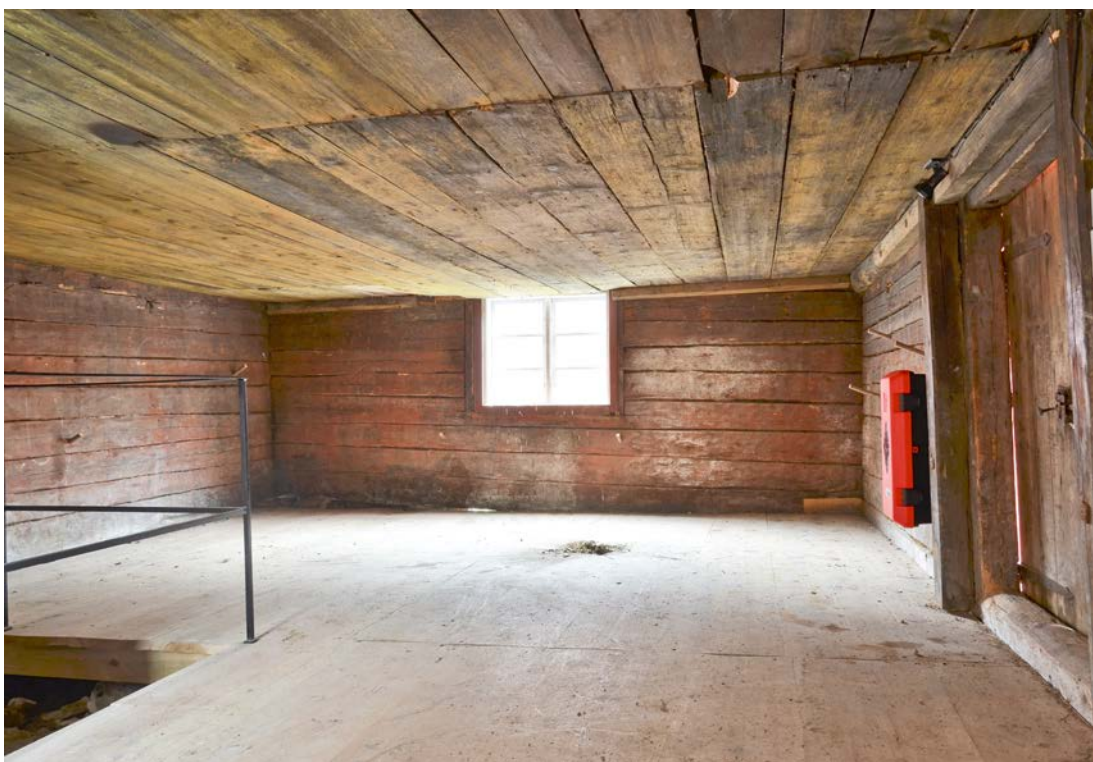
Bild 13. Bottenvåningens södra del, vy mot söder. I rummets sydvästra del (mellan entrén och fönstret) finns det äldre brädtaket med breda grova brädor, som kan ha använts som brädgolv. SLM D2021-0276.
