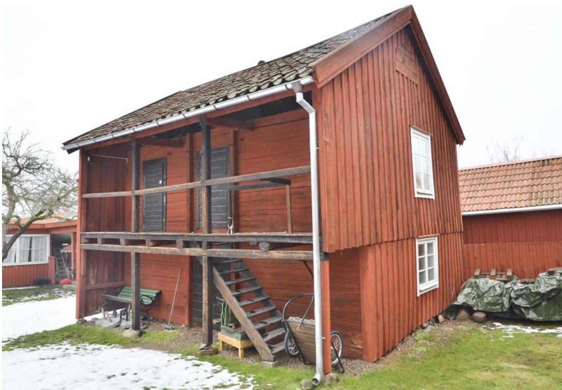
Bild 2. Garveriets sydvästra fasader. SLM D2021-0267.
