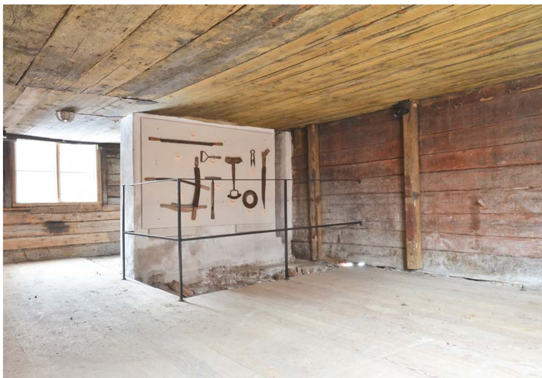
Bild 16. Bottenvåningens sydöstra del, mellan murstocken och södra gaveln. Vy mot nordöst. SLM D2021-0279.
