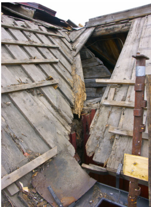
Bild 8. Garvarebostaden under renoveringen 2005. Foto: Eva Wockatz, Sörmlands museum, 2005-09-08. SLM D2021-0246.
