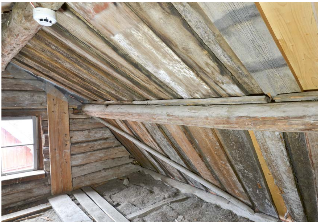
Bild 15. Garvarebostadens vind under södra delen av taket, vy mot söder. Notera bjälklaget som är isolerat med bitar av torv. SLM D2021-0253.
