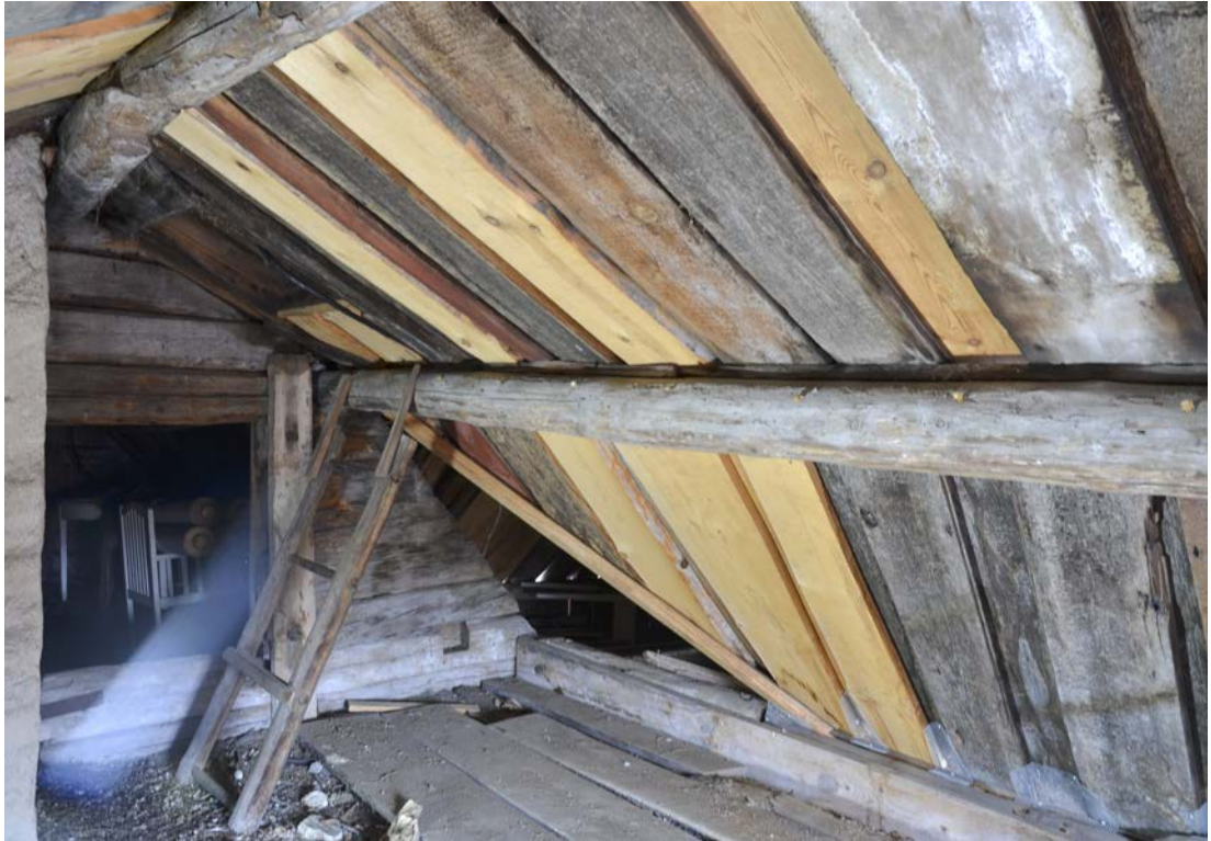
Bild 14. Garvarebostadens vind under södra delen av taket, vy mot norr. SLM D2021-0252.
