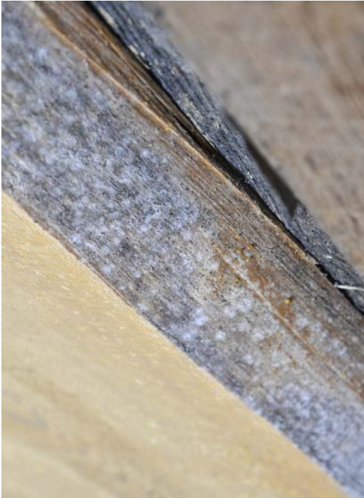
Bild 16. Närbild på en av brädorna som nytillverkades 2005, med vita mögelprickar på sidorna. SLM D2021-0254.
