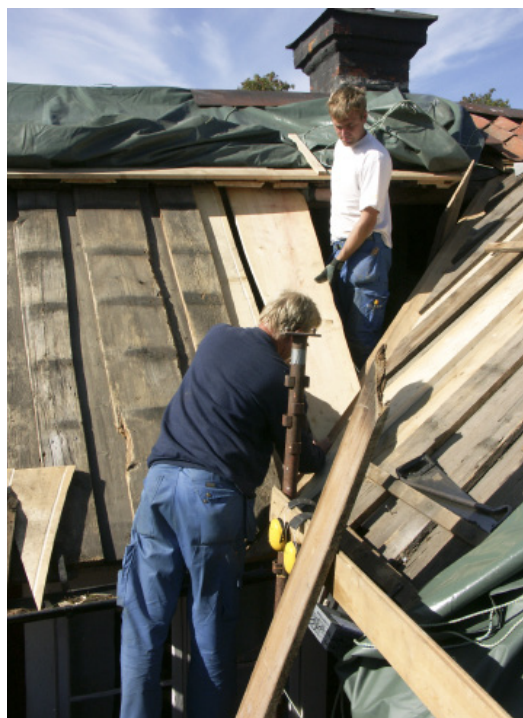
Bild 9. Underlagstaket renoveras. Foto: Eva Wockatz, Sörmlands museum, 2005-09-16. SLM D2021-0247.
