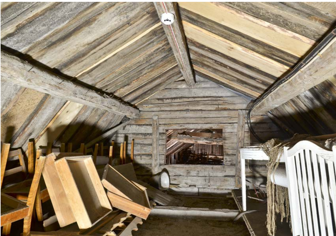
Bild 18. Garvarebostadens vind (norra delen av byggnaden), vy mot norr. Genom hålet mitt i timmerväggen på gaveln syns insidan av torkladan. SLM D2021-0256.
