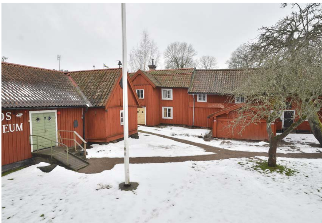
Bild 2. Garvaregårdens innergård, vy mot väster. Garvarebostaden (med gula entrédörrar) och torkladan intill syns längst bak i bilden. SLM D2021-0242.
