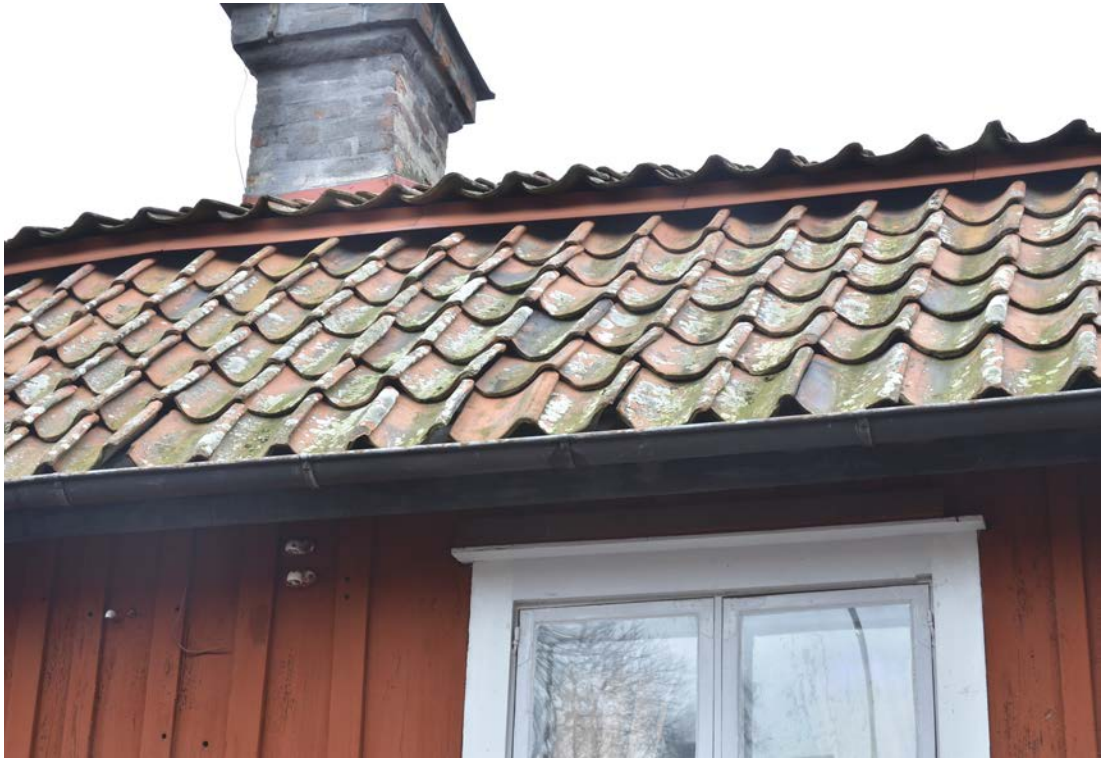
Bild 12. Garvarebostadens västra takfall. SLM D2021-0250.
