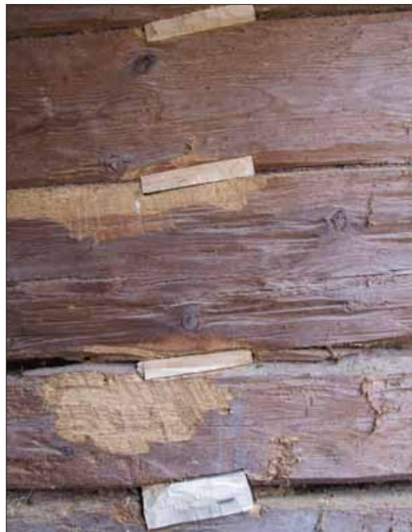
13 Detalj av klossarna som placerades mellan timmervarven (Slm D13-0055).
