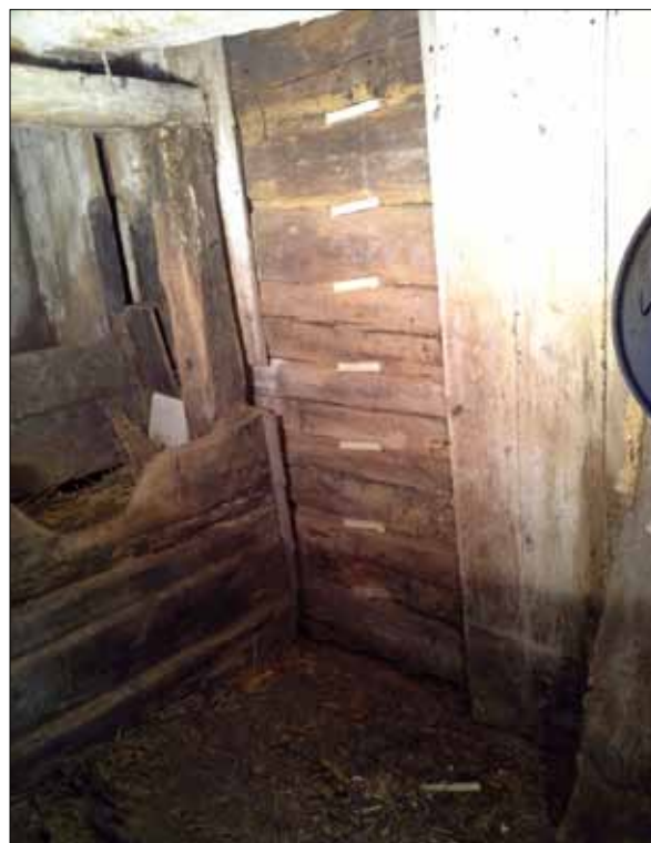
15 Vy av västra väggen efter montering av klossar. Fotografi inlänat av Emanuel Jakobsson, Historiskt trähantverk.
