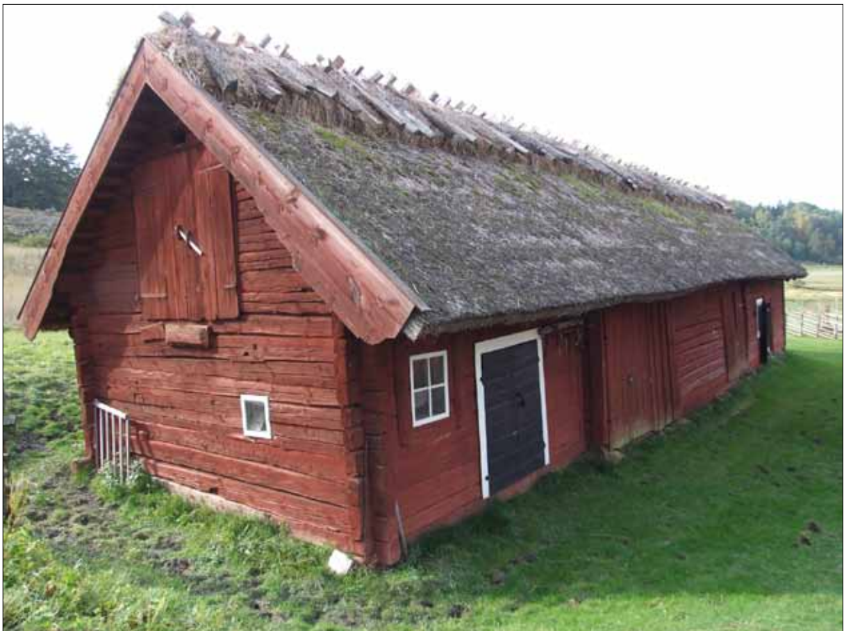
2 Ladugården sedd från nordost i september 2011, då ryggningen just har förnyats. Detta arbete ingick i etapp 1 (Slm D13-0050).
