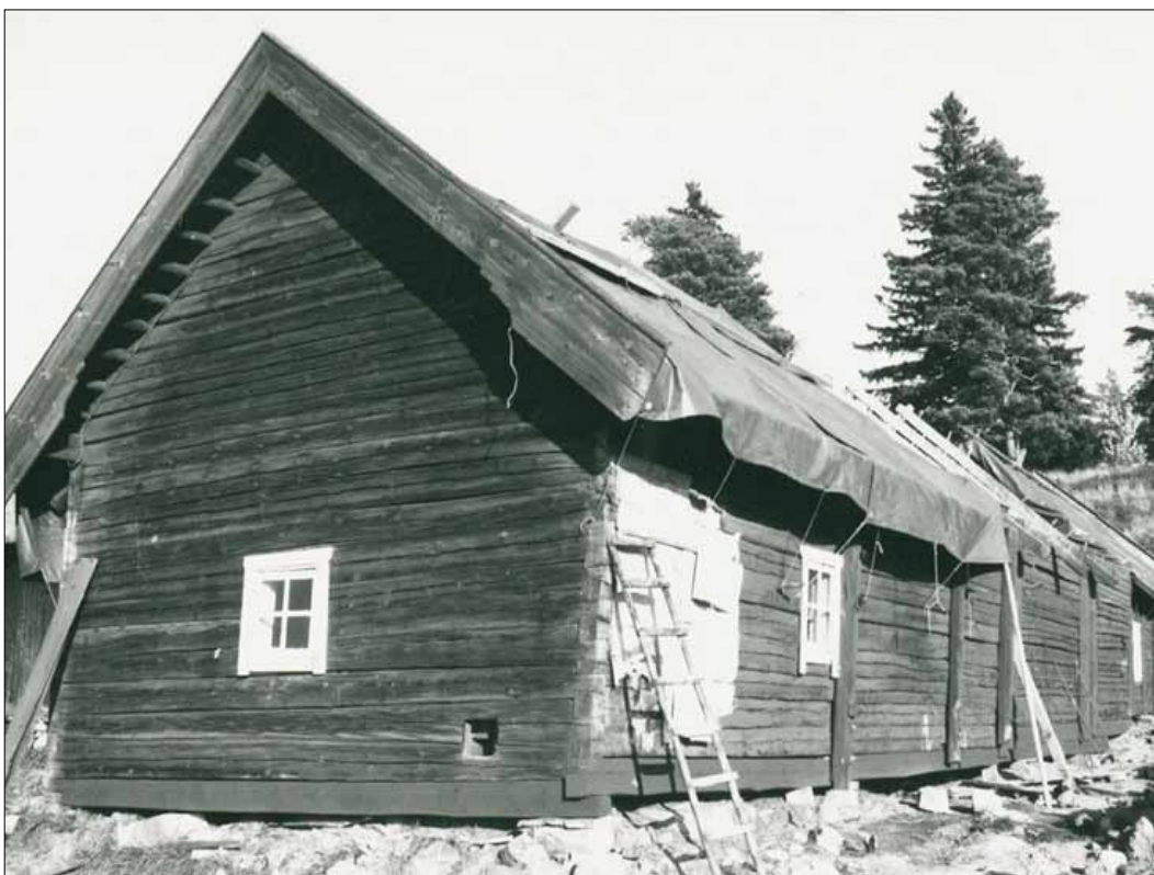
6 Ladugården renoveras 1986. Syllen har bytts utmed hela södra och västra sidan. Södra väggen har riktats och förstärkts med vissa följare. Vasstaket kommer att läggas om. Dasset är undanflyttat (Slm S35/86-34).
