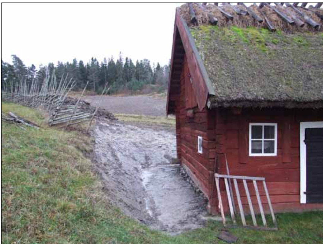
18 Vy av östra gaveln när jordlager schaktats bort och marken har bearbetats (Slm D13-0059).
