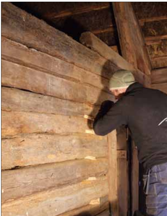
12 Klossar monterades i väggarna för att motverka byggnadens lutning. Hål borrades och bearbetades av Emanuel Jakobsson (Slm D13-0054).
