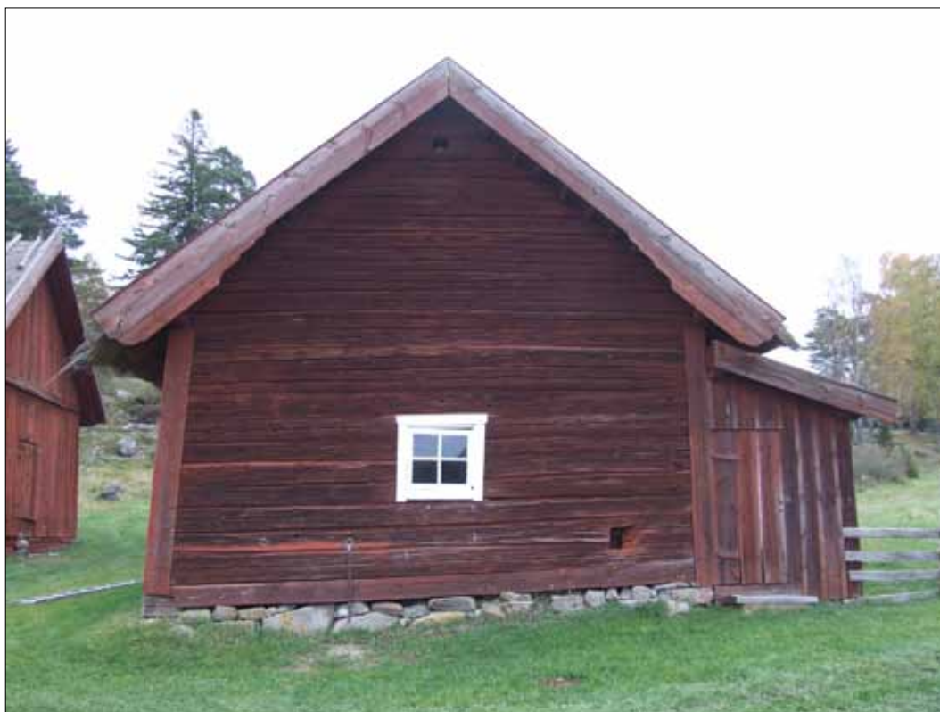
9 Vy av västra gaveln där lutningen mot söder syns tydligt. Bilden tagen 2010 (Slm D13-0052).
