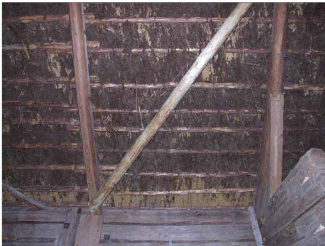
11 Snedsträvor monterades nu i förrådsdelens taklag (Slm D13-0053).
