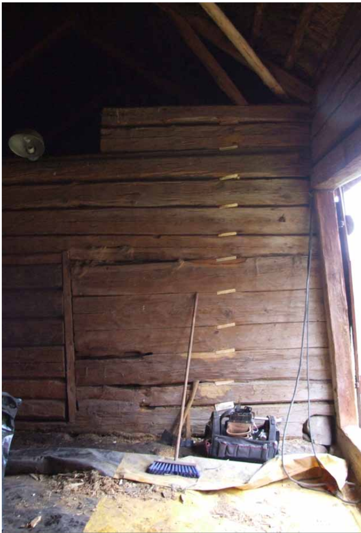
19 Vy av timmerväggen mellan stora förrådet och ladugården vid slutbesiktningen i november 2012 (Slm D13-0060).
