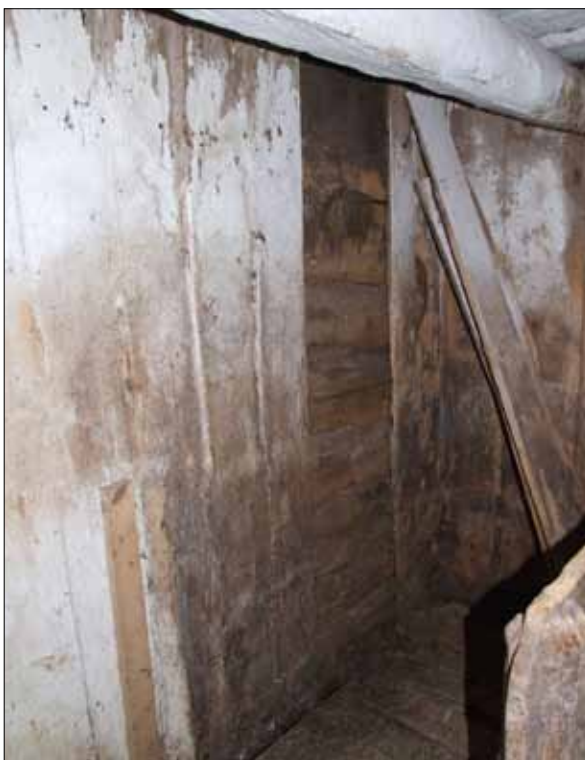
14 Invändiga panelbrädor lyftes bort på västra gaveln, för att kunna montera klossar i timmerväggen (Slm D13-0056).
