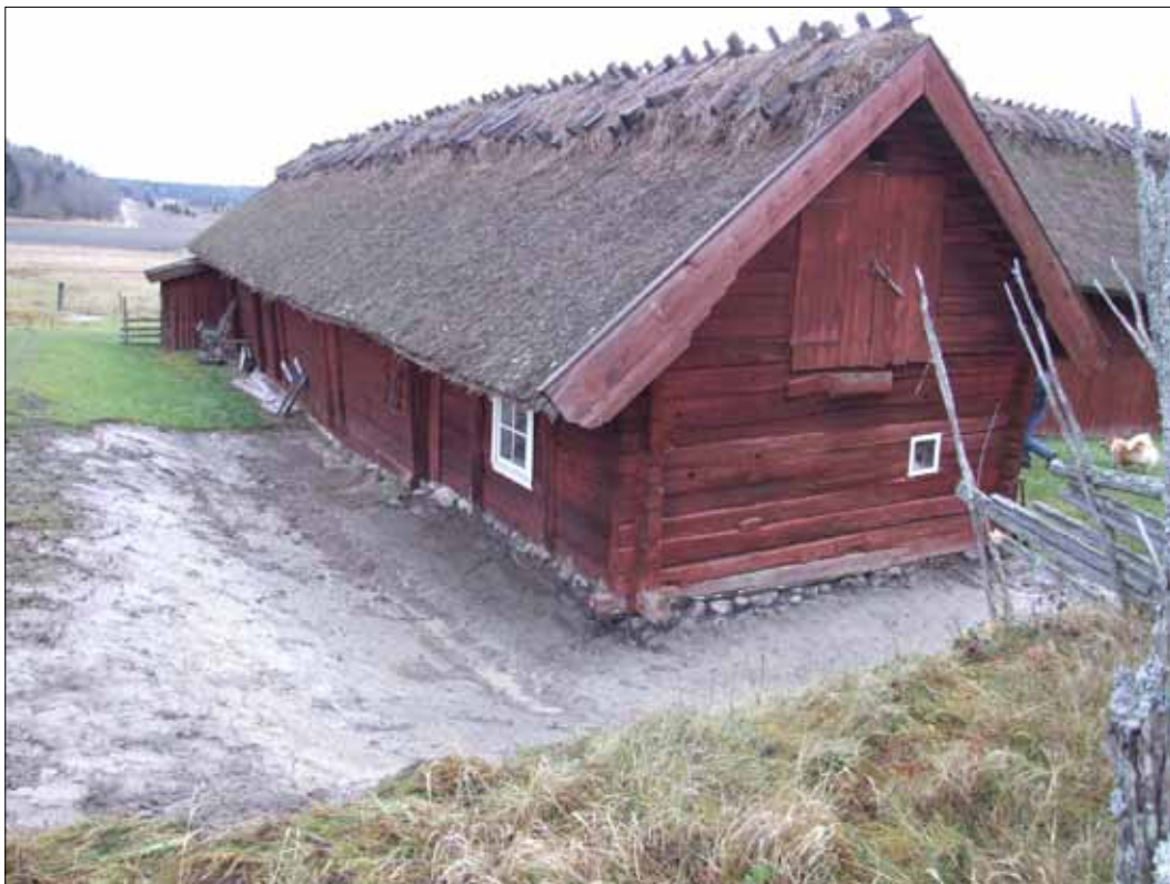
17 Ladugården sedd från sydost vid slutbesiktningen. Marknivån har sänkts och marken har släntats (Slm D13-0058).
