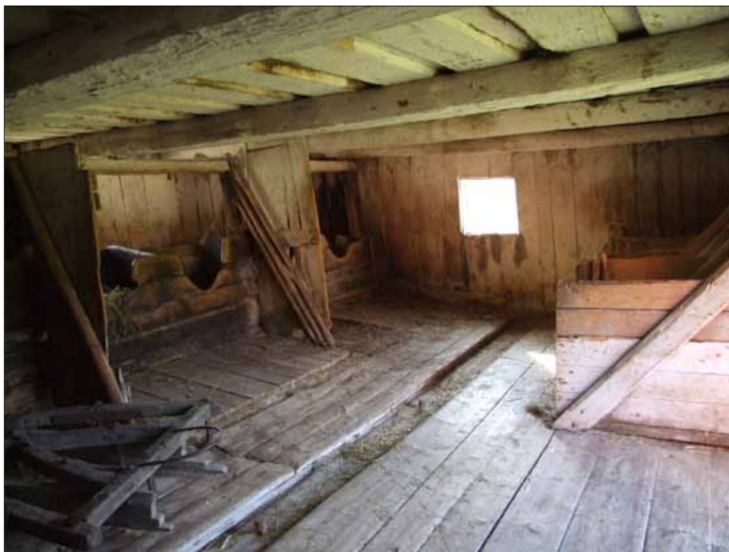
16 Vy av ladugården sedd mot sydväst 2011. Västra gaveln är på insidan klädd med slåta brädor (Slm D13-0057).
