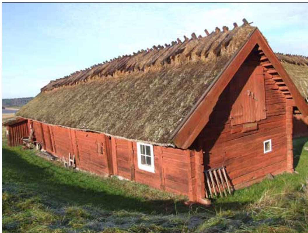
7 Ladugården sedd från sydost före arbeten 2012. Marknivån är för hög och byggnaden lutar mot söder (Slm D13-0051).
