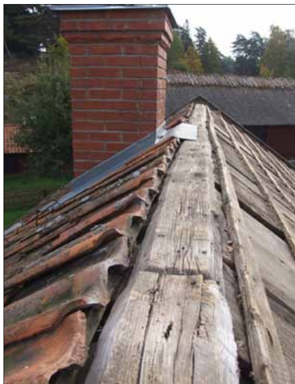
6 Nockbrädan var av äldre modell. Oljehärdad masonit lades på brädan, som täcktes med tegelpannor (Slm D11-783).
