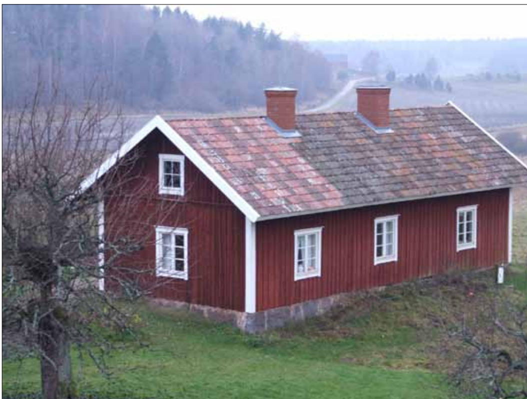
10 Bostadshuset sett från öster efter takomläggningen. Det ljusare teglet närmast i bild fanns i ett förråd på gården (Slm D11-786).
