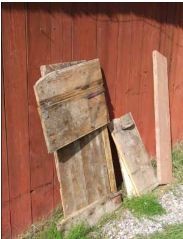
15 Den äldre dörren mellan "farstun" och jordkällaren ställdes undan. Dörren var sammansatt av äldre brädor och lades nu i trösklogen (Slm D11-791).
