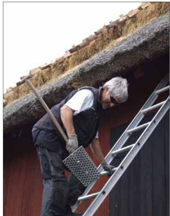
12 Nedkanad vass klappas upp på plats. I bild Jan Andersson, Norrbygårdens snickeri och hantverk (Slm D11-788).
