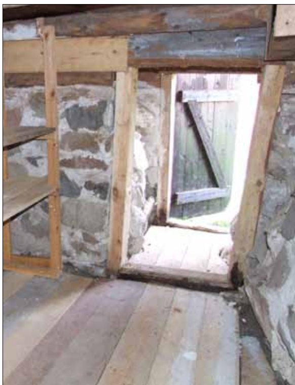
14 Både "farstuns" och jordkällarens golv byttes ut (Slm D11-790).
