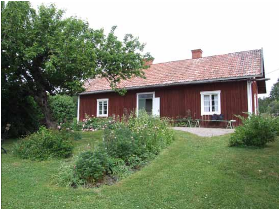
2 Bostadshuset sett från söder innan takomläggningen (Slm D11-781).
