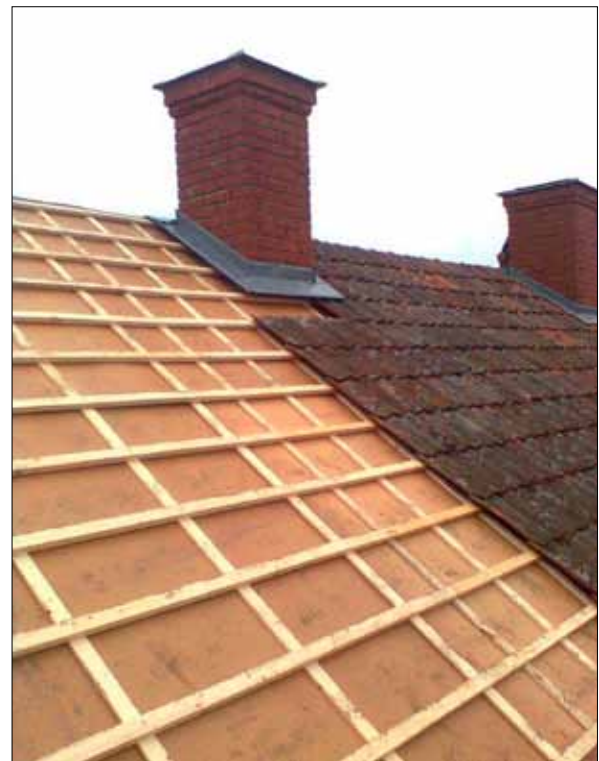
8 Oljehärdad masoinit lades på underlagstaket. Fotografi inlänat av Örjan Karlsson, Sörmlands Naturbruk.
