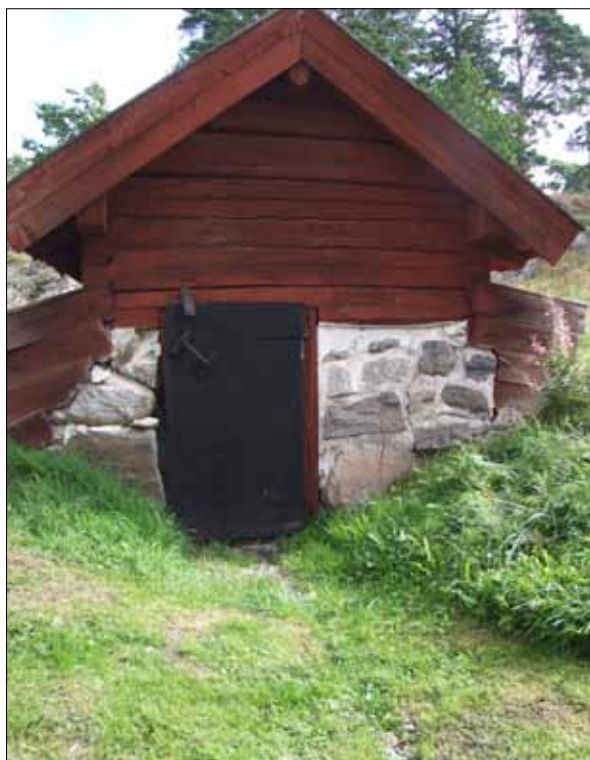
13 Jordkällaren sedd från väster efter det att dräneringsledning har lagts ned (Slm D11-789).
