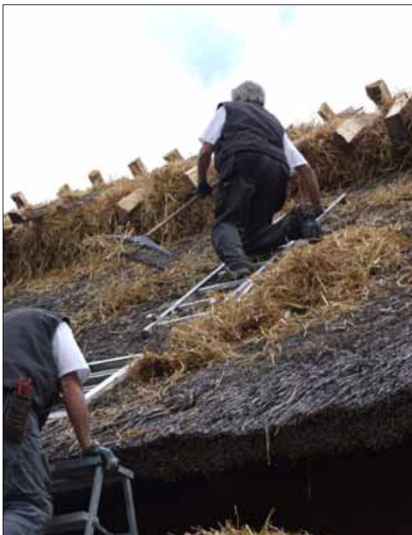
11 Den nya ryggningen av råghalm justeras på trösklogen (Slm D11-787).
