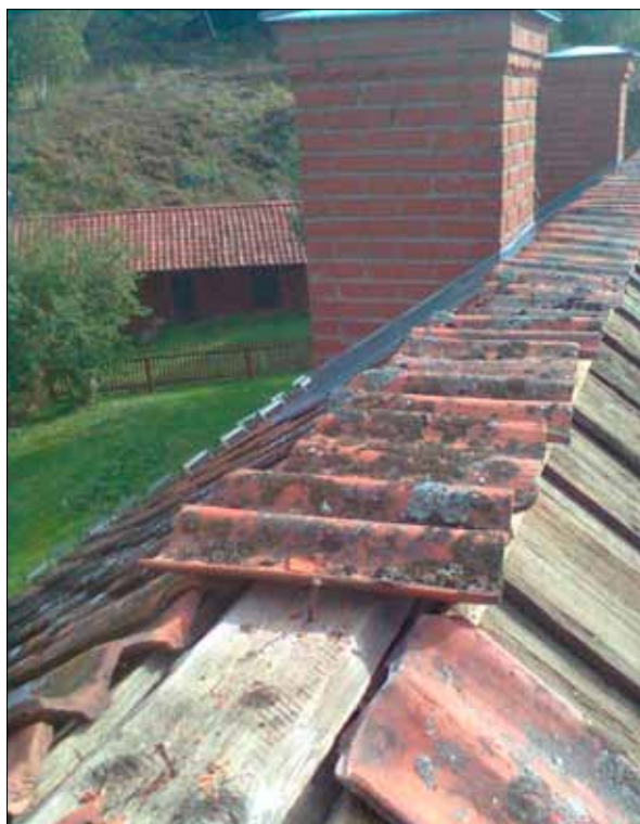
5 På bostadshusets nock var vanliga tegelpannor fastspikade. Fotografii inlänat av Örjan Karlsson, Sörmlands Naturbruk.
