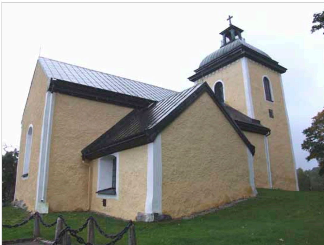
19 Kyrkan sedd från sydost vid slutbesiktningen den 16 september 2010. (D10-864)
