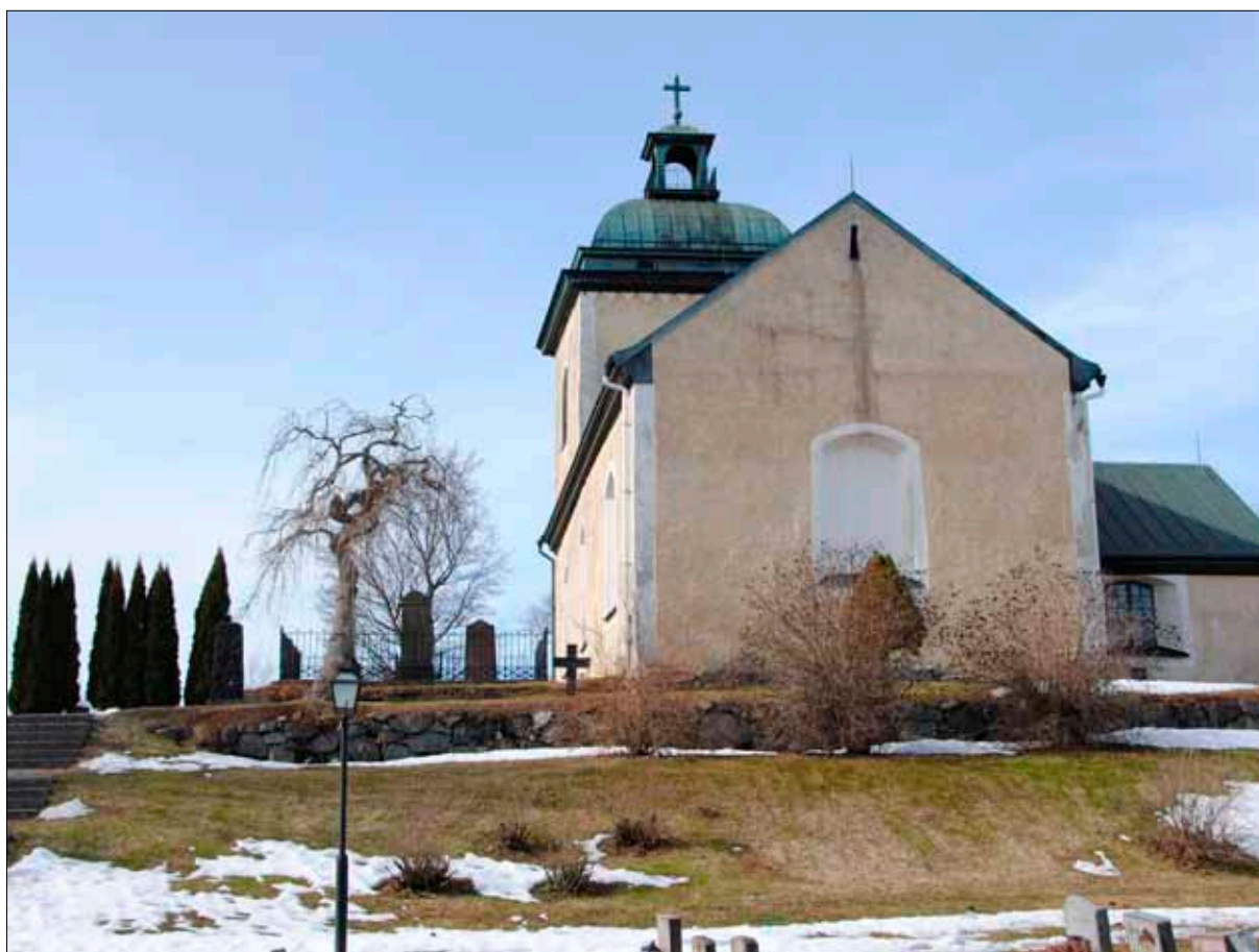
3 Vy från öster före renoveringen. (D10-868)
