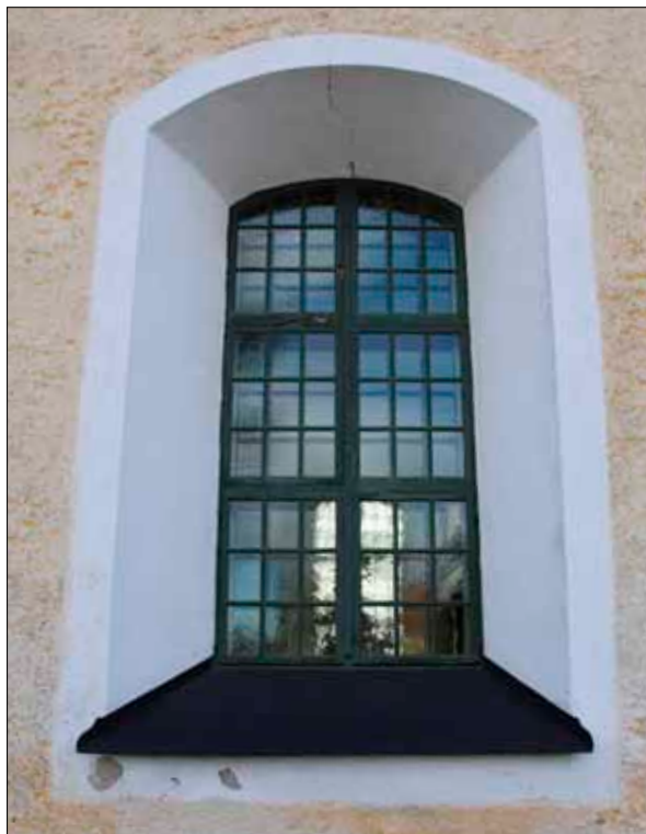
5 Fönsterbågarna var tidigare målade i mörk grönt. Sprickor förekom i valvbågens mitt (Slm D10-869).
