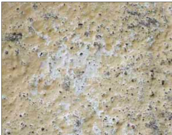
6 De två senaste kalkavfärgningarna var gula, under var det en vit strykning. Stenarna i spritputsen är relativt skarpa och vassa. (Slm D10-858).
