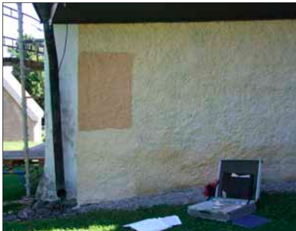
8 Två uppstrykningsprover gjordes till byggmöte 2. Den undre strykningen är kulören 94:5, den övre en blandning med obränd terra (Slm D10-854).
