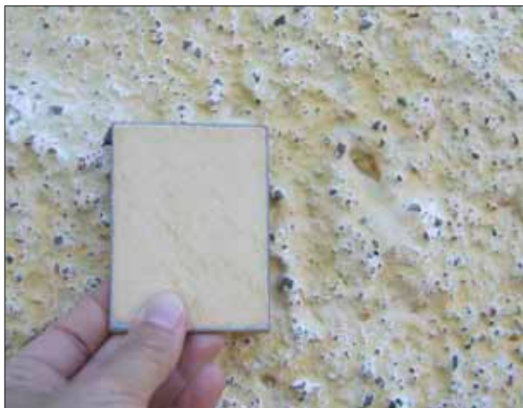
7 Yttersta lagret liknade kulören 94:5, dvs 2100 gr guldocker till 25 kg kalkpasta. (D10-856)
