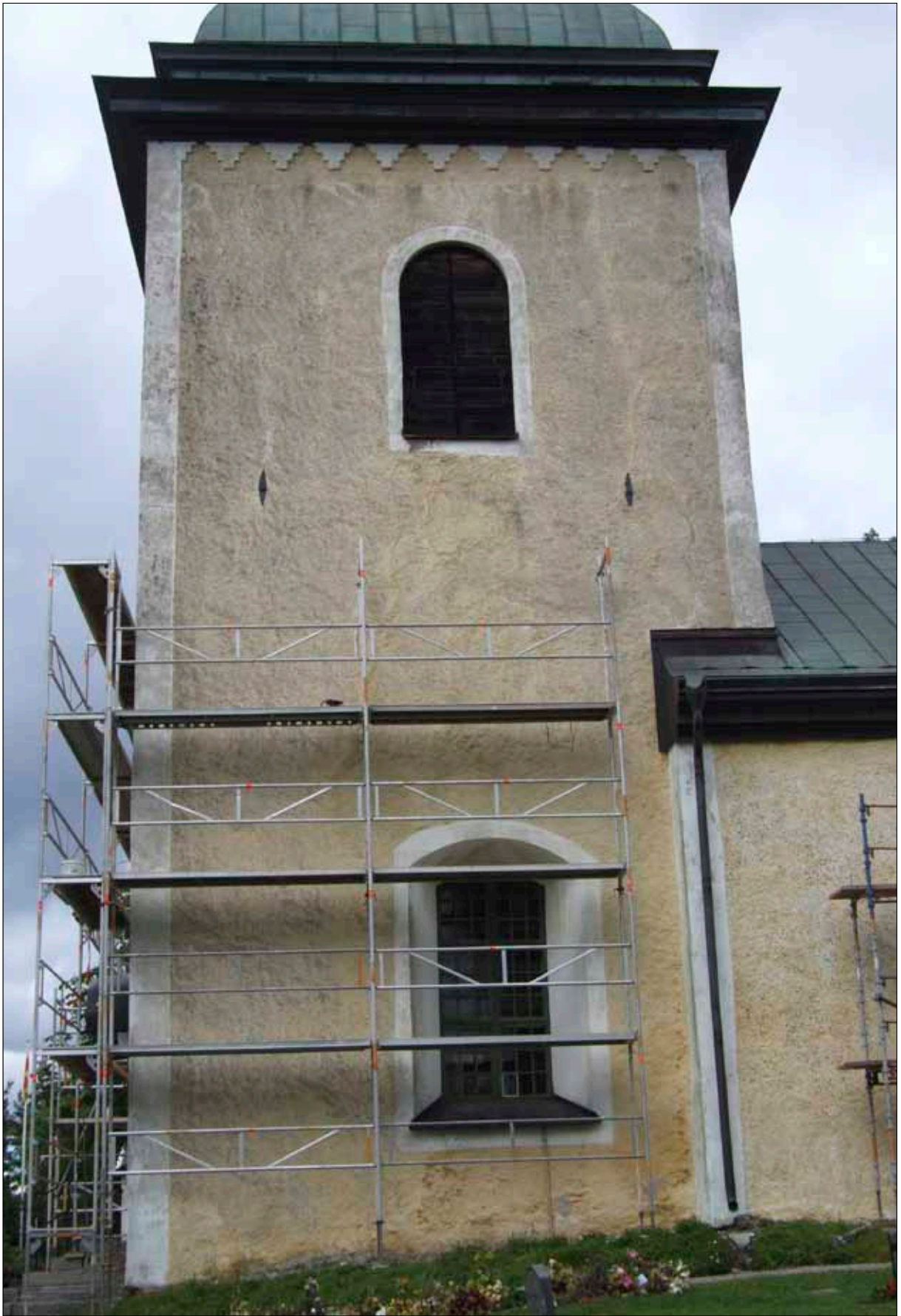
14 Tornets södra fasad före renoveringen, där sprickor förekom, främst på tornets övre del. (D10-849)
