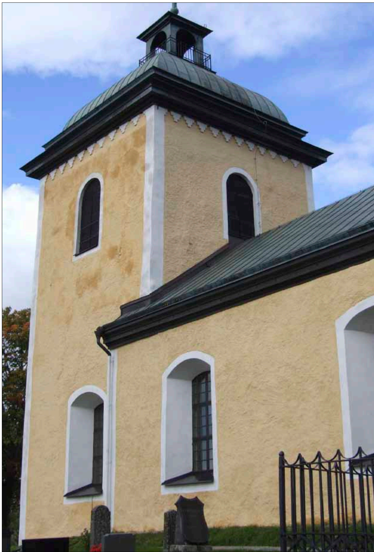
24 Vagnhärads kyrka vid slutbesiktningen sedd från sydost. (D10-860)
