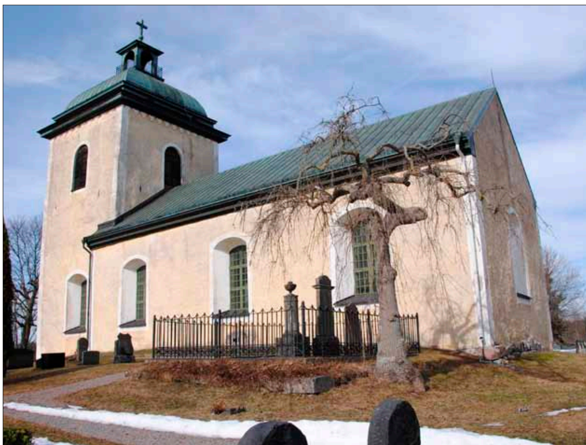
2 Vagnhärads kyrka före renoveringen sett från sydost. (D10-867)
