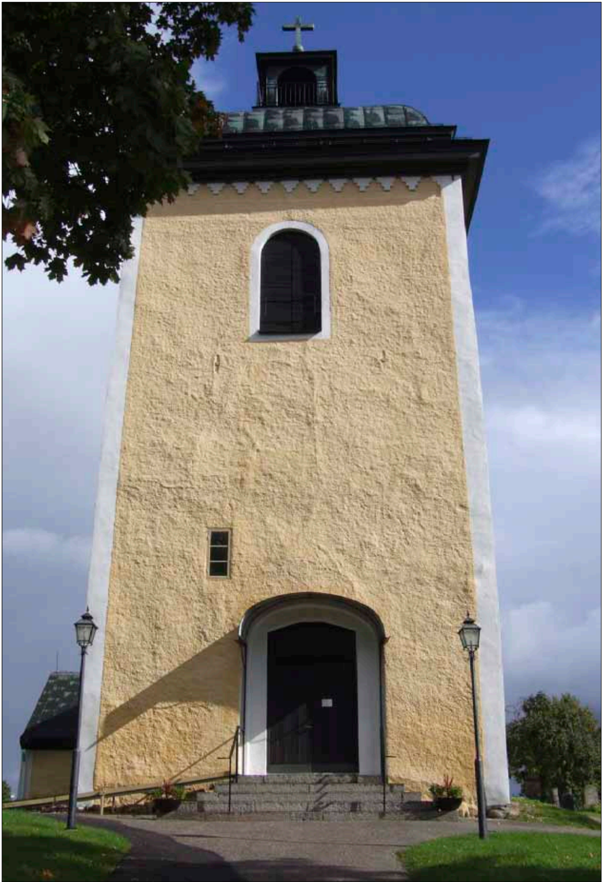
20 Tornets västfasad vid slutbesiktningen. (D10-862)
