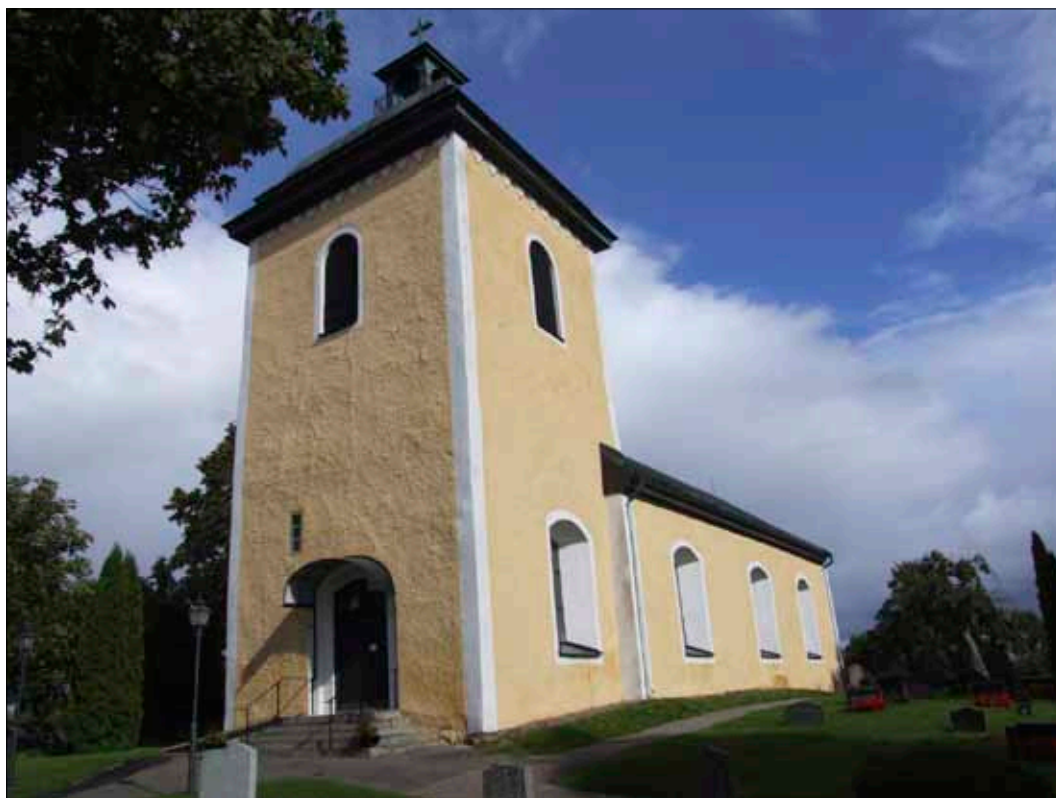
23 Vagnhärads kyrka vid slutbesiktningen sedd från sydväst. (D10-863)
