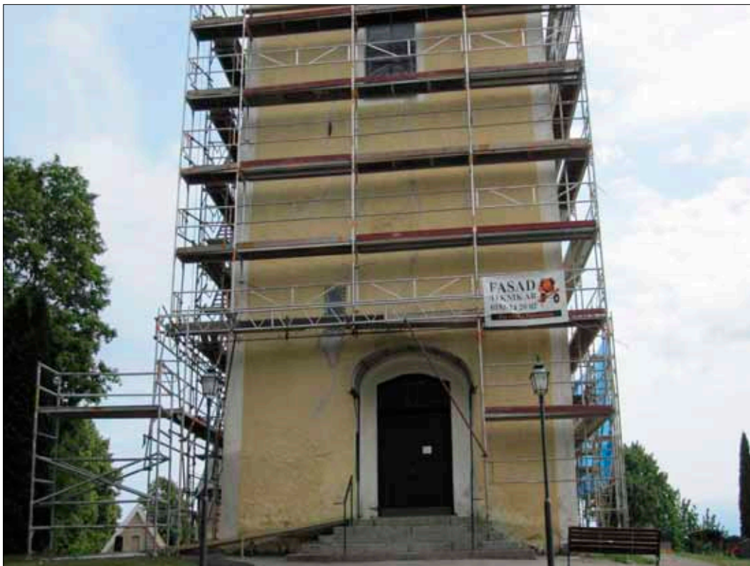
17 Tornets nedre del efter lagningar. Fotografi Magnus Josephson (Slm D10-865).
