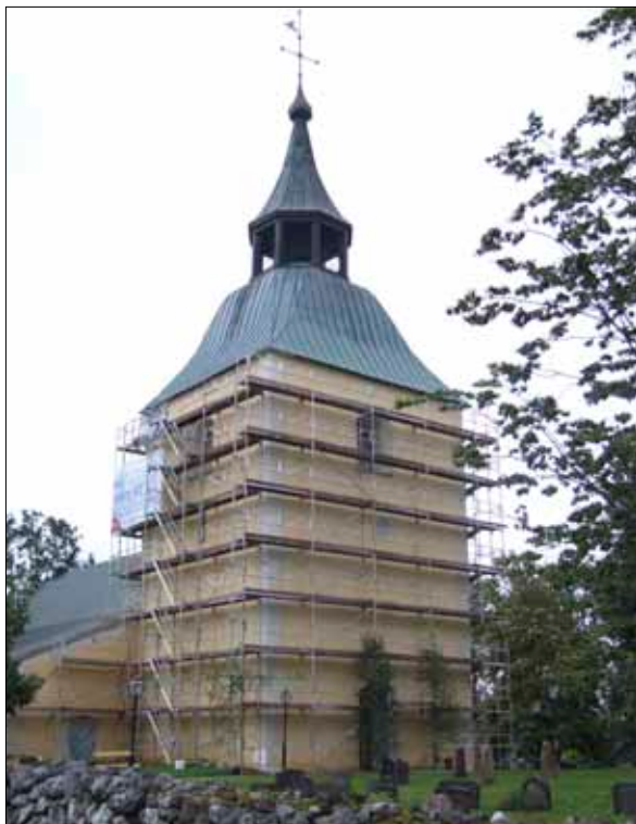
16 Kyrkan från nordväst under fasadrenoveringen den 16 augusti 2007.
