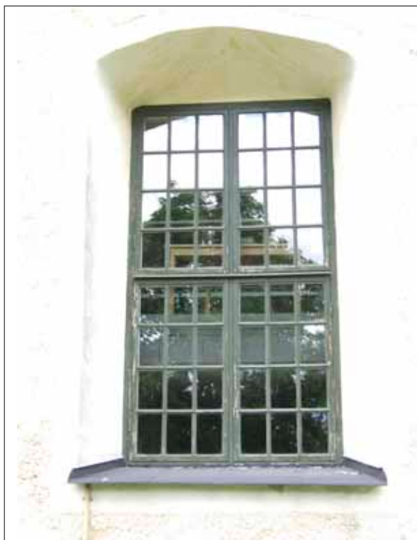
6 Fönsterbågarna var före renoveringen målade mörkt gröna.
