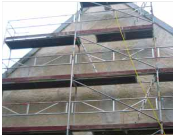
12 Del av korgaveln efter lagningar. Fotografi Fasadenoveringar Roland Karlsson i Mälardalen AB.
