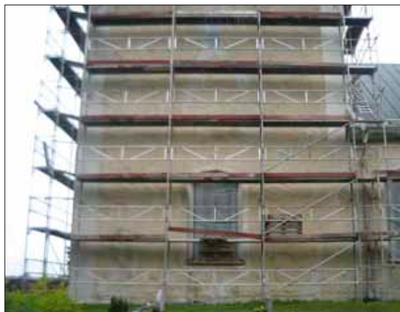
14 Del av tornets södra fasads lagningar. Fotografi Fasadenoveringar Roland Karlsson i Mälardalen AB.
