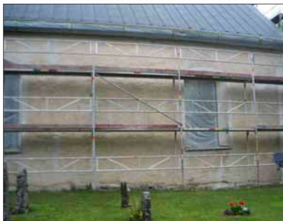
13 Del av södra fasadens lagningar. Fotografi Fasadenoveringar Roland Karlsson i Mälardalen AB.
