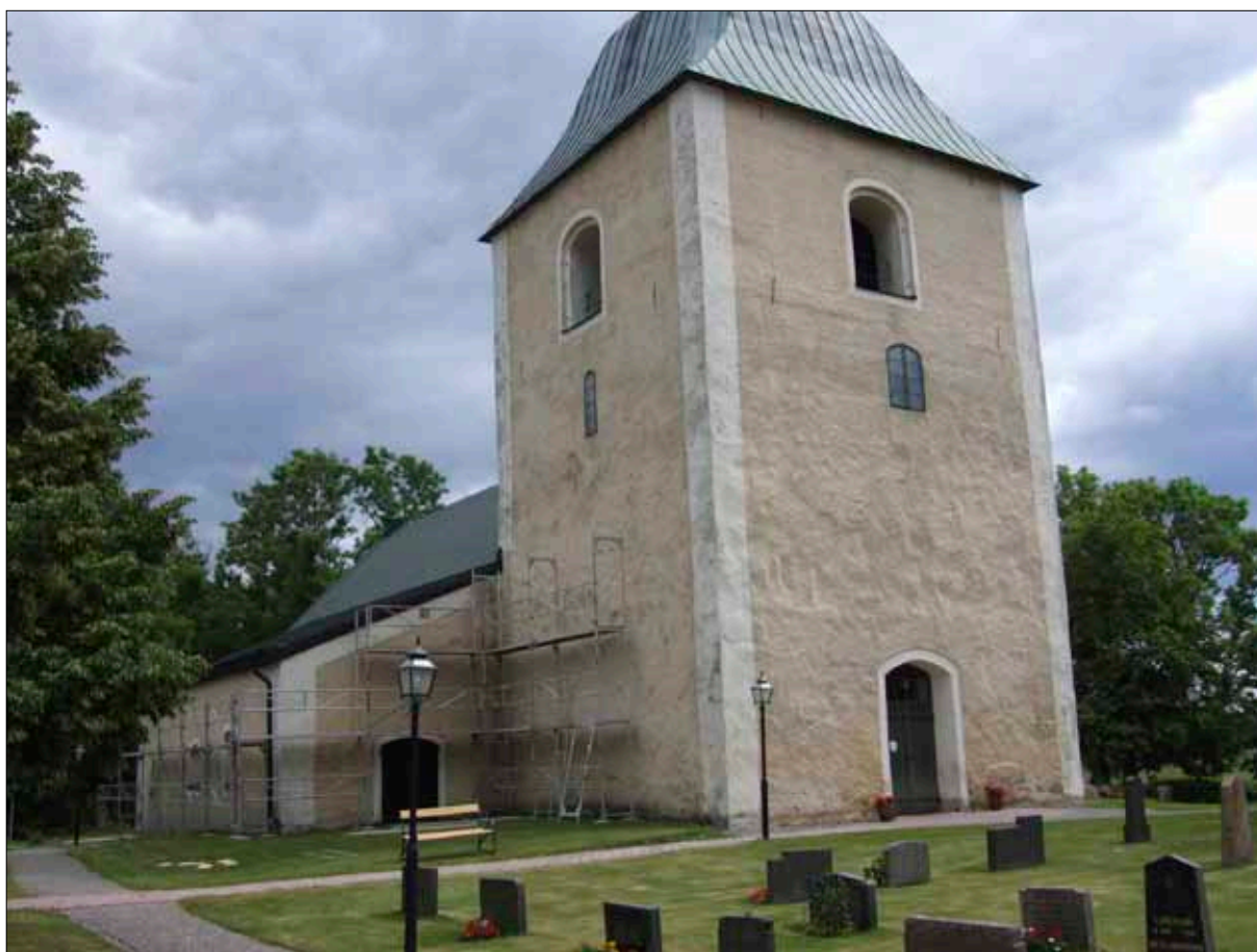
4 Vy från nordväst före renoveringen, 29 juni 2007.
