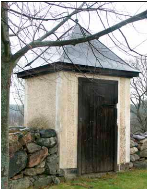
9 Transformatorstationen den 7 november 2005, som 2006 byggdes om till en stiglucka, då en parkering anlades norr om kyrkan.
