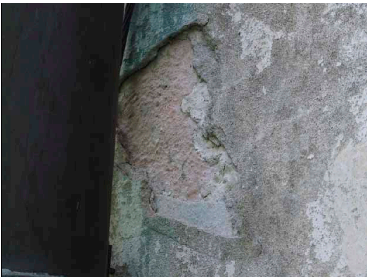
11 Detalj av det underliggande äldre putslagret med rosa avfärgning, den 29 juni 2007 på kapellet nordöstra hörn.
