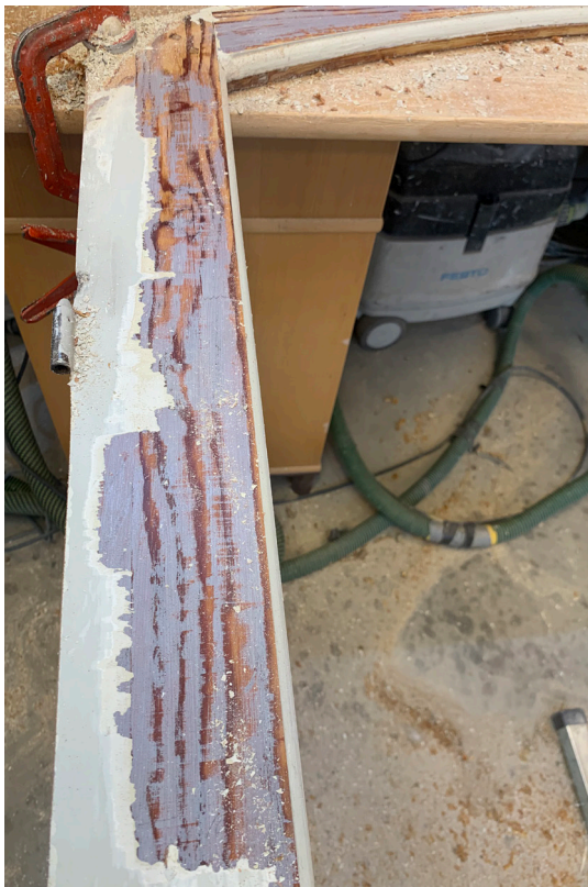
Bild 16. Äldre färgskikt på ett an de större fönsterpar- terna. Foto av Thomas Lundqvist. SLM D2024-0016.
