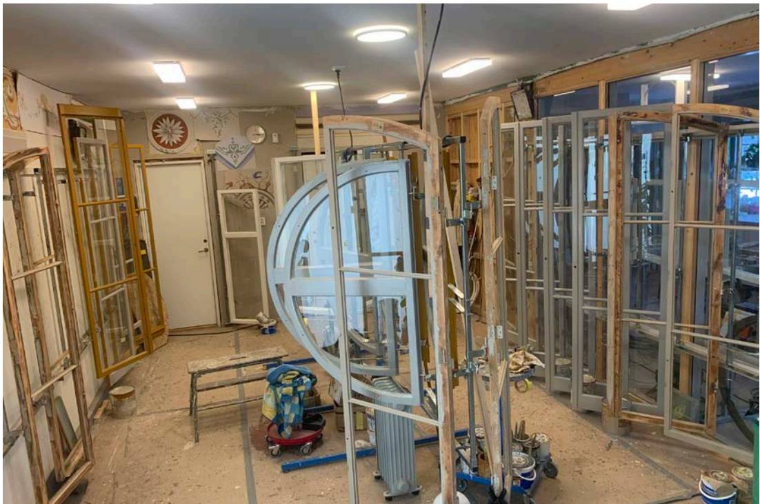
Bild 9. Pågående fönsterrenovering i verkstad. Bl.a. syns fönster A3 och A4 uppmärka. I mitten hänger bl.a. fönster B9. Foto av Thomas Lundqvist. SLM D2024-0009.
