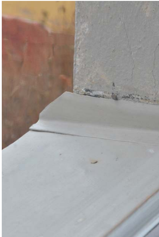
Bild 21. Återsatt plåtbleck efter renovering och ommålning i kulör lika fönsteromfatningar. SLM D2024-0021.
