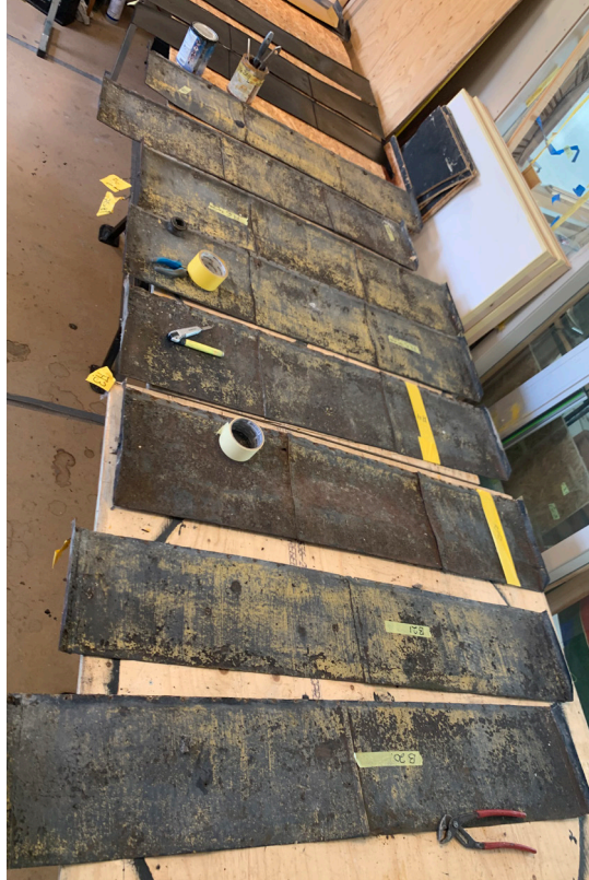
Bild 19. Renovering av äldre bleckplåtar av svartplåt på verkstad. SLM D2024-0019.
