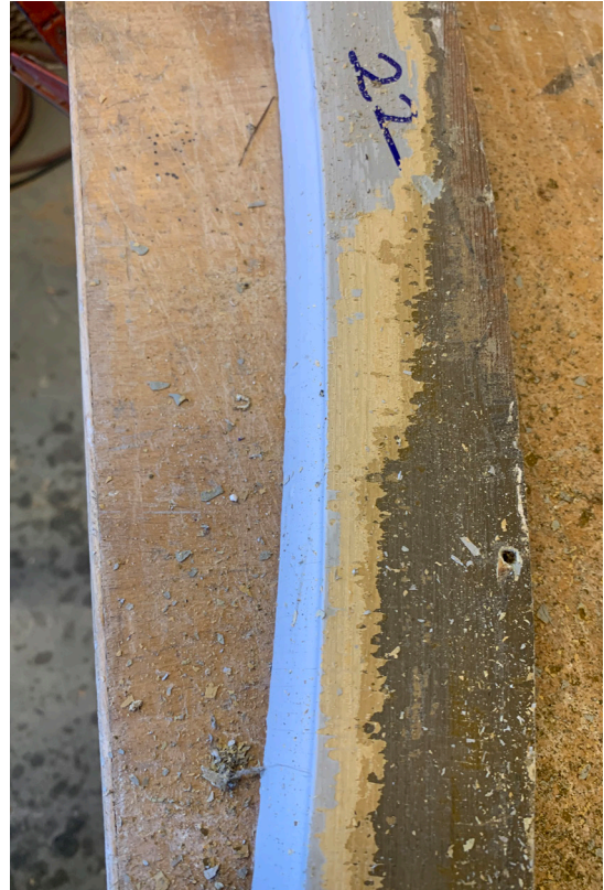
Bild 15. Äldre färgskikt med bl.a. flera gula lager. Foto av Thomas Lundqvist. SLM D2024-0015.
