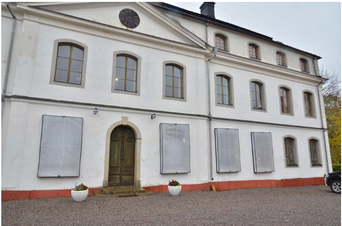
Bild 6. Östfasadens fönster, varav några är under pågående renovering. Foto 2023-10-31 av Sofia Fredriksson, Sörmlands museum. SLM D2024-0006.
