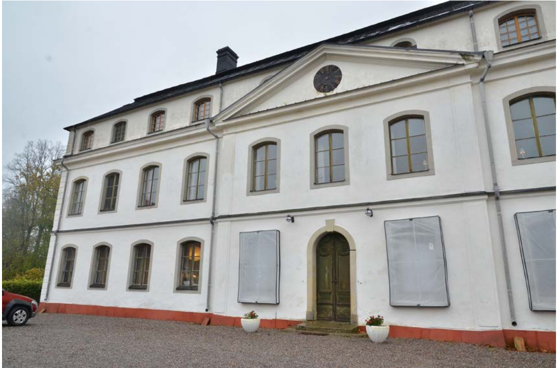
Bild 5. Östfasadens fönster, varav några är under pågående renovering. Foto 2023-10-31 av Sofia Fredriksson, Sörmlands museum. SLM D2024-0005.
