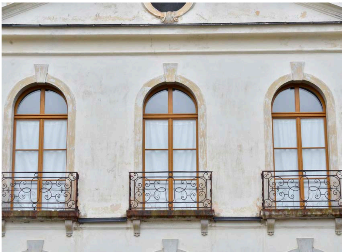
Bild 24. Fönster B9, B10 och B11 efter avslutad renovering. Foto 2023-03-14. SLM D2024-0024.
