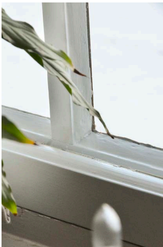
Bild 26. Innerbåge A22 eller A23 efter avslutad renovering. SLM D2024-0026.
