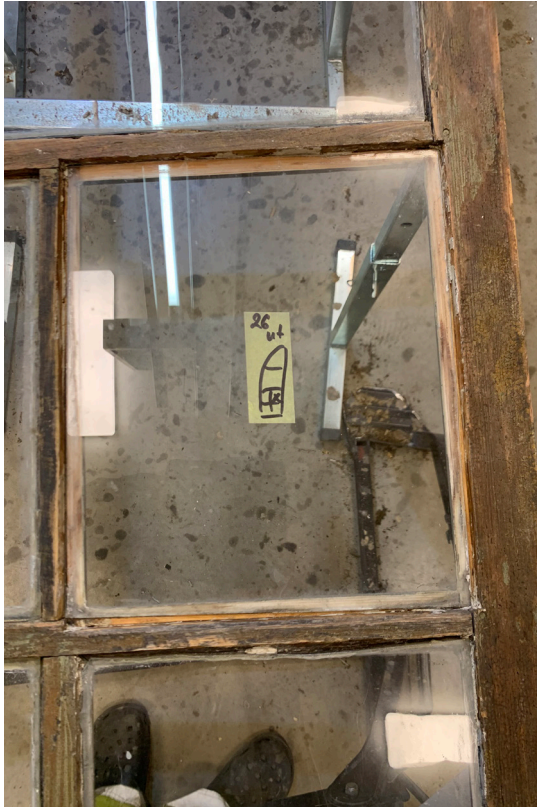
Bild 7. Ytterbåge A26 under renovering. Foto av Thomas Lundqvist. SLM D2024-0007.
