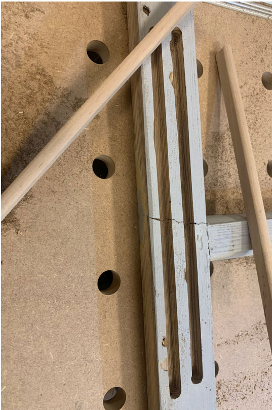
Bild 12. En knäckt båge i ett av bottenvåningens fönster lagades genom urfräsning och ilagning med nytt virke. Foto av Thomas Lundqvist. SLM D2024-0012.
