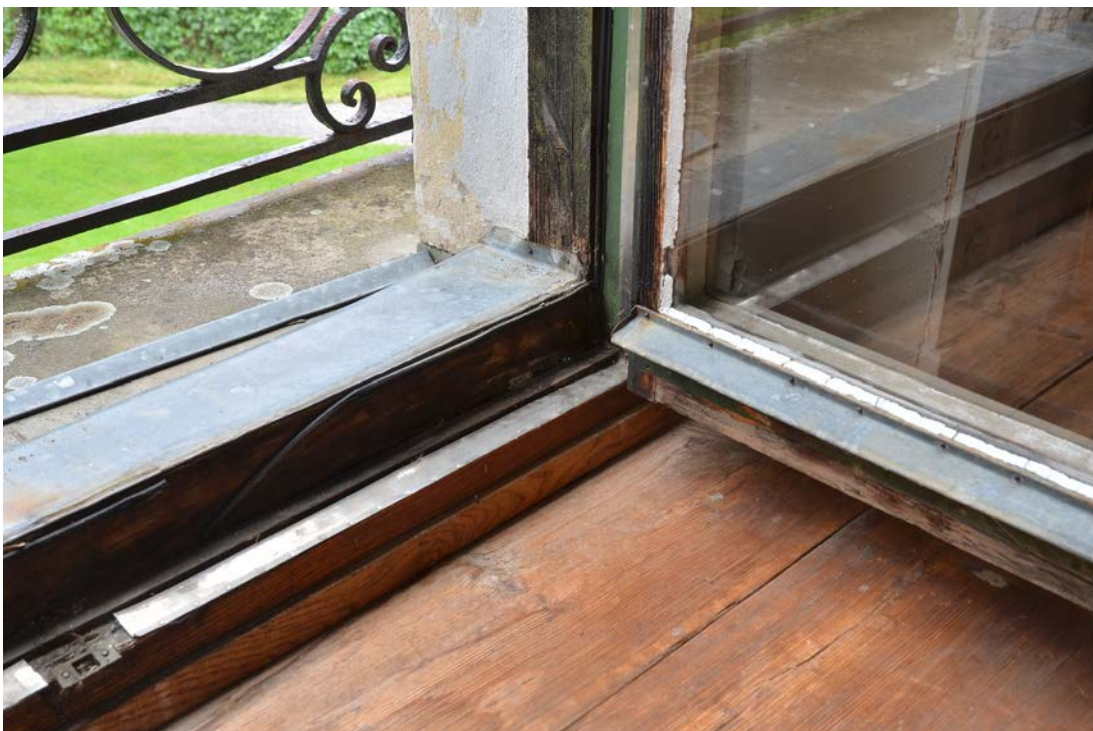
Bild 4. En av mellanvåningens balkongdörrar innan renovering (B9-11). Foto 2021-08-27. SLM D2024-0004.
