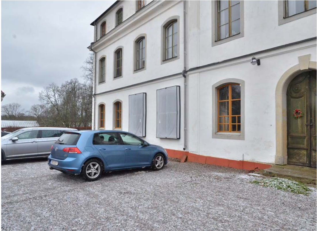
Bild 22. Fönster A26, A29 och A30 efter avslutad renovering. A27 och A28 renoveras på verkstad och förväntas att bli färdiga i slutet av januari 2024. Foto 2023-12-20. SLM D2024-0022.
