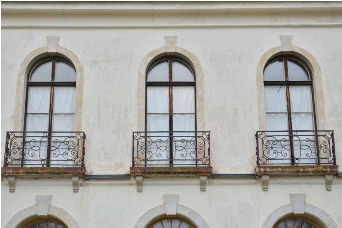
Bild 3. Fönster B9-11 innan renovering. Foto 2022-02-15. SLM D2024-0003.
