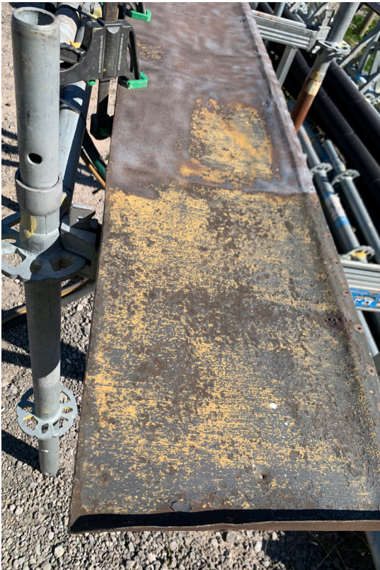
Bild 20. Pågående mjukblästring av äldre svartplåt. SLM D2024-0020.
