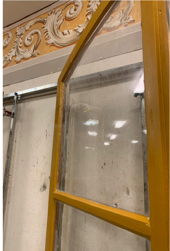
Bild 8. Ytterbåge A27 efter renovering. Foto av Thomas Lundqvist. SLM D2024-0008.
