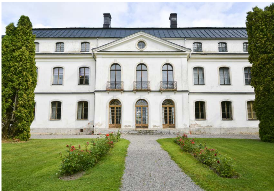
Bild 3. Fasaden mot trädgården innan renovering. SLM D2020-0295.
