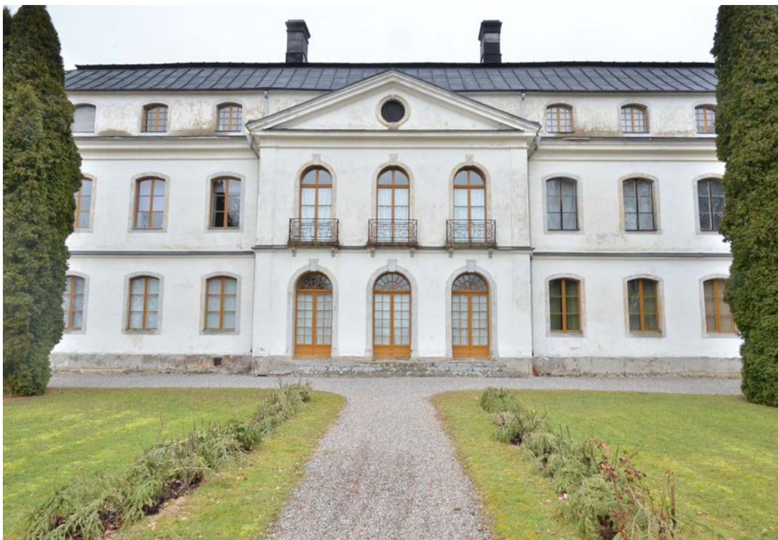
Bild 17. Sydöstra fasaden i mars 2023. Notera att även balkongdörrarna (B9-11) har renoverats. Dessa ingår i etapp 3 som kommer att redovisas i en separat delrapport. Foto 2023-03-14. SLM D2023-0212.
