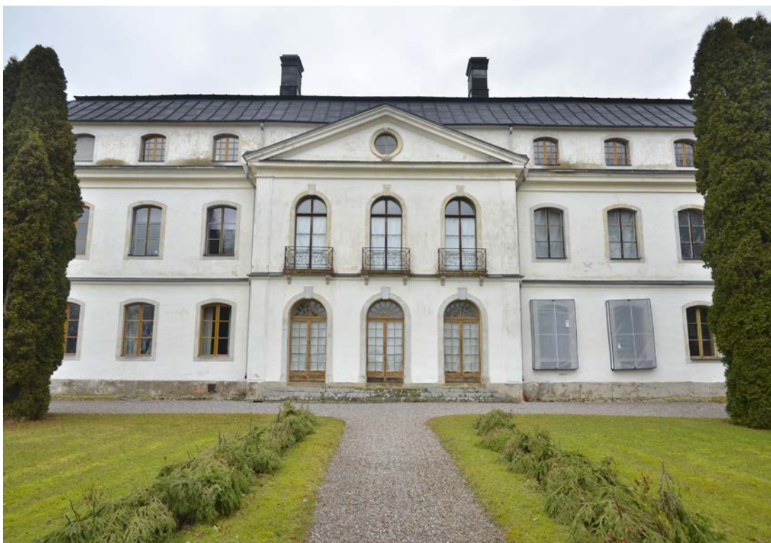
Bild 16. Sydöstra fasaderna i februari 2022. Fönster A12-14 och C6-8 har renoverats. Foto 2022-02-15. SLM D2023-0208.
