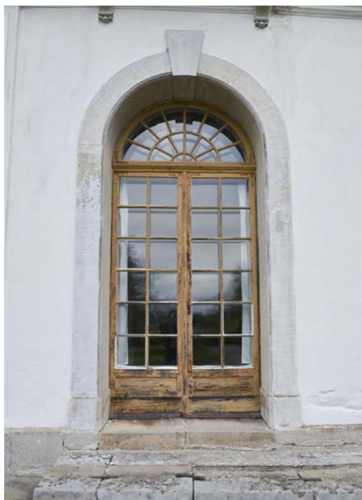
Bild 8. Norra nedre altandörrarna (A11) innan renovering. Foto 2020-10-11. SLM D2023-0200.
