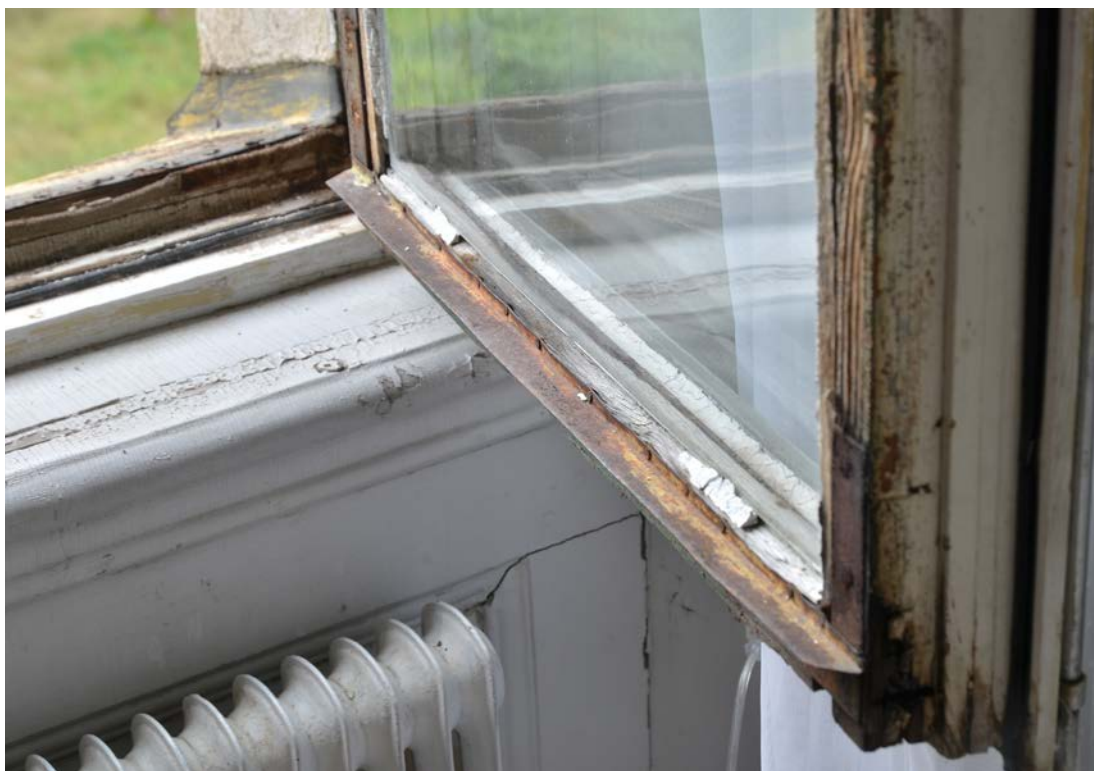
Bild 6. Troligtvis fönster B15, innan renovering. Foto 2021-08-27. SLM D2023-0198.
