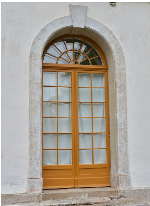
Bild 23. Altandörr A9 efter renovering. Foto 2022-09-15. SLM D2023-0194.
