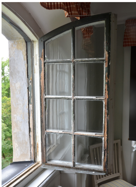
Bild 5. Vindsfönster innan renovering. Foto 2021-08-27. SLM D2023-0197.
