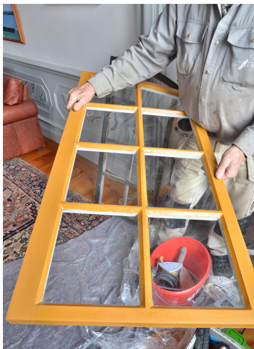
Bild 12. Nyttillverkat vindsfönster enligt befintliga förlagor, redo att sättas in i bågen. SLM D2023-0204.
