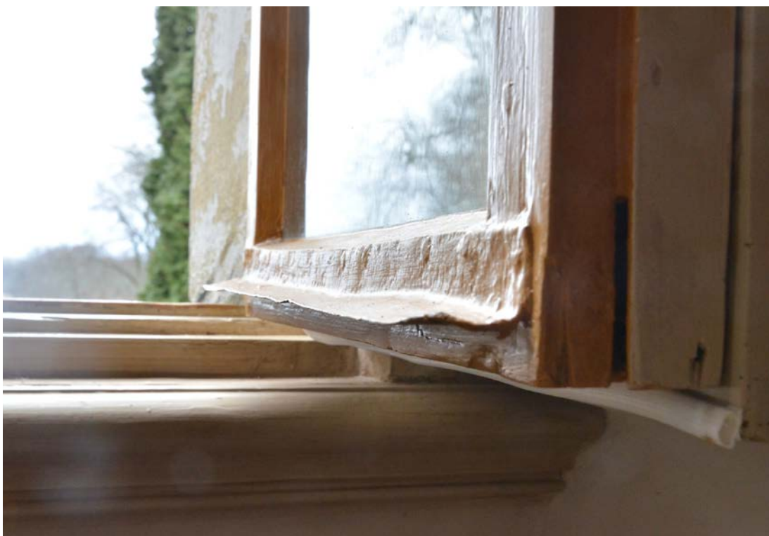
Bild 19. Fönster A6 efter renovering. Foto 2023-03-14. SLM D2023-0211.
