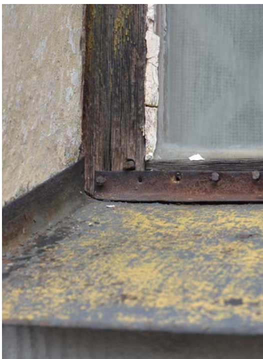
Bild 7. Fönster A12 innan renovering. Foto 2020-10-11. SLM D2023-0199.
