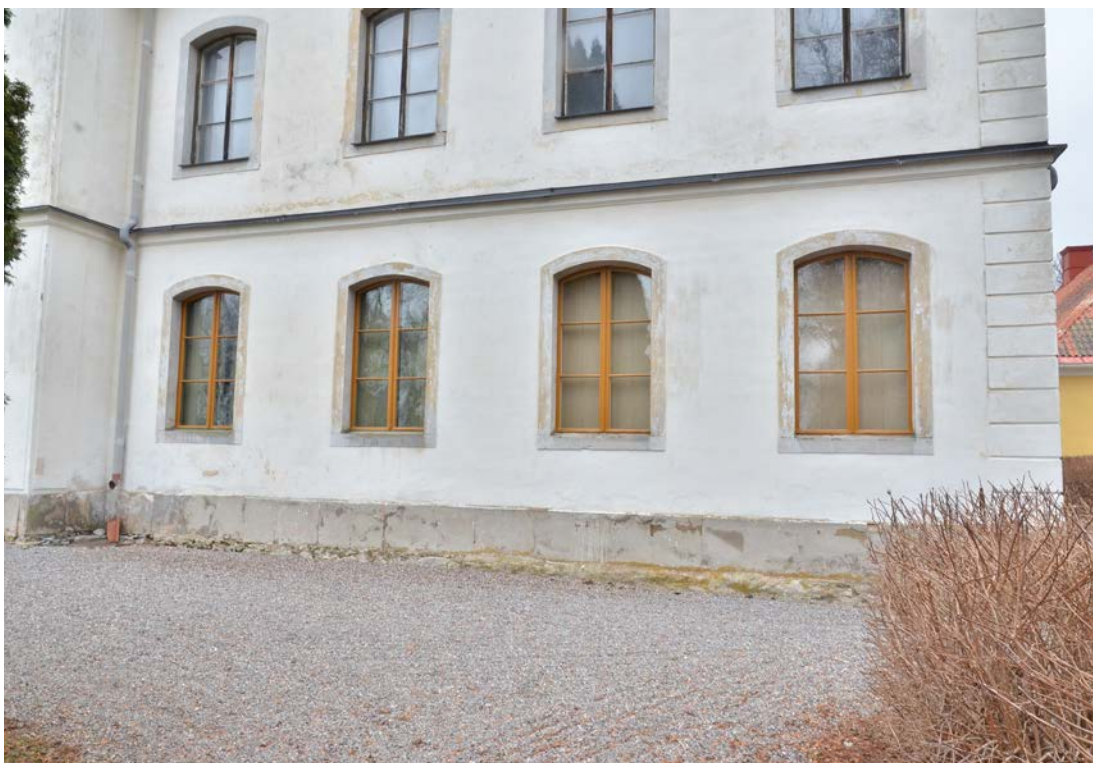
Bild 18. Fönster A5-8 efter renovering. Foto 2023-03-14. SLM D2023-0210.
