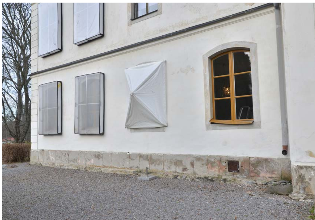
Bild 10. Fönster A12-15 samt B14-15 under pågående renovering. I fönster A12 utprovas en nyrenoverad gul bleckplåt. Foto 2021-11-25. SLM D2023-0202.
