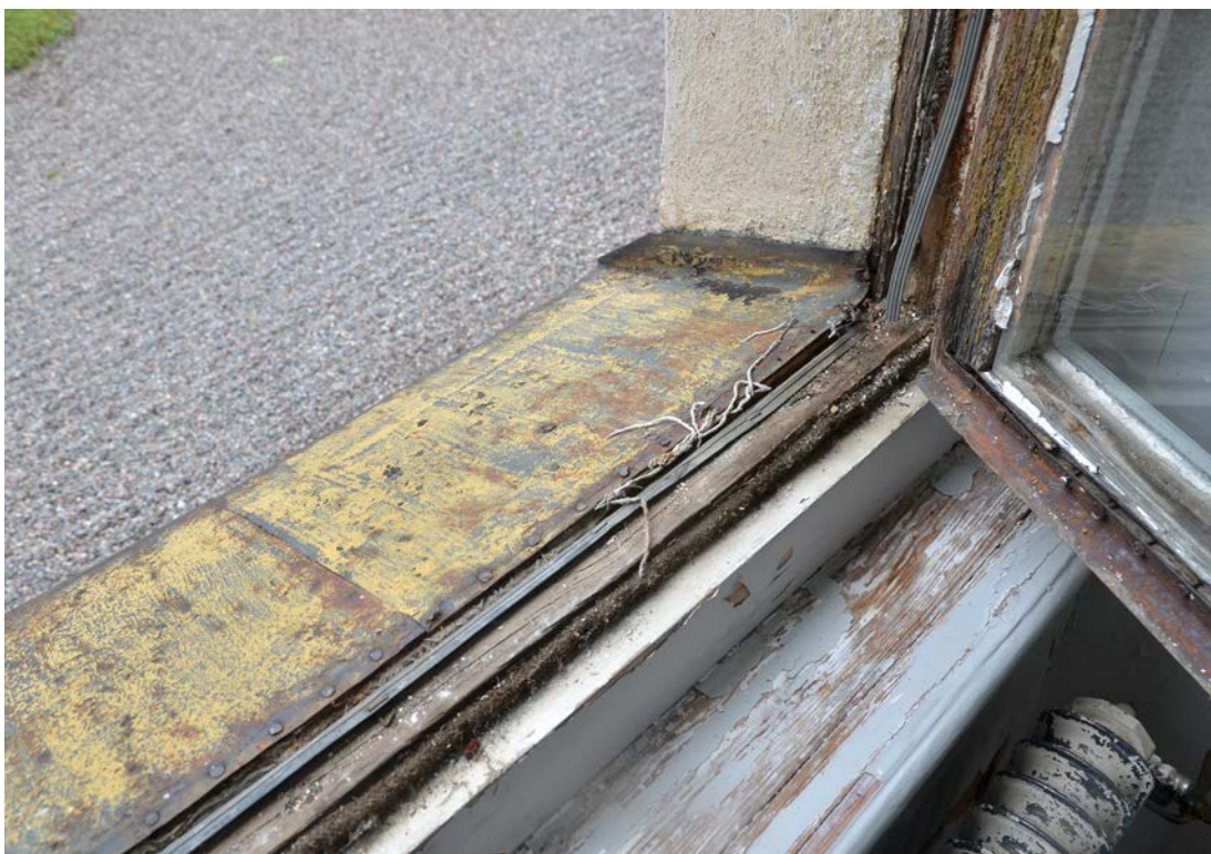
Bild 9. Troligtvis fönster B13, innan renovering. Foto 2021-08-27. SLM D2023-0201.
