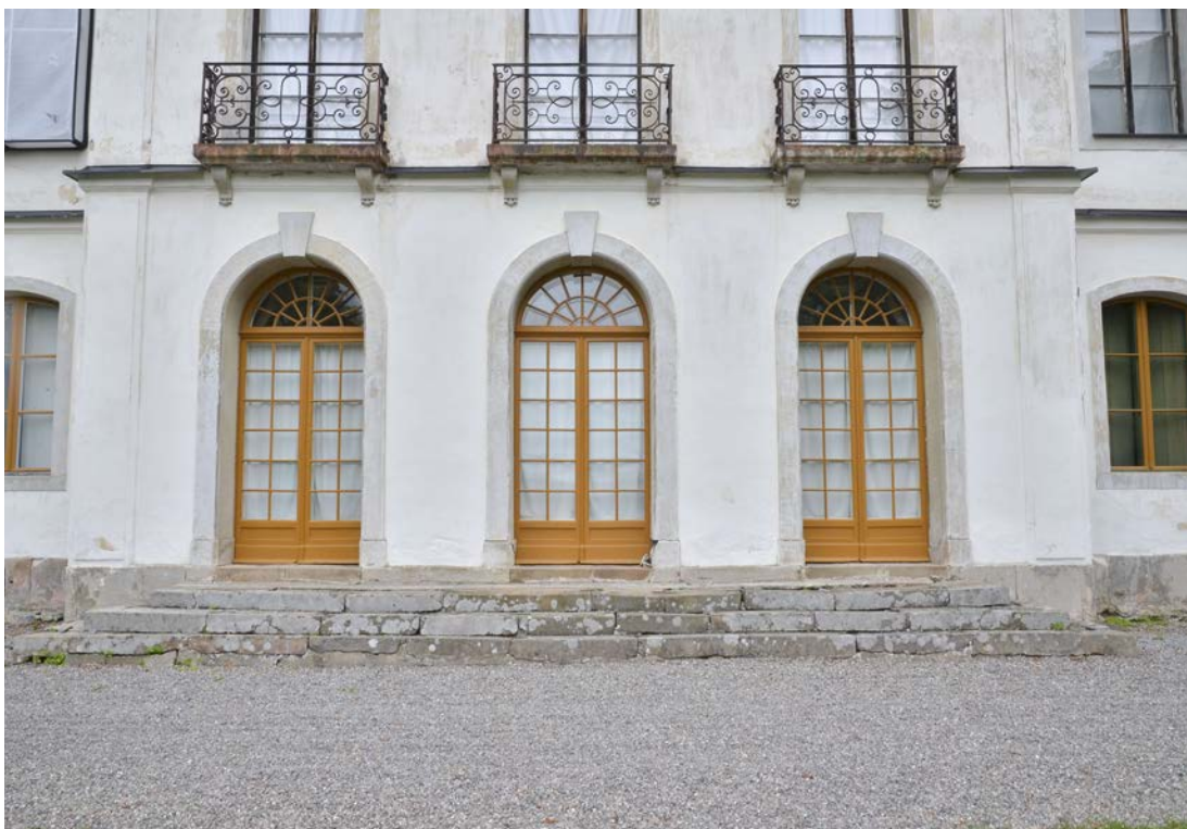
Bild 22. Altandörrarna (A9-11) efter renovering. Foto 2022-09-15. SLM D2023-0209.
