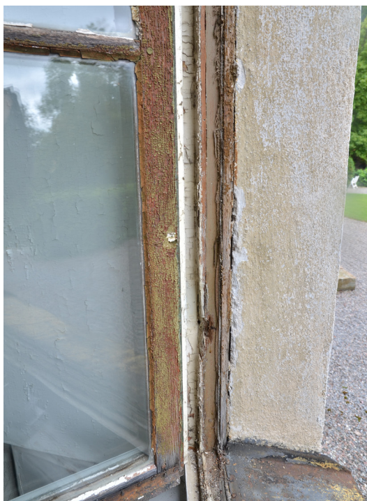
Bild 4. Fönster i bottenvåningen innan renovering. SLM D2023-0196.
