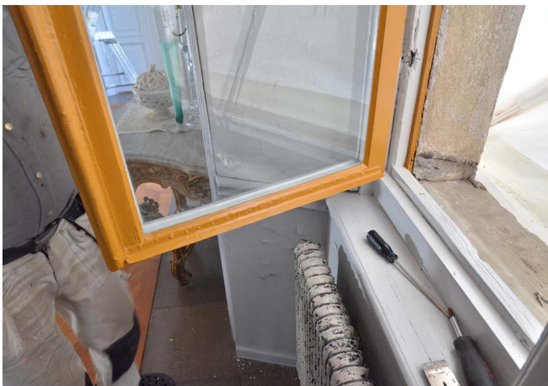
Bild 13. Fönster A13 efter renovering. Silikonlisten har ännu inte monterats. Foto 2021-11-25. SLM D2023-0205.
