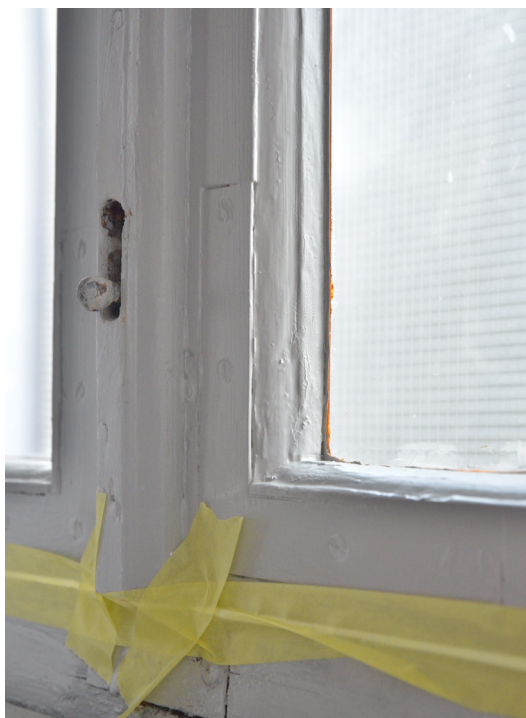
Bild 11. Hörnjärnen flyttades till ytterbågarnas insida. Foto 2021-11-25. SLM D2023-0203.
