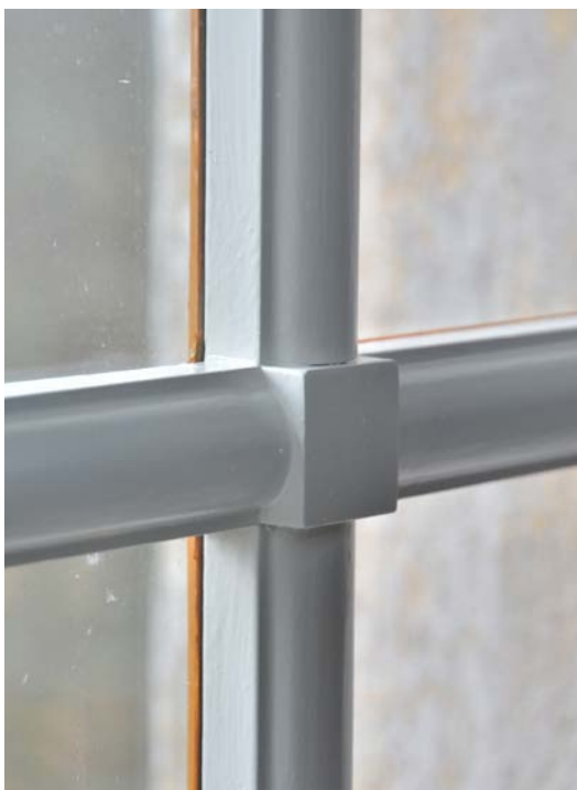
Bild 14. Insidan av C2-fönstrets ny tillverkade ytterbåge. Foto 2022-02-15. SLM D2023-0206.
