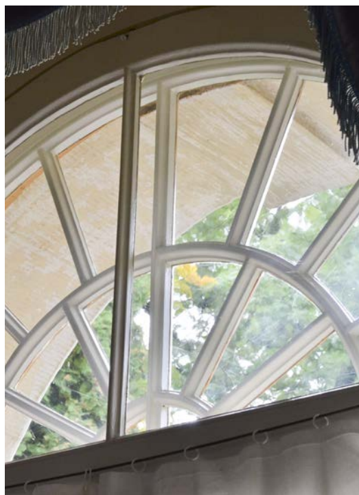
Bild 24. Lunettfönster efter renovering. Foto 2022-09-15. SLM D2023-0215.
