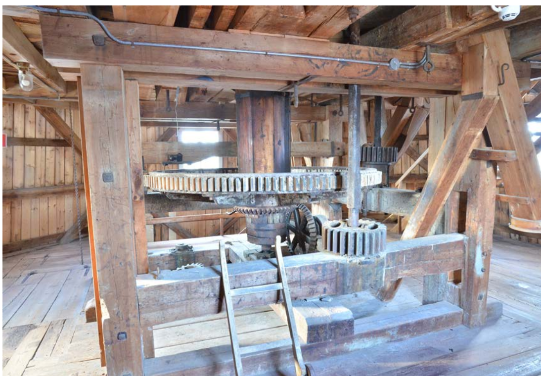
Andra våningen rymmer det stora hjärtstockshjulet av gjutjärn med kuggar av oxelträ. Från detta överförs kraften till de mindre kugghjulen (drillarna), vars järnaxlar driver kvarnstenarna på våningen ovanför. SLM D2022-0668.
