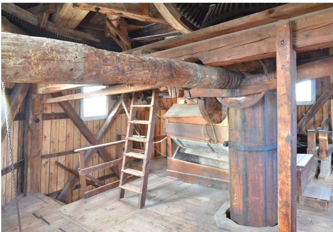
Fjärde våningen. Den nötta timmerstocken har använts till att lyfta upp säckarna med omlagen säd. I golvet till vänster i bilden syns luckan där säckarna hissades genom. Likadana luckor finns på alla våningsplan. SLM D2022-0670.
