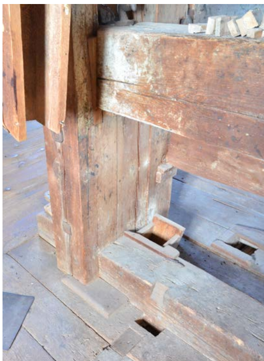
Trasig mjölkista (högst upp t.v.) samt hål i golven vars funktion inte har klarlagts helt. SLM D2022-0685.
