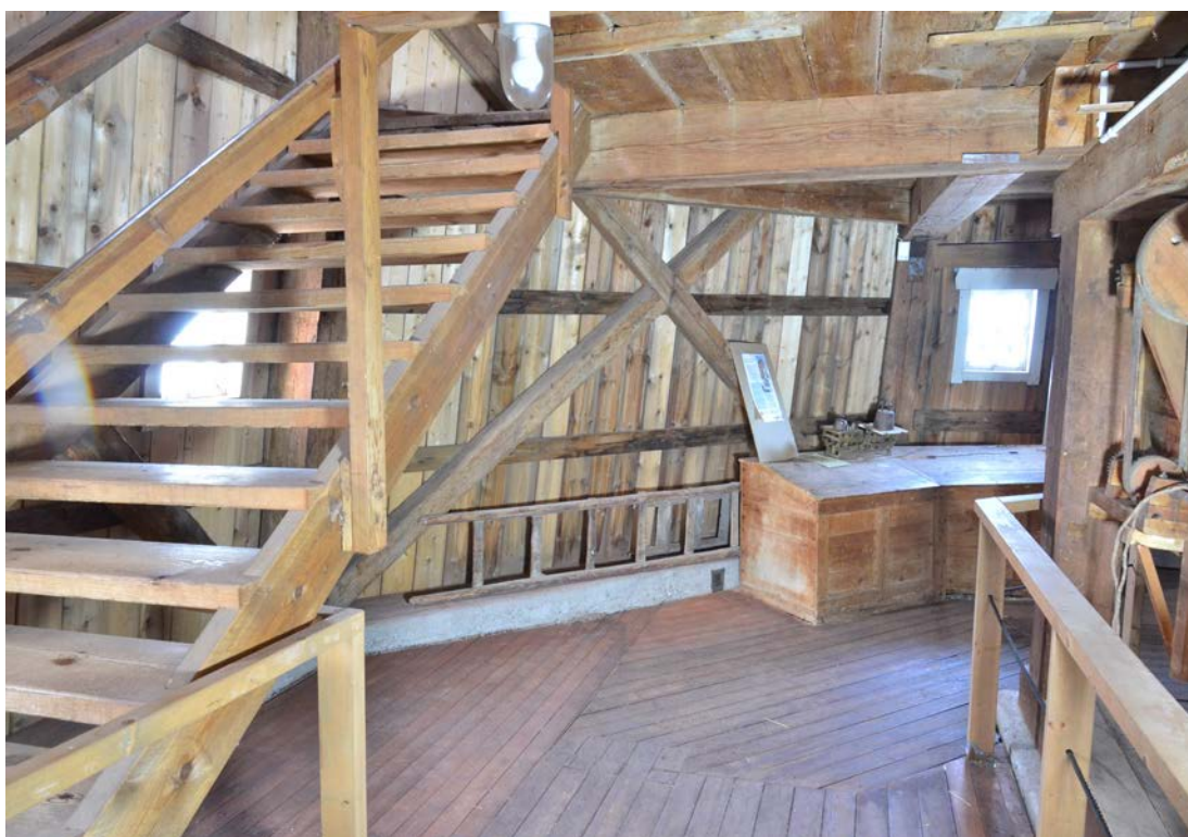
Den del av bottenvåningen där Gillet vill placera bildskärmar. SLM D2022-0687.
