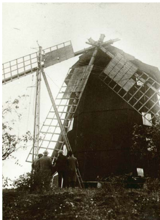
Väderkvarnen efter stormen 1933 som fick vingarna att knäckas. Foto: Eriksson. Sörmlands museums arkiv. SLM SEM_A24-36R.
