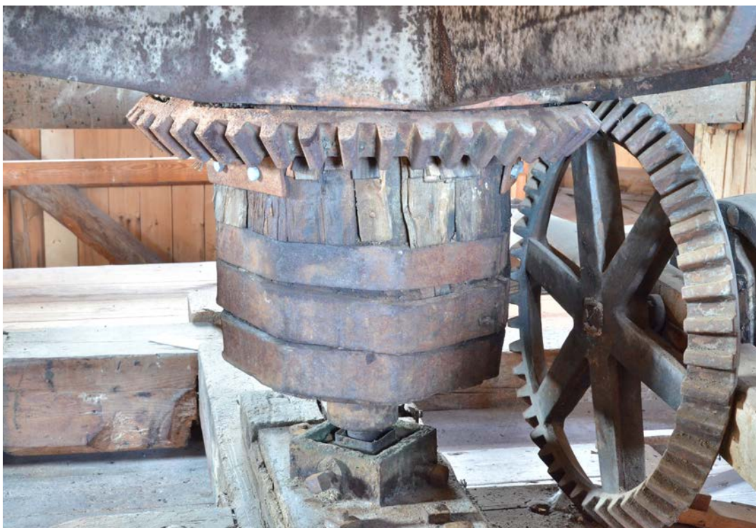
Hjärtstockens nedre del som befaras vara rötskadad. SLM D2022-0676.
