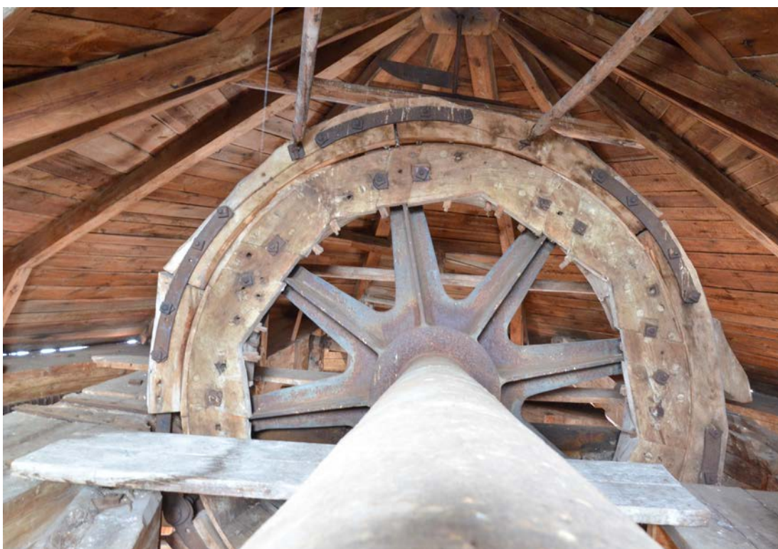
Vingaxeln av järn och det stora bromshjulet, vars yttre rörliga ledade träkrans nyper åt innerhjulet och får vingaxeln att stanna. I stället för järn har bromshjulet tidigare haft träekrar. Troligtvis har även själva vingaxeln varit av trä. SLM D2022-0677.
