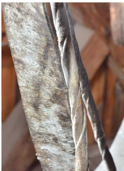
Tvinnade remmar av djurhud på fjärde våningen. Liknande remmar finns på kuphästarna och bottenvåningens siktar. SLM D2022-0684.
