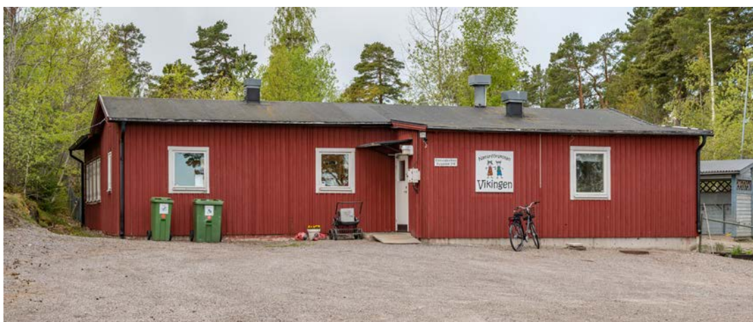
Byggnad 218 uppförd 1971. F d kokhus och kokutbildningsplats. Används sedan 2008 av Naturförskolan Vikingen. Byggnaden har rödfärgade fasader av trä och tak täckt med papp. Fönstren är vitmålade. (SLM D2020-0422)
