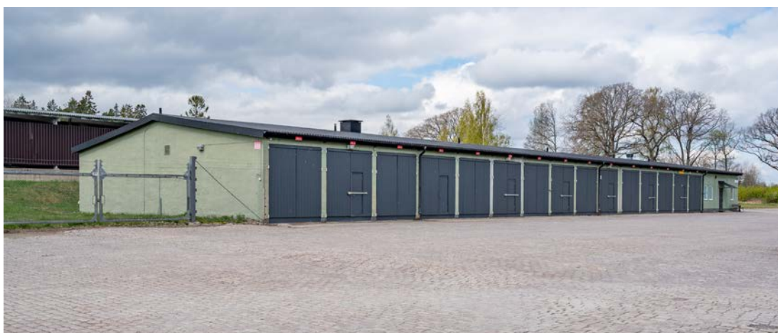
Byggnad 101 uppförd 1944. Byggnaden användes länge av garnisonens transportcentral, respektive regementets bilskola. Byggnaden är murad av lättbetong, med slätputsade fasader och tak av korrugerad plåt. (SLM D2020-0428)
