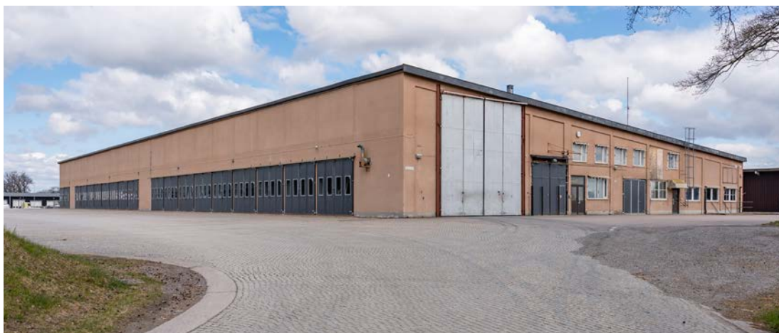
Byggnad 129 sedd från söder. Byggnaden uppfördes som Miloverkstad (militärområdesverkstad) 1944. Den västra sidan som syns till vänster innehöll stridsvagnsverkstaden. Murad/gjuten stomme av betong med putsade fasader och tak av papp. Underliggande putslager visar att byggnaden tidigare har varit grön. (SLM D2020-0433)
