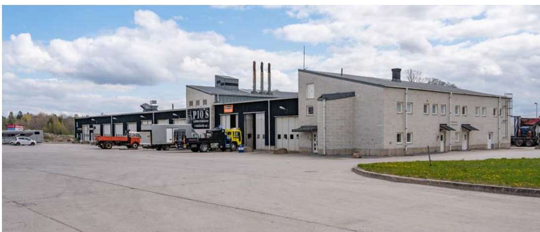
Byggnad 235 uppförd som smörj- och tillsynshall 1986. Byggnaden har fasad av betong och trä, och tak av papp och korrugerad plåt. (SLM D2020-0447)
