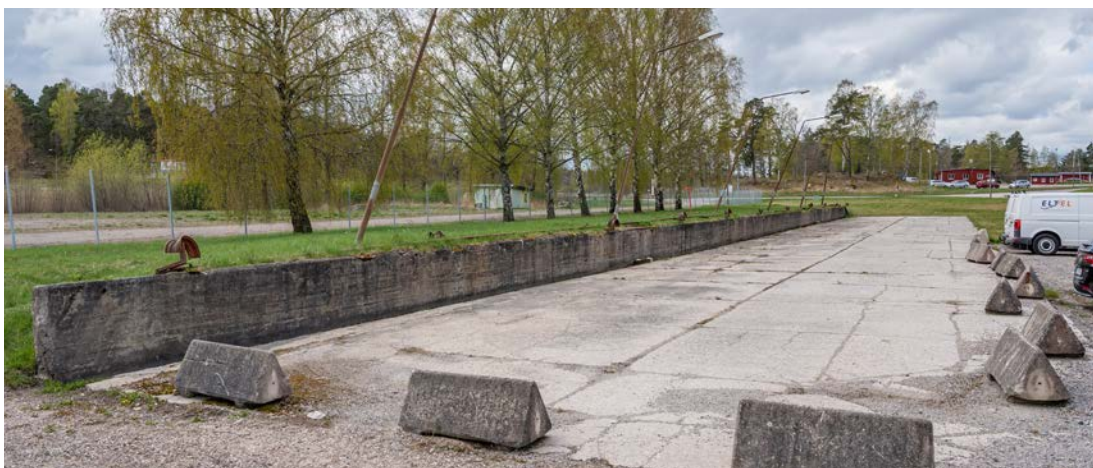
Spolplatsen för rengöring av stridsvagnar och andra terrängfordon söder om byggnad 104. Markbeläggningen består av betongplattor. Slanghållare och vattenledningar finns ännu kvar. (SLM D2020-0460)
