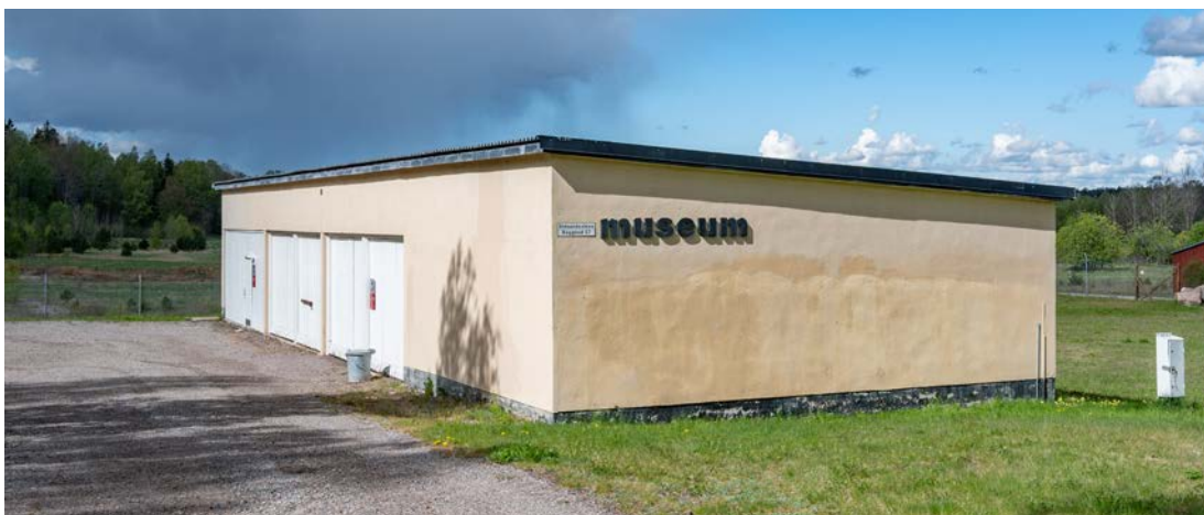
Byggnad 57 sedd österifrån uppförd 1940. Byggnaden uppfördes som målverkstad men byggdes om till museum på 1990-talet. Byggnaden är murad och putsad och delar bortsett från kulören utformningen med andra putsade byggnader inom området från samma tid. (SLM D2020-0418)
