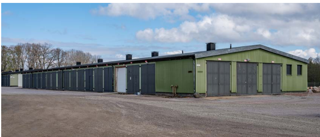
Byggnad 102 uppförd 1944 innehållande varmgarage. Byggnaden är murad av lättbetong, med fasader och tak av korrugerad plåt. (SLM D2020-0432)
