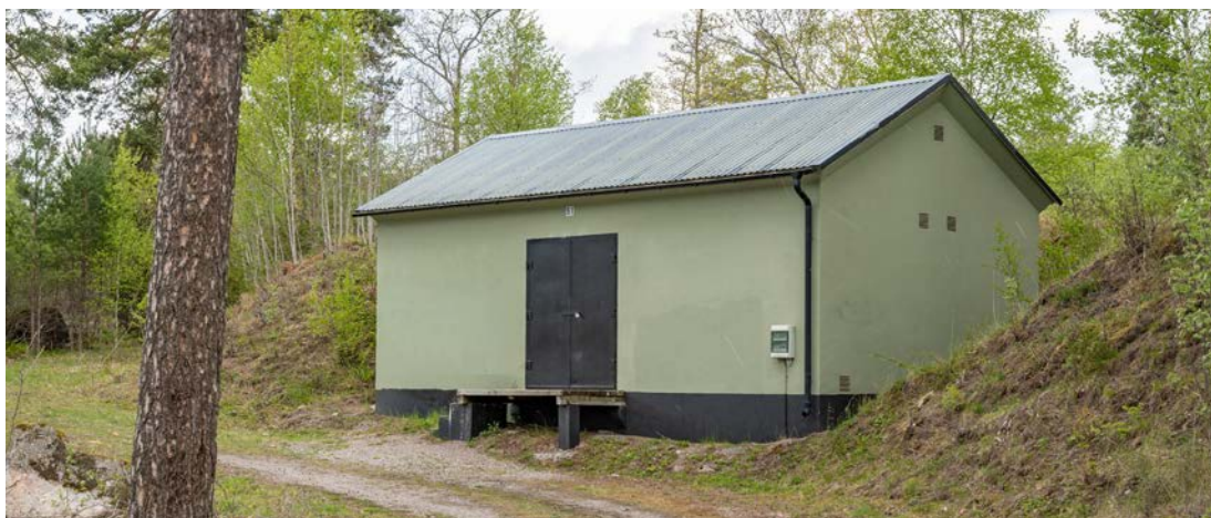
Byggnad 51 uppförd 1938 som kallförråd. Byggnaden är murad och putsad, och taksprånget är inklätt med snedställda skivor vilket ger den ett speciellt utseende. (SLM D2020-0421)
