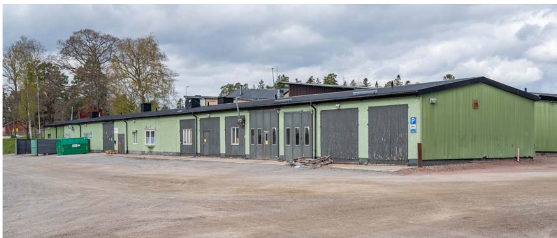
Byggnad 104 sedd från sydost. (SLM D2020-0427)
