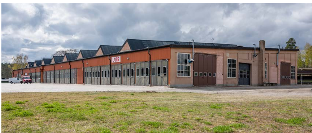
Byggnad 129 sedd från norr. Byggnadens östra del, som innehöll hjulfordonsverkstad, har sågtandat tak, men takfönstren är idag täckta av korrugerad plåt. Östra fasaden är täckt med korrugerad plåt. Fönstren är av trä och har vitmålade spröjsade och ospröjsade fönsterbågar. (SLM D2020-0434)
