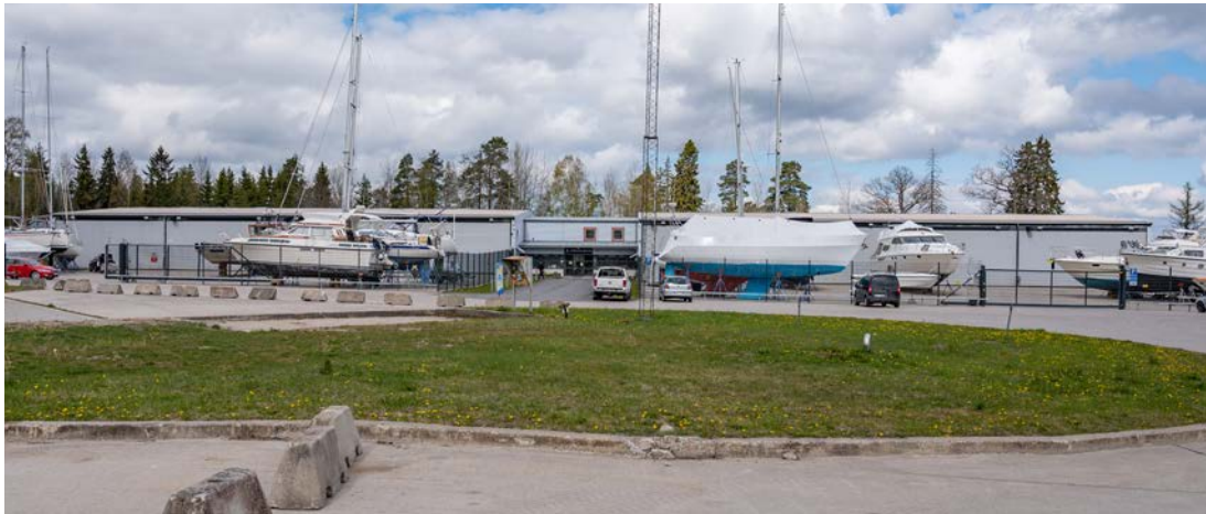
Byggnad 298 uppförd som stridsvagnsgarage 1990. (SLM D2020-0445)
