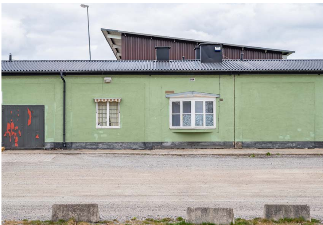
Garagebyggnad 104 vid Kasgaren. Garagen har en funktionalistisk utformning där burspråket utgör en tidstypisk och karakteristisk detalj. (SLM D2020-0466)
