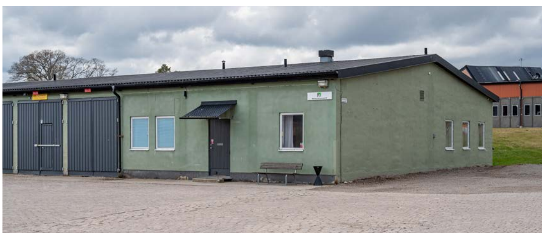
Norra änden av byggnad 101 med lokaler åt garnisonens transportcentral. Fönstren är av trä och har ospröjsade vitmålade fönsterbågar. (SLM D2020-0429)
