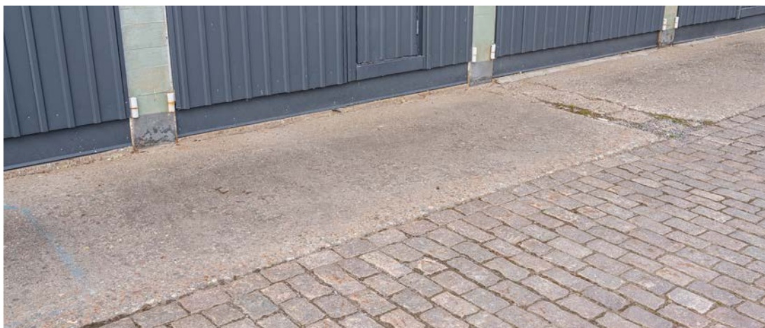
Markbeläggningen mellan byggnad 100-103 består av storgatsten lagd i rader. Längs anslutande betongplattor vid garageportarna löper en linje med tvärställda stenar. (SLM D2020-0464)
