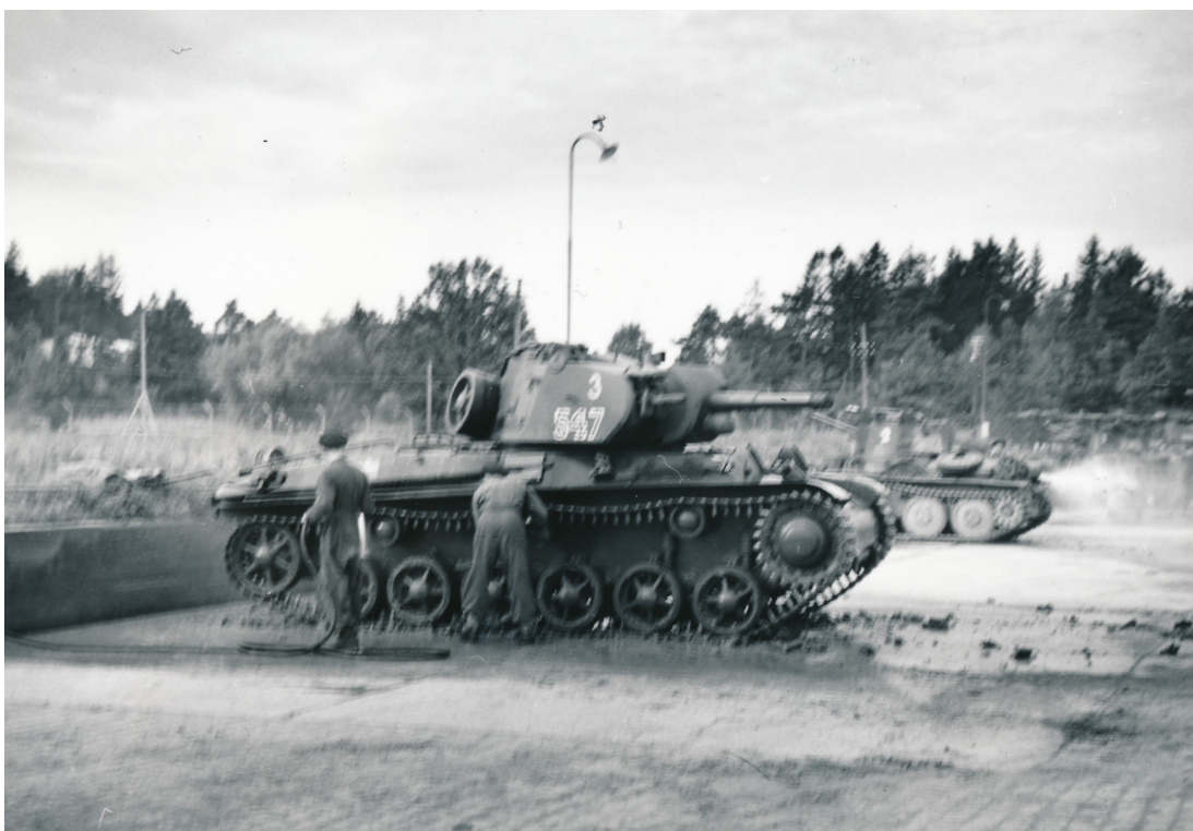
Spolning av stridsvagn m/42 i samband med repetitionsövningen 1954. Bilden är tagen vid spolningsplatsen söder om byggnad 104 som ännu finns kvar. Notera betongmuren till vänster med slanghållaren som skymtar bakom stridsvagnen vilket kan jämföras med bilderna på sidan 41. Foto: Stigh Rydh (SLM MIL0025)
