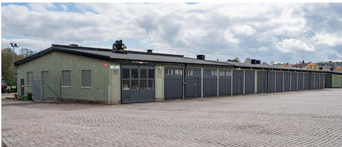
Byggnad 100 uppförd 1944. I norra delen närmast i bild fanns en torsträningshall med ett stridsvagnstorn fastmonterat i golvet. Här fanns också under en period en köldkammare för fordons- och materieförsök. Byggnaden är murad av lättbetong, med slätputsade fasader och tak av papp och korrugerad plåt. (SLM D2020-0430)
