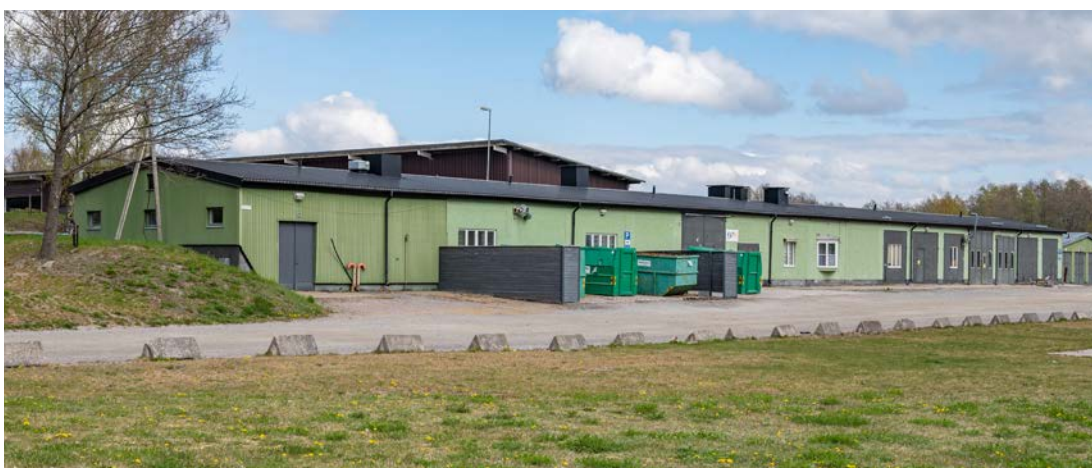
Byggnad 104 sedd från sydväst, uppförd 1944 som motorförråd. Byggnaden har en murad stomme av lättbetong, med slätputsade fasader och tak av korrugerad plåt. Västra änden och norra sidan har fasader klädda med plåt. Fönstren har spröjsade och ospröjsade fönsterbågar av trä, vitmålade på den södra sidan och gråmålade på den norra. (SLM D2020-0425)
