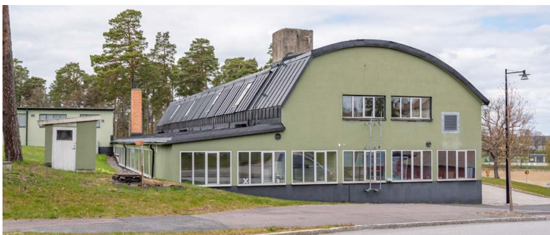
Byggnad 65 uppförd som utbildningsverkstad 1940. Även denna byggnad delar det funktionalistiska formspråket och karakteriseras av det runda takfallet som ger gaveln sin form. På taket syns en större skorsten av betong. (SLM D2020-0416)
