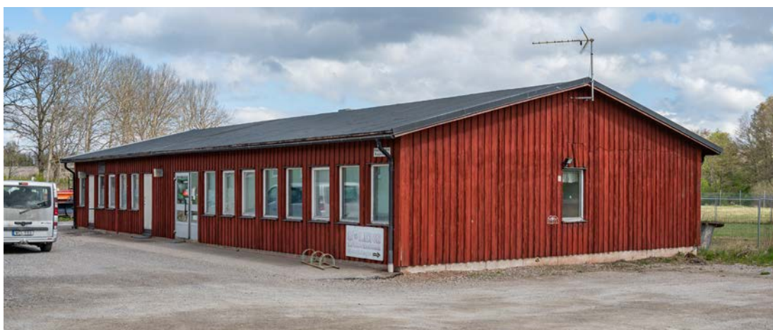
Byggnad 234 uppförd som expeditiönsbyggnad 1982. Användes av personal vid Arméns Motorskola. Byggnaden har trästomme, fasader med rödfärgad locklistpanel och tak av papp. Fönstren är av trä och vitmålade. (SLM D2020-0440)
