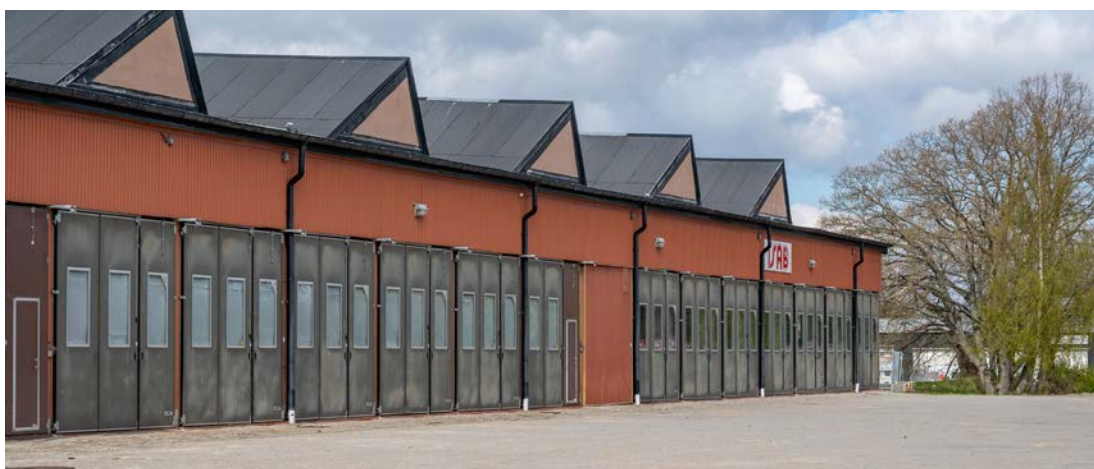
Byggnad 129 sedd från sydost. Större delen av byggnaden omges av smågatsten vilket kontrasterar mot den industriella karaktären. (SLM D2020-0435)
