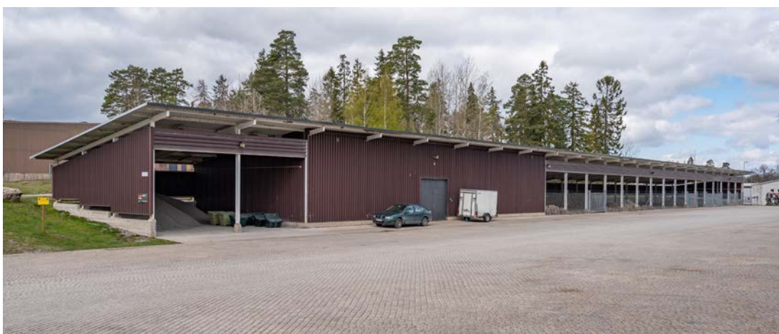
Byggnad 74. Verkstadsförråd uppfört 1984. Byggnaden har stålstomme, plåtfasader och plåttak. (SLM D2020-0438)
