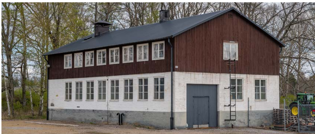
Byggnad 173 uppförd 1948 som signalverkstad. Undervåningen innehöll verkstad och övervåningen personallokaler. Byggnaden har en stomme av tegel och trä och bottenvåningen är slammad och den övre har en locklistpanel av trä. Taket är täckt med korrugerad plåt. Fönstren är spröjsade med äldre glas och beslag. (SLM D2020-0439)
