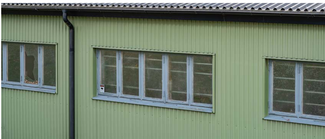
Fönstren på norra sidan av byggnad 104 har äldre glas och beslag. Formspråket är funktionalistiskt med fem lika stora lufter på rad. (SLM D2020-0426)
