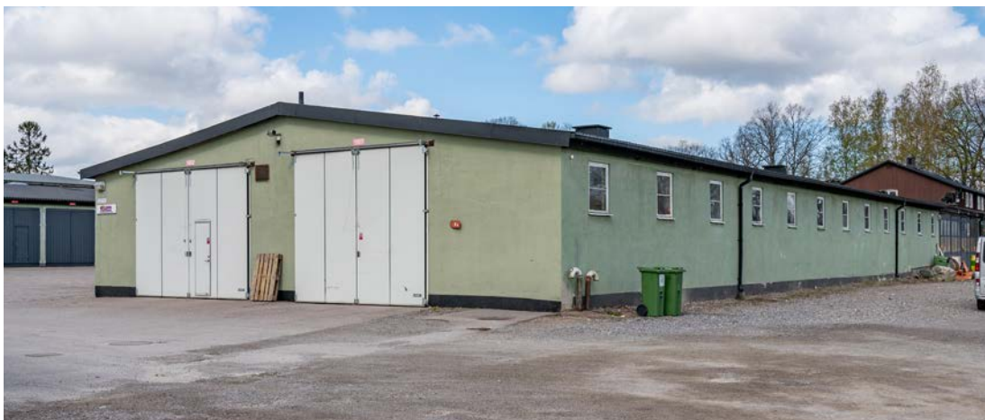
Byggnad 100 sedd från sydost. Baksidans fönster med en tvärgående post bedöms vara ursprungliga och har äldre glas och beslag. (SLM D2020-0431)
