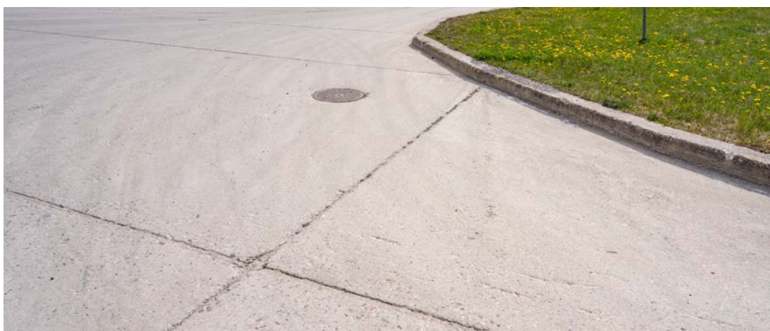
Markbeläggningen i anslutning till stridsvagnsgaraget vid det nya motorområdet längst i norr består av betongplattor. (SLM D2020-0465)
