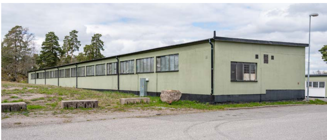
Byggnad 63 sedd söderifrån. Den sydvästra långsidan domineras av fönsterbandet av funktionalistisk karaktär. (SLM D2020-0413)
