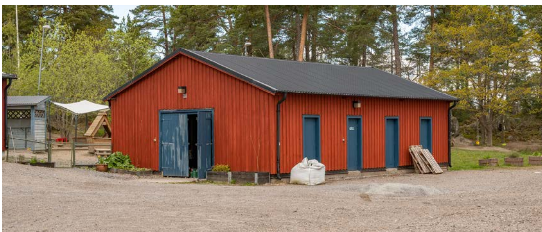
Byggnad 67 uppförd 1942. F d kokhus och kokutbildningsplats. Används sedan 2008 av Naturförskolan Vikingen. Byggnaden har trästomme och fasad av rödfärgad träpanel. Taket är täckt med korrugerad plåt. (SLM D2020-0423)
