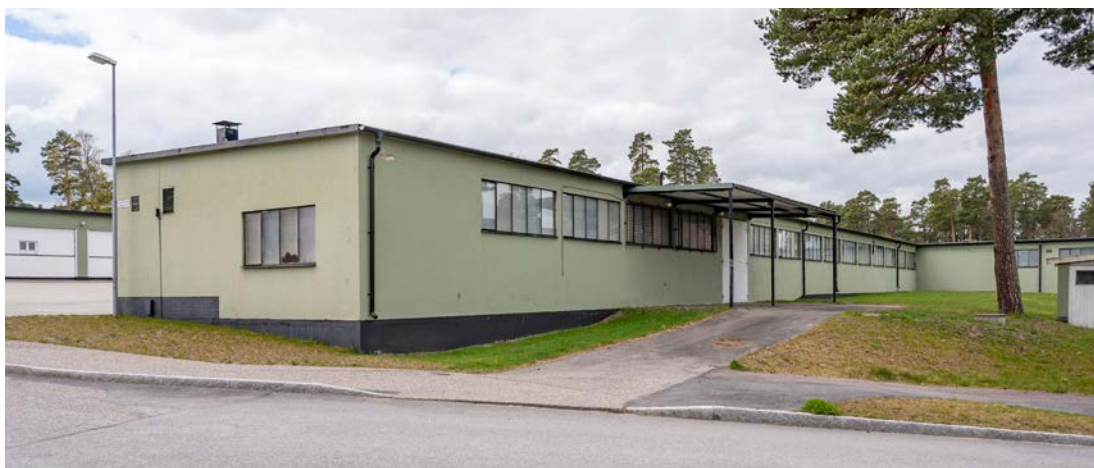
Byggnad 64 sedd österifrån. Utformningen är utpräglad funktionalistisk med platta tak, långa fönsterband och fasader utan dekorativa inslag. (SLM D2020-0415)
