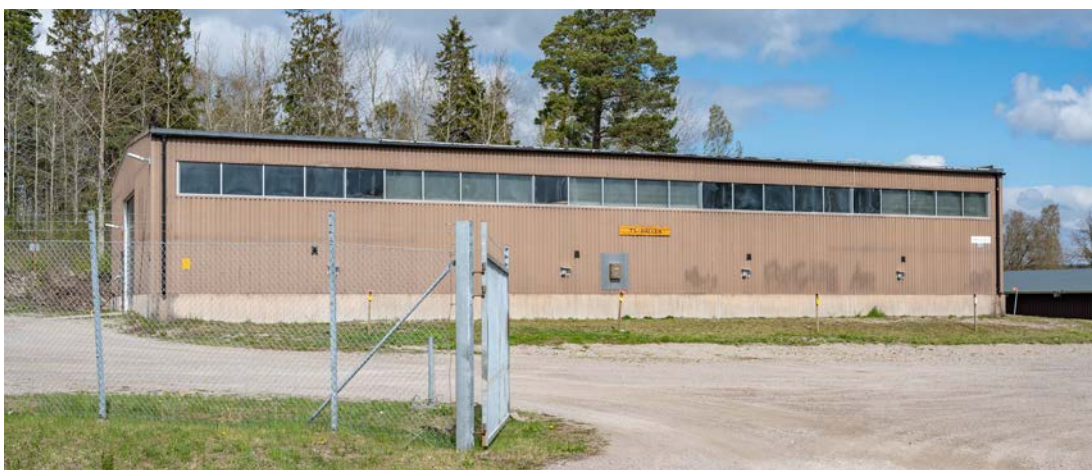
Byggnad 220 uppförd som övnings- och vårdhall 1973. Här gjordes bland annat övningar i krigskirurgi på grisar. Byggnaden har en stomme av stål och fasader och tak av plåt. (SLM D2020-0449)
