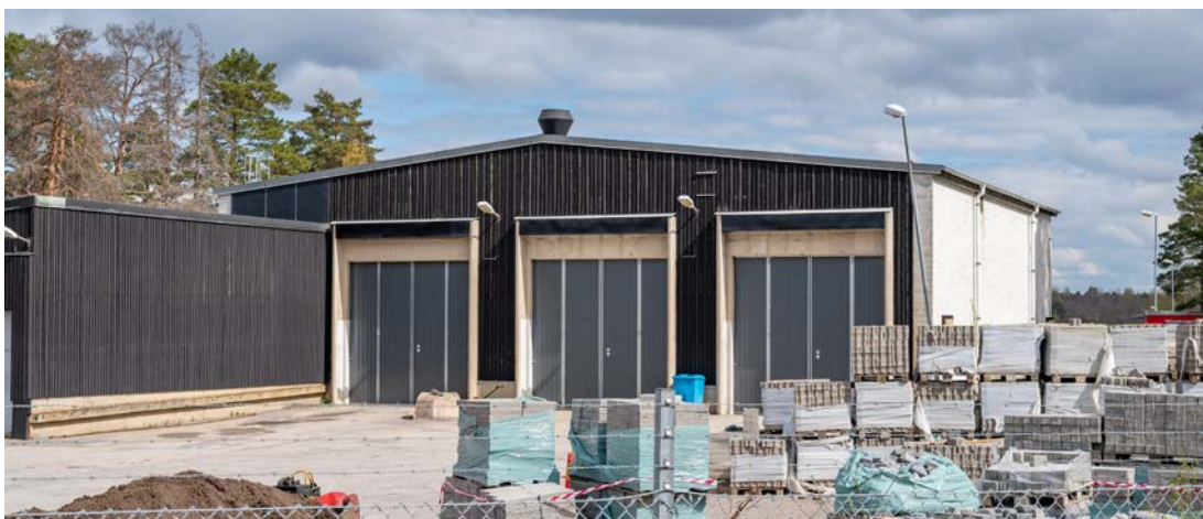
Byggnad 236 uppförd som spolhall 1986, sedd västerifrån. Byggnaden har stomme av lättbetong och trä, med fasadpartier av trä och plåttak. (SLM D2020-0448)
