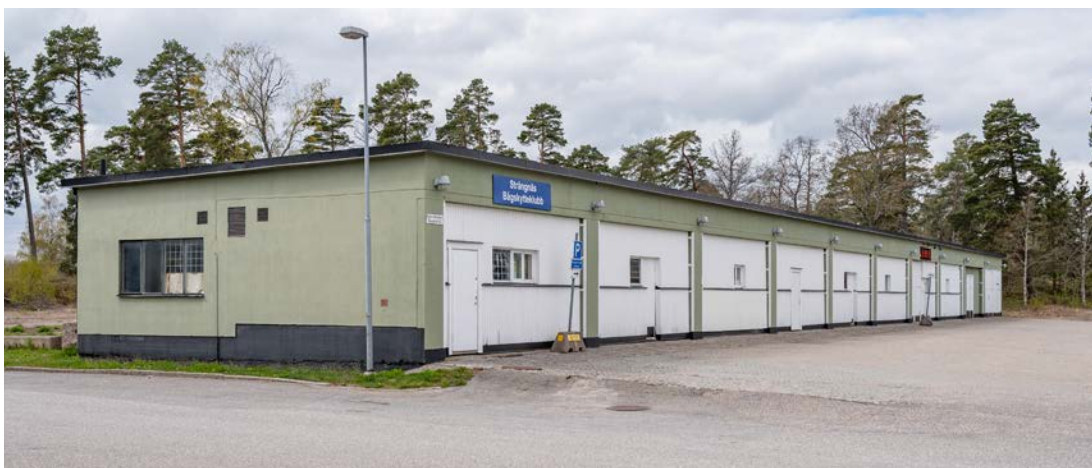
Byggnad 63 sedd österifrån. Byggnaden uppfördes 1940 som varmförråd. Idag används lokalerna av olika mindre verksamheter. Byggnaden har slätputsade fasader och tak av papp. (SLM D2020-0412)
