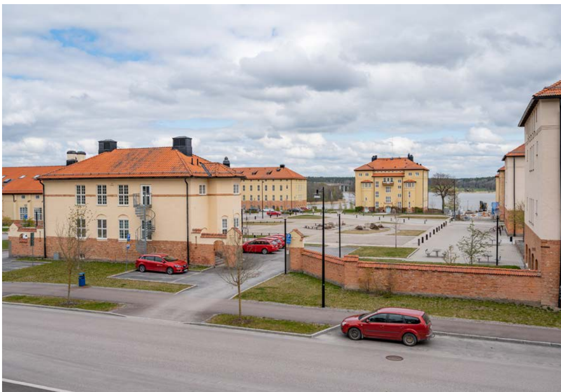
Foto av kaserngården sett söderifrån taget från samma punkt som bilden på sidan 10. De två något ljusare kaser- nerna till höger i bild (byggnad 2 och 3) inrymmer idag Thomasgymnasiet. Kanslibyggnaden till höger i bildens mitt innehåller kontor och kasernbyggnaderna på ömse sidor byggs eller har byggts om till bostäder. (SLM D2020-0410)
