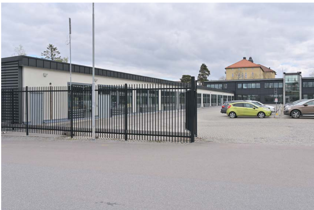
Byggnad 62 sedd västerifrån. Byggnaden ligger utanför utredningsområdet. Fasaderna utåt har försetts med plåt och den gröna färgen har ersatts av en bruten vit. Det är idag svårt att se att det är samma byggnad som på bilden på sid 15. Till höger i bild syns en tvärställd kontorsbyggnad uppförd 2008 med samma typ av plåtfasad. (SLM D2020-0411)
