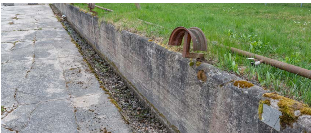
Slanghållare och bakomliggande vattenledning vid spolplatsen. I framkant av uppställningsytan finns går en ränna. Till höger syns en nummerplåt som sannolikt markerar att spolplatsen har nummer 97 i enlighet med byggnadernas numrering. (SLM D2020-0461)
