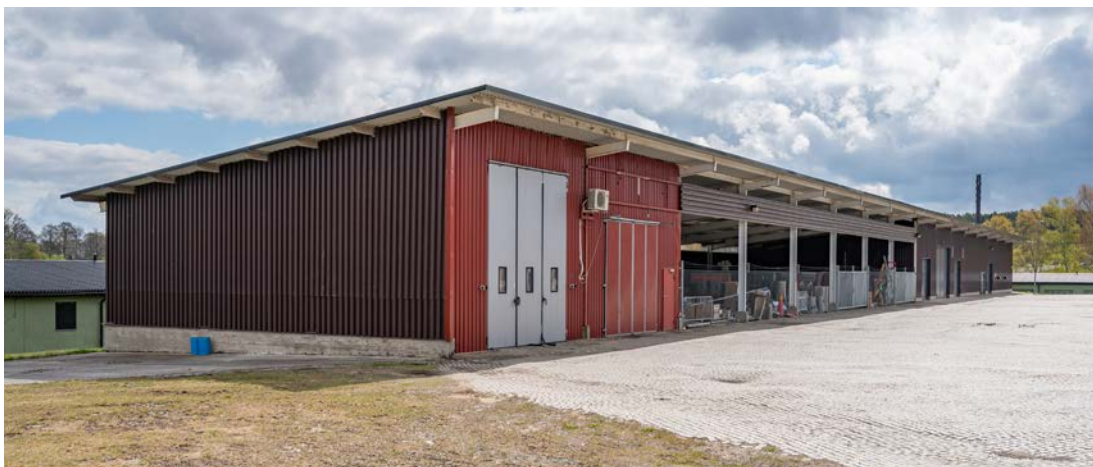
Byggnad 75. Verkstadsförråd uppfört 1984. Byggnaden har stålstomme, plåtfasader och plåttak. (SLM D2020-0437)
