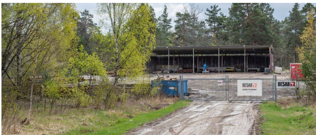
Byggnad 299. Stolplada uppförd på 1980-talet. (SLM D2020-0441)
