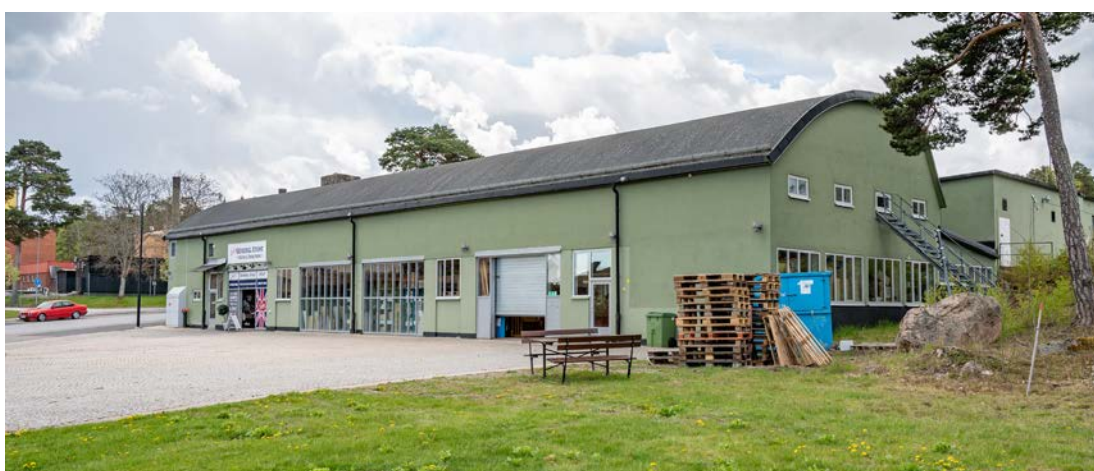
Byggnad 65 sedd från norr. Den rundade delen av takfallet är täckt med papp. Fönstren har bytts ut i senare tid, men har behållit sina stående rektangulära lufter. (SLM D2020-0417)
