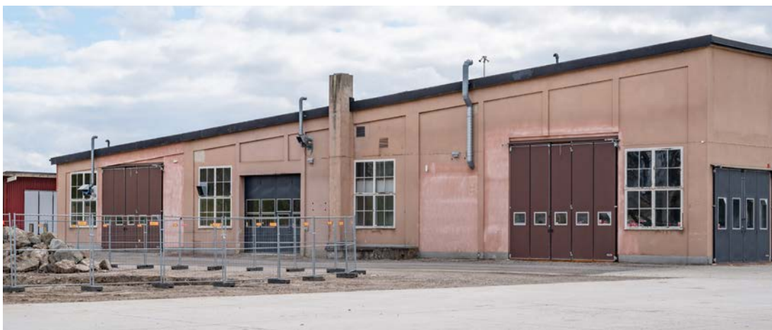
Byggnad 129. Den norra gaveln är relativt välbevarad med stora spröjsade fönster av trä med äldre glas och beslag som bedöms vara ursprungliga. Ett framträdande karaktärsdrag är också fasadytans indelning i fack vilket sannolikt har med stomkonstruktionen att göra. De två yttre portöppningarna har sannolikt gjorts större i senare tid och samtidigt försetts med nya garageportar. (SLM D2020-0436)
