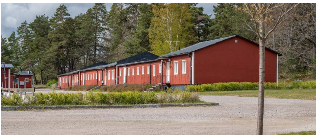
Byggnaderna 201, 202, 208 och 758 innehållande förlägningsrum. Längst till vänster i bild skymtar byggnad 200 som är expeditiönsbyggnad. De tre första uppfördes ursprungligen som fristående baracker men byggdes ihop med mellanliggande delar under 1960-talet. (SLM D2020-0443)
