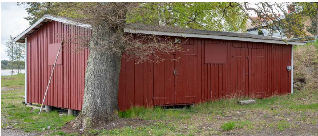
Byggnad 139 uppförd 1941. Används som kallförråd för båtklubben. Byggnaden har en rödmålad träpanel med vita knutar och taket är täckt med papp. (SLM D2020-0424)
