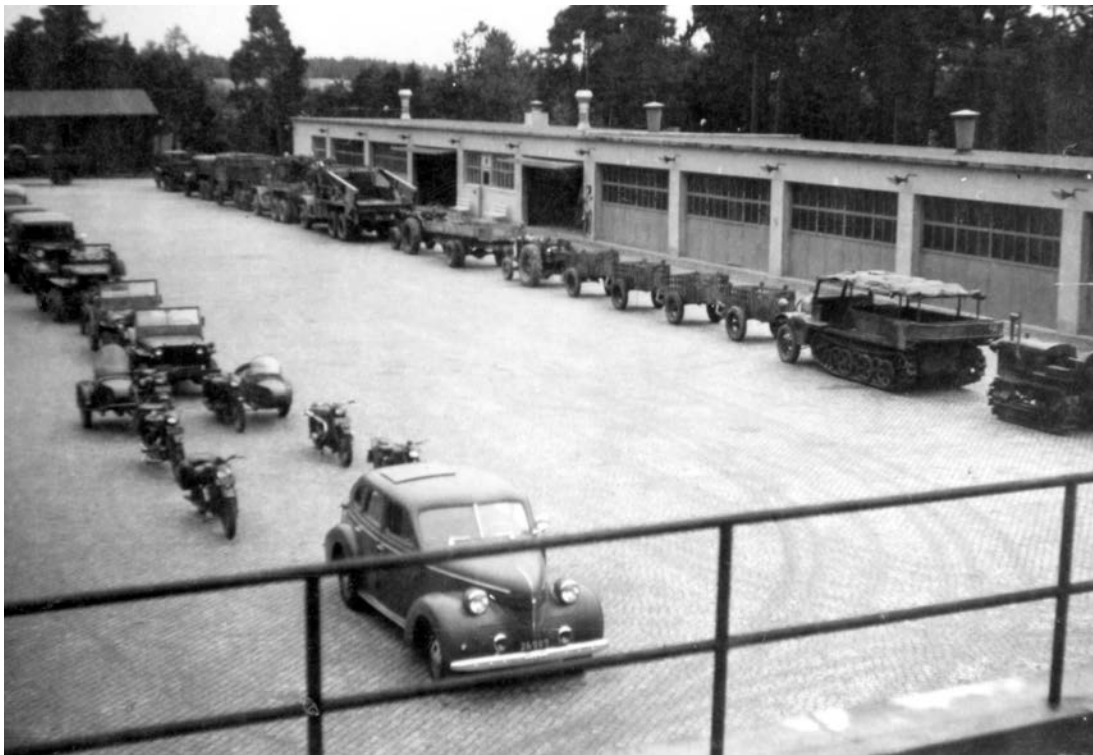
Bild av garagen tillhörande Arméns motorskola väster om kasernområdet (byggnad 62 och 61). Byggnaderna ingick i kasernområdets omvandling och detaljplaneområde och har idag byggts om till kontorslokaler. Fotot är taget under regementets dag 1947. Foto: Sven Olof Ericsson. Bilden är hämtad från Södermanlands Regementes Bildarkiv, Arsenalen.
