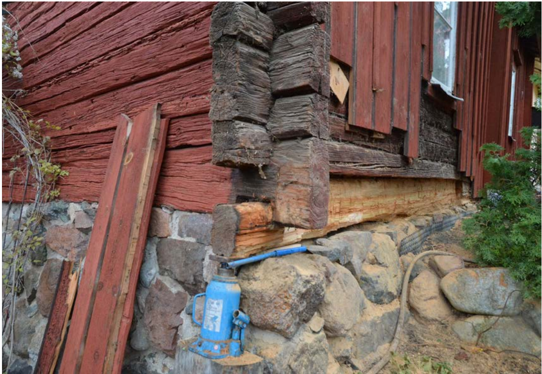
Bild 32. Syllen under pågående halvsulning. Foto 2019-11-08. SLM D2020-0219.
