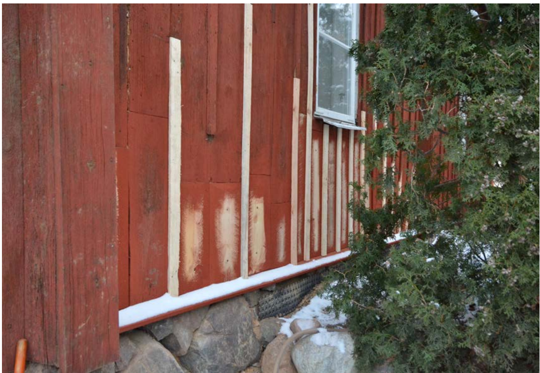
Bild 33. Renoverad locklistfasad. Foto 2019-12-03. SLM D2020-0220.
