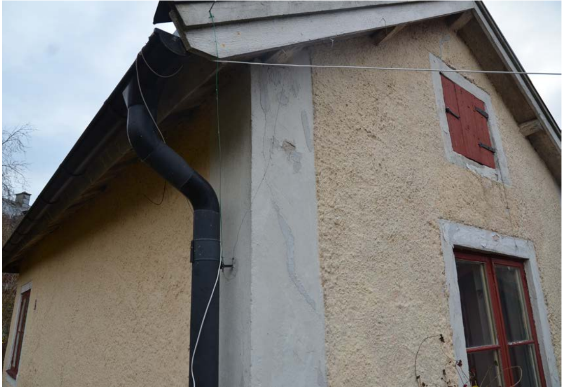
Bild 5. Gårdshusets östra och norra fasader. Notera de skämmande lagningarna på de slätputsade omfattningarna. Foto 2018-11-15. SLM D2020-0 193.
