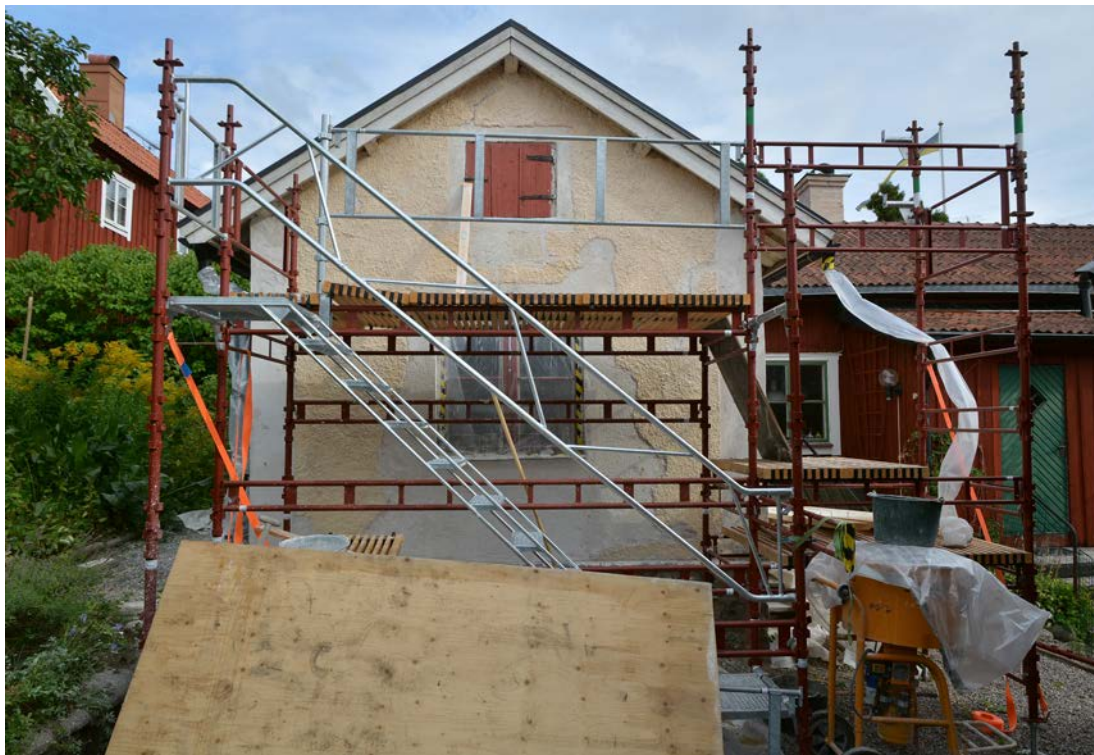
Bild 16. Färdig utstockning av luftkalk på gaveln mot öster. Foto 2019-08-13. SLM D2020-0204.
