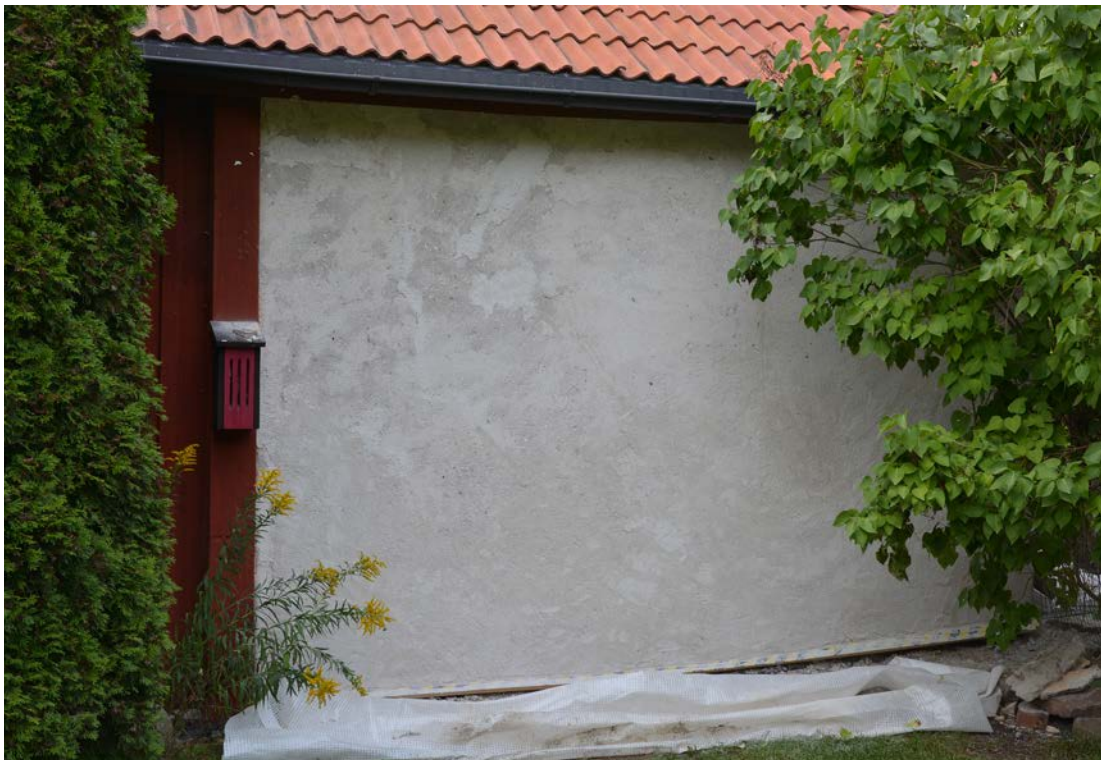
Bild 23. Färdig utstockning av luftkalk på västra fasaden. Foto 2019-08-13. SLM D2020-0211.
