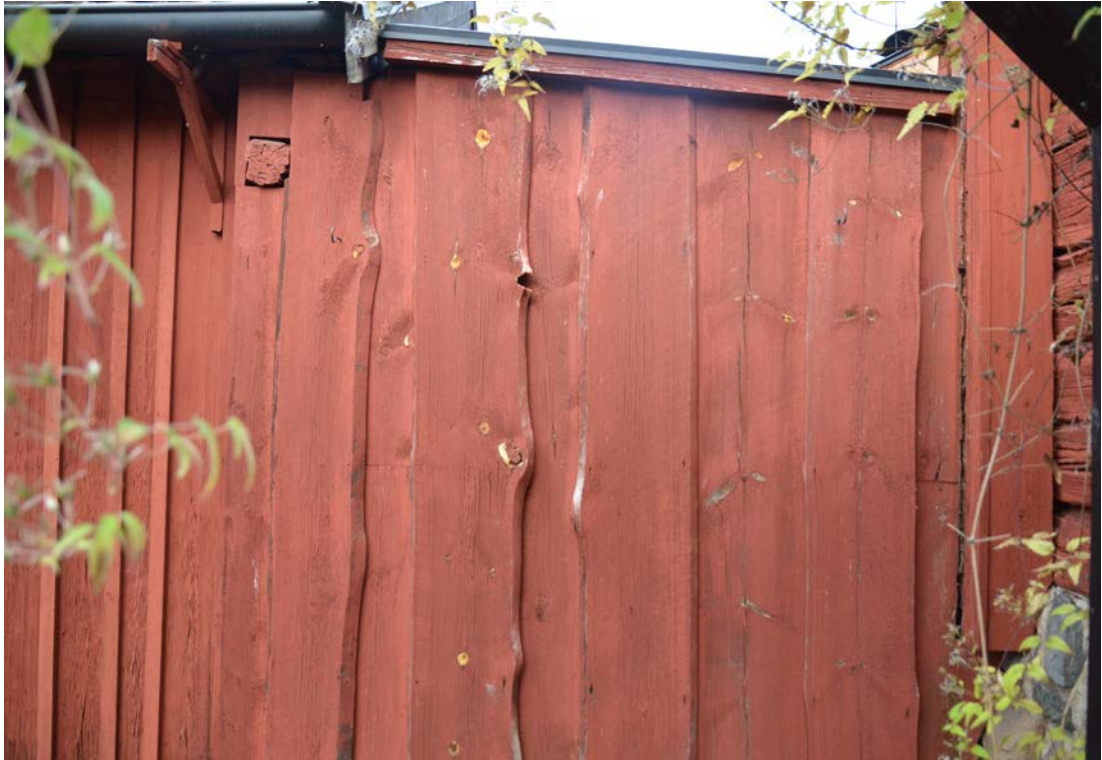
Bild 9. Plank som åtskiljer fastigheterna Helsingen 3 och 4. Knutlådan till höger i bild var något rötskadad. Foto 2018-11-15. SLM D2020-0197.
