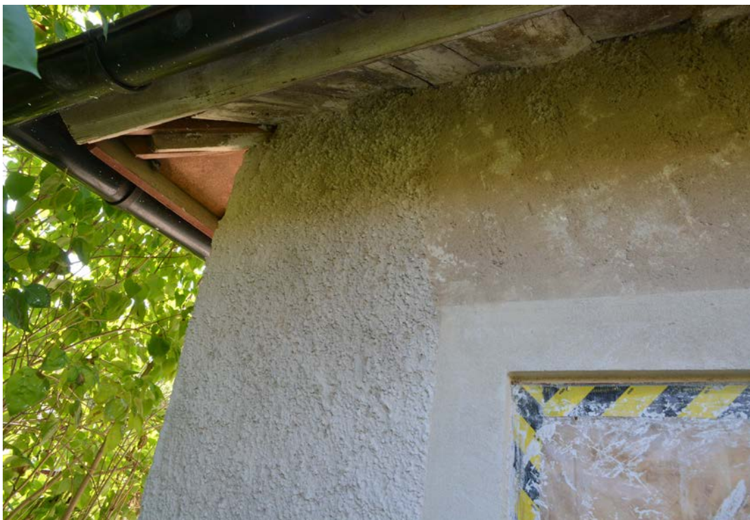
Bild 25. Pågående spritputsning på norra fasaden. Foto 2019-08-28. SLM D2020-0213.
