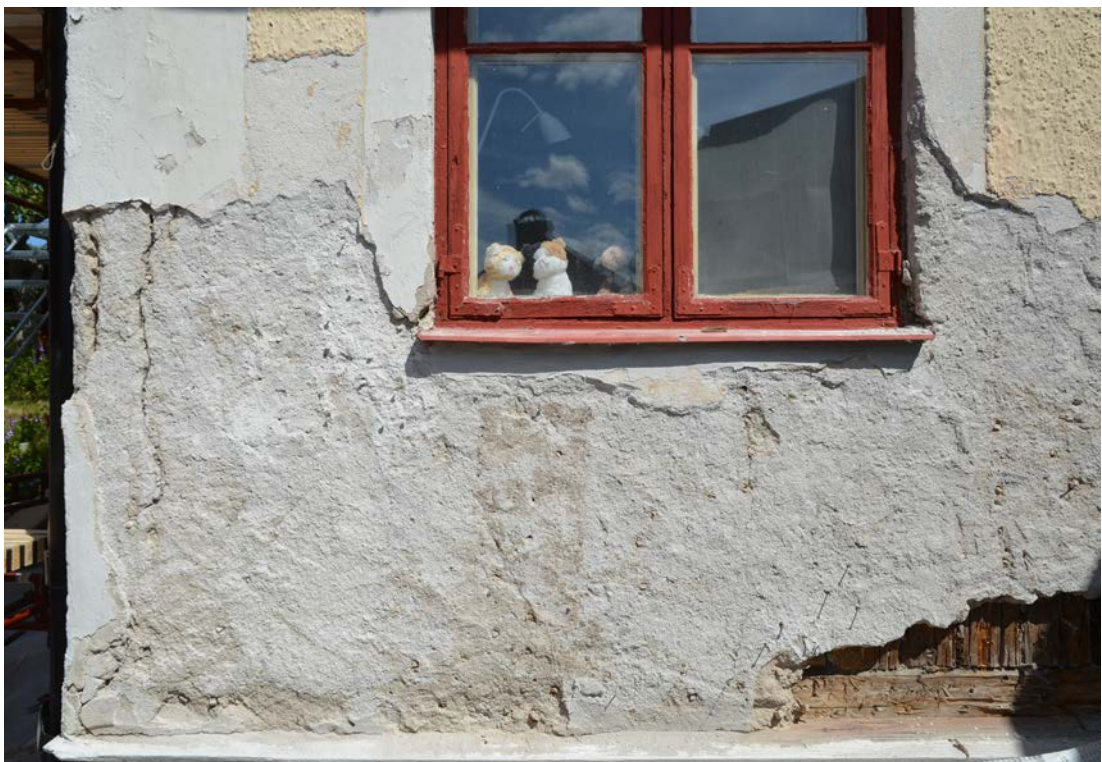
Bild 12. Entréfasaden mot söder under pågående renovering. Foto 2019-07-10. SLM D2020-0200.
