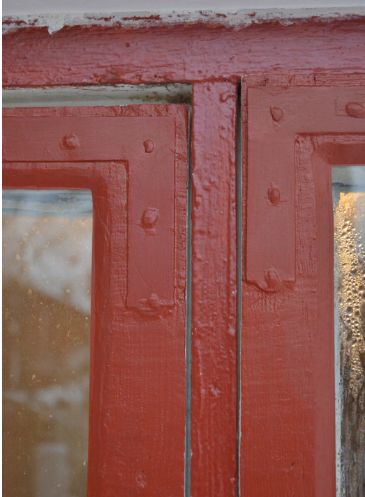
Bild 39. Nyligen renoverad fönsterbåge. Foto 2019-12-03. SLM D2020-0226.
