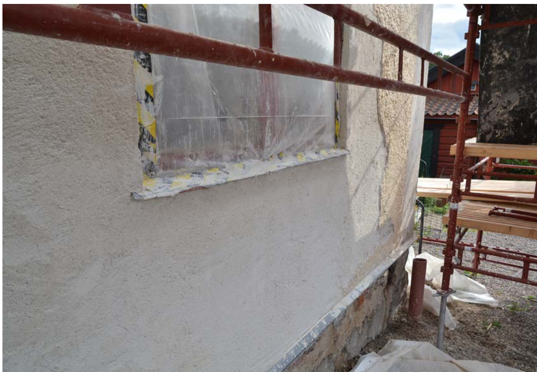
Bild 20. Färdig utstockning av luftkalk på gaveln mot öster. Foto 2019-08-13. SLM D2020-0208.
