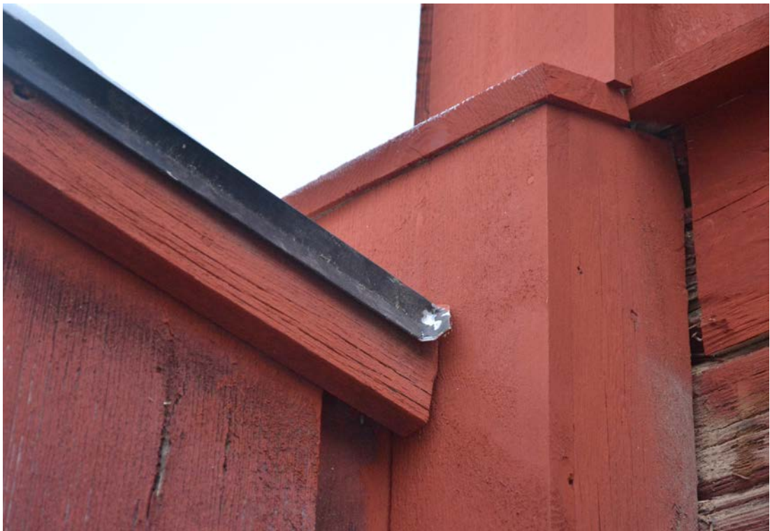
Bild 37. Plåten på plankets krön böjdes till för att leda bort rinnande vatten från knutlådan. Foto 2019-12-03. SLM D2020-0224.
