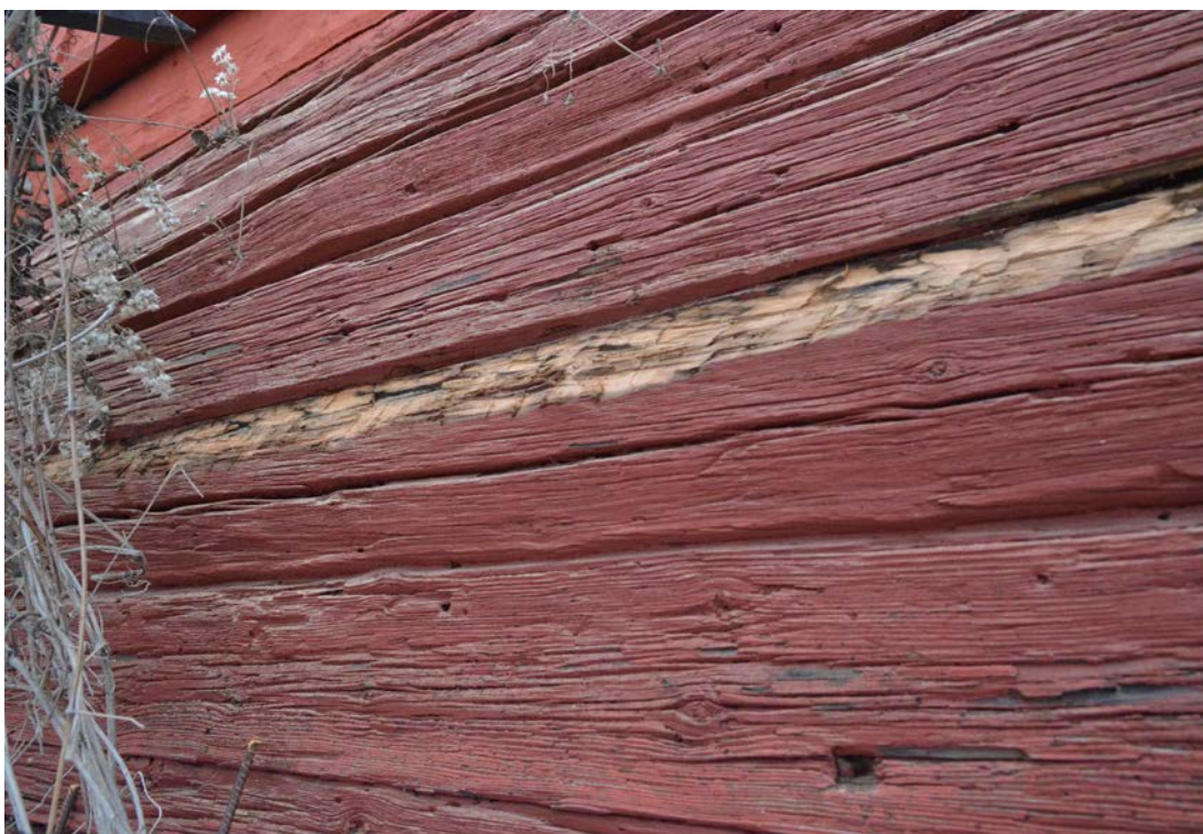
Bild 35. Yteroderad splintved bilades bort. Foto 2019-12-03. SLM D2020-0222.
