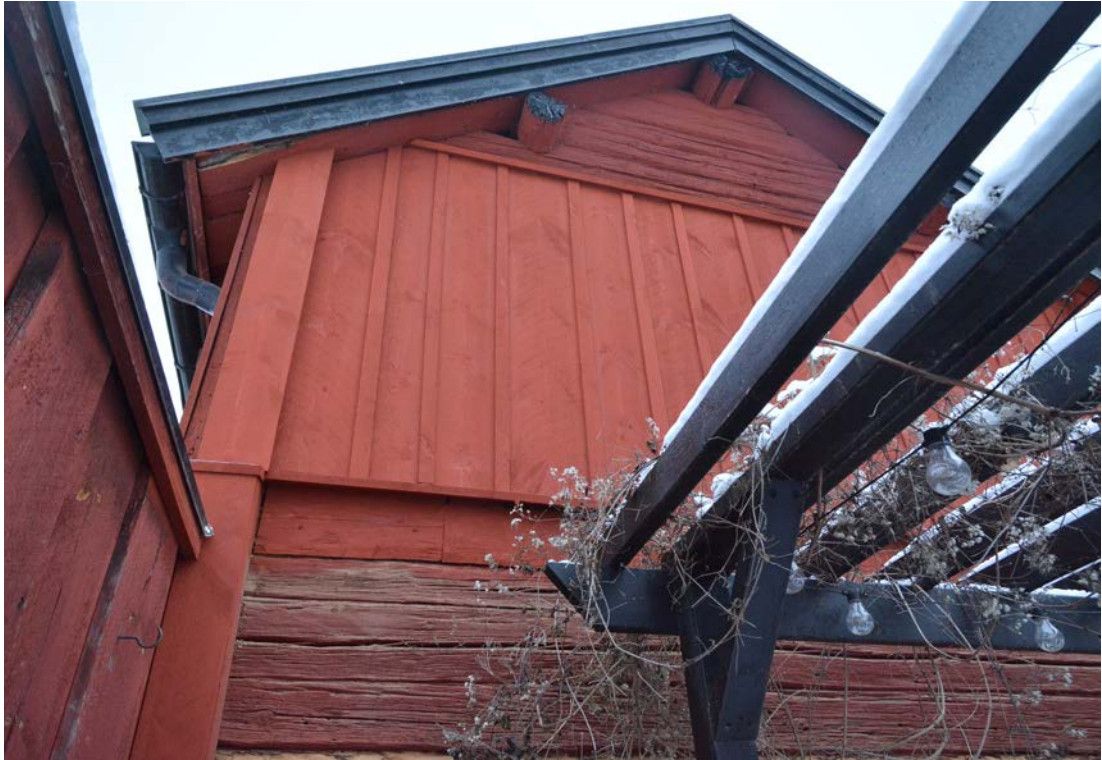
Bild 36. Ny kilsågad locklistpanel på södra gaveln. Foto 2019-12-03. SLM D2020-0223.
