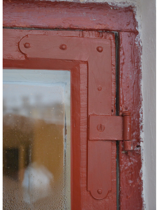
Bild 40. Nyligen renoverad fönsterbåge. Foto 2019-12-03. SLM D2020-0227.
