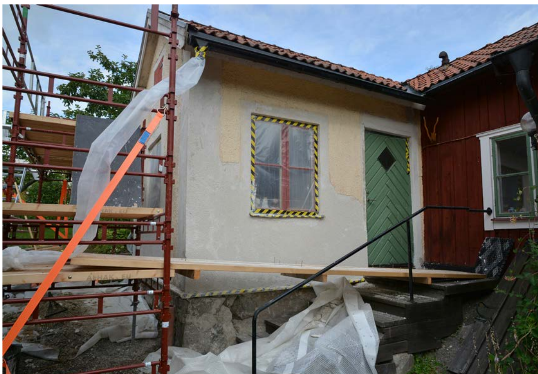
Bild 17. Färdig utstockning av luftkalk på entréfasaden mot söder. Foto 2019-08-13. SLM D2020-0205.
