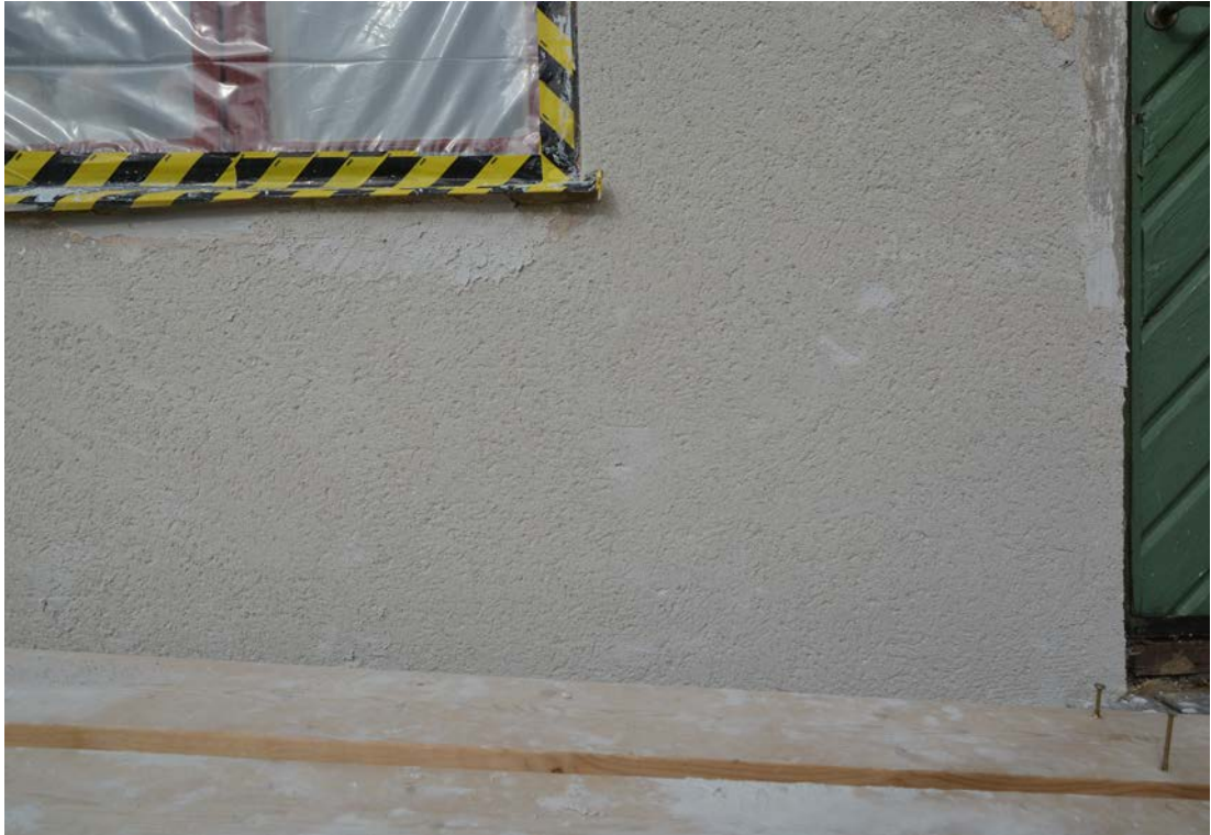
Bild 18. Färdig utstockning av luftkalk vid entrén. Foto 2019-08-13. SLM D2020-0206.
