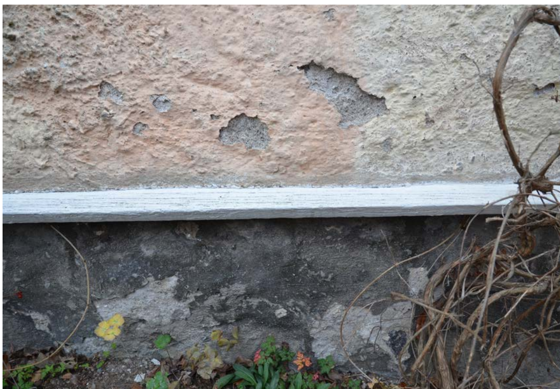
Bild 4. Sockel och fasad på östra gaveln. Foto 2018-11-15. SLM D2020-0192.
