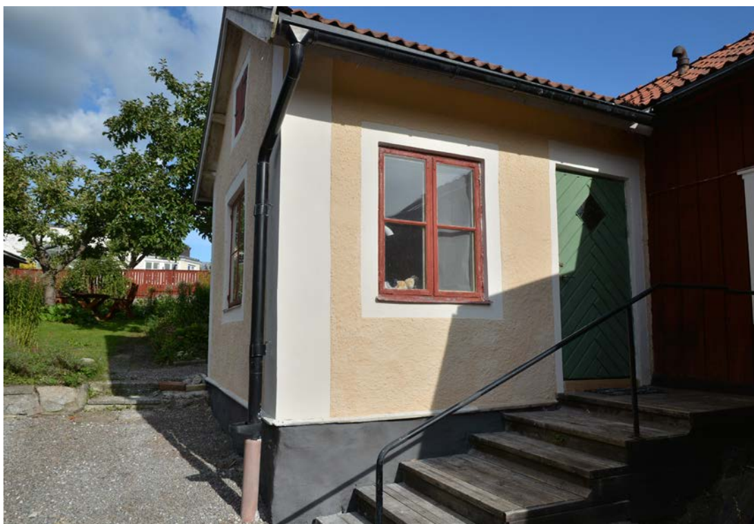
Bild 28. Gårdshusets östra och södra fasader efter avslutad avfärgning. SLM D2020-0216.
