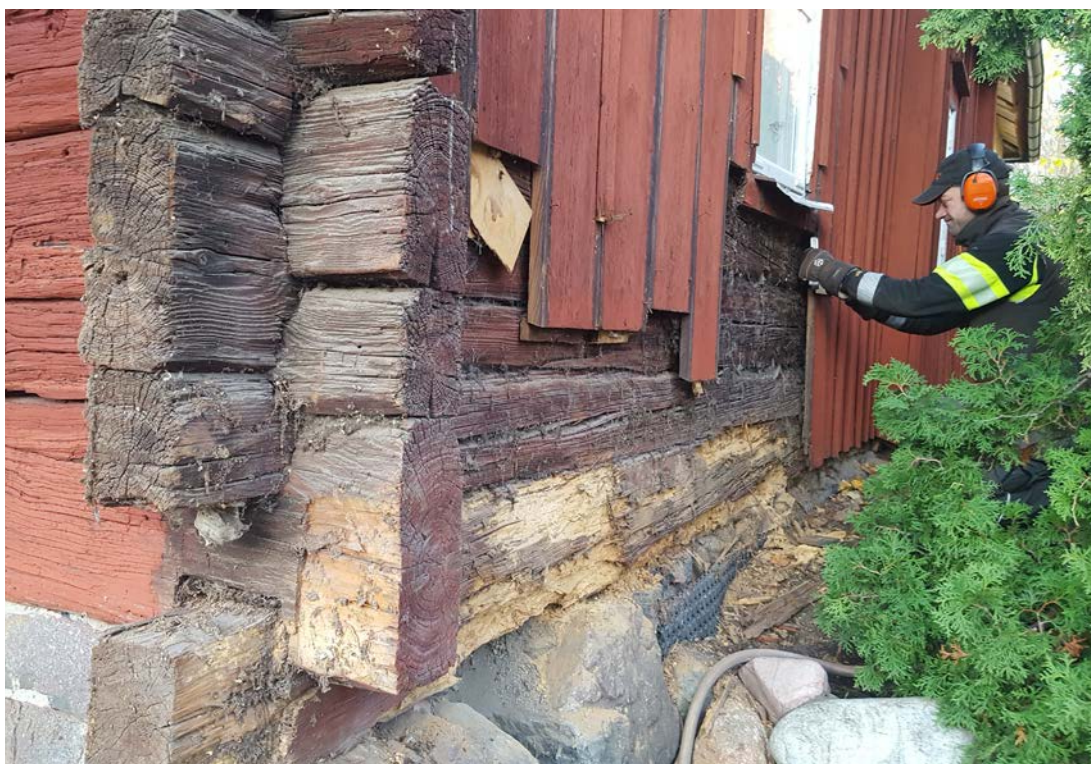
Bild 31. Pågående renovering. Foto 2019-11-05, Ulrich Nitsch.
