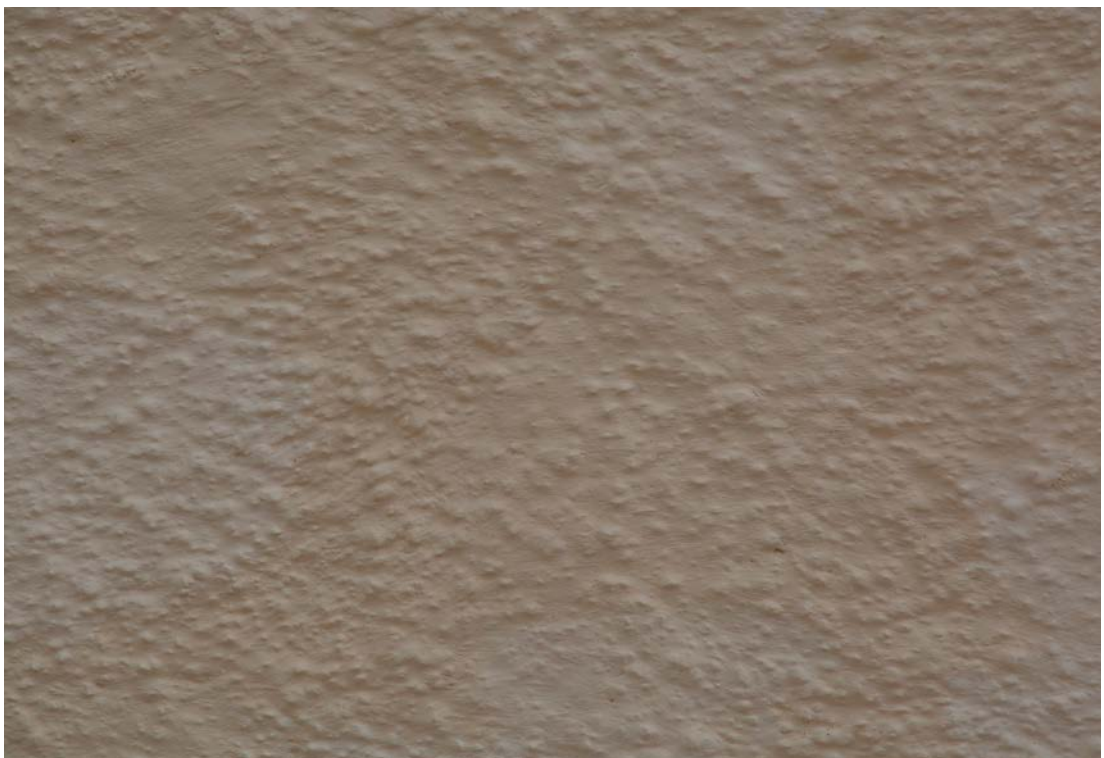
Bild 26. Nyligen avfärgad spitputs. Foto 2019-09-17. SLM D2020-0214.
