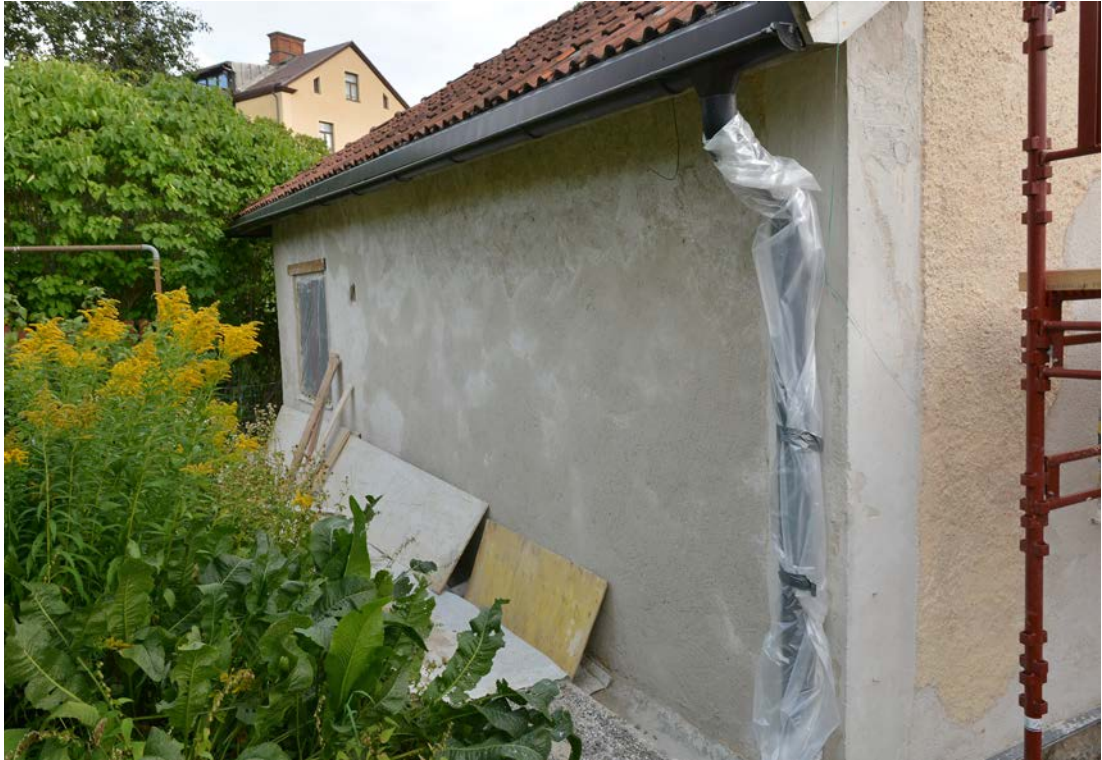
Bild 22. Färdig utstockning av luftkalk på norra fasaden. Foto 2019-08-13. SLM D2020-0210.
