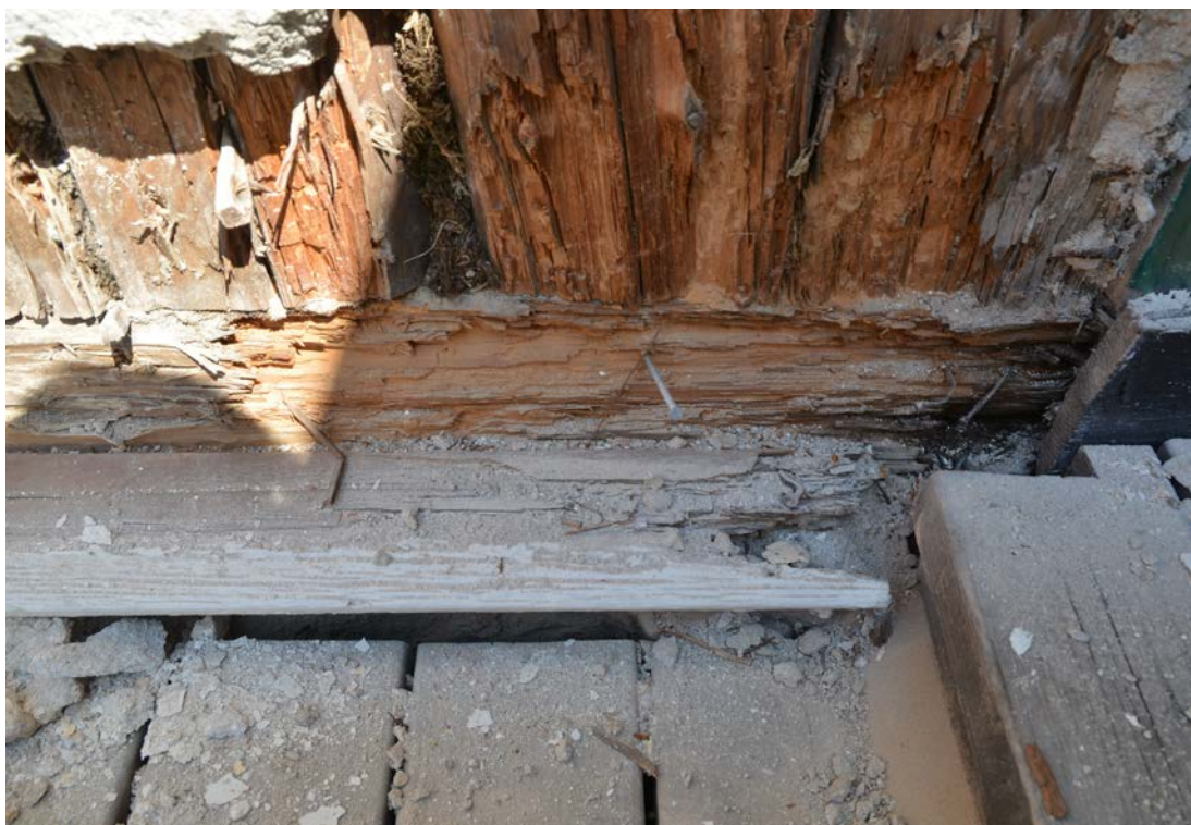
Bild 13. Entréfasaden mot söder under pågående renovering. Förutom träpliggar satt också trådspik till fäste för utstockningen. Foto 2019-07-10. SLM D2020-0201.
