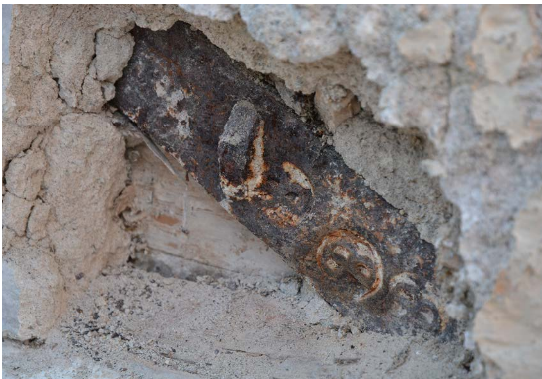
Bild 42. Hörnjärn med stämplor. Foto 2019-07-10. SLM D2020-0229.
