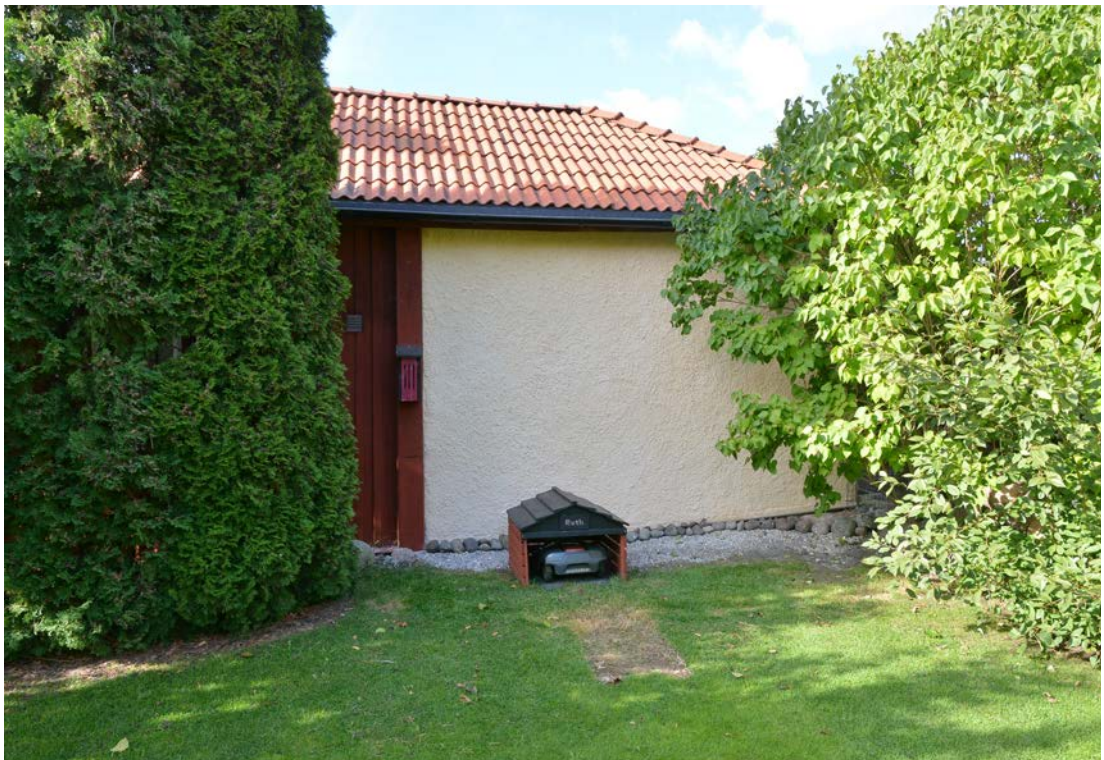
Bild 30. Gårdshusets västra fasad efter avslutad avfärgning. Foto 2019-09-17. SLM D2020-0218.
