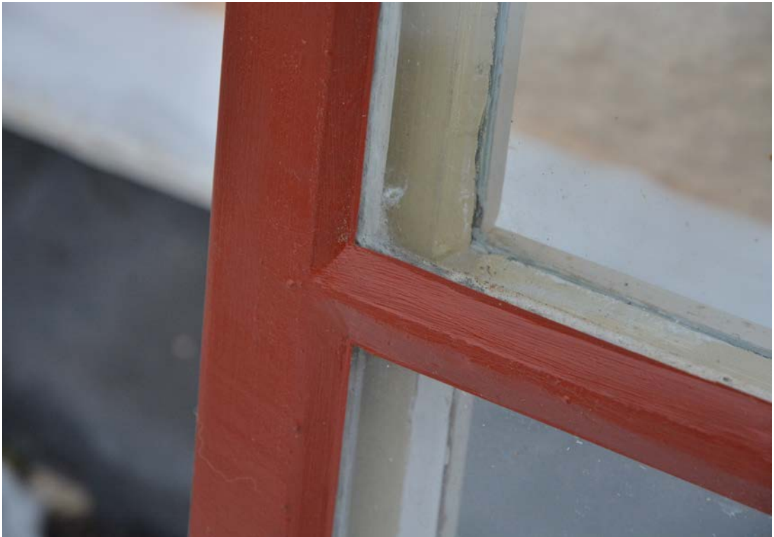
Bild 41. Nyligen renoverad fönsterbåge. Foto 2019-12-03. SLM D2020-0228.
