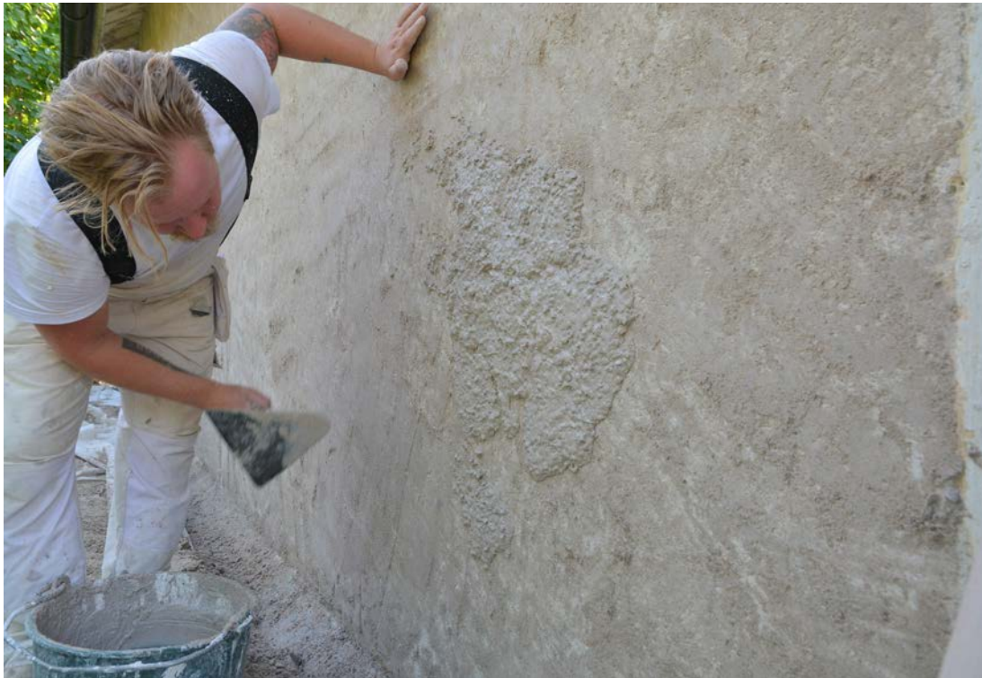
Bild 24. Spritputsens struktur och ytgräng kontrolleras. Foto 2019-08-28. SLM D2020-0212.
