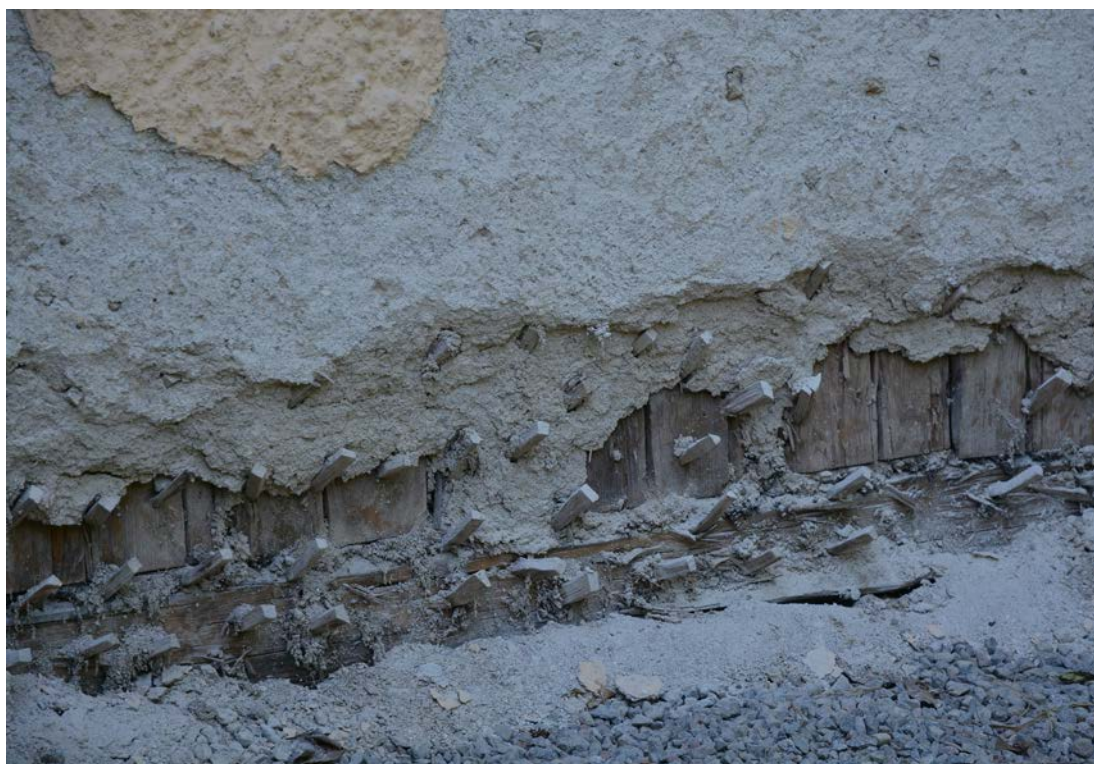
Bild 15. Västra fasaden under pågående renovering. Foto 2019-07-10. SLM D2020-0203.
