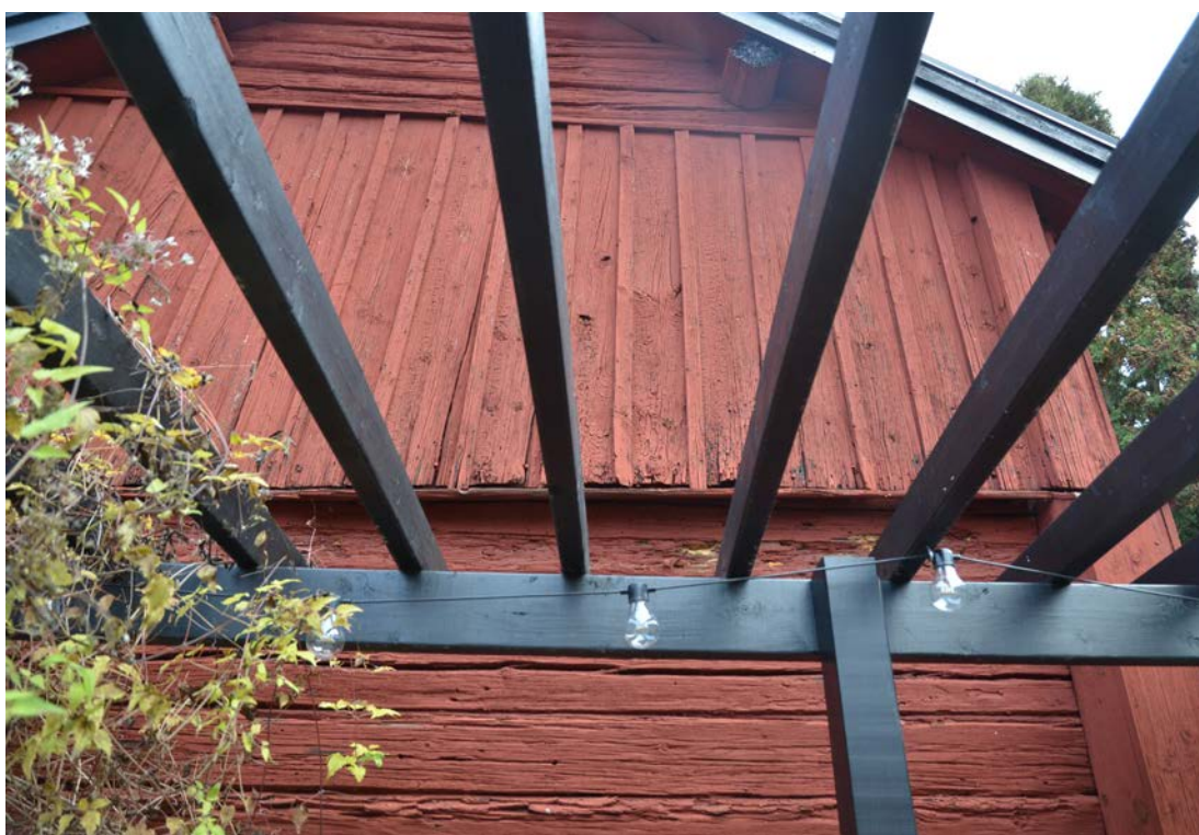
Bild 8. Gaveln mot söder. Foto 2018-11-15. SLM D2020-0196.
