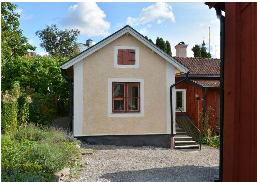
Bild 43. Gropgårdens gårdshus efter avslutad putsrenovering. Foto 2019-09-17. SLM D2020-0189.
