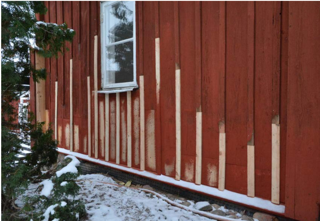
Bild 34. Renoverad locklistfasad. Foto 2019-12-03. SLM D2020-0221.
