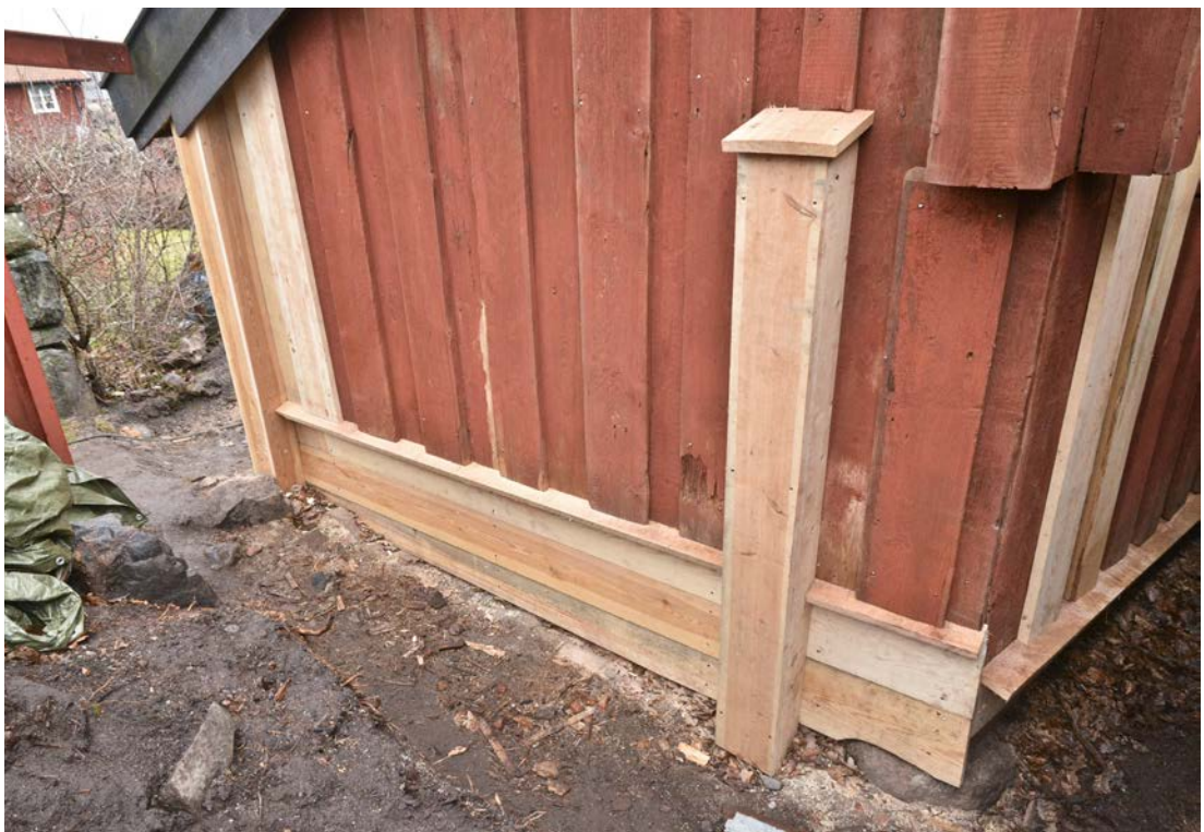
Bild 16. Västra gaveln efter avslutade trälagningar. Foto: 2020-01-29. (SLM D2020-0753)
