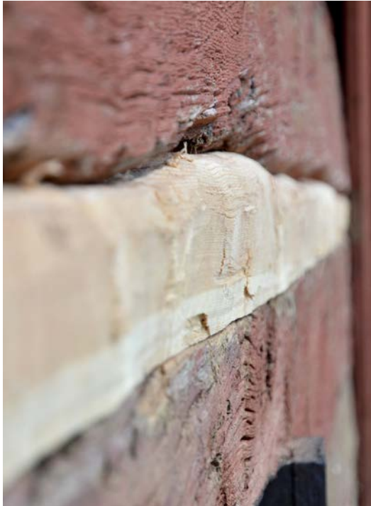
Bild 27. Ilgning med nytt virke i norra fasadens östra del. Nya delar bilades för hand till ytstruktur lika befintligt timmer. Foto: 2020-03-10. (SLM D2020-0764)
