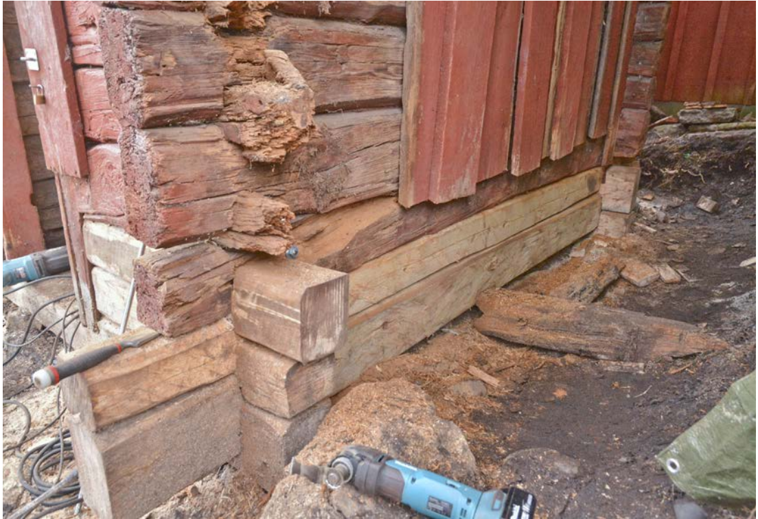
Bild 15. På västra gaveln byttes de två nedersta stockarna, innan panelen spikades tillbaka och delvis renoverades. Foto: 2019-12-19. (SLM D2020-0752)
