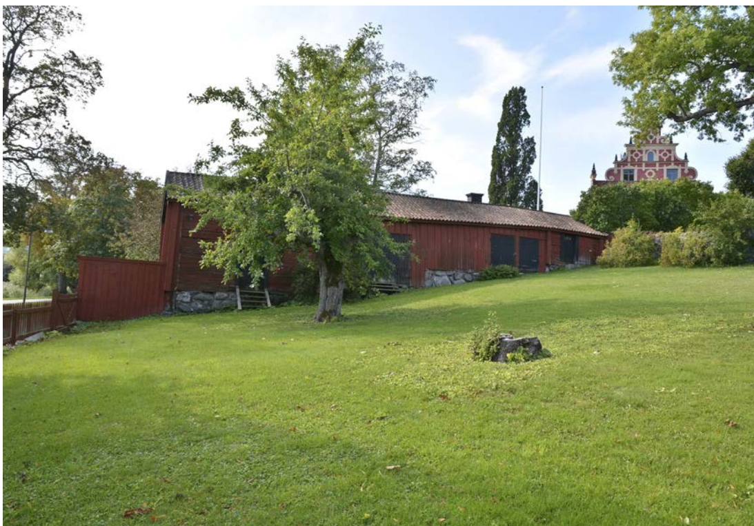
Bild 3. Uthusets norra fasad innan renovering. Till höger i bilden syns Biskopsgårdens karakteristiska renässansgavel. Foto: 2019-09-17. (SLM D2020-0740)
