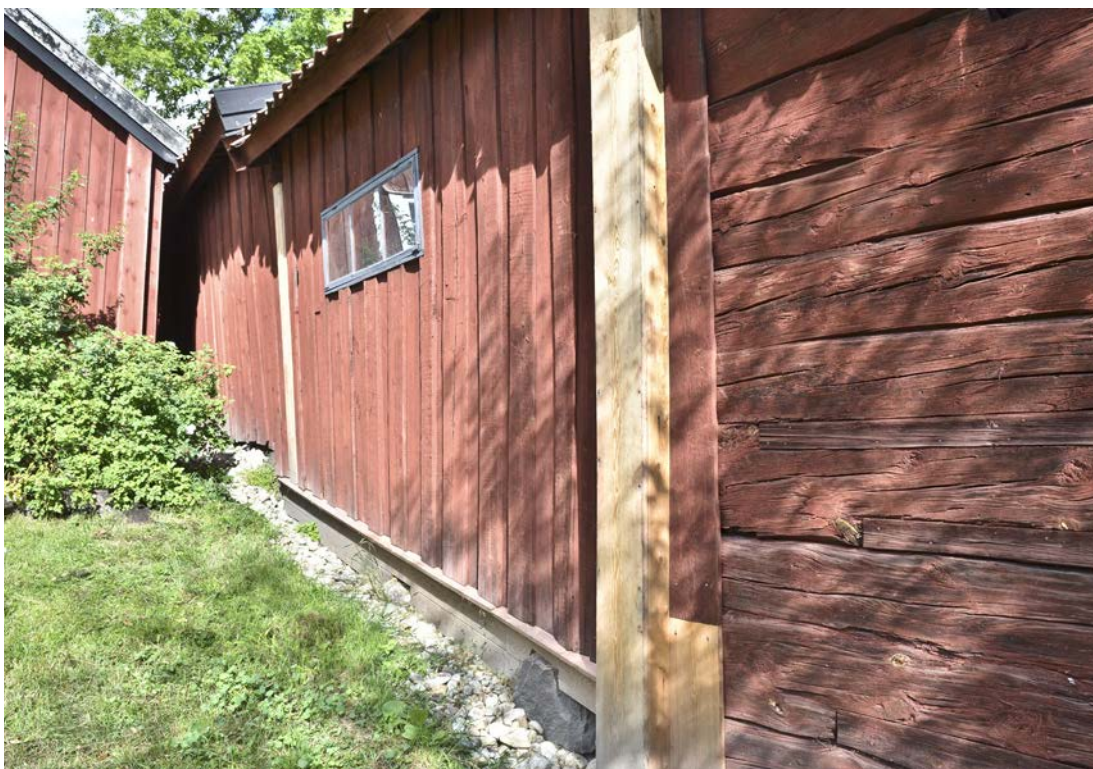
Bild 32. Södra fasaden, strax nedanför (öster om) Biskopsgårdens uthus. Lockpanelens ruttna ändträ kapades. Den övre delen av syllen timmerlagades. Likt gaveln och övriga delar på södra fasaden monterades offerbrädor och en vattbräda. Enstaka panelbrädor skarvades. Foto: 2020-08-31. (SLM D2020-0769)
