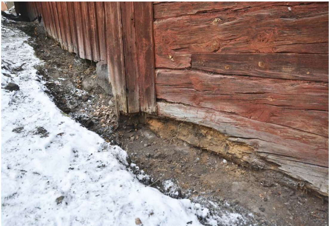
Bild 14. Södra fasadens östra del efter att jordmassorna schaktats bort. Foto: 2019-12-03. (SLM D2020-0751)
