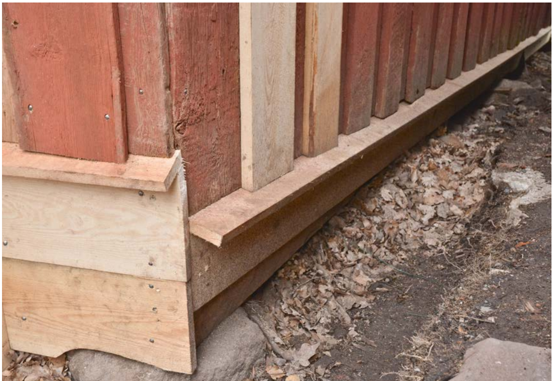
Bild 20. Hörnet mellan västra gaveln och norra fasaden efter avslutade trälagningar. Foto: 2020-02-17. (SLM D2020-0757)
