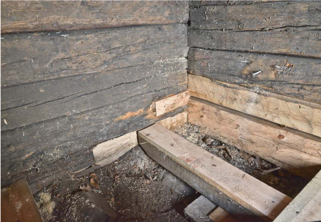
Bild 17. Boden i västra gaveln (vy mot sydväst). Golvbjälkarna kompletterades med brädor för att tillskapa ytterligare höjd mellan golvplankorna och marken. Till höger syns gavelns nya timmer. Foto: 2020-02-17. (SLM D2020-0754)
