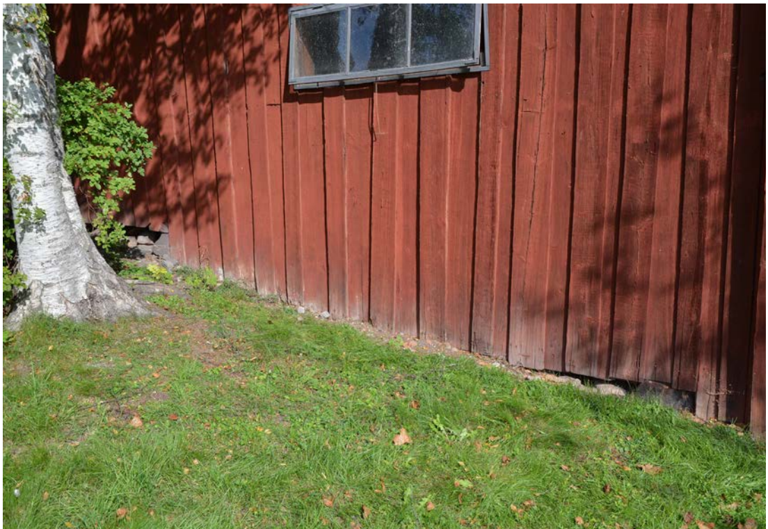
Bild 6. Södra fasaden strax nedanför Biskopsgårdens uthus, innan renovering. Foto: 2019-09-17. (SLM D2020-0743)
