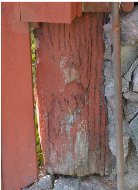
Bild 39. Stående timmerstock vid byggnadens nordöstra hörn. Betongen intill bilades bort under arbetet. Foto: 2019-09-17. (SLM D2020-0771)
