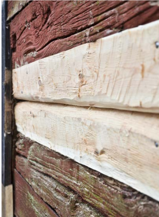
Bild 25. Ilagning med nytt virke i norra fasadens östra del. Foto: 2020-03-10. (SLM D2020-0762)
