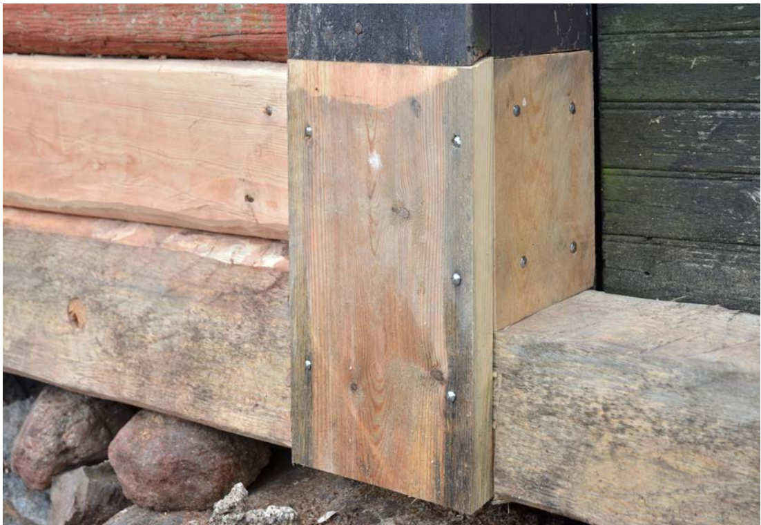
Bild 23. Syllstock och halvsulning samt skarvad panel spikad med handsmidd spik. Foto: 2020-03-10. (SLM D2020-0760)
