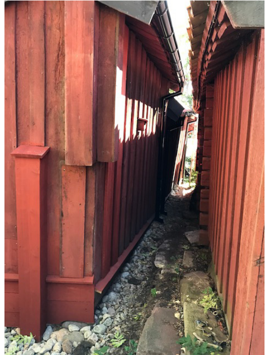
Bild 34. Foto: Ulrika Gräns, Statens Fastighetsverk
