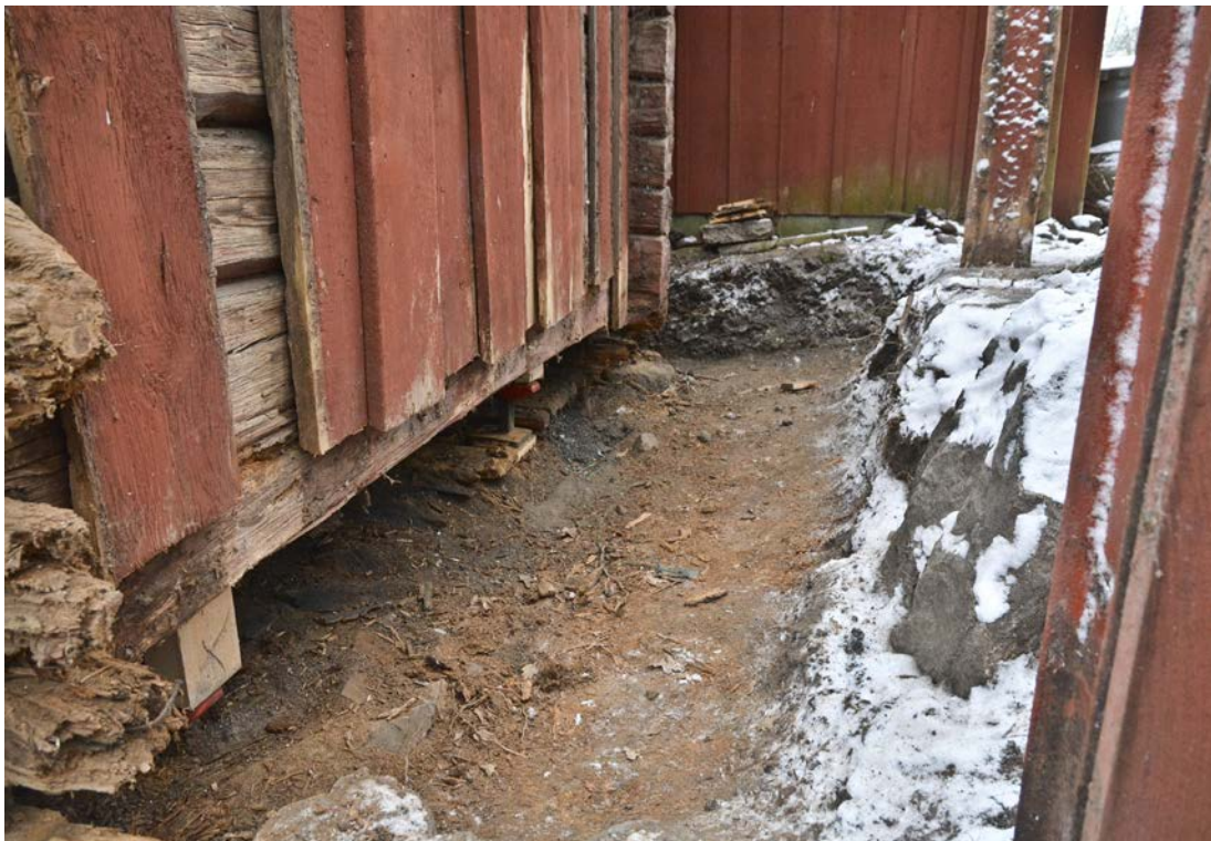
Bild 12. Västra gaveln efter att jordmassorna som begravt stommens och fasadens nederdel schaktats bort. Foto: 2019-12-03. (SLM D2020-0749)
