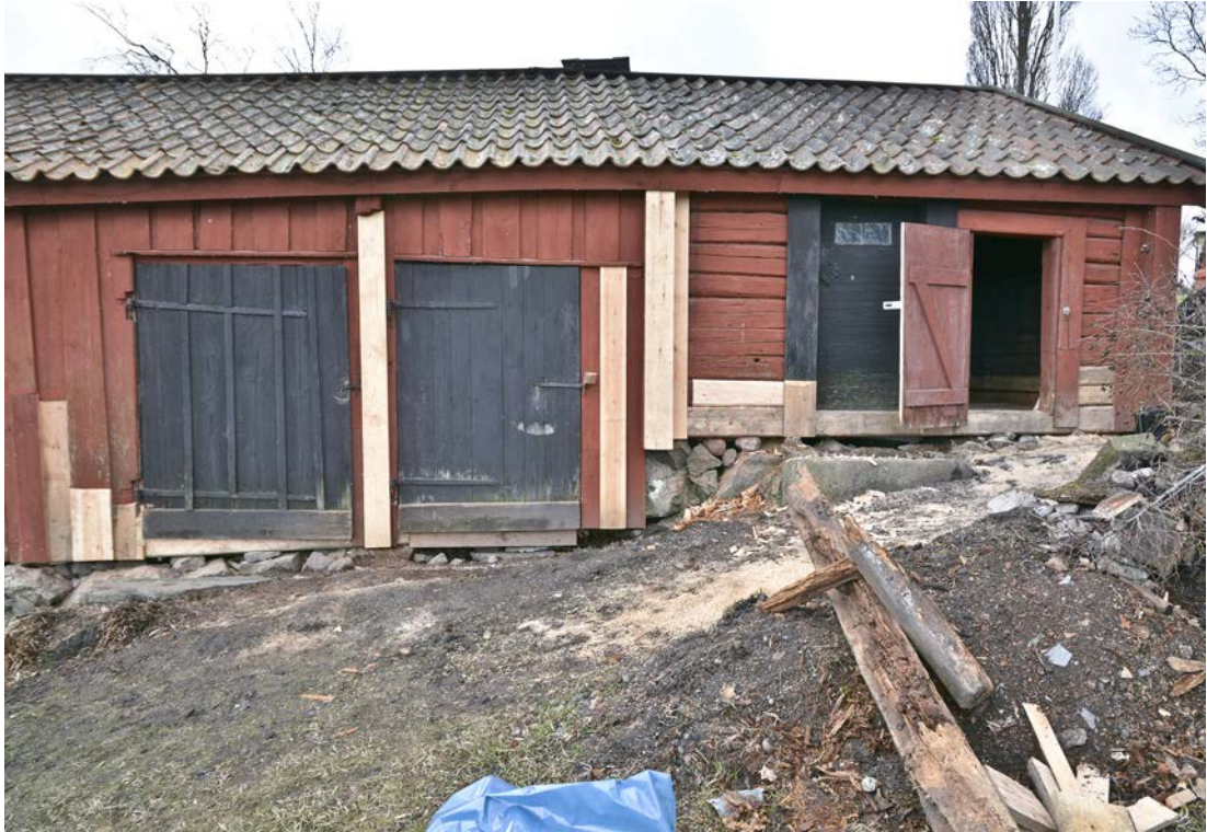
Bild 22. Norra fasadens västra del efter avslutade trälagningar. Foto: 2020-02-17. (SLM D2020-0759)
