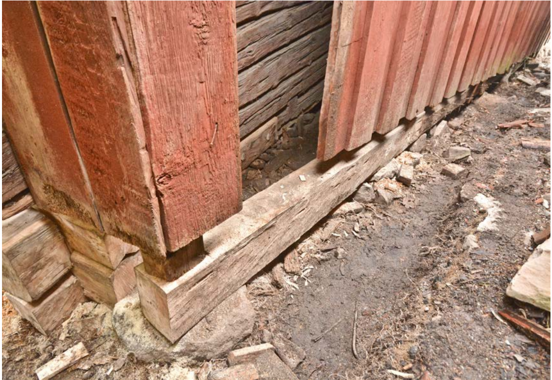
Bild 19. Hörnet mellan västra gaveln och norra fasaden under pågående trälagningar. I hålet bakom den rödfärgade fasaden syns innerväggens skarvade och dymlade syll. Foto: 2019-12-19. (SLM D2020-0756)
