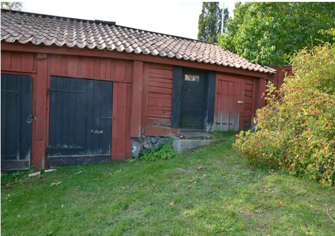
Bild 9. Norra fasadens västra del, innan renovering. Foto: 2019-09-17. (SLM D2020-0746)
