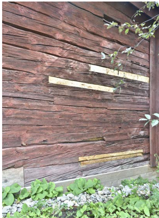
Bild 31. Mindre trälagningar på södra fasadens östra del. I bildens nedre vänstra hörn syns den skarvade syllstocken. Foto: 2020-08-31 (SLM D2020-0768)
