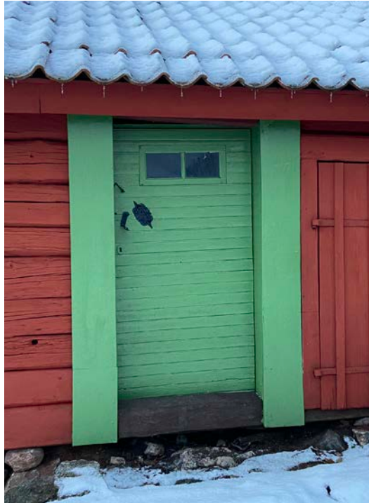
Bild 37. Dörren längst åt väster efter målning med linoljefärg. Fodren skulle dock ha målats med röd slamfärg. Foto: Jörgen Malm, SFV
