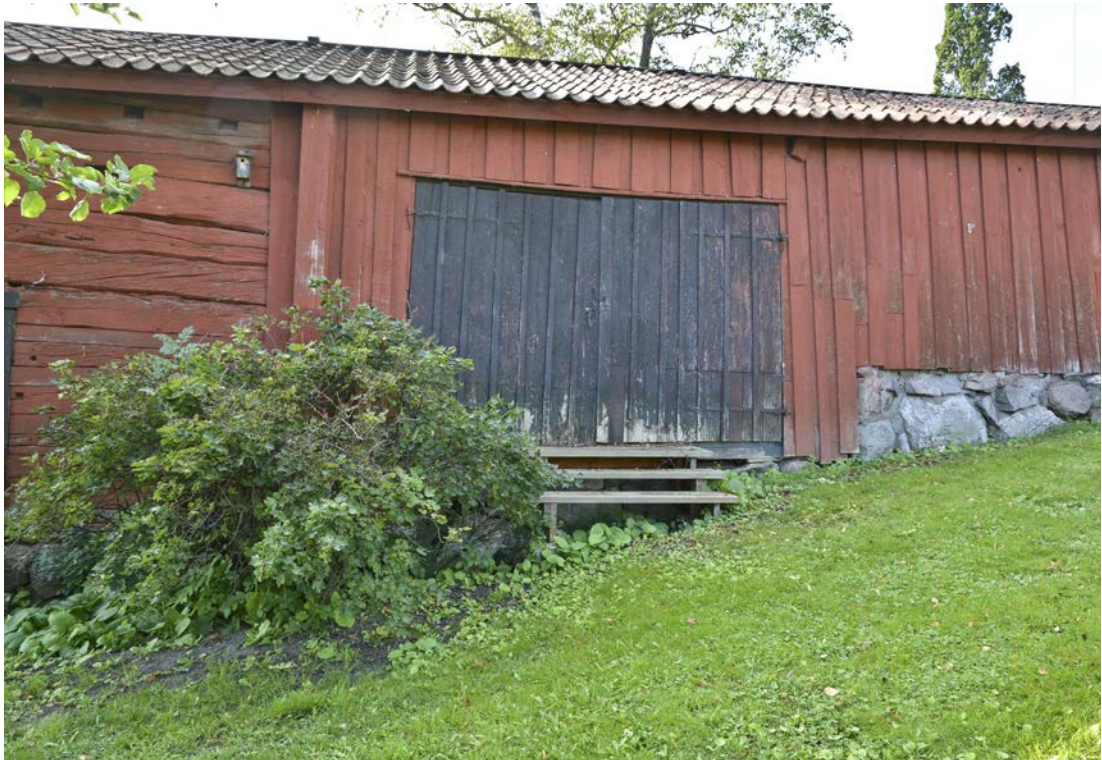
Bild 10. Norra fasadens mittersta del, innan renovering. Foto: 2019-09-17. (SLM D2020-0747)
