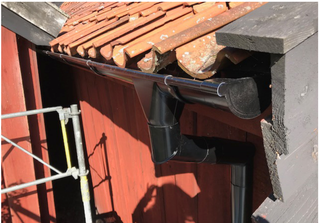
Bild 35. Foto: Ulrika Gräns, Statens Fastighetsverk
