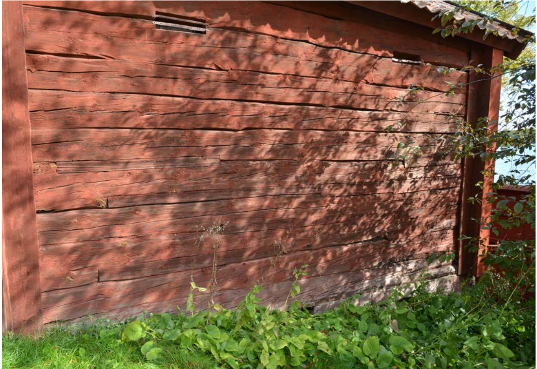
Bild 5. Södra fasadens östra del innan renovering. Foto: 2019-09-17. (SLM D2020-0742)
