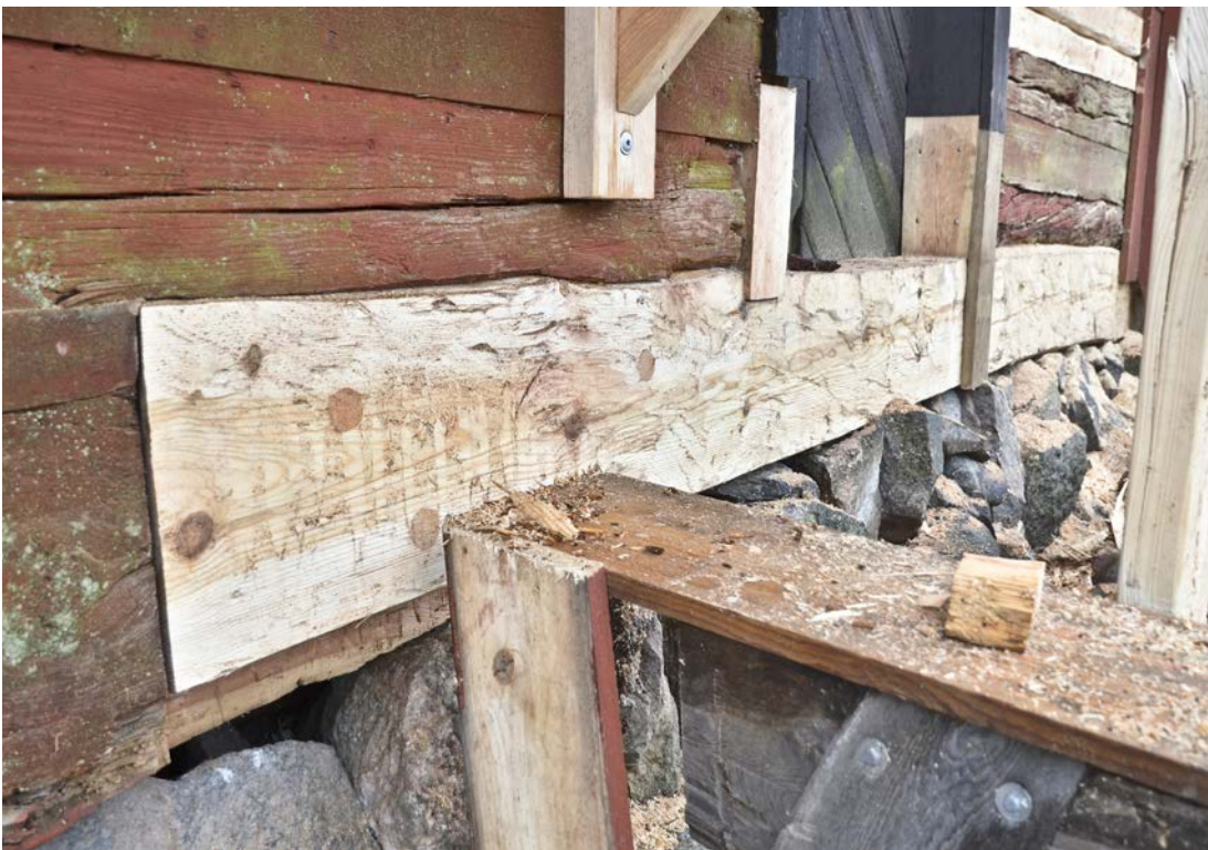
Bild 26. Skarvad och dymlad syllstock i norra fasadens östra del. Foto: 2020-03-10. (SLM D2020-0763)
