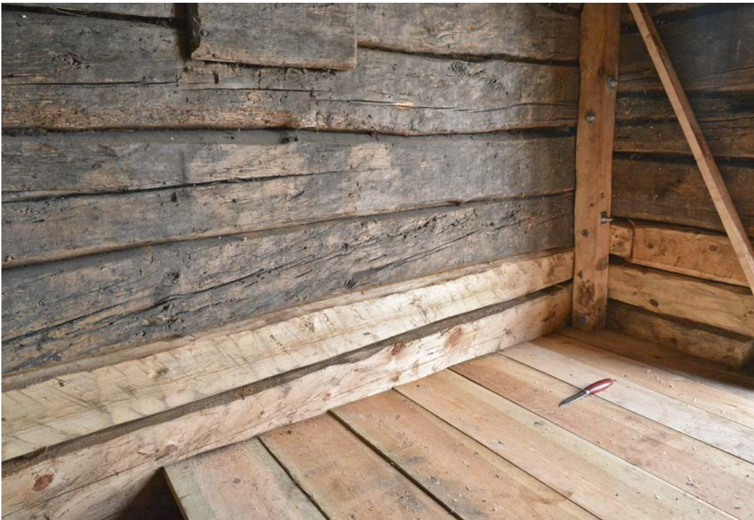
Bild 18. Boden i västra gaveln (vy mot nordväst). Pågående golvrenovering. Till höger syns hörnet mellan västra och norra väggen, där en spännbjälke monterats för att ge knutarna bättre stadga. Foto: 2020-02-17. (SLM D2020-0755)
