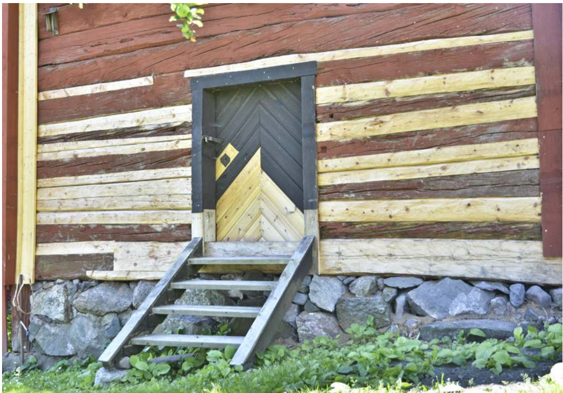
Bild 29. Norra fasadens östra tillika byggnadens äldsta del, efter avslutade trälagningar. Foto: 2020-07-23. (SLM D2020-0766)
