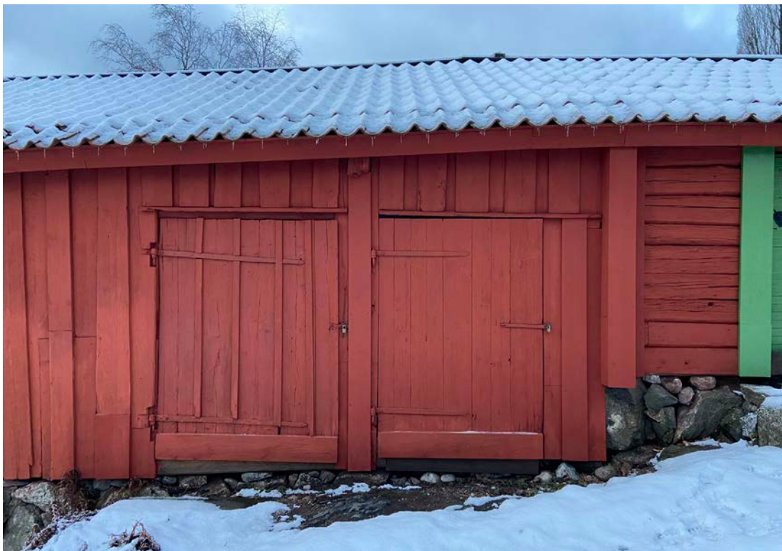
Bild 38. Plankdörrarna efter rödfärgning med slamfärg. Foto: Jörgen Malm, SFV
