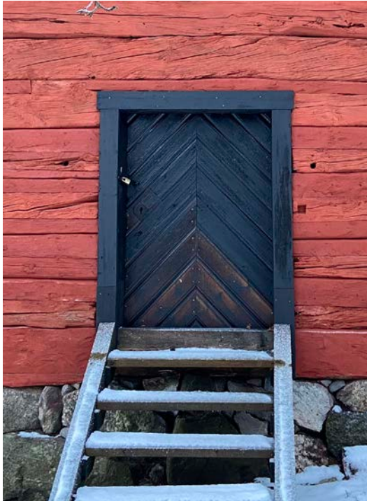
Bild 36. Dörren längst åt öster, efter tjärning. Foto: Jörgen Malm, SFV
