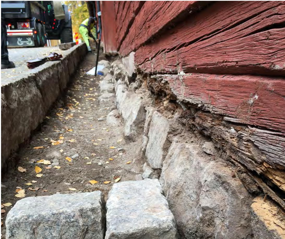
Pågående grävning och arkeologisk schaktövervakning inför anläggande av rännstenen. Notera den rötskadade syllen i fack 7 till höger i bilden. Foto: 2018-10-11. SLM D2019-0601.
