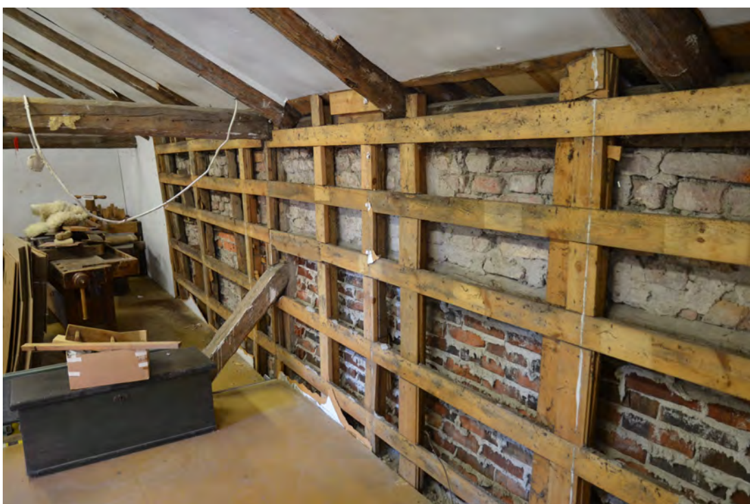
Hantverksbodens utställningslokal, vy mot sydväst. När väggskiket tagits bort blottades teglet i fackverken. Underdelen var murad med maskinslaget tegel och överdelen var murad med äldre handslaget stortegel. Framför fackverket satt en regelkonstruktion. SLM D2019-0599.
