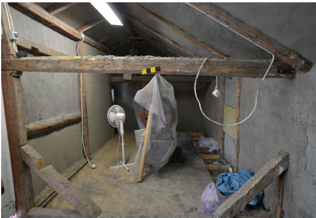
Brandbodens utställningslokal efter att väggarna och taket lerklinats, jämför med bild på sidan 17. Hembygdsföreningen kommer att fortsätta den interiöra renoveringen under 2020, och avser att utforma en mer modern utställningslokal än den tidigare. Notera luckan som är igensatt med glasfiberisolering till höger i bilden, denna är tänkt att utformas som ett titthål i vilket väggen syns i genomskäring. På så vis kan den traditionella väggkonstruktionen och lerkliningens fördelar belysas. Foto: 2019-10-21. SLM D2019-0629.
