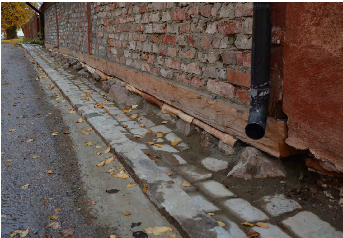
Rännstensens övre (norra) del. Syllen har inte målats eftersom hela fasaden ska putsas med kalkbruk under 2020. Foto: 2019-10-21. SLM D2019-0631.
