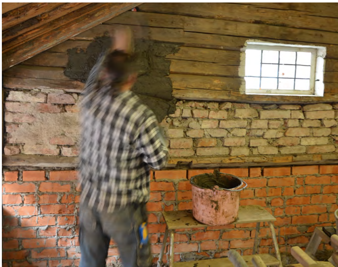
Under kursens andra dag fick deltagarna prova på lerklining av innerväggar. Här syns återigen Johannes Riestrer som visar det rätta handlaget. Foto: 2019-05-19. SLM D2019-0627.
