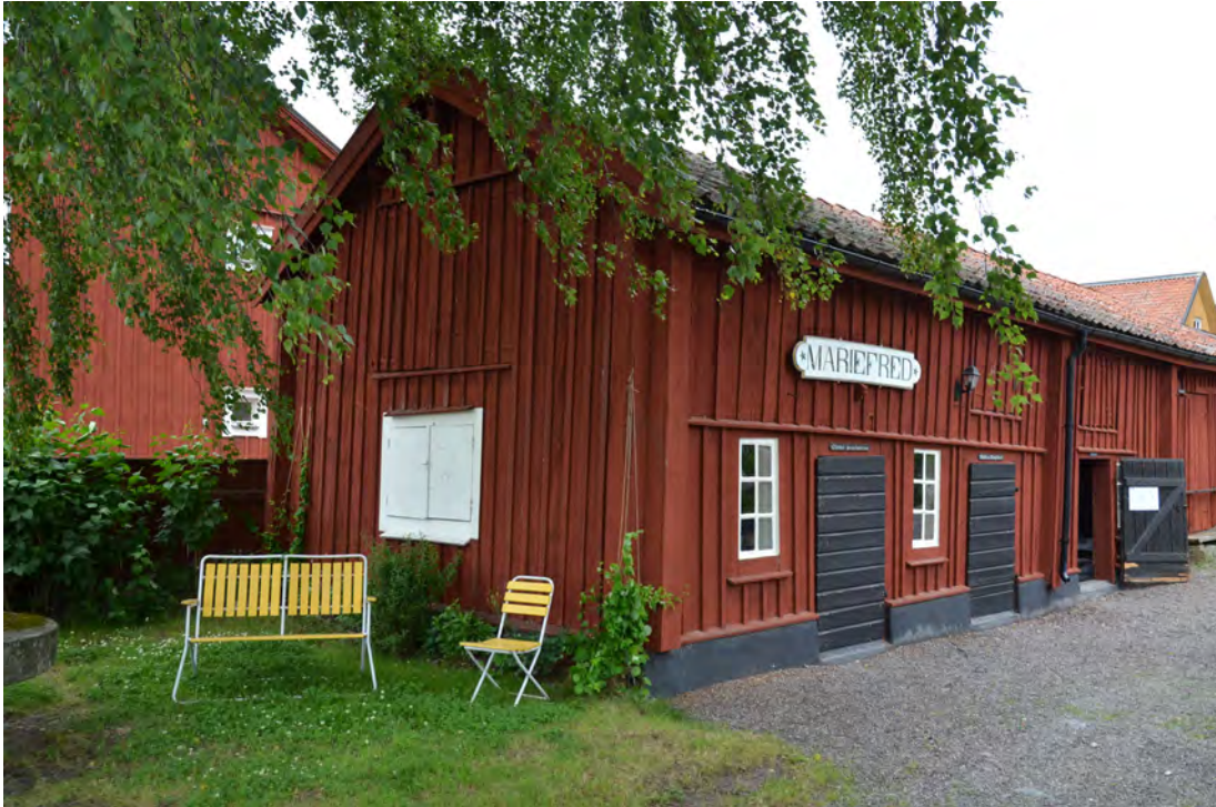
Mjök- och mangelbodens fasader mot innergården och mot hamnen. Foto av Kjell Taawo, Sörmlands museum, 2016-06-21. SLM D2019-0596.
