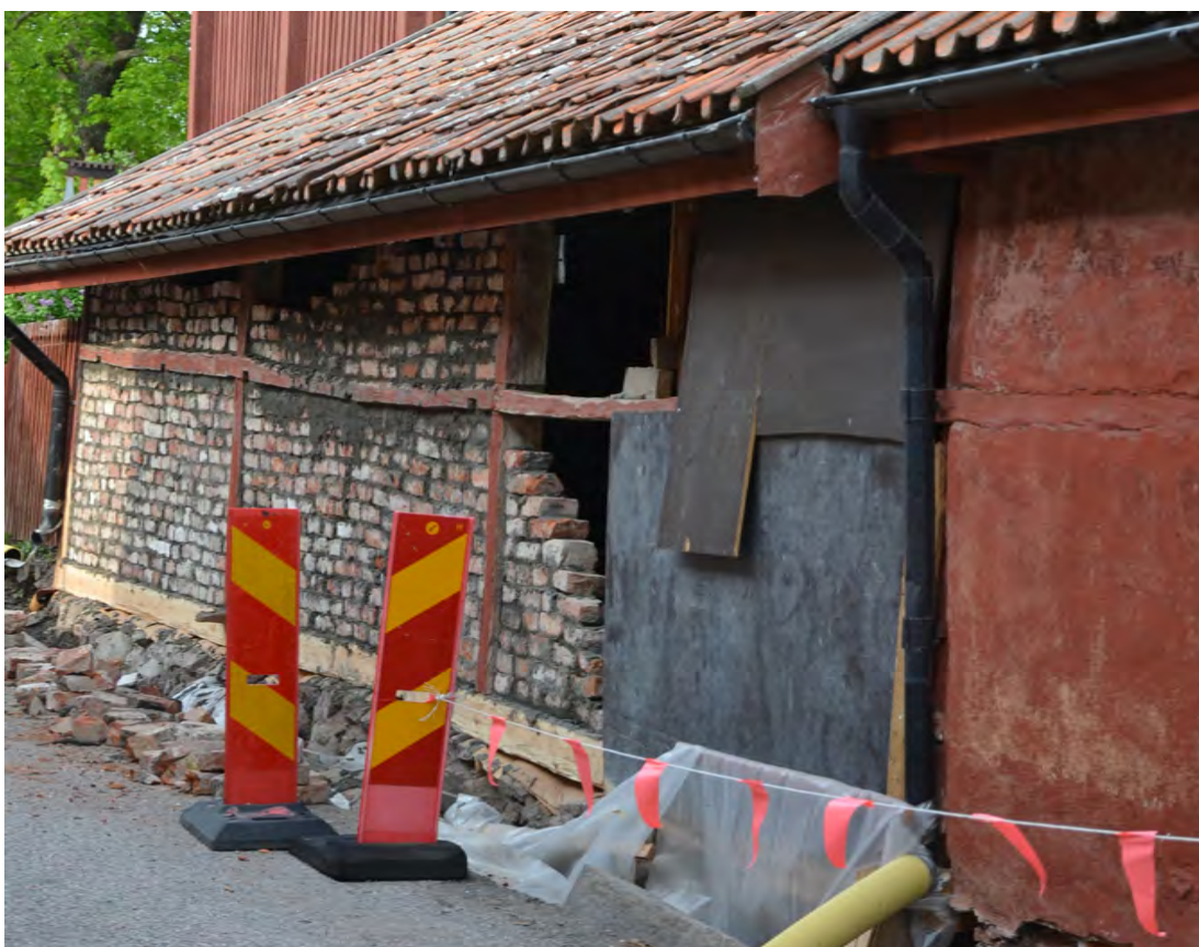
Kursdeltagarna under hann mura upp nästan hela väggen, vilket var långt över förväntan. Resterande murning avslutades av Johannes Riestrer med anställda. Foto: 2019-05-19. SLM D2019-0626.
