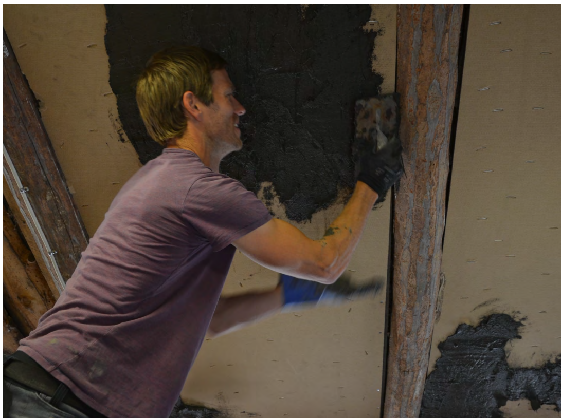
Kursdeltagare provar på att lerklina innertaket. Notera träfiberskivorna som häftats fast i underlagstaket för bättre isolering och vidhäftning av lerbruket. Foto: 2019-05-19. SLM D2019-0628.
