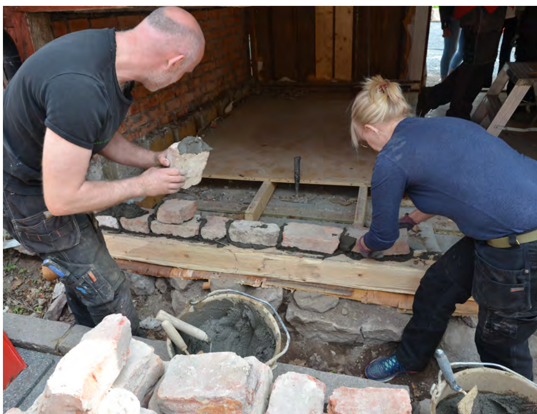
Första raden läggs. Foto: 2019-05-18. SLM D2019-0625.
