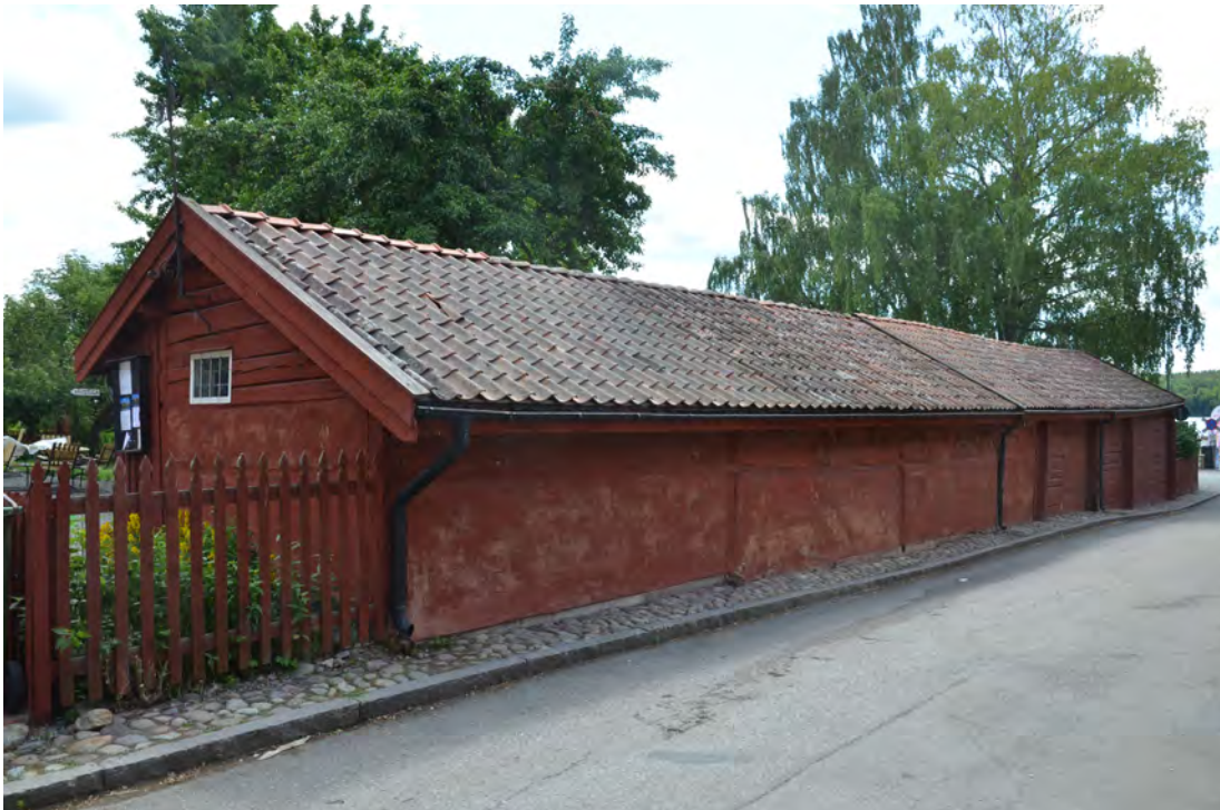
Bodlängans fasad mot Kyrkogatan innan renovering. Foto Kjell Taawo, Sörmlands museum, 2017-07-20. SLM D2019-0597.
