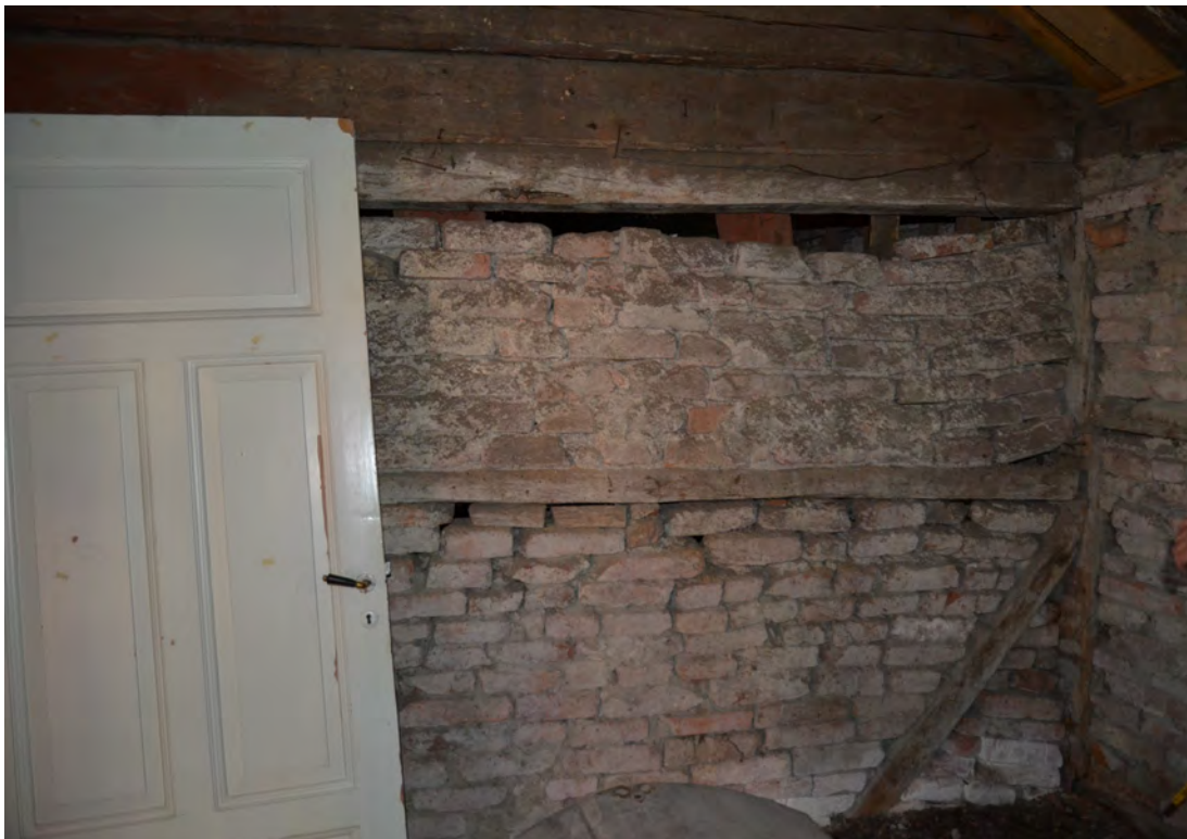
Storteglet i mellanväggen i hantverksbodens södra del (bakom det fjärde facket enligt beskrivning på sid. 19) knackades ned och återanvändes i fackverken mot Kyrkogatan. 2018-10-12. SLM D2019-0634.
