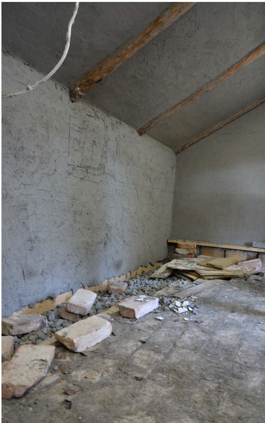
Under byggnadsvårdskursen den 23-24 augusti 2019 lades ett tegelgolv i brandboden. Under teglet ligger ett lager av skumglas. Bilden är tagen i samband med slutbesiktningen. Foto: 2019-10-21. SLM D2019-0630.
