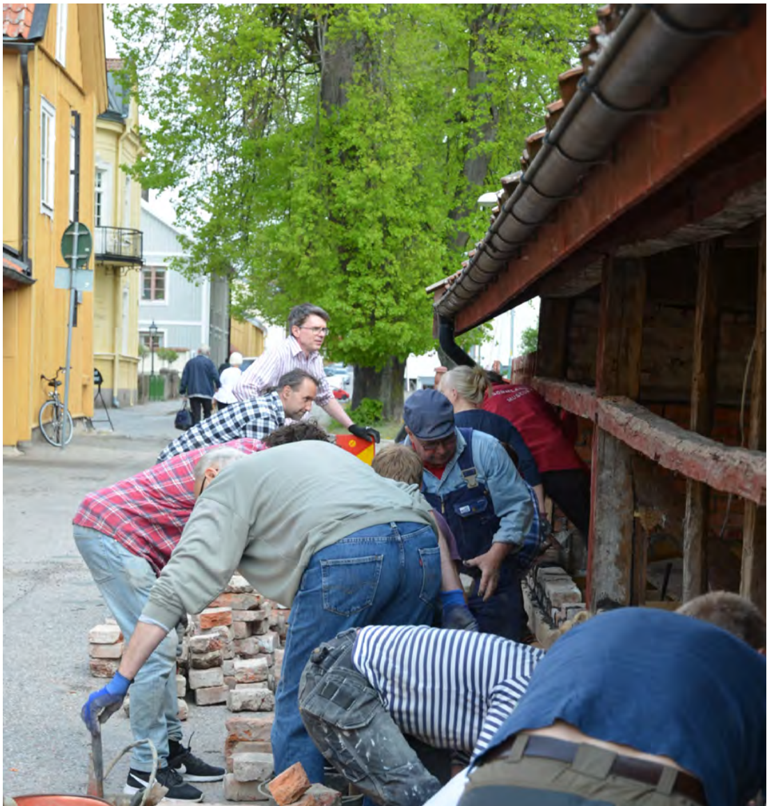
Hängivna kursdeltagare murar med lerbruk och stortegel. Foto: 2019-05-18. SLM D2019-0623.
