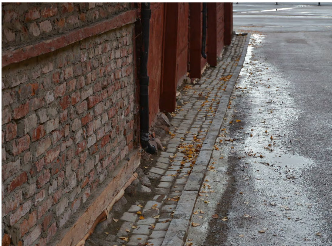
Rännstenens nedre (södra) del. Foto: 2019-10-21. SLM D2019-0632.
