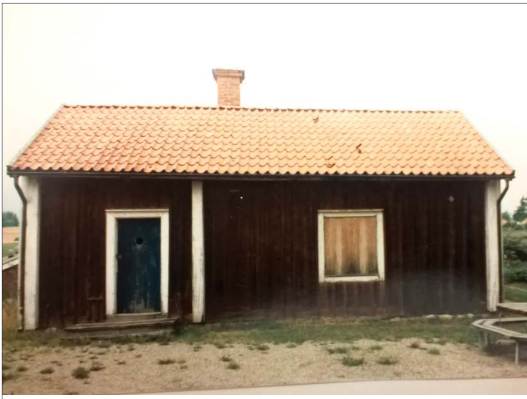
18 Undantagsstugans södra fasad före renoveringen år 1984. Fotograf Urmas Bergfeld, Strängnäs kommun.
