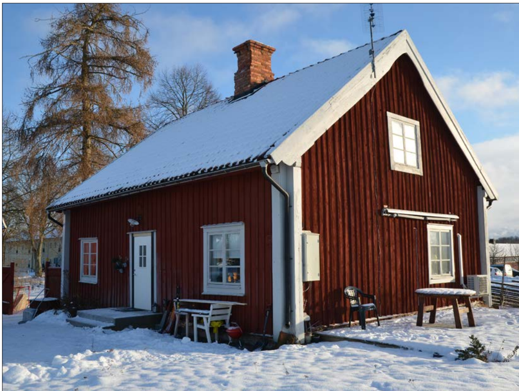
29 Solberga gårds huvudbyggnad, hus C, sedd från nordväst i januari 2016 (SLM D2016-124).
