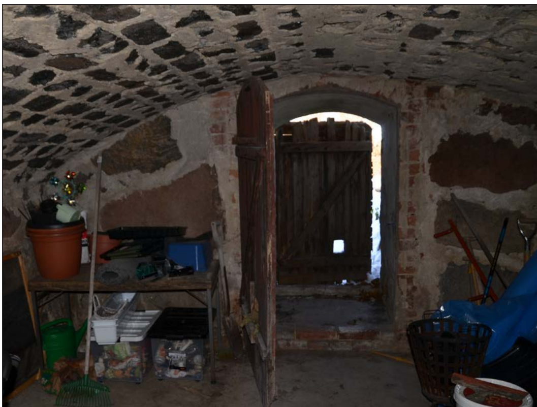
36 Jordkällaren är murad med ett tunnvalv av naturstenar (SLM D2016-127).
