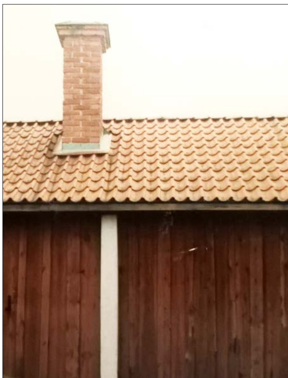
20 Del av norra fasaden före renoveringen 1984. Notera den breda paneln. Fotograf Urmas Bergfeld, Strängnäs kommun.
