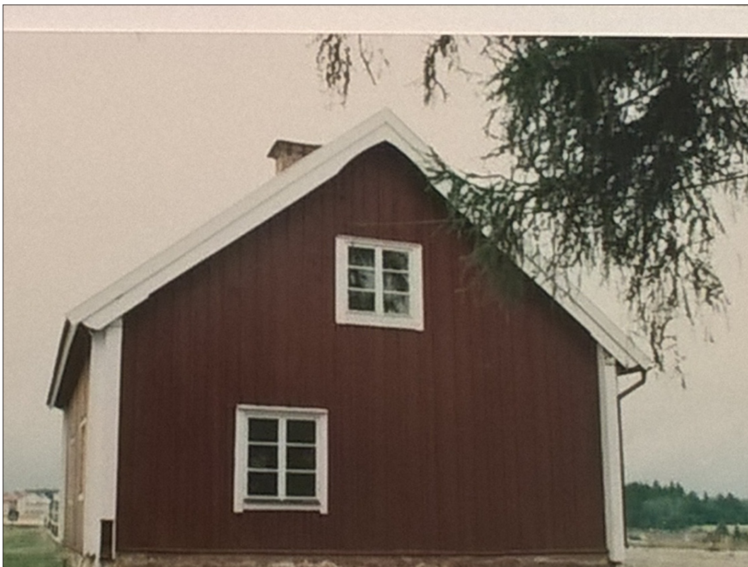
32 Huvudbyggnadens östra gavel före renoveringen år 1984. Fotograf Urmas Bergfeld, Strängnäs kommun.
