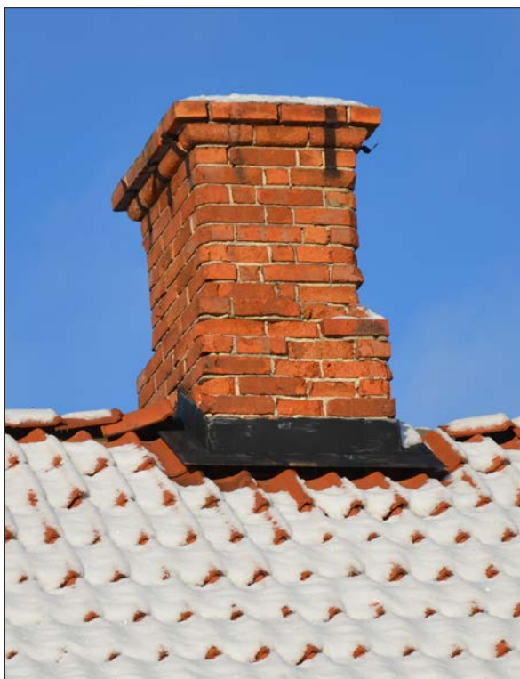
38 Skorstenarnas utkragning är typisk på äldre hus och bör behållas. Skorstenarna var i äldre tider ofta putsade (SLM D2016-129).
