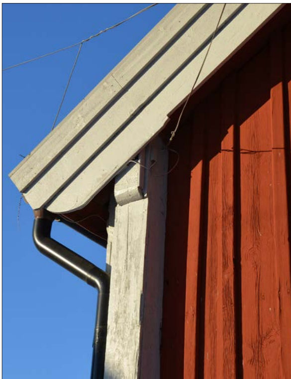
39 Väggbanden har en huggen droppnäsa, vilket är ålderdomligt. Vindsnivornas figursågning är ovanlig och bör behållas (SLM D2016-130).
