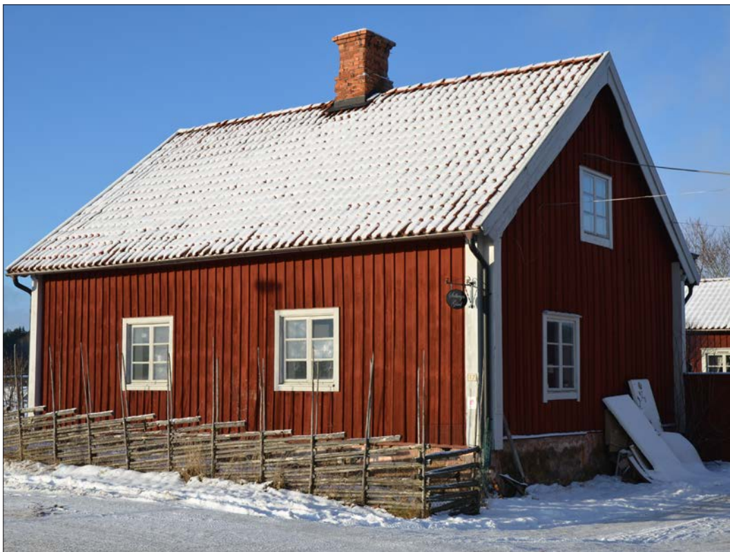
30 Huvudbyggnaden, hus C, sedd från sydost (SLM D2016-125).
