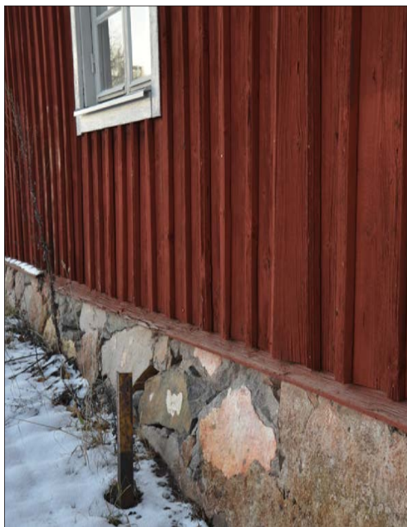
37 Äldre fasadpanel är bredare och ofta fasad på kanterna. Panelen avslutas nedtill med en snedställd vattbräda (SLM D2016-128).
