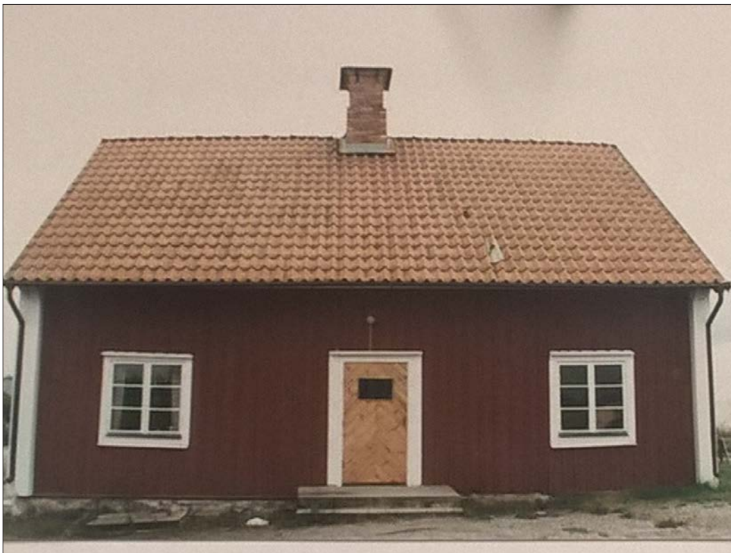
31 Huvudbyggnadens norra fasad före renoveringen år 1984. Fotograf Urmas Bergfeld, Strängnäs kommun.
