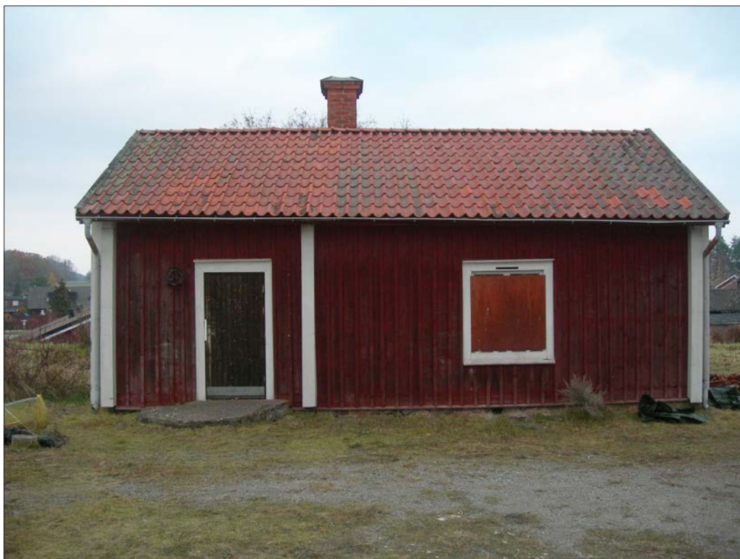
21 Undantagsstugans södra fasad år 2009. Fotografi lånat av Strängnäs kommun, Samhällsbyggnadskontoret.
