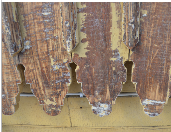
17. Övervåningens stående panel med locklister har ett arbetat utseende. Ursprunglig kulör bränd terra. SLM D2016-2435
