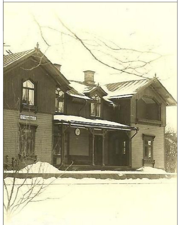
12. Strängnäs första stationshus 1896, bilden är beskuren. Byggnaden revs i samband med uppförandet av nytt stationshus.
