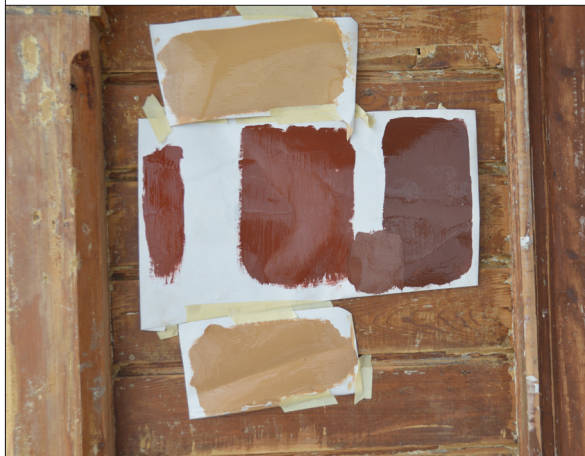
23. Provstrykning av färgprover före beslut. SLM D2016-2440
