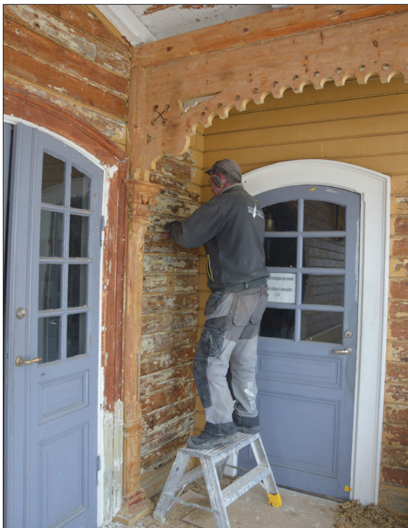
20. Torrskrapning av fasaden. Målare Thomas i arbete. SLM D2016-2437
