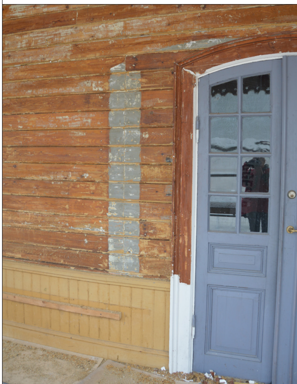
21. När SJ tog över stationshuset ändrades kulören till gråblå, se framskrapat väggfält. Även ytterdörren har flyttats något. SLM D2016-2438
