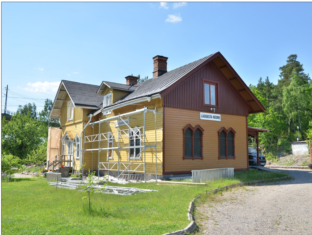
25. Läggesta stationshus i slutet av maj 2016. Halva stationshuset har återfått ursprunglig färgsättning. SLM D2016-2442
