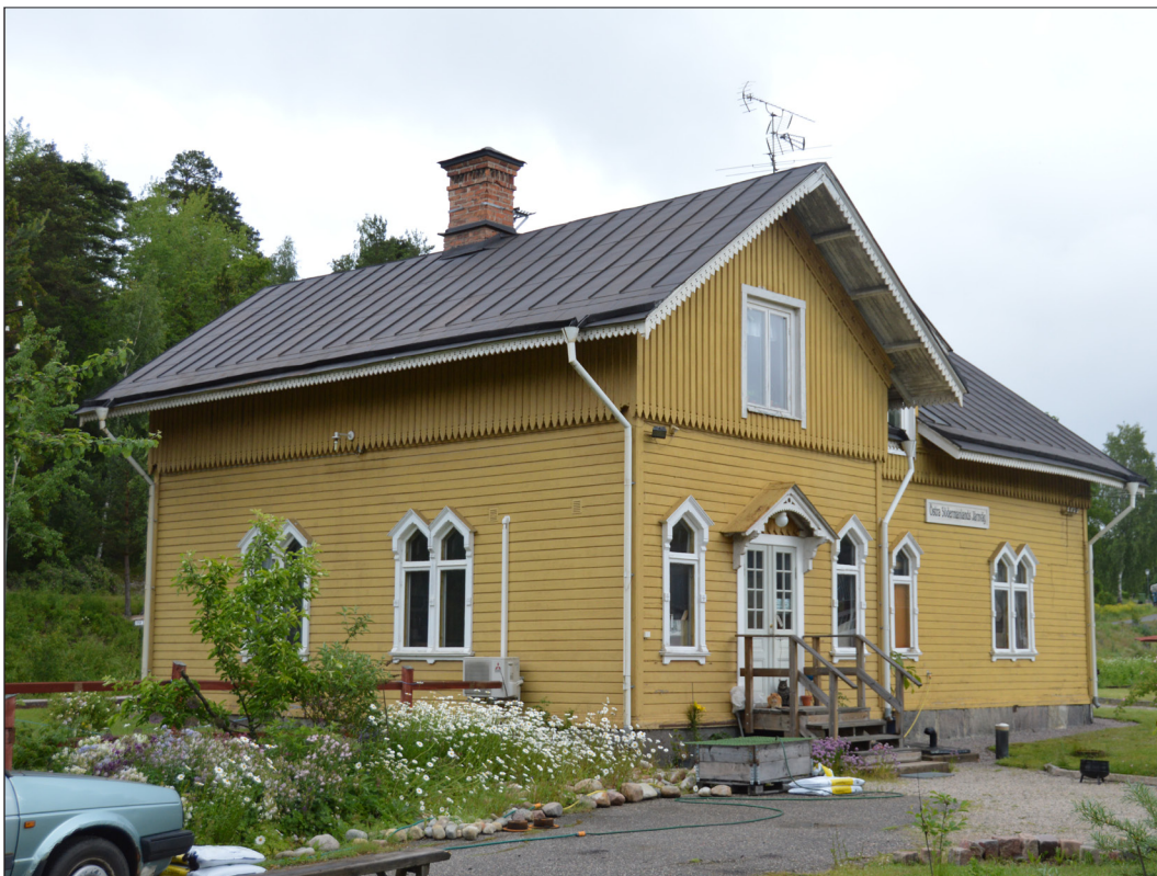
14. Läggesta stationshus med entré till bostaden, Sommaren 2015. SLM D2016-2432
