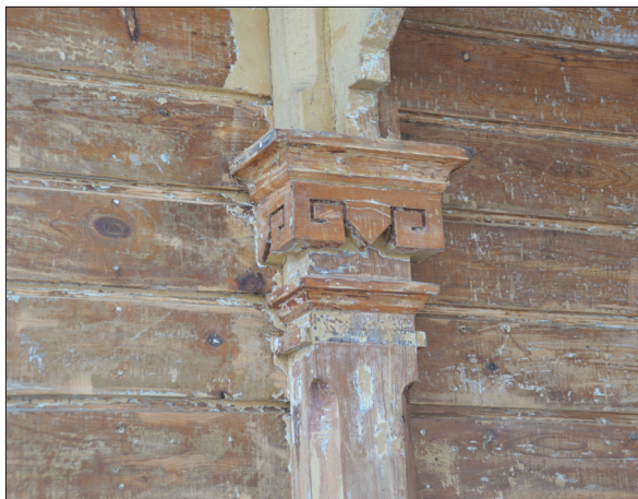
22. Dekorativ snickarglädje tog tid att skrapa. SLM D2016-2439
