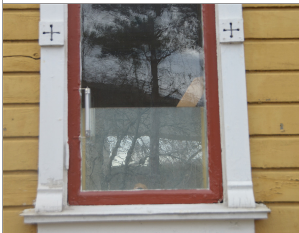
24. Provmålning av fönsterbågar i engelskt rött. SLM D2016-2441
