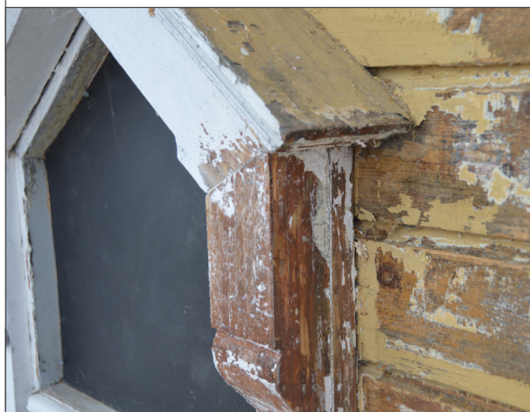
16. Vid torrskrapning framträder tydligt ursprunglig färgsättning på fönsterfoder och panel. SLM D2016-2434
