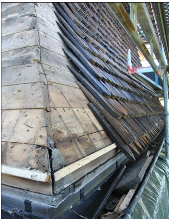
19 Tornets underlagstak var i gott skick. Spånen lades på samma sätt som tidigare...(SLM D2015-1089).
