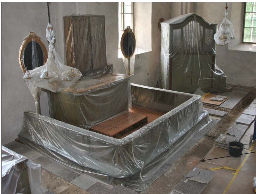
11 Vid demontering av korgolvet kom äldre tegelstenar, naturstenar och delar av ett tegelvalv fram. Tegelvalvets hjässa syns precis framför (väster om) altarringen. Se även uppmättningsritning bilaga 2 (SLM D2015-1081).
