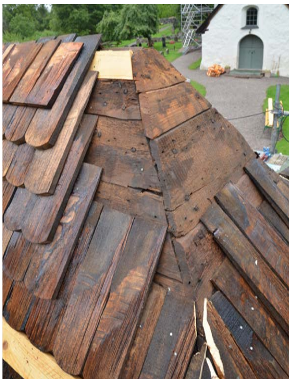
23 Arbeten med södra stigporten (SLM D2015-1093).
