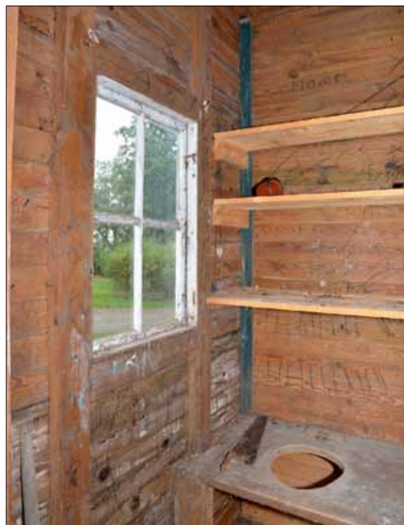
9 Utedasset i byggnadens nordöstra hörn från nordväst (Slm D12-0642).
