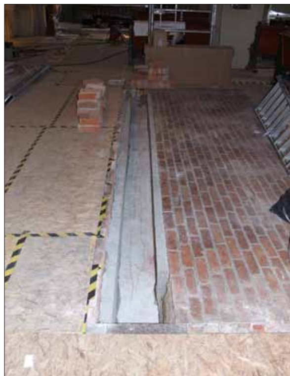
25 Det södra bänkkvarterets tegelgolv efter gjutning av ledningskanal (Slm D11-159).
