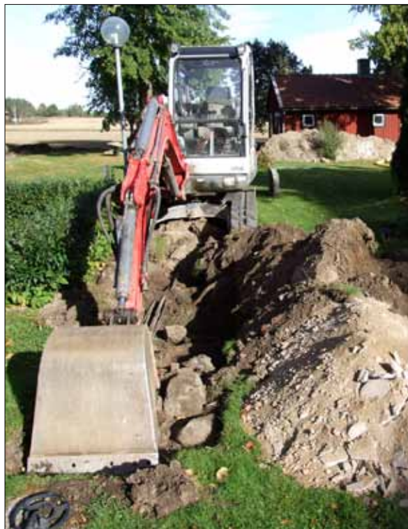
5 Pågående schaktning mellan personalbyggnadens värmecentral och kyrkan (Slm D11-139).
