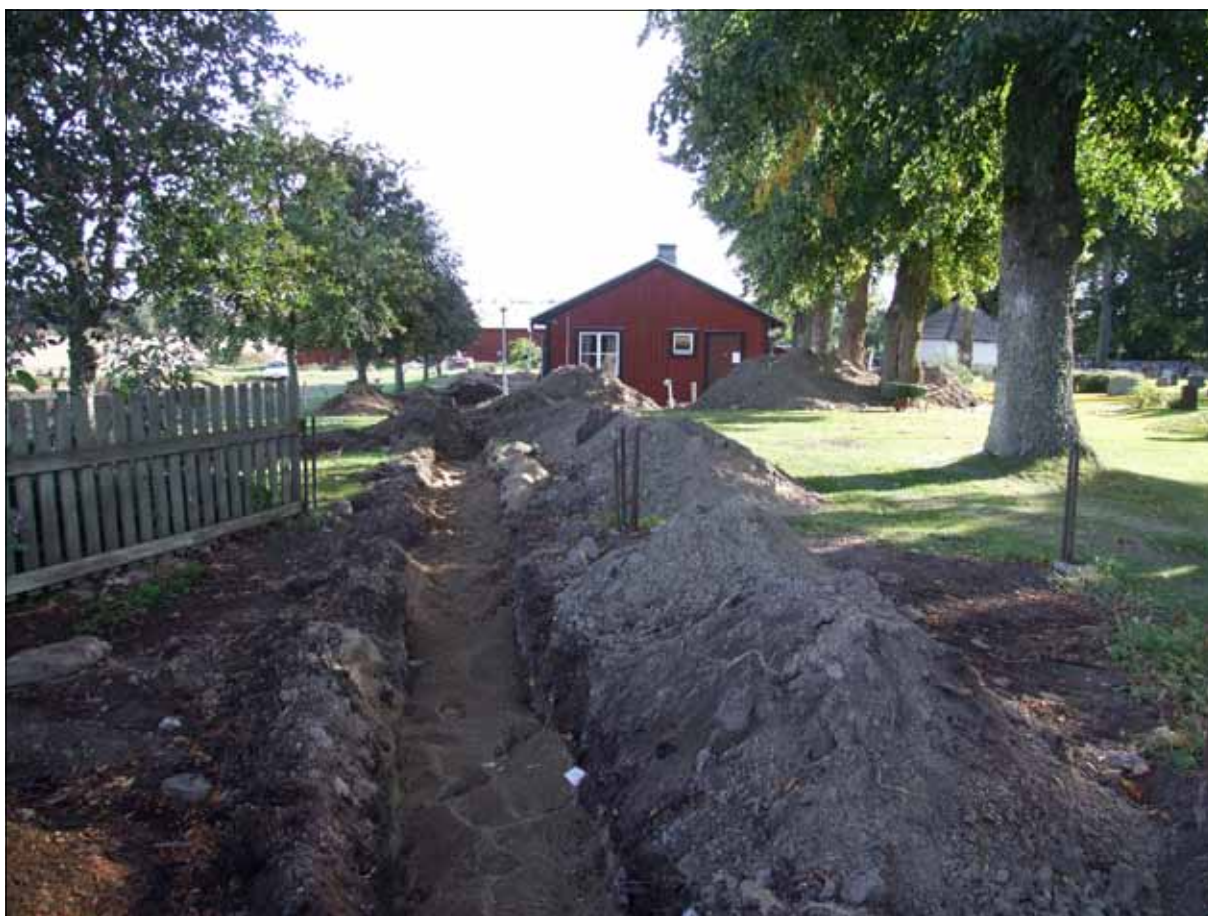
6 Schakt mellan värmecentralen och energibrunnar väster om personalbyggnaden (D11-140).
