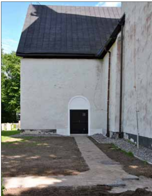
7 Utrymningsvägen i den norra korsarmens västra fasad (Slm D11-141).
