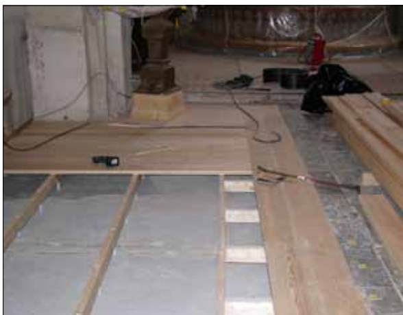
17 Läggnig av nytt brädgolv i det norra bänkkvarteret (Slm D11-151).
