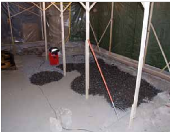
16 Södra delen av arbetsområdet vid återfyllning med tvättat singel (Slm D11-150).
