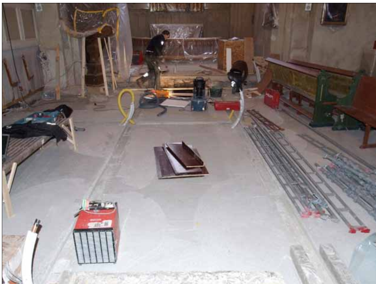
4 Arbetsområdet efter gjutning av nytt underlagsgolv av betong (Slm D11-138).
