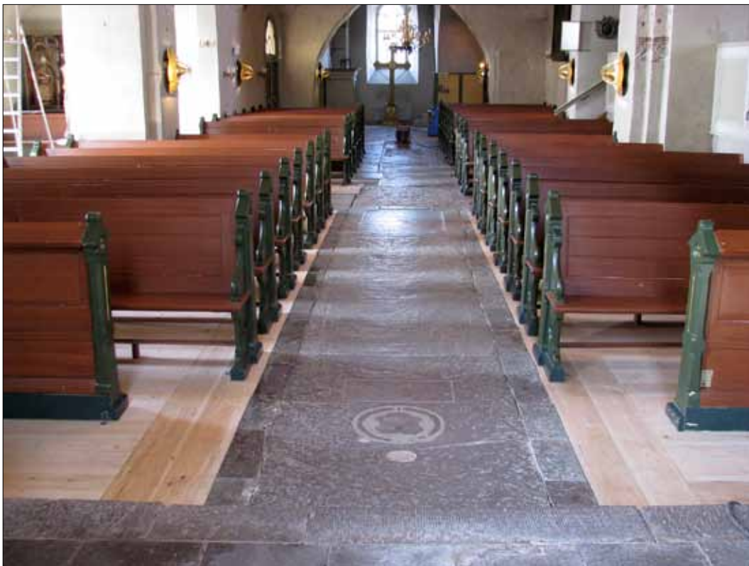
22 Nylagda brädgolv i bänkkvarteren och omlagd mittgång i långhusets östra travé efter avslutade arbeten (Slm D11-156).
