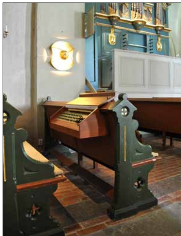
29 Manöverpulpiten rymmer styrningsreglage för ljus, ljud och klockringning (Slm D11-163).
