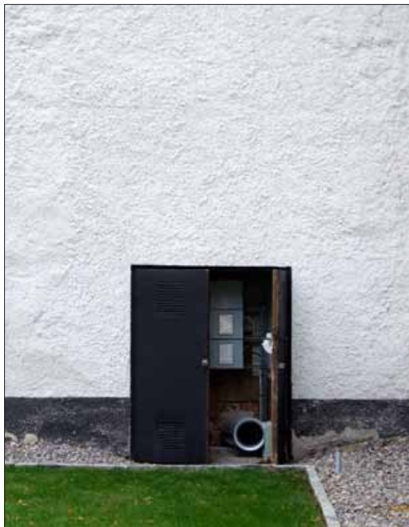
26 Ingången till den norra korsarmens blinderades vid restaureringen 1955 (Slm D11-160).
