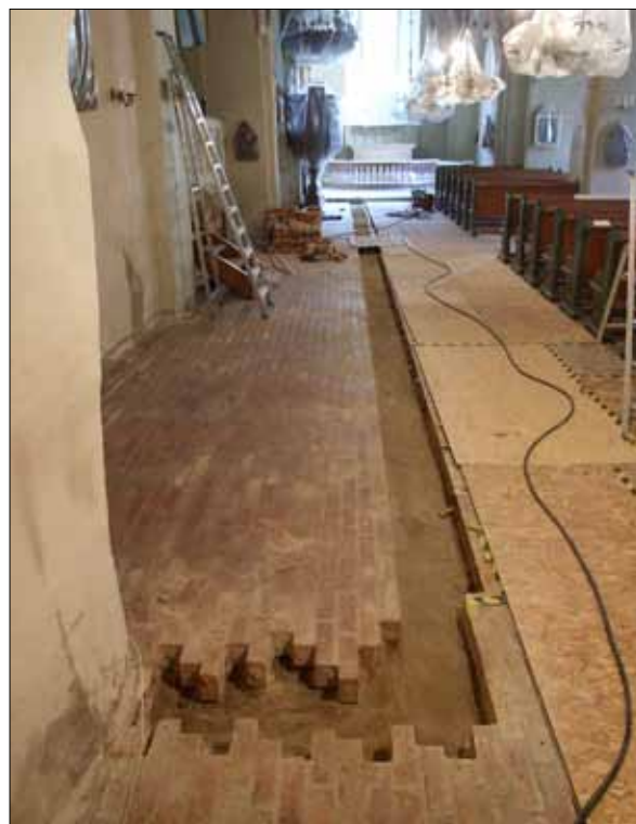
24 Det norra bänkkvarterets tegelgolv efter upptagning av tegel inför schaktning (Slm D11-158).
