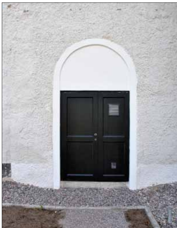
27 Den nyupptagna utrymningsdörren (Slm D11-161).
