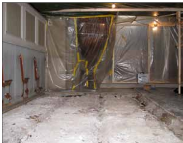
14 Det norra bänkkvarteret efter demontering av befintligt underlagsgolv (Slm D11-148).
