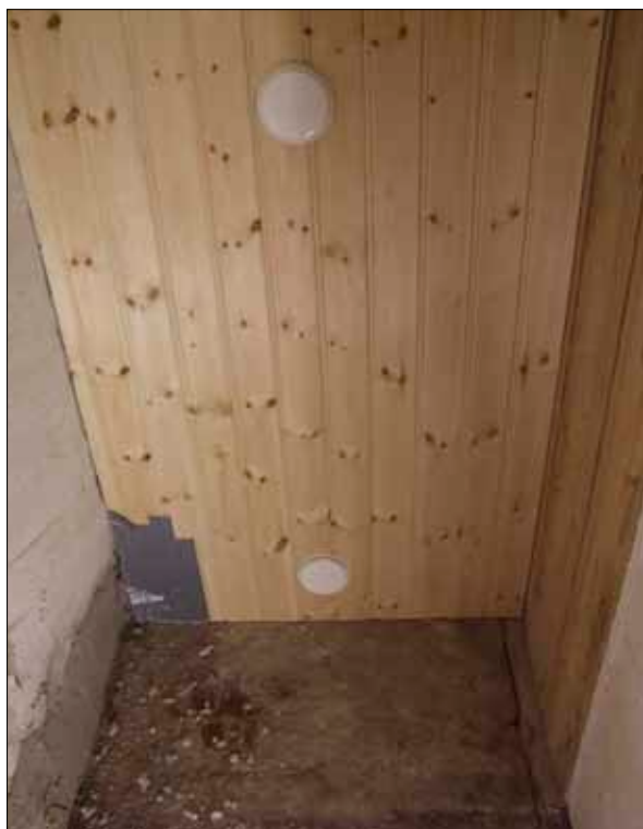
27 En vägg i förrådet byggdes med ny panel.
