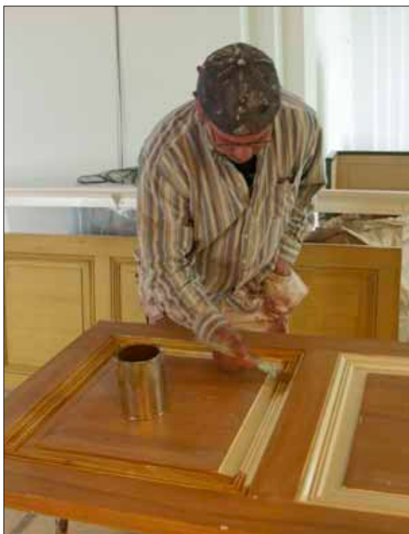
29 Innerdörrarnas profilering laserades på nytt av målaren Jörgen Pekkari. Resten av dörrbladet retuscherades.
