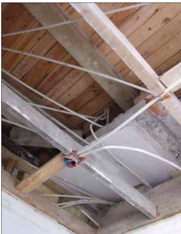
33 Under undertaket i kapprummet såg man 1900-talets stickvalv, som av någon anledning har kapats i senare tid. Vy upp i taket sett mot sydost.
