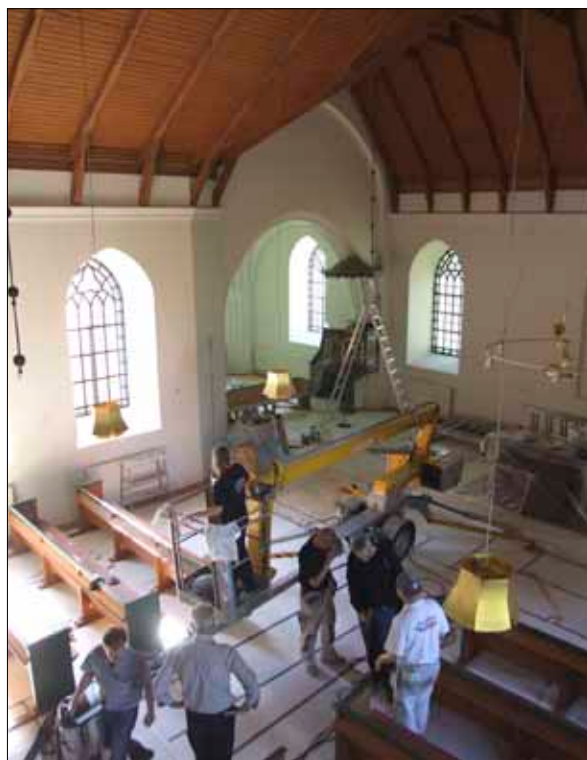
18 Taket gjordes rent med hjälp av dammsugning och torkning från skylift.
