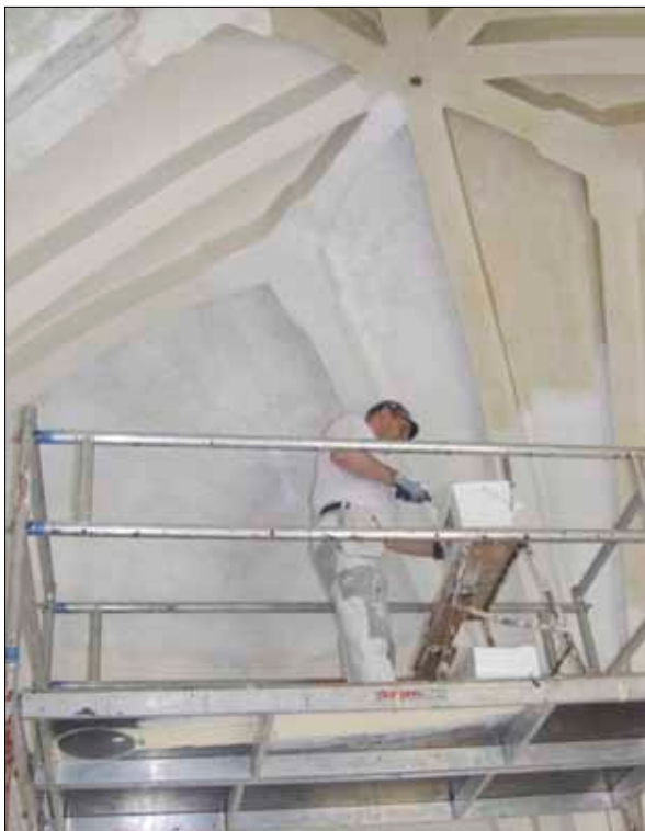
16 Valven rengjordes genom att våtrumsklister lades på, som tog med sig det senaste färglagret.
