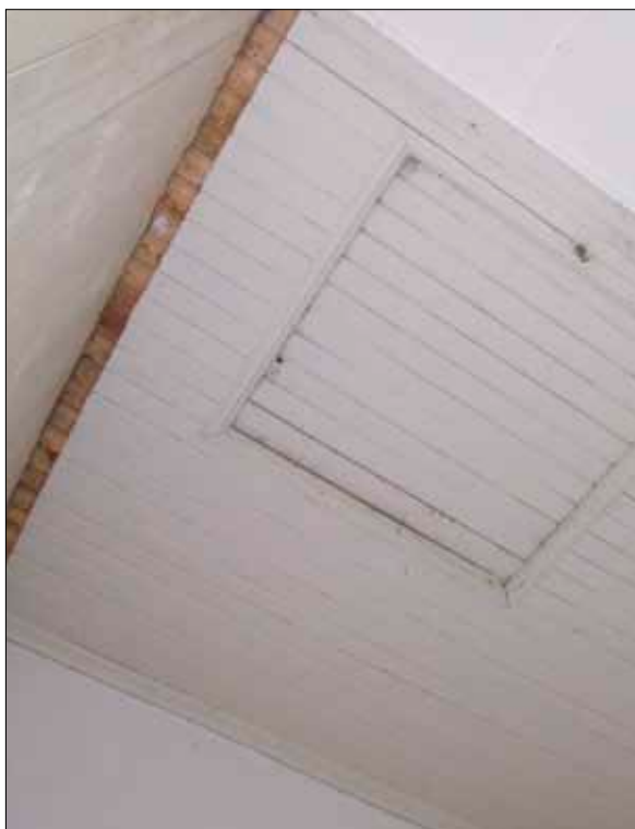
23 Under undertaket kom den äldre pärlspontpanelen fram, med taklucka upp till vind för klockorna.
