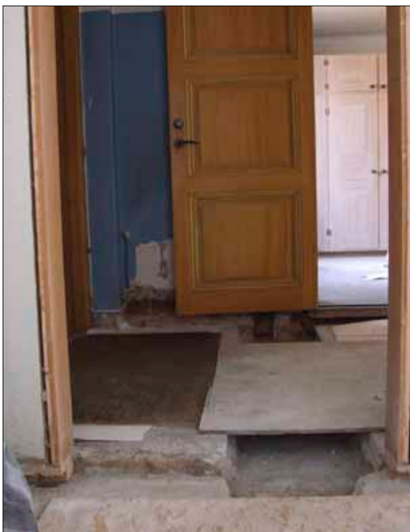
30 Eftersom det hade varit problem med avrinningen från sakristians piscina, lades "avloppet" om.
