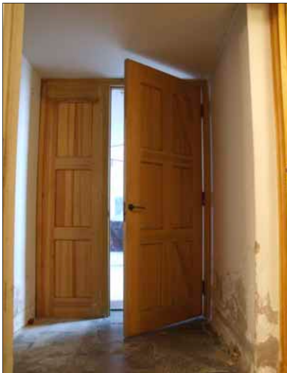
22 Dörren in mot kyrkorummet gjordes om, på så sätt att båda dörrbladen skulle kunna öppnas. En automatisk dörröppnare monterades.
