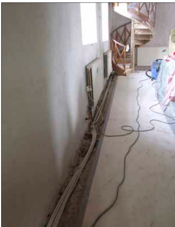
17 Rördragningarna göts in vid väggen under golvnivå.
