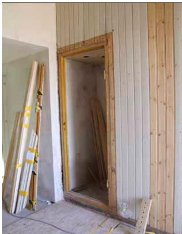
21 Befintlig panel behölls och kompletterades. Dörrfoder märktes och ställdes upp på vinden.
