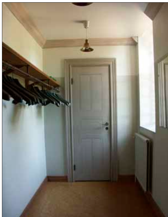
11 Kapprummet före renoveringen, augusti 2007.
