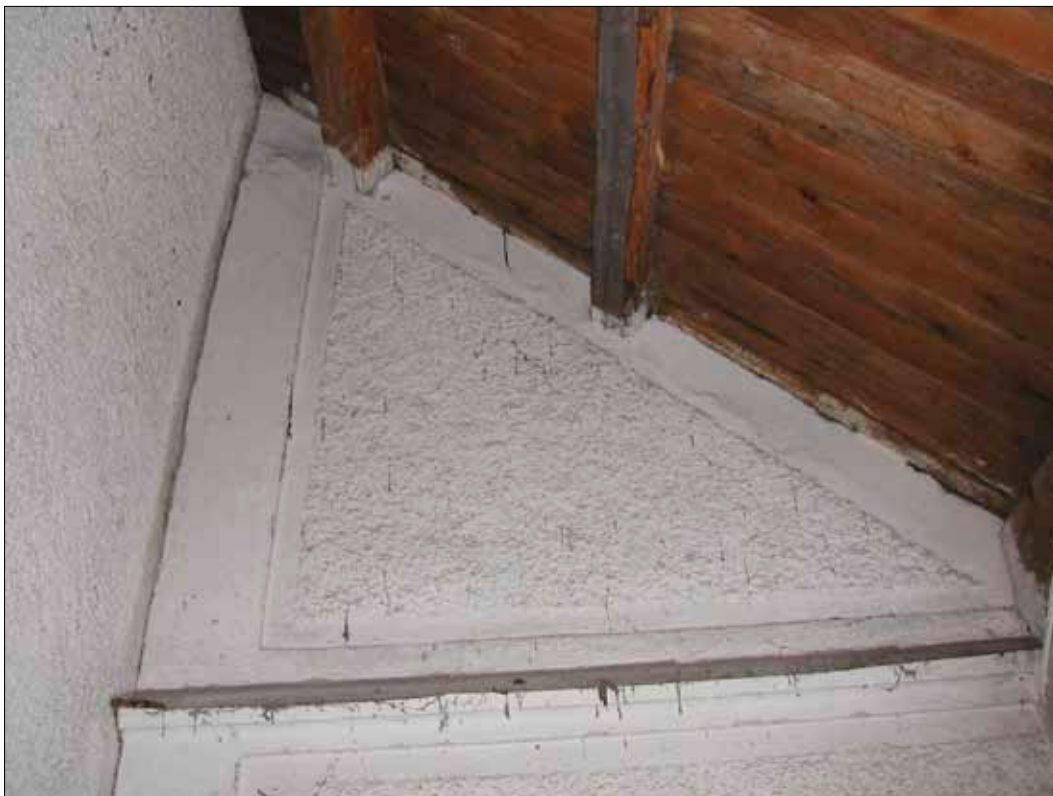
Fig 10 Inne i det västra, norra förrådet kan spritputs och slät puts ses från väggparti som var synligt före 1880 års ombyggnad.
