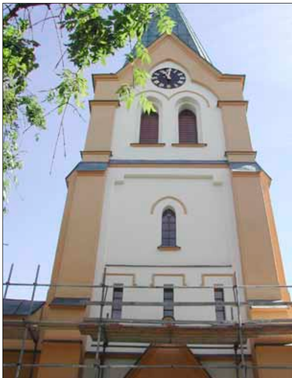
Fig 23 Tornet har blivit färgsatt i originalfärgställningen. Därmed framhävs de arkitektoniska delarna.
