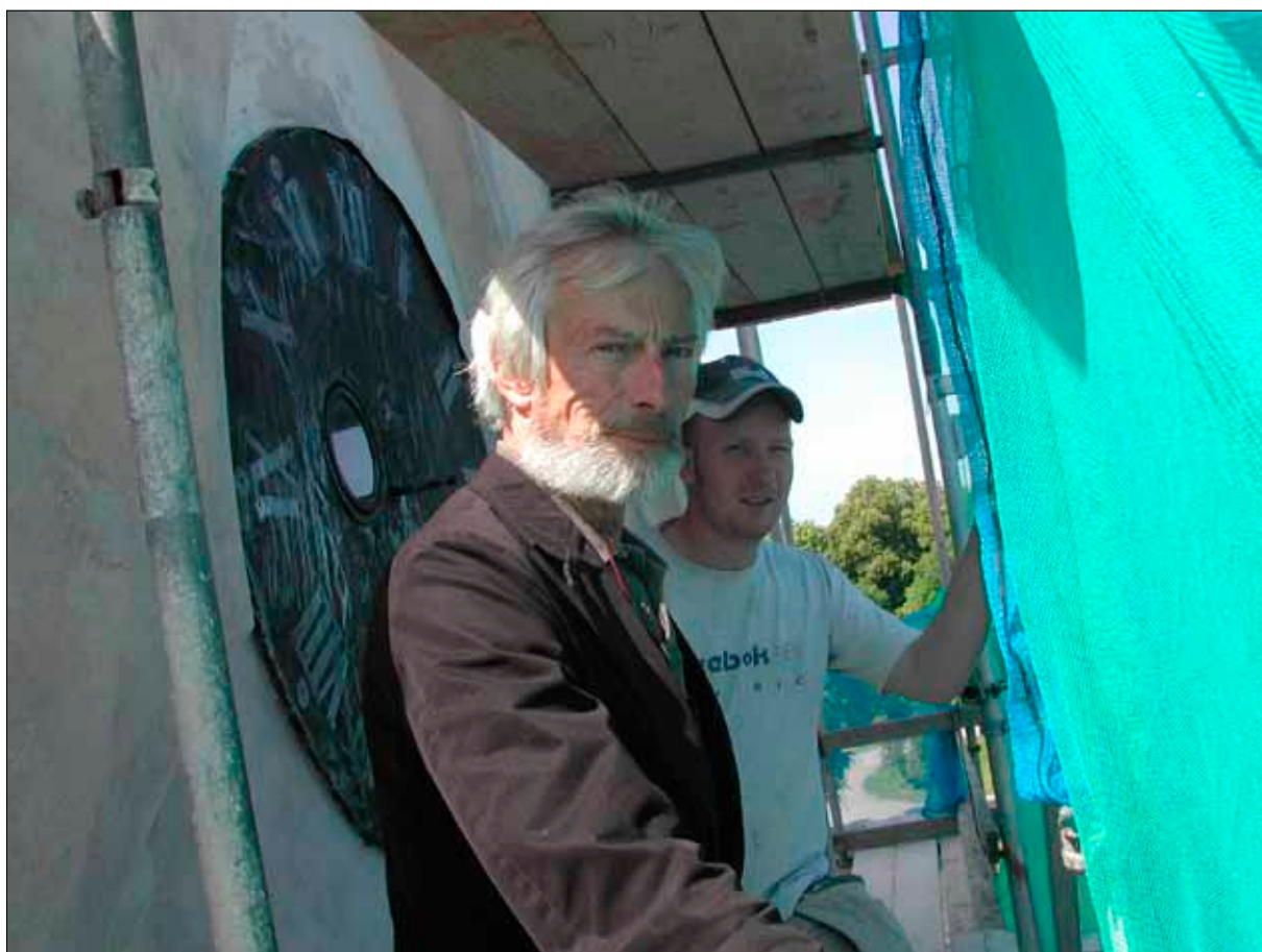
Fig 16 Arkitekt Pål Nyström var projektledare. Bakom honom syns Heikki Kirves, murare. De står på byggställningen framför en av urtavlor på tornet. De romerska siffrorna och visarna är bortmonterade inför förgyllning.
