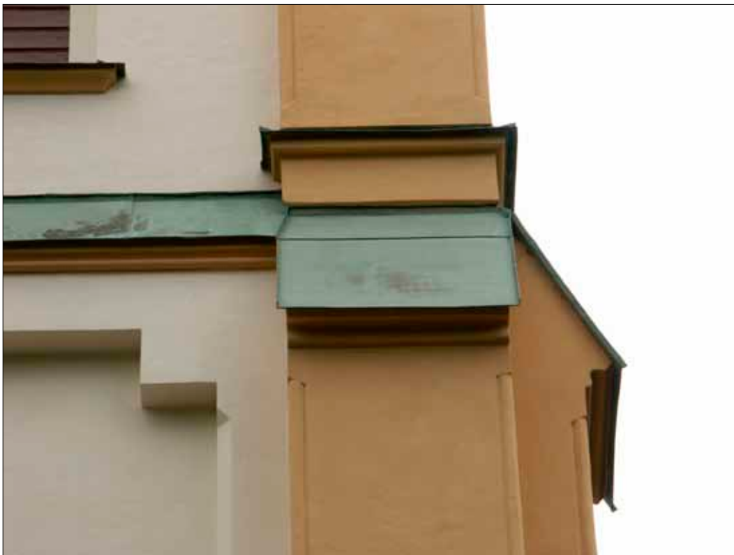
Fig 19 Ny kopparplåt har monterats på den vertikala pelaren. Modern, markant avslutning av putsen mot plåten.
