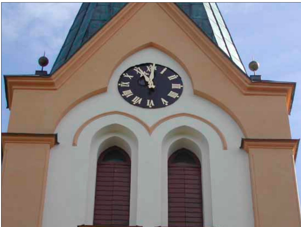
Fig 25 Urtavlan i väster har målats. Visarna och de romerska siffrorna har förgyllts. Ljudluckorna har målats bruna.
