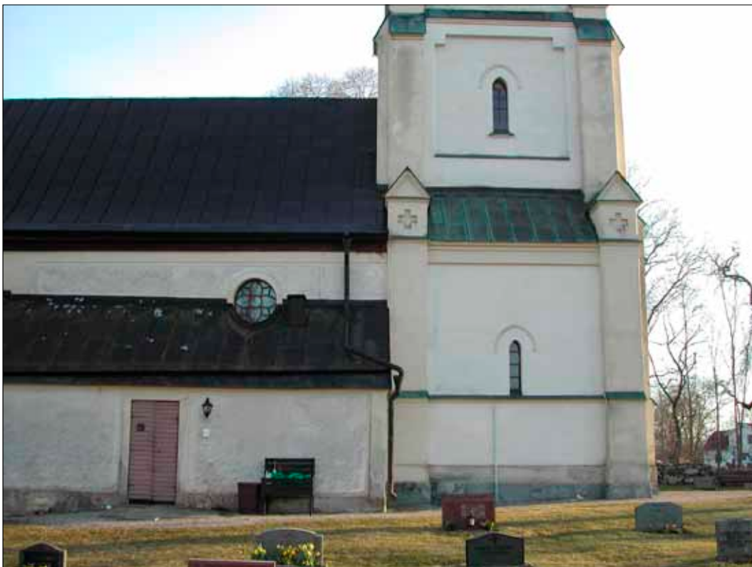
Fig 7 Taken är täckta med olika plåtmaterial och är lagda med olika tekniker.
