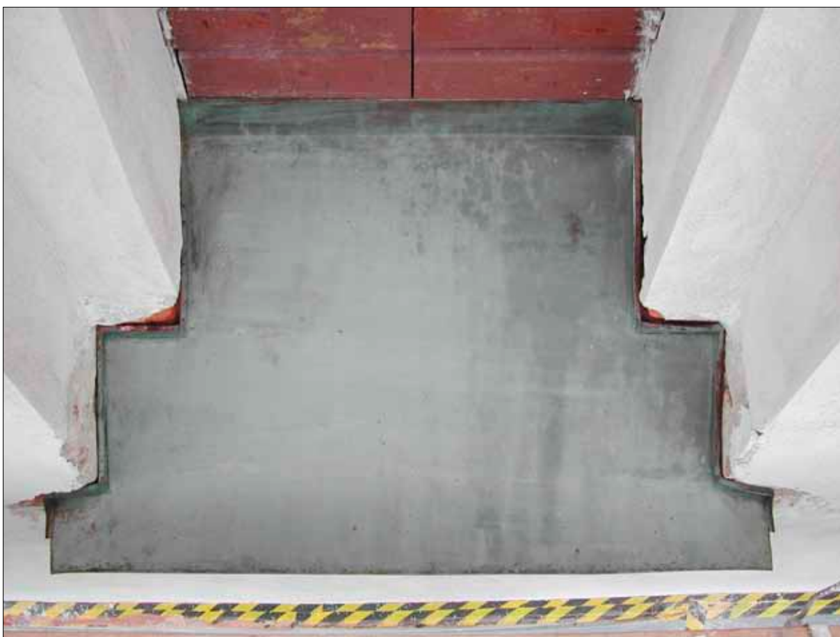
Fig 24 Den nya plåten har monterats vid ljudluckan.
