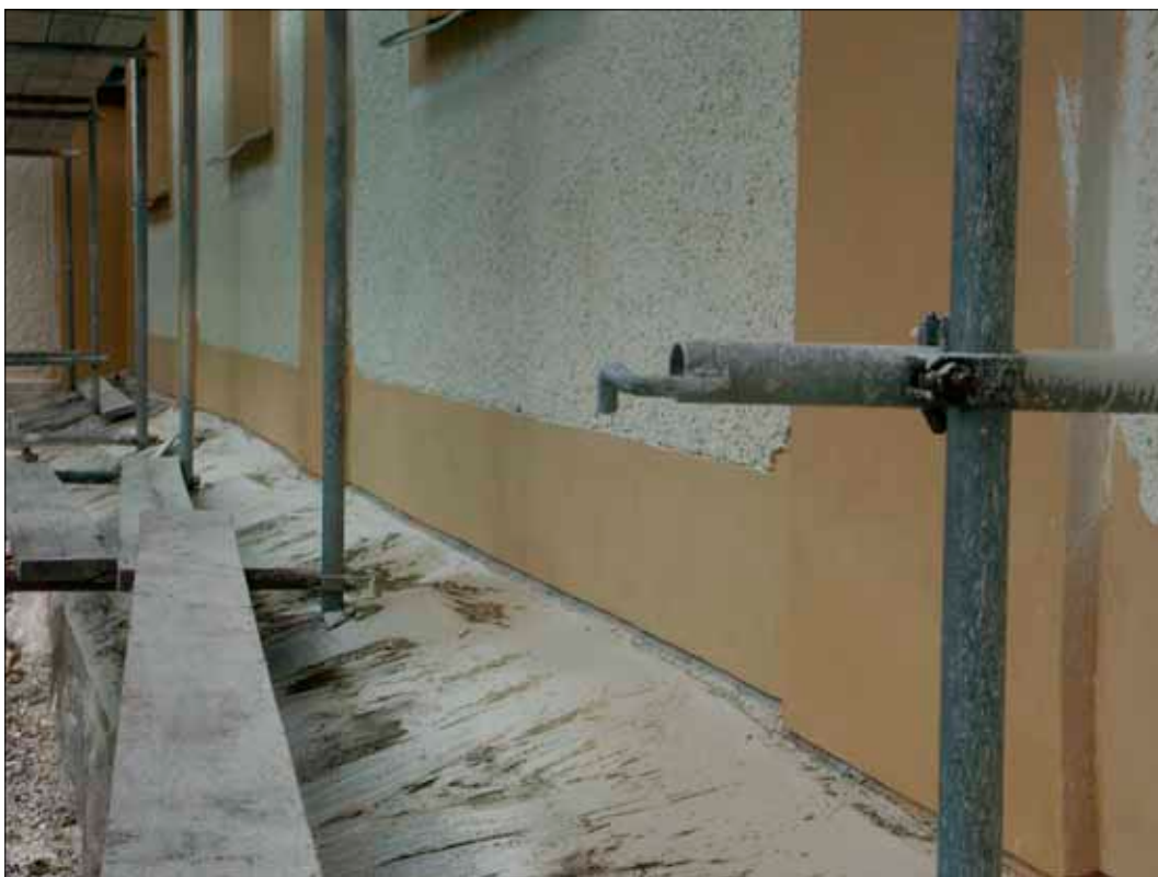
Fig 18 I stället för den markerade listen nertill målades motsvarande form på slät puts.
