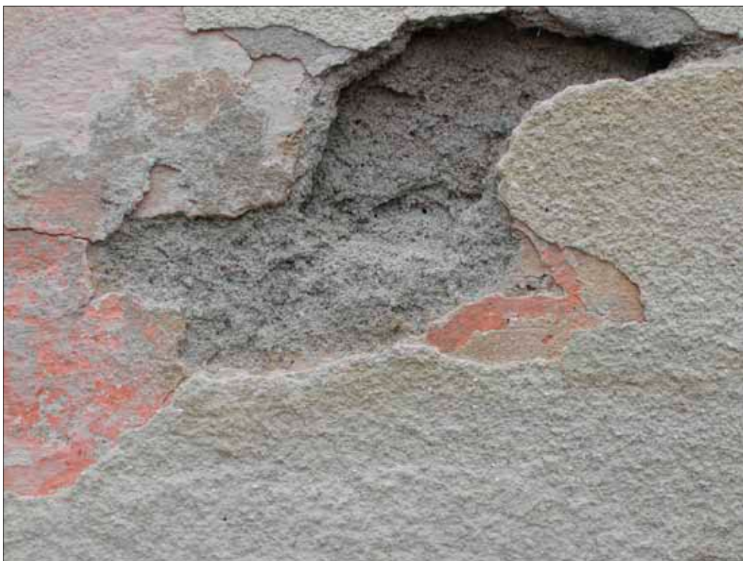
Fig 13 Längre in under gula putsikt fanns rosa kulör. Den ytan kan ha varit synlig under 1700-talet.
