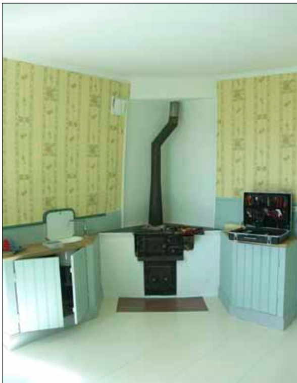
29 Drängkammarens norra del med vedspisen efter renoveringen.
