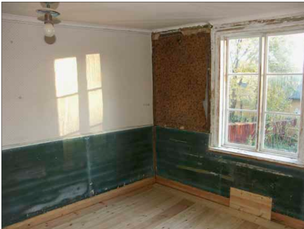
17 Drängkammarens nya golv sett mot sydost. Bröstningspanelen är upplagd. Fotografi Hugo Larsson 2003, Sörmlands museum.
