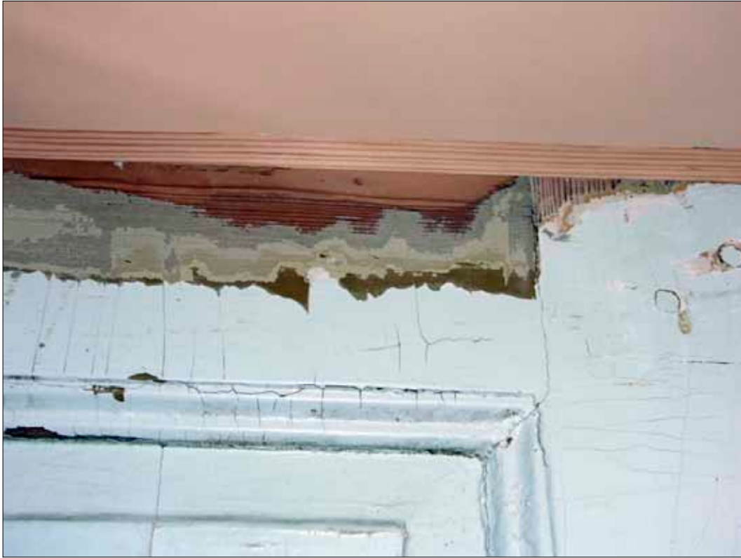
20 Detalj av dörrbladet, med flera färglager, se sidan 16.
