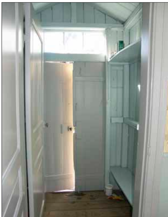
26 Förstugan efter åtgärd.
