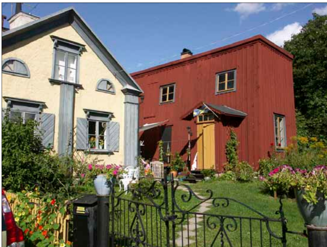
2 Före detta tullhuset till vänster och före detta tullmagasinet till höger sett från sydväst efter renoveringen 2005.
