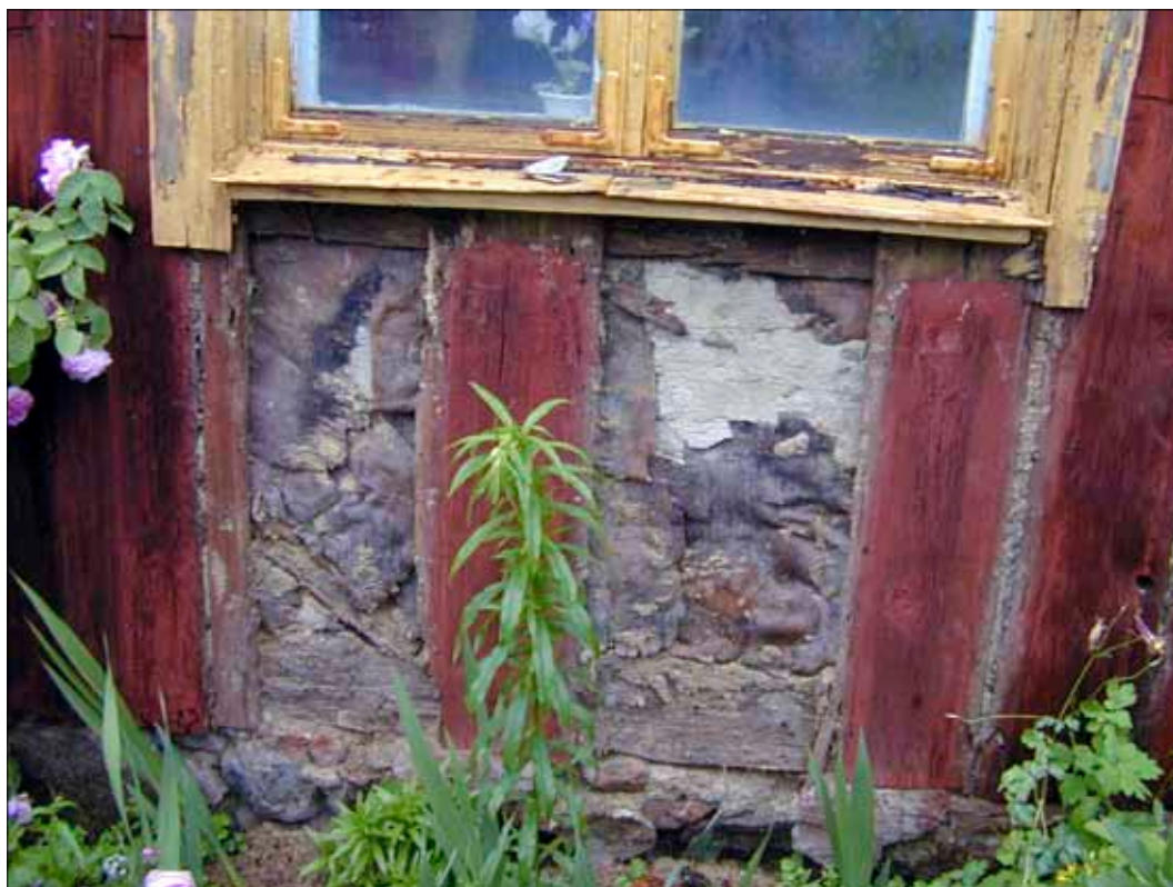
10 Tullmagasinets södra fasad som har korsvirkesstomme. Stommen har isolerats med näver och har varit slätputsad. Fotografi Hugo Larsson 24 juni 2004, Sörmlands museum.
