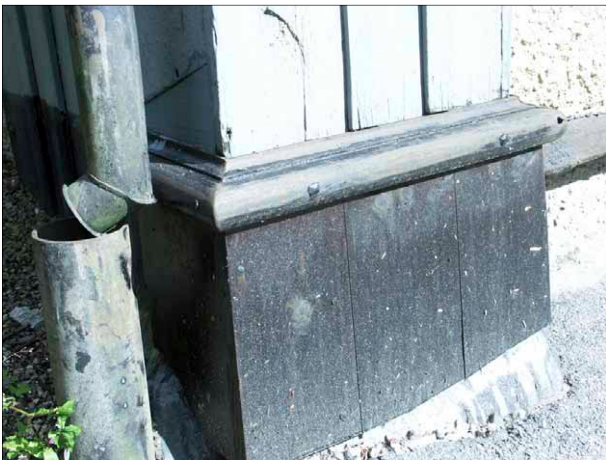
31 Detalj av en av pilasterbaserna på tullhuset efter åtgärd.
