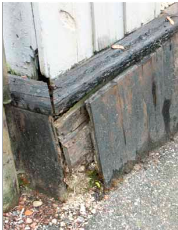
5 Detalj av norra pilasterbasen på tullhuset före åtgärder.
