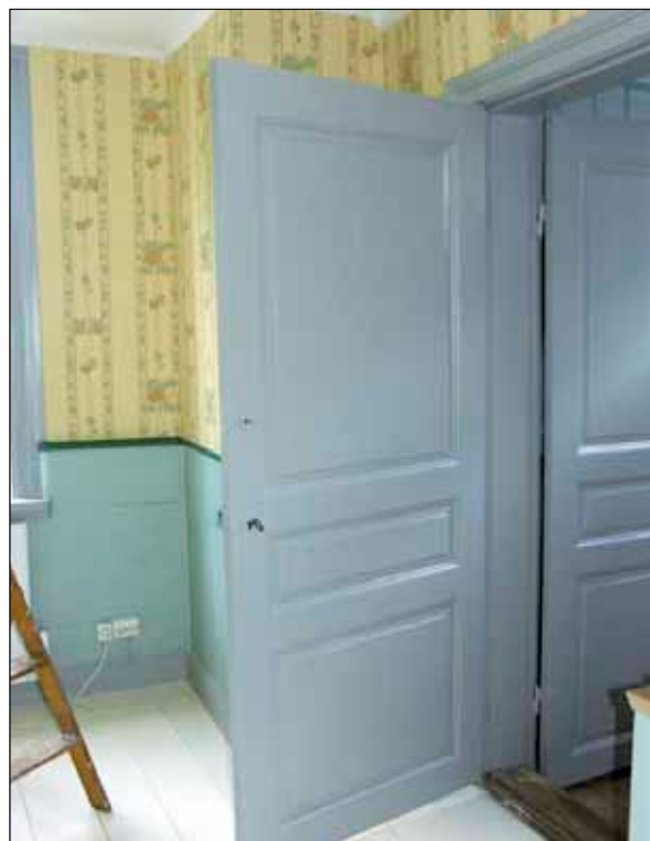
27 Dörren efter åtgärd och målning.
