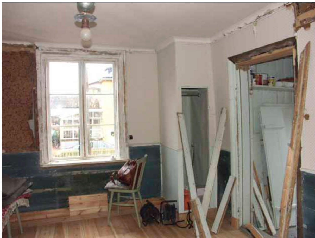
11 Drängkammaren i tullmagasinet sett mot söder. Till höger skimtar förstugan och den inbyggda gardero- ben.
