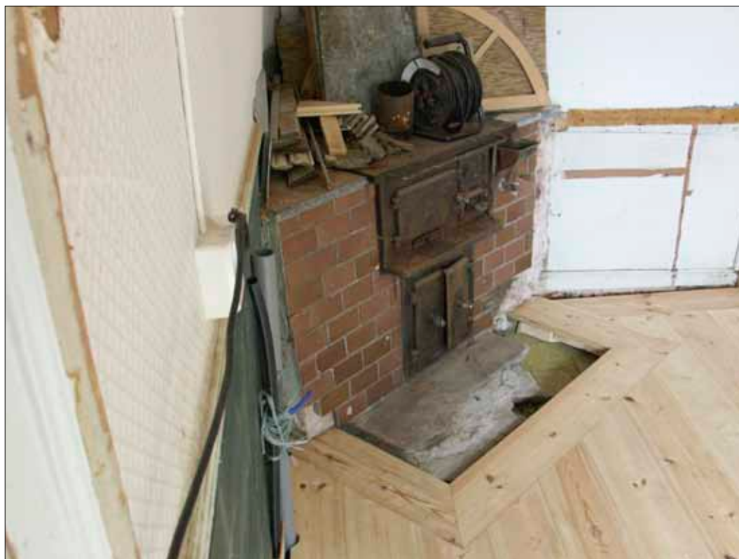
19 Detalj av den tidigare gjutna plattan framför spisen.
