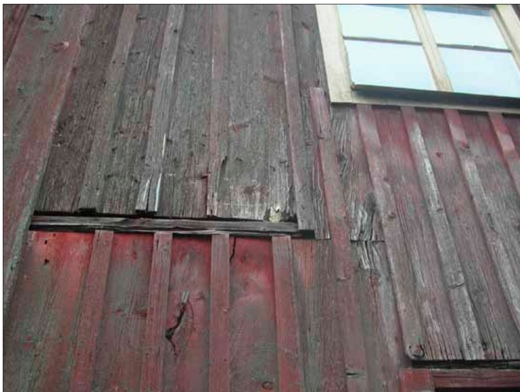
7 Detalj av västra fasaden på tullmagasinet före åtgärder. Fotografi Hugo Larsson 22 april 2002, Sörmlands museum.
