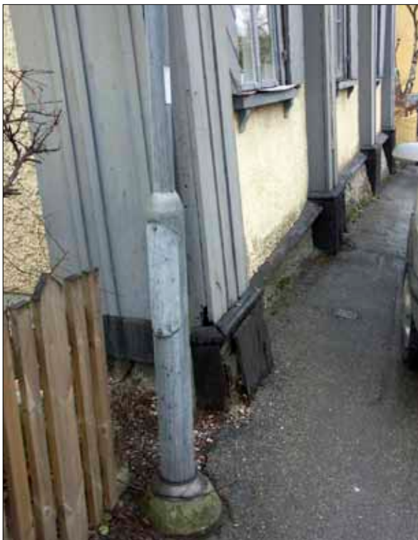
4 Tullhusets fasad mot Sturegatan före åtgärder.
