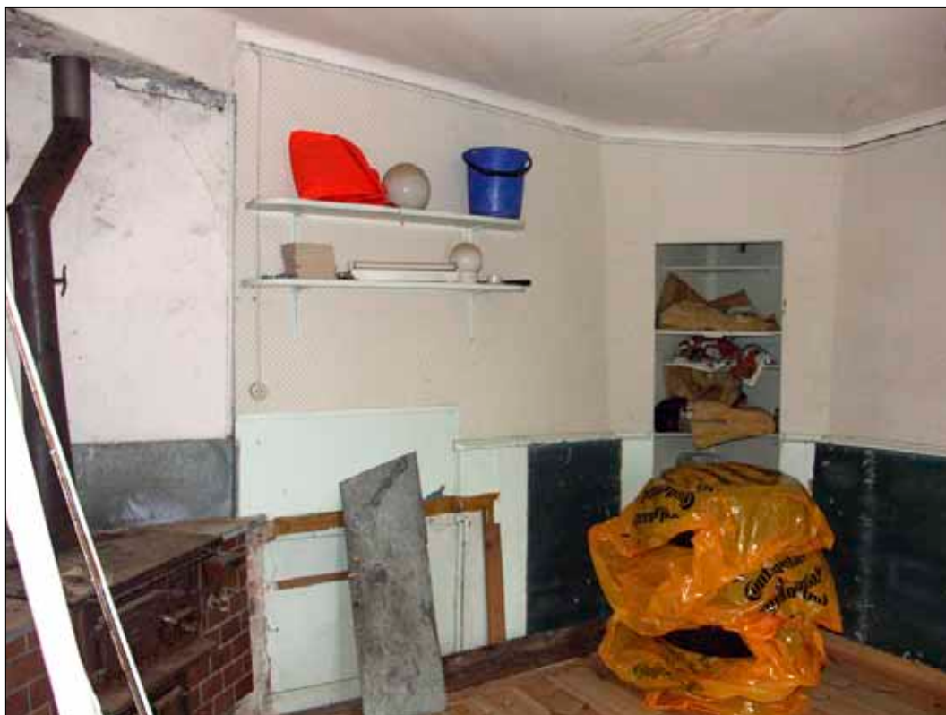
18 Drängkammaren sedd mot norr, där zinkplåten ovanför vedspisen och garderoben i nordöstra hörnet syns.
