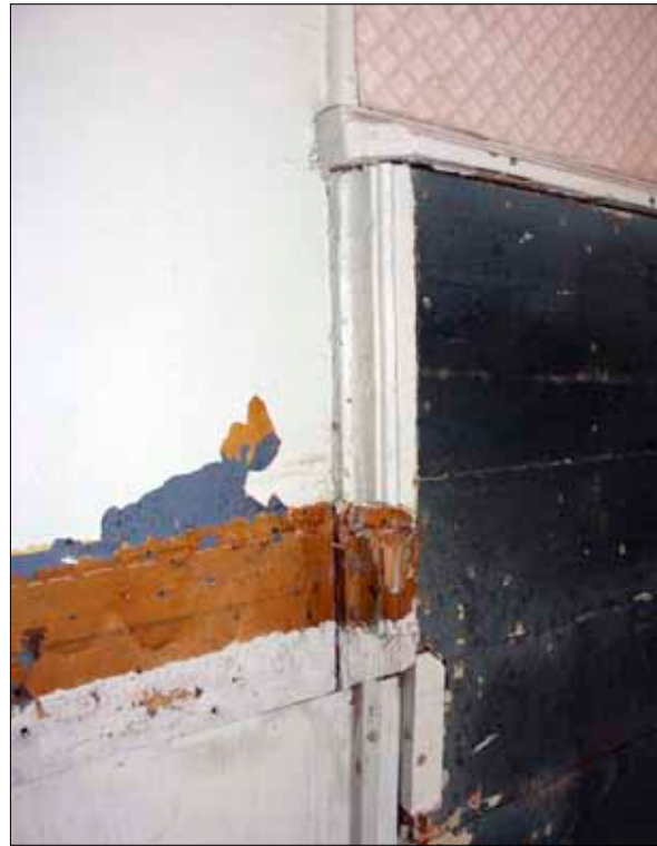
22 Björkimitation på väggytan bakom vedspisen, där zinkplåten varit monterad.
