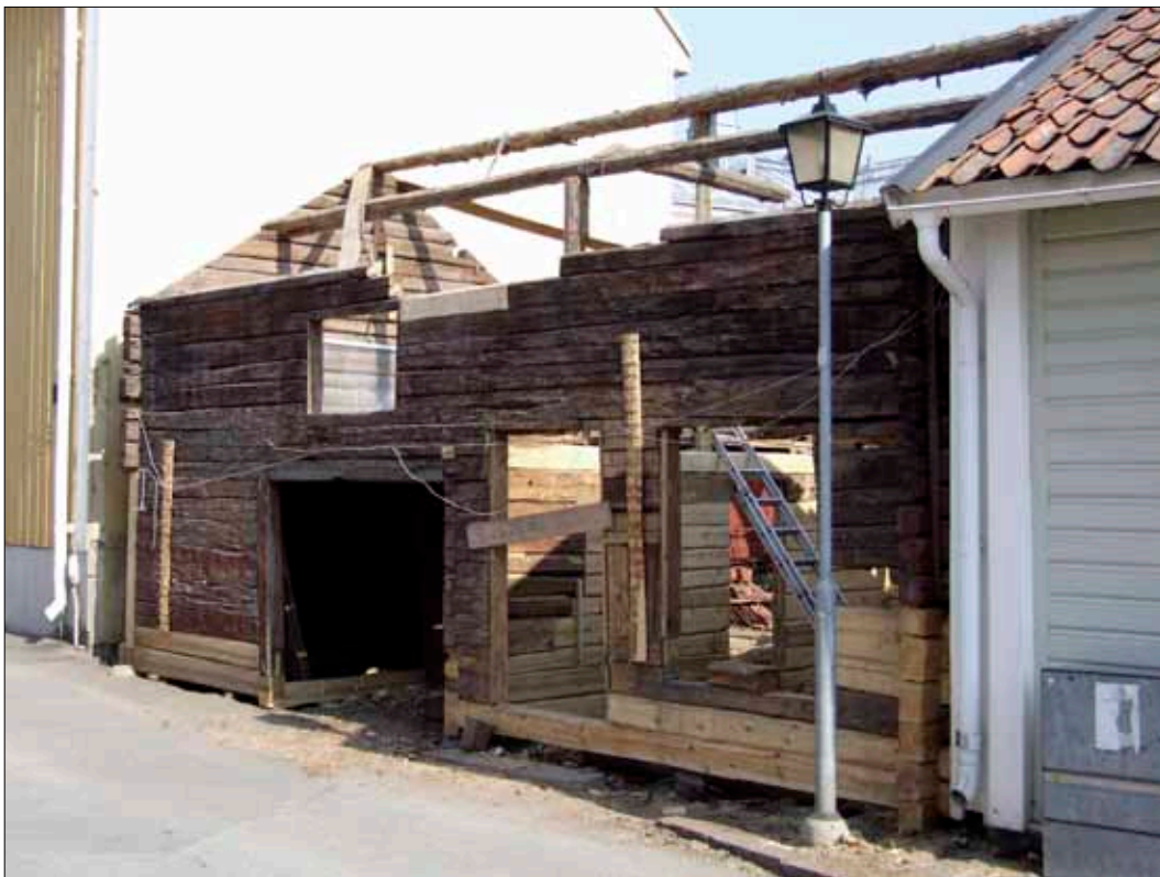
11 Fasaden mot Långgatan från sydväst under pågående renovering, 20080404 (D08-655).
