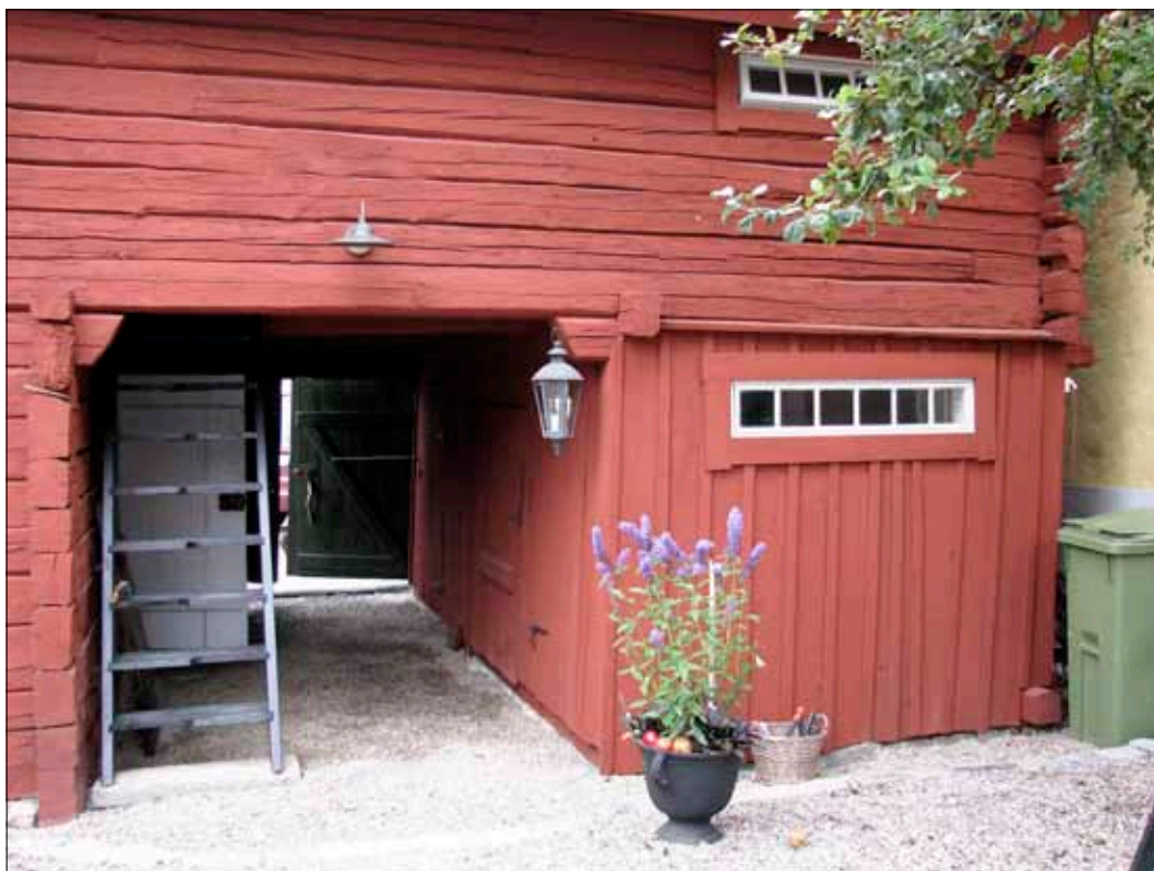
21 Portlidret och gårdsfasadens norra del från sydost efter avslutad renovering, 20080915 (D08-668).
