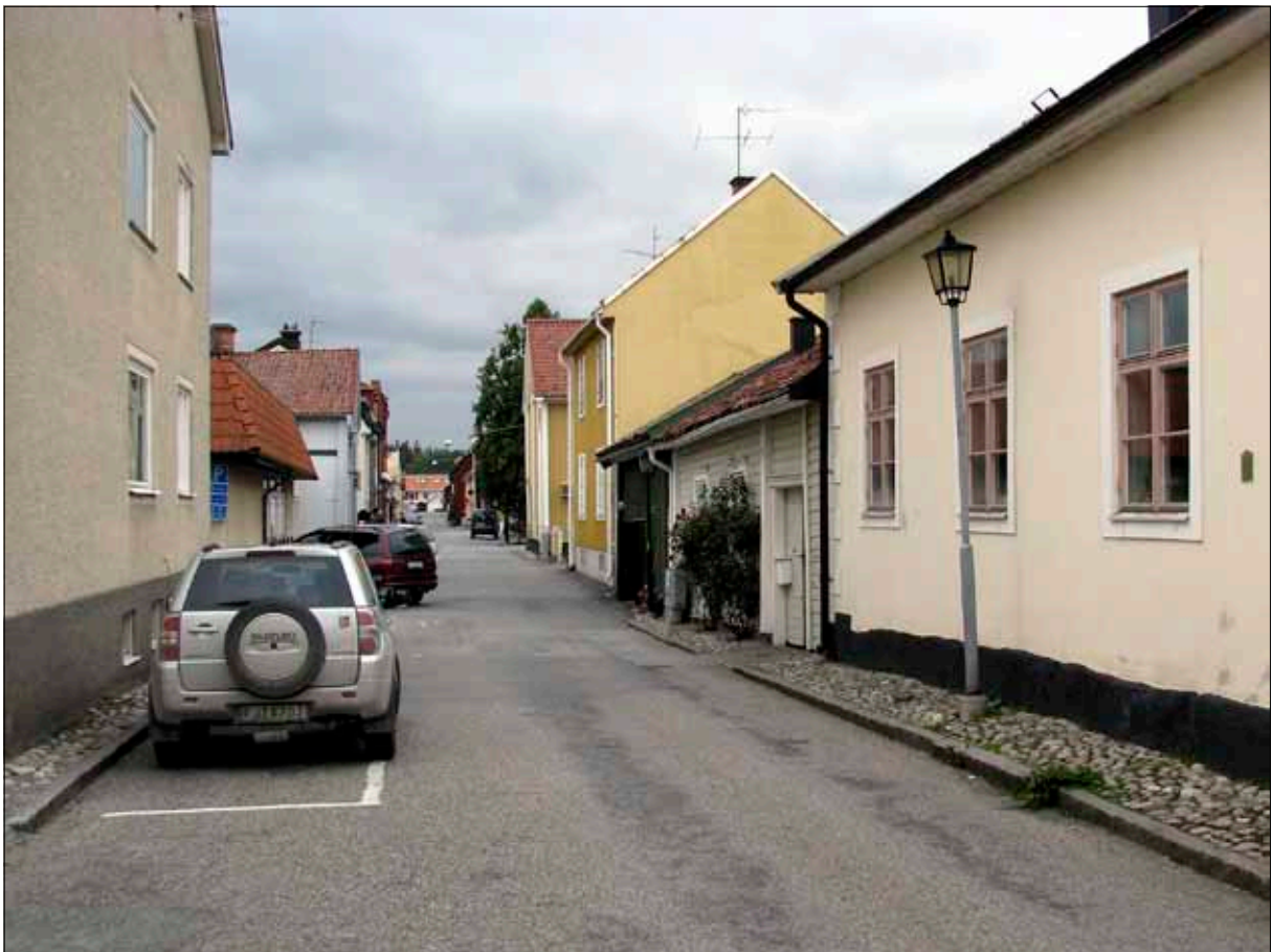
4 Det f d stallhuset utmed Långgatan äger ett stort miljöskapande värde vid gatan och i kvarteret. Fotografiet taget från sydväst, 20080915 (D08-669).
