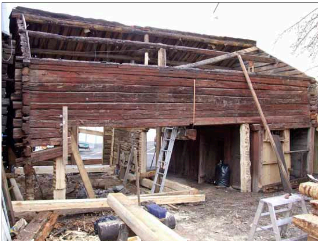
8 Det f d stall- och fähuset vid Långgatan 8 från sydost, 20080303 (D08-653).
