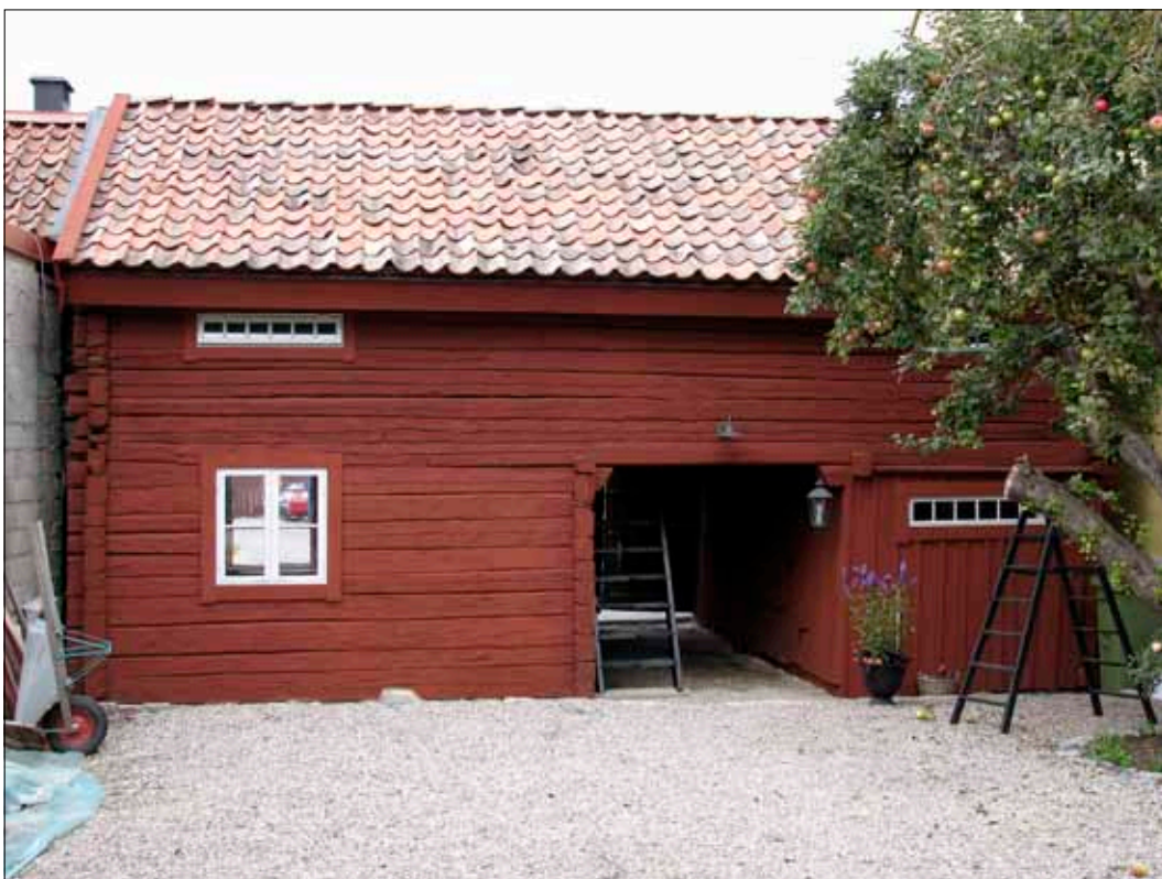
19 Gårdsfasaden från öster efter avslutad renovering, 20080915 (D08-667).
