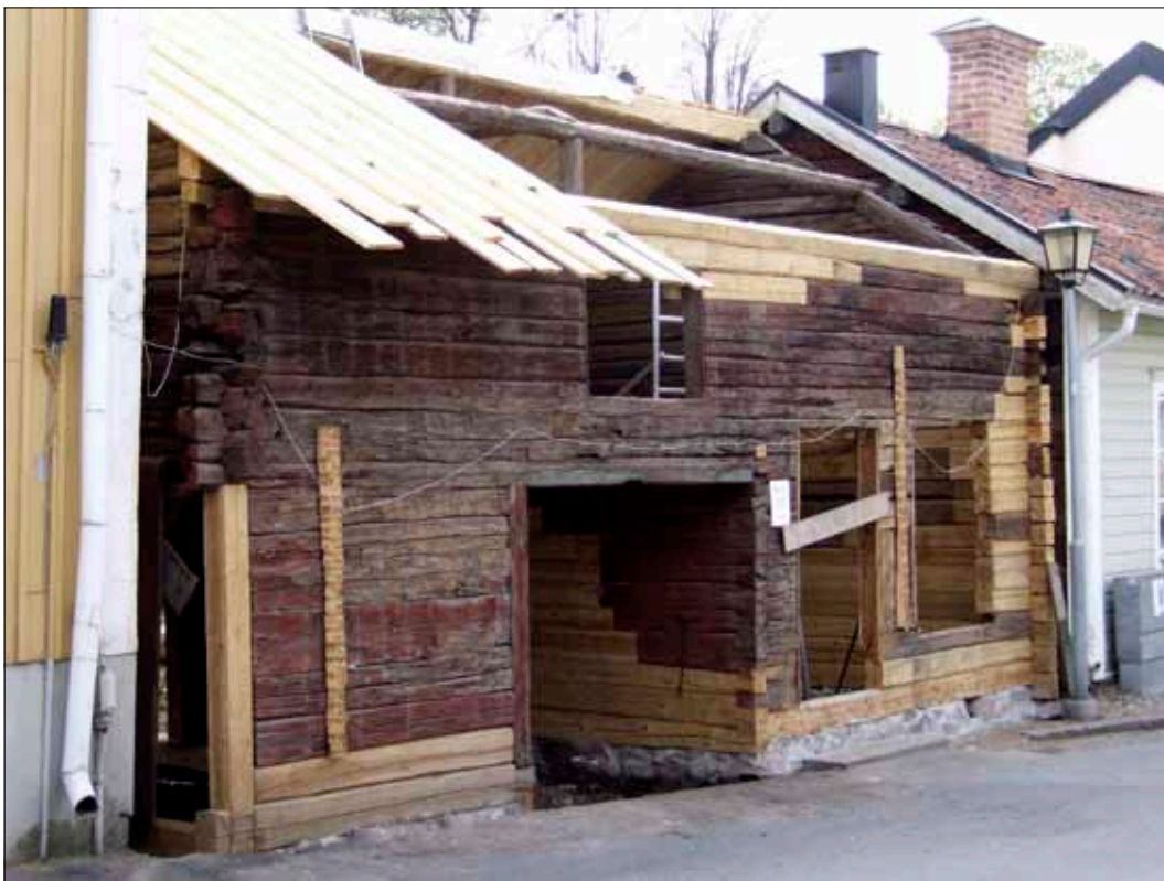
12 Gatufasaden från nordväst under pågående renovering, 20080507 (D08-659).
