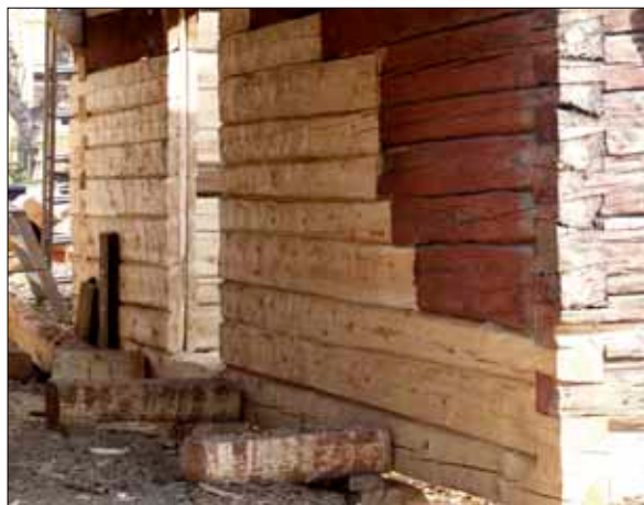
15 Portlidrets södra sida från nordväst, 20080404 (D08-658).
