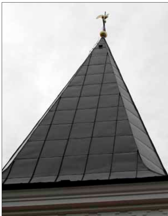
14 Torntakets plåt och nyförgyllt klot och tupp. En ny tornventilation togs upp i plåten nedanför tuppen.
