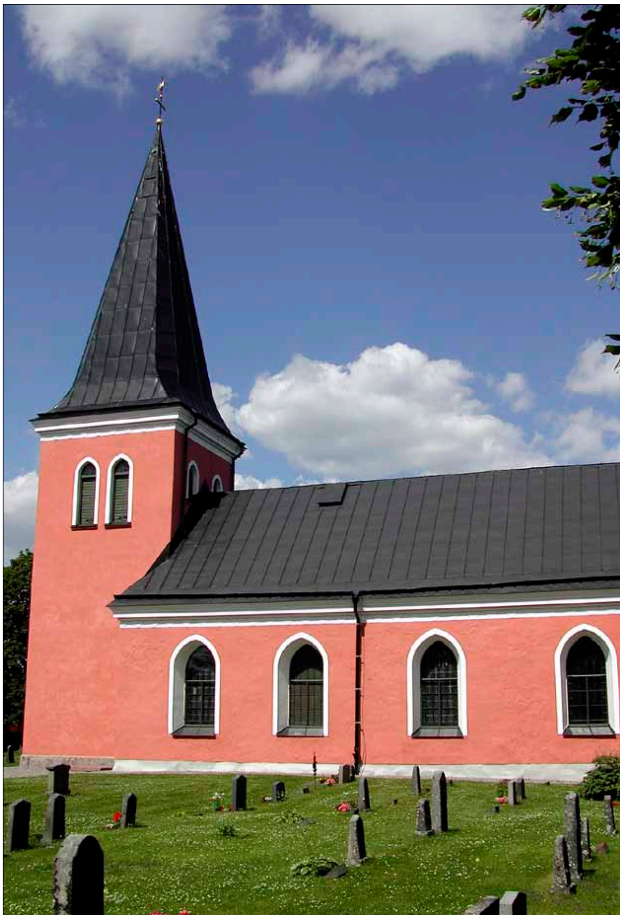
19 Länna kyrka med den varmare röda färgsättningen 2004.
