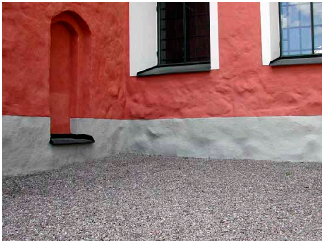
9 Sakristians nisch som markerar tidigare öppning togs upp och murades om 2004. Naturstensmuren är påtaglig.
