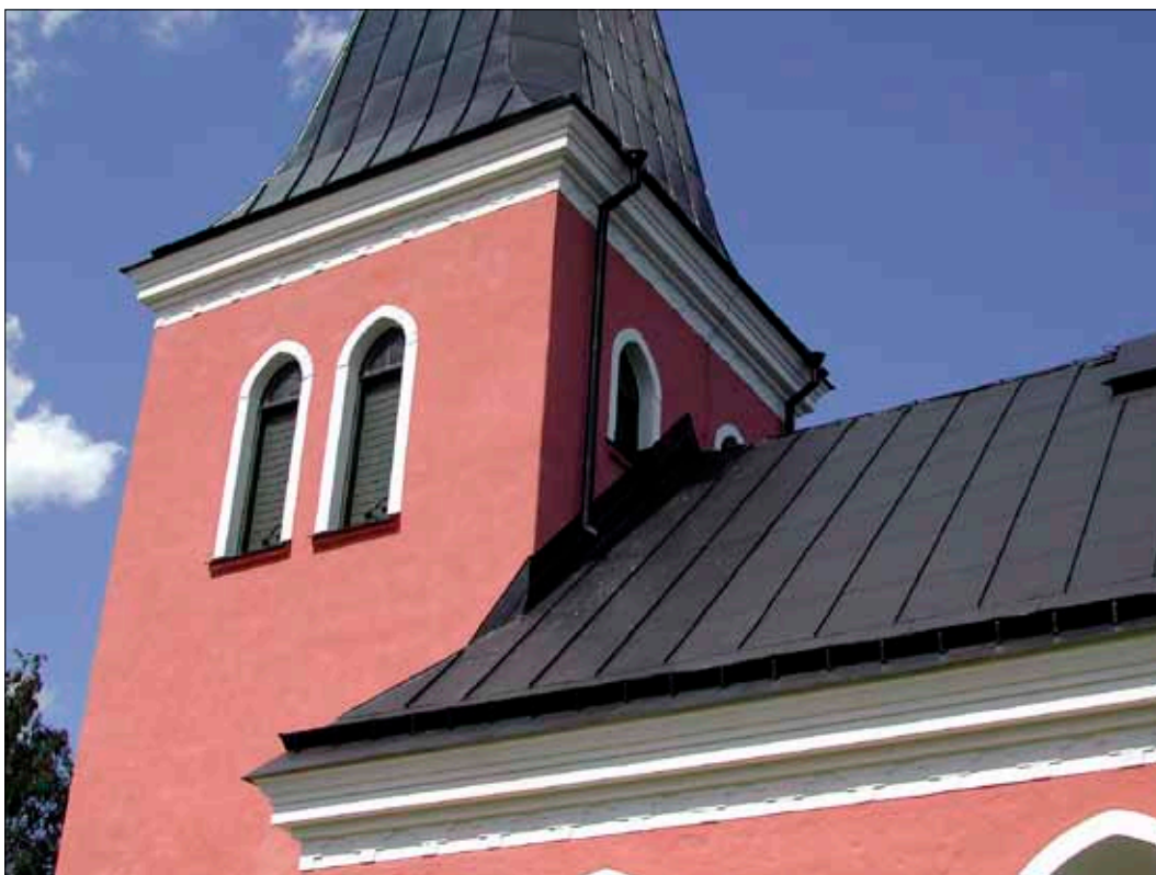
18 Detalj av tornets utsmyckningar, långhusets takfris samt plåtmålning.
