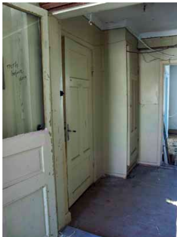
Bild 80. Vy mot öster av rum 211, med dörr in till 202A närmast och längst bort uppgången till vinden.
