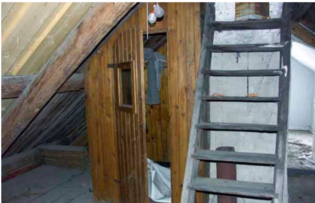
Bild 88. Förråd på vinden.
