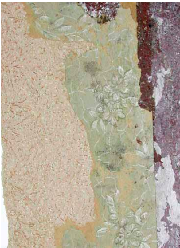
Bild 72. Till höger sjätte ytskiktet, grön tapet med blommönster i rum 207.
