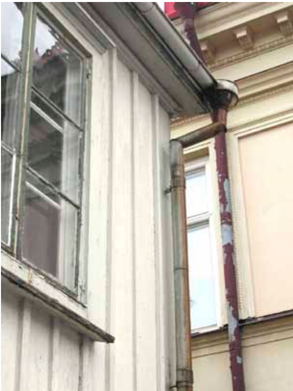
Bild 13. Stupspråk med raka knän och tratt i nordöstra hörnet av byggnaden.
