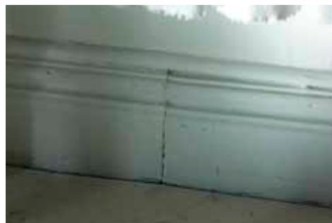
Bild 29. Profilerad golvlist vid norra väggen.
