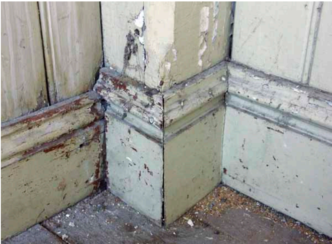
Bild 38. Detalj av verandans nordöstra hörn. Två olika golvlistprofiler finns.
