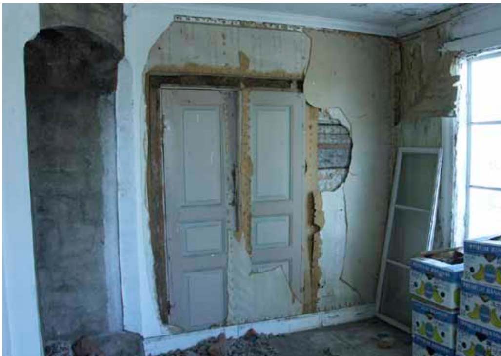
Bild 63. Vy av rum 206. Pardörren har varit försatt, vilket troligen gjordes vid sekelskiftet 1900.
