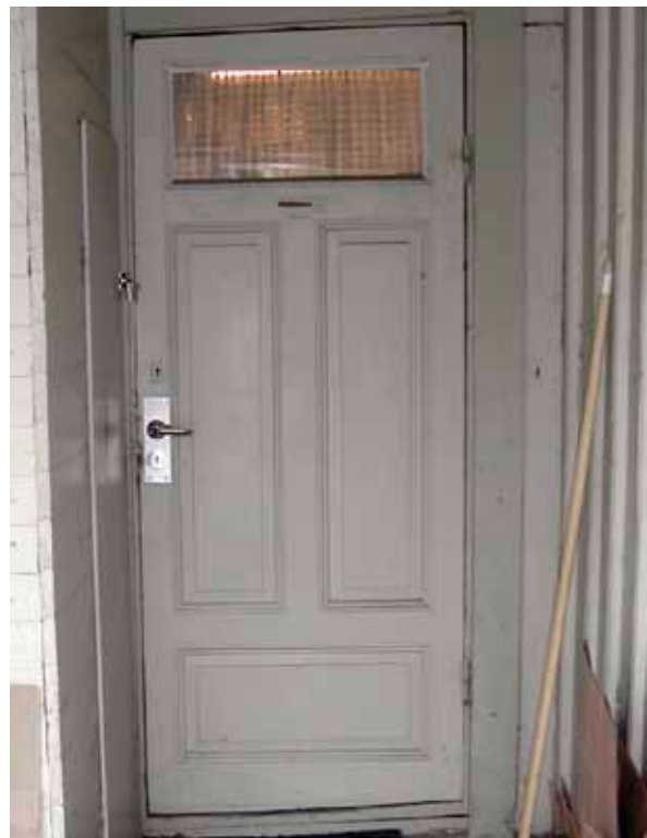
Bild 14. Dörr i norra fasaden in till östra butiken.
