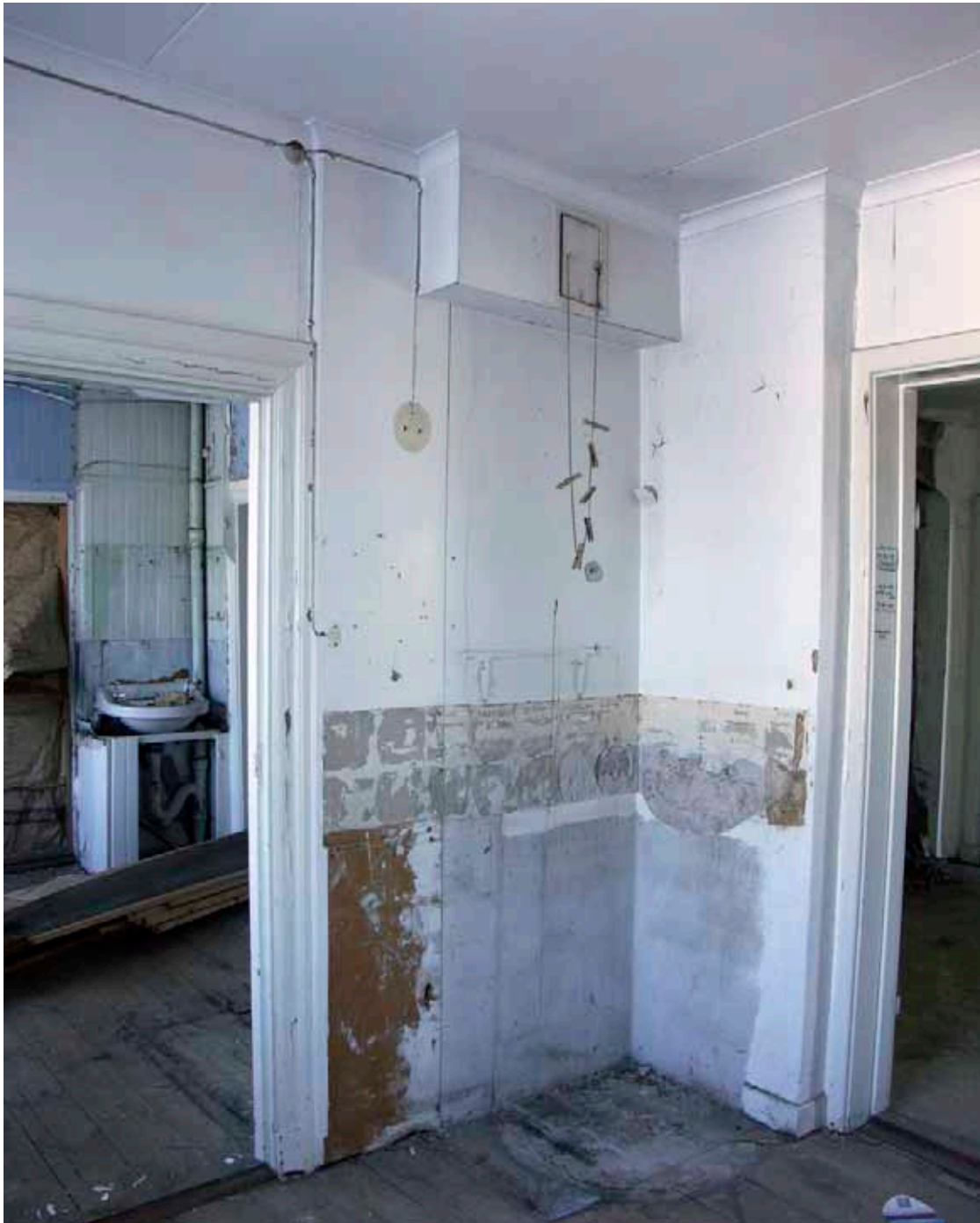
Bild 76. del av rum 208 sett in mot rum 209.
