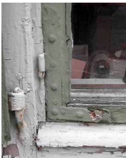
Bild 20. Äldre hörnjärn av 1700-talstyp som sitter på fönsterbåge på östra fasaden.
