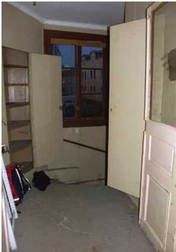
Bild 42. Övre vestibul mot trapploppet.
