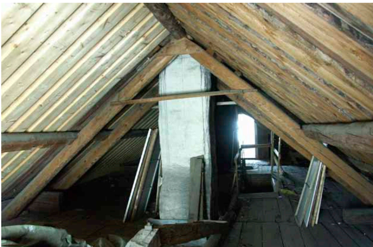
Bild 83. Vindsplanet mot väster. Södra takfallet är nyligen omlagt.
