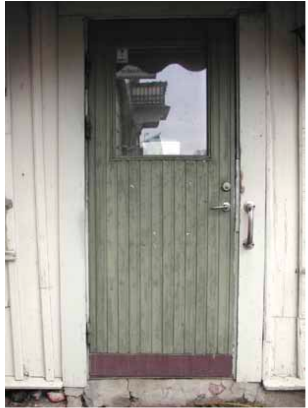
Bild 17. Södra dörren i västra fasaden.
