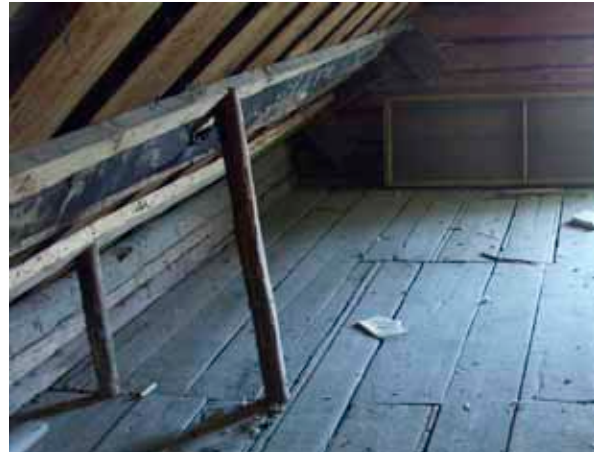
Bild 82. Detalj av golvbrädor på vind.
