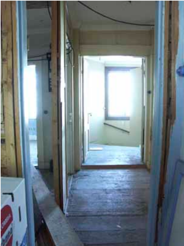
Bild 81. Rum 211 sett mot trapphuset.
