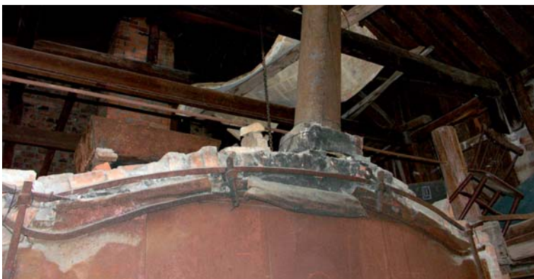
Bild 26. Skorsten som evakuerar röken vid förbränning i ugnens bakkant.
