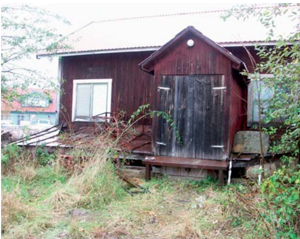
Bild 12. Utbyggnad mot söder. Det låga pulpettakets klätt med järnplåt täcker den del av källaren, där leran togs in och bearbetades.
