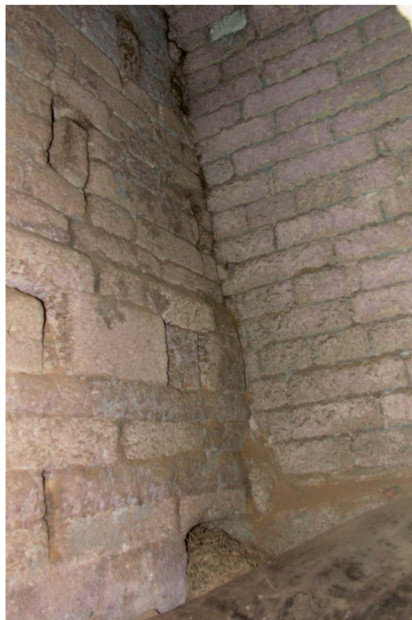
Bild 30. Vy upp i förrummet, där draghålen i ständarmuren är synliga. Ett flertal av hålen är försatta.
