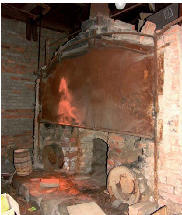
Bild 27. De tre eldinkasten vid ugnens baksida. Mittersta eldinkastet är öppet. De båda sidoeldhålen är täckta av löstagbara järnluckor.
