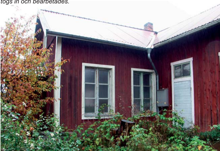
Bild 12. Utbyggnad mot söder. Det låga pulpettakets klätt med järnplåt täcker den del av källaren, där leran togs in och bearbetades.
