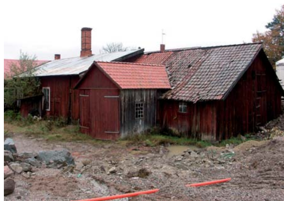
Bild 9. Krukmakeriet sett från sydväst. Ladans gavel till höger. Den höga skorstenen sitter ovan ugnens framkant och skorsten av plåt som evakuerar röken i ugnens bakkant ca 2.5 m ovan nock.
