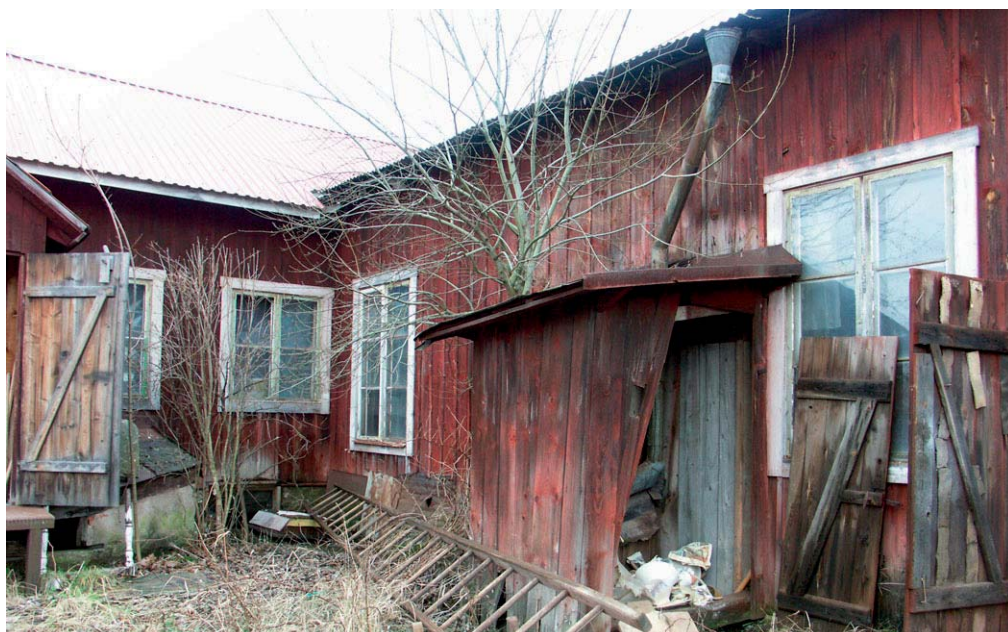
Bild 34. I öppningen under västra längans östra fönster, till vänster om husvinkeln, togs leran in till lerkällaren.
