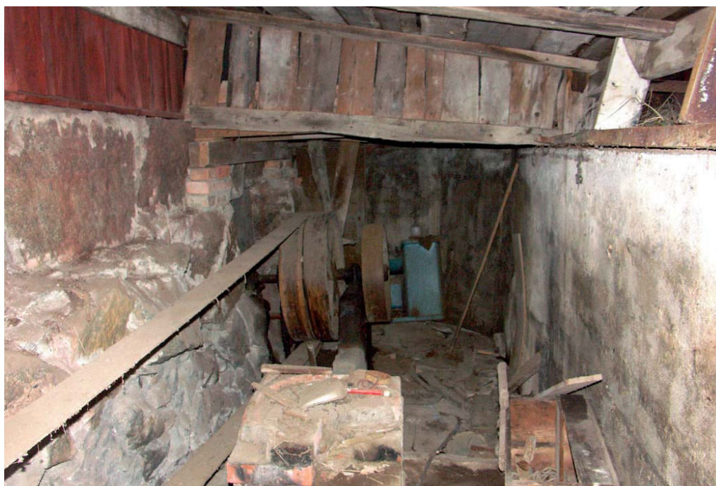
Bild 35. I utbyggnaden, se bild 12, är motorn som drev remmarna placerad.
