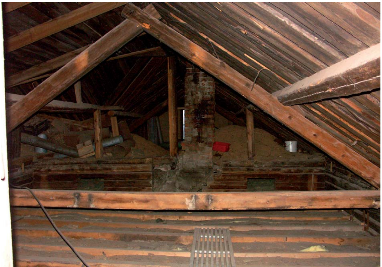
Bild 42. Takstolskonstruktioner ovan norra delen av verkstaden.
