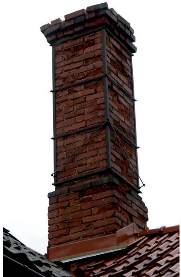
Bild 33. ...och den utkragade skorstenen med 2 1/2 sten ovan nock.
