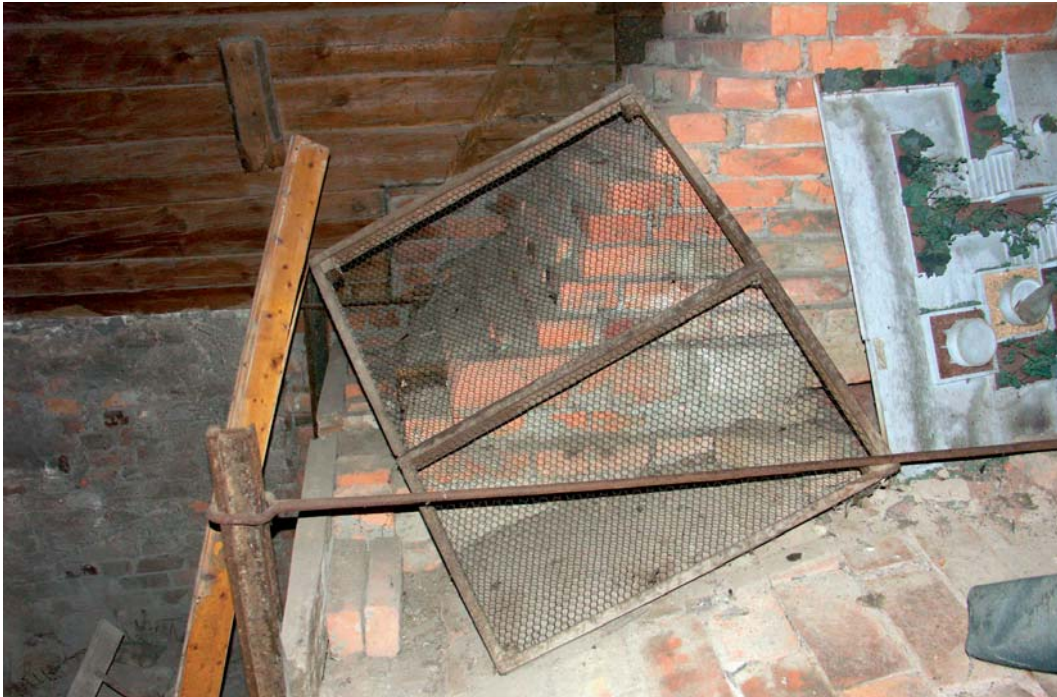
Bild 31. Murstockens nedre del. I bild syns järnstängerna som håller ihop ugnen. Fotografi taget ovanpå ugnen.
