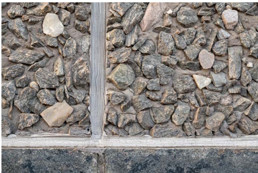
Närbild av ett prefabricerat betongelement med ballast av krossmaterial i ytan. Merparten av stenarna är grå, men en del är vita. Betongstenarna är fogade med någon slags mjukfog. (SLM D2024-0055)
