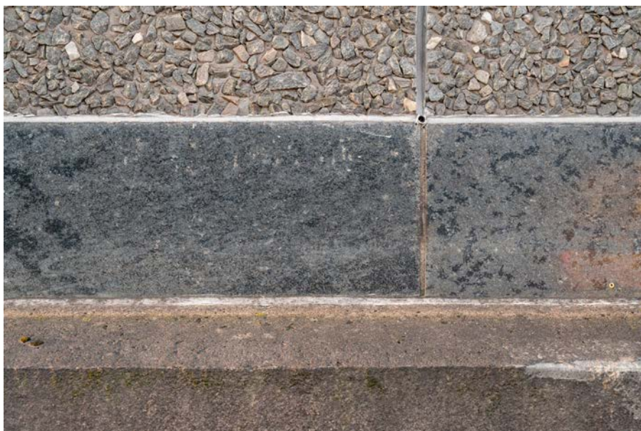
Detalj av naturstensockeln som fortfarande finns kvar på baksidan av byggnaden. Tidigare löpte stensockeln också längs hela torgsidorna. (SLM D2024-0054)
