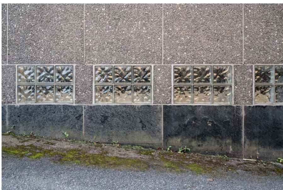
I anslutning till den nordvästra entrén finns ljusinsläpp till bottenvåningen genom betongglas. (SLM D2024-0056)
