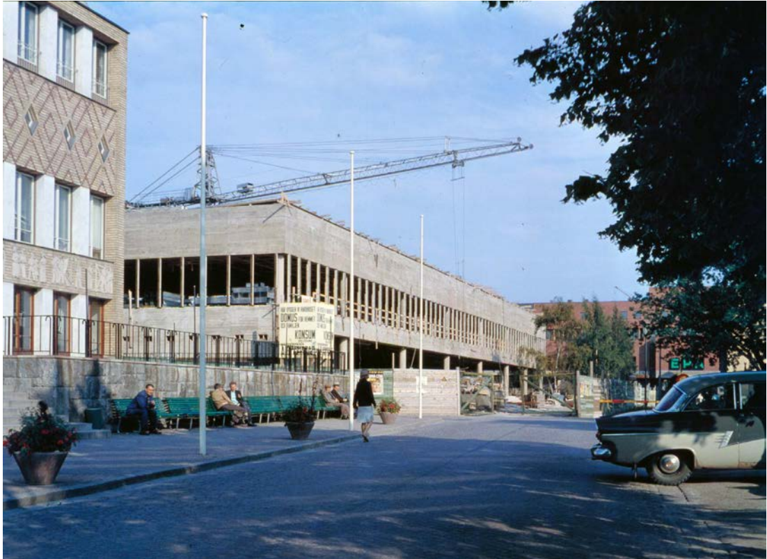
Bild tagen under bygget av Domus-varuhuset. Till vänster syns Folkets hus och i bakgrunden till höger det nyligen uppförda EPA-varuhuset. På bilden syns de runda betongpelarna som utgör den bärande konstruktionen. Foto: Ulf Wallnér. (Oxelösundsarkivet, Bild ID: 012079)
