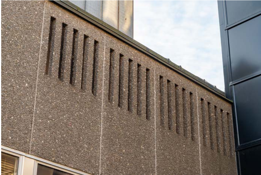
Den nord-västra fasadens långsmala öppningar som utgörs av nätade ventilationsöppningar. I samband med tillbyggnaden av Folkets hus täcktes en stor del av öppningarna för. (SLM D2024-0057)
