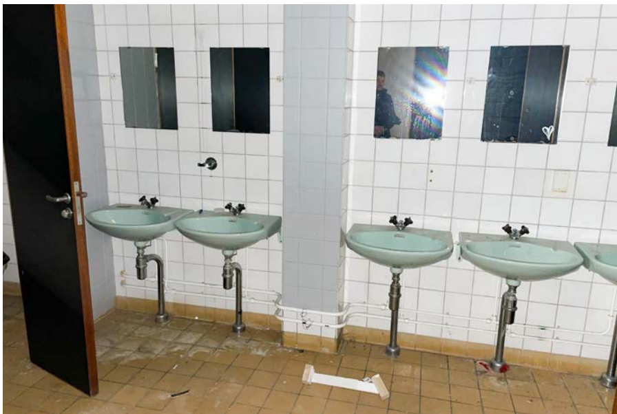
I omklädningsrummen finns många bevarade detaljer, däribland handfat, duschar och dörrar till toalettutrymmen. (SLM D2024-0068)
