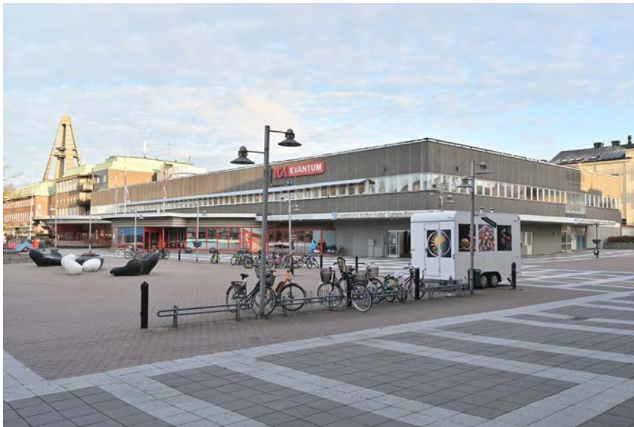
Domusbyggnaden sedd söderifrån. De långa fönsterbanden och taket utan uppstickande delar är påtagliga karaktärsdrag. (SLM D2024-0050)
