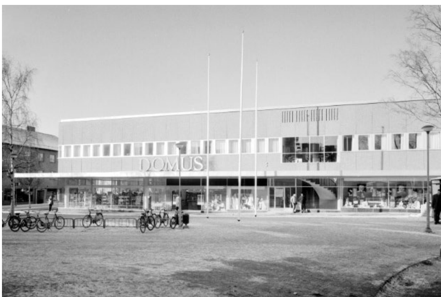
Domusvaruhuset sydöstra fasad. Trapphusets spiraltrappa till andra våningen bildar tillsammans med det glasade partiet och försänkningarna i fasaden dekorativa inslag. Trappan ersattes med raka trapplopp i samband med att en hiss installerades. (Oxelösundsarkivet Bild ID: 017449)
