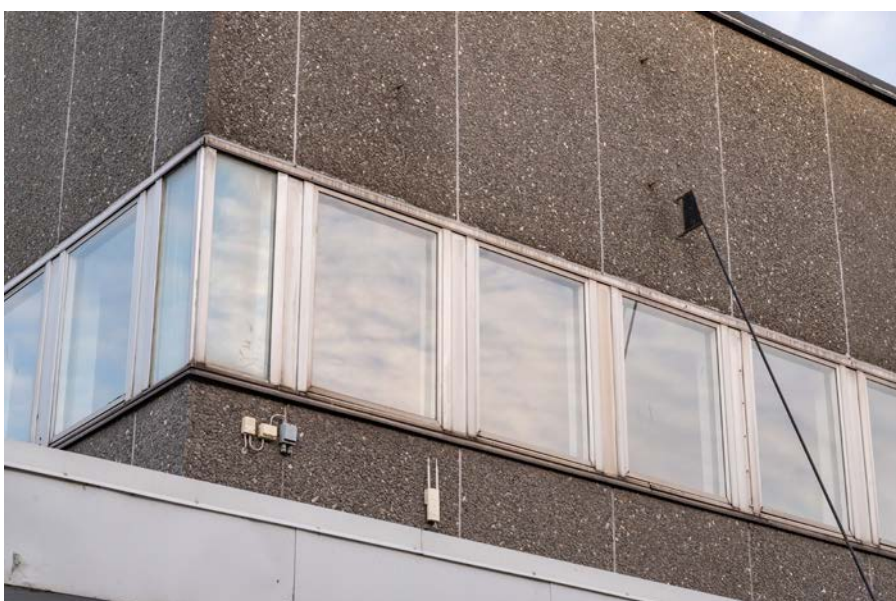
Detaljbild av fönsterbanden på andra våningen. Både fönsterbågar och intäckningar över, under och mellan fönster är av aluminium. (SLM D2024-0059)
