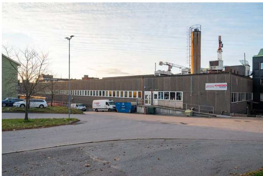
Domusbyggnadens baksida med entrén till kommunens lokaler på andra våningen i mitten av bilden. Längs med fasaden till vänster löper en väg ned till lastintaget som anordnades 1997. Till höger skymtar den nordvästra entrén som leder till bottenvåningen. (SLM D2024-0053)
