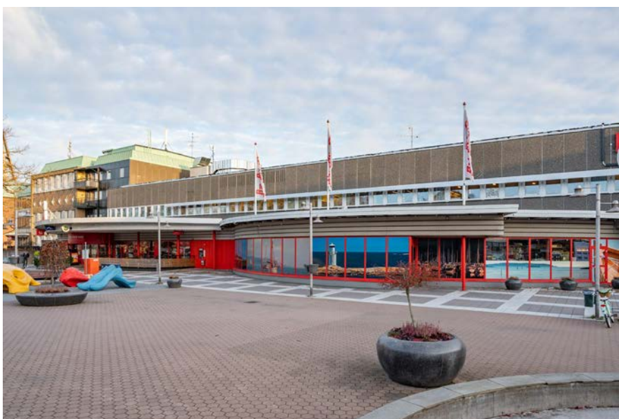
Torgfasaden med ICA:s två tillbyggnader mot torget. Den högra av dem byggdes 1999 och innehöll förbutik och café. 2013 uppfördes den västra delen och caféet och förbutiken flyttade innanför den nya delen. Fönsterpartierna sattes för i samband med det. (SLM D2024-0073)
