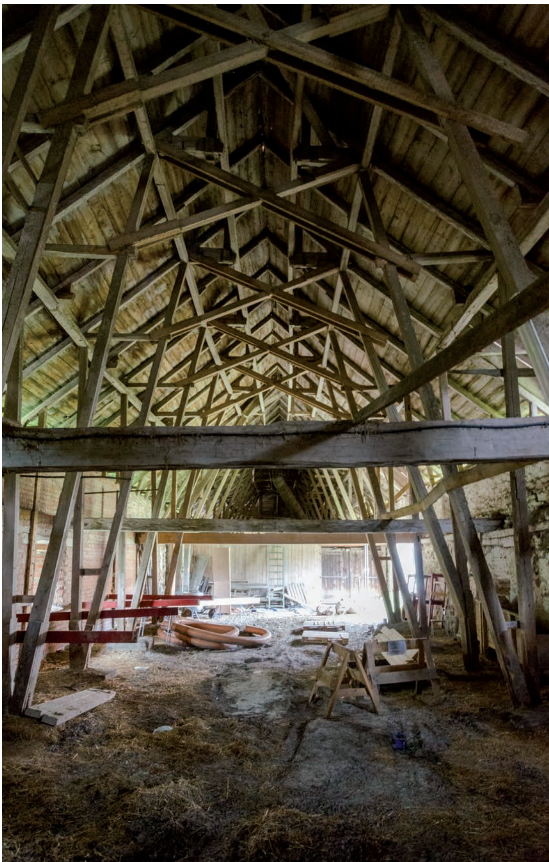
Den södra delen av västra längan sedd söderifrån. Kryssen i mitten av takstolarna är senare stabiliseringsåtgärder. Bakom väggen i mitten av bilden ligger kostallet.
