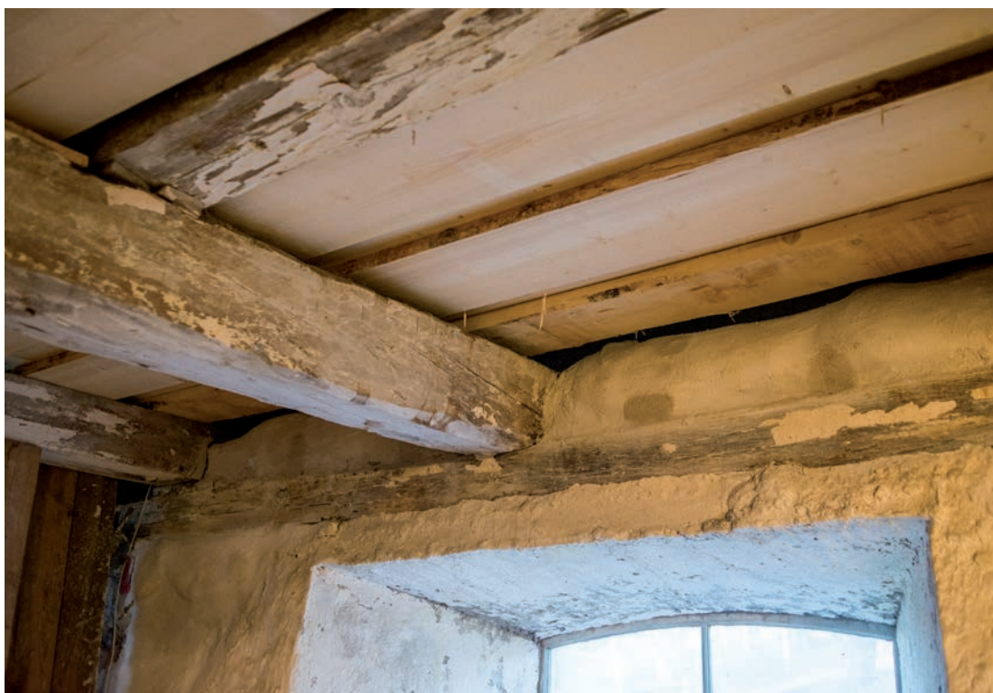
De äldre bjälkarnas anslutning till muren på den västra sidan. Muren har lagats och putsats. Upptill skimtar en av takstolarnas bärlinor. (SLM D2019-0111)
