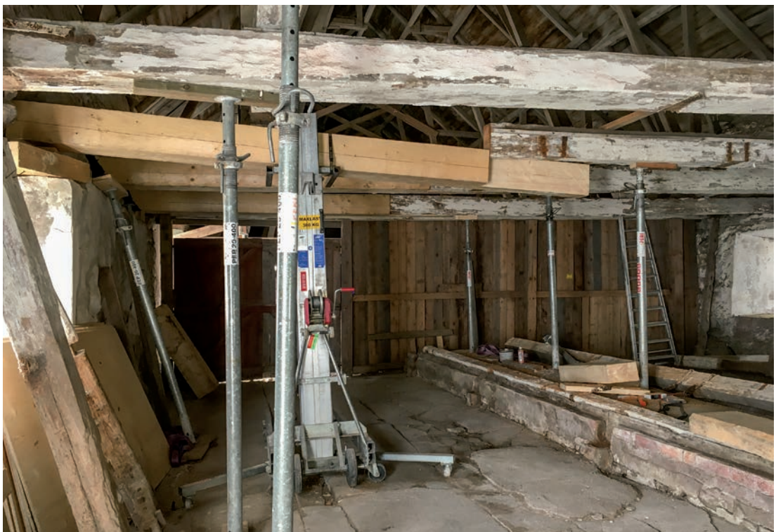
Kostallet under pågående arbete med skarvning av bjälkarna. De bortre bjälkarna är skarvade och klara. Foderbordet monterades ned för att möjliggöra arbetet, och delarna ligger på bordet samt står längs väggarna. (SLM D2019-0097)
