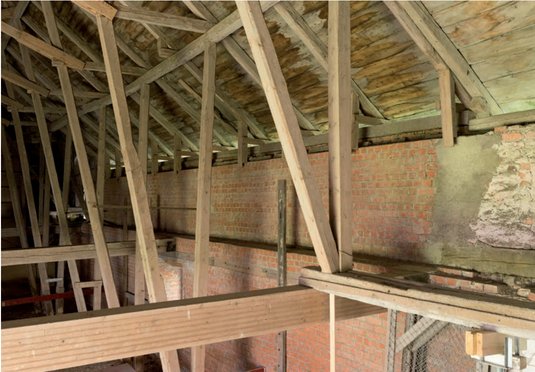
Södra delen av västra längan sett från vindsvåningen. Närmast i bild syns den limträbalk som sattes in 1985 samt den del av ytermuren som ommurades. På muren syns de korta stödben som i olika grad halkat av muren. Till höger ses en bärlina som stöts av skruvstämp. (SLM D2019-0088)
