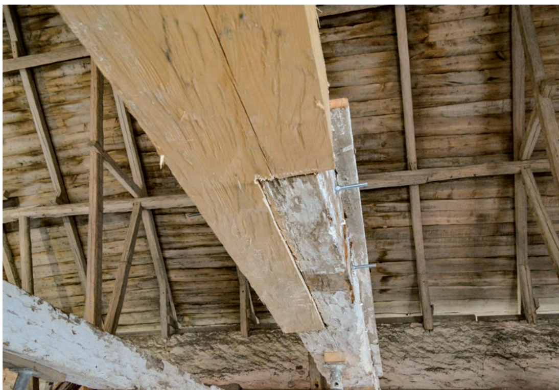
Skarvarna utfördes halvt i halvt. (SLM D2019-0099)
