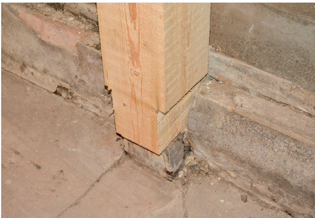
Det nya forderbordets stolpar har fasats ur för att passa i de äldre urtagen. (SLM D2019-0109)
