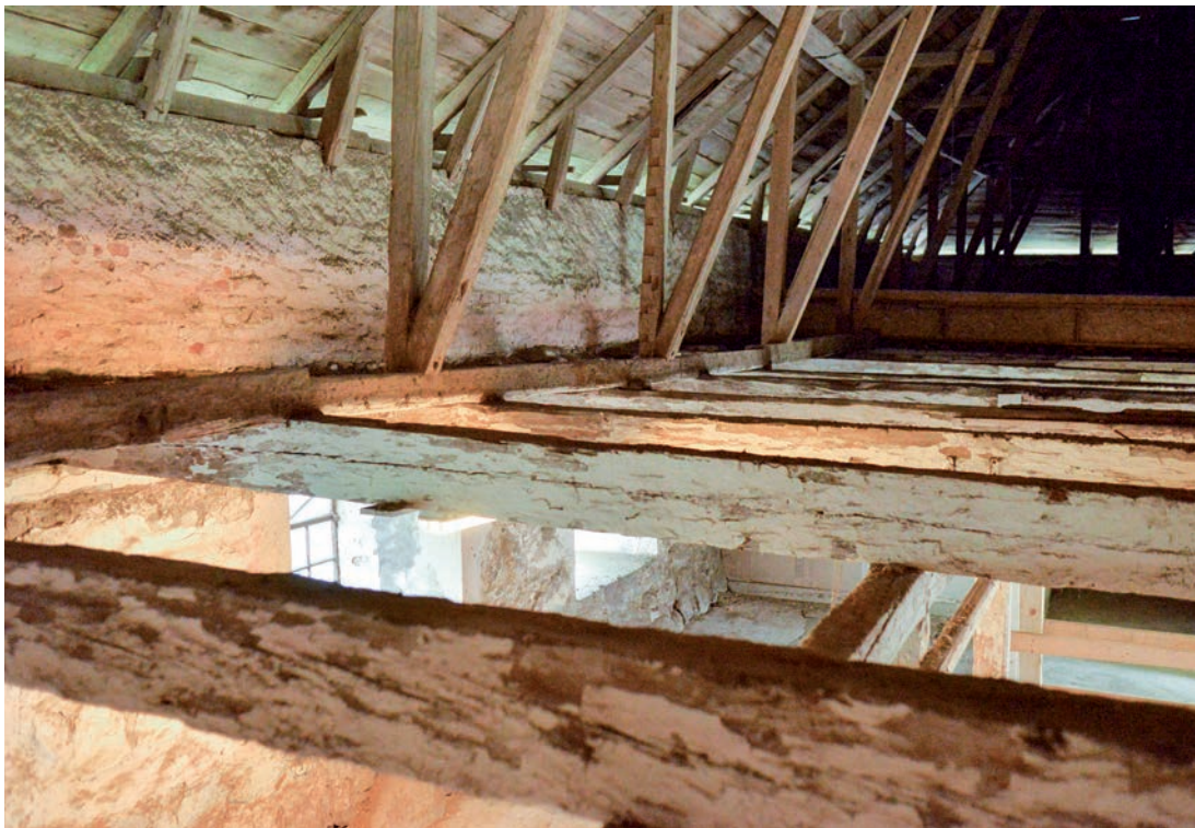
Bjälkarna över kostallet sedda söderifrån efter att vindsvåningens golv rivits. Notera takstolarna som vilar på en längsgående bärlina. Den borte delen sprack under renoveringen och ersattes av en ny. (SLM D2019-0092)
