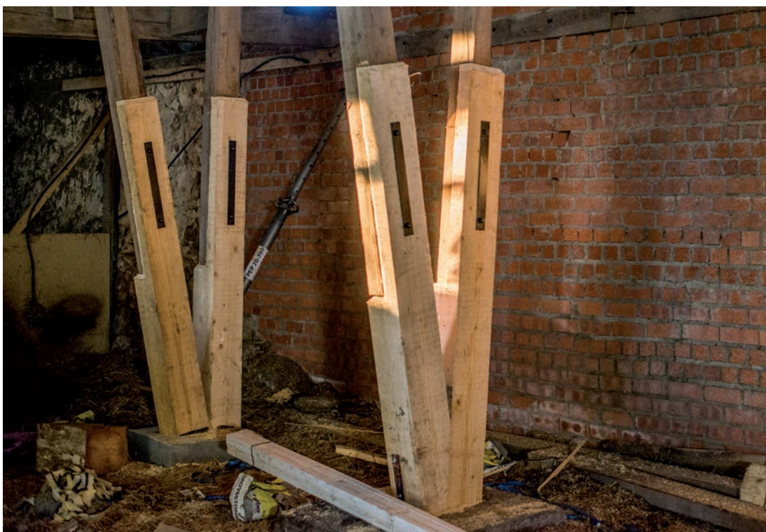
TVå nya skarvar på takstolarnas stödben sammanfogade med gängstång och mutter genom plattjärn. (SLM D2019-0105)
