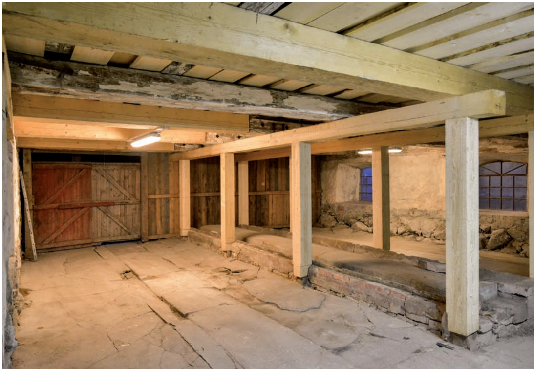
Kostallet sett från norr efter slutfört arbete 20171218. (SLM D2019-0108)
