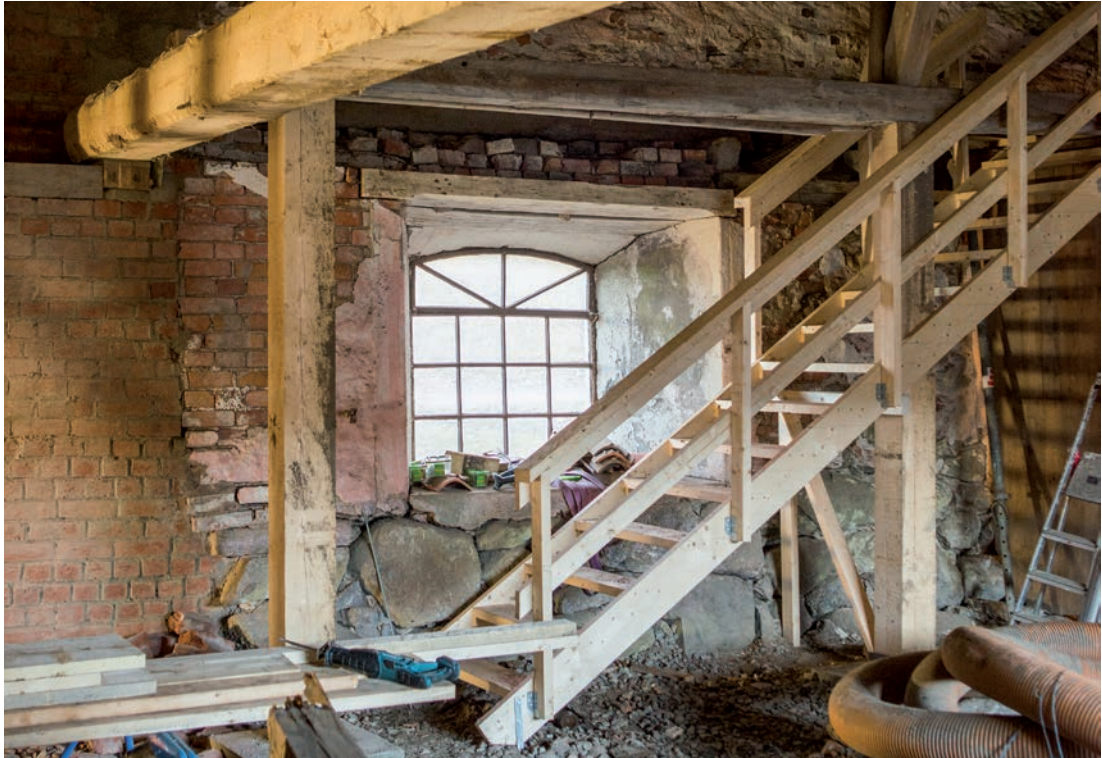
Den nya trappan upp till vindsvåningen ovanför kostallet. Den tidigare uppstämpade bärlinan har försetts med två nya stolpar stående på var sin betongklack. Överst i bild skimtar den nya bjälken som ersatte limträbalken. (SLM D2019-0106)
