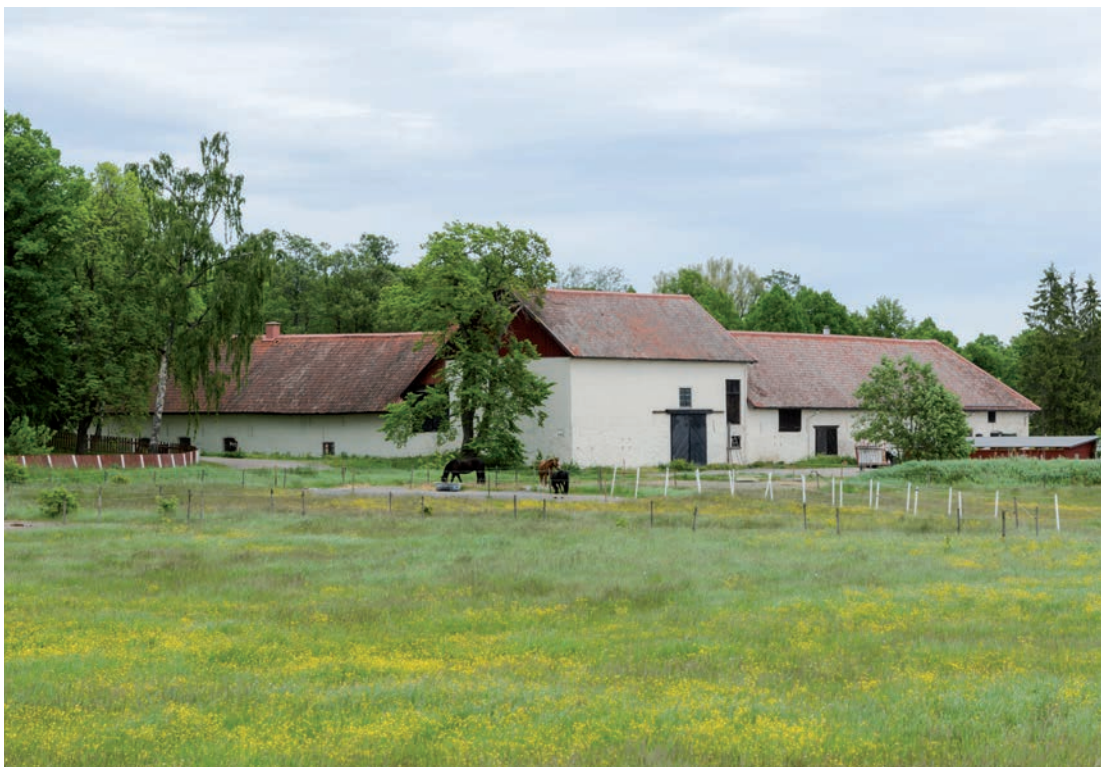
Stjärnholms ladugård fotograferad från sydväst 2015. Den södra delen av västra längan syns till vänster i bild. Delen med förhöjt tak närmast i bild rymmer fyra silotorn. (SLM D2019-0081)
