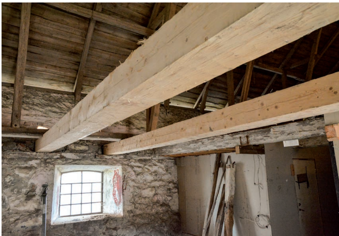
De två norra bjälkarna som byttes ut i sin helhet. I bakgrunden syns väggarna till det ena av förråden som ligger mellan kostall och häststall. (SLM D2019-0098)
