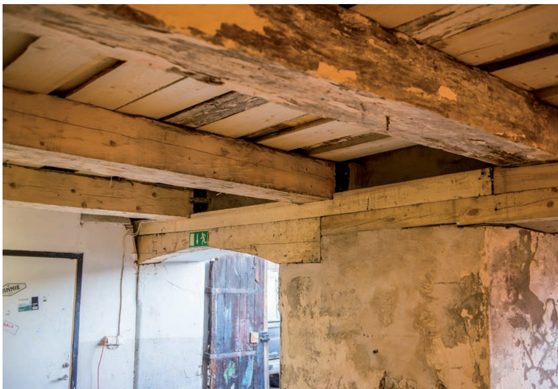
Ingången till kostallet med en äldre bjälke närmast i bild samt två nya. Över ingången har lagts en bjälke som sågats med motorsåg likt den äldre förlagan. Muren har lagats med ny puts. (SLM D2019-0110)
