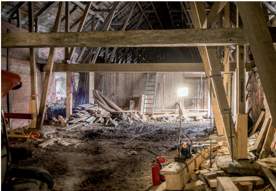
Den södra delen sedd söderifrån under pågående arbete. Bakom väggen i bakgrunden ligger kostallet. (SLM D2019-0104)
