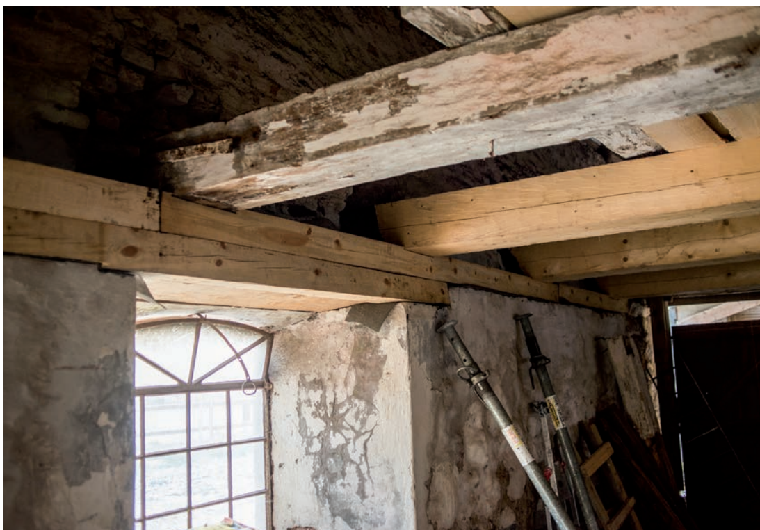
Det nya remstycket på den östra sidan. Mellan mur och remstycke lades papp för att reducera fuktvandring. (SLM D2019-0103)
