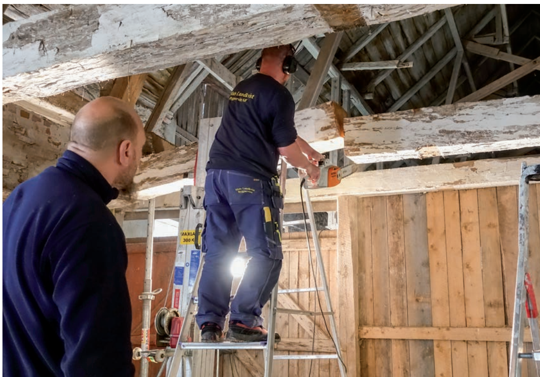
En av bjälkarna sågas av för att skarvas över foderbordet. Den avsågade delen hålls upp av en saxlift. (SLM D2019-0094)
