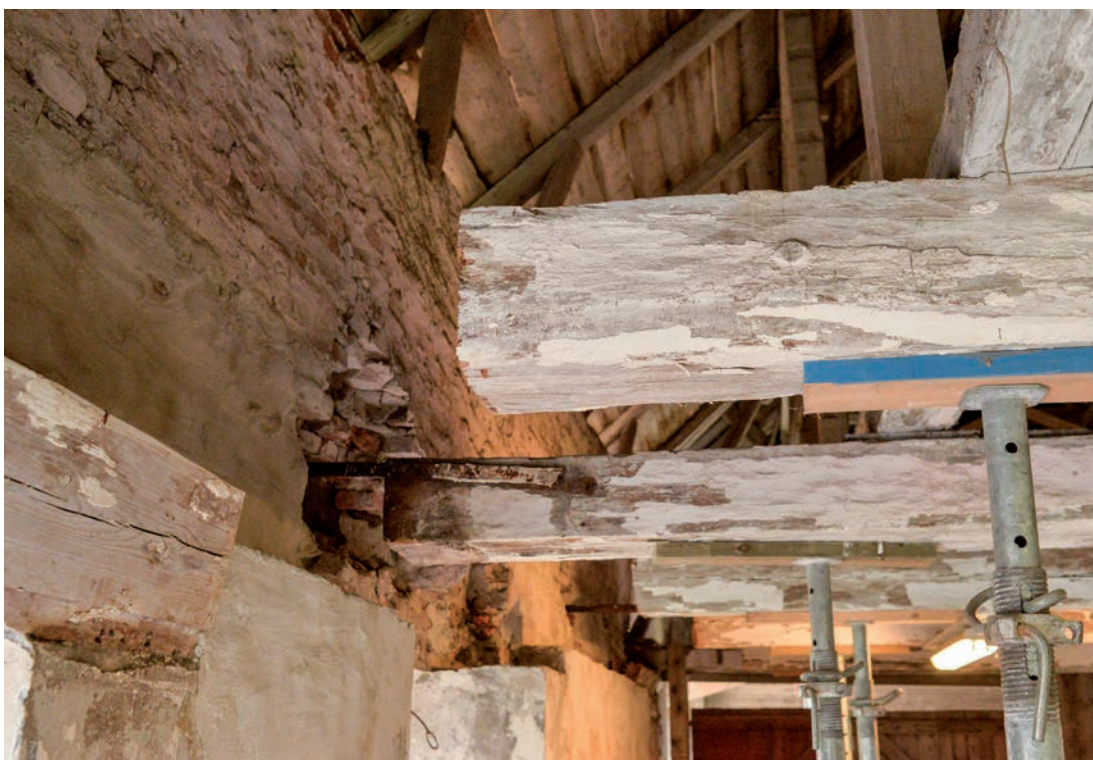
Bjälkarnas östra ändar sågades av för att möjliggöra rivning av remstycke och mur. (SLM D2019-0093)
