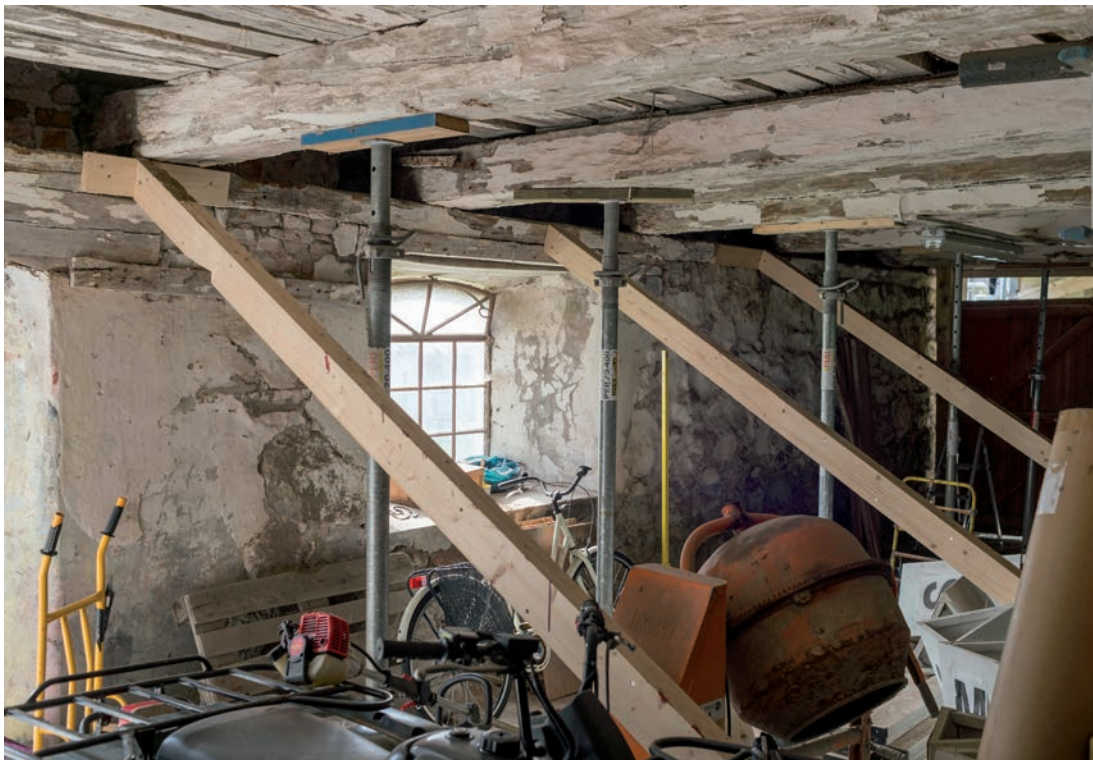
Kostallets inre mur före åtgärd. Bjälklaget är uppstöttat med skruvstämp och remstycket hålls tillbaka med plank ställda mot foderbordet. Utrymmet används som förråd. Bjälkar och entresolgov är vitkalkade. (SLM D2019-0084)
