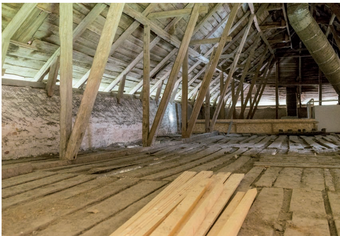
Vindsvåningen över kostallet sedd mot norr före åtgärd. (SLM D2019-0087)
