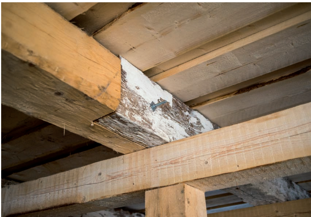
En av skarvarna efter att det nya golvet på vindsvåningen lagts på plats. Notera foderbordets sågade yta. (SLM D2019-0102)
