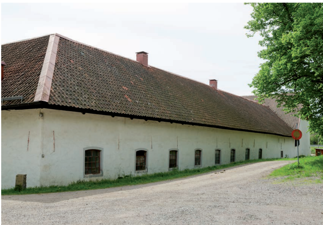
Västra längan sedd från nordväst. Bakom de första tre fönstren ligger häststall och fönstret därefter hör till ett mindre förrådsutrymme. Därefter kommer kostallets tre fönster. Bjälklaget markeras av de raka ankarslutarna över fönstren. (SLM D2019-0083)
