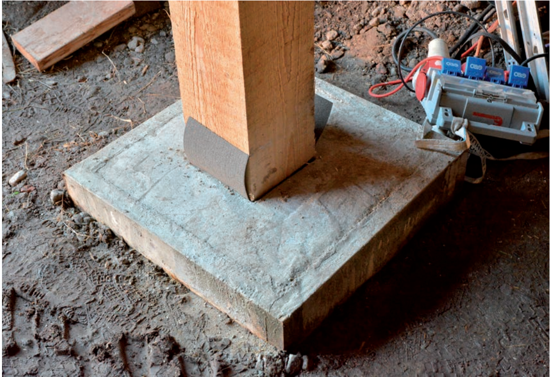
En av de nya stolparna vid ingången till den södra delen av västra längan. Här göts en ny betongklack med urtag för stolpen. Mellan betong och stolpe lades papp för att reducera fuktvandring. (SLM D2019-0100)
