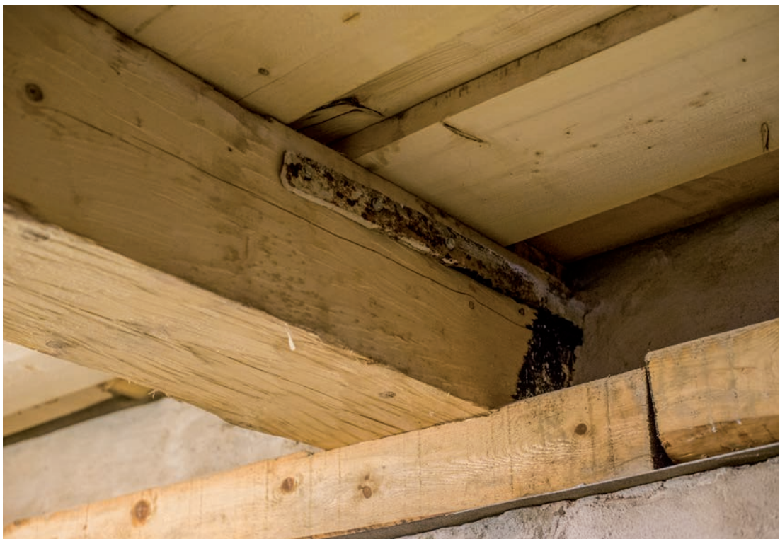
En bjälkände av nytt virke vid den östra muren. Bjälken har sammanfogats med de gamla ankarjärnen. Bjälkarnas ändar är tjärade för att göra dem mindre fuktkänsliga. (SLM D2019-0107)
