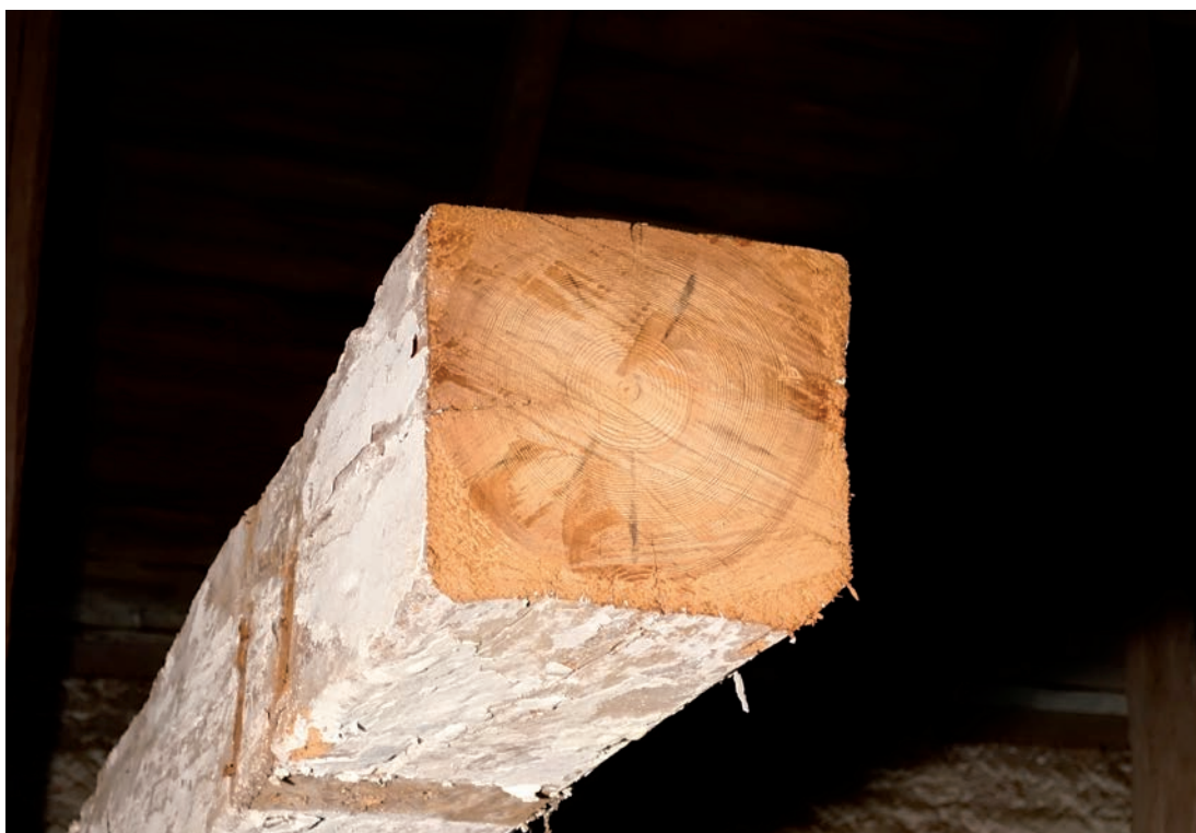
Den avsågade ytan visade ett mycket tätvuxet virke med en centrerad märke. Bjälken doftade starkt av kåda och var bortsett från den mjukare splintveden i mycket gott skick. (SLM D2019-0095)
