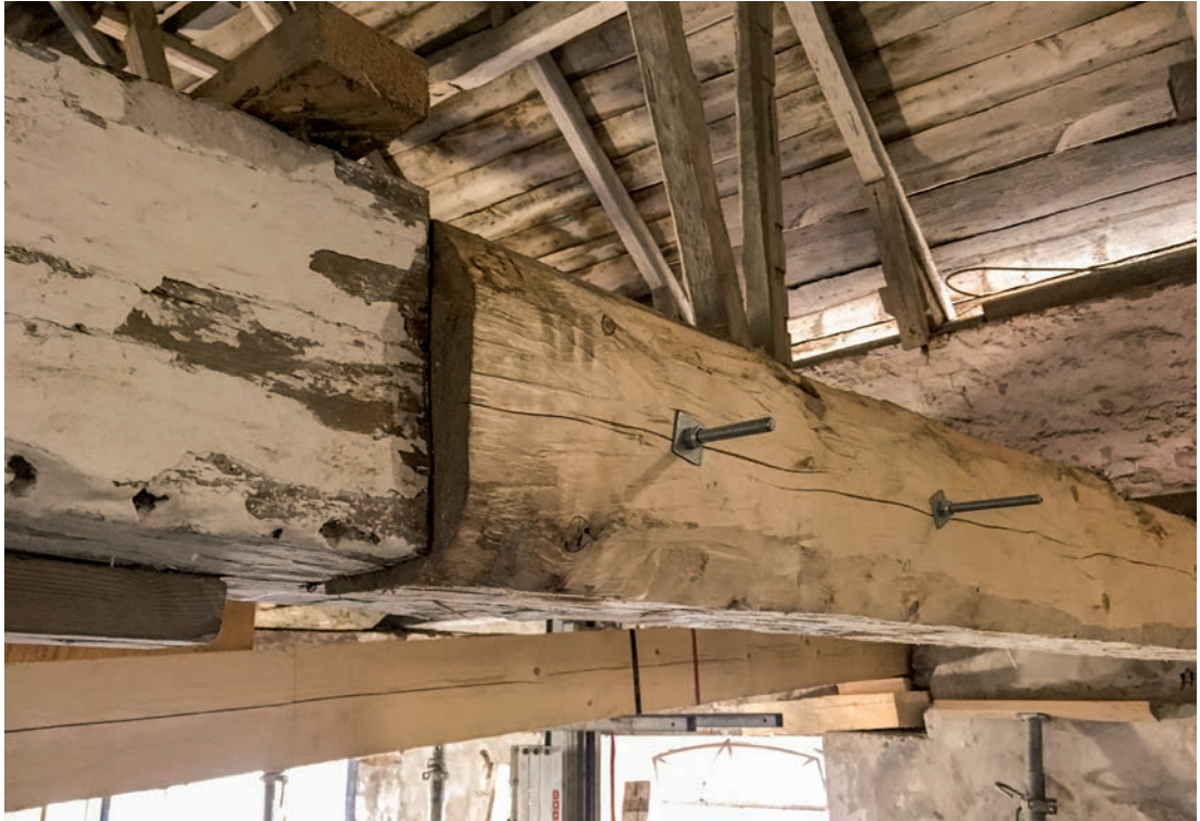
En av de nya skarvarna med en tillfällig gångstång och mutter. Det nya virket skiljer sig något i dimension från det äldre. (SLM D2019-0096)
