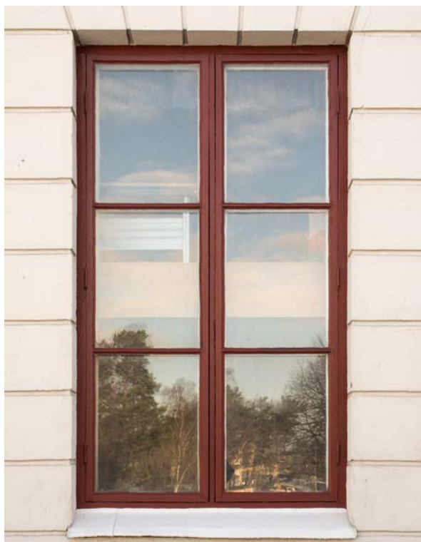
Ursprungligt fönster på D-skolan som finns bevarat på norrfasaden. Fönstret har två spröjsade lufter med tre rutor i varje båge. (SLM D2018-0404)
