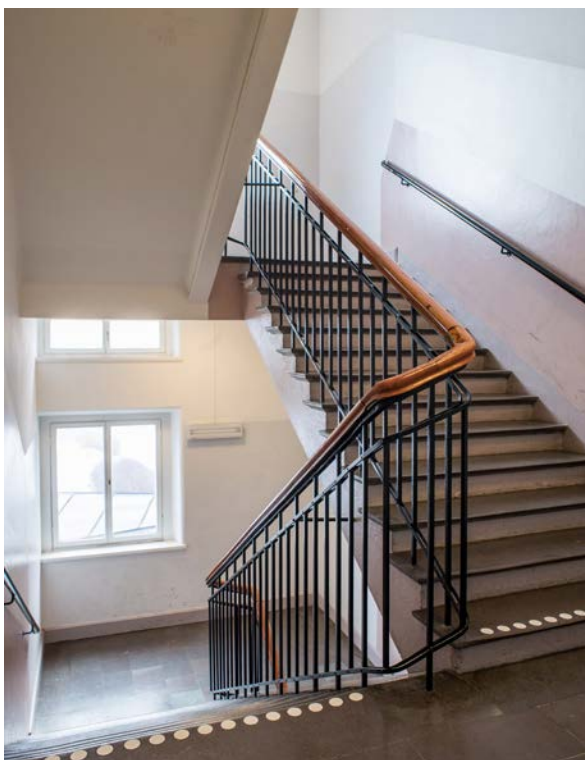
Det mindre trapphuset i D-skolan som ligger i slutet av korridoren vid den södra gaveln. Båda trapphusen har trappor med steg av kalksten och smidesräcke med en profilerad överliggare av trä. (SLM D2018-0408)
