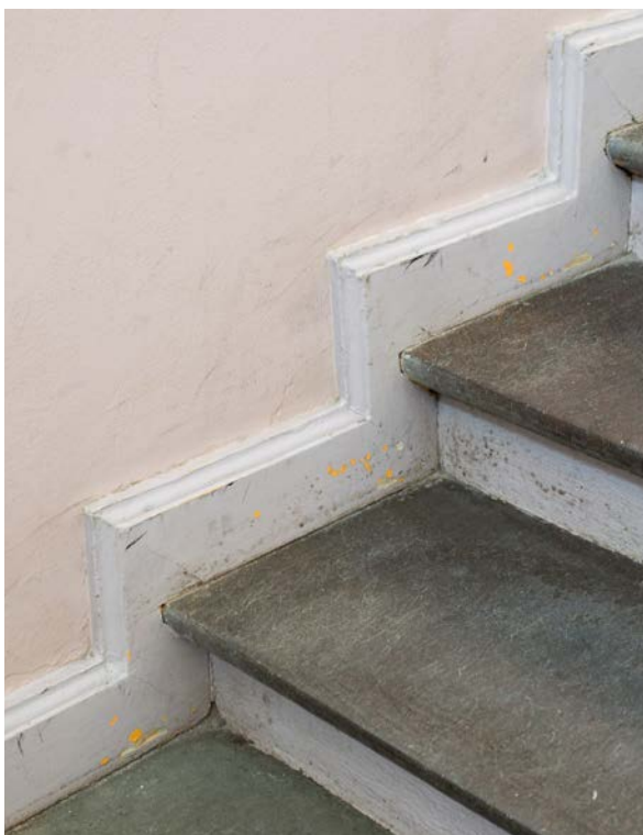
Golvsockeln i trapphuset är omsorgsfullt utformad och följer trappstegen. (SLM D2018-0410)
