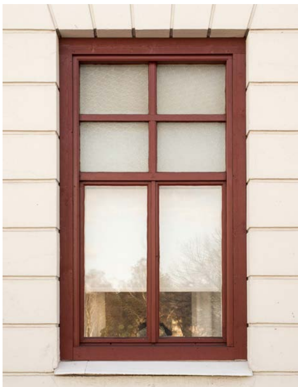
Samtliga fönster utom ett byttes till denna typ vid renoveringen 1965. Dessa har en helt annan indelning och spröjsning än de tidigare, och har betydligt mindre (25 %) total fönsteryta. Den övre luften försågs med ornamentglas. (SLM D2018-0405)
