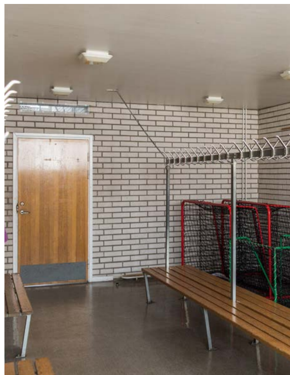
Ett av omklädningsrummen i gymnastikbyggnaden. Bänkar och dörrar är sannolikt ursprungliga. Notera också de tidstypiska taklamporna. (SLM D2018-0419)
