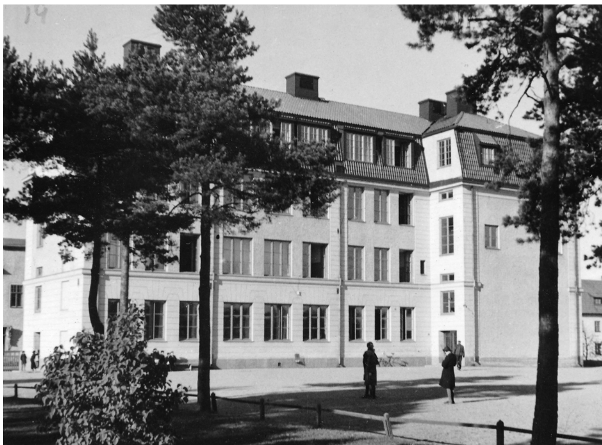
D-skolan sett från skolgården troligen på 1940-talet. Skolan har på bilden kvar sina ursprungliga fönster och hela taket är täckt med tegel. Den nya entrédelen har ännu inte tillkommit. Notera den äldre entrén på sidan till den utskjutande delen. (SLM M022440)
