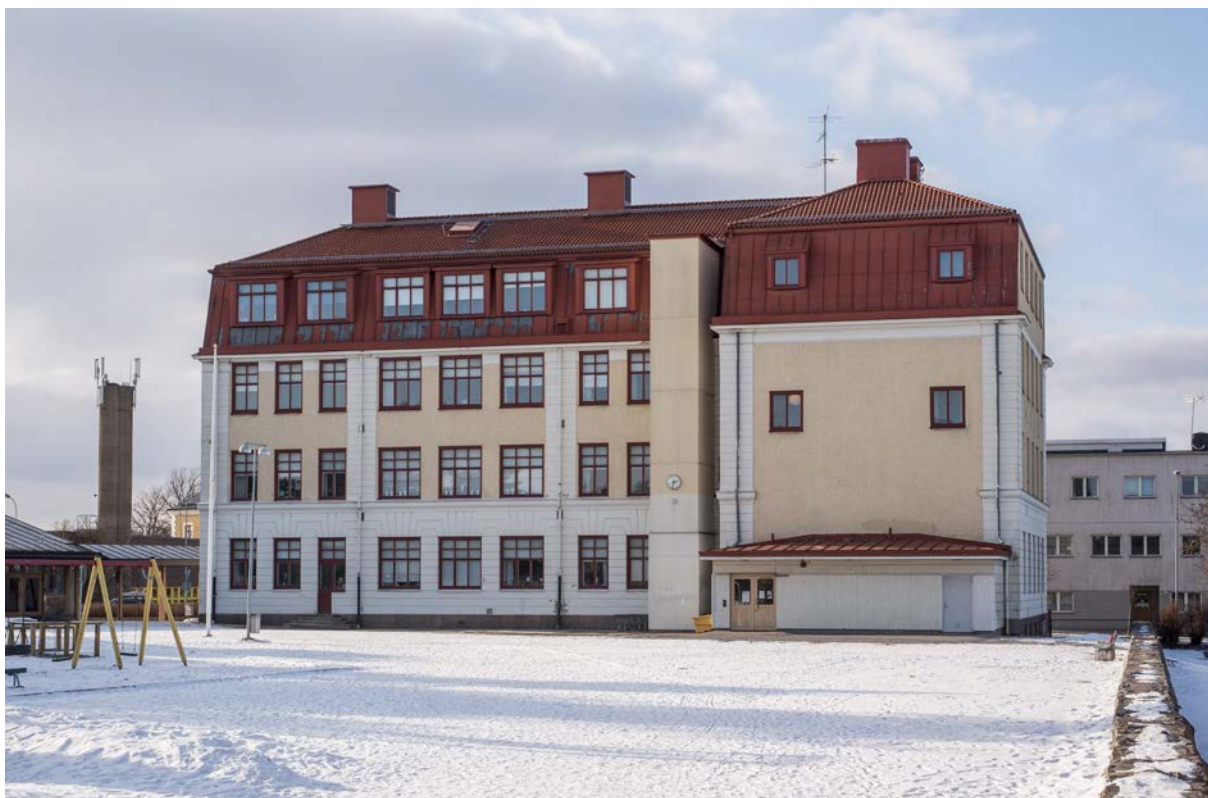
D-skolan sedd från öster. Byggnadsdelen med klockan på är ett hisschakt som byggdes vid renoveringen 2000. Den låga entrédelen tillkom 1952 och hade då toaletter i källarplanet. Till höger syns en stenmur som skiljer D-skolans skolgård från Torgskolan. Bortanför muren ligger det tidigare Konsumhusets tillbyggnad vilken från 1960-talet innehöll fritidsgården Briggen. Idag är huset ombyggt till bostäder. Till vänster i bild skymtar matsalsbyggnaden. (SLM D2018-0403)
