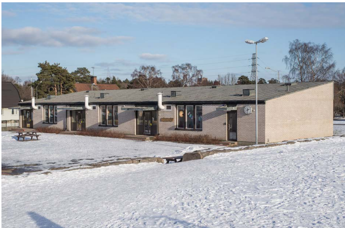
Torgskolans förskola ligger parallellt med gymnastikbyggnaden och delar dess enkla formspråk. Varje klassrum har var sin entré och närmast i bild syns ingången till personalutrymmet. Ventilationsrören i fasaden har tillkommit under senare tid. (SLM D2018-0416)
