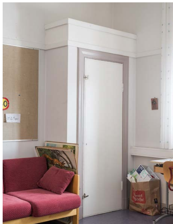
Ett av de väggfasta skåpen med profilerat dörrfoder som finns i en del av klassrummen. (SLM D2018-0409)
