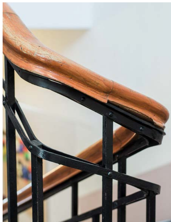
Detalj av trappräcket med den profilerade överliggaren av trä. (SLM D2018-0411)
