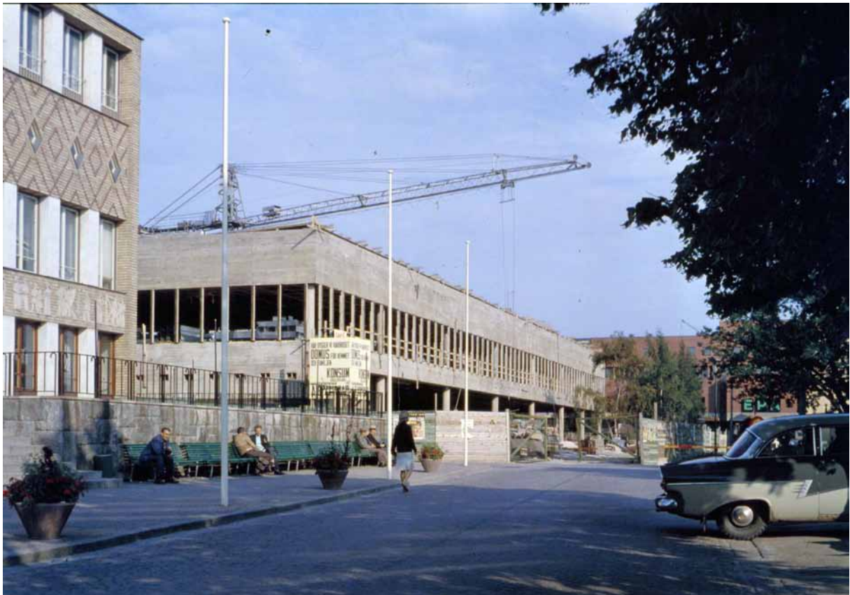
Domusvaruhuset under uppförande 1963. I bakgrunden syns EPA-varuhuset invigt 1961 och till vänster skimtar Folkets hus. Foto: Ulf Ingvar Wallnér. Bild från Oxelösundsarkivet, Bild ID 012079
