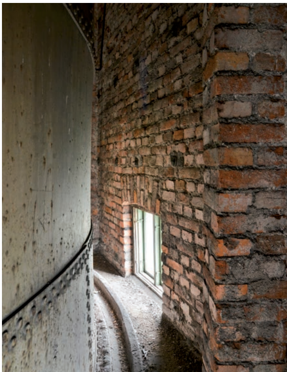
(5) Utrymmet mellan vattencistern och vägg. (SLM D2016-2704)
