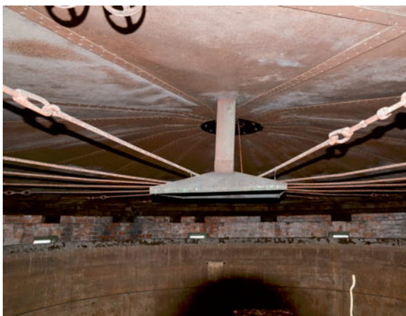
(5) Taket som invändigt är täckt med papp. Mitt i bilden syns en ventilationsöppning. Takkonstruktionen bär genom horisontella dragstag som är fästa i vertikala tryckstag som i sin tur är fästa i takets mittenplatta. (SLM D2016-2710)
