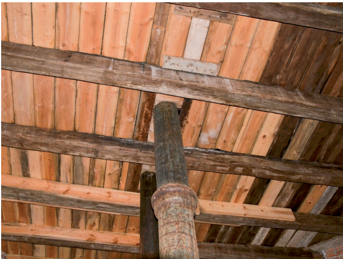
(2) Bjälklaget mot tredje våningen är förstärkt och en stor del av golvbrädorna är utbytta vid renoveringen 1985. (SLM D2016-2690)
