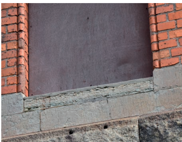
(SV) Solbänkarna under fönstren på andra våningen har lagats med putsbruk. (SLM D2016-2664)
