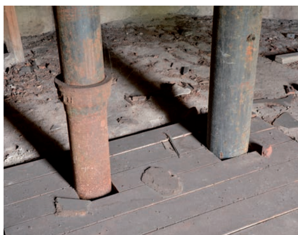
(BV) Rörledningarna där de går ner i golvet på bottenvåningen. (SLM D2016-2686)
