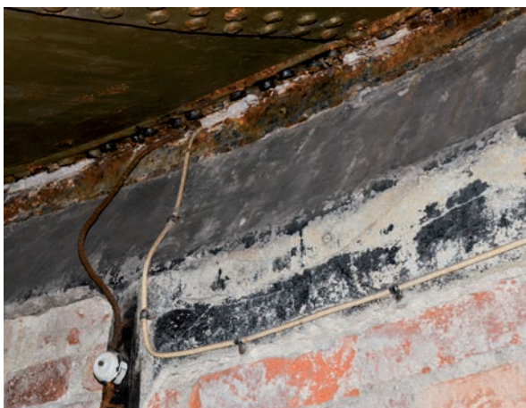
(4) Vattencisternens underkant och den järnring som vattencisternen vilar på. Väggen på fjärde våningen var tidigare putsad vilket syns i putsrester nära kanten. (SLM D2016-2700)
