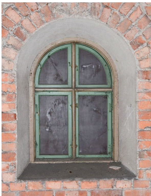
(2) Samtliga fönsterbågar finns kvar och är hela men saknar rutor. Karm och korsposter är målade i en gulbeige kulör och bågar i grönt. Nischerna är putsade. (SLM D2016-2688)
