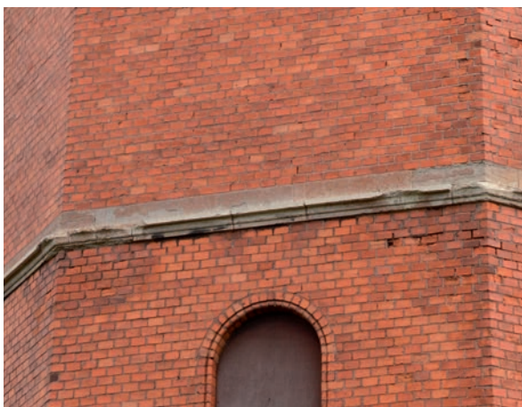
(SV) Den nedre kalkstensfrisen har flera skador med vittrad sten och urspjälkning. Till höger finns ett parti vittrat och frostsprängt tegel. (SLM D2016-2663)
