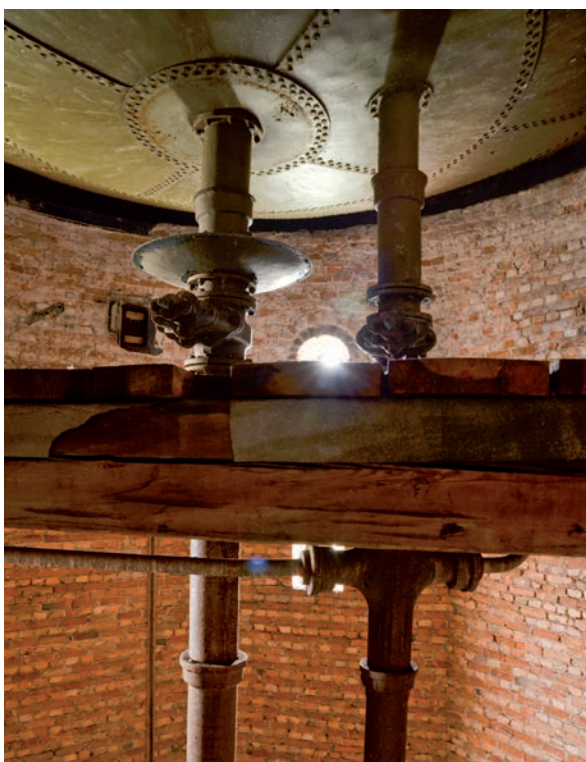
(4, 3) Bjälklaget mellan våning tre och fyra med rörledningarna från vattencisternen. (SLM D2016-2697)
