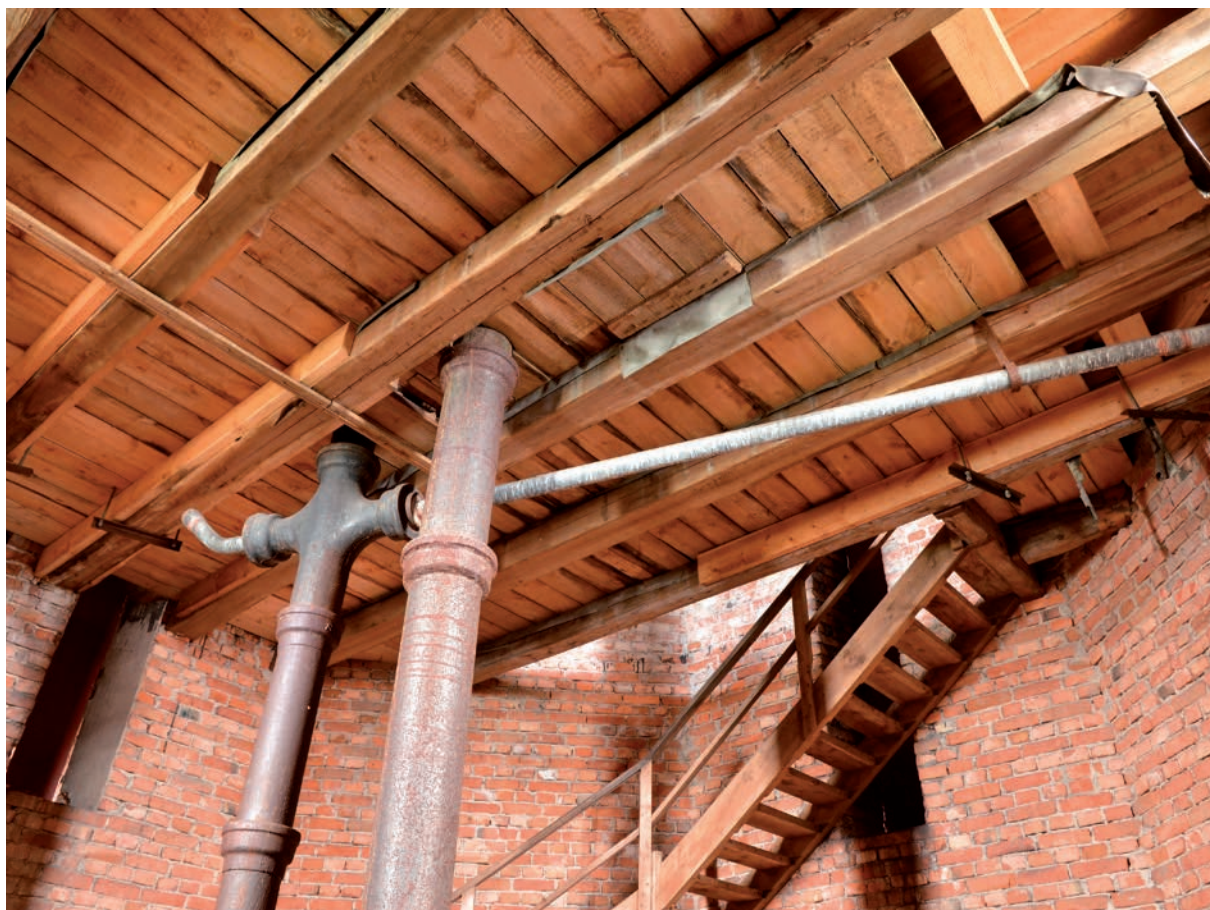
(3) Rörledningarna och taket mot fjärde våningen. Bjälklaget förstärkt och brädor utbytta vid renoveringen 1985. (SLM D2016-2693)
