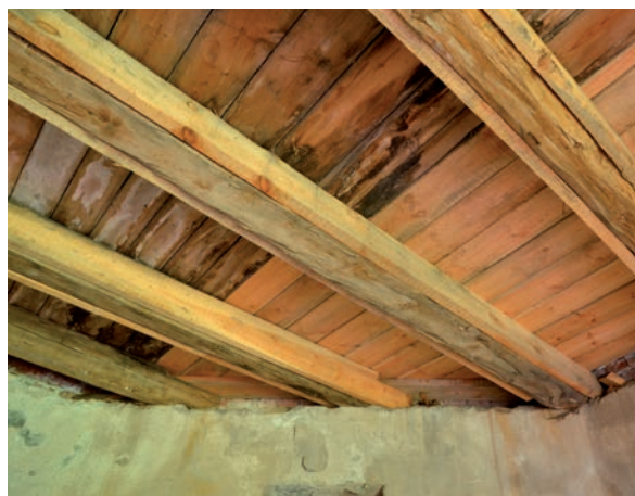
(BV) Bjälklaget mot andra våningen förstärktes vid renoveringen 1985 med plankor. Bjälklaget vilar på ett upplag i sockelmuren. (SLM D2016-2684)
