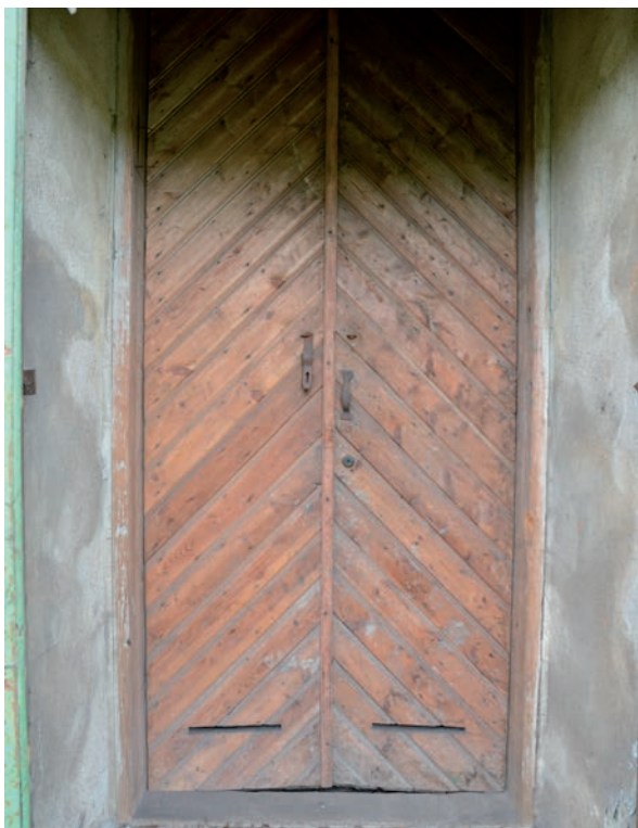
(BV) Innerdörrarna med snedställd pärlspont sedda utifrån. (SLMD2016-2680)
