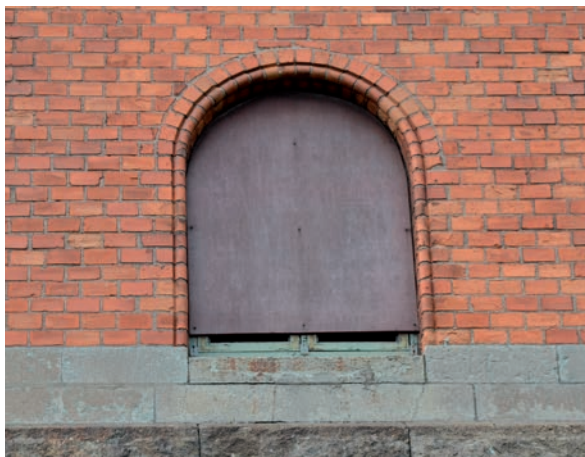
(Ö) Den övertäckta fönsterbågen skymtar under plywoodskivan. Bågen är grönmålad och har platta nedsänkta hörnjärn. (SLM D2016-2676)
