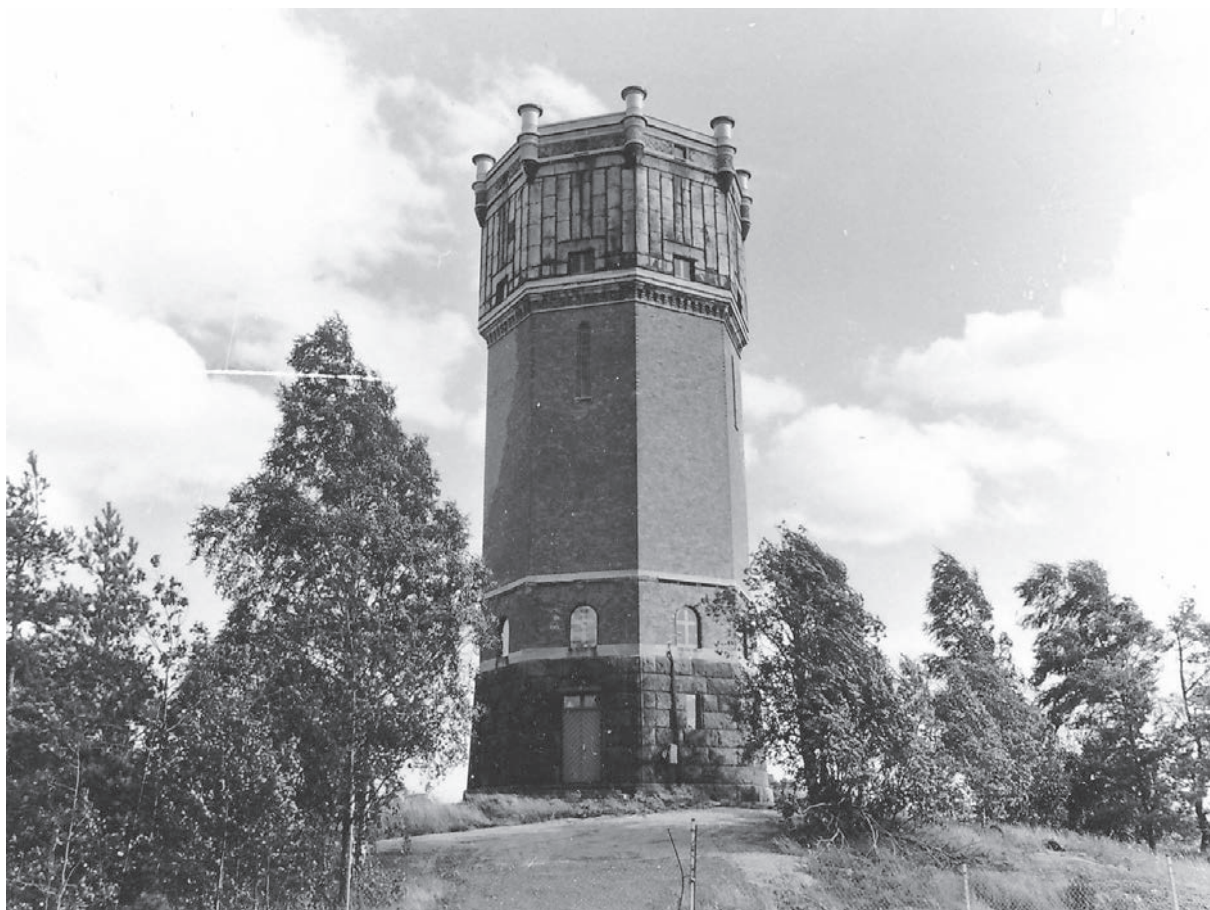
Vattentornet i september 1986 nästan ett år efter efter renoveringen. Notera skaftets ljusare parti till vänster där en stor mängd tegel har bytts ut. Den nedre kalkstensfrisen lagades inte. (SLM K2:87)
