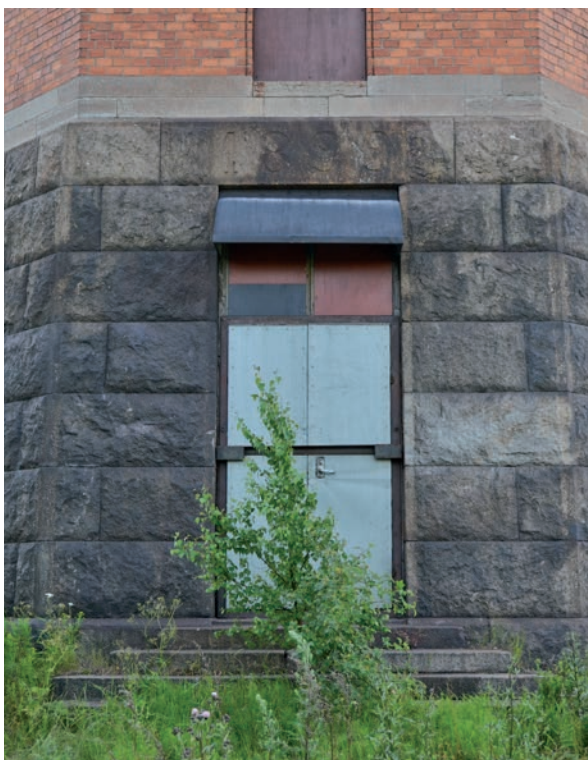
(NV) Entrédörren har vid något tillfälle sedan renoveringen 1985 täckts med plåt, överljusfönstren har täckts för och försetts med en skyddande plåtkupa. (SLM D2016-2655)
