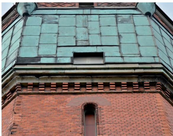
(Ö) Kalkstensfrisen har mindre vittringsskador. (SLM D2016-2677)
