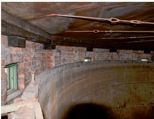
(5) Taket vilar på ett grövre remstycke av timmer med stöd i murens hörn och över fönster. (SLM D2016-2711)
