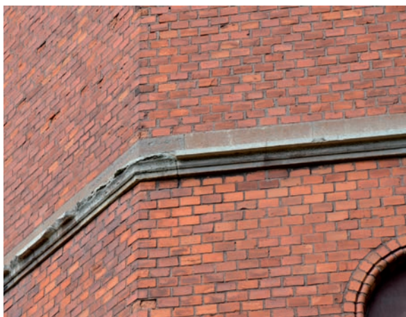
(SO) Den nedre kalkstensfrisen är hel bortsett från hörnstenen. (SLM D2016-2674)
