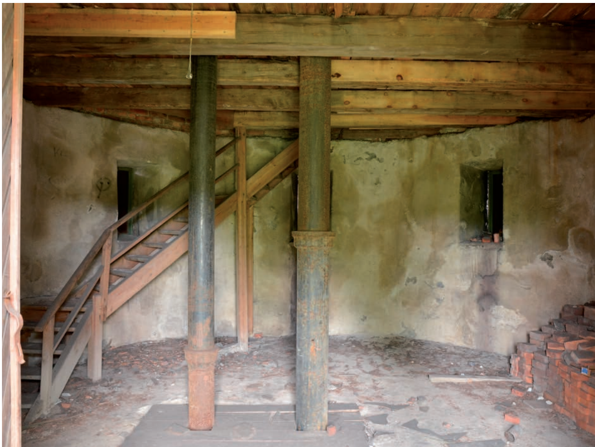
(BV) Bottenvåningen sett från ingången med trappan till vänster som leder upp till andra våningen. Rörledningarna löper genom samtliga våningsplan. Golvet består av stampad jord. (SLMD2016-2679)
