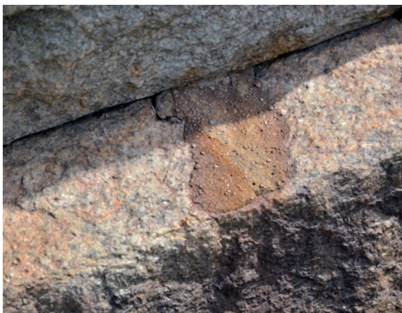
(SV) Håligheter i stensockeln har fyllts i med cementhaltigt bruk. (SLM D2016-2665)
