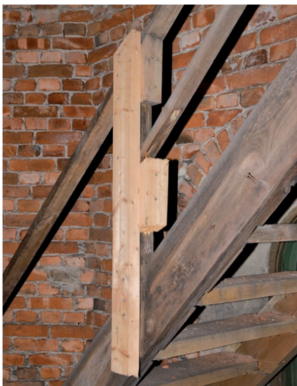
(2) Trappan till tredje våningen har förstärkts med brädor på sina ställen. (SLM D2016-2689)
