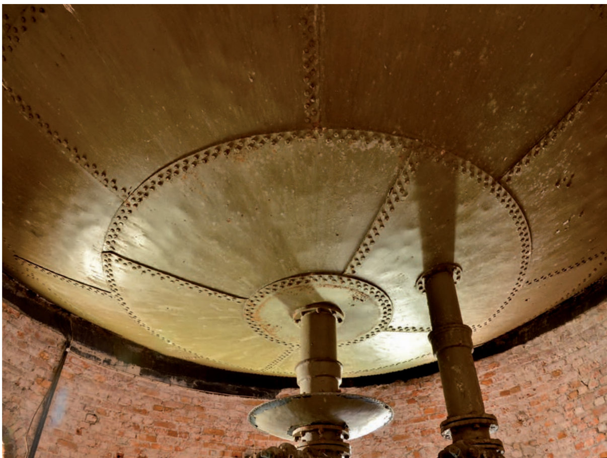
(4) Undersidan på vattencisternen av järnplåt sammanfogad med nitar. (SLM D2016-2696)
