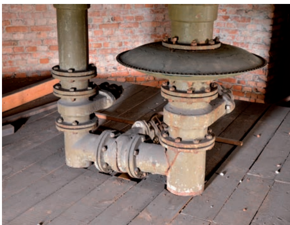
(4) Rörledningarna i anslutning till vattencisternen. (SLM D2016-2699)
