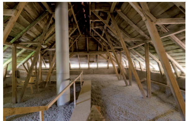
Takstolarna i den östra längan sett från söder. (D2015-1068)
