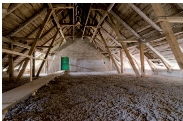
Takstolarna i det mittersta vindsutrymmet sett åt väster. (D2015-1062)
