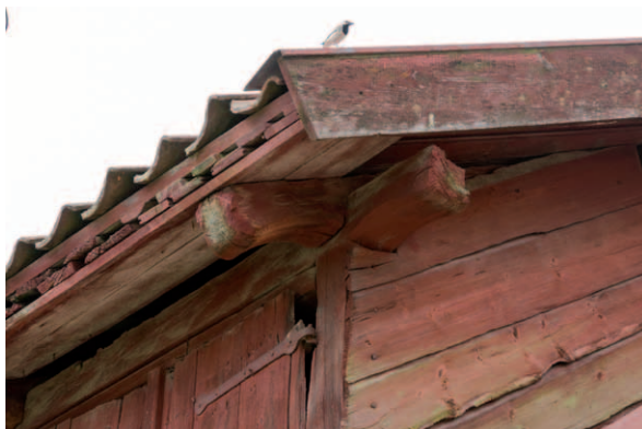
Vackert utformad knutad konstruktion med rundade avslut. Notera även gångjärnet av äldre typ. (D2015-1024)
