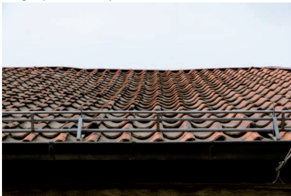
Takfallet nära den norra längan med snörasskydd av rör. (D2015-1042)
