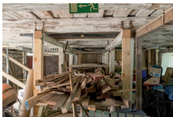
Den bärande konstruktionen över foderbordet har till vissa delar bytts ut. (D2015-1060)
