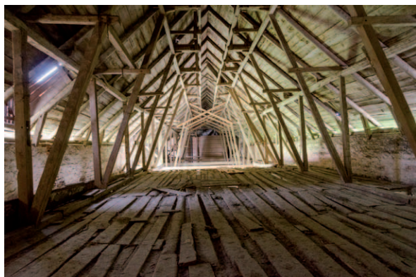
Takstolskonstruktionen över kostallet. (D2015-1054)
