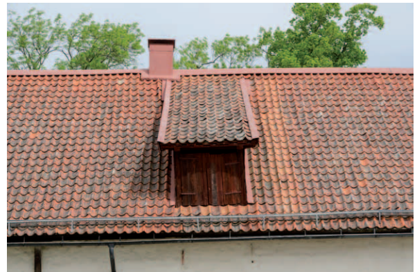
Den västra takkupan. (D2015-1034)
