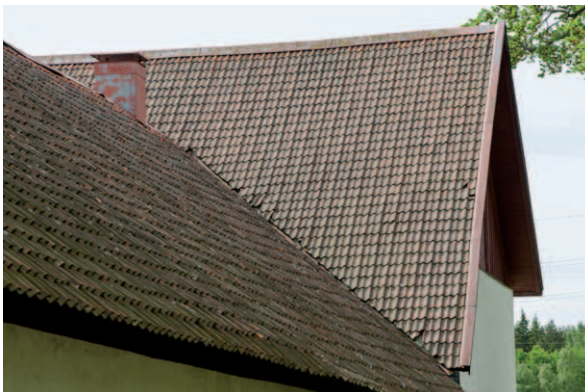
Den höga delens inre takfall sett från utsidan av ladugårdsfyrkanten. (D2015-1015)
