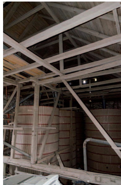
Takstolarna med snedsträvor vid det södra hörnet sett i höjd med bjälklaget. (D2015-1053)
