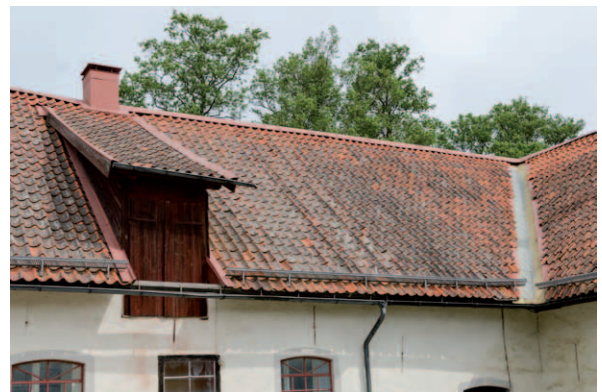
Den östra takkupan som bryter takfoten. (D2015-1035)
