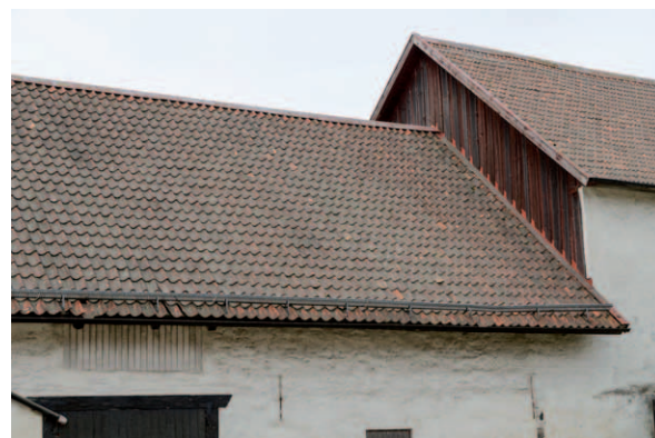
Det inre takfallet vid anslutningen till den höga delen. (D2015-1008)
