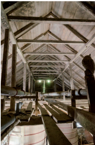
Den höga delens takstolar sett från öster i höjd med den övre hanbjälken. (D2015-1051)
