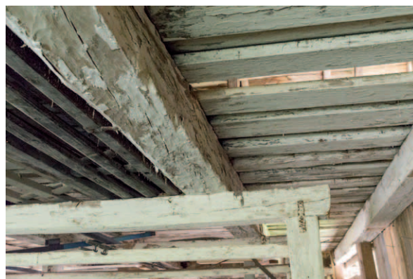
Bjälklaget har stora dimensioner och är av hög ålder. (D2015-1059)
