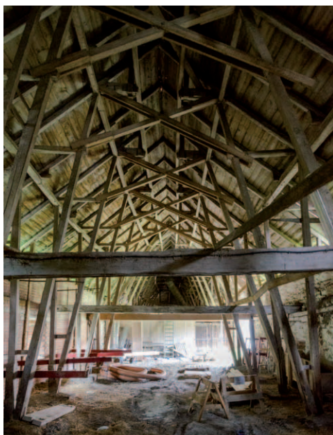
Takstolskonstruktionen över den öppna delen sett från söder. (D2015-1057)
