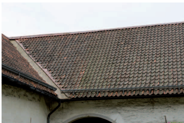
Det inre takfallet vid vinkeln mot den östra längan. (D2015-1006)
