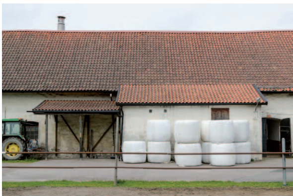
Det östra takfallet med det fristående taket samt utbyggnaden vilka båda är senare tillägg. (D2015-1037)
