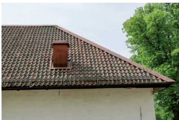
Norra takfallet åt väster. (D2015-1030)
