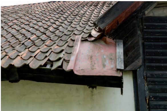
Plåt vid den utskjutande delen på den västra längan. (D2015-1074)
