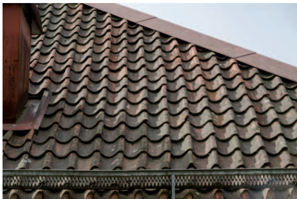
Snörasskyddet bör rödmålas för att bättre smälta in mot teglet. (D2015-1031)
