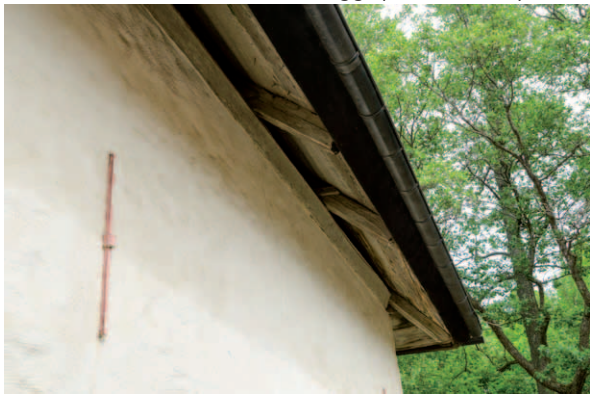
Takfoten nära den norra längan. (D2015-1038)
