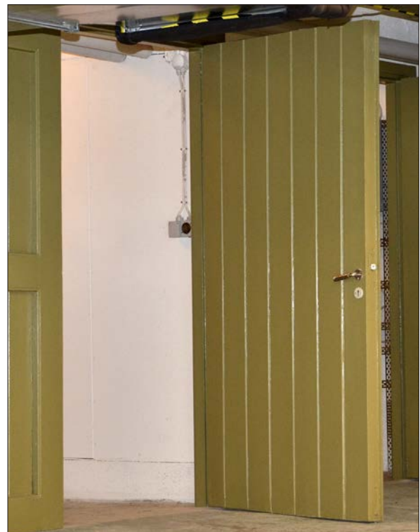
20 Samma dörröppning efter avslutad målning (Slm D13-0131).
