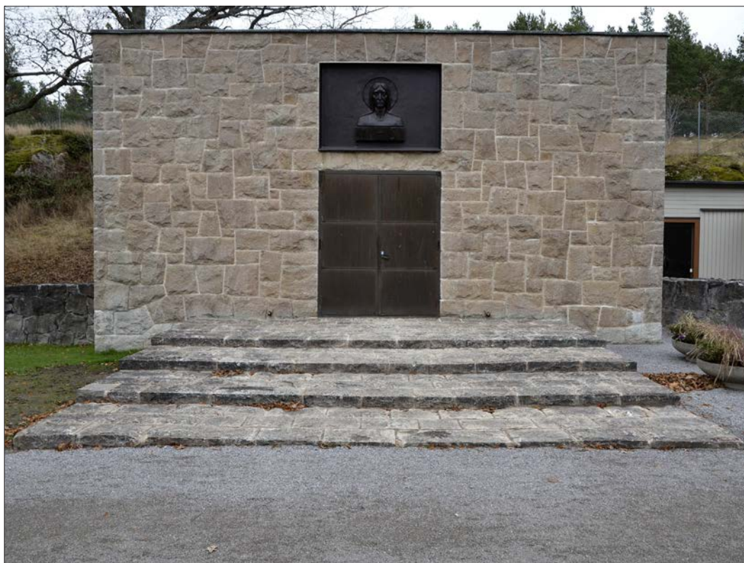
11 Entrétrappan efter avslutat arbete (SIm D13-0122).
