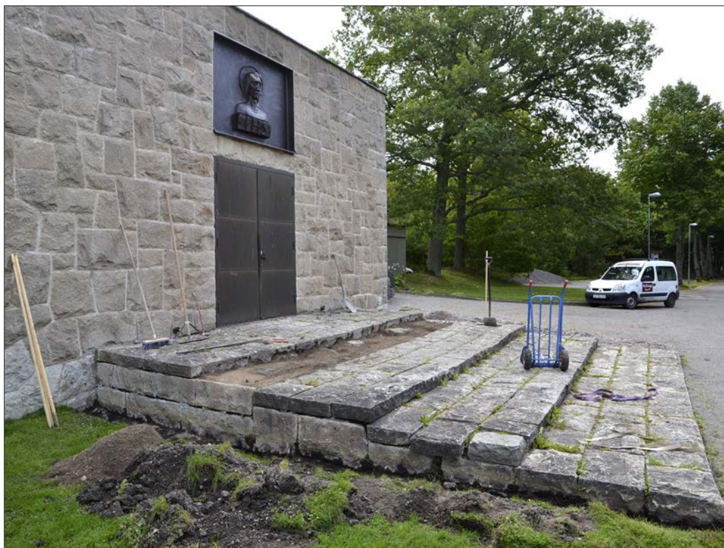
10 När stenarna i det översta trappsteget demonterades konstaterades att trappans grundläggning var i bättre skick än förväntat (SIm D13-0121).
