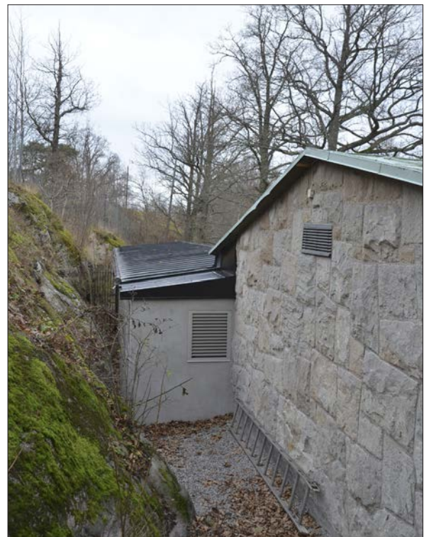
9 Fläkttillbyggnaden efter avslutat arbete i november 2012 (Slm D13-0120).
