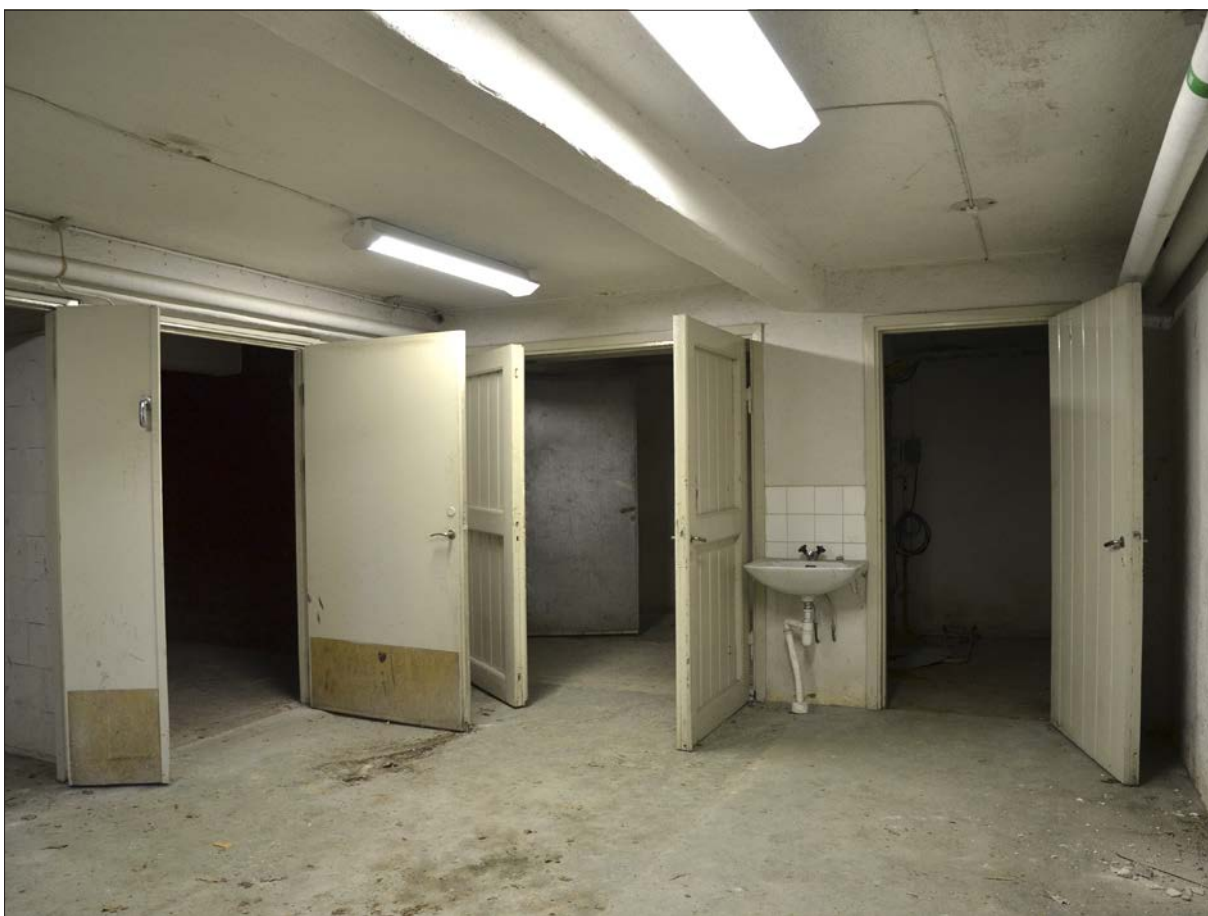
18 Källarutrymmet sett från ingången innan ombyggnadsarbetet startade (Slm D13-0129).
