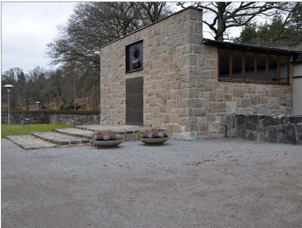
5 Frösångs kapell från sydväst efter avslutad utvändig renovering (Slm D13-0116).
