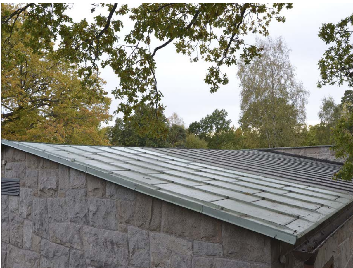
15 Det norra takfallet efter avslutat arbete (Slm D13-0126).
