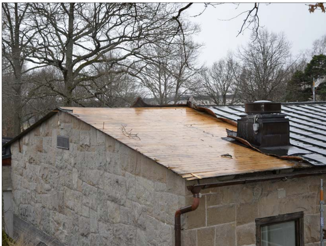
14 På det norra takfallet stals mer kopparplåt. Till höger i bilden ses ventilationshuv som demonterades i samband med återläggning av skivtäckningen (Slm D13-0125).
