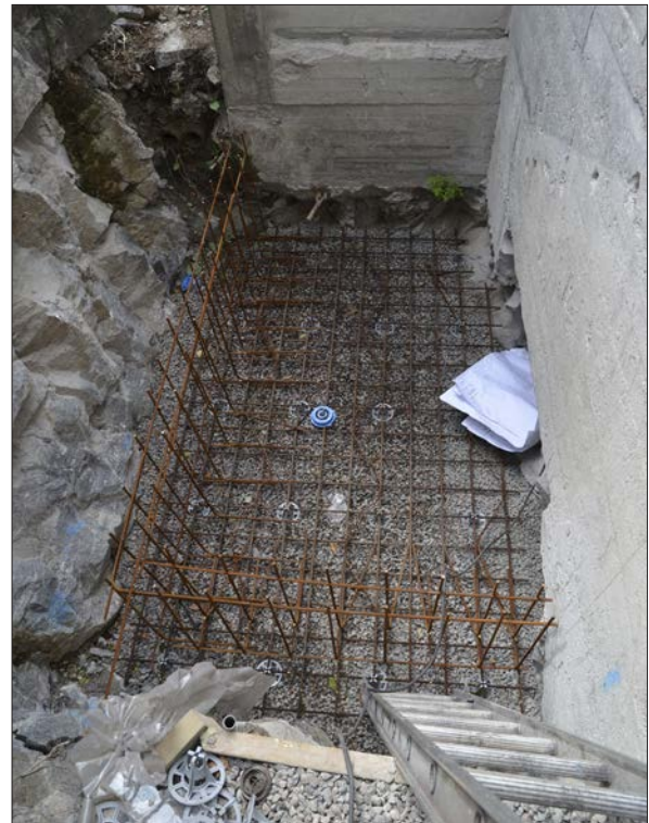
7 Arbete med gjutformen för tillbyggnaden i augusti 2012 (Slm D13-0118).
