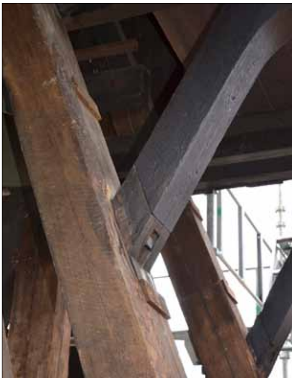
6 På takfotssträvorna fanns märken efter spikad plåt (Slm D11-269).
