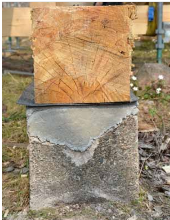
4 Betongplinten efter lagning i samband med återmonteringen av klockstapeln (Slm D11-267).
