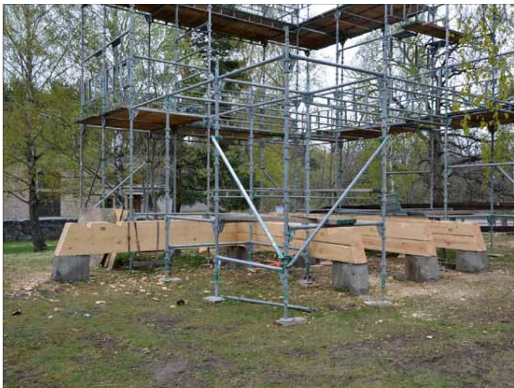
9 Klockstapelns nya syllstockar (Slm D11-272).
