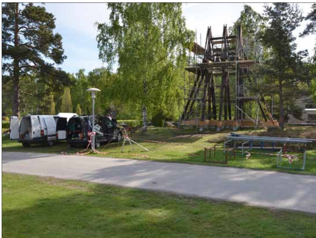
10 Klockstapelns stomme återmonterad (Slm D11-273).
