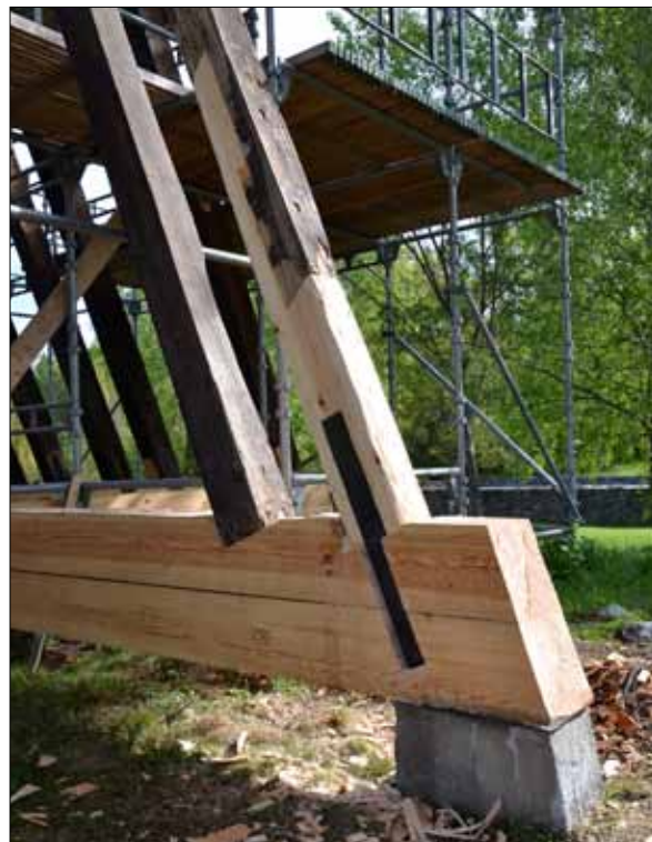
7 Nya syllstockar och skarvad sträva (Slm D11-270).
