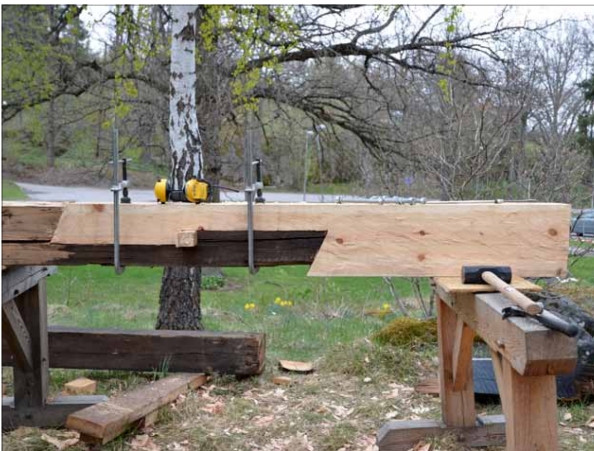
8 Pågående skarvning av en av klockstapelns strävor (Slm D11-271).
