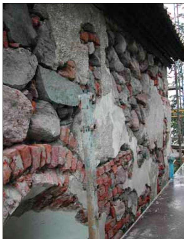
Fig 23 Två meter högt väggparti av långhusmuren i norr, upp mot takfoten från det västra fönstret och väster ut.
