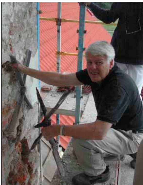
Fig 33 Kent Fredriksson visar det avrostade dragjärnets ankarslut på tornet i sydost.
