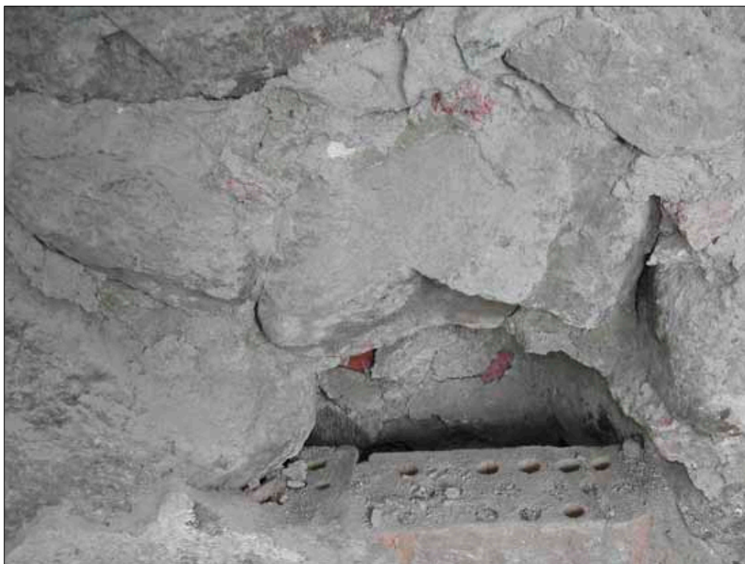
Fig 29 På tornets norrsida vid marken finns ett upptaget hål eventuellt för VA.
