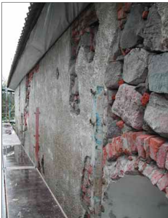
Fig 20 Långhusväggen i norr efter bortknackning av löst bruk. Den dubbla valvbågen hör ihop med fönstret i nordväst.
