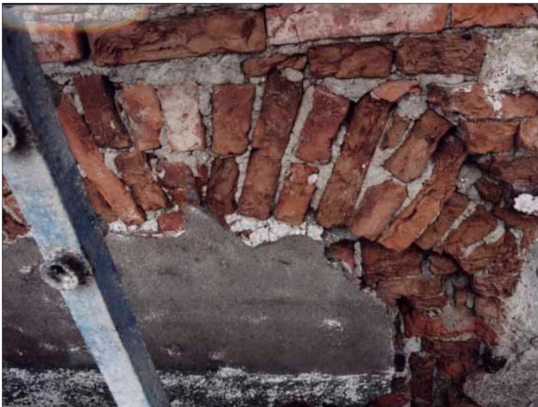
Fig 13 Närbild på den välvda överdelen till en annan, dold ljudöppning än den synliga.
