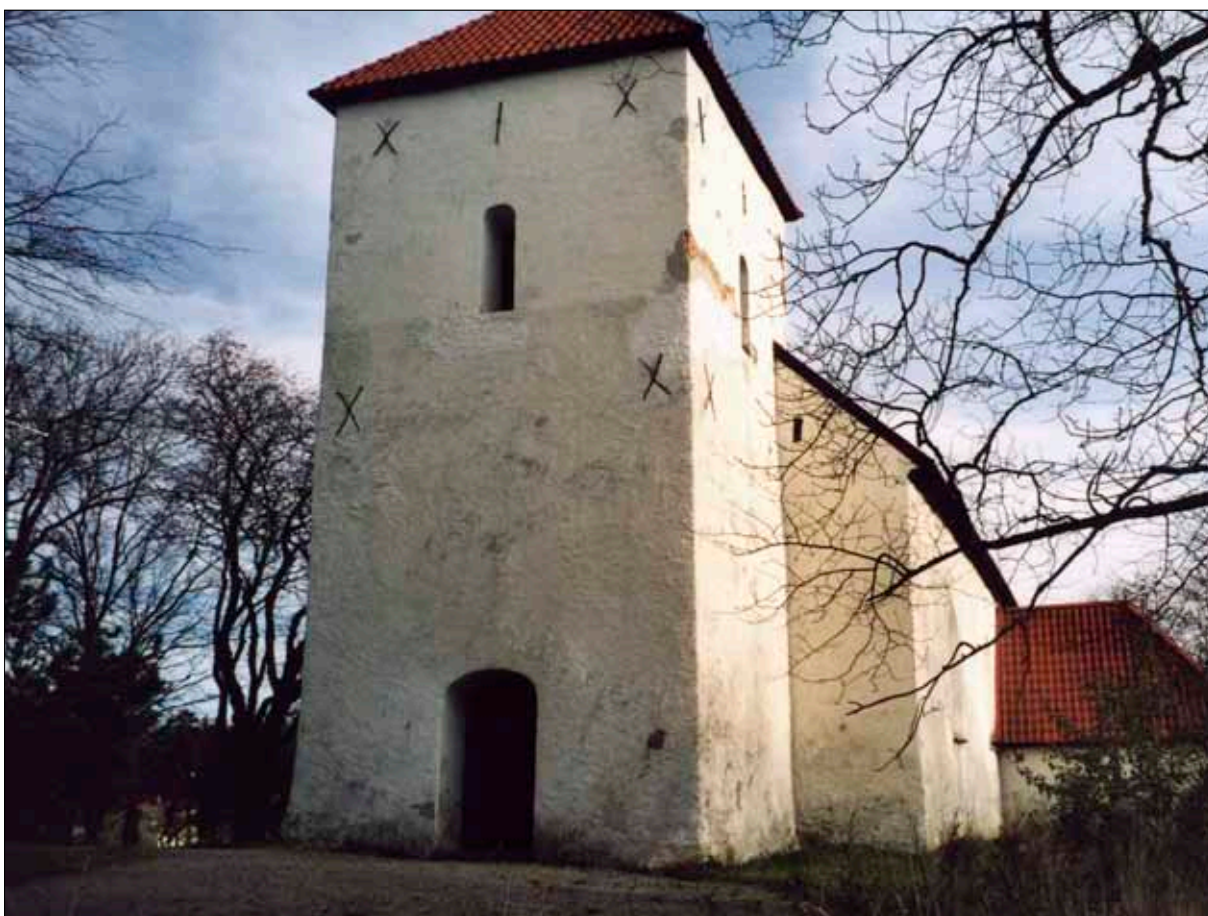
Fig 9 Västtornet före upprustning. Foto Margit Webjörn 2002. Här finns en gräns i putsen under ljudöppningarna.
