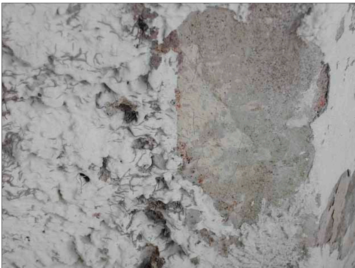
Fig 35 De olika putsskikten på fasaden. Ytterst spritputs från 1949, därefter en slät putsyta som är grovt arbetad. Färgen är varmt ljusocker.
