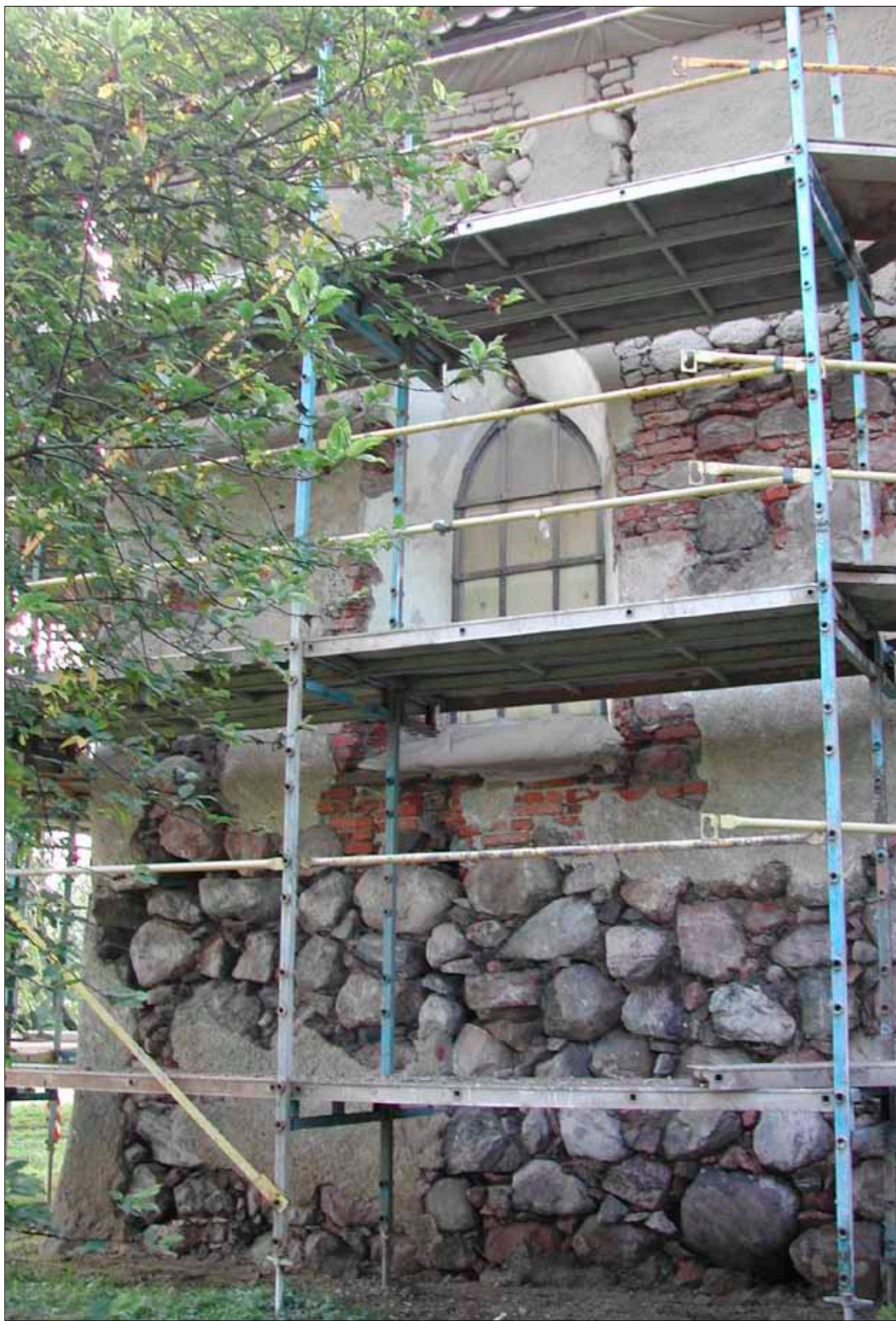
Fig 24 Koret i sydost ger en sammanfattande bild av byggnadsmaterialet i kyrkans murverk. De olika stenmaterialen är sammanfogade med ett lerrikt bruk. Leran kommer från trakten intill.
