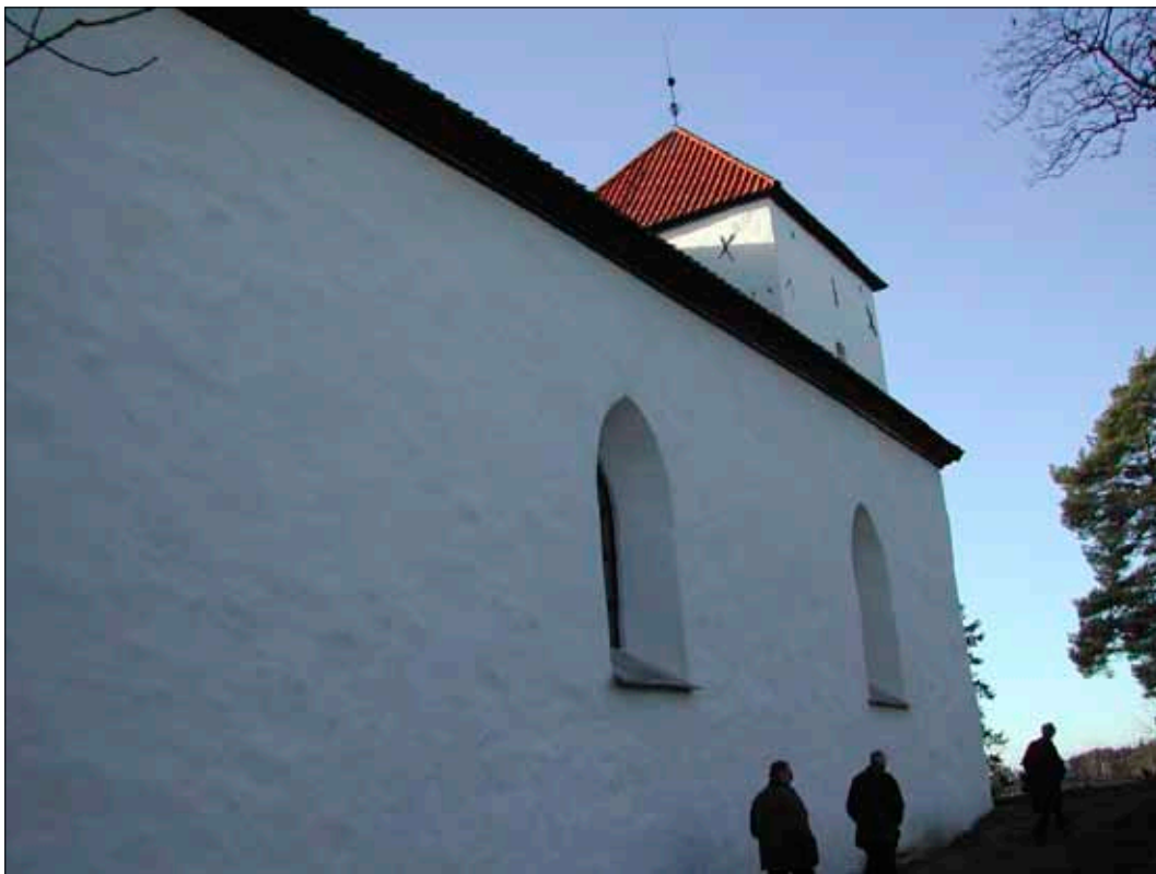
Fig 38 Kyrkans norrfasad med en slät putsyta som avslöjar den böljande fasadytan. På tornet högst upp i nordost saknas nu ett rakt ankarslut nedanför takfoten.
