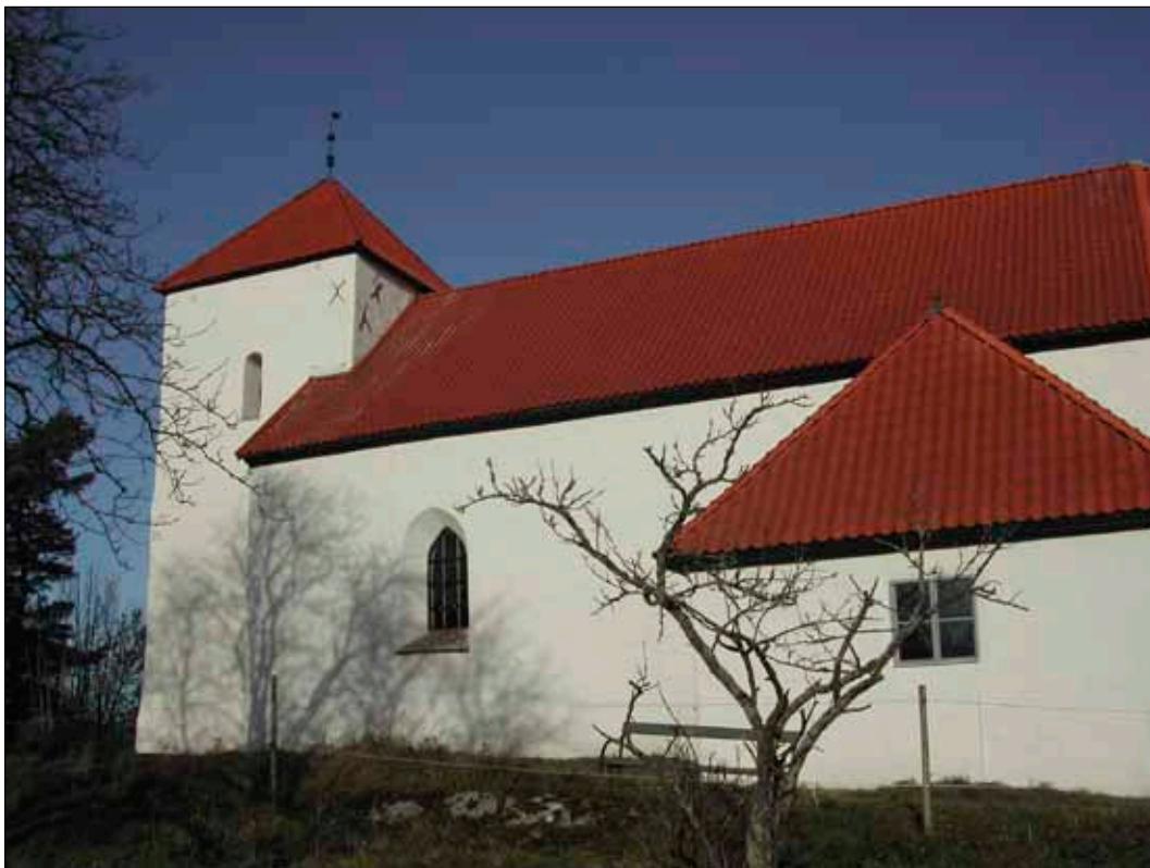
Fig 37 Stjärnholms kyrka är upprustad. Detta är sydfasaderna. På tornet saknas i sydost ett av två kryssformade ankarslut. Det förvaras på tornvinden.
