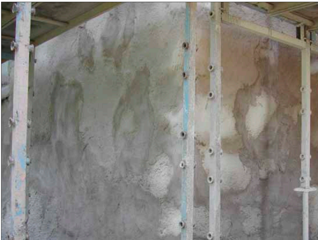
Fig 31 Murningslagning och putsgrundning är gjord på tornet i sydväst.
