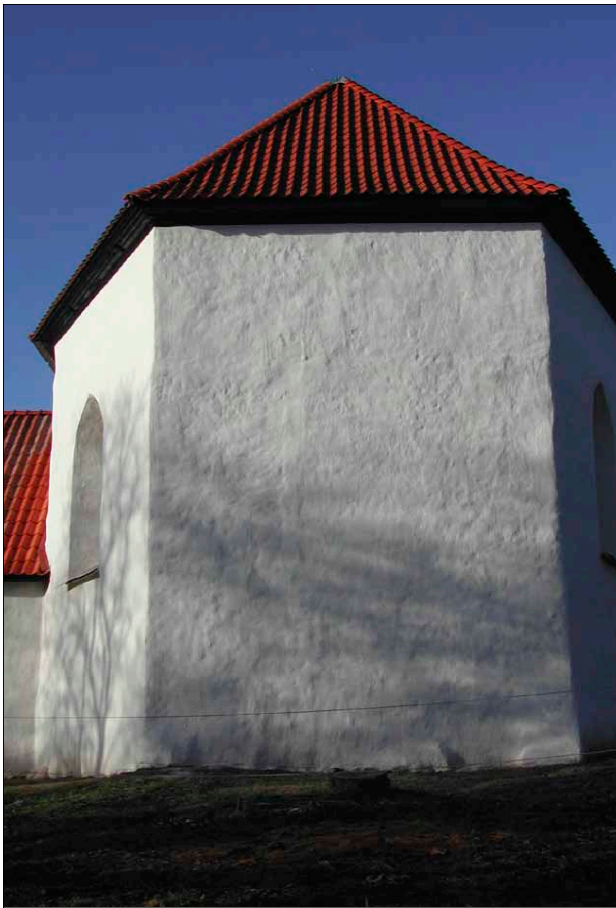
Fig 36 Den östra korfasaden har frilagts genom att trädet har tagits bort. I mitten antyds läget för fönstret, som har murats igen tidigare.
