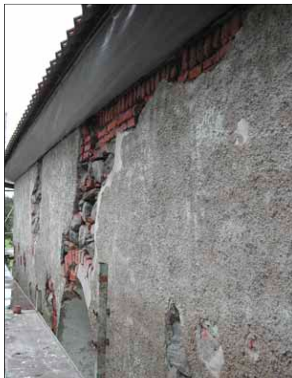
Fig 21 Ovanför fönstret i nordost satt bruket löst. Därmed gavs möjlighet att granska uppbyggnaden av muren.
