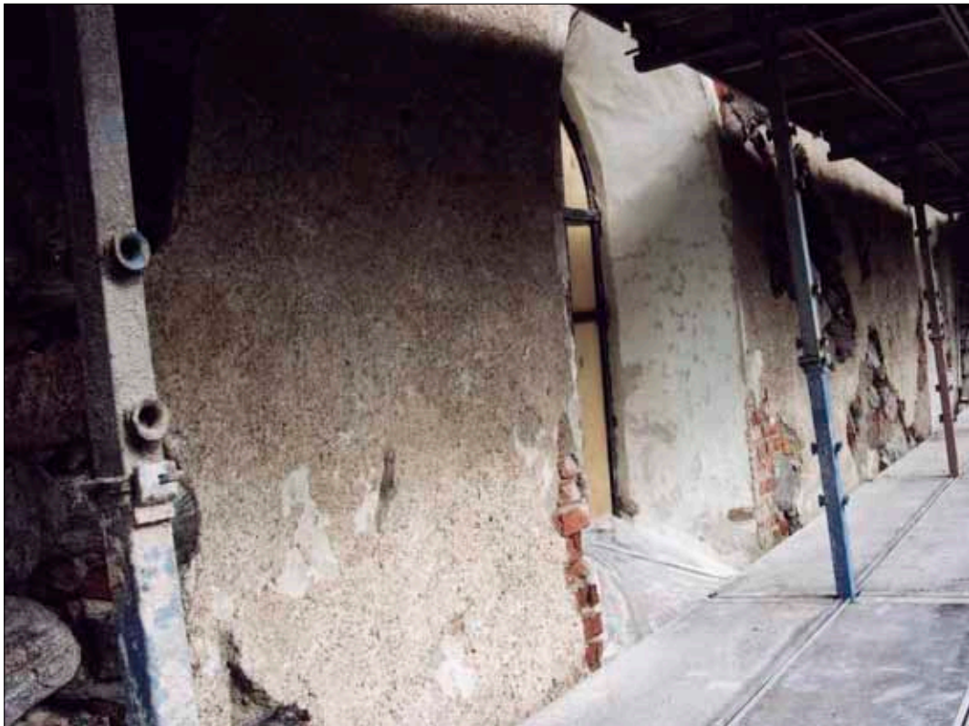
Fig 17 Översikt över mellanplanet av byggställningen i fönsterhöjd.
