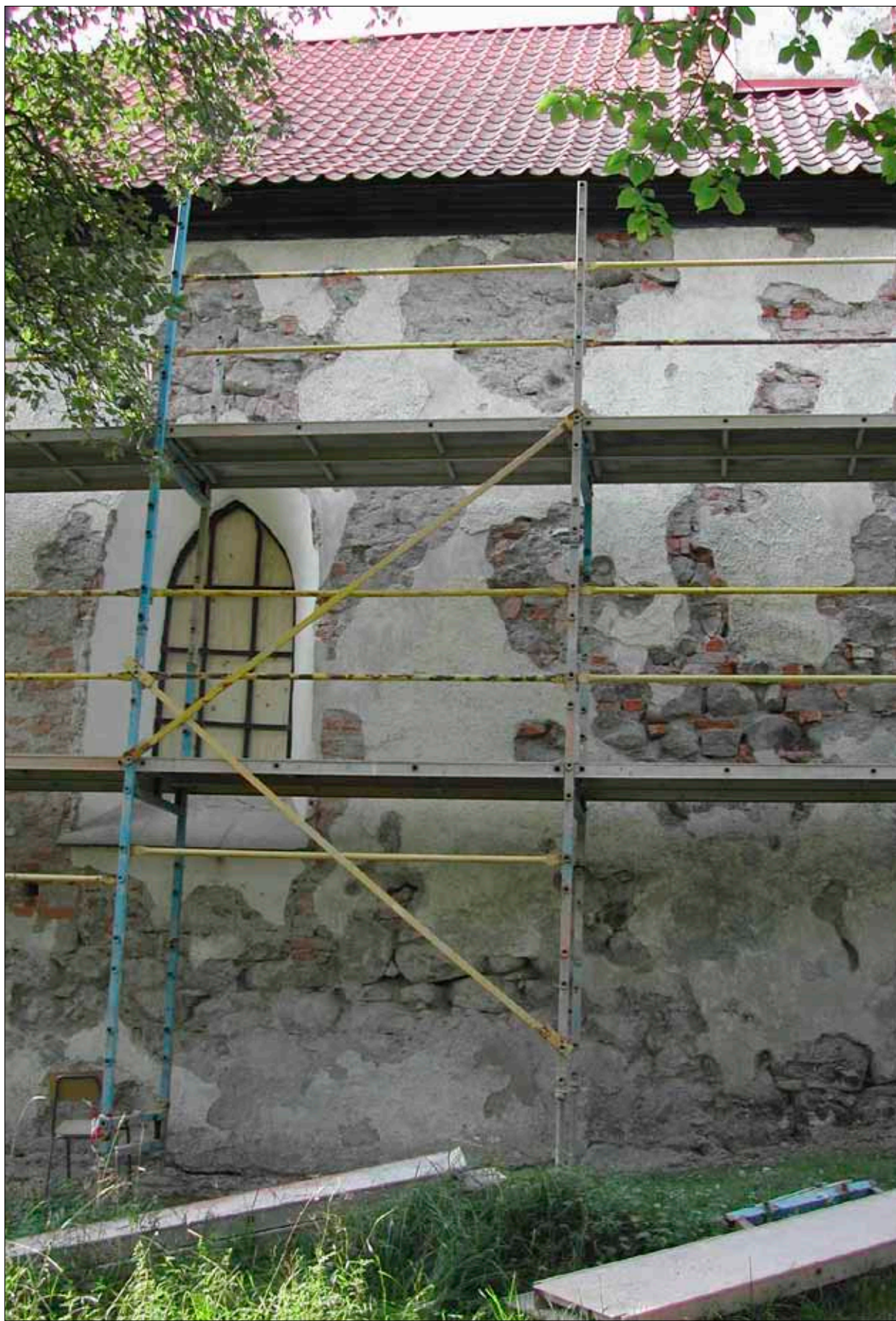
Fig 19 Norrfasaden i sin helhet från grunden och upp till takfot, förberedd för ilagning, grundning, stockning och ytputs.
