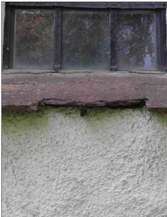
Fig 8 Ett antal solbänkar hade skador som har lagats och konserverats av stenkonservator Svante Nilsson. Detta är bänk A i norr.
