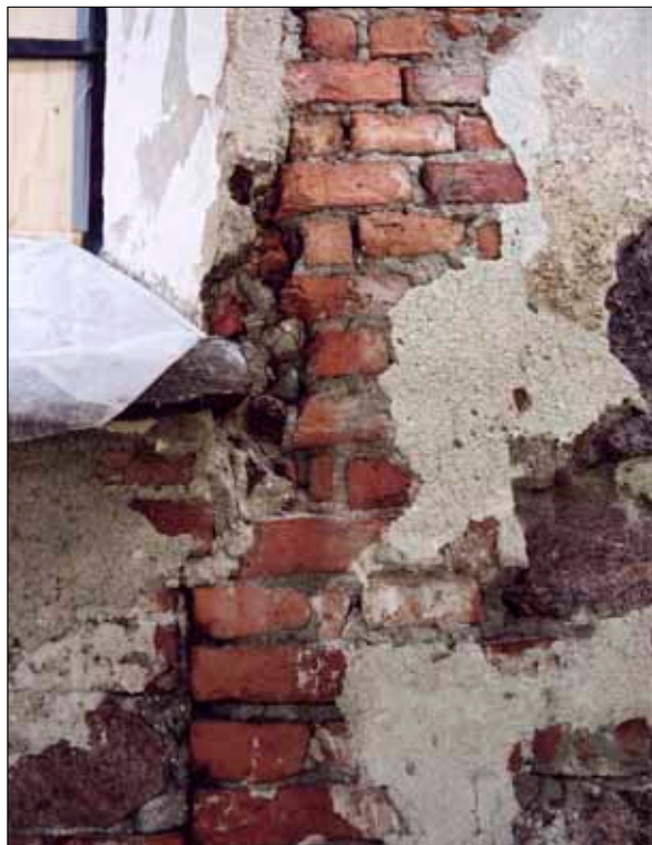
Fig 26 Närbild av murningen vid fönstret. En port mot herrgården kan ha ersatts av igenmurning och upptagning av ett fönster.
