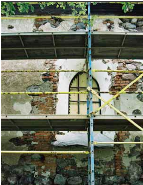
Fig 25 Norrfasaden i full höjd och cirka sex meters bredd. På båda sidor om fönstret syns en tegelmurning som tyder på att det har funnits en port i norr.
