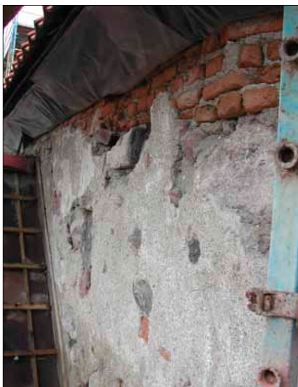
Fig 22 Övre delen av korväggen i söder mot sakristian, vars tak skymtar till vänster.
