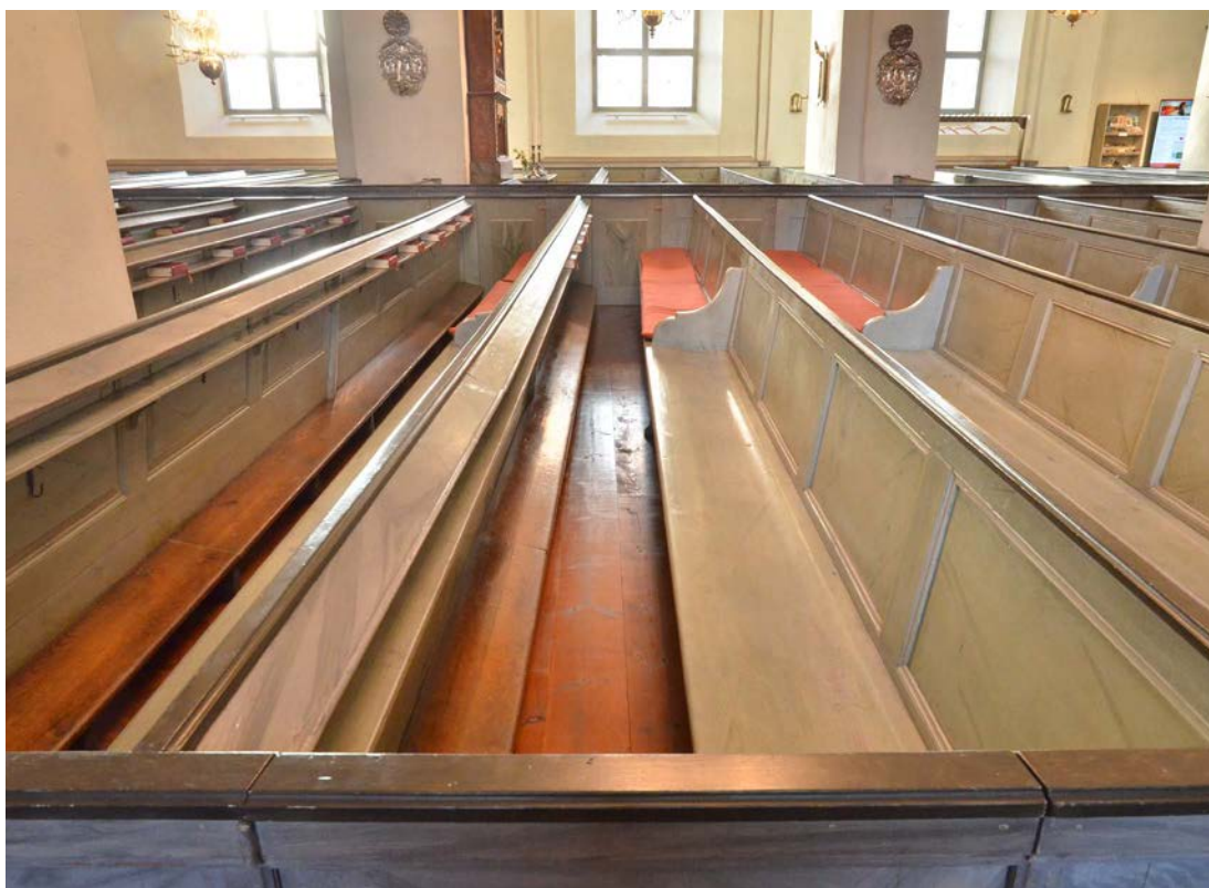
Bild 28 Bänkar, gavlar och fronter efter återmontering. SLM D2023-0807.
