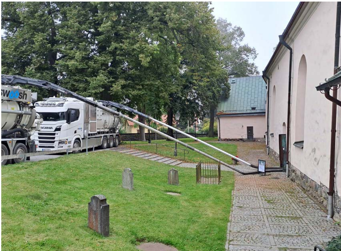
Bild 21. Grävsug kopplad till tankbilar. SLM D2023-0800.
