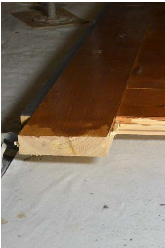
Bild 31. Nytt spontat trägolv struket med pigmenterad linoljefernissa. SLM D2023-0810.
