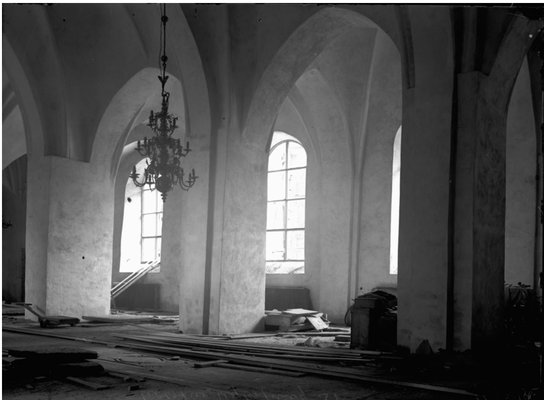
Bild 6. Södra pelarraden under restaurering. Under det delvis avlägsnade brädgolvet syns stenhällar som täcker mittgången. Foto: Erik Lundberg
