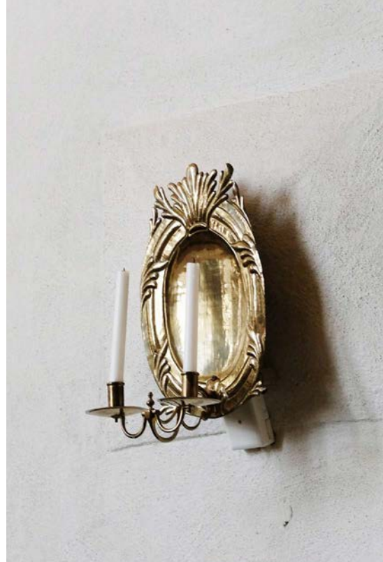
Bild 30. Synlig täckdosa vid ljusplåt på bänkkvarterets nordvästra pelare. SLM D2023-0809.
