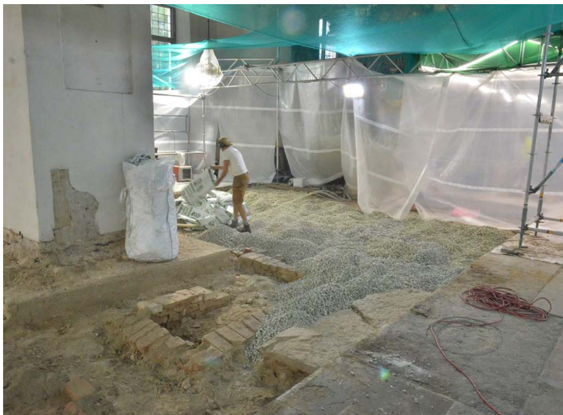
Bild 23. Det utgrävda golvet återfylls med skumglasgrus. SLM D2023-0802.
