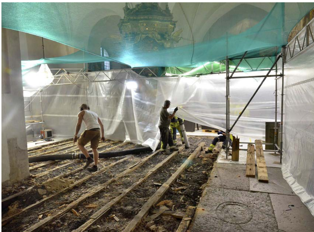
Figur 2. Borttagning av slagg mellan golvbjälkarna med så kallad grävsug. Foto: Björn Pettersson. SLM D2023-0872.
