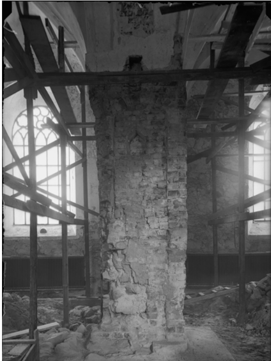
Bild 7. Pelare efter demontering av predikstol. Foto: Erik Lundberg
