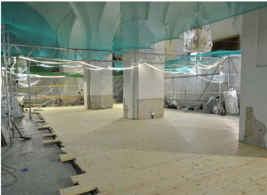
Bild 26. Nytt massivt trägol. SLM D2023-0805.
