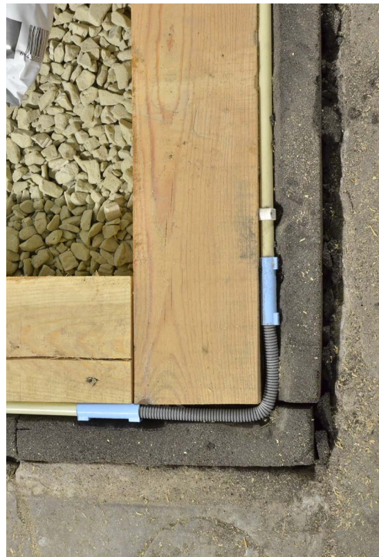
Bild 32. Ny hörslinga placerad i rör mellan golvbjälke och skumglasskiva i bänkkvartets utkant. SLM D2023-0811.
