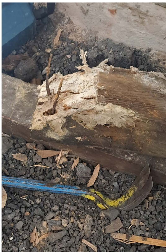
Bild 13. Svampangripen golvbjälke. SLM D2023-0792.
