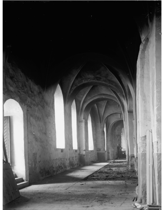
Bild 8. Norra sidoskeppet. Stenläggning synlig efter avlägsnande av brädgolv. Foto: Erik Lundberg
