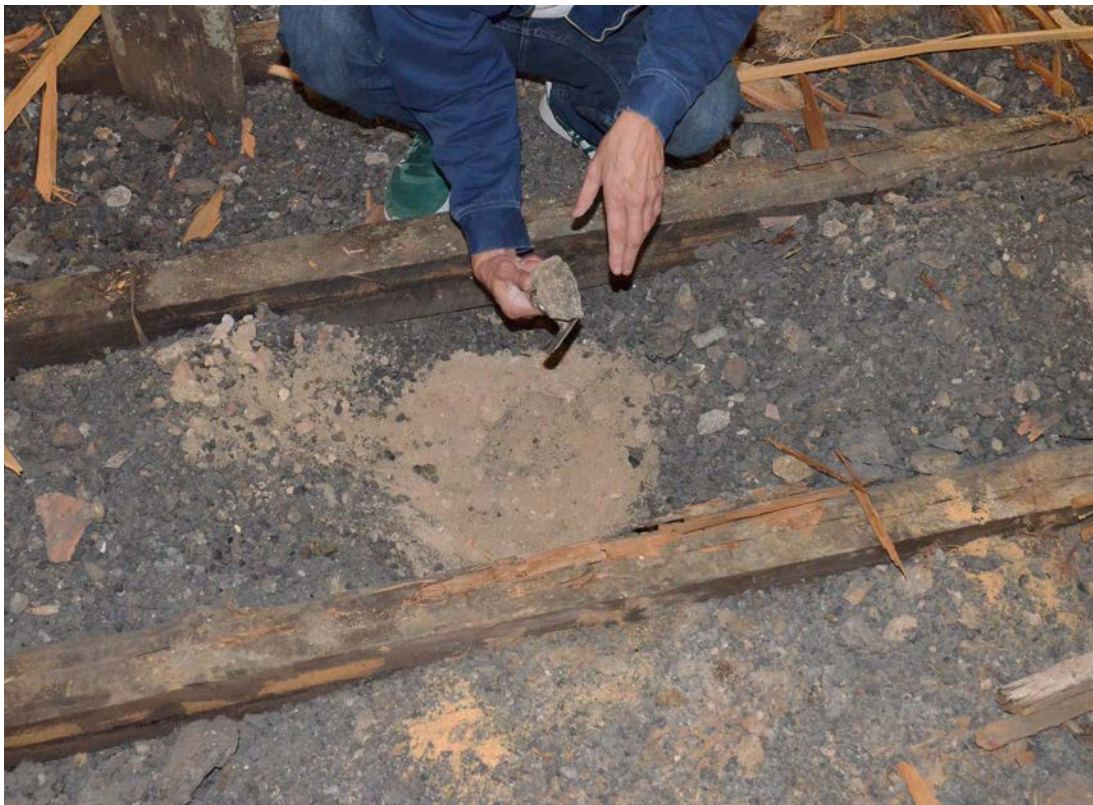
Bild 19. Golvfillning i form av kolstybb i det översta lagret. SLM D2023-0798.
