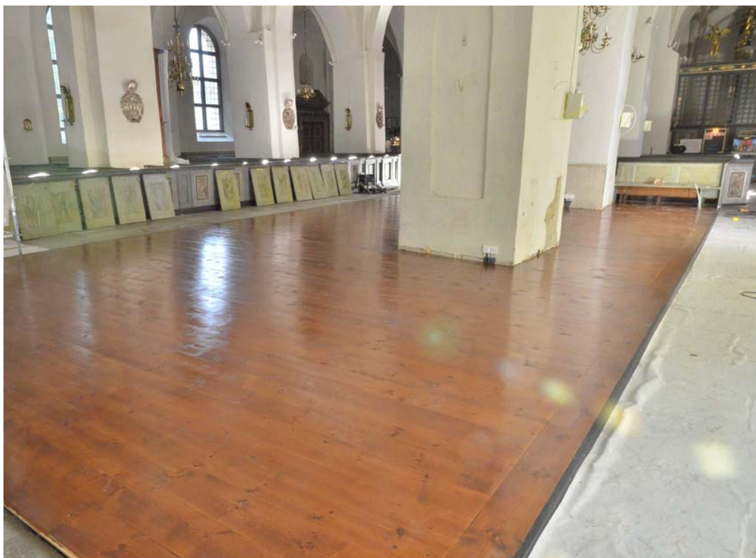
Bild 27. Det nya golvet ytbehandlades med pigmenterad färg. SLM D2023-0806.
