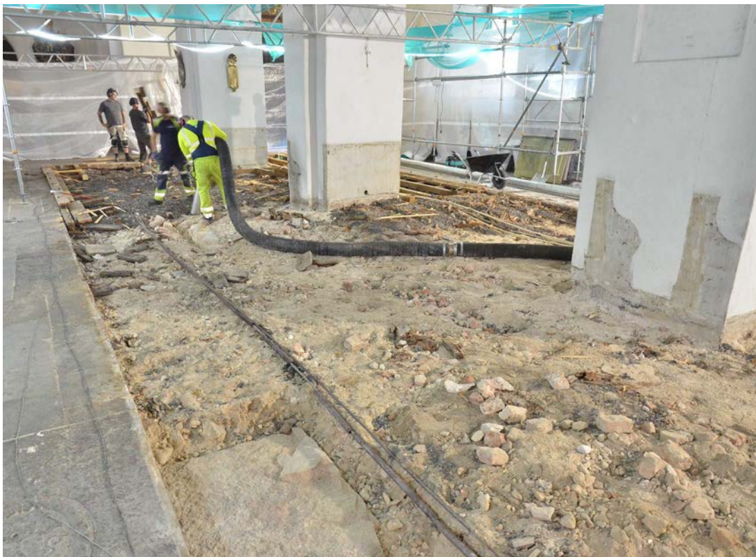
Bild 20. Avlägsnande av befintlig golvfillning. Först avlägsnades ett ca 15 cm lager av kolstybb, sedan ytterligare ett lager av grus och fyllnadsmassor. Äldre rör för el togs bort. SLM D2023-0799.
