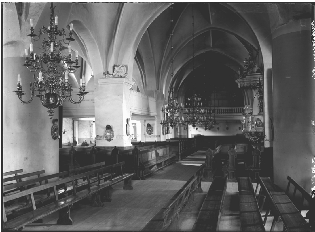
Bild 5. Bänkkvarter före renovering 1923. Långhuset täcks av ett brädgolv. Foto: Erik Lundberg
