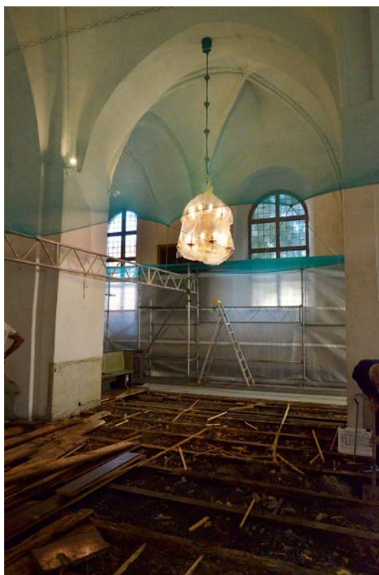
Bild 18. Rivning av bänkkvarter mot nordväst. SLM D2023-0797.
