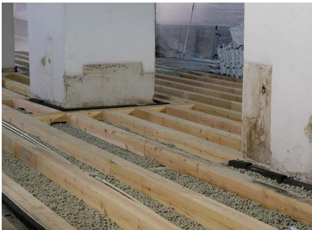
Bild 24. Nya golvbjälkar, 150 x 150 mm, ovanpå kapillärbrytande lager av skumglasgrus. SLM D2023-0803
