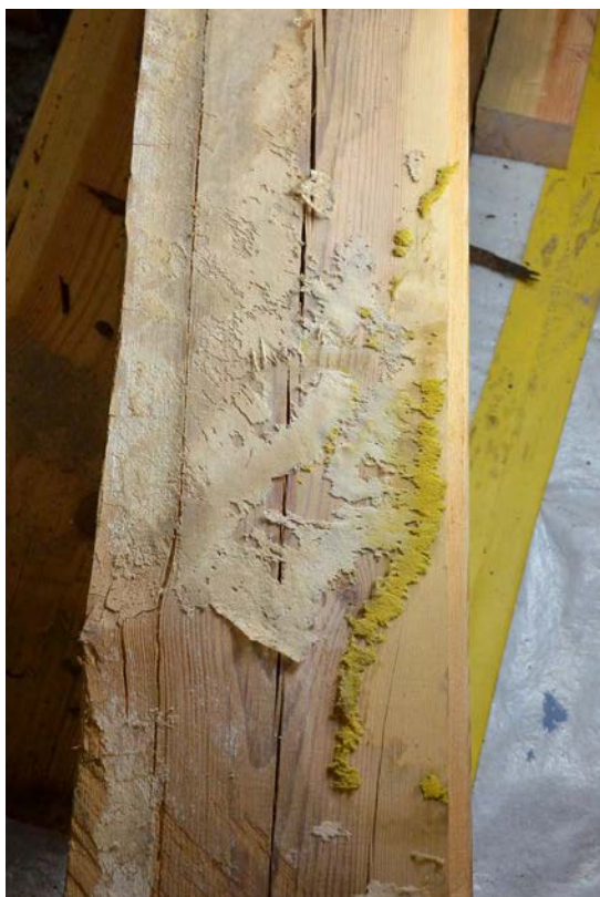
Bild 14. Fruktröpp och mycel på undersida golvräda. SLM D2023-0793.
