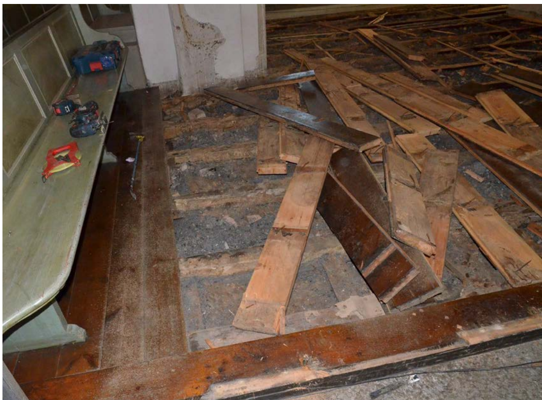
Bild 16. Pågående rivning av svampangripet golv. SLM D2023-0795.
