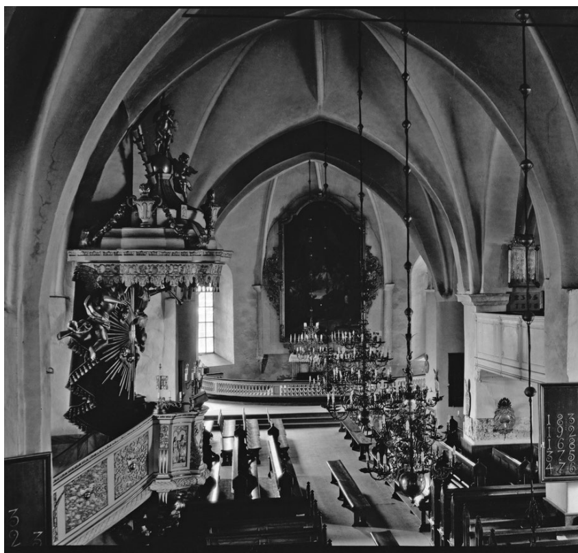
Bild 3. Bänkkvarter före renovering 1923. Foto: Erik Lundberg (bilden är beskuren). SLM X8-78.
