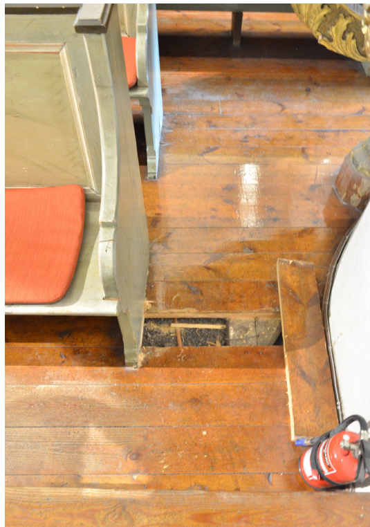
Bild 17. Trägolvet under predikstolen, där en bräda har lösgjorts på prov. SLM D2022-0905.
