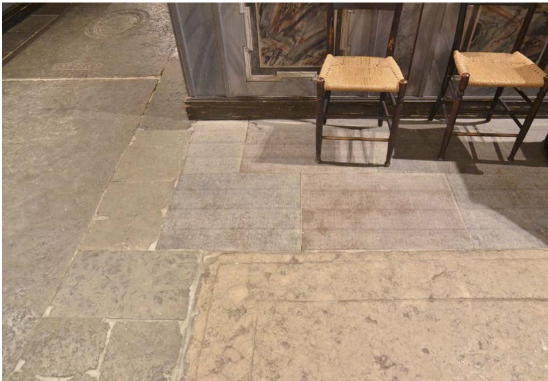
Bild 14. Vid platsen för de borttagna bänkraderna ska samma typ av kalkstensgolv läggas som det närmast södra bänkkvarterets front (under stolarna). Stenen är av typen Borghamnssten, gråbrun hyvlad. SLM D2022-0902.
