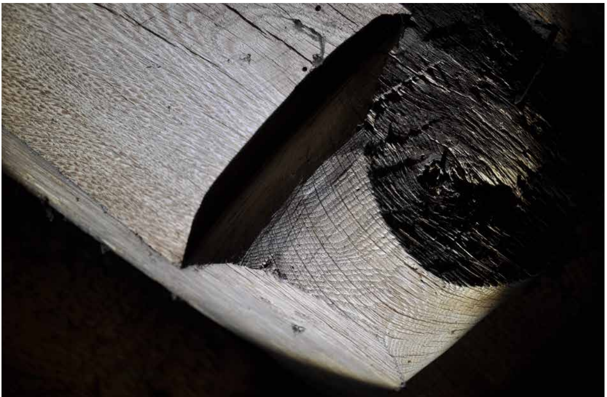
Detaljbilder på nockåsens dekoration visar att de är mycket omsorgsfullt bearbetade med yxa. Fotografi: Daniel Eriksson
