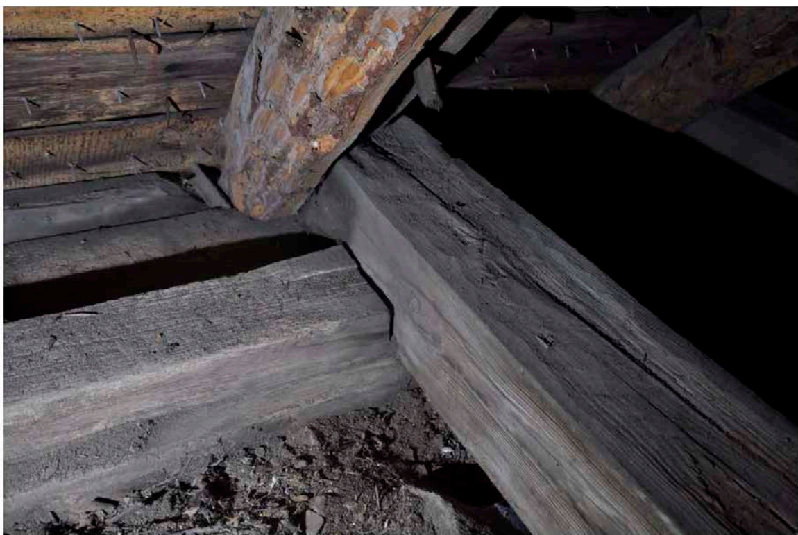
Remstycke i ek. Samtliga högben har påspikade förstärkningar vilket försvårar undersökningen. Fotografi: Daniel Eriksson
