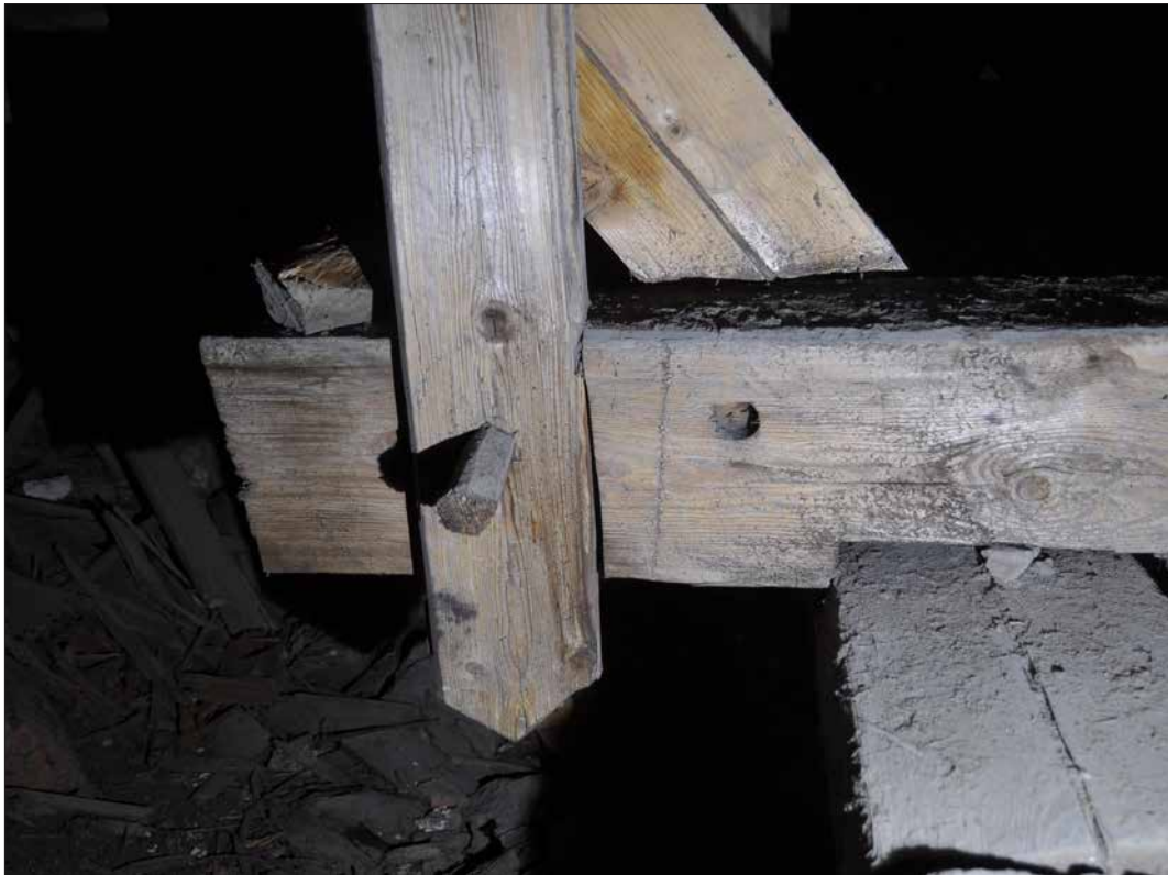
Rits och borrhål till höger om stödbenet. Tanken var tydligen att från början sätta stödbenet intill remstycket men av någon anledning ändrade man sig. En detalj som kan berätta något om processen vid tillverkning av en takstol (SLM D2015-1515). Foto: Daniel Eriksson.
