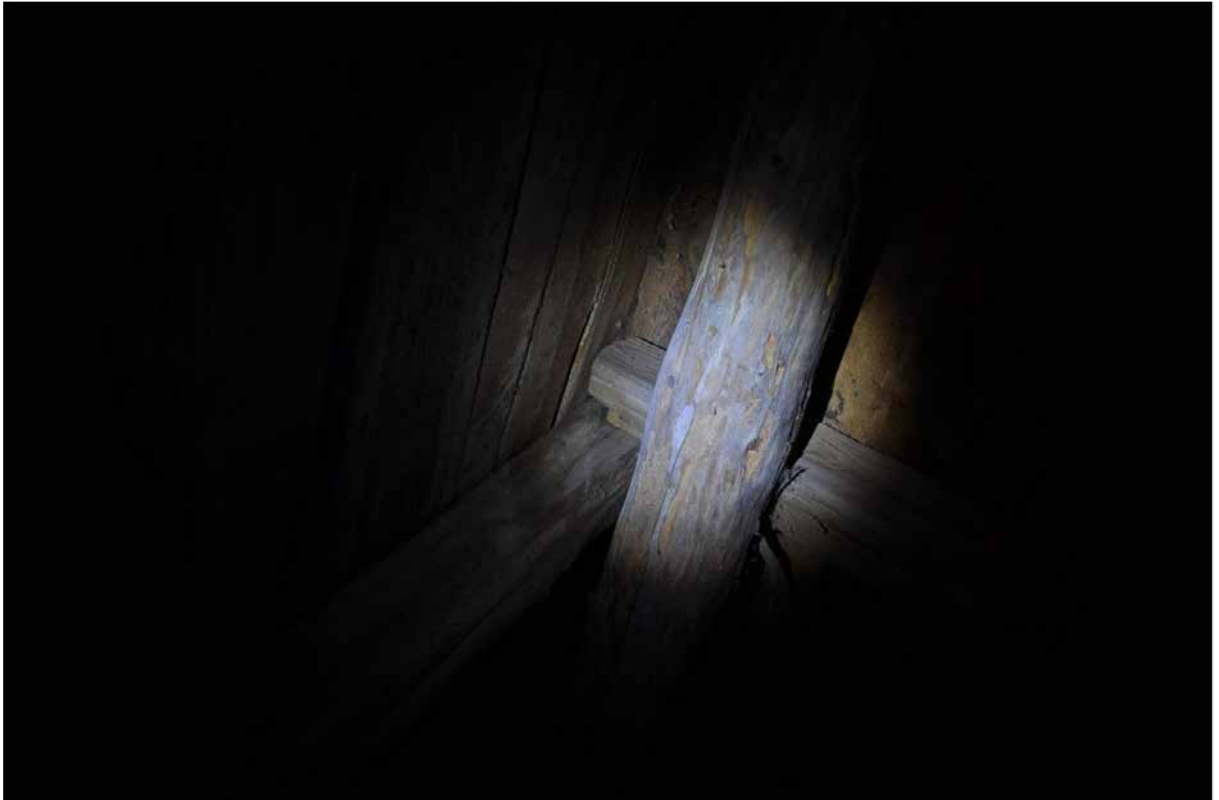
I nock är högbenen kapade, men man kan se spår av bladning även i denna knutpunkt. Fotografi: Daniel Eriksson
