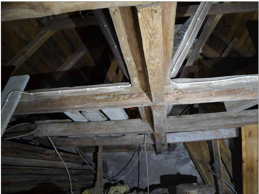
Den T-formade styrbjälken ihopknutad med bindbjälkarna (SLM D2015-1431).
