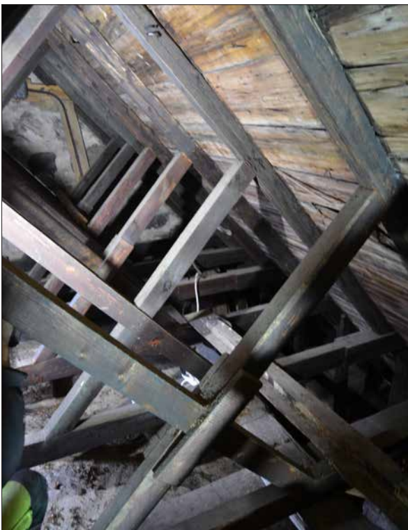
Takstolarna över långhuset är renoverade år 1953. Takstolarna har dock en romansk utformning (SLM D2015-1437). Fotograf Eva Wockatz.
