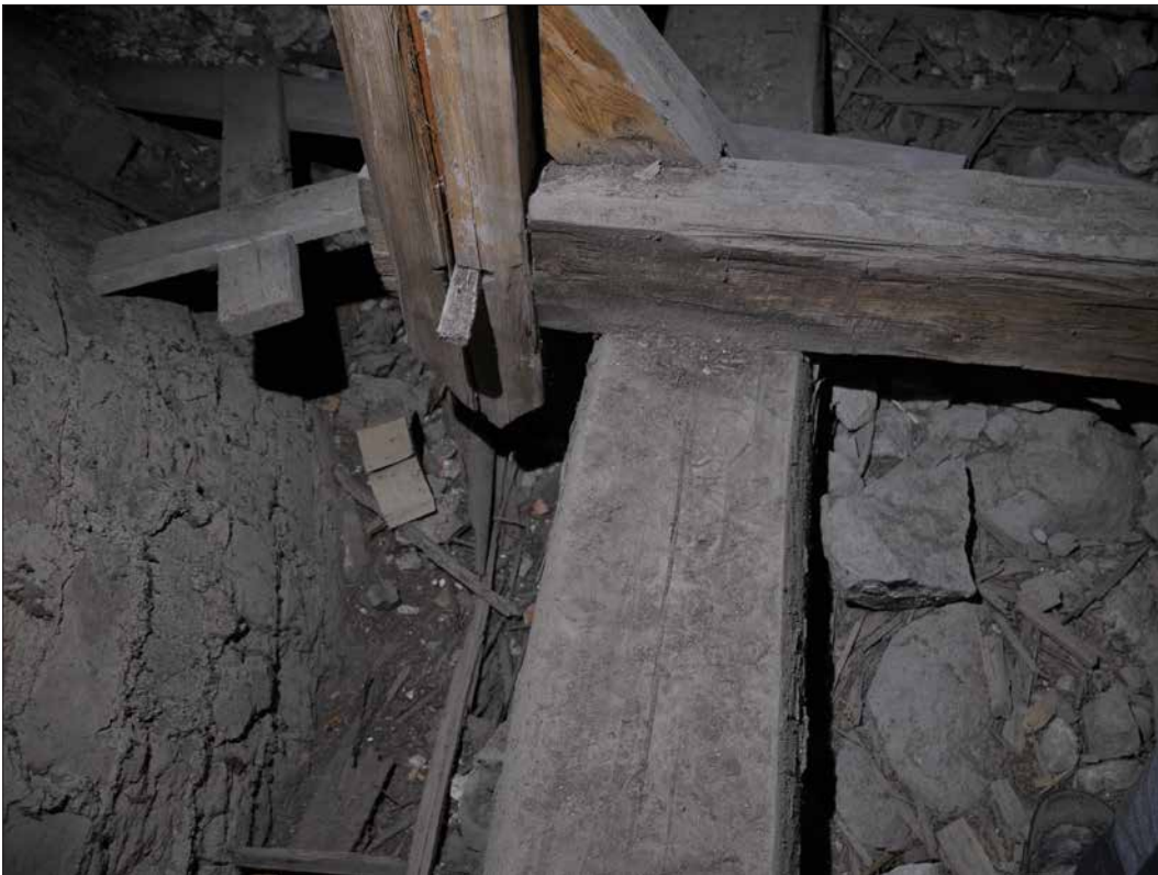
Mötet mellan stödben, tass och inre remstycke. Det inre remstycket har två sidor helt obearbetade (SLM D2015-1512). Foto: Daniel Eriksson.
