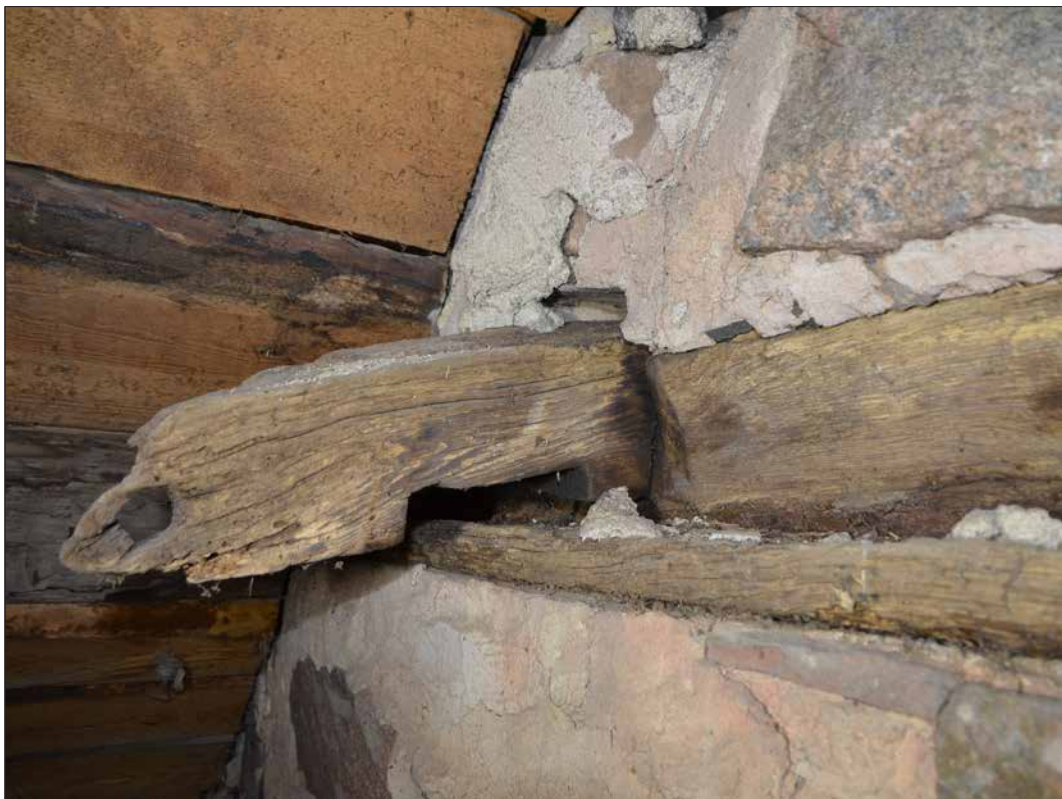
Utstickande taktass och yttre remstycke av ek med hylla tillhörande korets romanska takkonstruktion sedd från vinden över sakristian (SLM D2015-1479).
