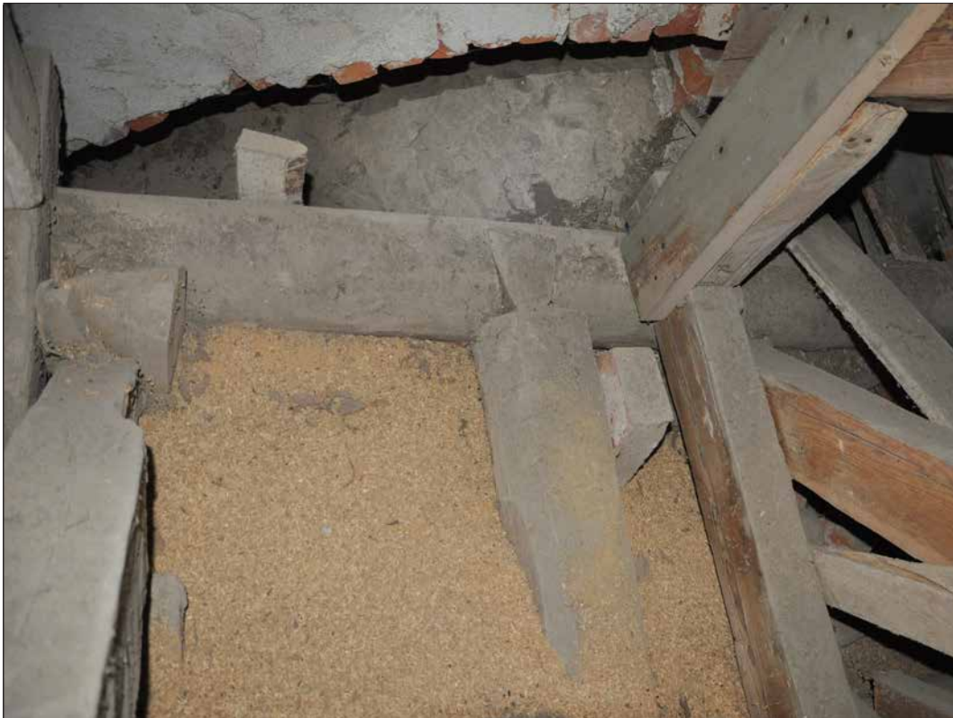
Yttre och inre remstycket har sammanfogats med laxade kortlingar (SLM D2015-1373). Fotografi: Daniel Eriksson.
