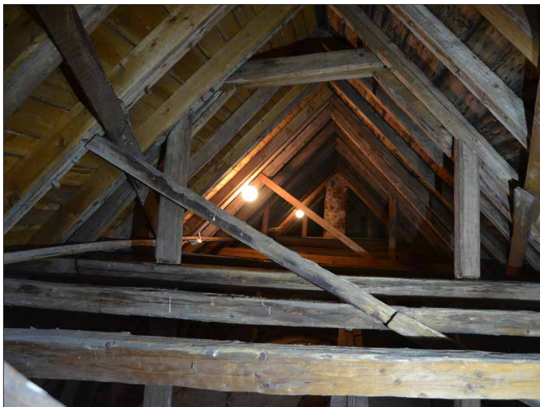
Långhusvinden sedd mot öster. Romanska högben med dymlingar för infästning av taktro (SLM D2015-1490).
