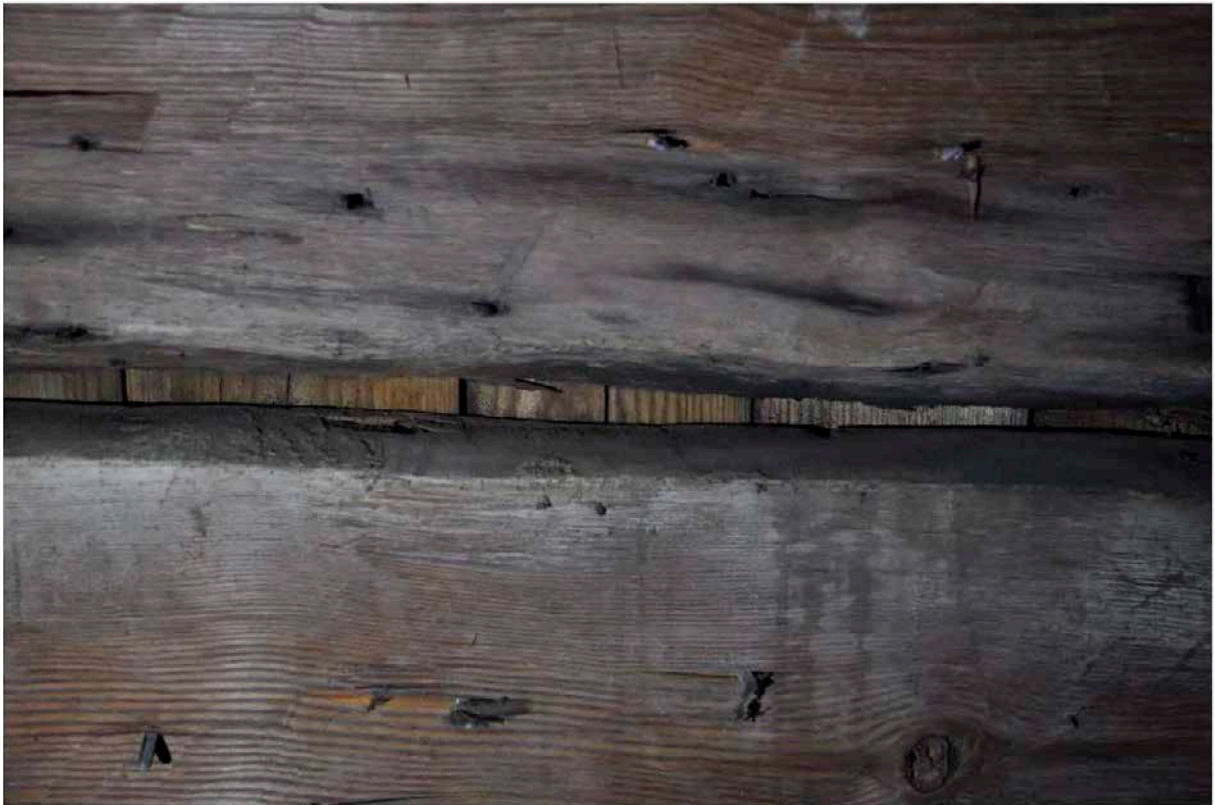
Taktron är till stora delar okantad, vilket möjliggör dendrodatering. Fotografi: Daniel Eriksson
