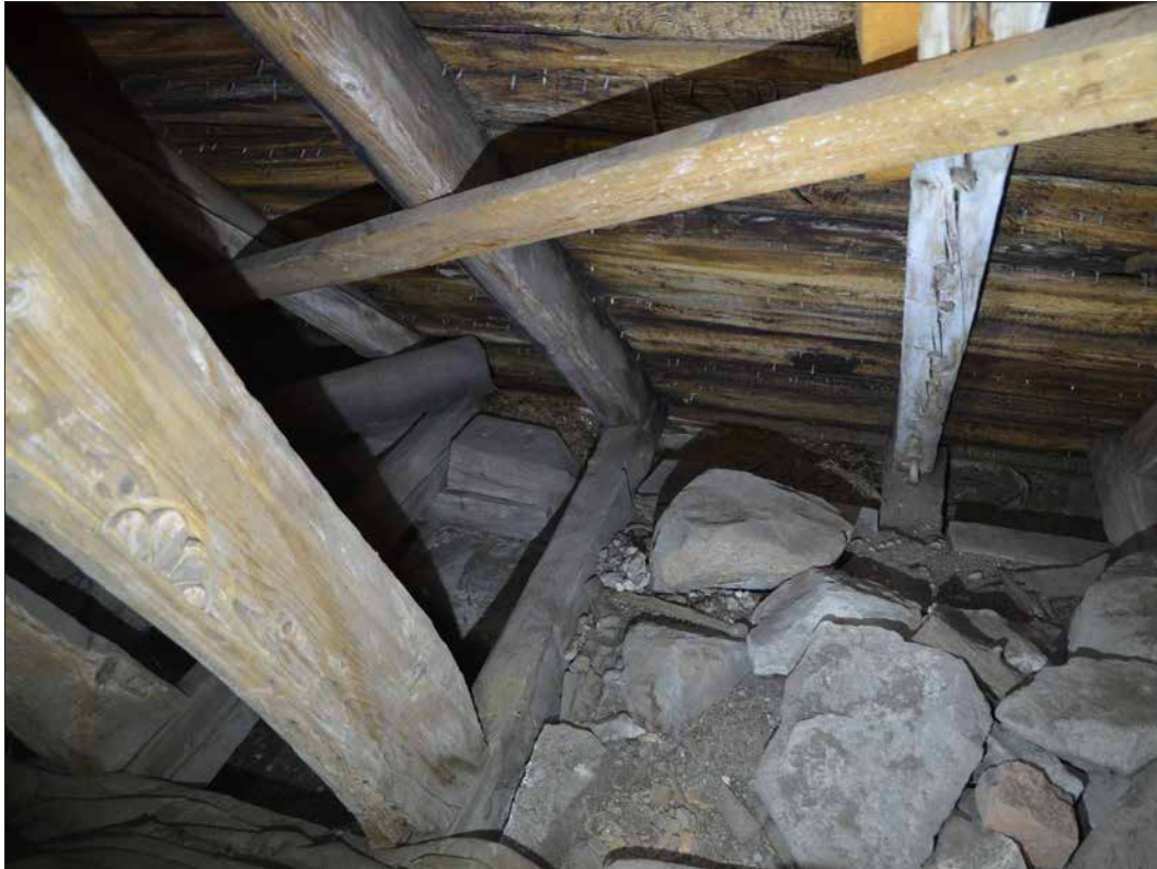
Sista högbenet i den romanska takkonstruktionen och första takstolen för tunnvalvet över långhusets södra murkrön (SLM D2015-1491).
