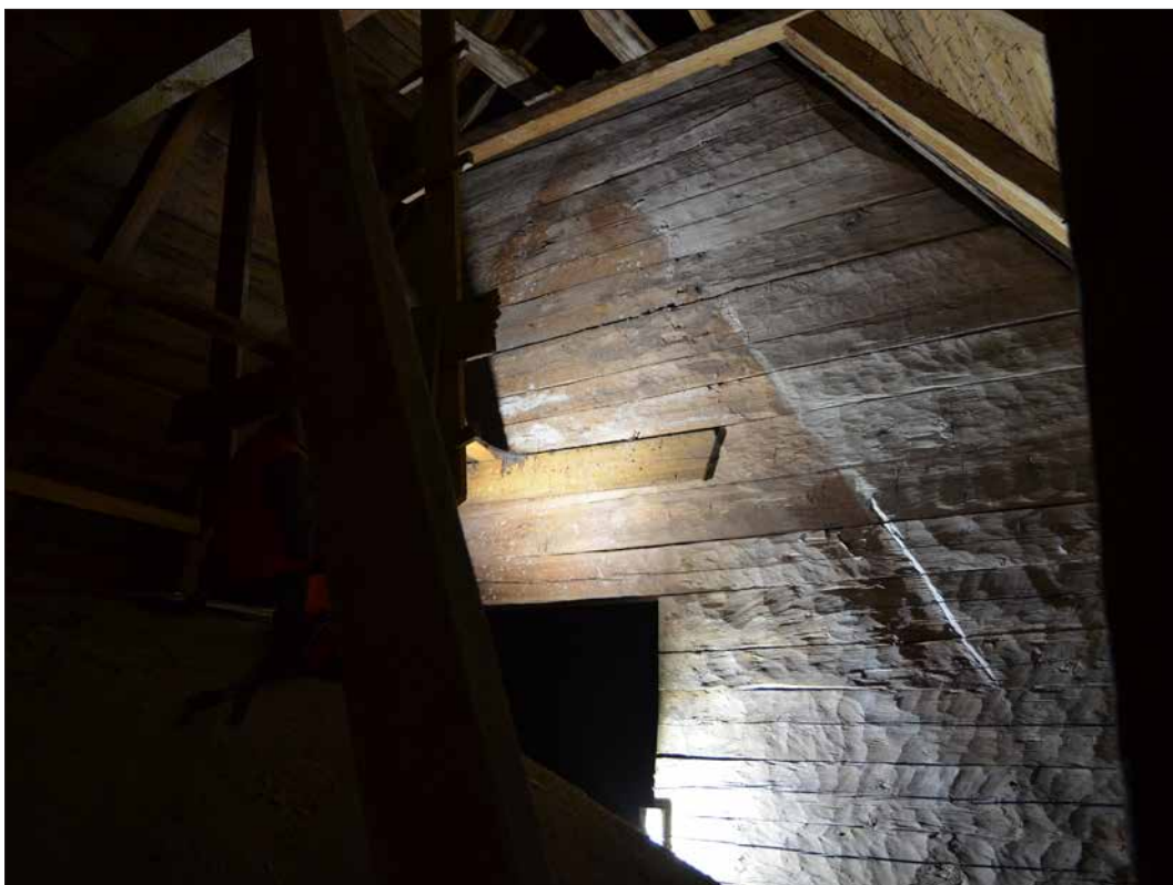
Det ursprungliga långhusets östra gavelröste är timrat. På röstets östra sida ser man det anslutande lägre och smalare äldre kortaket avteckna sig, för det norra takfallet har ett spår även huggits i timmerytan (SLM D2015-1446).
