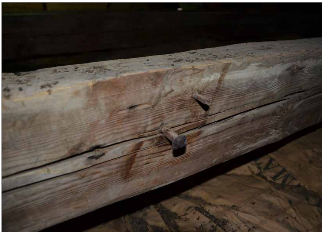
Grovt sprätthuggen romansk bindbälke med avtryck efter anslutande stödben som fästs in med två smidda spikar. (SLM D2015-1486).
