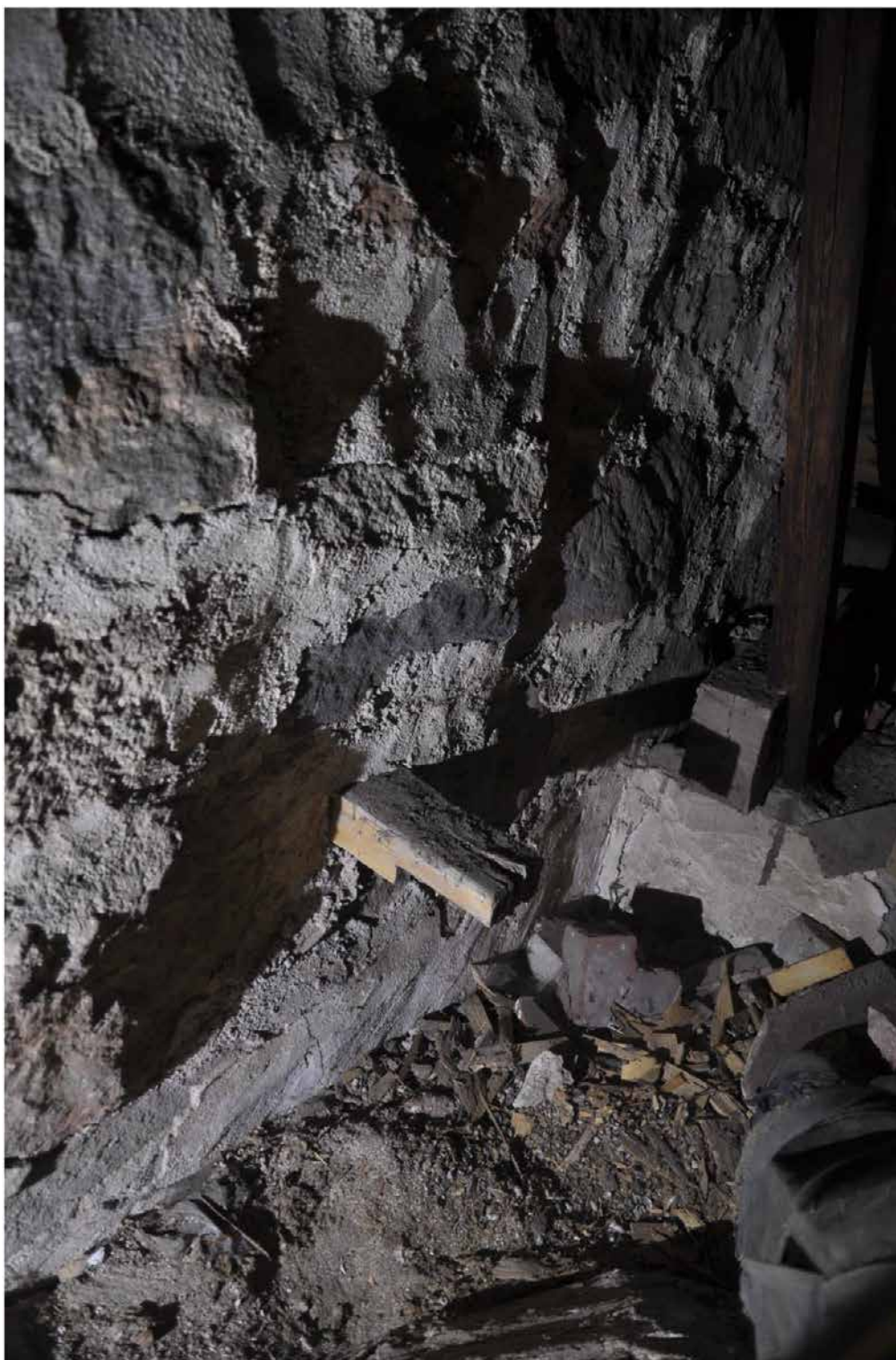
Mellan den yttre, synliga stickbjälken och bindbjälken närmast gavelmurens insida löper ett par tvärgående bjälkar. En på södra sidan, och en på norra sidan. Till höger i bilden syns den numer avkapade bindbjälken som ursprungligen löpt över till andra sidan och därmed passerat den tvärgående bjälken som sticker ut ur muren. Den lilla bjälken har en bladning som legat i ett urtag i bindbjälken, fixerad med spik. Detta betyder att åtminstone bindbjälkarna lagts på sin plats innan gavlarna murades. Fotografi: Daniel Eriksson
