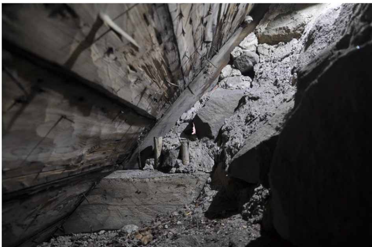
Här syns konstruktionen från insidan, men på denna bild från östra gaveln. Stickbjälken i ek tycks sitta med två ekdymlingar i remstycket. Fotografi: Daniel Eriksson
