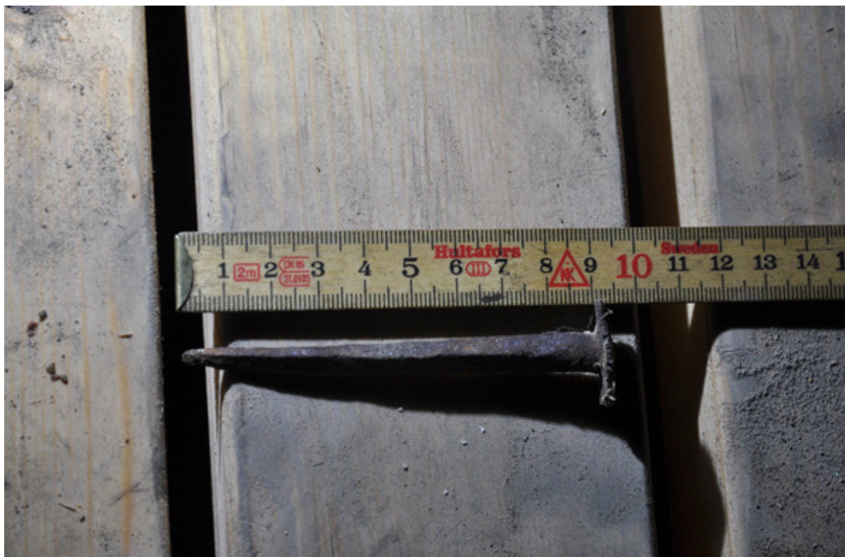
Den ena spiken sitter löst och går att ta ur. Den har en stor skalle, samt en klinga som närmast under skallen har en rund form. Fotografi: Daniel Eriksson
