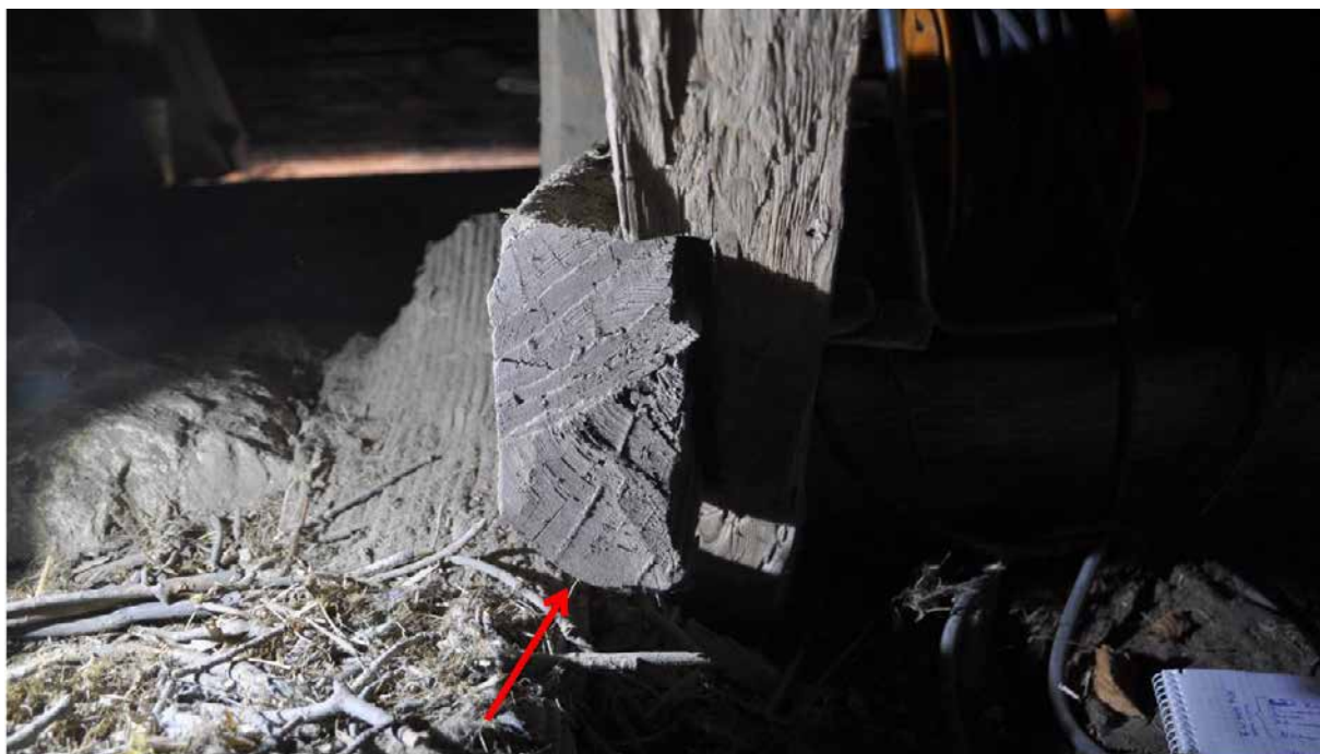
Tassarna har nog alltid varit just tassar och inte bindbjälkar. Ändarna kan omöjligt ha kapats på plats då vissa hugg kommer i riktning nedifrån Fotografi: Daniel Eriksson
