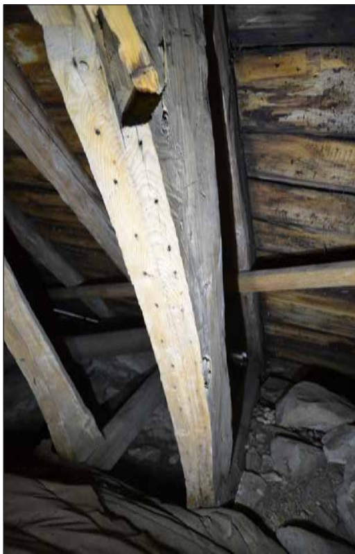
Fals med spår av spikning, takstol 18 (SLM D2015-1495).
