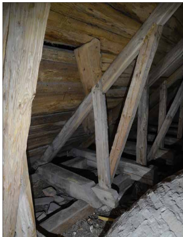
Återanvänd konstruktionsdel har fått ny funktion som tass (SLM D2015-1448).
