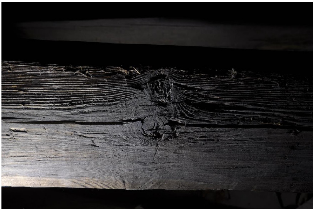
Bindbjälkarna är "efterbreddilade". I nedre kanten syns den ursprungliga sprätthuggningen. Någon har därefter justerat ytan med en helt annan behuggningsteknik. Kontinentala influenser? Kanske ett tecken på att lokala människor levererade virke, och särskilda kyrkbyggare reste taklaget. Fotografi: Daniel Eriksson
