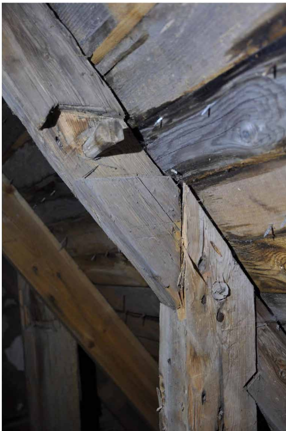
Taklaget i sakristian består av noggrant bearbetat virke med välgjorda knutar med nacke. Det kan mycket väl vara senmedeltida. Fotografi: Daniel Eriksson
