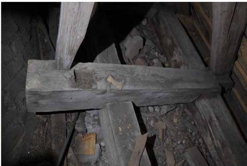
Bindbjälkarna har grunda tapphål som är i lod. Men har det verkligen varit lodräta stödben så långt ut? Det känns inte romanskt. Fotografi: Daniel Eriksson
