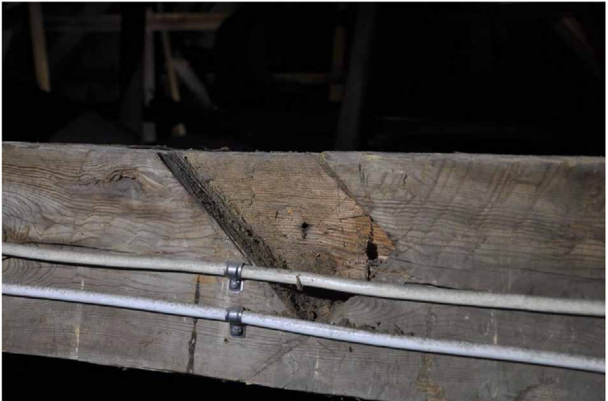
Knutpunkt för stödben i en bindbjälke. Stödbenen har varit fixerat med en spik.
