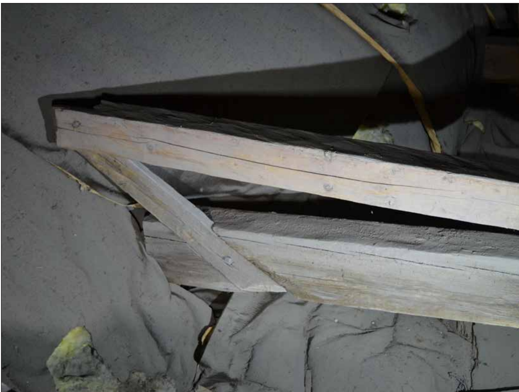
Kvarvarande del av ursprungligt möte stödben-bindbjälke (SLM D2015-1476).
