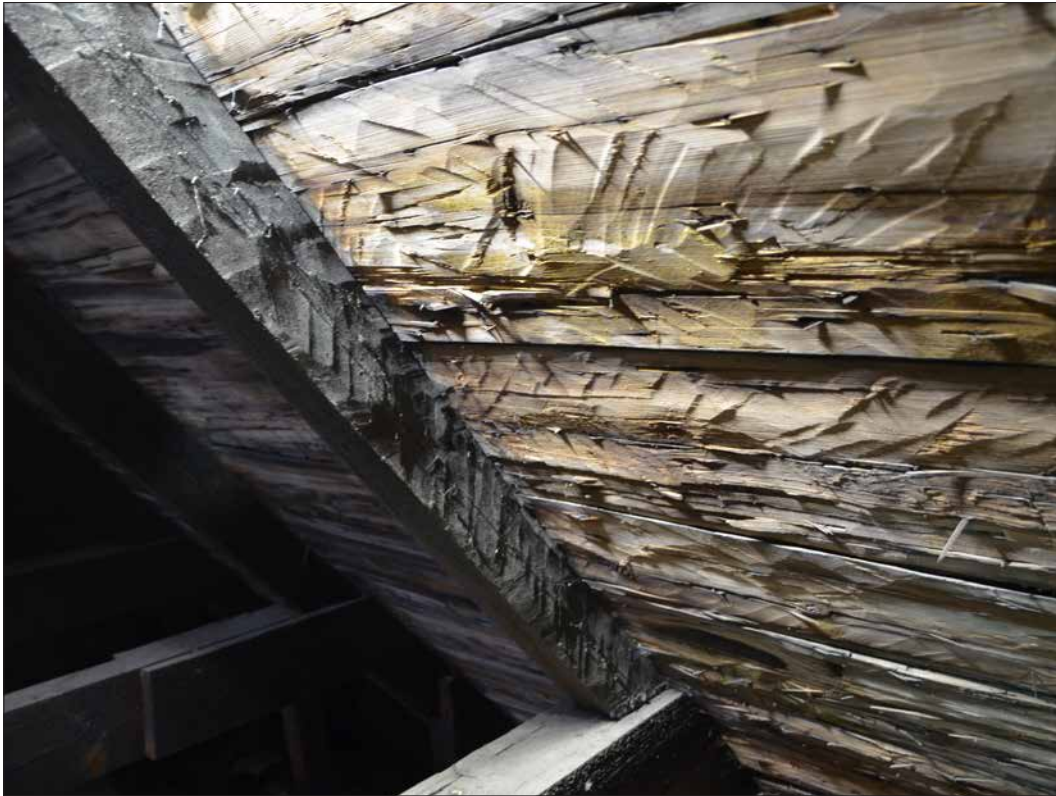
Trobrädorna är bilade och bördade, vissa brädor är sprätthuggna (SLM D2015-1439).
