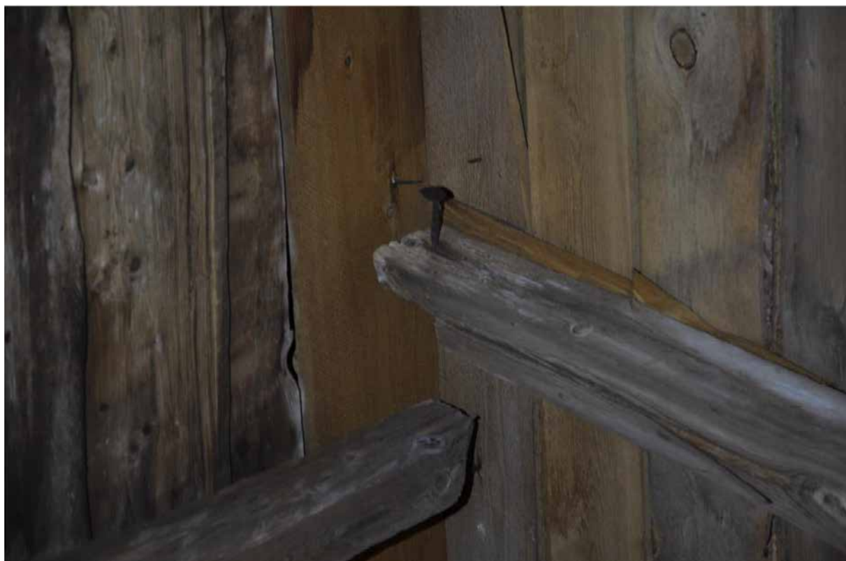
Högbenens möte med bladning och dymling. Högbenet till vänster är ej ursprungligt. Fotografi: Daniel Eriksson
