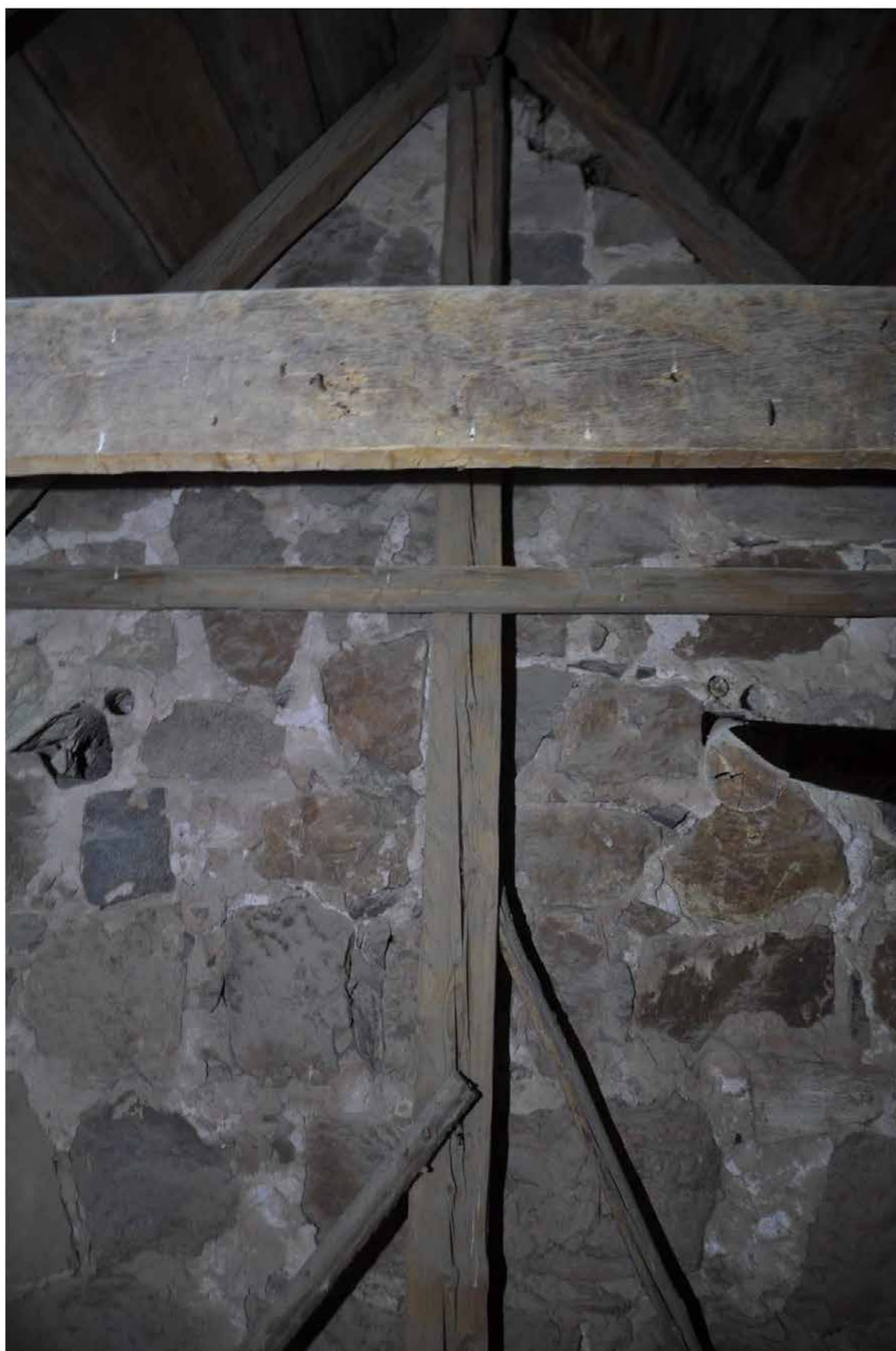
Nockåsen vilar i sin östra ände på en kungsstolpe. I den västra änden vilar den på ett upplag i muren. Fotografi: Daniel Eriksson
