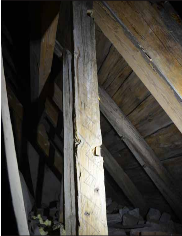
Återanvänt stödben på södra sidan av långhusvinden. Urtag för klockaxlar, sprätthuggen yta och teckning med kolkrita (SLM D2015-1477).
