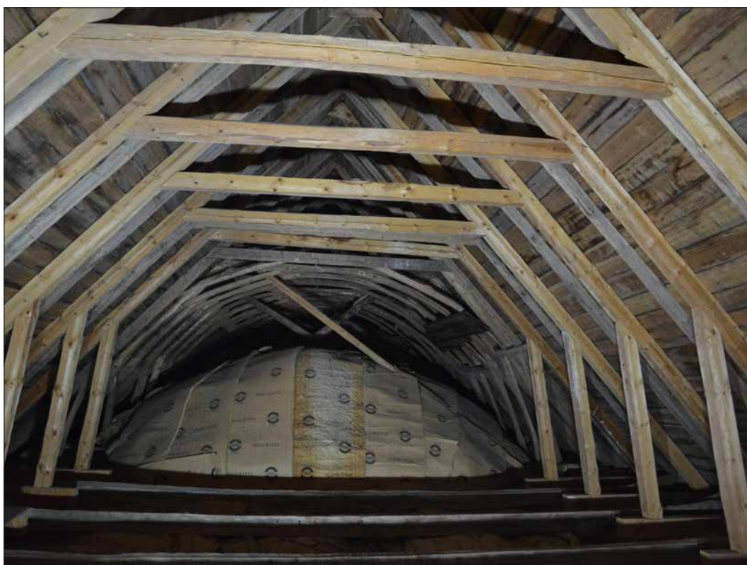
Långhusvinden sedd från väster. Närmast i bild syns förstärkningstakstolarna från 1881 och mellan dessa de mer silvergrå medeltida högbenena. Längst bort i bild över valvet syns takstolen för 1300-tallets trätunnvalv (SLM D2015-1485).
