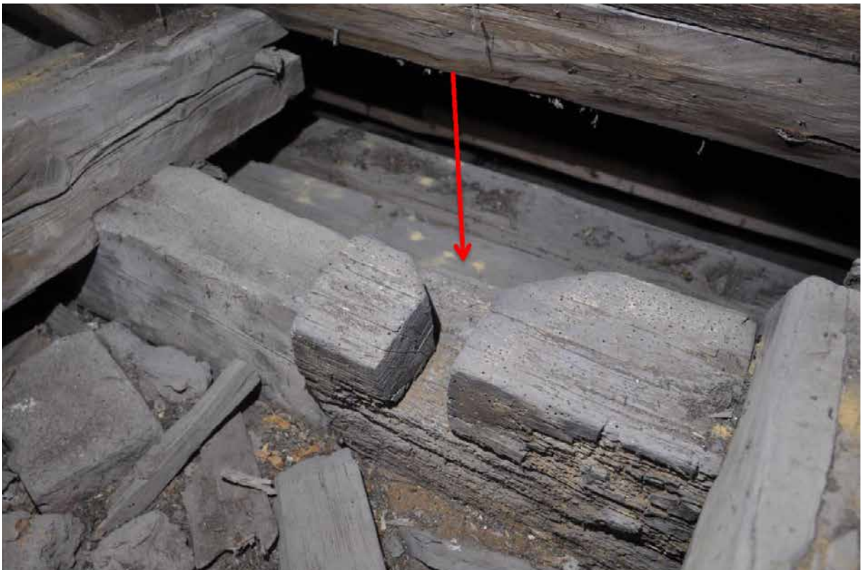
Remstycke i ek med ett y-format hak för bindbjälken. Se nästa bild. Fotografi: Daniel Eriksson
