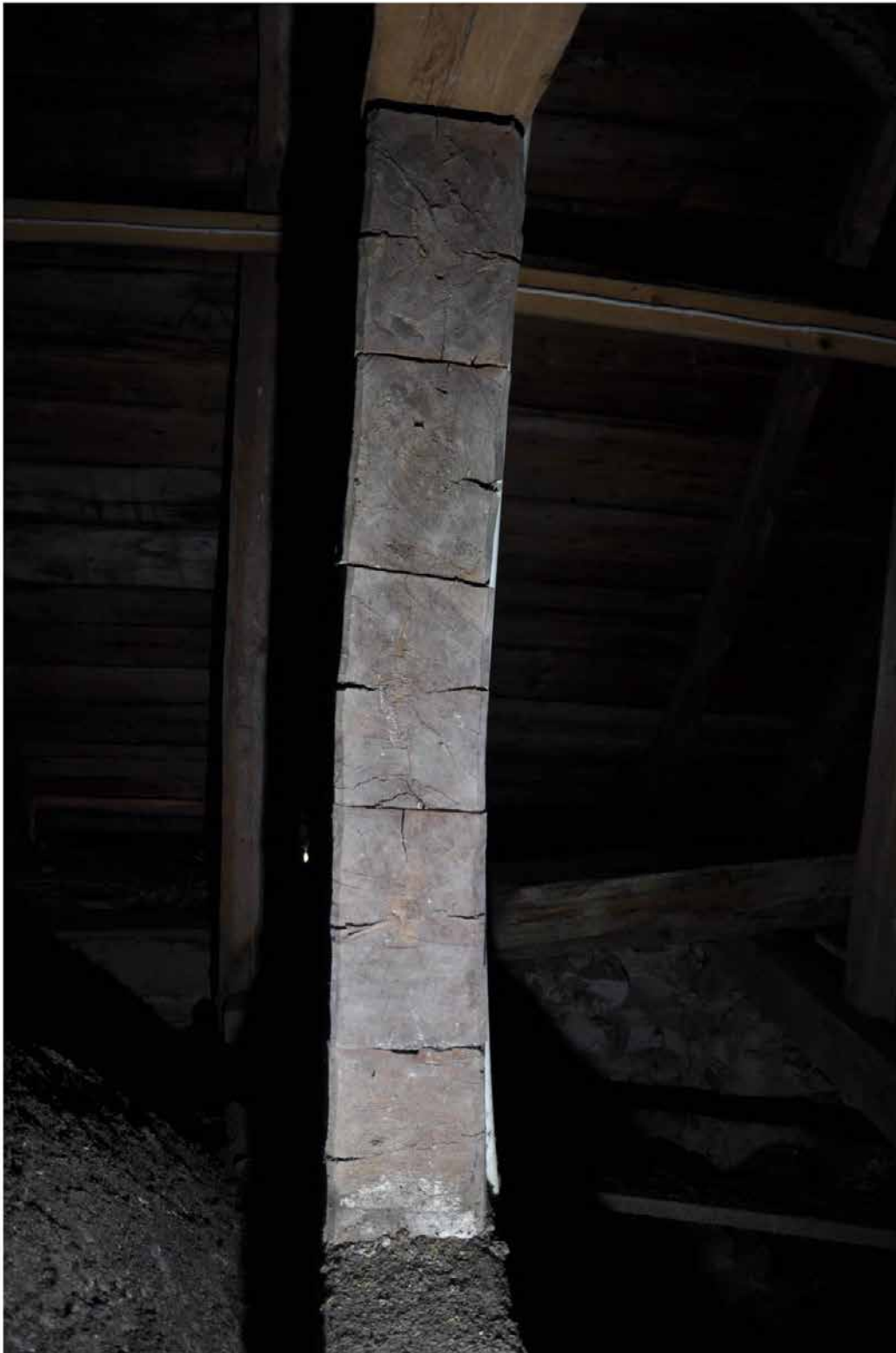
Bilden är tagen i röstets öppning. Timrets bredd är här ca 130-150mm (ca 5-6 verktrum). Virket är av tätvuxen fura och den genomsnittliga bygghöjden är 210mm. Längre upp förekommer grövre timmer. Timren ligger ganska platt mot varann, inget långdrag. Fotografi: Daniel Eriksson
