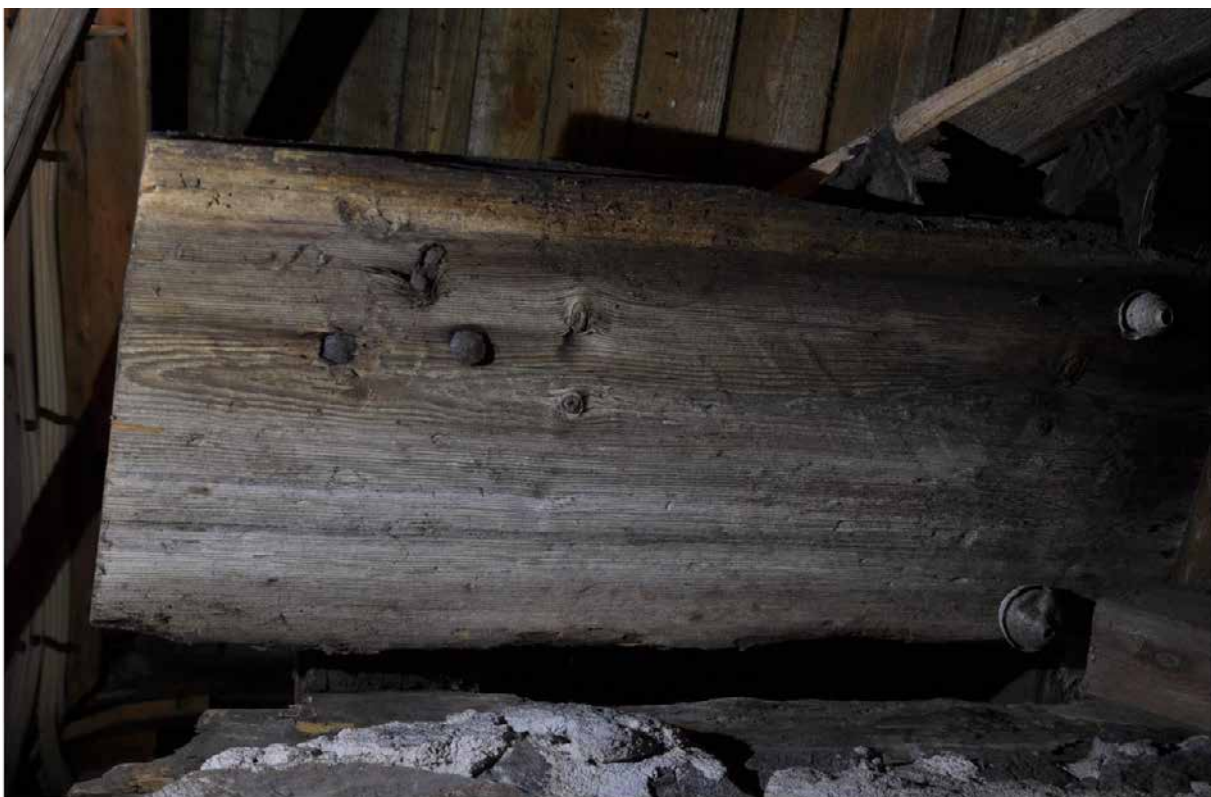
Underifrån ser man att den är fäst med tre spik, alla tre med en sammanhållen placering ganska långt ut i takfoten. Märkligt att det inte sitter någon spik längre in mot muren. Här ser man också att den är sprättäljd. Observera att brädans yttre kant har ett ljusare fält, som om det har varit skyddat av något. Se skiss längre ned. Fotografi: Daniel Eriksson
