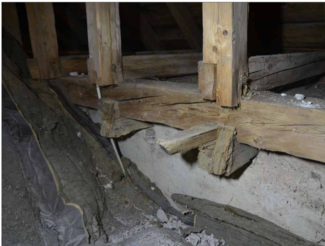
Takstolarna i långhuset vilar på dubbla remstycken som i sin tur vilar på resterna av den romanska takkonstruktionen. I bild syns de avkapade bindbjälkarna strax innanför det nuvarande inre remstycket och muren (SLM D2015-1420).
