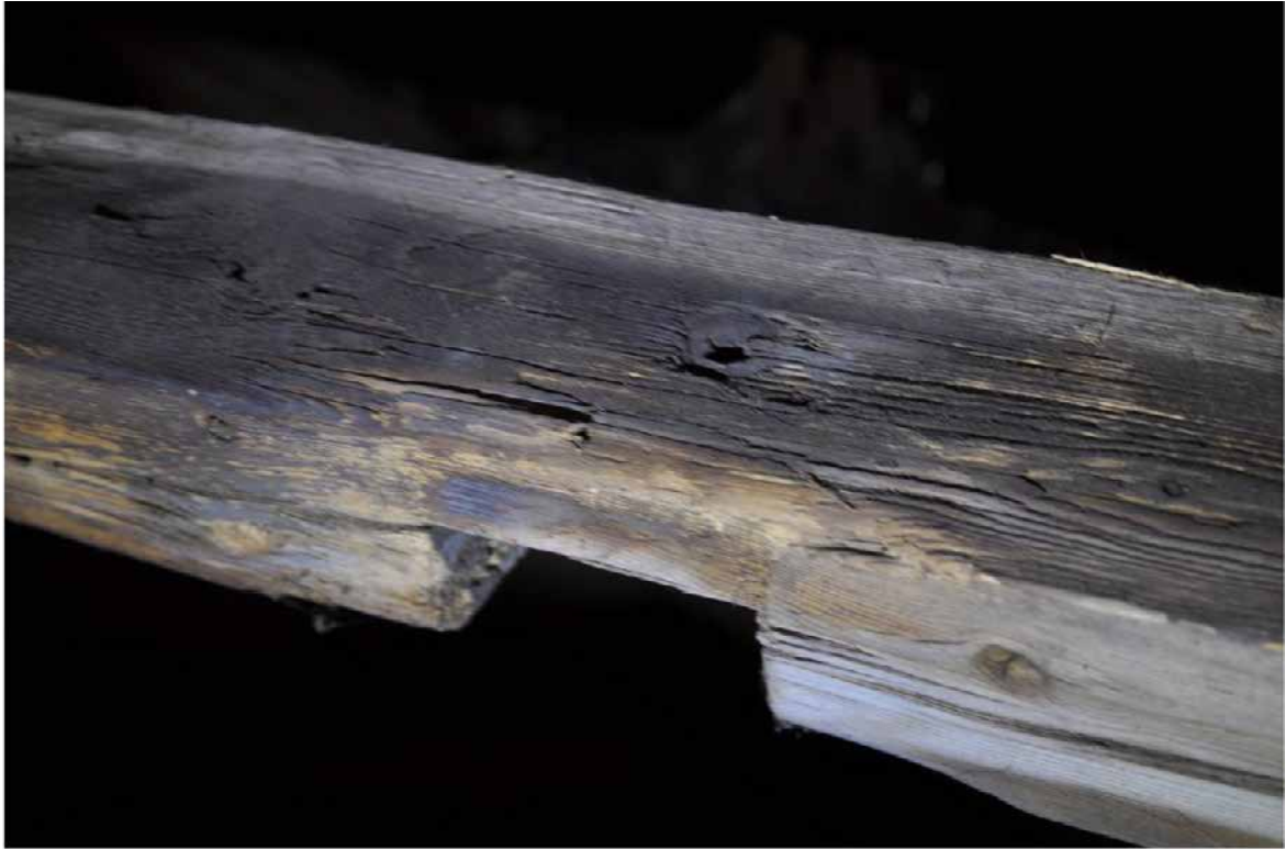
Ett tidigare stödben. Här ser man att stödbenens knutpunkter varit huggna halvt-i-halvt och fixerade med en spik. Fotografi: Daniel Eriksson
