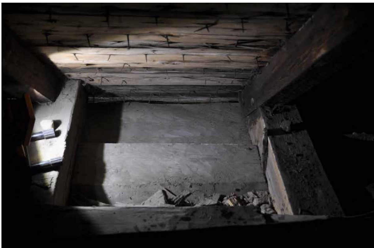
På denna bild syns även den ursprungliga takfotsbräda som finns kvar på norra sidan. Brädan är sprätthuggen och 25mm tjock. Fotografi: Daniel Eriksson
