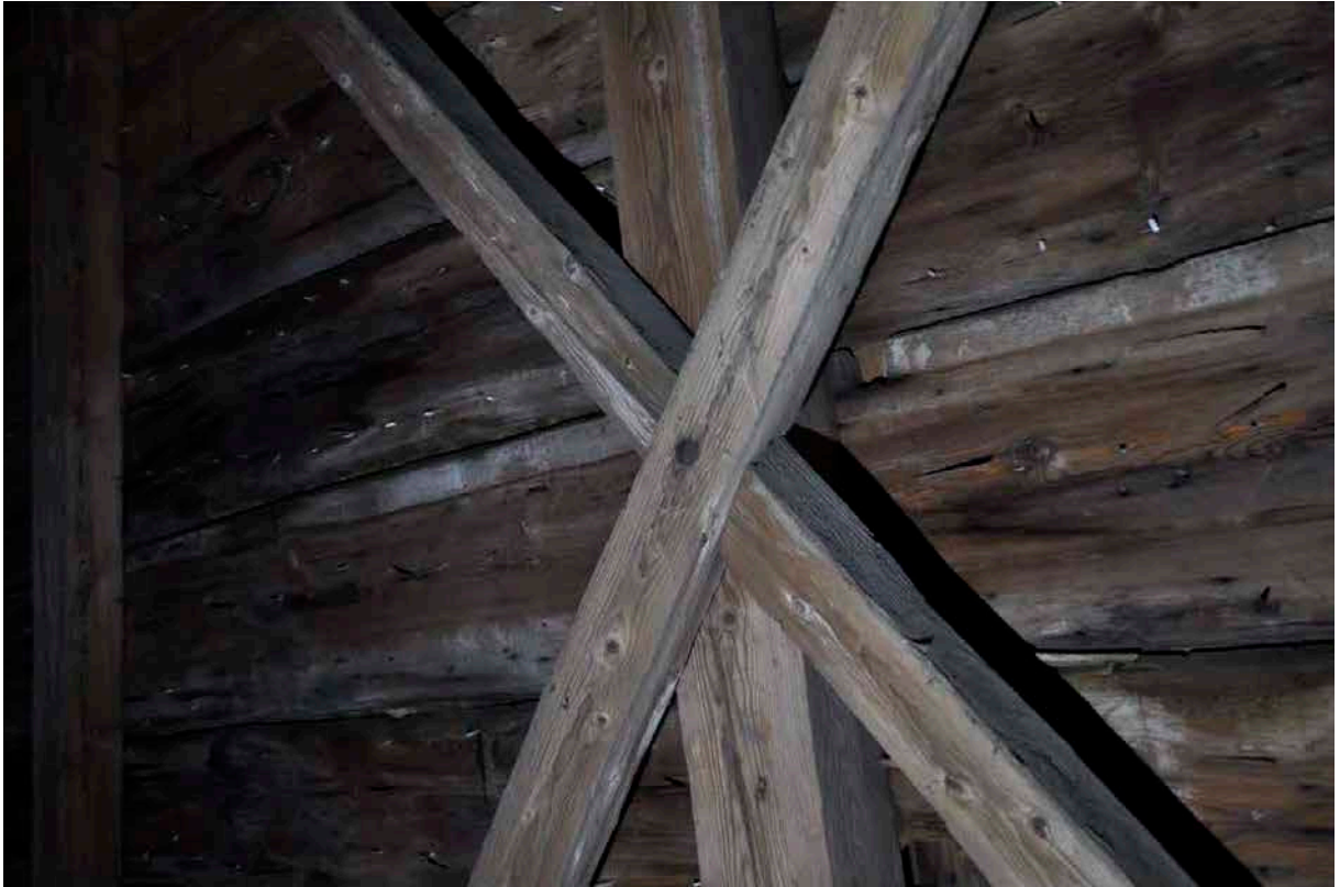
Intill vardera takfall finns en sidoförsträvning i form av korslagda strävor. De löper från syllramen upp till det bjälklag som finns en bit upp i tornhuven. Sammanfogningarna är fixerade med spik. Fotografi: Daniel Eriksson
