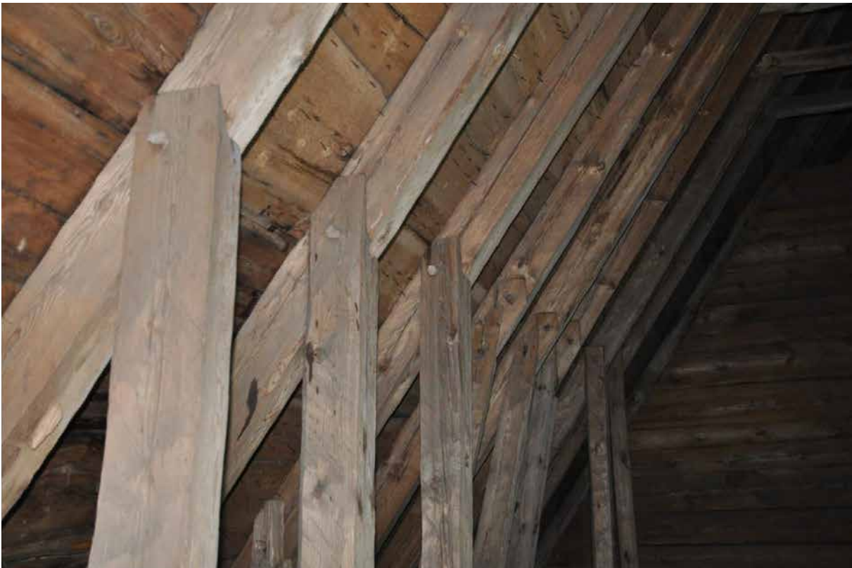
Stödbenen sitter upptill i husade knutar med horisontellt avslut som delvis bryter igenom högbenets övre/yttre kant. Längst bort i bild är stödbenen omflyttade p.g.a. valvslagningen. Hela taklaget består av heltimmer, d.v.s. det finns inga kluvna ämnen.
