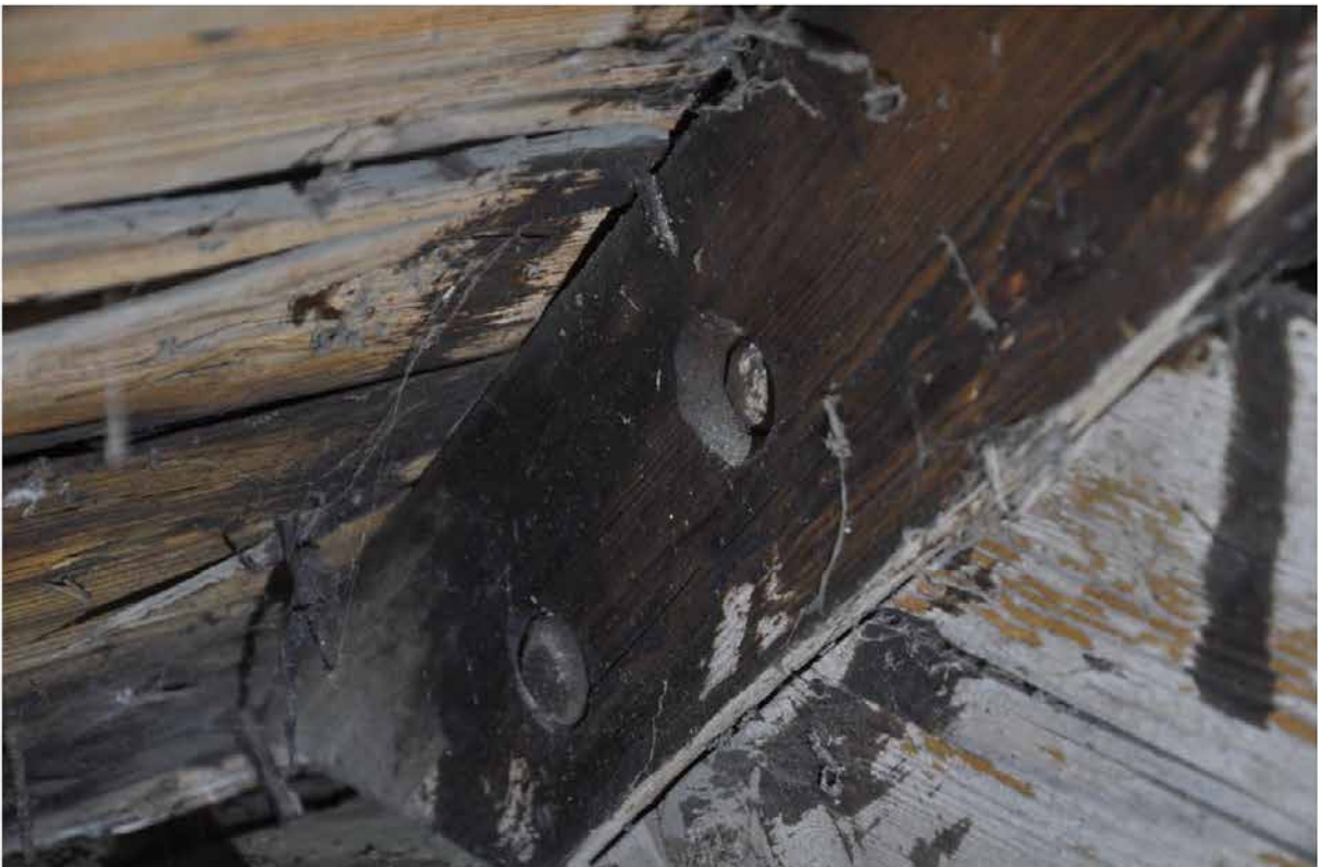
Bilden visar knutpunkten där högbenet möter bindbjälken. Högbenet är låst med två dymlingar. Dymlingarna har mycket fint täljda "spikskallar". Dessutom är de omsorgsfullt försänkta genom fasade kanter i borrhålen, varav den övre dymlingen blivit kraftigt försänkt. Detta är en punkt i taklaget som aldrig varit synlig för människorna nere i kyrkorummet, ändå har man lagt ned mycken möda i arbetet. Typiskt för det tidigmedeltida sakrala timmermanshantverket. Fotografi: Daniel Eriksson
