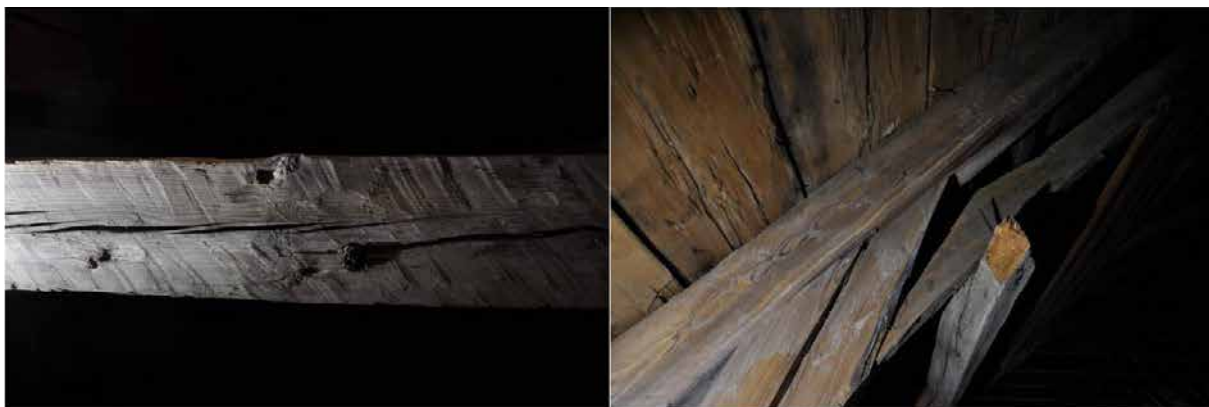
Exempel på sprätthuggen bit som sitter återanvänd tunnvalvets taklag. Fotografi: Daniel Eriksson
