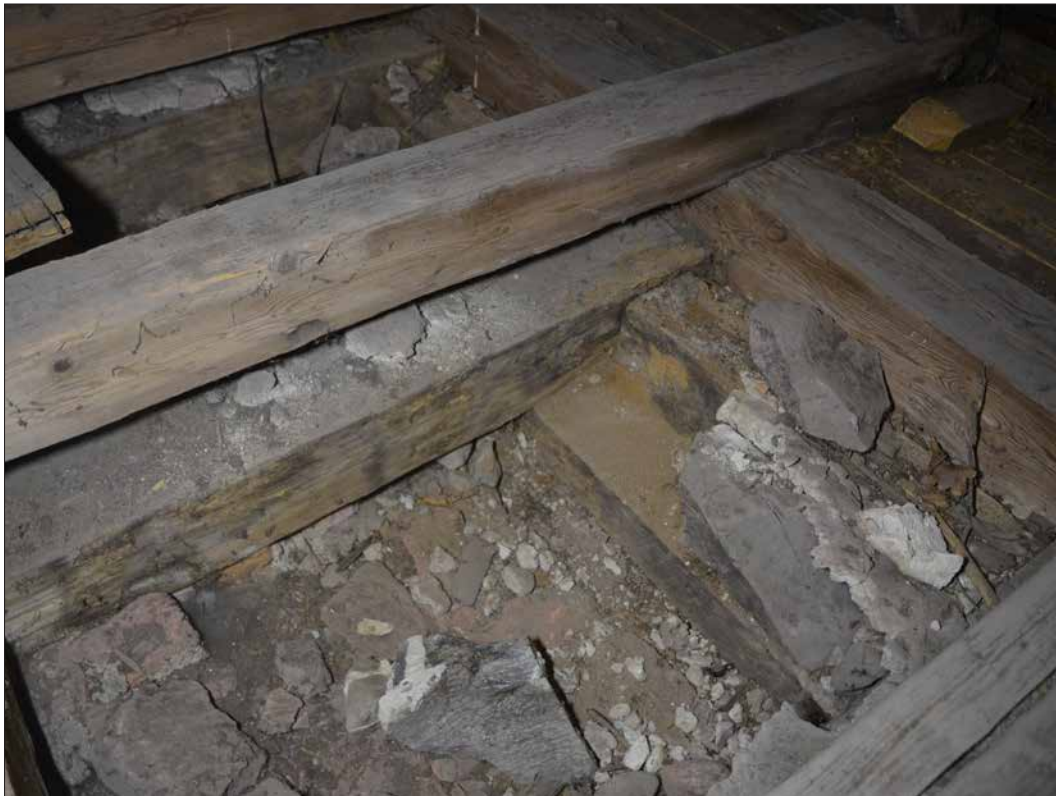
Yttre remstycket med invändig hylla och nedfälld bindbjälke (SLM D2015-1422).
