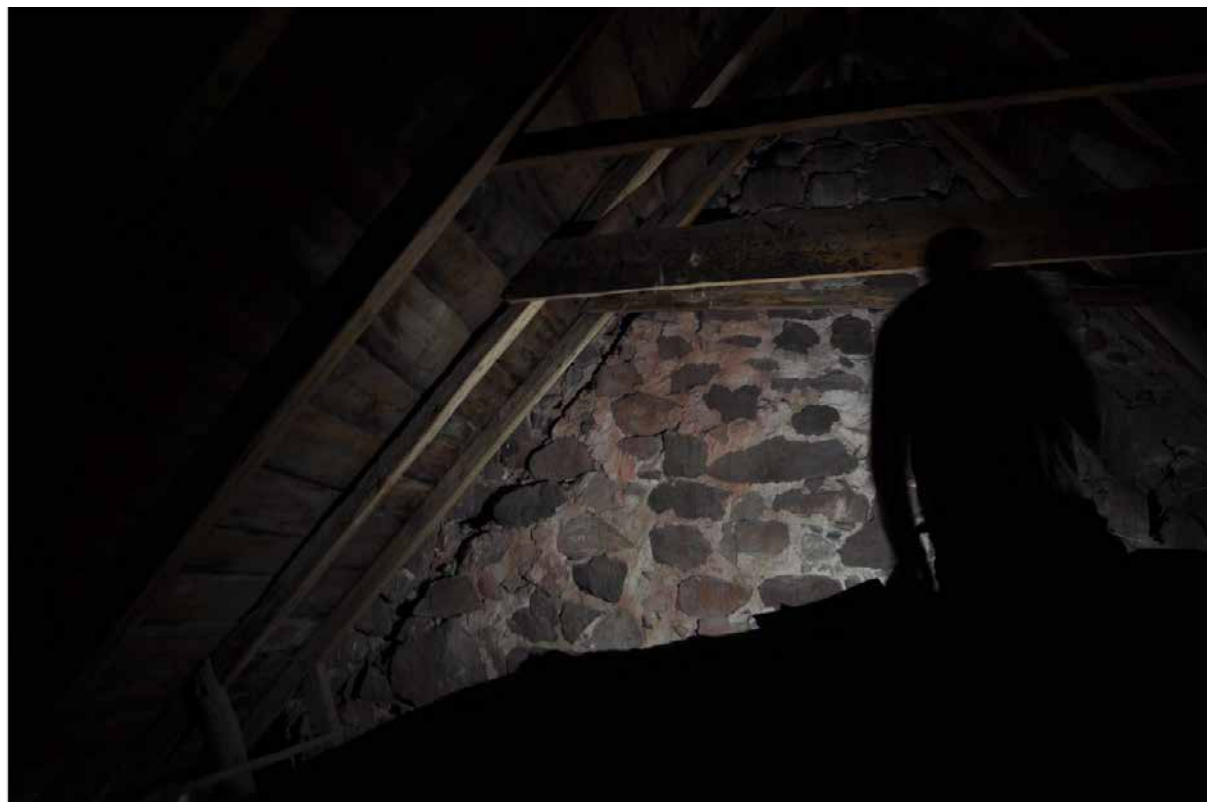
I västra muren ser man samma fenomen i form av avtrycket av det tidigare kortakets taktro, som har en brantare vinkel än det nya. Fotografi: Daniel Eriksson
