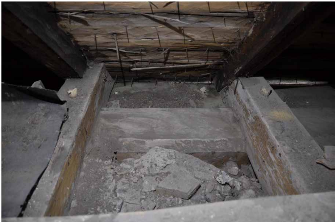
Ursprungliga bindbjälkar (samtliga numer kapade), högben, remstycke samt taktro. Dimensionerna på högben och bindbjälkar är väl sammanhållna och varierar inte mycket. Högbenen mäter i tvärsnittet ca B:80mm, H:100mm. Motsvarande mått för bindbjälkarna är ca B:120mm H:190mm. Remstyckets bredd är ca 220mm. Alla delar är i furu. Bindbjälkarna är fixerade i remstycket med kraftiga ekdymlingar. Dymlingarna är ej möjliga att montera då högbenen är på plats. Det betyder att bindbjälkarna monterats först, därefter har man rest högben och stödben.
