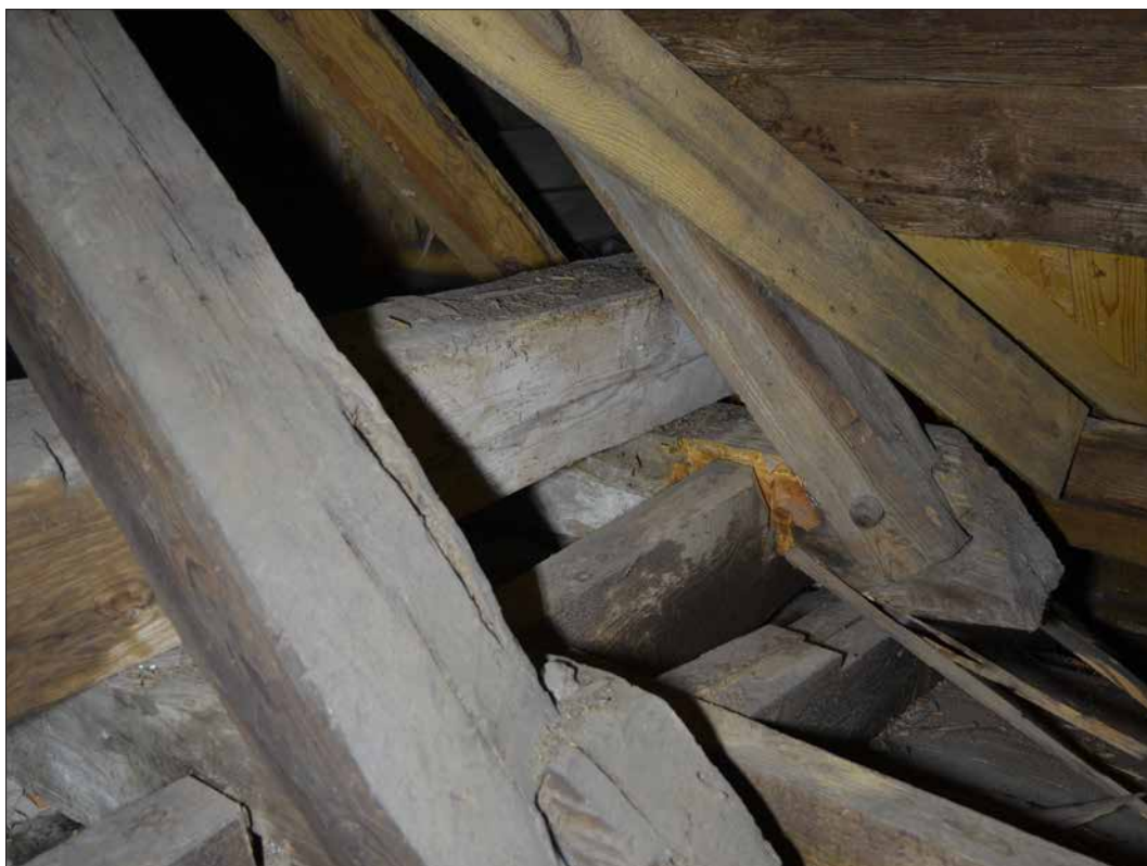
Takfoten på norra sidan av långhuset sedd från norra korsarmens vind. Remstycke av ek med hylla och spikskalledympling i mötet högben-bindjälke/tass (SLM D2015-1451).
