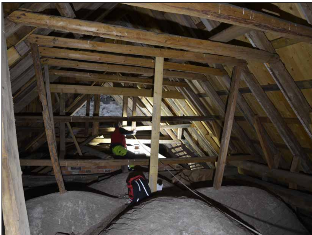
Långhusets taklag sett mot öster (SLM D2015-1450).
