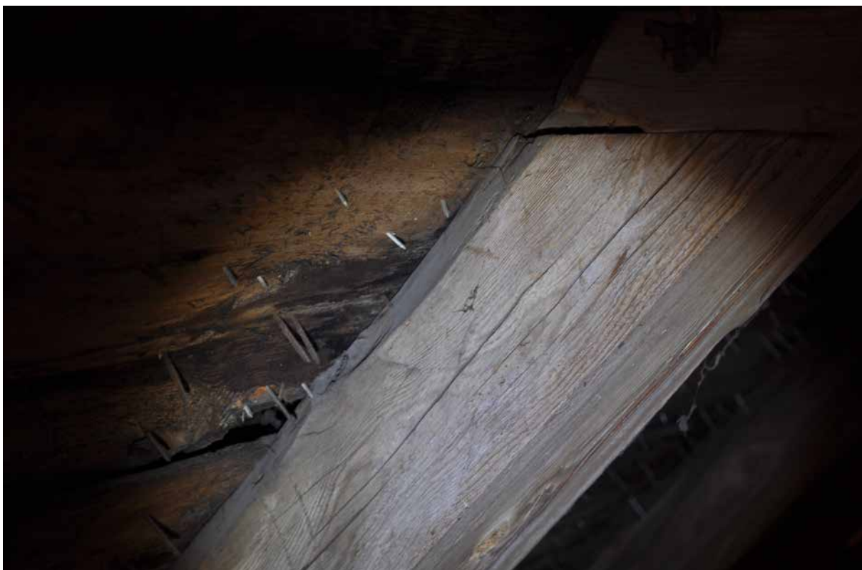
Den mittre av de primära takstolarna har gott om vankant, lämplig för dendro. Fotografi: Daniel Eriksson
