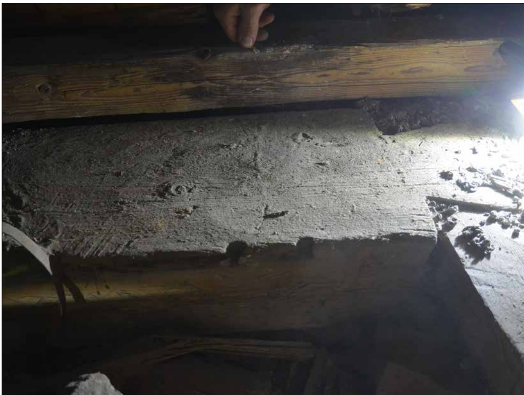
Den laxstjärtsförsedda bindbjälken mellan det inre och yttre remstycket i söder är sprätthuggen och antagligen utförd av återanvänt liggtimmer (SLM D2018-0002)
