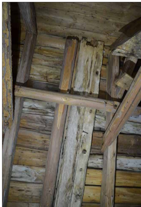
Kombinerat högben/takfotsbräda av ek i skarven mellan 1100-talskyrkan och 1400-talets utbyggnad österut (Slm D2015-1504).
