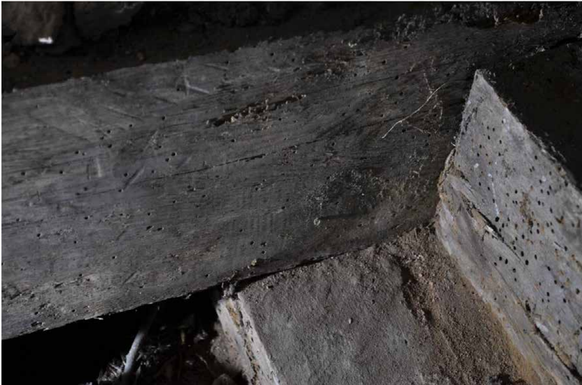
På bindbjälken syns spår av skave men även lite rester av sprätthuggning. Allt är mycket omsorgsfullt bearbetat med raka skarpa kanter och släta ytor. Fotografi: Daniel Eriksson
