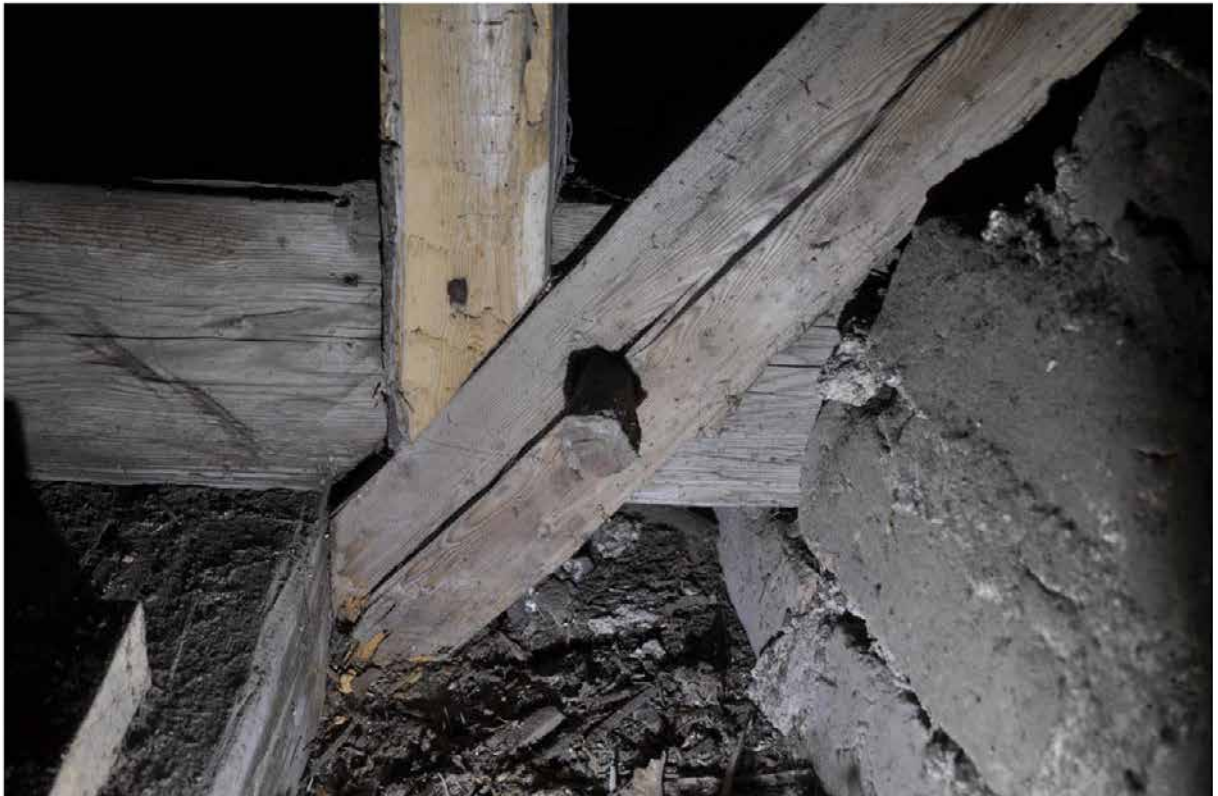
Tassarna ligger bara löst uppe på remstyckena. Istället löper stödbenen förbi tasserna och stöter mot inre remstycket. På så vis kan inte takstolarna glida isär. Fotografi: Daniel Eriksson
