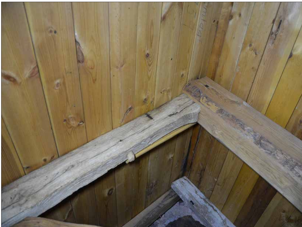
Ovanför koret står 7 takstolar med romanska och gotiska högben. Takstol nr 1 har på södra sidan ett sprätthugget högben i ek med två urtag för saxsparrar och dymlingar för taktro. Uppe vidnock har högbenet en skuren rundning (SLM D2015-1423).
