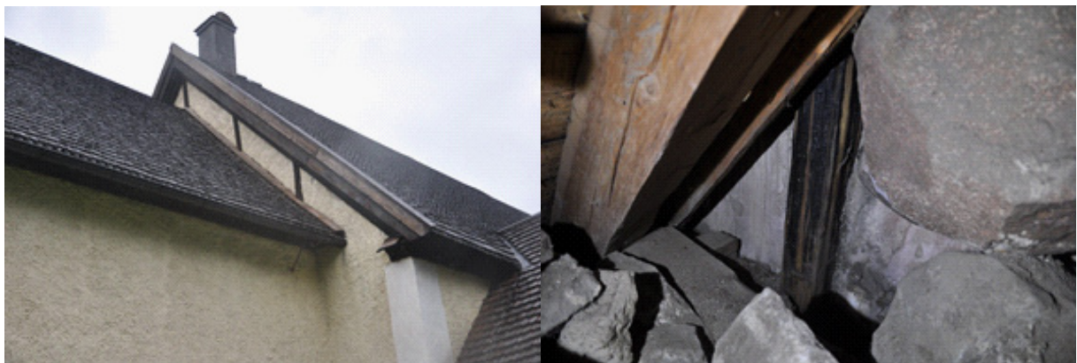
Utvändigt på långhusets västra gavel syns stående virken. De yttre/nedre är synliga från tornvinden. Är de ursprungliga? De övriga tre verkar sluta vid torntakets anslutning mot muren. Fotografi: Daniel Eriksson
