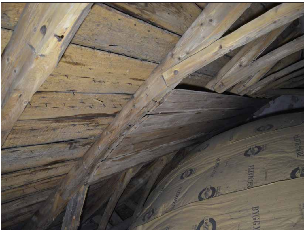
Kvarvarande valvbrädor i tunnvalvskonstruktionen. Brädorna har bearbetats med skave (SLM D2015-1487).
