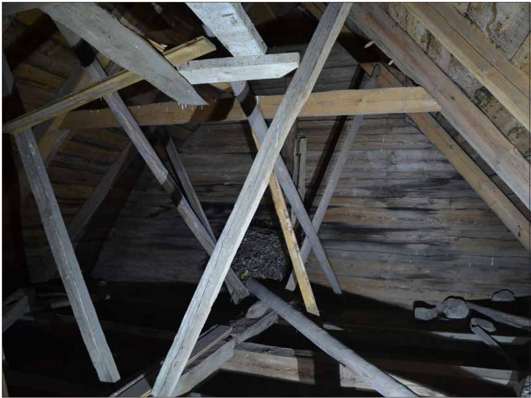
Tornrummets vind sedd mot väster (SLM D2015-1430).
