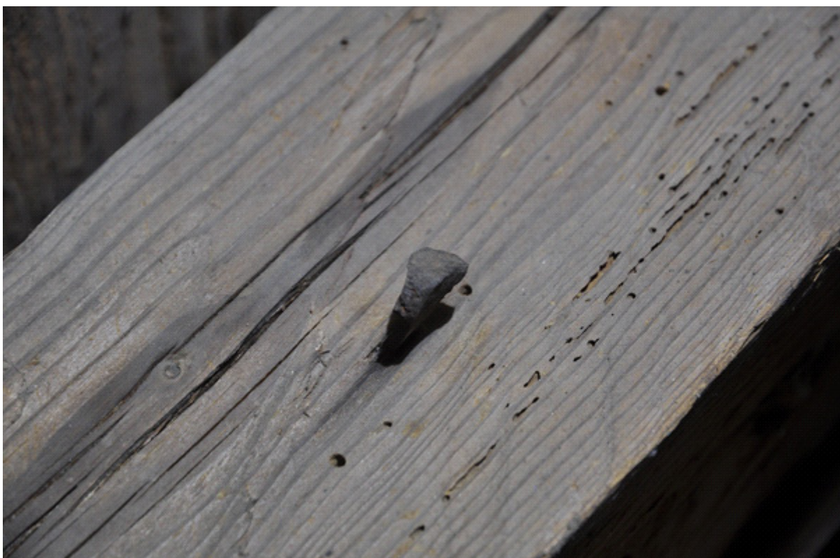
På norra högbenet i takstol 2 sitter en spik som har mycket speciell form. En likande typ av spik finns i ganska stort antal i taklaget på Knista kyrka, Örebro län, dendrodaterad till ca 1123. Om de inte har tillkommit i samband med resningen av taklaget så är det ändå möjligt att de spikats dit under den romanska tiden. Fotografier: Daniel Eriksson
