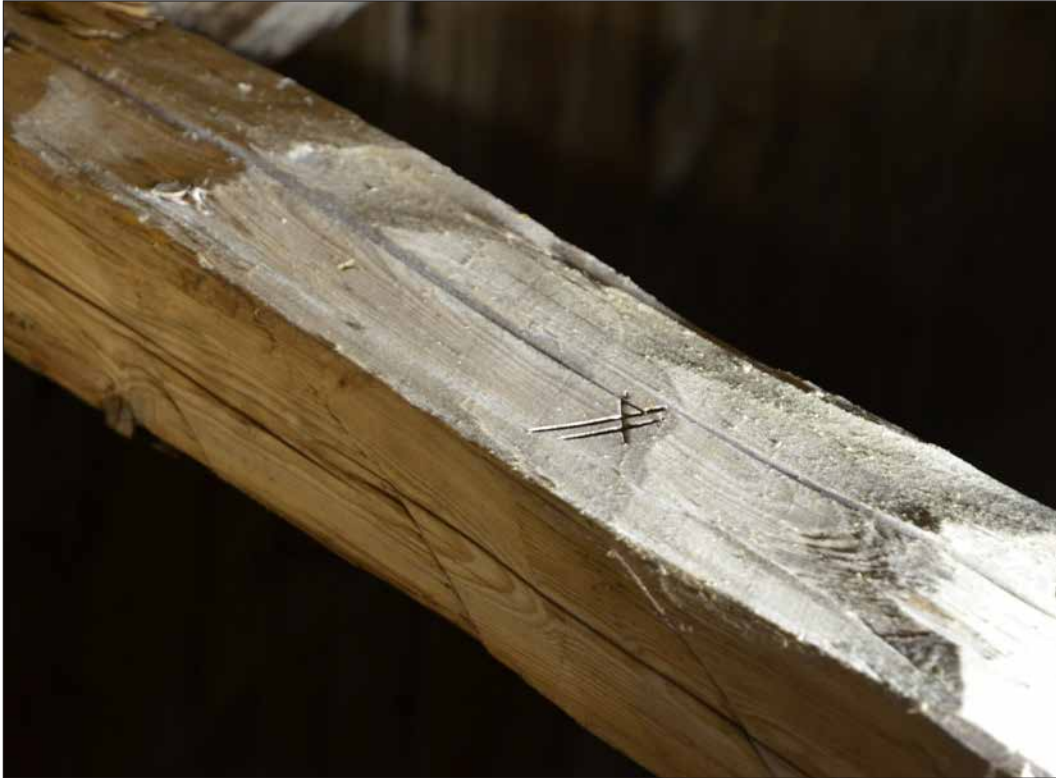
Timmermansmärken är utförda i form av runor, romerska siffror och symboler (SLM D2015-1462).
