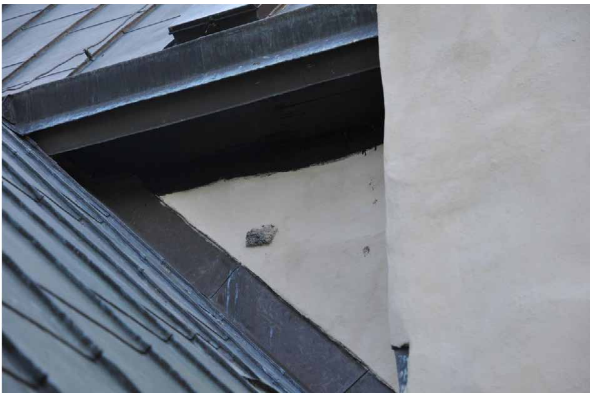
Utvändigt på norra korväggen syns resterna av en bindbjälke. Fotografi: Daniel Eriksson
