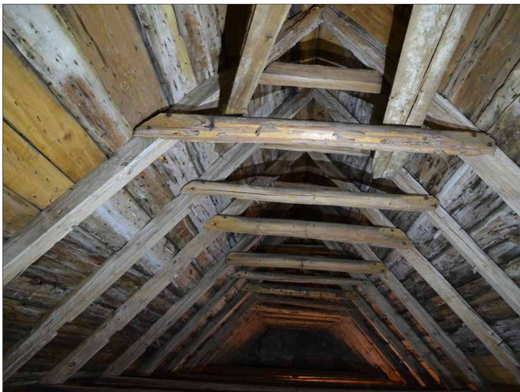
Långhusvinden sedd mot öster. Sprätthuggna högben med urtag för stödben och dymlingar för infästning av taktrö. Delar av taktrö är sprätthuggen och fastdymlad i högbenen (SLM D2015-1505).
