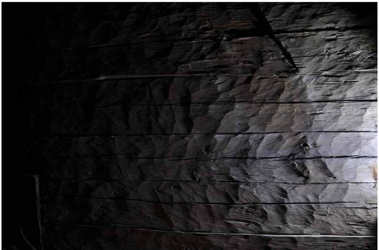
Exempel på huggspår. Man tycks ha arbetat med timret på låg höjd och en yxa med överställt skaft. Huggspåren går i svagt diagonala band bakåt mot huggaren, men man har arbetat sig framåt. Dessa teorier kan dock vara lätt att missta sig på utan att göra ett praktiskt experiment. Fotografi: Daniel Eriksson
