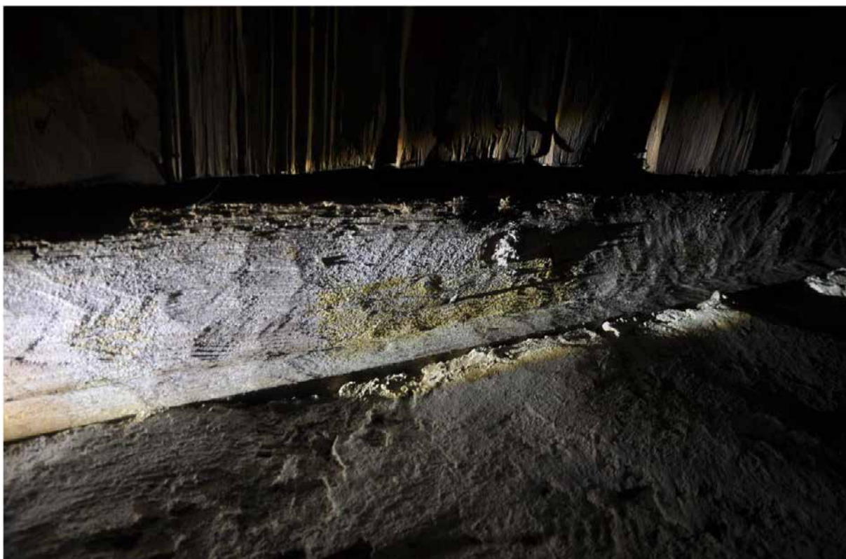
På undersidan av den L-formade takutsprängsbrädan kan man ana sprätthugning. Fotografi: Daniel Eriksson
