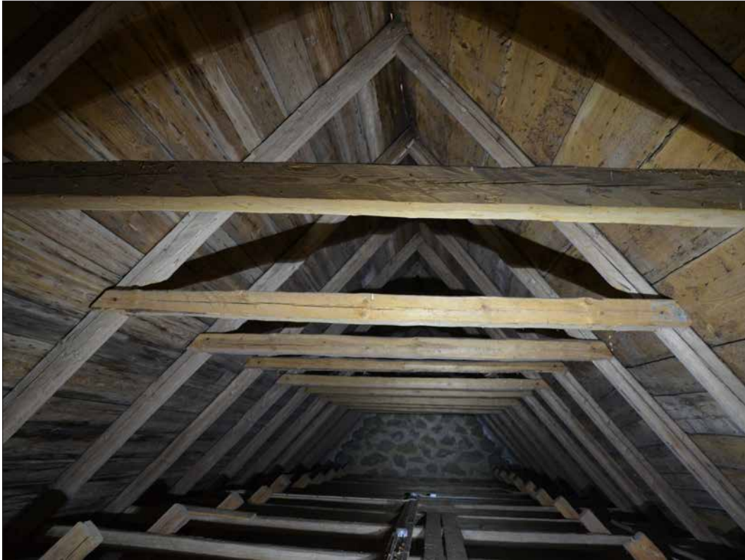
Takstolen över långhuset. Taklaget tillkom 1517 eller strax därefter enligt utförd dendrokronologisk analys (SLM D2015-1368).
