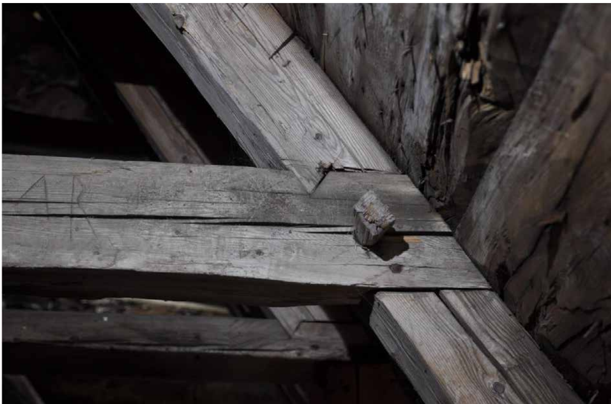
Hanbjälkarna har knut med nacke. Övriga knutpunkter är raka, genomgående bladningar, alla med dymlingar. Fotografi: Daniel Eriksson
