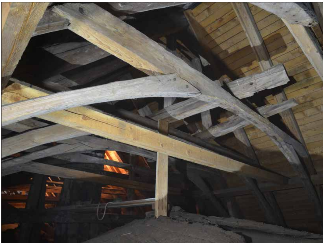
Tunnvalvstakstolen sedd mot öster (SLM D2015-1492).
