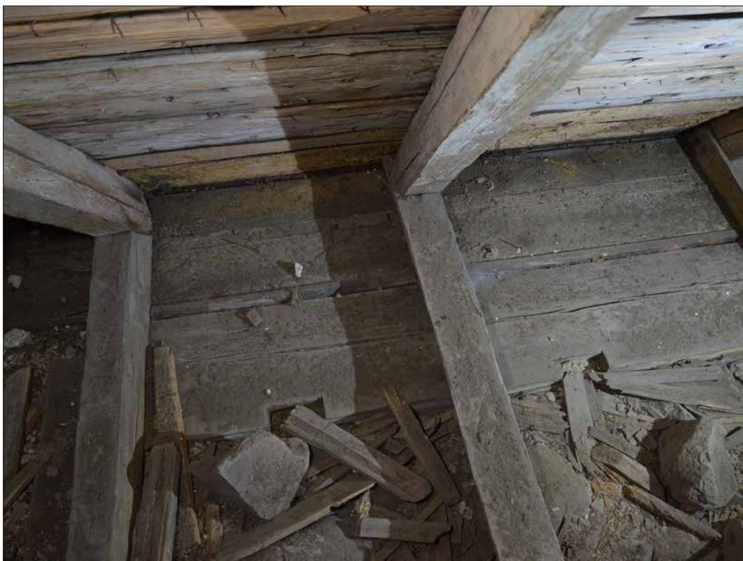
Det yttre remstycket längst i väster på norra sidan har urtag, antagligen efter bindbjälkar, vilket indikerar att det varit ett väggband (SLM D2018-0003).
