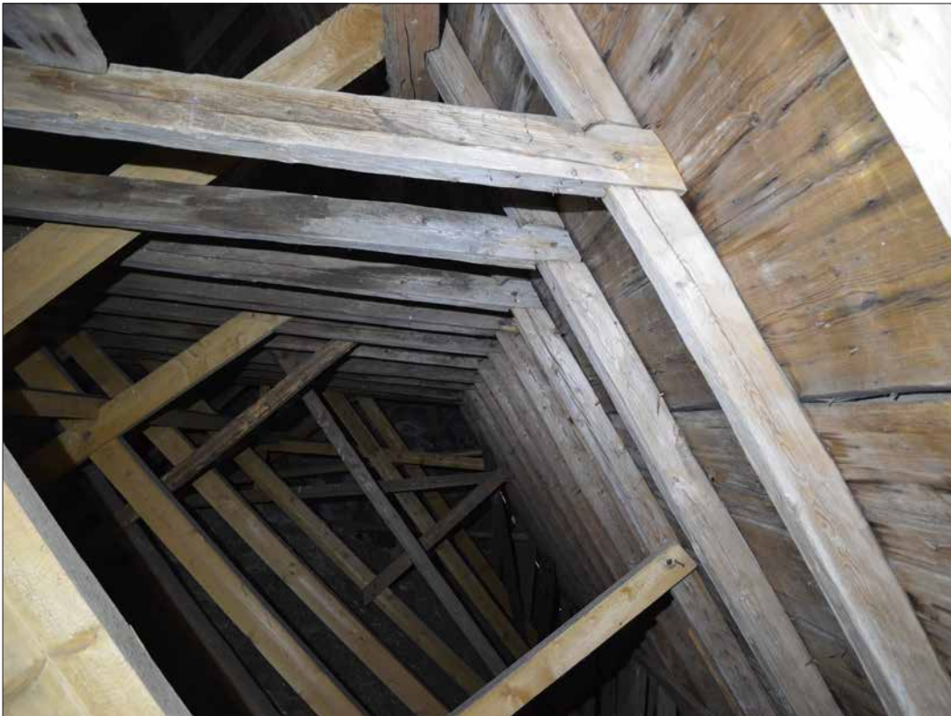
Mötet högben-hanbjälke är utfört som bladning med nacke (SLM D2015-1392).
