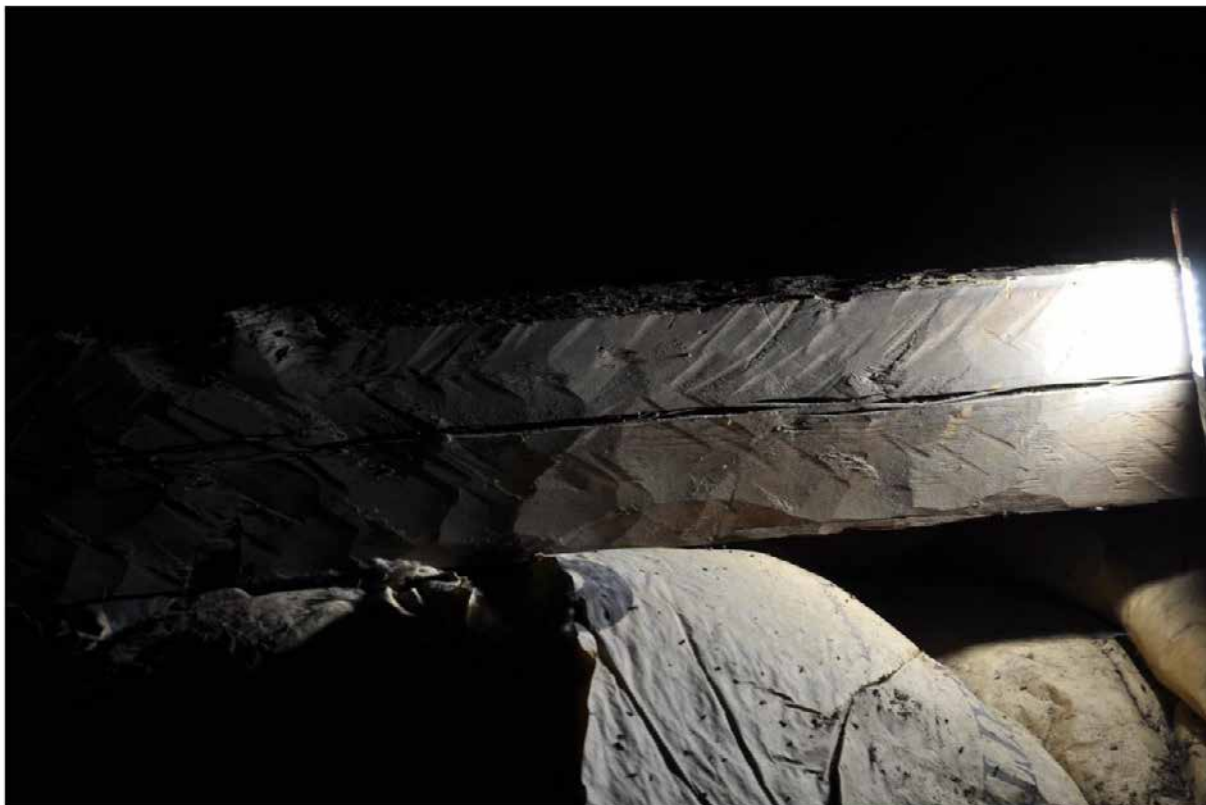
Exempel på behuggning, bindbjälke i västra delen. Flera av bindbjälkarna har trapetsform, de är bredare i nederkant än i överkant. Fotografi: Daniel Eriksson
