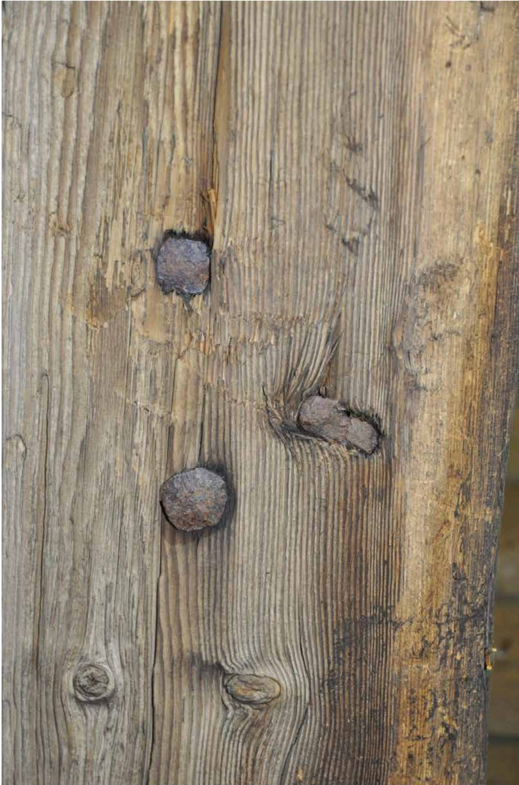
En av de tre spikarna har en skalle med annorlunda form. Denna typ ser man ganska ofta i medeltida byggnader, ofta i kombination med en "vanlig" spik. Även här syns det ljusare fältet till höger. Fotografi: Daniel Eriksson
