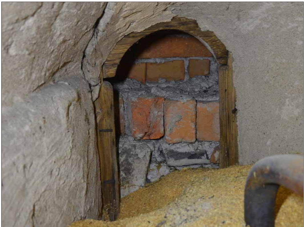
Romanskt fönster i långhusväggen på vapenhusets vind. (SLM D2015-1425).
