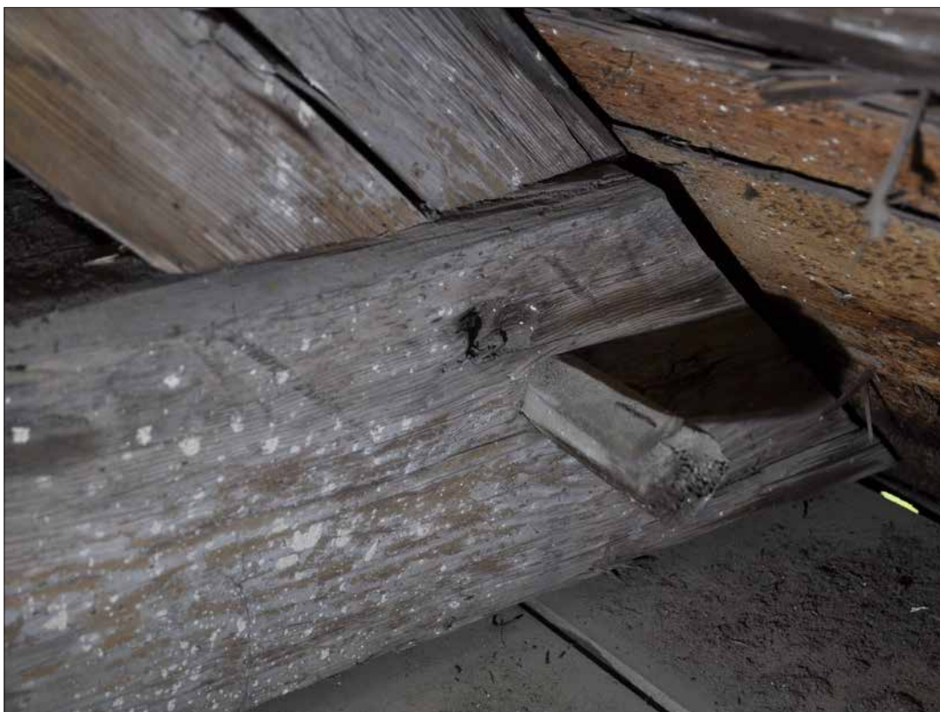
Snett ovanför dymlingen syns två grunda borrhål som går i varandra. Troligen har de uppstått då takstolen använts som mall. Malltakstolen har legat på marken och övriga har tillverkats ovanpå. Vid borring har man råkat borra in i "mallen" (SLM D2015-1516). Daniel Eriksson.
