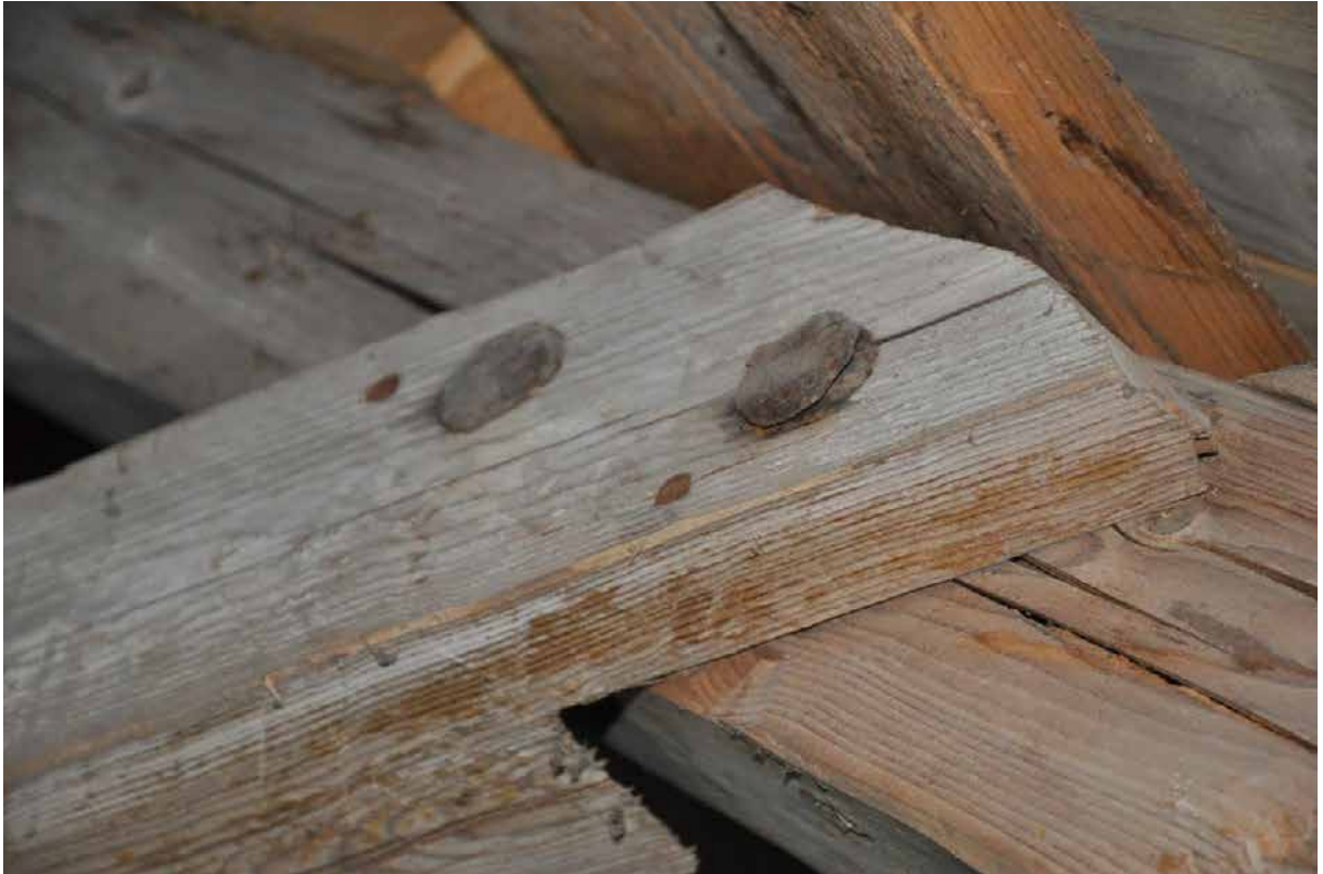
Många sprätthuggna delar sitter återanvända. Här spikad med något som kan vara återanvänd romansk dekorationsspik. Stora platta skallar. Fotografi: Daniel Eriksson
