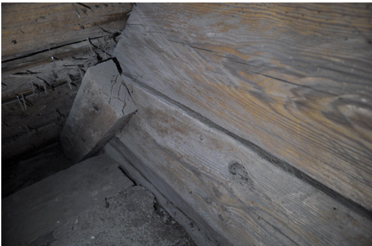
Vankant tycks finnas på andra stockens södra ände. Kan vara svåråtkomligt för dendroborrning p.g.a. taket. Fotografi: Daniel Eriksson
