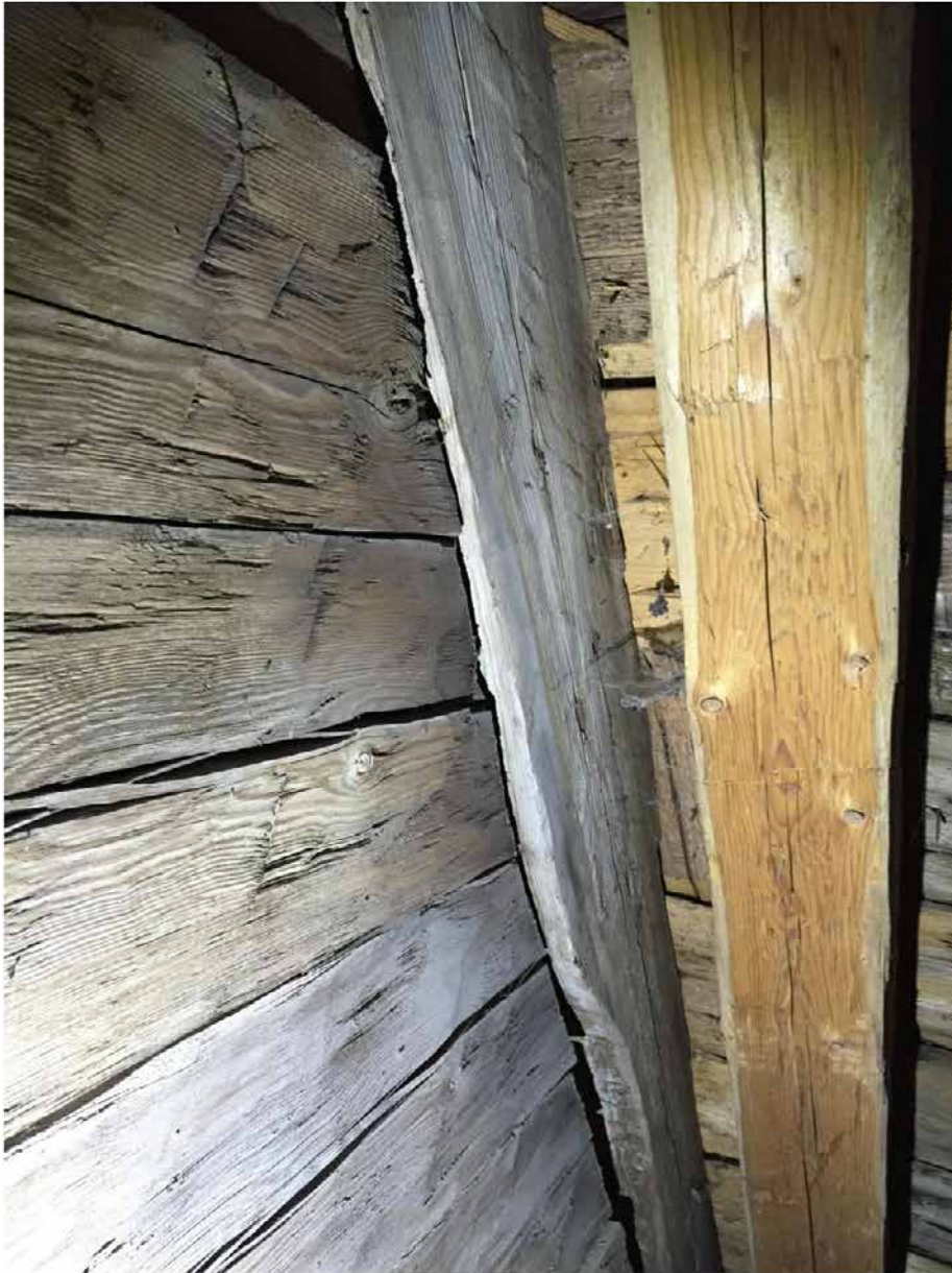
I röstets kanter ligger högbenen infällda i en fals. Notera urtaget i norra högbenets nedre del. Detta finns ej i det södra högbenet. Fotografi: Daniel Eriksson
