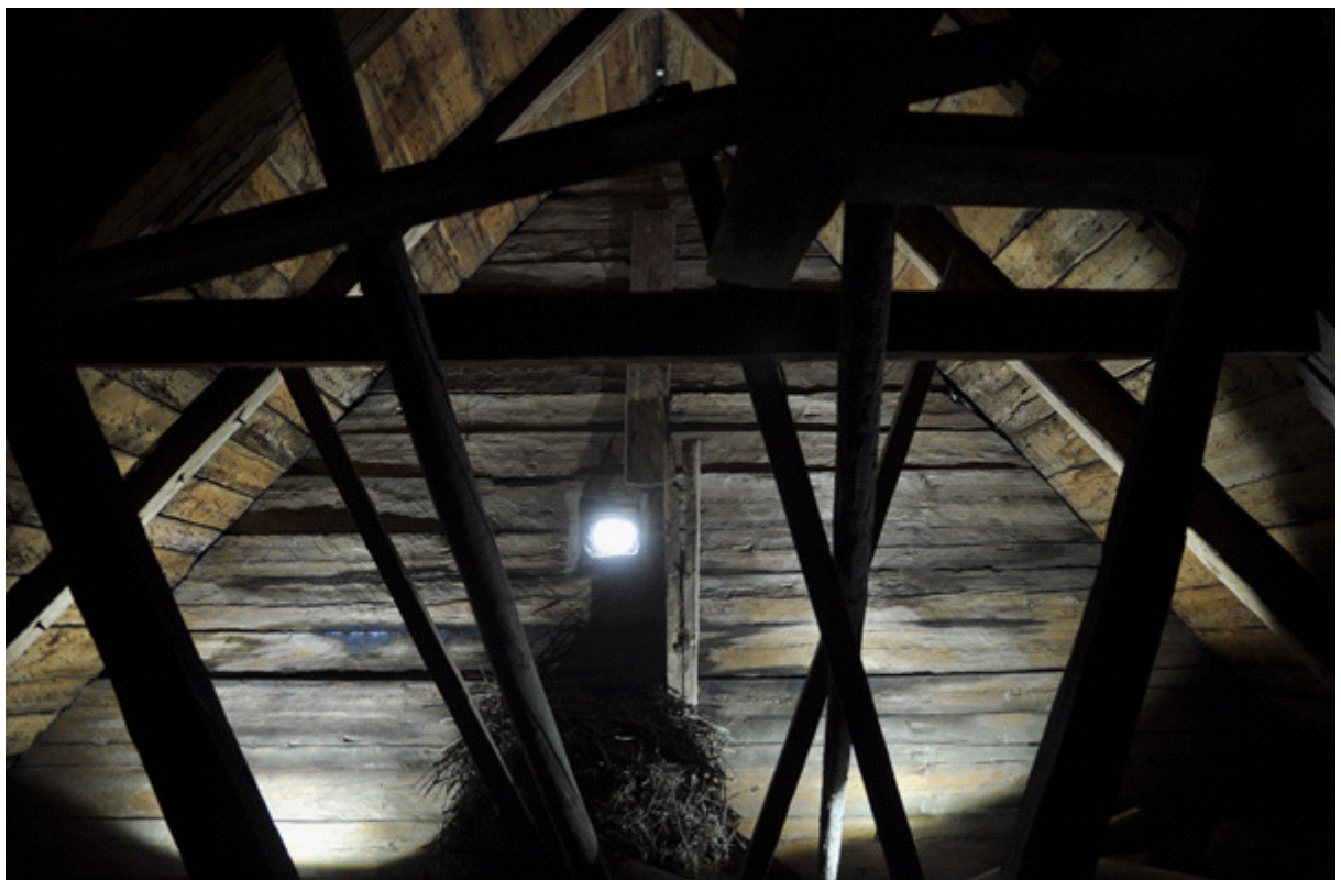
Västra gaveln består av ett timrat röste. Röset består av 19 varv sprätthugget och skarpkantigt timmer, med en genomsnittlig stockhöjd på 197mm. Där finns en ljusöppning, något förskjuten i sidled för att ge plats åt det bågknä i ek, som stabiliserar röset. Ljusöppningen täcks av ett nät som försvårar undersökningen. Om nätet demonteras kanske man kan avgöra om öppningen gjorts i samband med timringen, eller huggits upp i efterhand.
