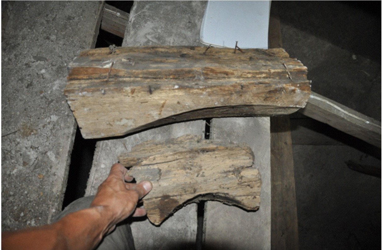
På södra muren finns ett lösfynd i form av en bit av ennockå. Jämfört mednockåsen i långhuset (överst i bild) är den utförd i en mindre dimension och en mindre radie på decorationen. Med stor sannolikhet har det funnits även ennockå i "tornet". Det mest troliga är nog attnockåsen demonterats och att högbenen sedan sammanfogats med varandra. Det kan också vara så att högbenen ursprungligen varit sammanfogade ochnockåsen varit nedfälld över takstolarna. Fotografi: Daniel Eriksson
