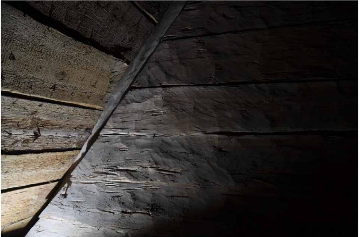
Man kan ana att behuggningen ändrar karaktär nära timrets ändar. Detta tyder på att även taklutningen huggits till färdigt mått innan timrets sidor bearbetats. Fotografi: Daniel Eriksson
