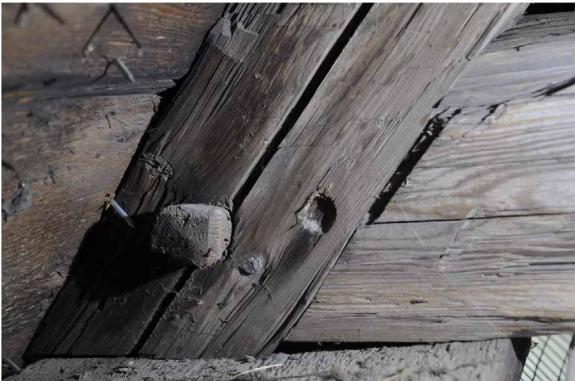
Knutpunkt tass/högben. Till höger om dymlingen syns ett grunt borrhål. Troligen har det tillkommit vid tillverkningen av takstolarna då man använt takstolen på bild som mall. Man har sammanfogat de andra takstolarna uppe på denna. När man borrar hålet för dymlingen har man borrar för djupt och gått ned i underliggande malltakstol. Mycket vanligt under den sena medeltiden. Fotografi: Daniel Eriksson
