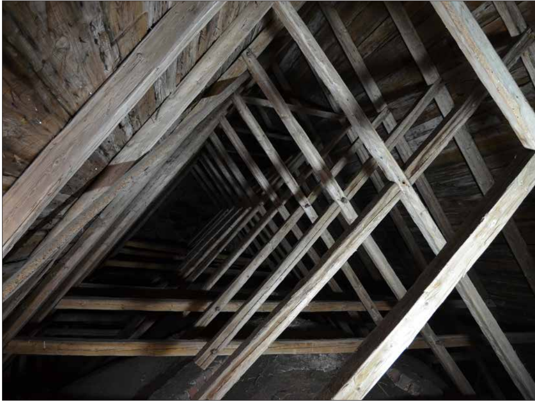
Långhusets takstolar (SLM D2015-1460).
