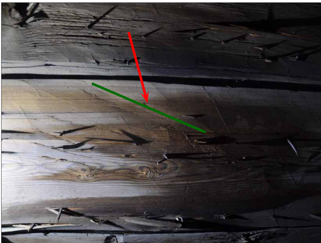
Taktrö med spår av samma behuggningsteknik men spegelvänt. Taktron är med största sannolikhet samtida med taklaget. Det har alltså varit en vänster-och en högerhänt timmerman med samma typ av yxa eller en dubbelhänt timmerman (SLM D2015-1522). Foto: Daniel Eriksson.
