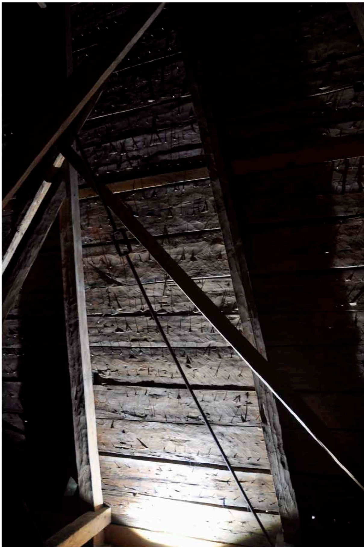
En stor del av den ursprungliga taktron finns bevarad. Fotografi: Daniel Eriksson
