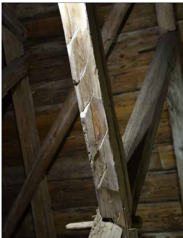
Detalj av en saxsparres undersida med upplättningshugg (SLM D2015-1459).
