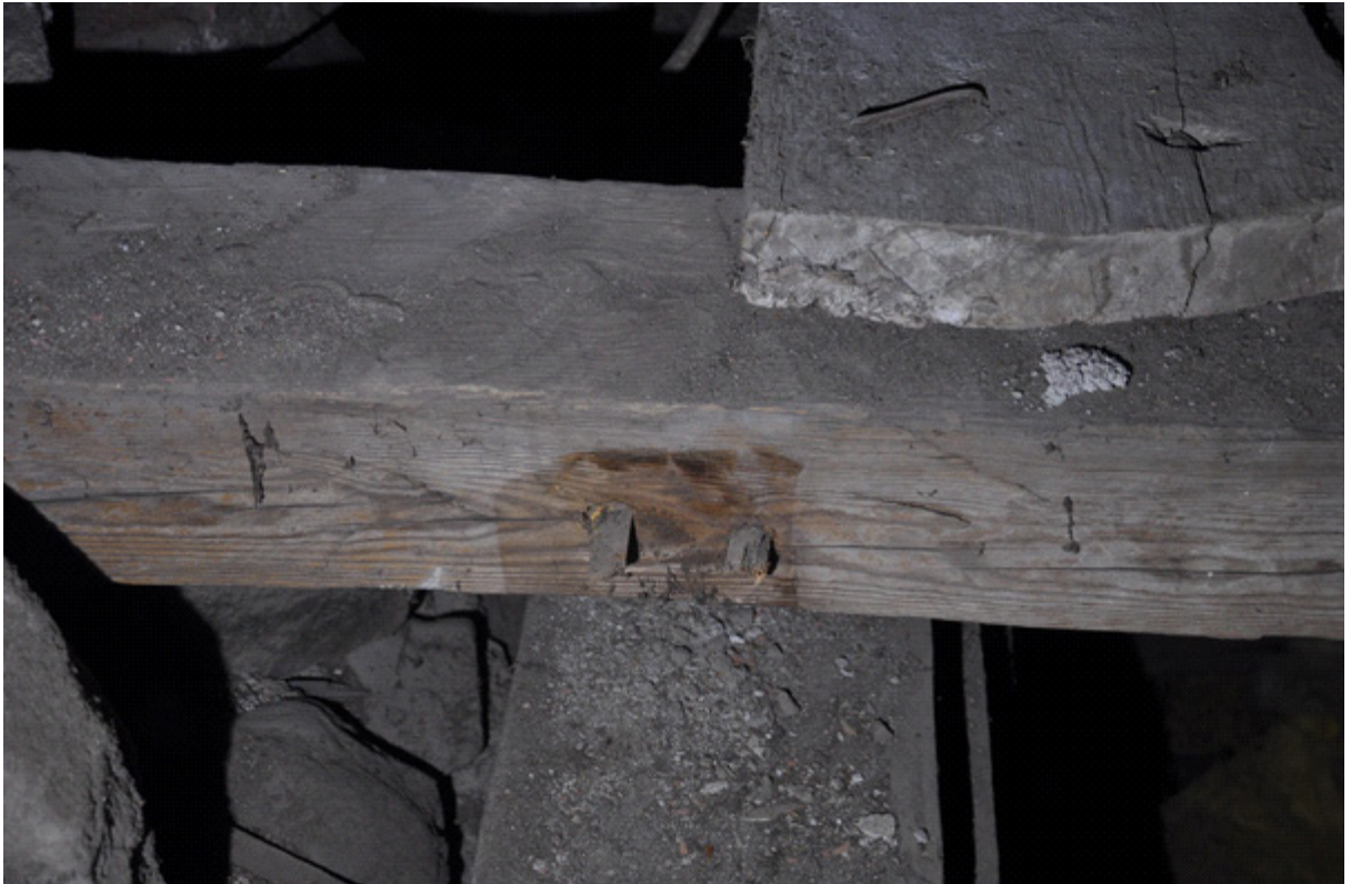
Bindbjälke 2 och 5 har avtryck/urtag för någon form av stödben som riktat sig ned mot kyrkorummet. Avtrycken befinner sig närmast intill muren i vardera änden på de två bindbjälkarna. Fotografi: Daniel Eriksson
