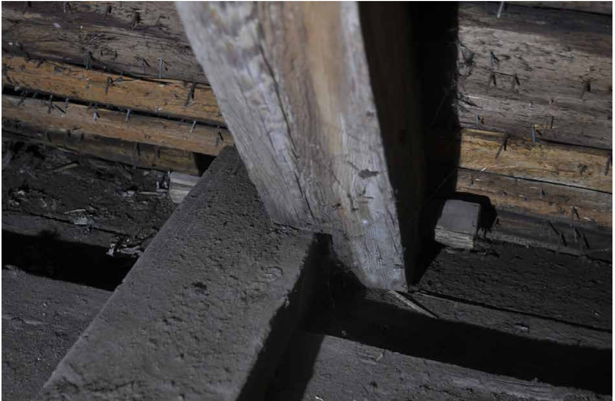
Här med blad endast i högbenet/sparren. Kraftig dymling med kil i baksidan. Bindbjälkarna har ett ungefärligt cc på 95cm. Dimensionerna är ca B: 160mm, H: 185mm. Fotografi: Daniel Eriksson
