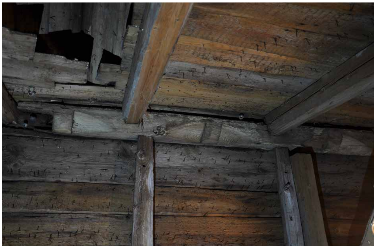
Nockåsens östra ände. Högbenens intappningar är förskjutna. Fotografi: Daniel Eriksson
