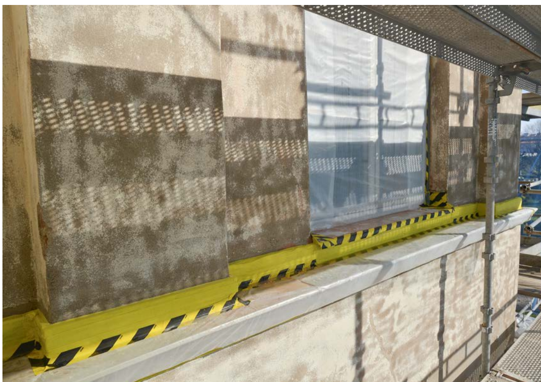
Bild 17. Blåstrade fasader på Tungelska gravkoret. Foto 2020-04-23. SLM D2020-0648.
