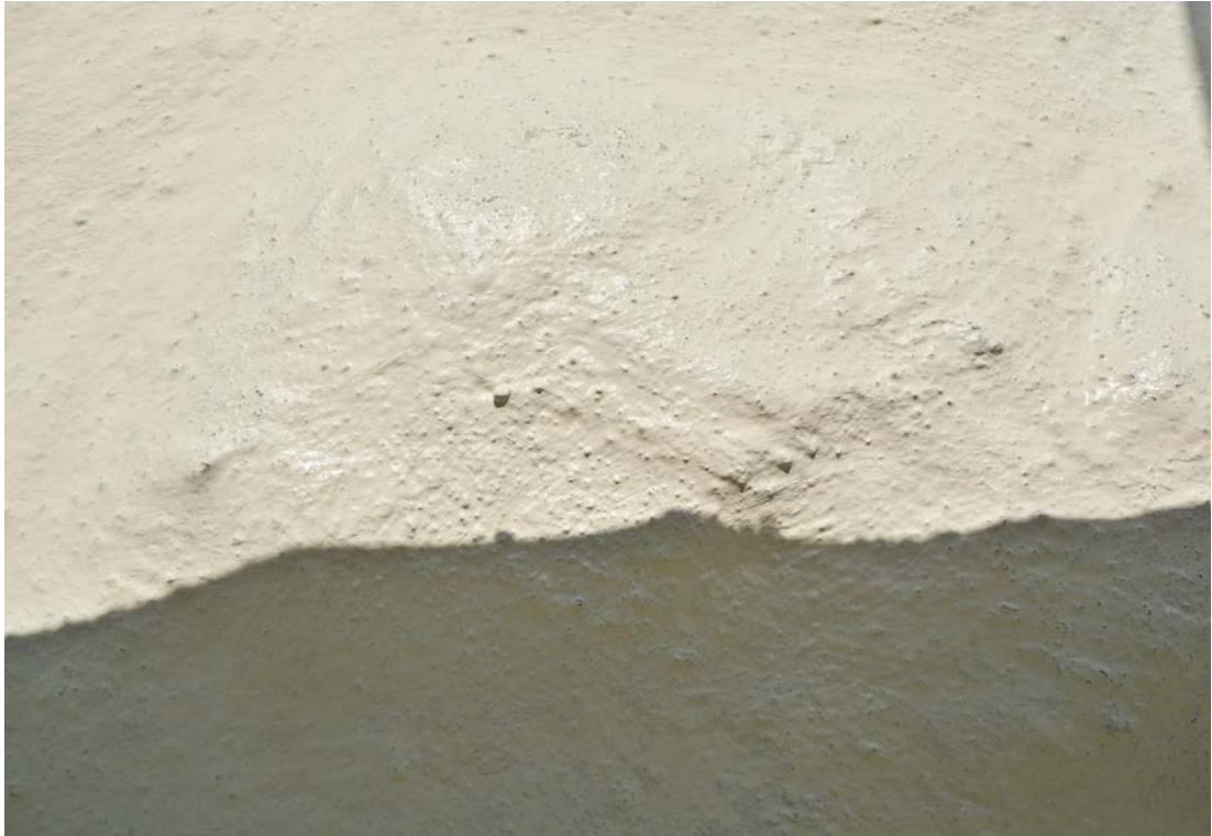
Bild 21. Pågående avfärgning av fasader. Foto 2020-05-14. SLM D2020-0652.
