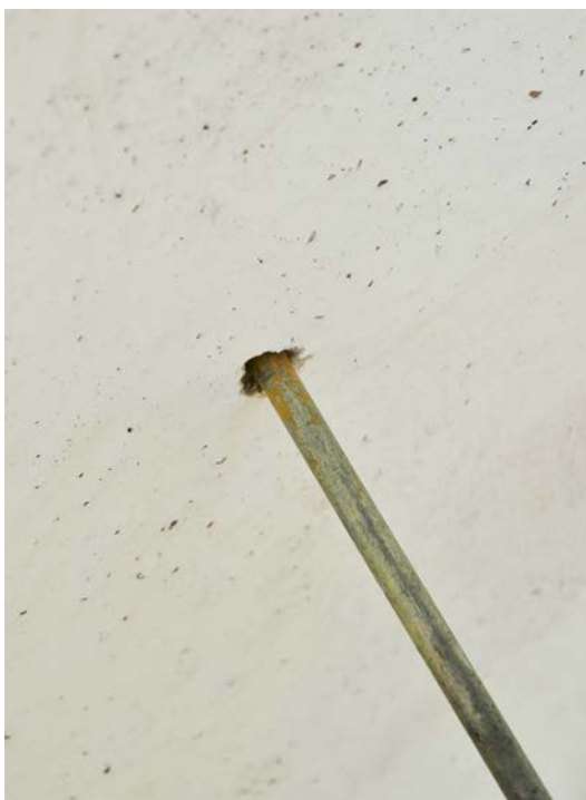
Bild 15. Infästning i fasaden för byggnadsställning. Foto 2020-05-14. SLM D2020-0646.
