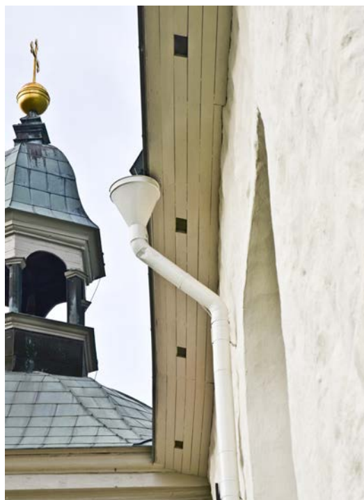
Bild 30. Långhusets/korets takfot, efter avslutad målning. Foto 2020-10-27. SLM D2020-0662.
