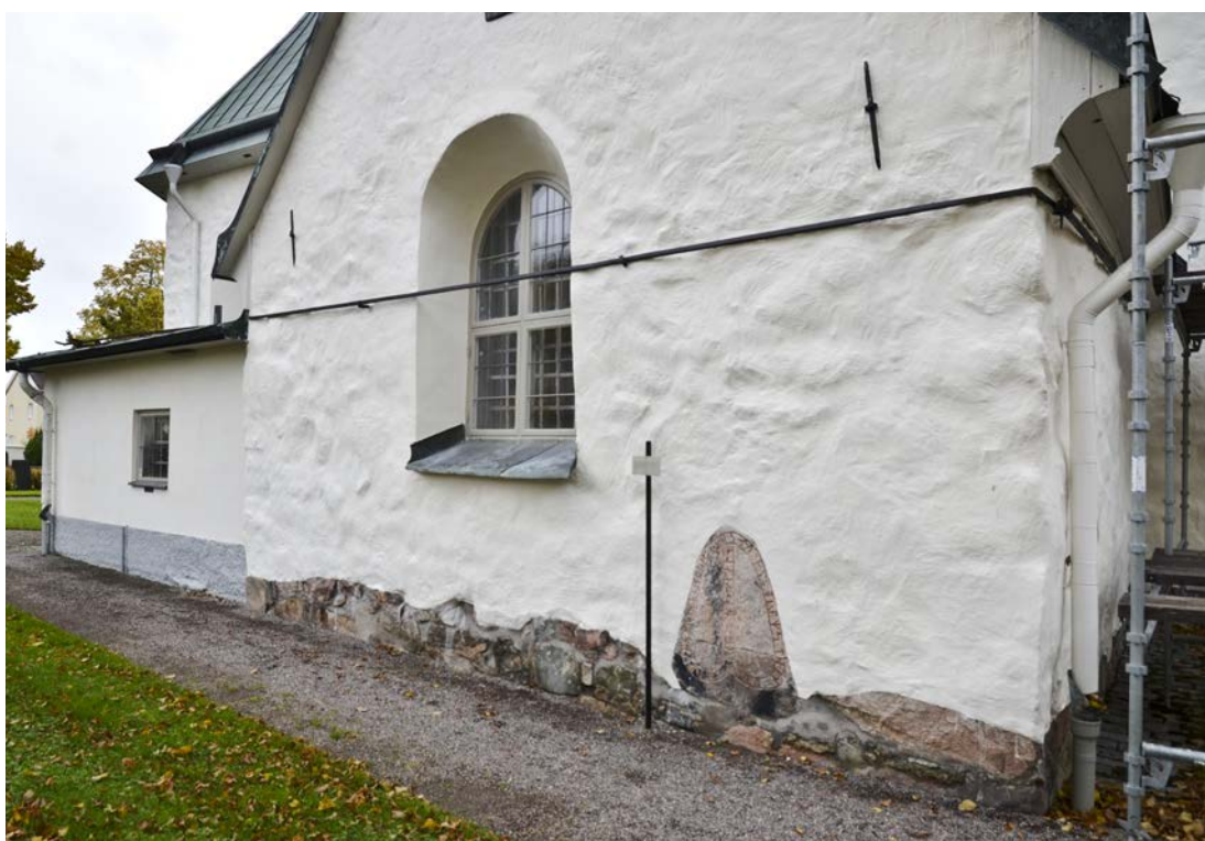
Bild 23. Sakristian, efter avslutade arbeten: fasadrenovering, fönsterrenovering, målning av smidesjärn samt avfärgning av tillbyggnadens (f.d. pannrummets) sockel. Foto 2020-10-27. SLM D2020-0654.
