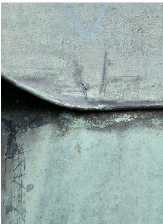
Bild 24. Utkastare vid fotrännan på långhusets norra takfall, innan lödning. Foto 2020-05-05. SLM D2020-0655.
