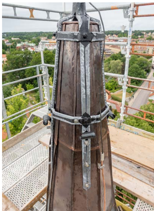
Bild 38. Spirans infästning i takryttaren, efter avslutad renovering. Foto 2020-07-01. SLM D2020-0667.
