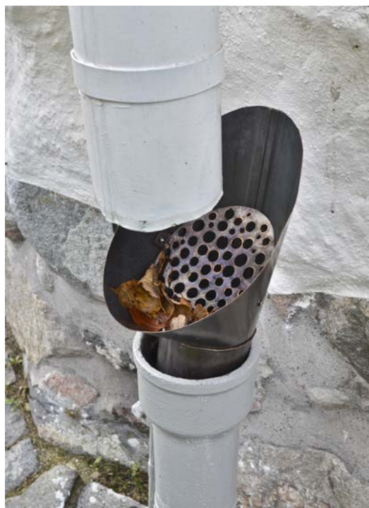
Bild 32. Nymålade stup- och markrör samt ny tratt. Foto 2020-10-27. SLM D2020-0664.
