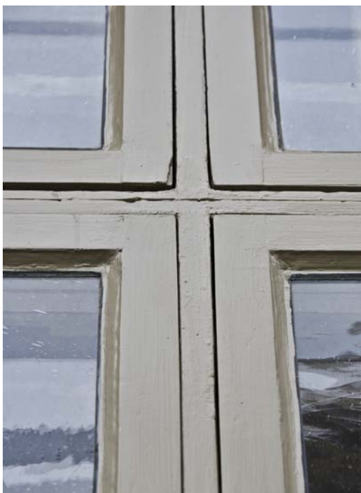
Bild 29. Fönster på långhusets norra fasad, efter avslutad renovering. Foto 2020-10-27. SLM D2020-0661.
