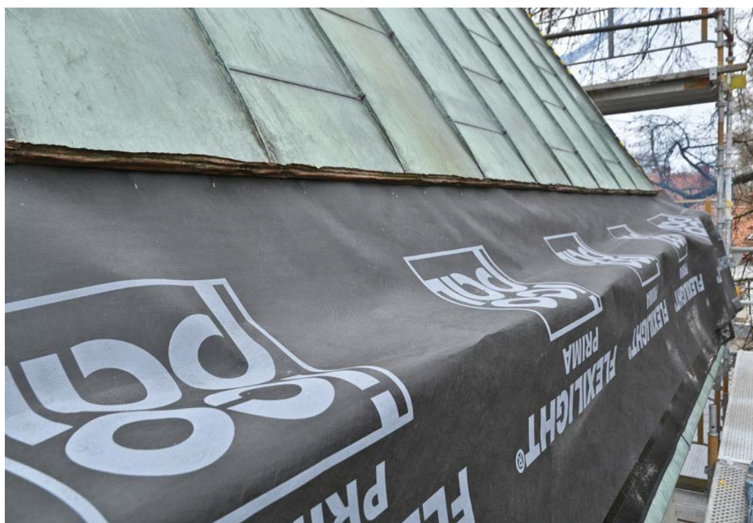
Bild 26. Pågående lagning av norra takfoten på långhuset. Foto 2020-05-05. SLM D2020-0658.
