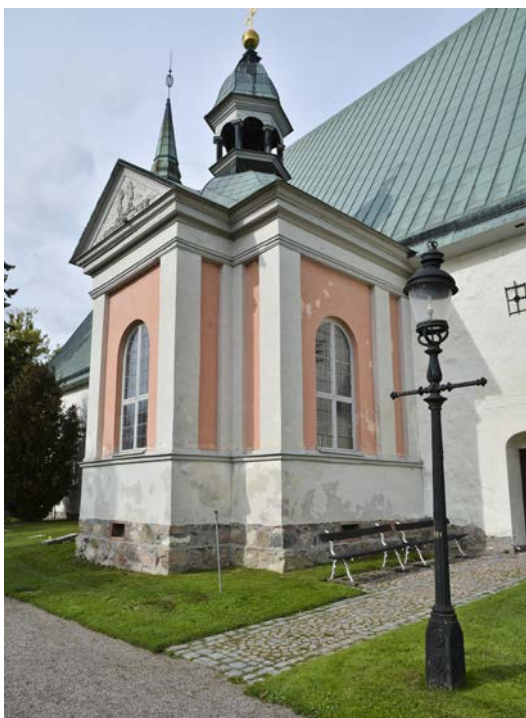
Bild 10. Tungelska gravkoret innan renovering, vy mot nordost. Foto september 2019. SLM D2020-0641.
