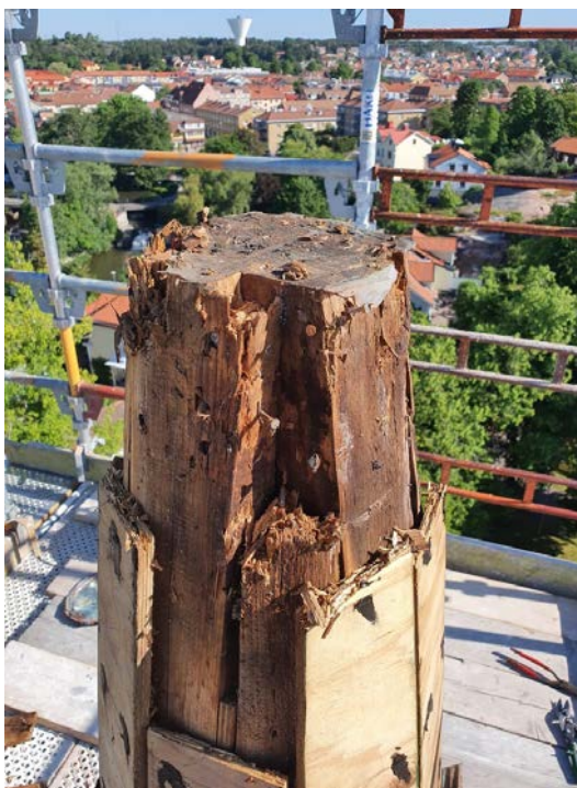
Bild 37. Takryttarens topp, innan påbörjad trälagning. Foto: Nyköpings Plåt & Fasad.
