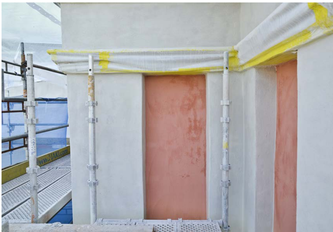
Bild 22. Pågående avfärgning av Tungelska gravkorets fasader. Foto 2020-05-14. SLM D2020-0653.
