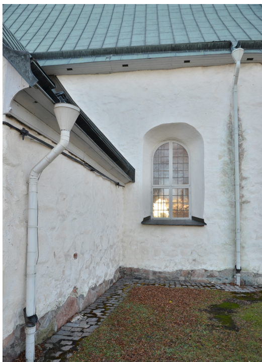
Bild 7. Långhusets norrfasad och sakristian innan renovering. Foto 2020-01-22. SLM D2020-0638.
