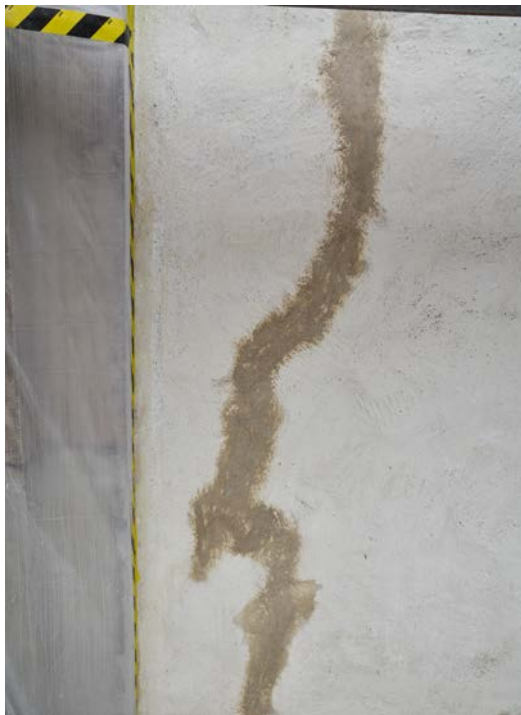
Bild 19. ... och putslagades med lufthårdnande kalkbruk.
