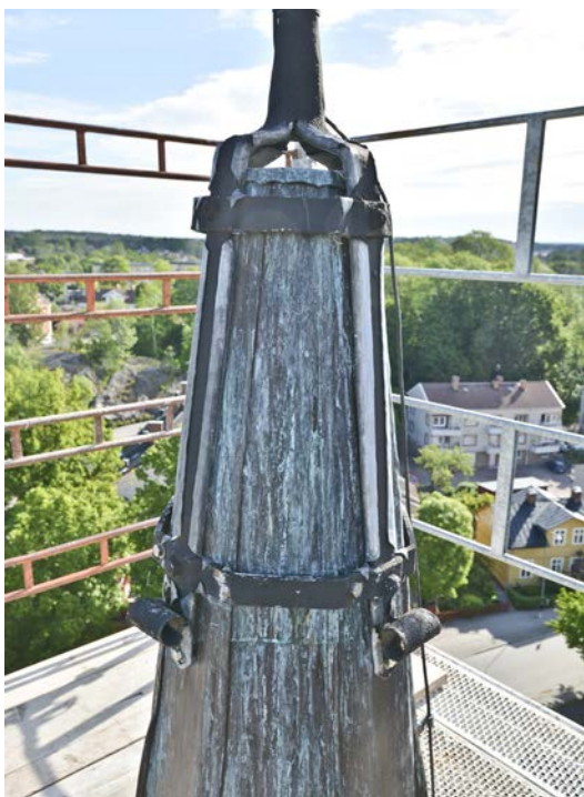
Bild 35. Spirans infästning i takryttaren, innan påbörjad renovering. Foto 2020-06-09. SLM D2020-0666.
