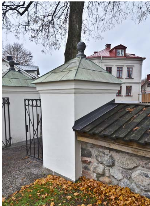
Bild 40. De fyra grindstolparna mot Östra torget puts- lades och avfärgades med silikatfärg. En ny vattbräda mellan grindstolpen och murkrönet monterades. Foto 2020-11-13. SLM D2020-0701.
