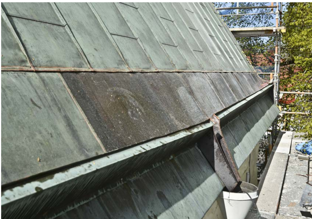
Bild 28. Norra takfallets fotränna och utkastare, efter avslutade arbeten. Foto 2020-05-14. SLM D2020-0660.
