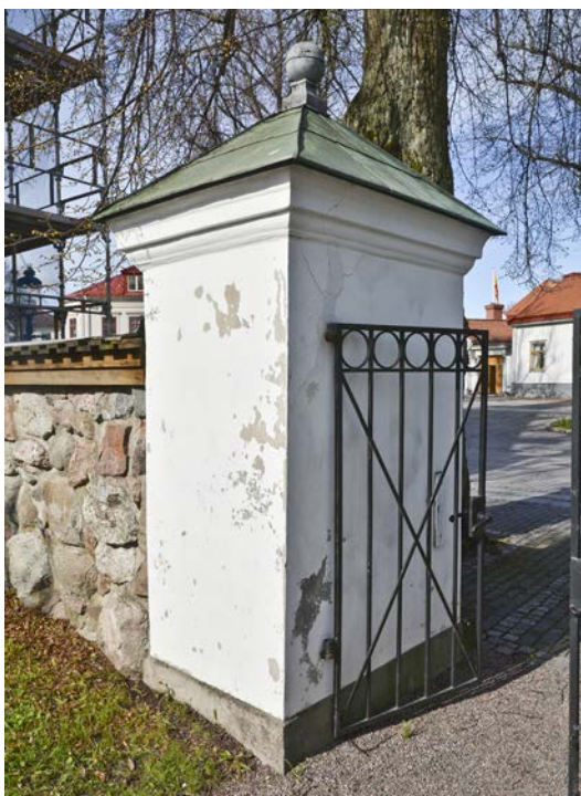
Bild 12. En av grindstolparna innan renovering. Foto 2020-05-05. SLM D2020-0643.
