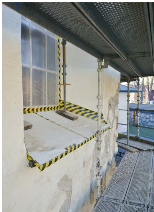
Bild 16. Pågående putslagningar vid koret. Foto 2020-04-23. SLM D2020-0647.
