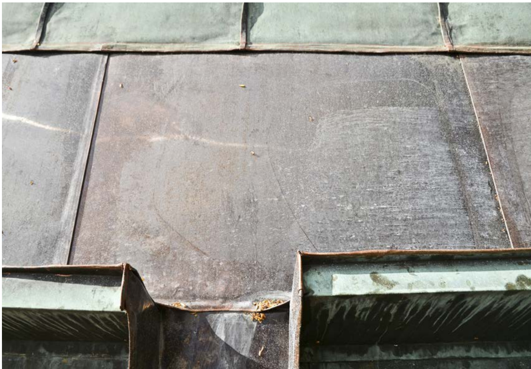
Bild 27. Plåtlagningar vid en av utkastarna på norra takfallet, efter avslutade arbeten. Foto 2020-05-14. SLM D2020-0659.
