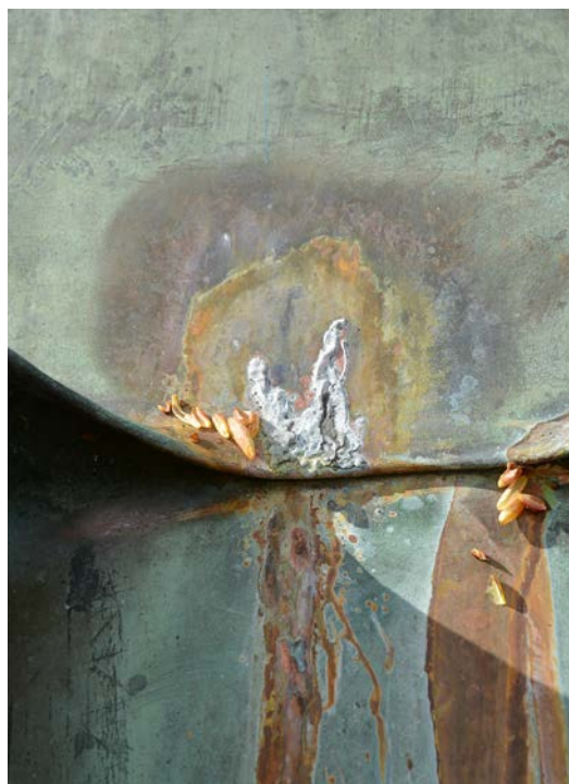
Bild 25. Utkastare vid fotrännan på långhusets norra takfall, efter lödning. Foto 2020-05-14. SLM D2020-0656.
