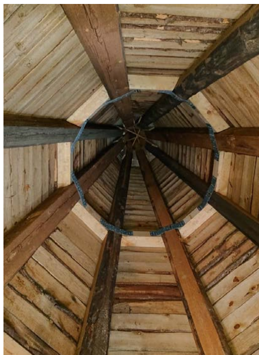
Bild 36. Takryttarens insida var i gott skick och lämnades utan åtgärd. Foto: Nyköpings Plåt & Fasad.
