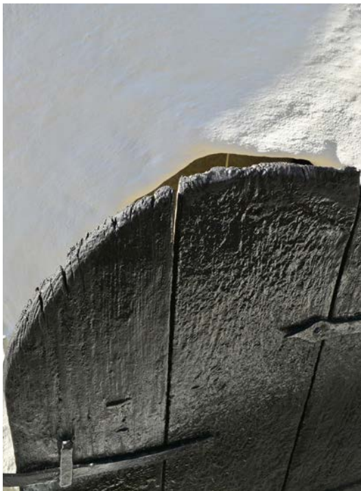
Bild 39. Fasadluckan i sakristians gavel efter tjärning. Foto 2020-06-03. SLM D2020-0701.
