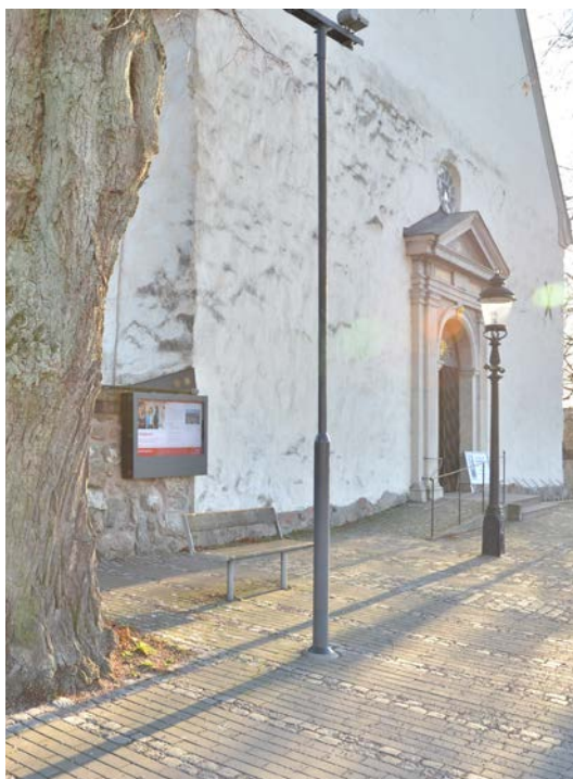
Bild 6. Östgaveln innan renovering. Foto 2020-01-22. SLM D2020-0638.
