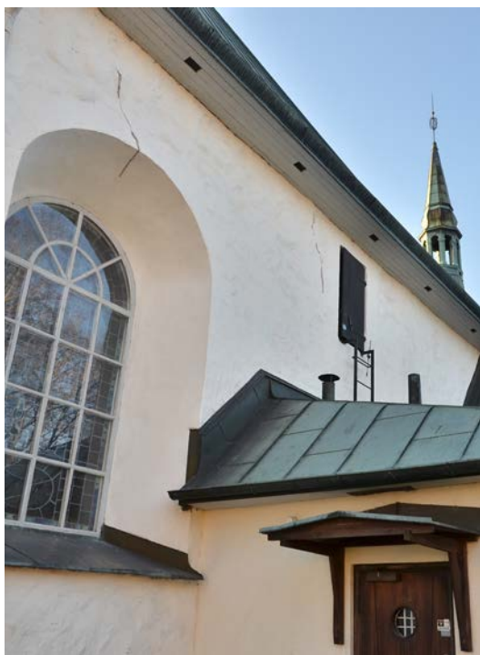
Bild 8. Långhuset och sakristian innan renovering. Foto 2020-01-22. SLM D2020-0639.
