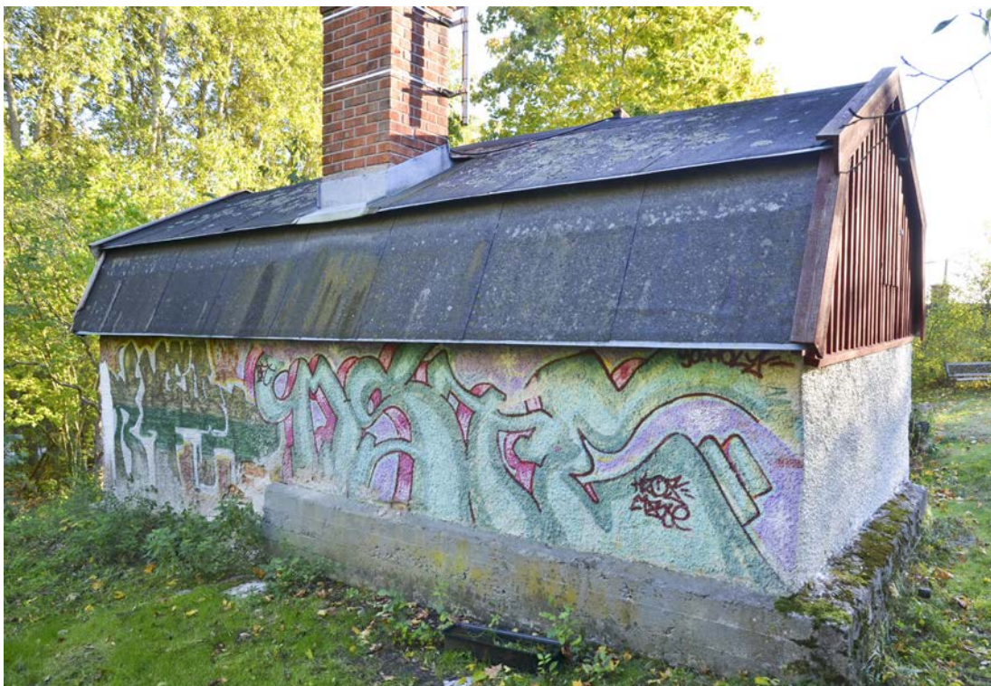
Bild 32. Norra stugans nordvästra fasader. SLM D2021-0495.
