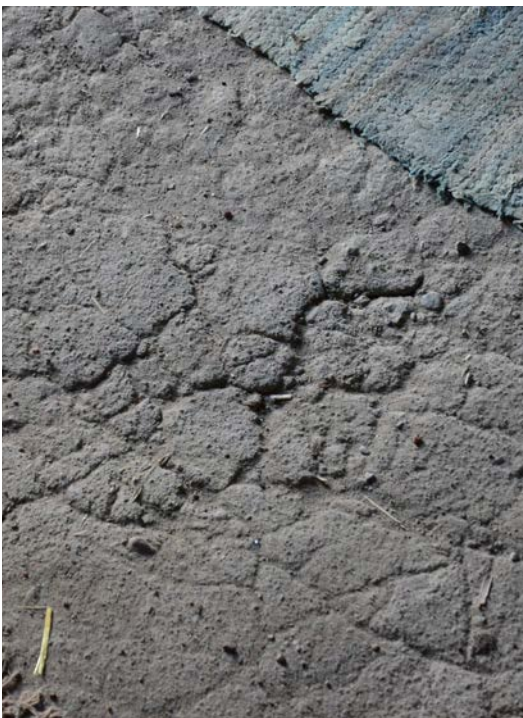
Bild 39. Grovputsat lergolv i rum 201: entréutbyggnad. SLM D2021-0502.
