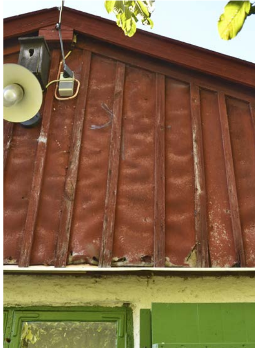
Bild 20. Gavelröstet mot öster med locklister på rödfärgad masonite. SLM D2021-0483.
