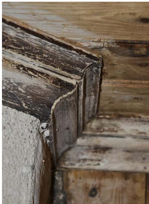
Bild 40. Profilerad taklist i rum 203: kammare. SLM D2021-0503.
