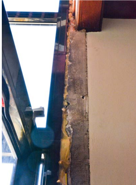
Bild 17. Karmarna monterades inifrån. Skarven mellan murverket och aluminiumkarmen drevades med mineralull. SLM D2020-0533.
