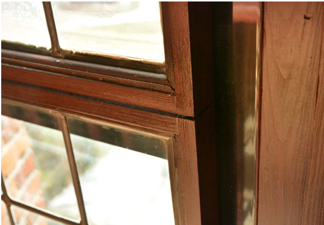
Bild 24. Närbild av träbågarna med infällda blyfönster, som hålls på plats av kvartsstavslister. SLM D2020-0540.
