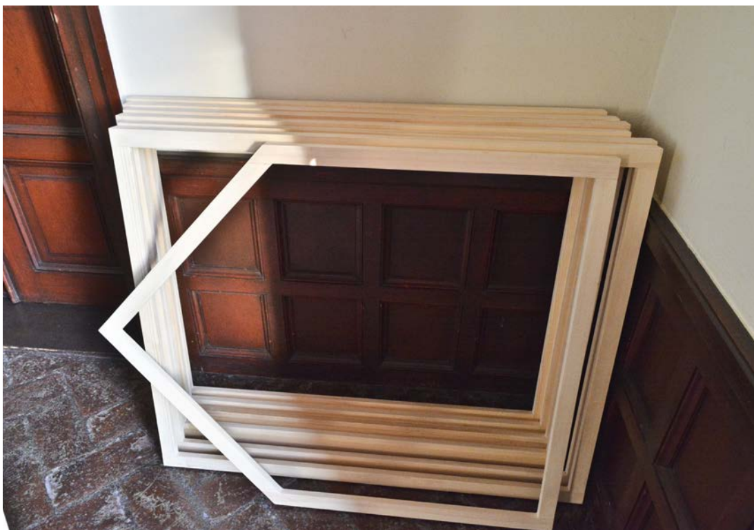
Bild 21. Specialtillverkade träbågar med traditionella infästningar (tapp, slits och träplugg utan lim). SLM D2020-0537.
