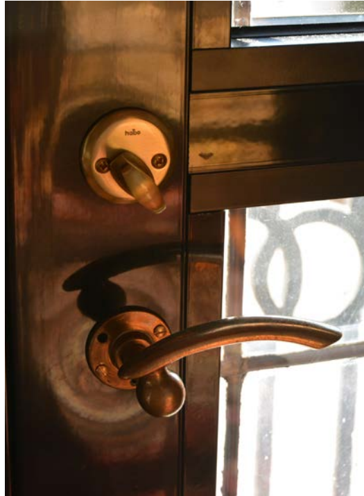
Bild 27. Nya handtag i mässing, som till viss grad efterliknar de befintliga handtagen. SLM D2020-0543.
