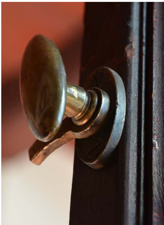
Bild 10. Låsvred i mässing på dörrarna. På varje dörr satt två stycken vred. Dessa togs bort men sparades. SLM D2020-0527.
