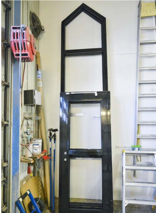
Bild 16. De nya dörr- och fönsterkarmarna i svart aluminium anlände till verkstaden i oktober. Notera att dörren står framför fönsterramens nedre del. SLM D2020-0532.
