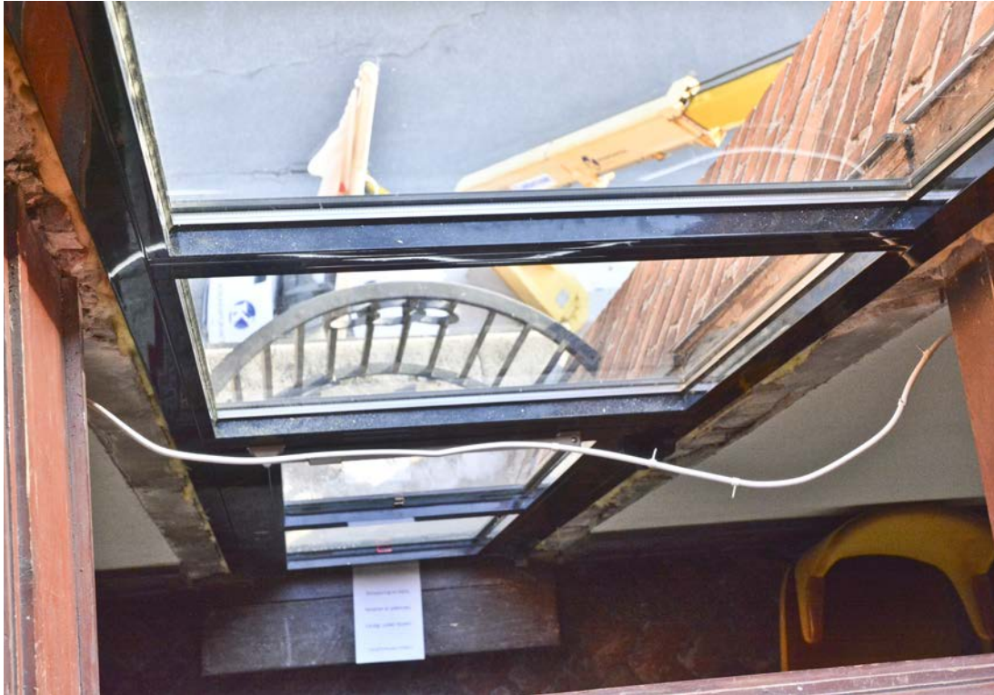
Bild 22. Den nya aluminiumkarmen innan blyfönstren och fönsterfodren återmonterades. Vy från orgelläktaren. SLM D2020-0538.
