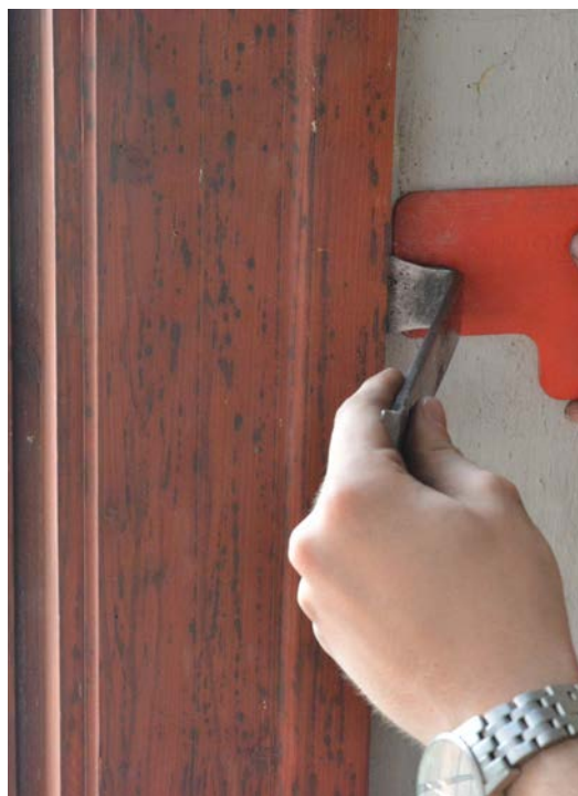
Bild 15. Befintliga dörr- och fönsterfoder avlägsnades varsamt och återanvändes. SLM D2020-0531
