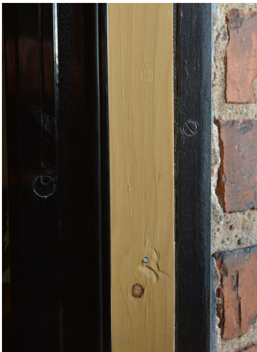
Bild 18. Mellan den nya aluminiumkarmen (till vänster) och den ursprungliga yttre järnkarmen spikades en tunn bräda för att ge bättre fäste och stadga åt vattplåten. SLM D2020-0534.
