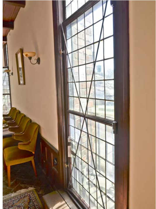
Bild 9. Vänstra balkongdörren, innan påbörjade arbeten. Vy mot öster. SLM D2020-0526.
