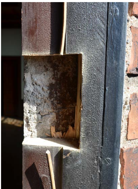
Bild 14. Provsnitt sågades ut ur karmen för att kontrollera passformen på den nya dörr- och fönsterkarmen. Därefter sågades hela insidan av karmen ur. SLM D2020-0530
