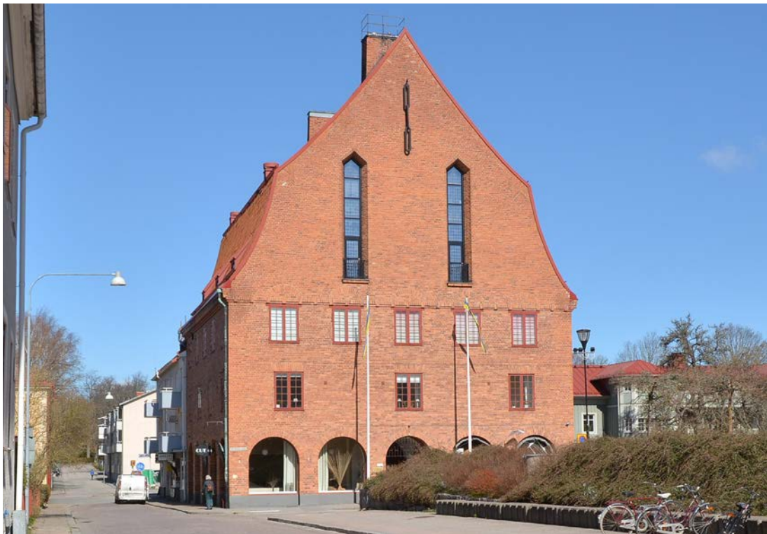
Bild 1. Odd Fellowhusets södra gavel, efter avslutade arbeten. SLM D2020-0519.
