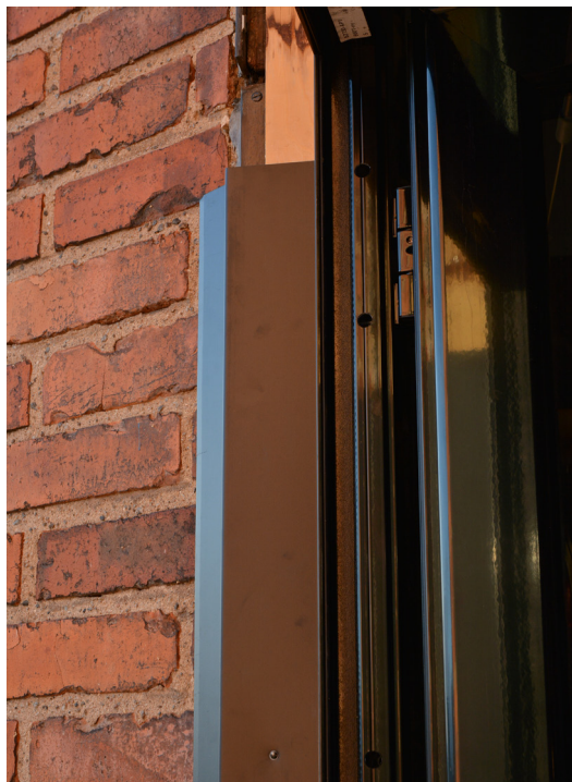
Bild 19. Fabrikslackerade svarta vattplåtar monterades med bleckspik med gummitätning. SLM D2020-0535.
