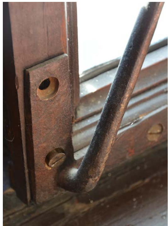
Bild 11. Ett av järnkorsens infästningar i dörren. Järnkorsen (ett kors på varje dörr) var enligt uppgift från Jonas Wärn inte ursprungliga. De förvaras nu i Odd Fellowhuset. SLM D2020-0548.
