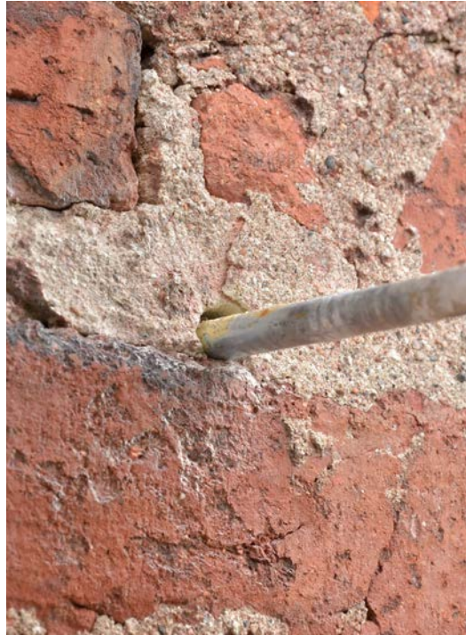
Bild 14. Borrhål med infästning för byggnadsställningen i tornets övre del. Foto: 2019-06-11 SLM D2020-0174.
