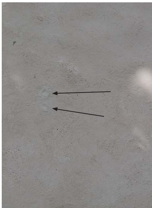
Bild 49. Borrhålen för byggställningen i kyrktornets putsade del fogades med hydrauliskt kalkbruk och avfärgades med kalkfärg. Foto: 2019-09-06. SLM D2020-0155.
