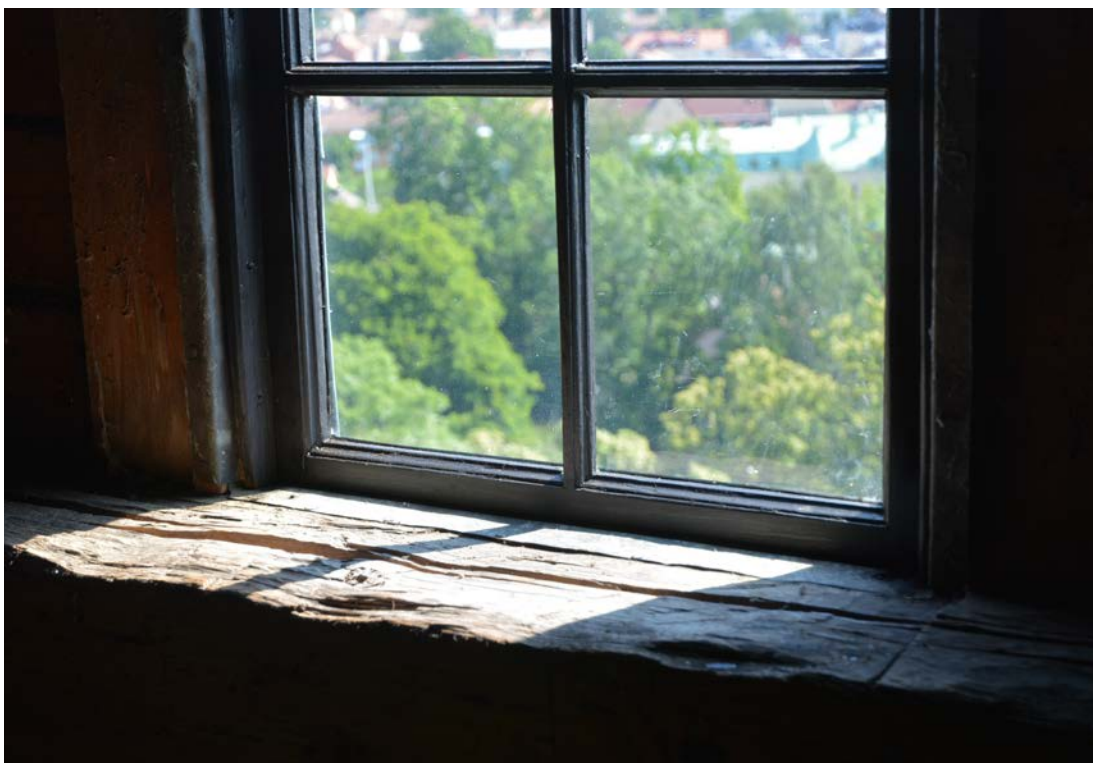
Bild 47. Fönster efter renovering. Foto: 2019-07-12. SLM D2020-0153.
