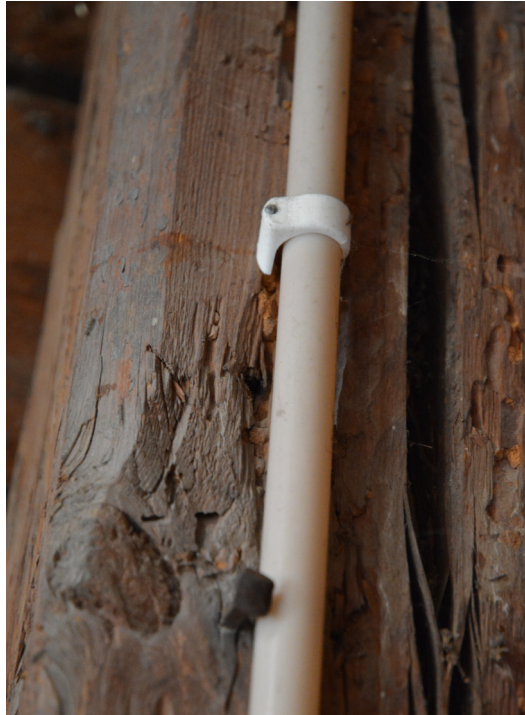
Bild 30. Nya elkablar monterades med kabelklamrar. Foto: 2019-07-12. SLM D2020-0136.
