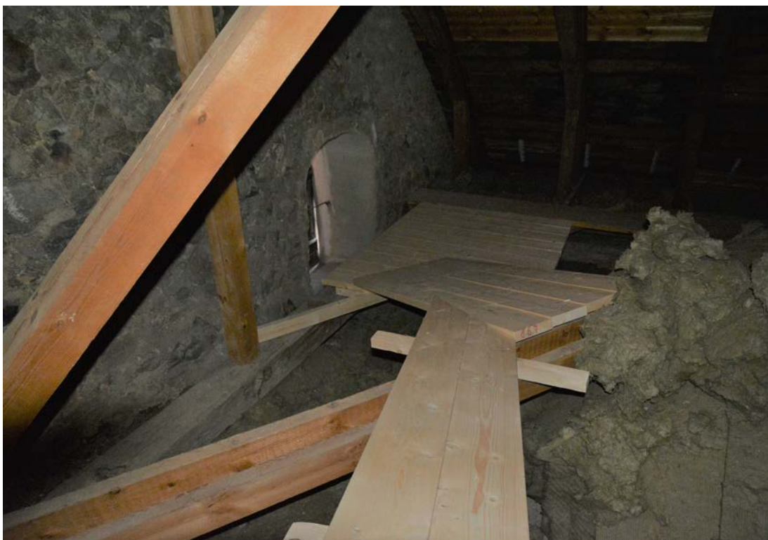
Bild 23. Spången till plattformen vid fasadluckan i kyrkvindens västra tvärvägg. Foto: 2019-03-28. SLM D2020-0129.
