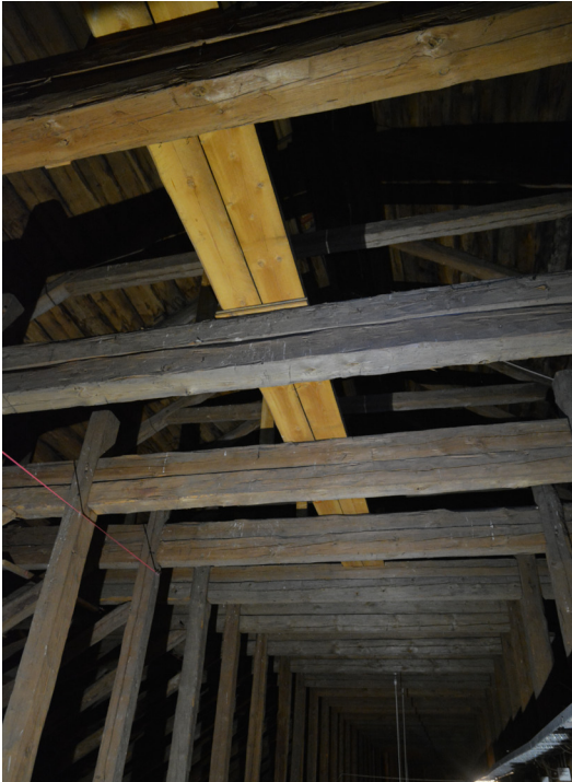
Bild 6. Spången sedd underifrån. Foto: Kjell Taawo, 2019. SLM D2020-0118.
