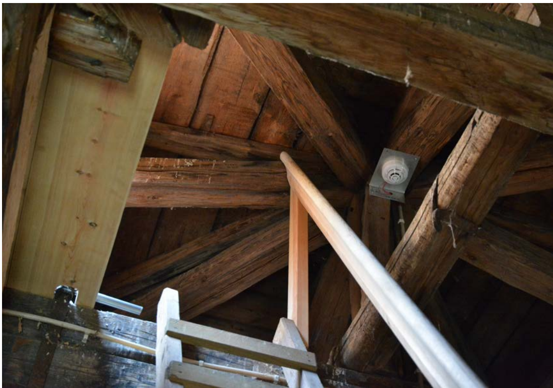
Bild 31. Ny rökdetektor i kyrktornetsnock, strax under korset. Foto: 2019-07-12. SLM D2020-0137.
