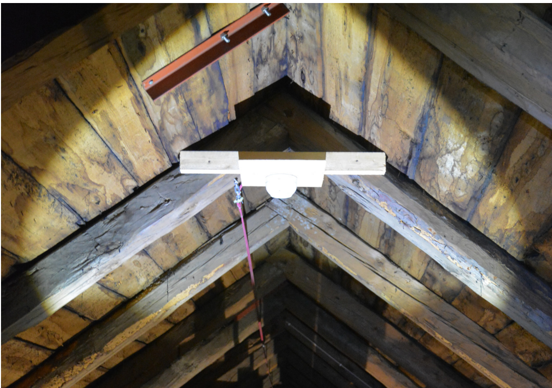
Bild 8. En av de tidigare branddetektorerna i kyrkvindensnock. Foto: Kjell Taawo, 2019. SLM D2020-0120.
