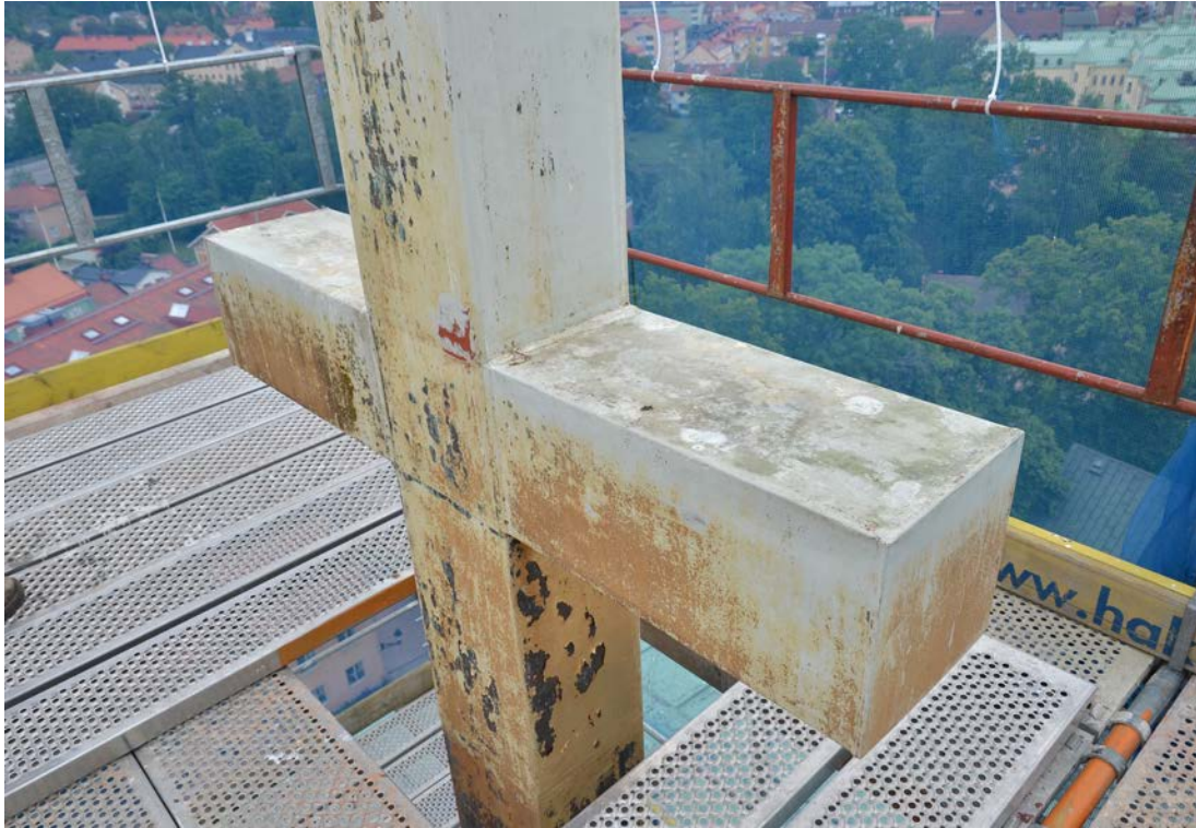
Bild 11. Korsets förgyllning innan påbörjad renovering. Foto: 2019-06-11. SLM D2020-0121.
