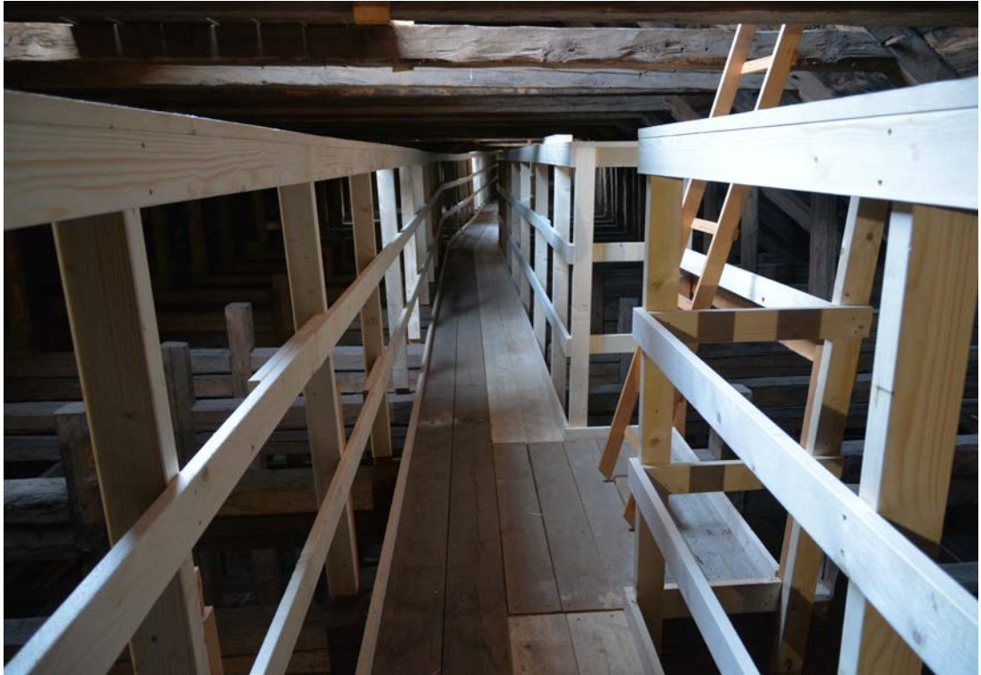
Bild 17. Kyrkvinden efter renovering, vy mot kyrkvindens västra del. Foto: 2019-03-28. SLM D2020-0123.
