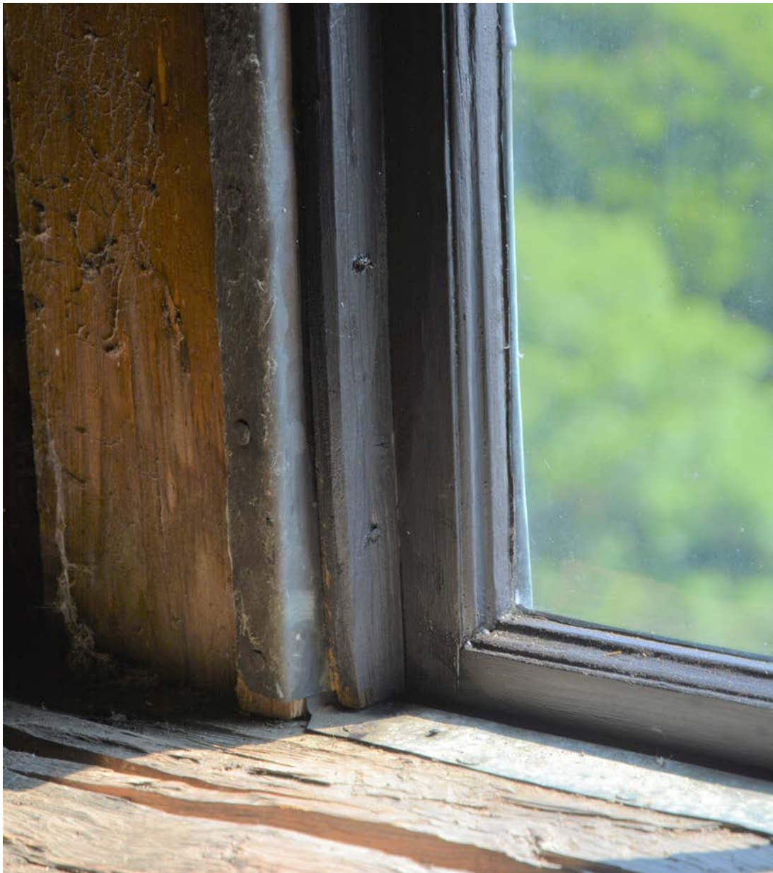
Bild 46. Fönstren renoverades genom kittning med linoljekitt och målning med linoljefärg. Bågen sitter fast mellan en spikad bräda på insidan av bågen, och den (sedan tidigare befintliga) galvaniserade plåten på utsidan av bågen. Foto: 2019-07-12. SLM D2020-0152.
