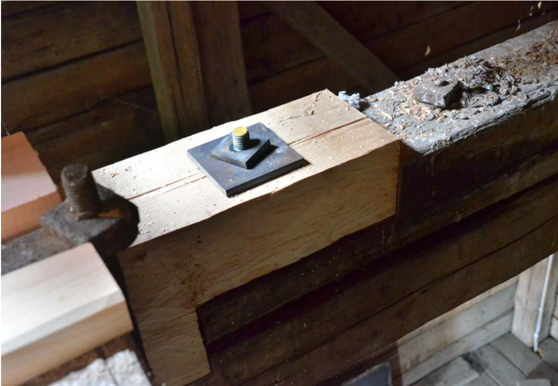
Bild 33. Det skarvade timret skruvades fast med franska träskruvar, lika befintligt. Foto: 2019-06-11. SLM D2020-0139.
