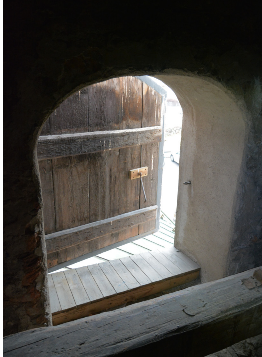
Bild 7. Fasadluckan i långhusets västra tvärvägg som vetter ut mot taket ovanför körövningsrummet. Foto: Kjell Taawo, 2019. SLM D2020-0119.
