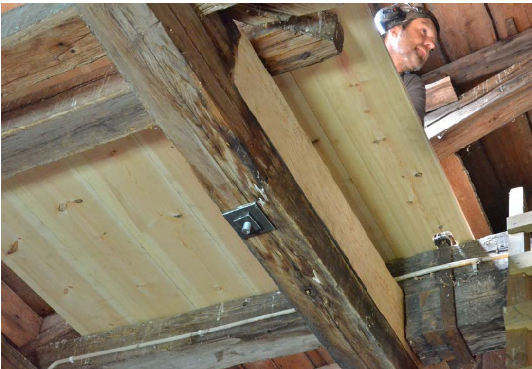
Bild 34. Ilagad timmerbjälke och ny platå under takluckan. Foto: 2019-06-11. SLM D2020-0140.
