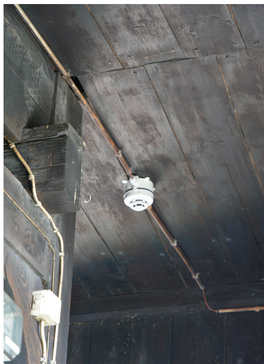
Bild 28. Ny rökdetektor i taket i kyrktornets lanternin. Foto: 2019-07-12. SLM D2020-0134.
