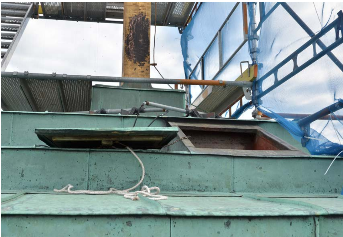
Bild 12. Takluckan innan renovering. Strax ovanför luckan syns de tidigare stängerna för strålkastarna. Foto: 2019-06-11. SLM D2020-0122.
