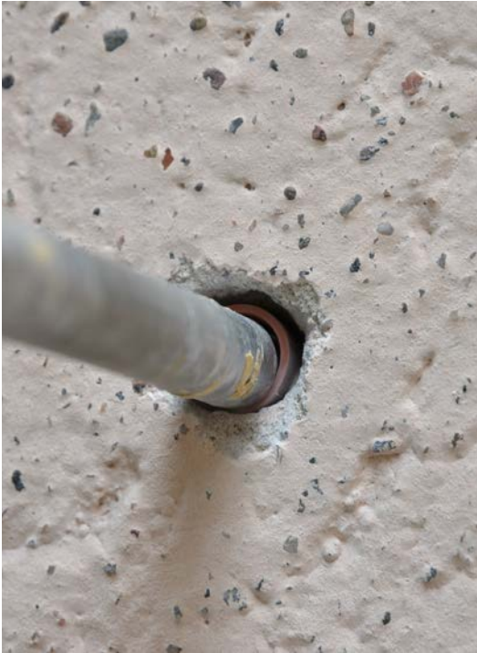
Bild 13. Borrhål med infästning för byggnadsställningen i nederdelen av kyrktornet. Foto: 2019-06-11 SLM D2020-0173.
