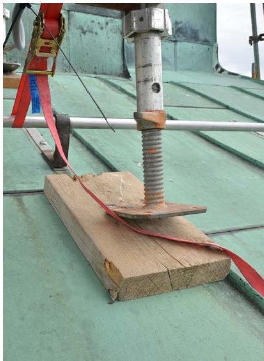
Bild 16. Där byggnadsställningens stolpar vilade på taket lades brädbitar ut till skydd för plåten. Foto: 2019-06-11 SLM D2020-0176.
