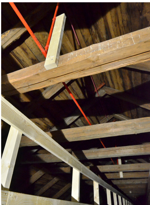
Bild 25. De uppstickande rökdetektorerna, som monterades på var fjärde takstol, stadgades upp med träreglar som skruvades fast i hanbjälkarna. Foto: 2019-04-12. SLM D2020-0131.
