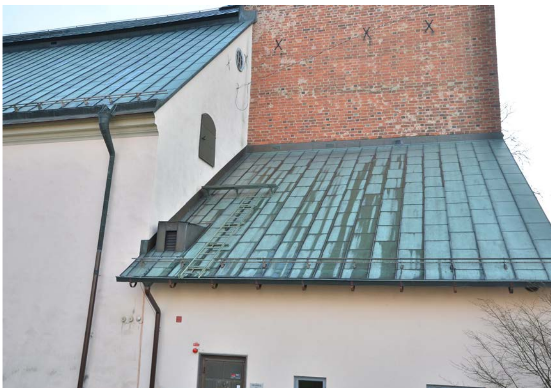
Bild 50. Stegen och takbryggan i aluminium klämdes fast i befintliga plåtfalsar och målades med Isotrol i kulör liknande den ärgade kopparplåten. Foto: 2020-02-12. SLM D2020-0156.
