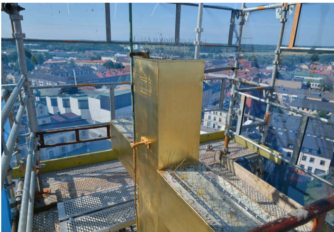
Bild 45. Korset efter avslutad renovering. Nya fästen till åskledaren gjordes, de gamla hålen löddes igen av plåtslagaren. Foto: 2019-07-12. SLM D2020-0151.
