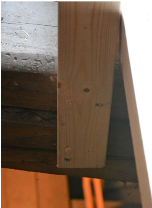
Bild 21. Närbild av stolpe som skruvats med två st torxskruv i det äldre timret. Foto: 2019-03-28. SLM D2020-0127.
