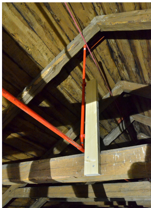
Bild 26. Reglarna monterades med två st torxskruv. Foto: 2019-04-12. SLM D2020-0132.
