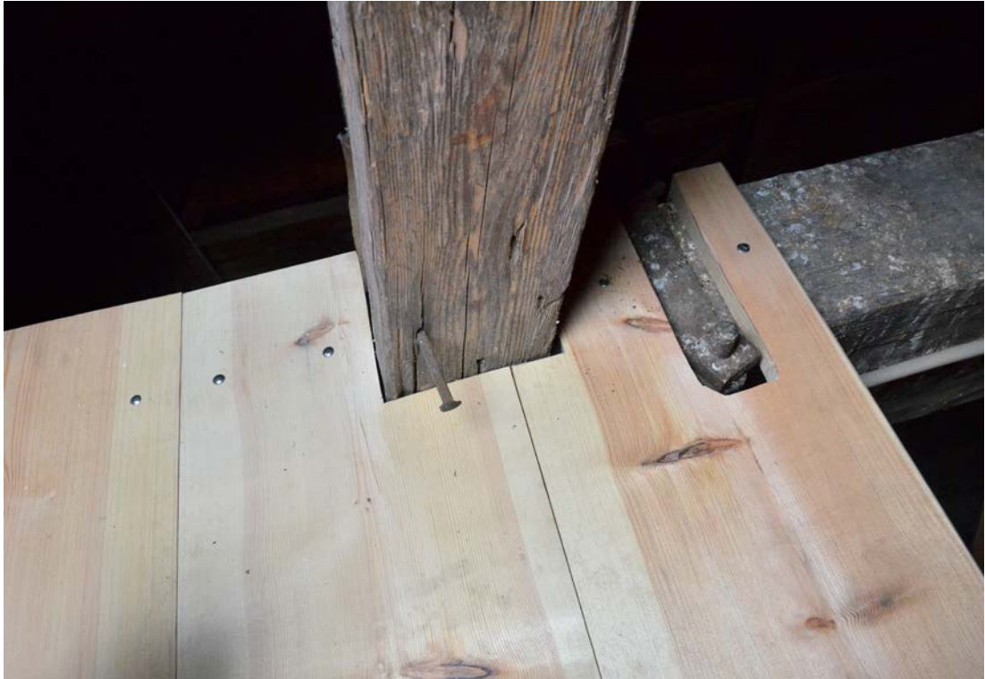
Bild 35. Brädorna sågades ur för att passa in mellan befintliga beslag mm. Notera de handsmidda spikarna. Foto: 2019-06-11. SLM D2020-0141.
