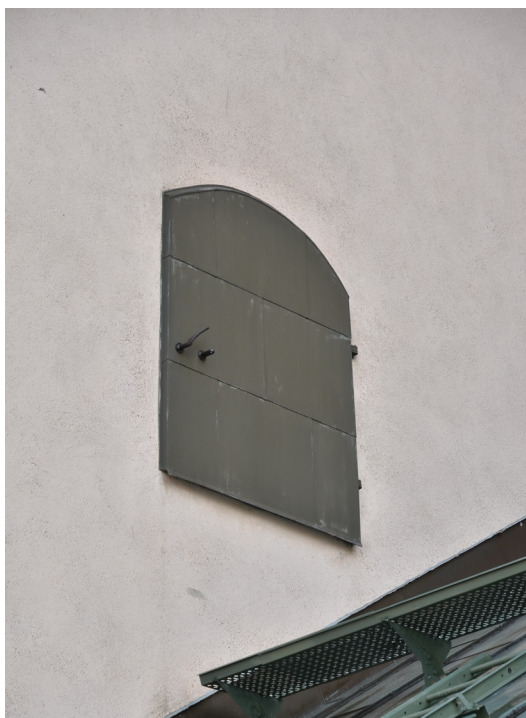
Bild 48. Fasadluckan till vinden kompletterades med ett låsbart diskret handtag. Konstruktionen krävde inga ingrepp i murverket. Foto: 2020-02-12. SLM D2020-0154
