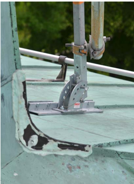
Bild 15. Infästning för byggnadsställningen på plåttakets ståndfals. Foto: 2019-06-11 SLM D2020-0175.
