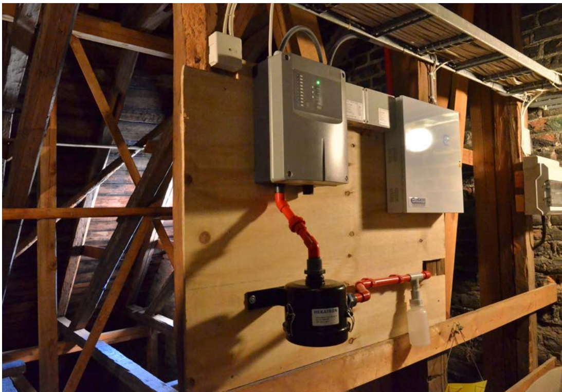
Bild 24. Brandcentralen vid kyrkvindens bakre del. Foto: 2019-04-12. SLM D2020-0130.
