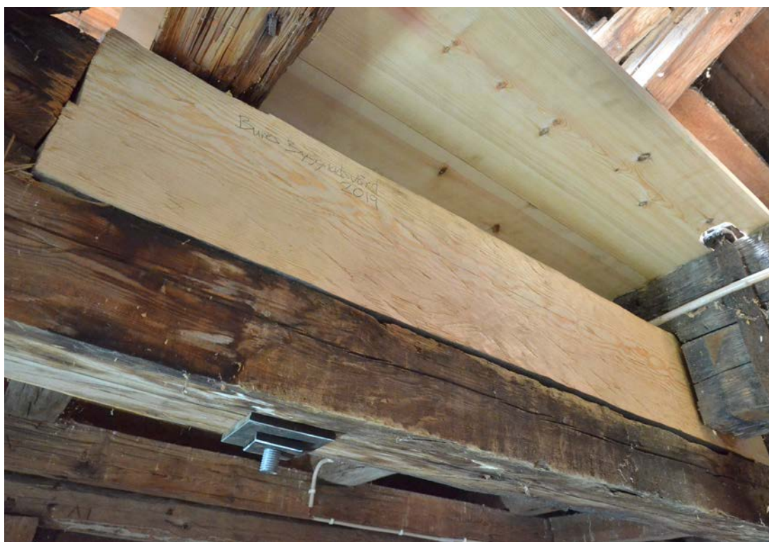
Bild 32. Den ilagade timmerbjälken och den nya platån strax under takluckan. Foto: 2019-06-11. SLM D2020-0138.
