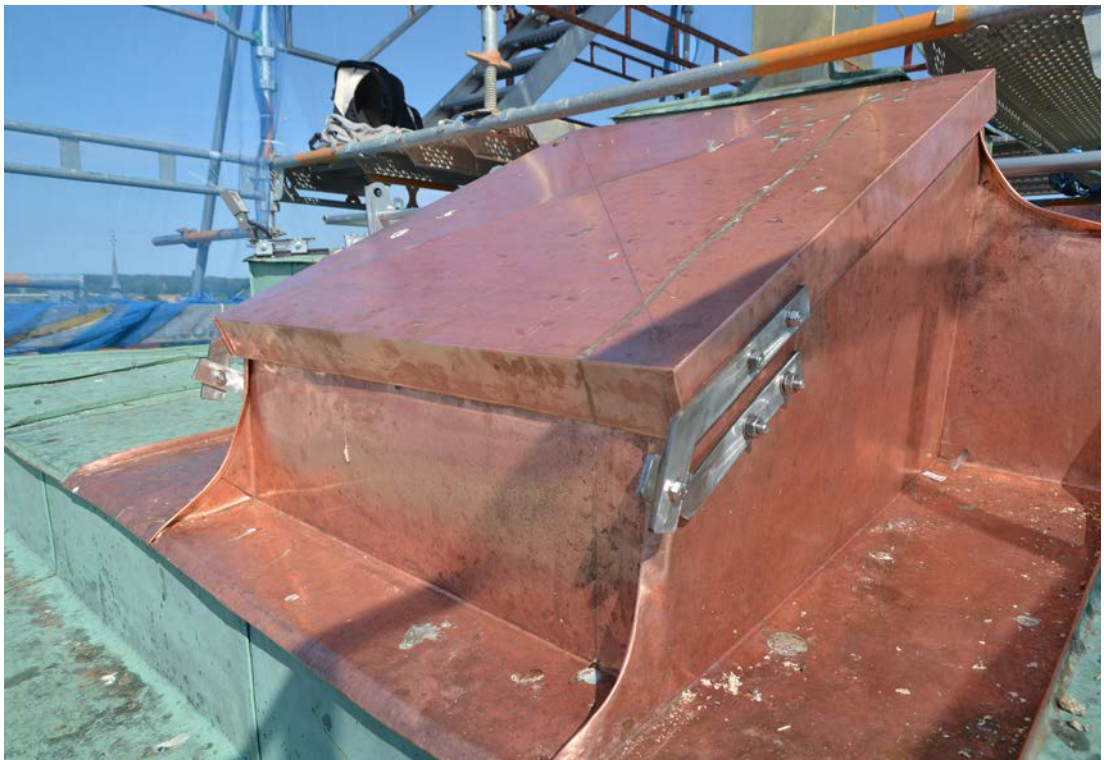
Bild 39. Takluckan efter avslutad renovering. Foto: 2019-07-08. SLM D2020-0145.
