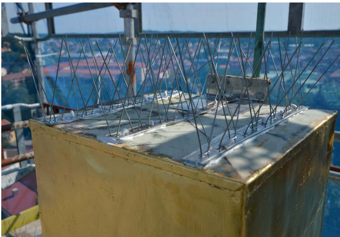
Bild 44. Korset efter avslutad renovering. Ytor som inte syns underifrån rengjordes endast, varpå fågelskydd limmades fast. Foto: 2019-07-12. SLM D2020-0150.
