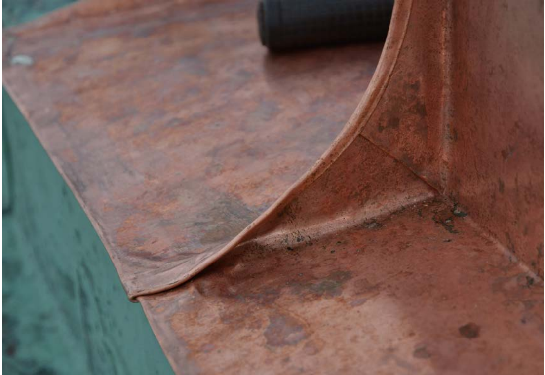
Bild 38. Ny kopparplåt med enkelfasning. Foto: 2019-07-08. SLM D2020-0144.
