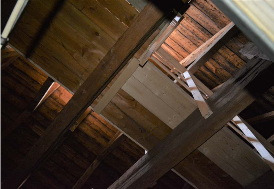
Bild 19. Den breddade landgången sedd underifrån. Bilden visar delar av konstruktionen: de nya plankorna skruvades endast i regler vid sidan av bindbjälkarna. De enda ingrepp som gjordes i det äldre timret var stolparna på högra (södra) sidan om landgången, vilka skruvades fast. Foto: 2019-03-28. SLM D2020-0125.
