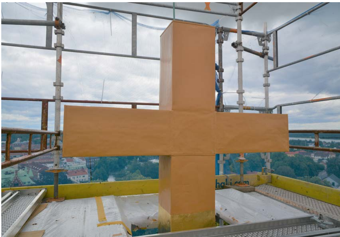
Bild 43. Korset under pågående renovering. Den gula färgen utgörs av linoljefärg med guldockrapigment. Nedtill syns bladguldet som limmades fast. Foto: 2019-07-08. SLM D2020-0149.
