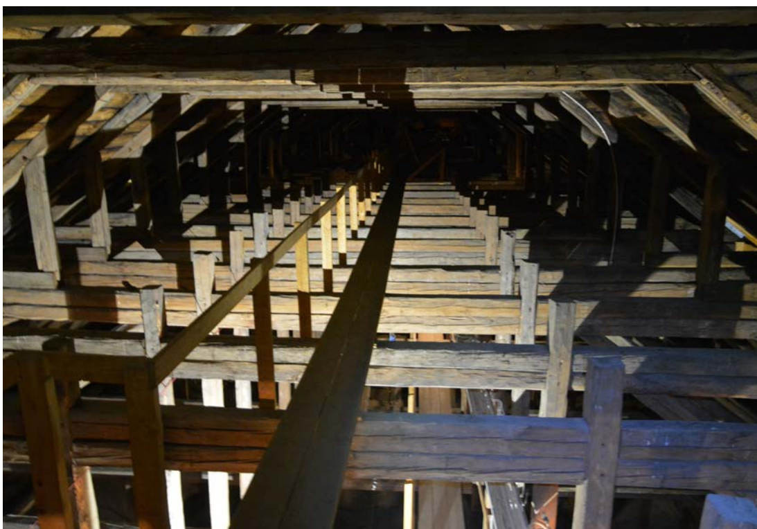
Bild 5. Långhusets vind. Bilden är tagen i riktning mot koret. Foto: Kjell Taawo, 2019. SLM D2020-0117.
