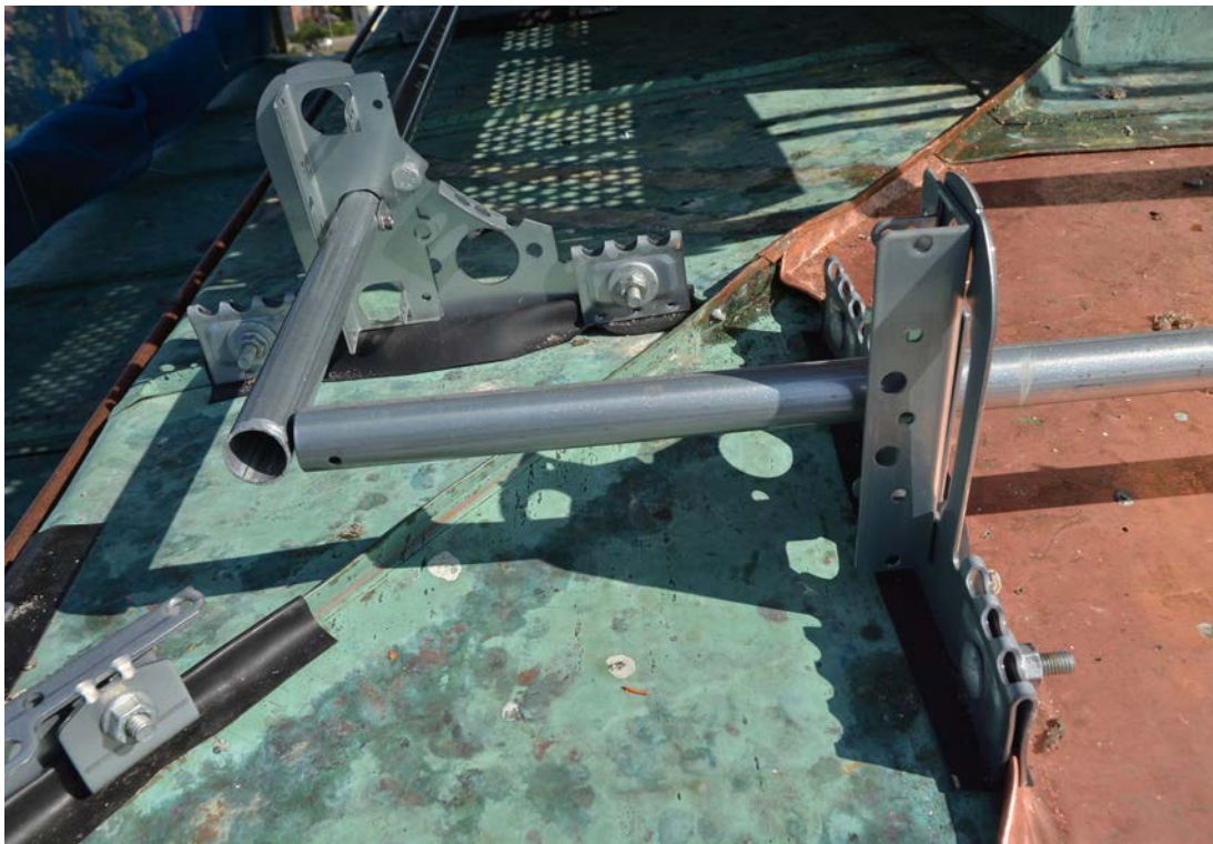
Bild 41. Nya säkerhetsskenor monterades för att underlätta framtida reparationer och andra åtgärder. Skenorna klämdes fast i takplåtens ståndfalsar. Foto: 2019-07-12. SLM D2020-0147.
