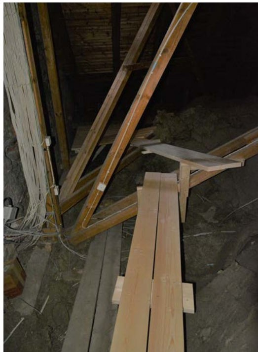
Bild 22. Spången till plattformen vid fasadluckan i kyrkvindens västra tvärvägg. Foto: 2019-03-28. SLM D2020-0128.
