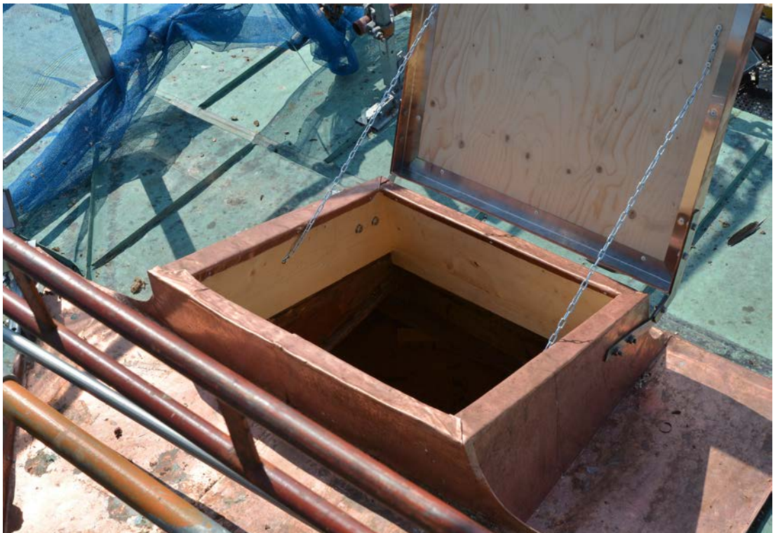
Bild 36. Den nya takluckan efter renovering. Notera sargen som är högre än i den föregående konstruktionen (jämför med bild 12). Foto: 2019-06-11. SLM D2020-0142.
