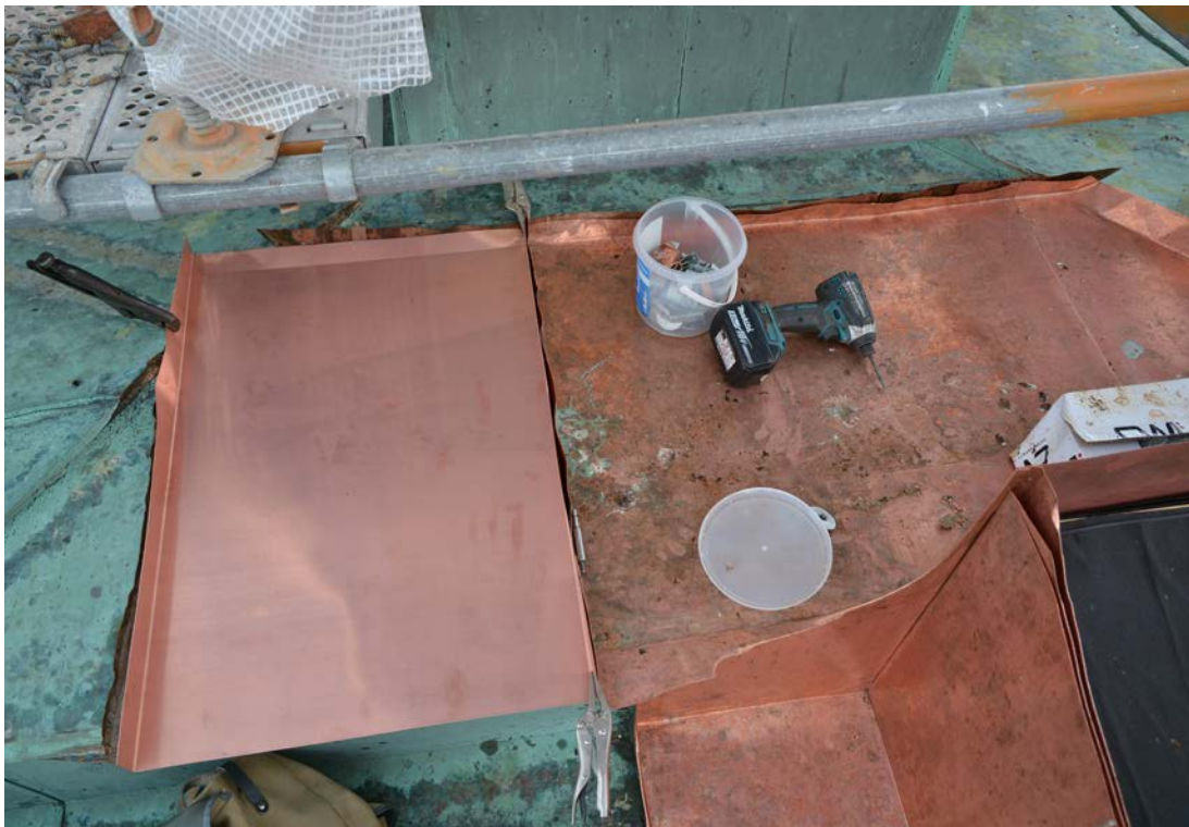
Bild 37. Även plåtarna vid sidan av luckan, där de tidigare fästena för strålkastarna var monterade, byttes ut. Foto: 2019-07-08. SLM D2020-0143.
