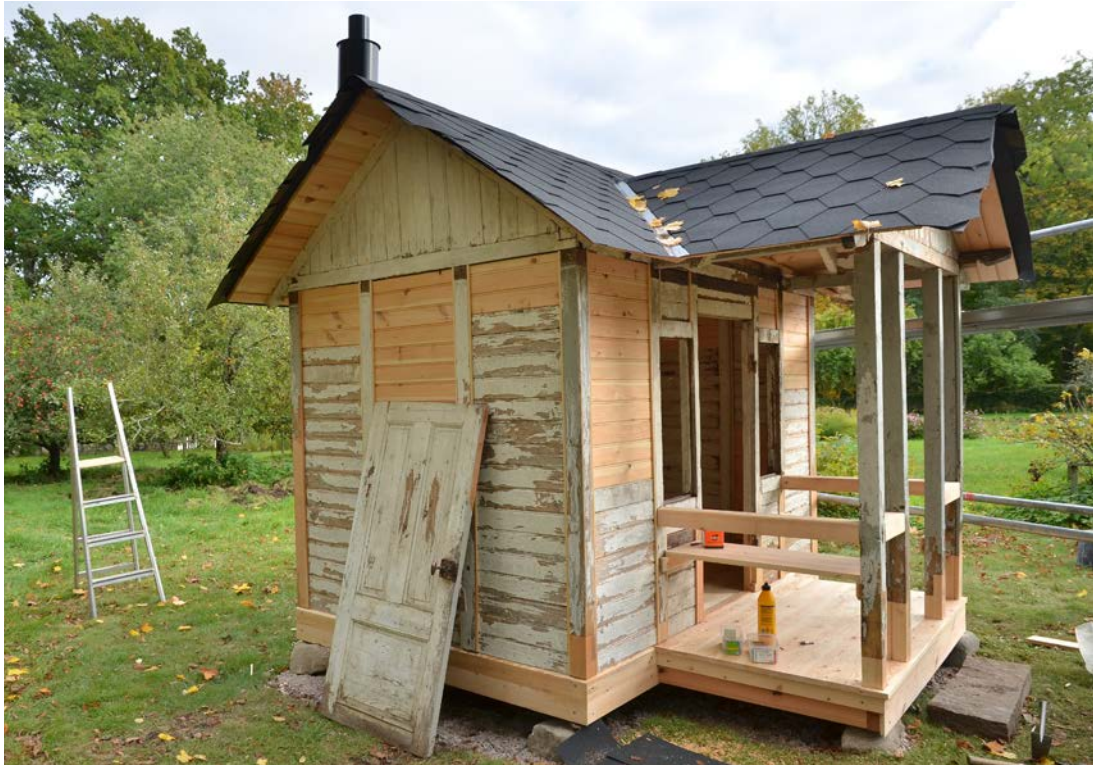
12 Lekstugan är flyttad, rötskadad väggpanel har ersatts och taket har klätts med papp och "shingel" (SLM D2020-0799).
