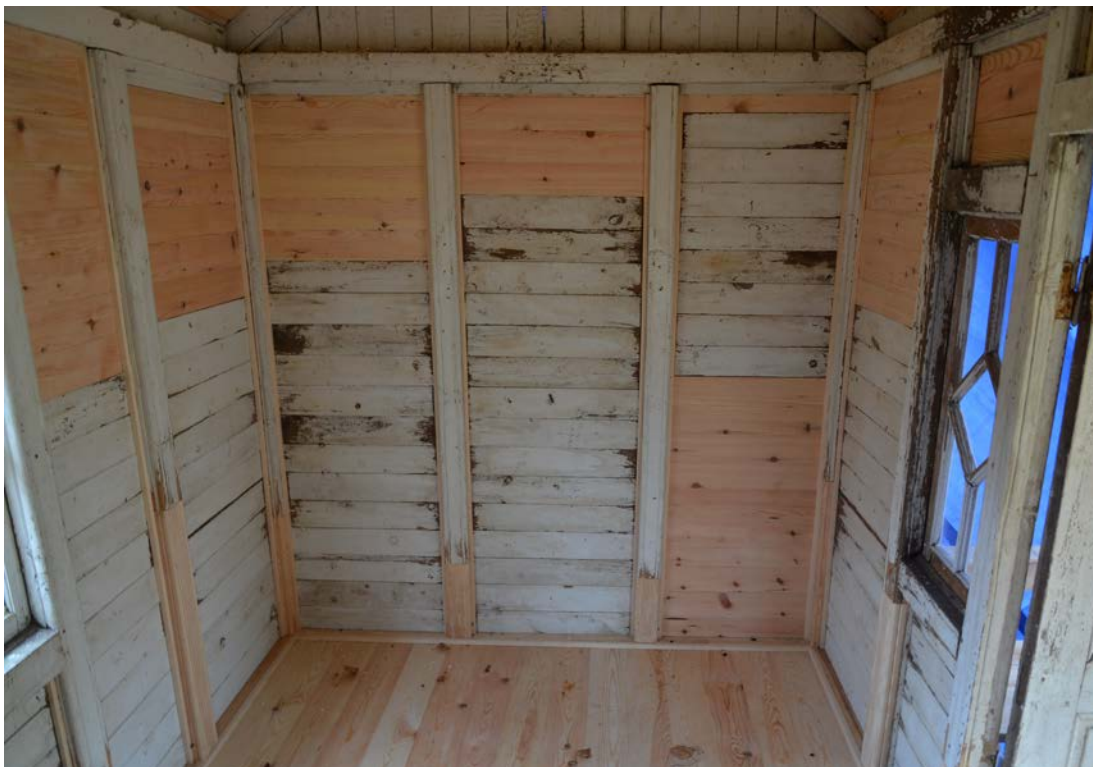
13 Vy av väggarna. Stora delar av ursprungsmaterialet sparades. Stolparna lagades i nedtill och skarvades halvt i halvt (SLM D2020-0800).
