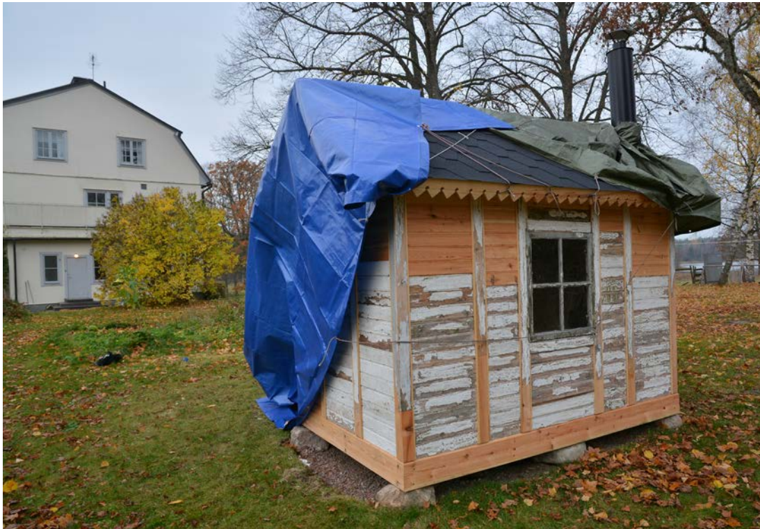
9 Lekstugan efter flytten och efter reparationer av tak och väggar. I bakgrunden mangårdsbyggnadens östra gavel (SLM D2020-0797).
