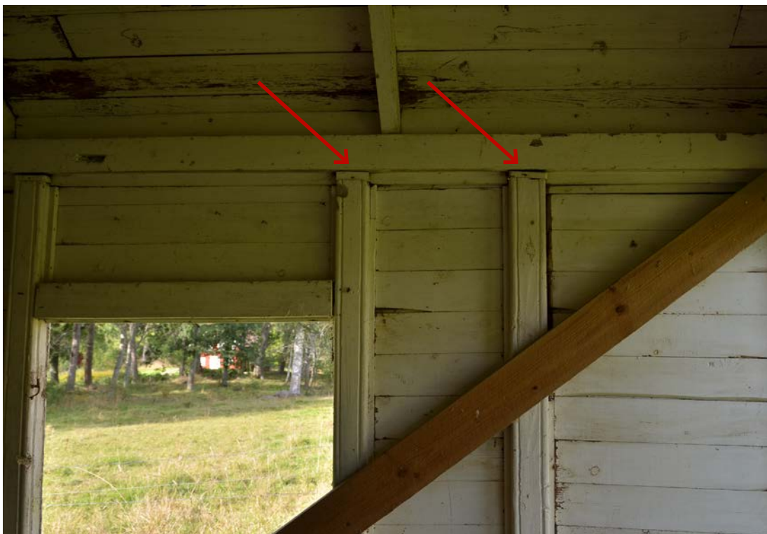
6 Ovanpå stolparna låg passbitar, som nu togs bort (SLM D2020-0794).
