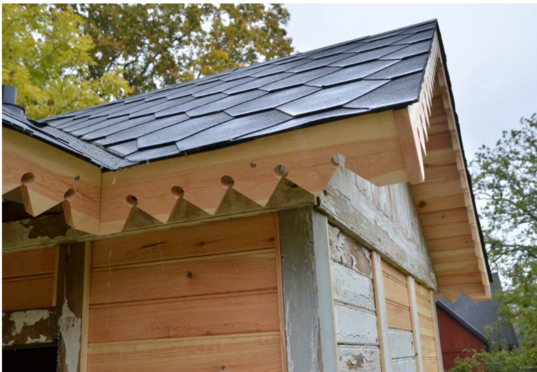
10 Takfotsdekorationen återskapades (SLM D2020-0798).
