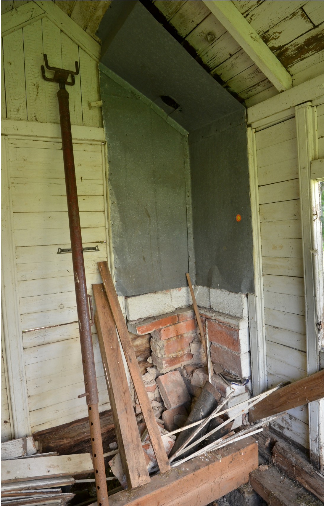
14 Lekstugans nordvästra hörn före flytt och renovering. Murstocken är raserad, vedspisen är tillfälligt undanställd (SLM D2020-0801).
