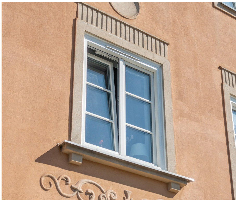
Utbytt fönster på Brandstoden 26. Fönstret har en yttersida av aluminium, utanpåliggande spröjs, plana glas och raka profiler på både karm och bäge. Dessutom har de en modern upphängning vilket gör att de kan öppnas på ett med hänsyn till byggnadens ålder främmande sätt. Detta gör att det ser ut som bågen är på väg att ramla inåt. Fönstret har enligt tillverkaren tio års garanti. Om hur många år kommer fönstret att behöva ersättas av ett nytt? De ursprungliga fönstren som nyligen kasserades hade suttit i 90 år. Som skäl för att byta ut dem angavs i första hand bullerproblematik från den trafikerade vägen, något som dock kunde ha åtgärdats t ex genom en extraruta och förbättrad tätning. Foto: David Hansson (SLM D2019-0401)
