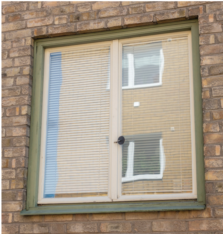
Ett av fönstren på Jägmästaren 16 mot Östra Kvarngatan. Bågarna är smäckra och karmarna väl anpassade till muröppningen. Notera också glasets "levande" reflektioner som är ett resultat av tillverkningen med valsar. Foto: David Hansson (SLM D2019-0399)
