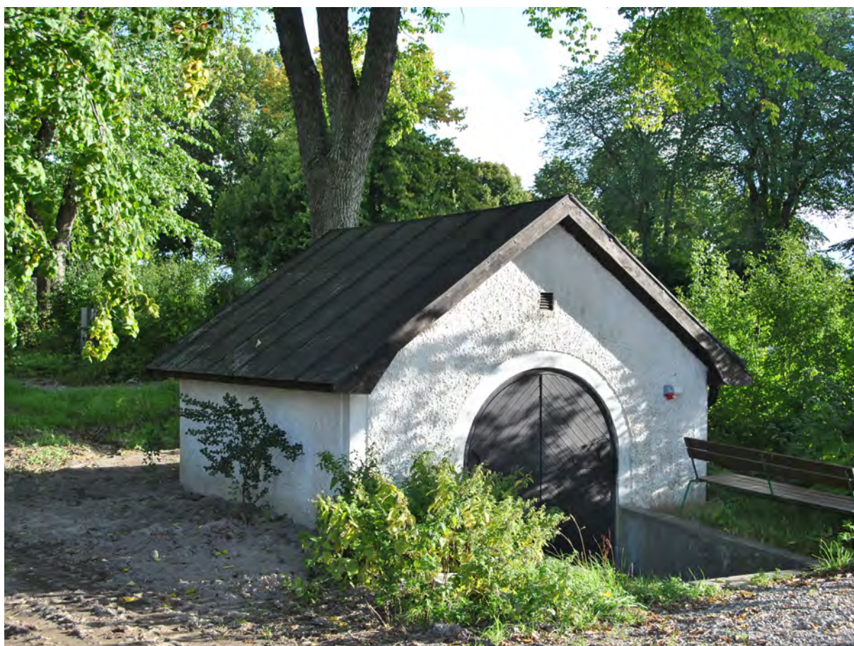
9 Bårhuset i väster som nu är ombyggt till teknikhus. Fotografi från 2010, Sörmlands museum, Dag Forssblad (SLM D10-1223).
